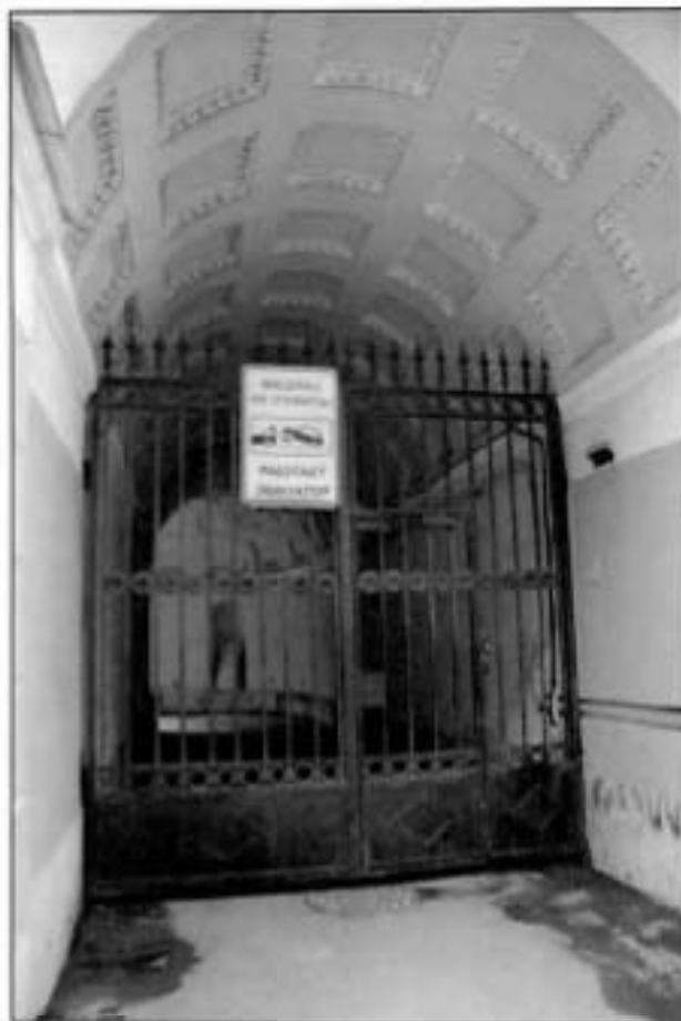
3. Арочный проезд. Северо-западный фасад.
