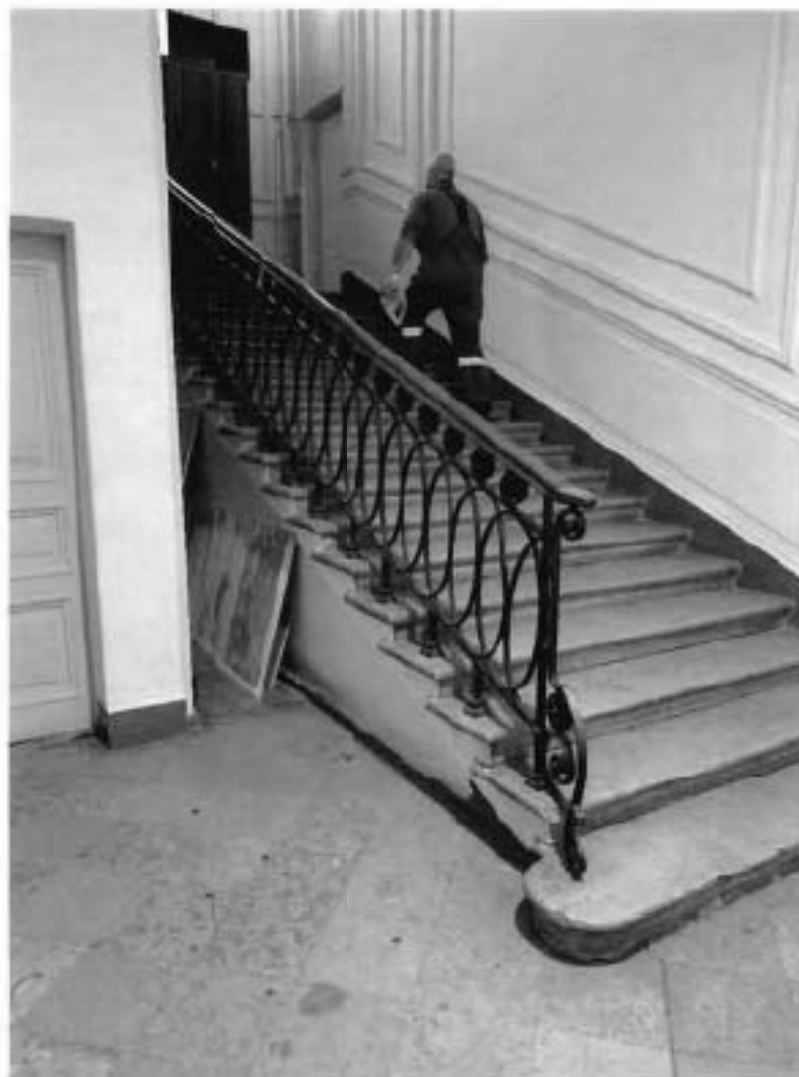
14. Фрагмент лестницы Л-6.
