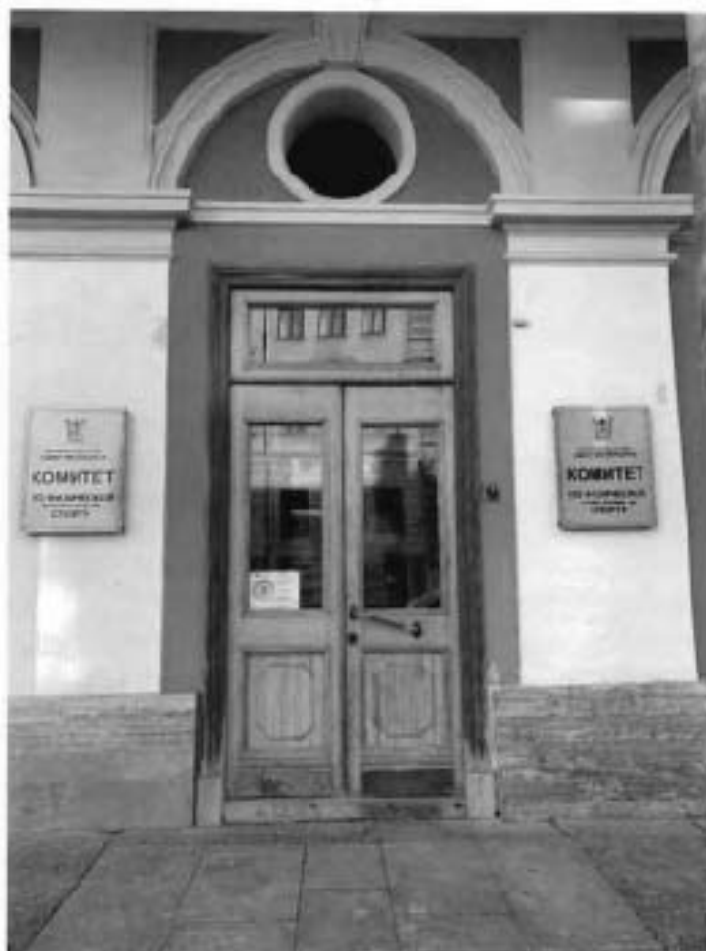
2. Дверь со стороны лицевого фасада по Миллионной ул.
