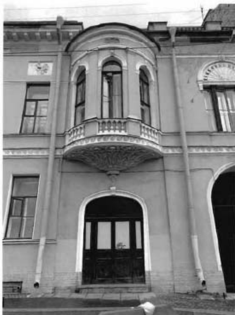
2. Фрагмент объекта культурного наследия со стороны наб.р.Мойки.
