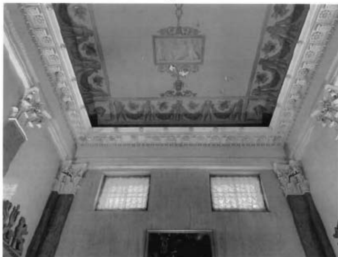
16. Интерьеры. пом. Театрального зала.
