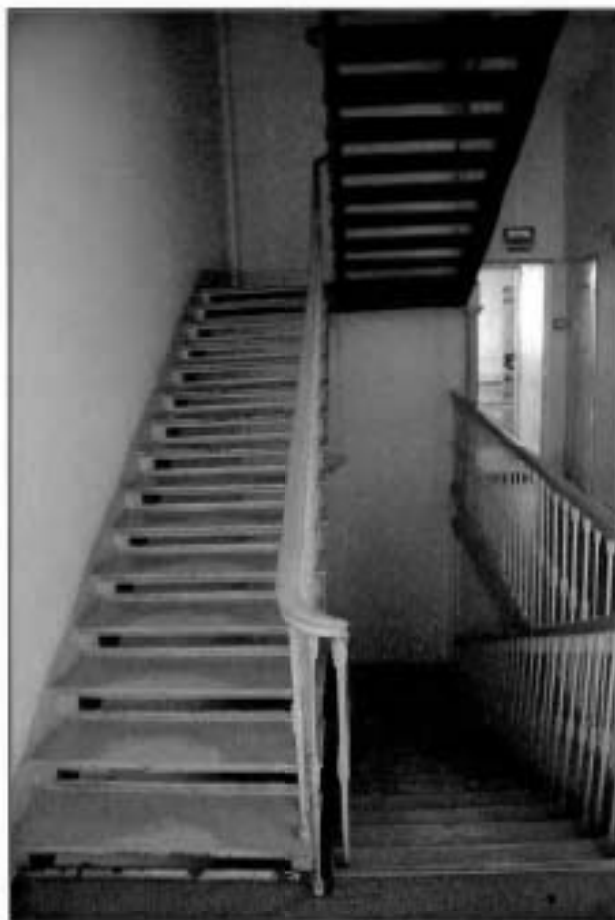
17. Лестница. Помещение 19-Н (43).
