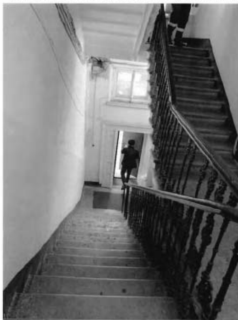
13. Фрагмент лестницы Л-7.
