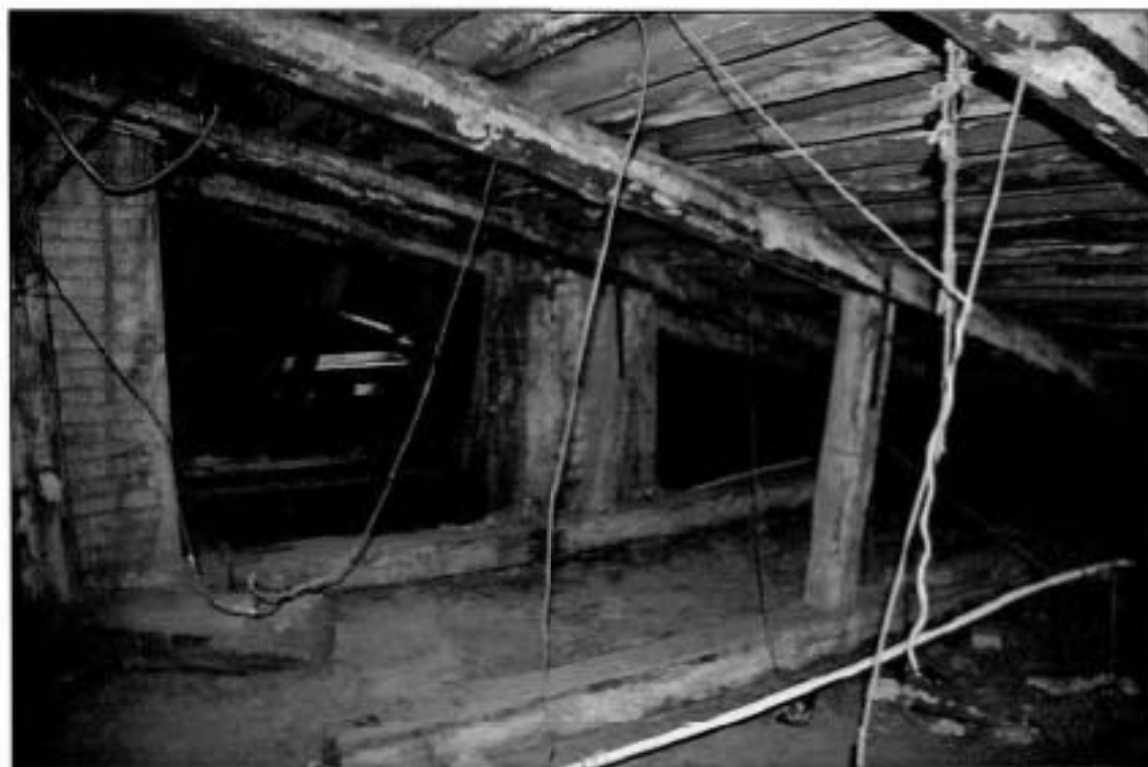
18. Стропильная система.
