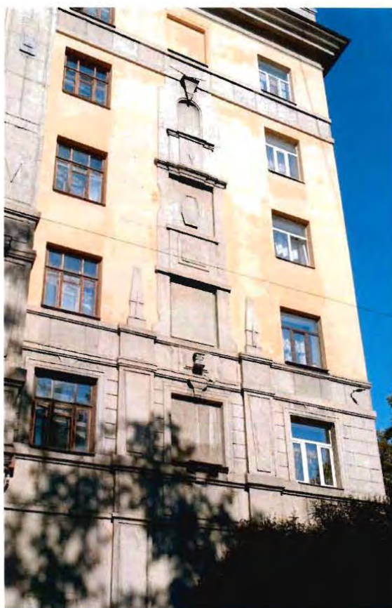
13. Фрагмент. Северный фасад северного флигеля.
