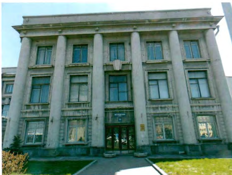
Фото 1. Фрагмент западного фасада.
