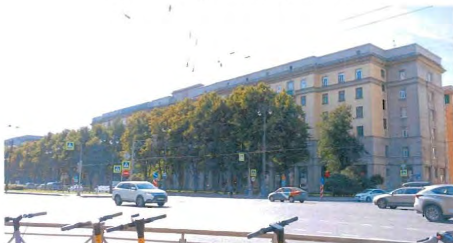
1. Общий вид. Восточный фасад северного флигеля.
