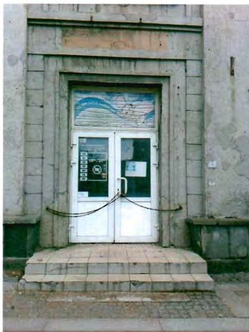
Фото 4. Дверной проем западного фасада.
