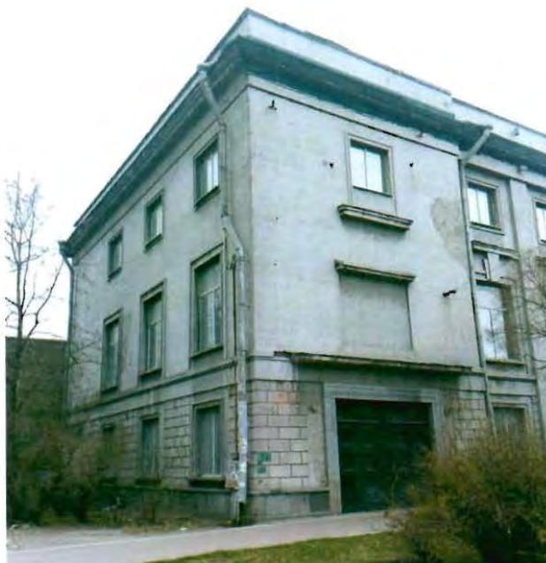
Фото 3. Часть западного и северного фасада.
