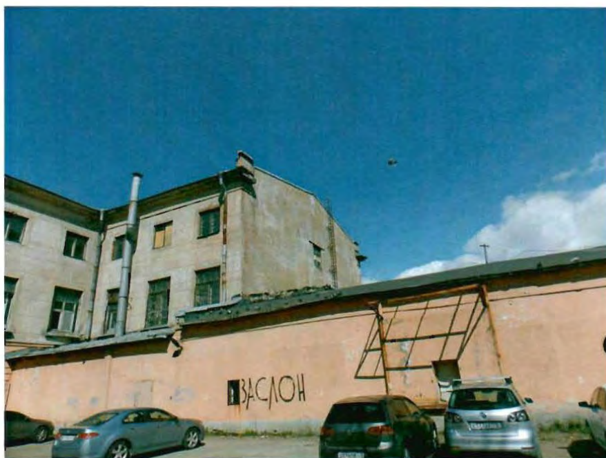
Фото 9. Часть южного и восточного фасада.
