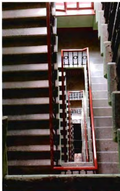
16. Интерьер. Пространство ЛК-9.
