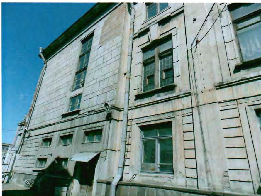
Фото 8. Часть южного фасада.
