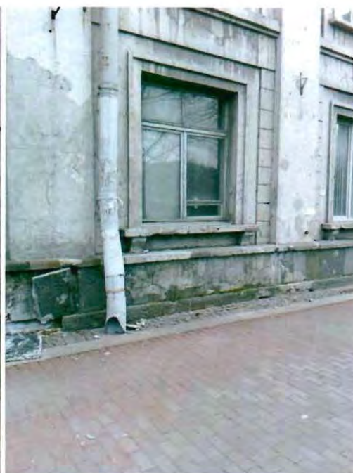
Фото 5. Фрагмент западного фасада.
