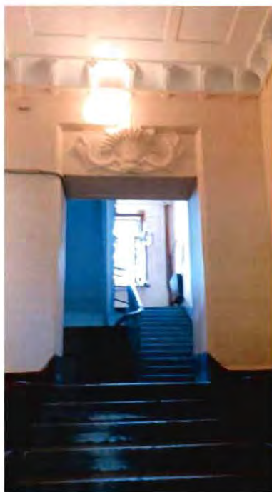
15. Интерьер. Пространство ЛК-4.
