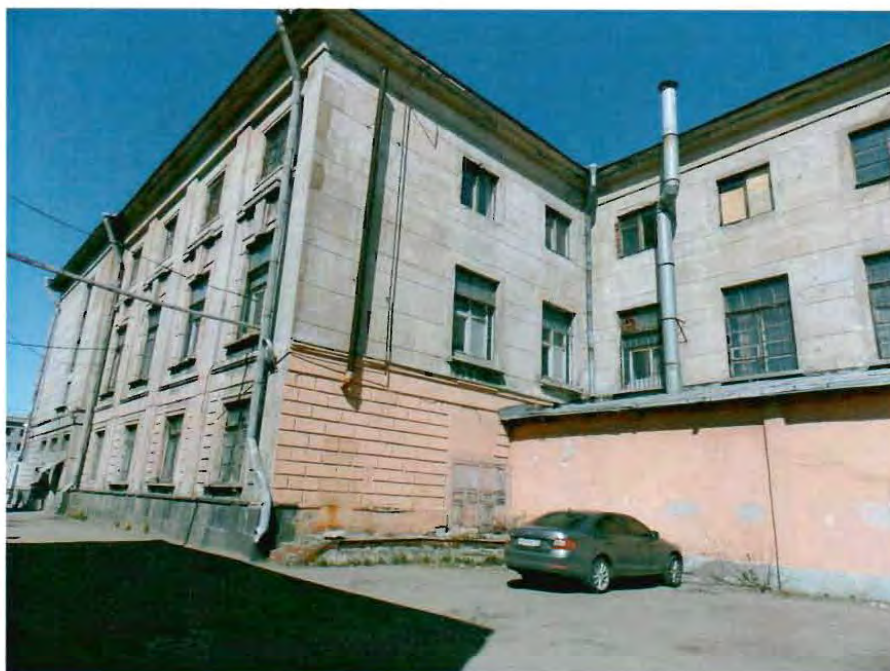
Фото 7. Часть южного и восточного фасада.
