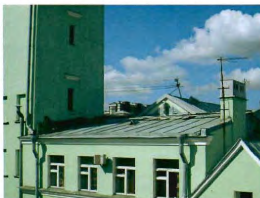
10. Вид на фальцевое покрытие кровли
