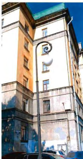
7. Фрагмент. Северный фасад южного флигеля.
