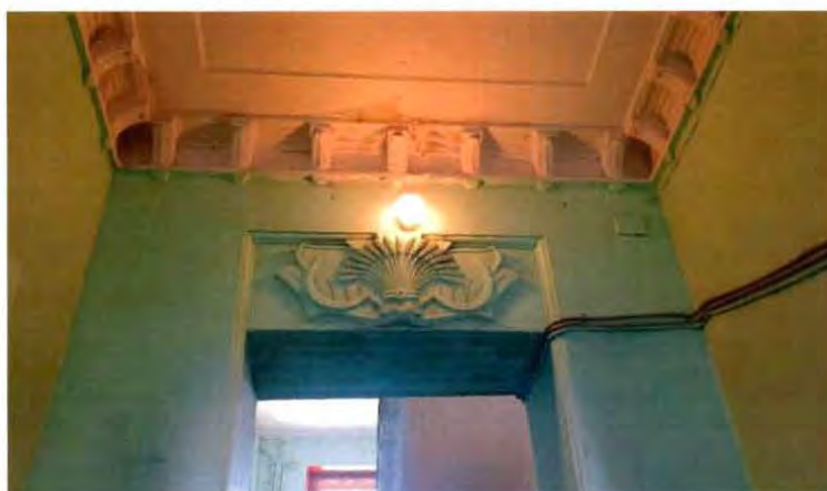
14. Интерьер. Пространство ЛК-1.
