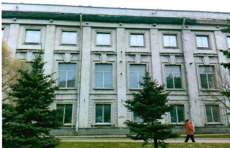
Фото 6. Фрагмент западного фасада.
