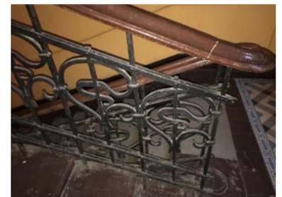
металлическое ограждение (металл, ковка) из вертикальных стоек и прутьев, декорированное волнтообразными элементами;
