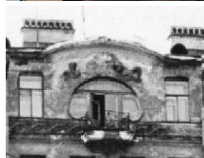
профилированный венчающий карниз, в том числе на стилизованных кронштейнах (эркер).
