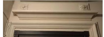
оформление потолка лестничной клетки – профилированный карниз, падуга, профилированные рамы, лепные композиции (в том числе растительного характера);
