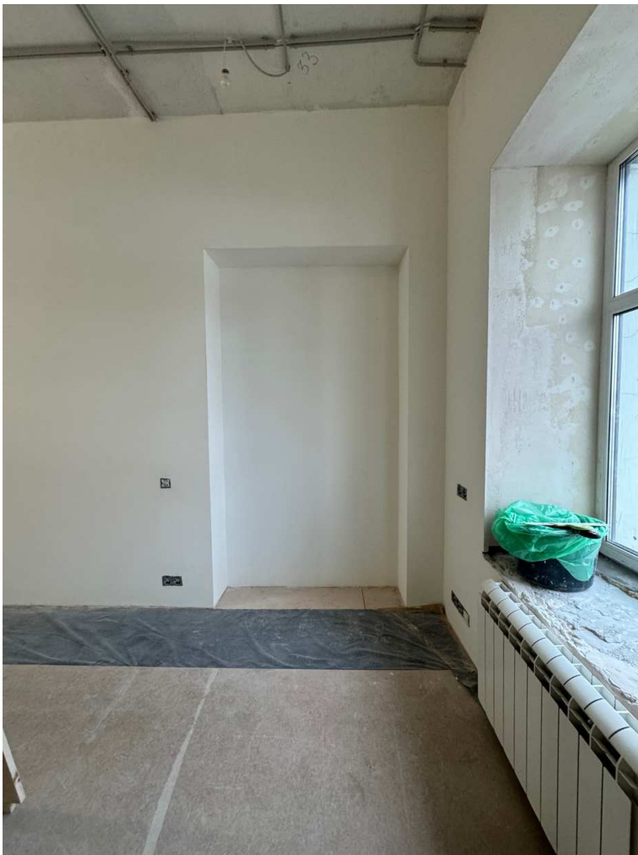
Фото 33. Вид на помещение квартиры № 39 объекта культурного наследия.
