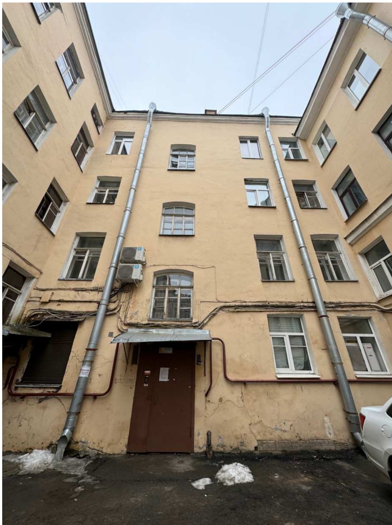
Фото 10. Общий вид дворовых фасадов объекта культурного наследия.
