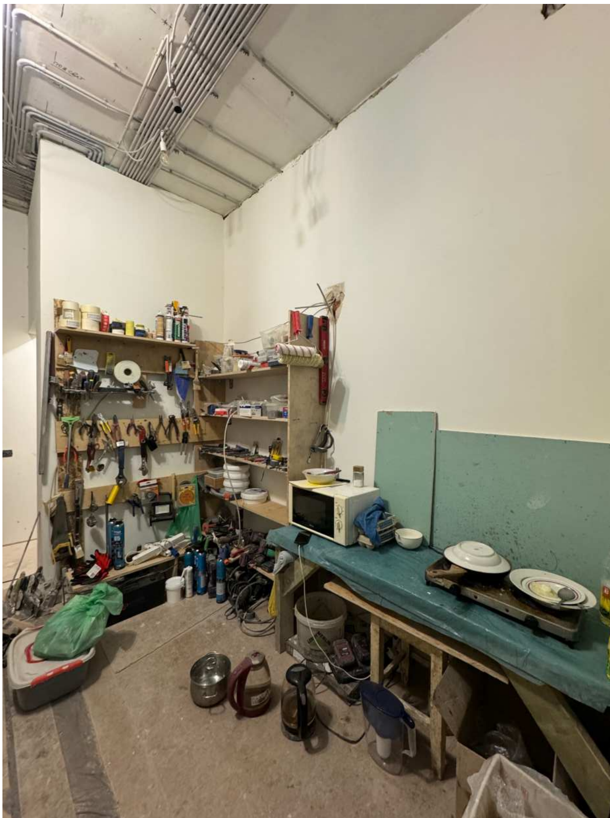
Фото 19. Вид на помещение квартиры № 39 объекта культурного наследия.
