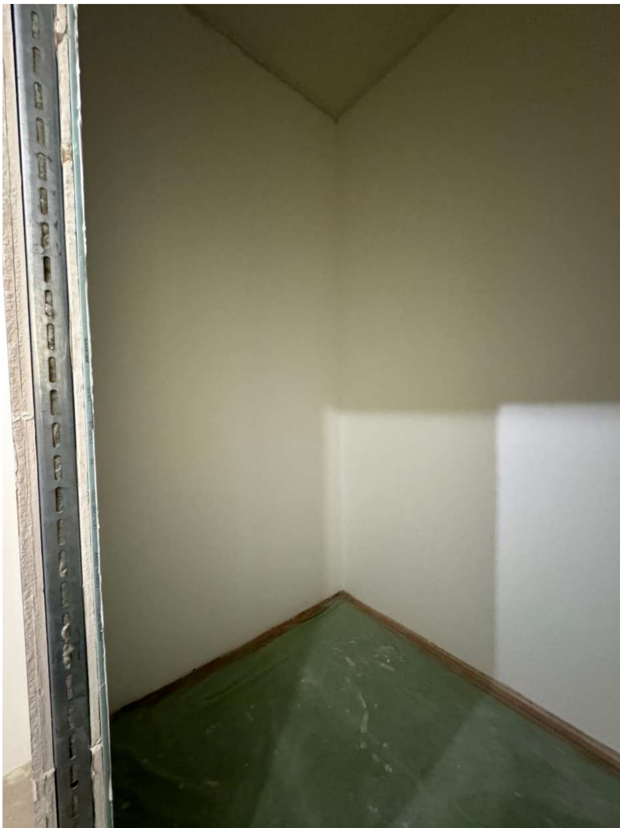
Фото 40. Вид на помещение квартиры № 39 объекта культурного наследия.
