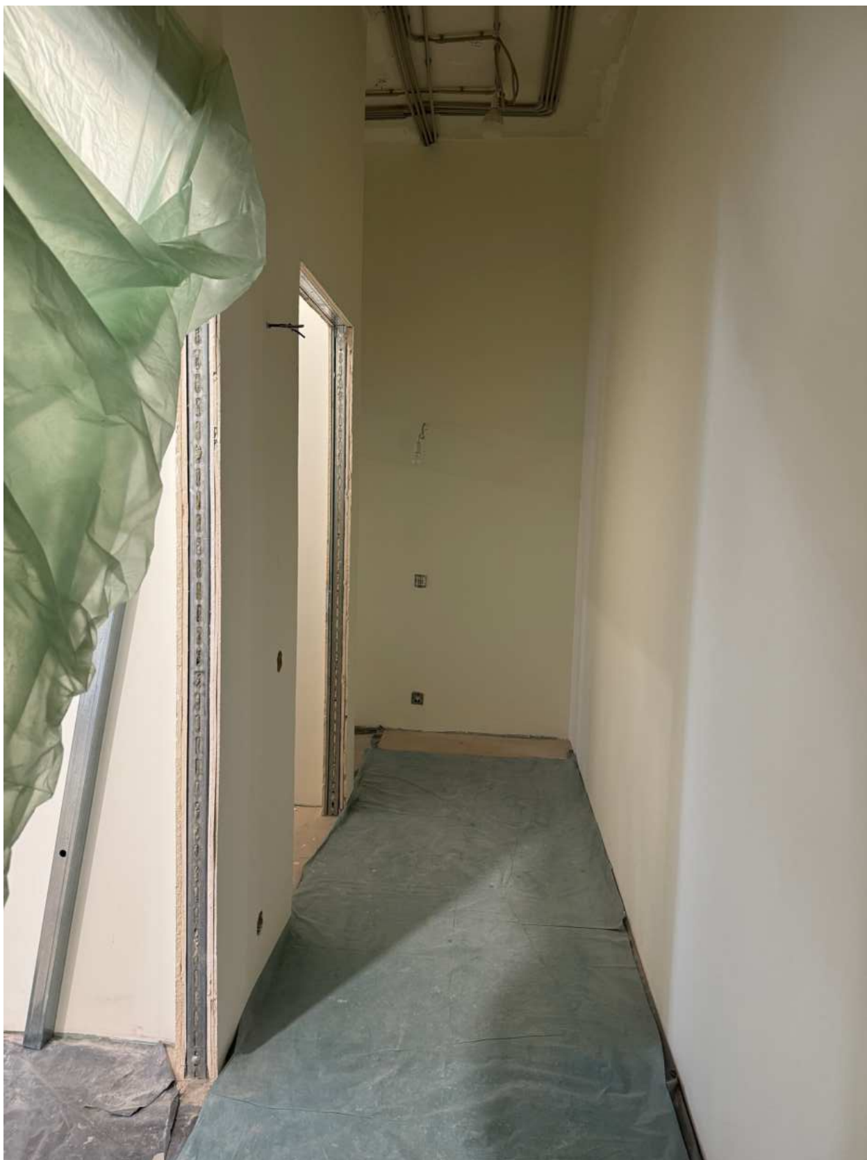
Фото 29. Вид на помещение квартиры № 39 объекта культурного наследия.
