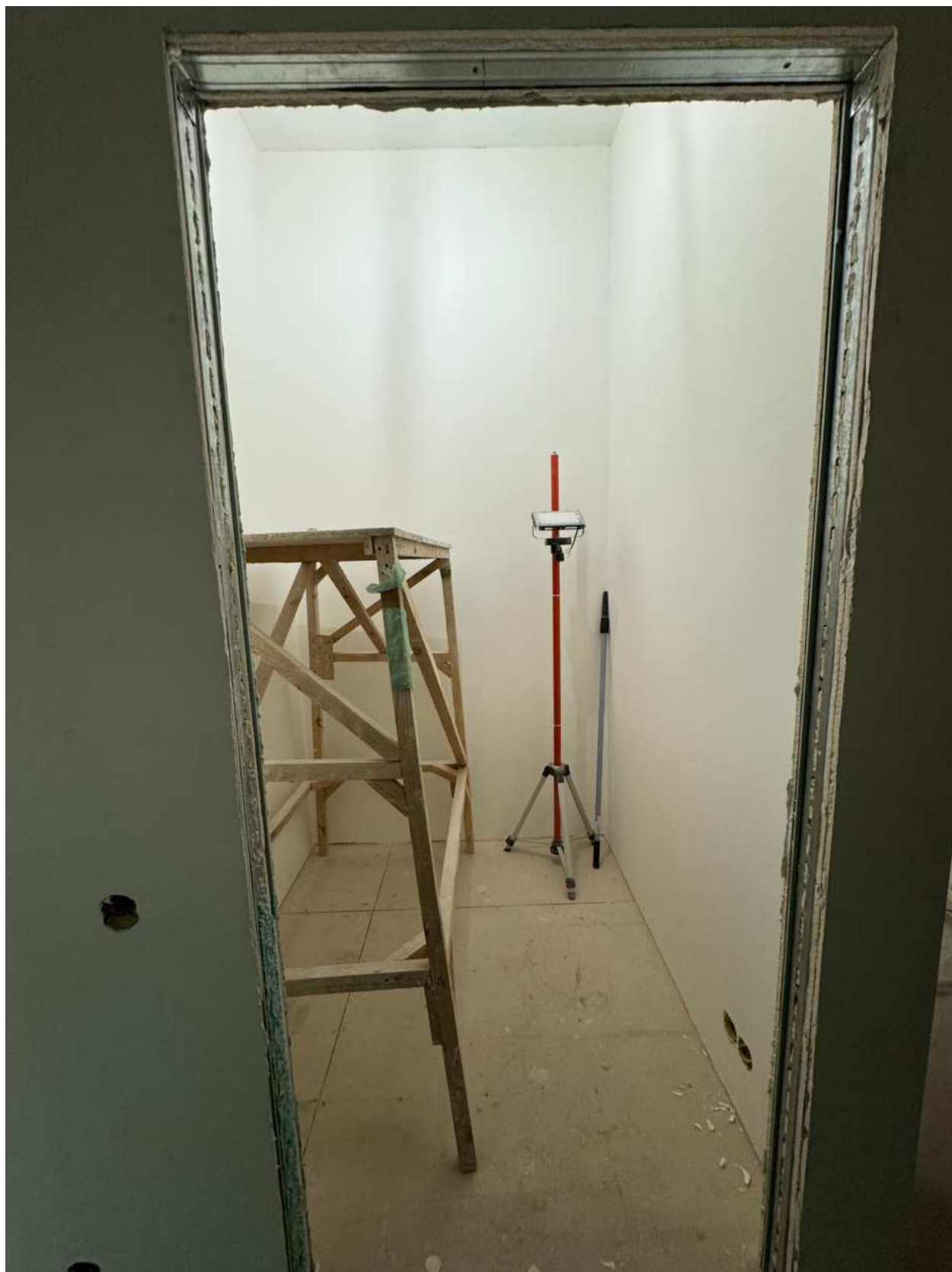
Фото 35. Вид на помещение квартиры № 39 объекта культурного наследия.
