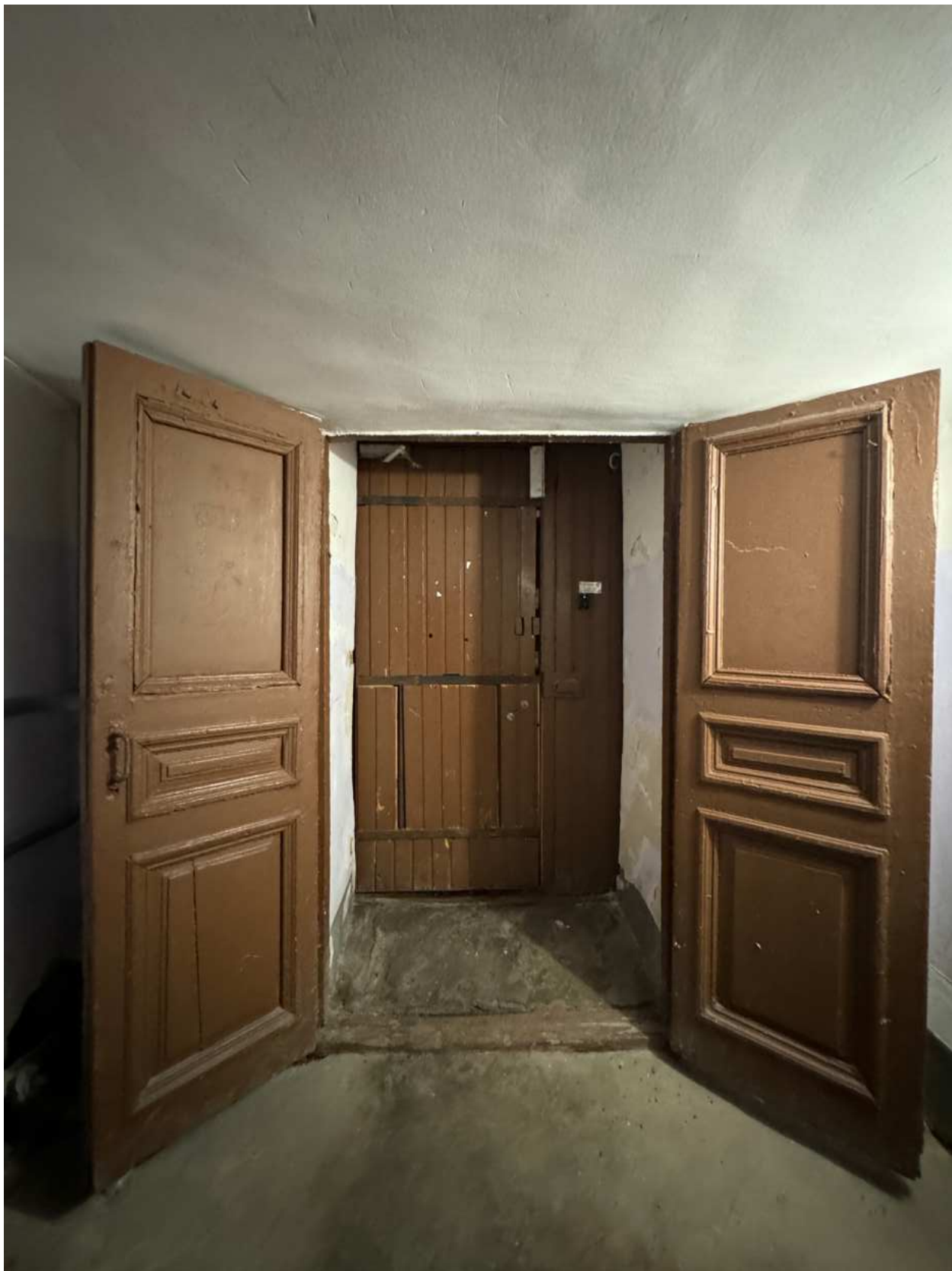
Фото 12. Вид на интерьер парадной, ведущей к квартире № 39, объекта культурного наследия.
