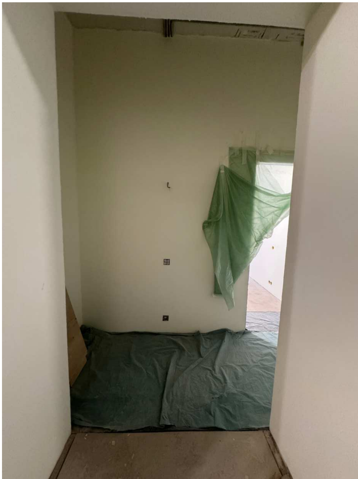
Фото 28. Вид на помещение квартиры № 39 объекта культурного наследия.
