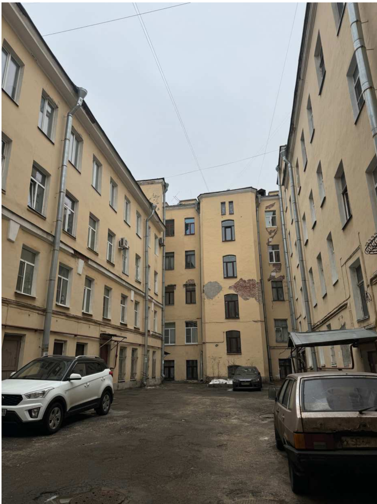
Фото 9. Общий вид дворовых фасадов объекта культурного наследия.
