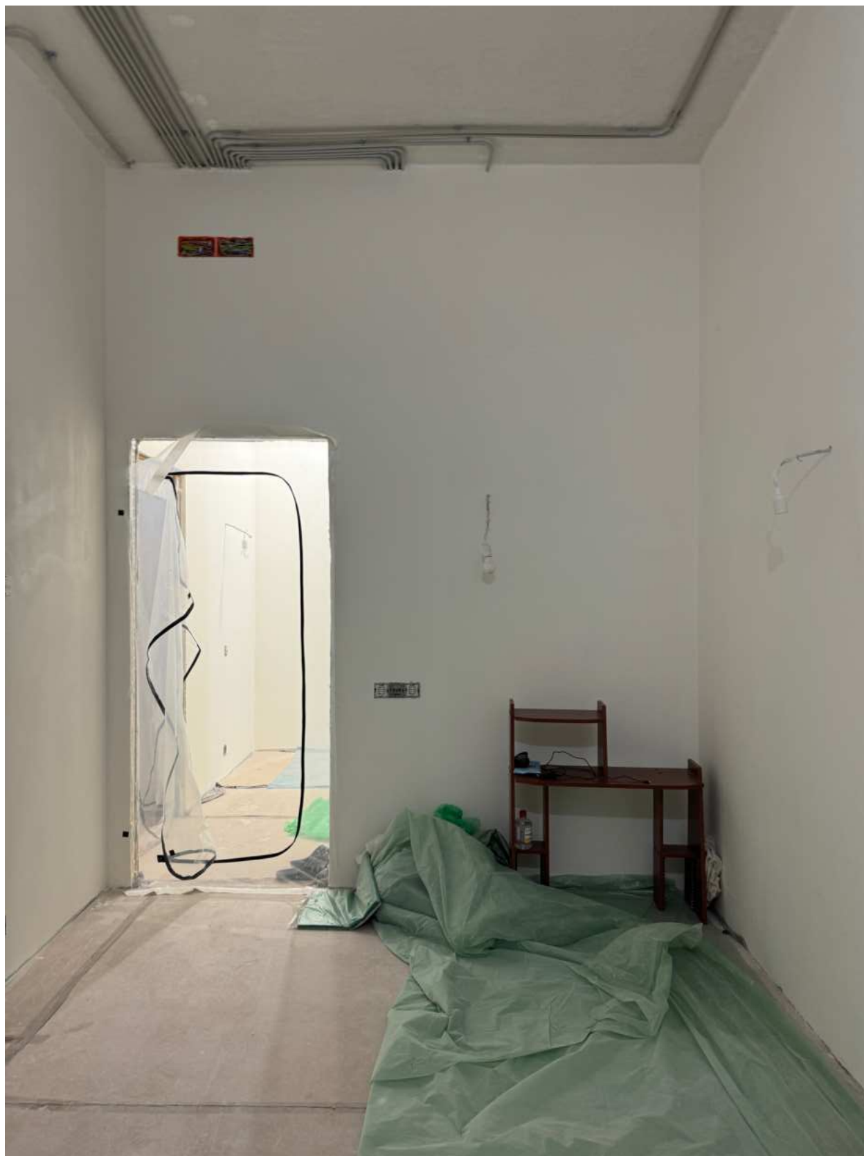
Фото 43. Вид на помещение квартиры № 39 объекта культурного наследия.
