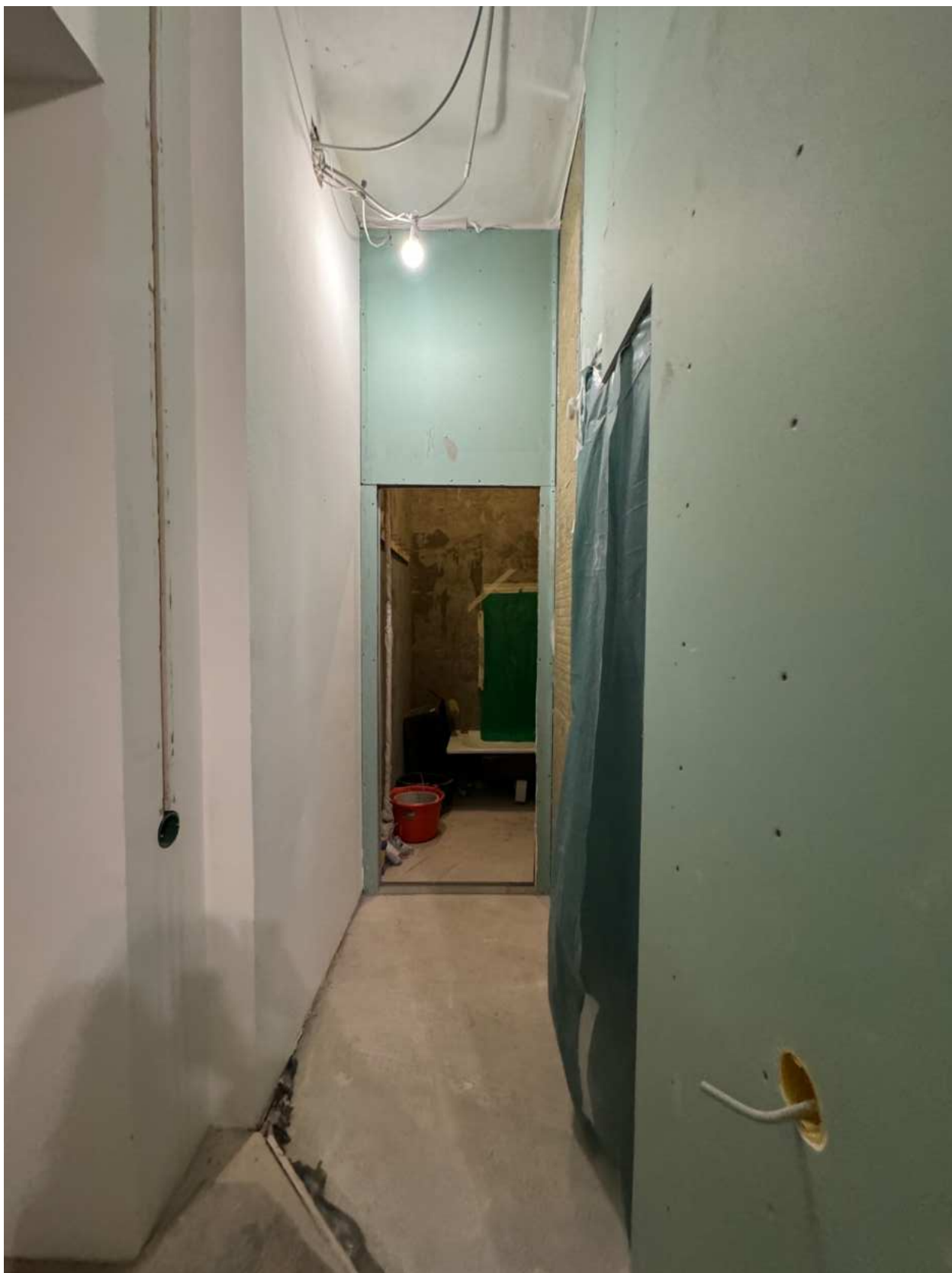
Фото 22. Вид на помещение квартиры № 39 объекта культурного наследия.
