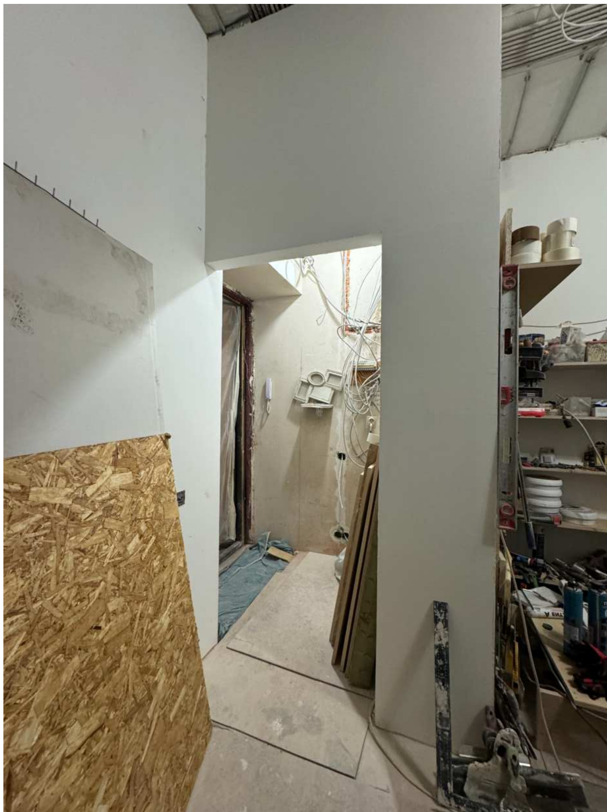
Фото 18. Вид на помещение квартиры № 39 объекта культурного наследия.
