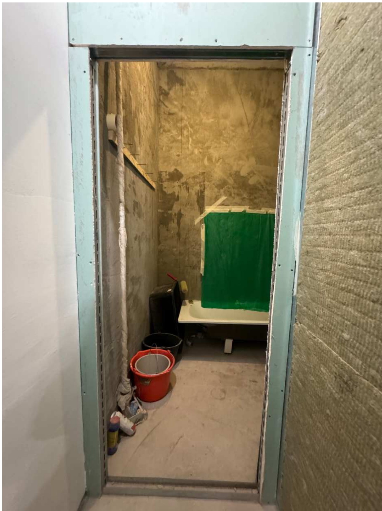
Фото 24. Вид на помещение квартиры № 39 объекта культурного наследия.
