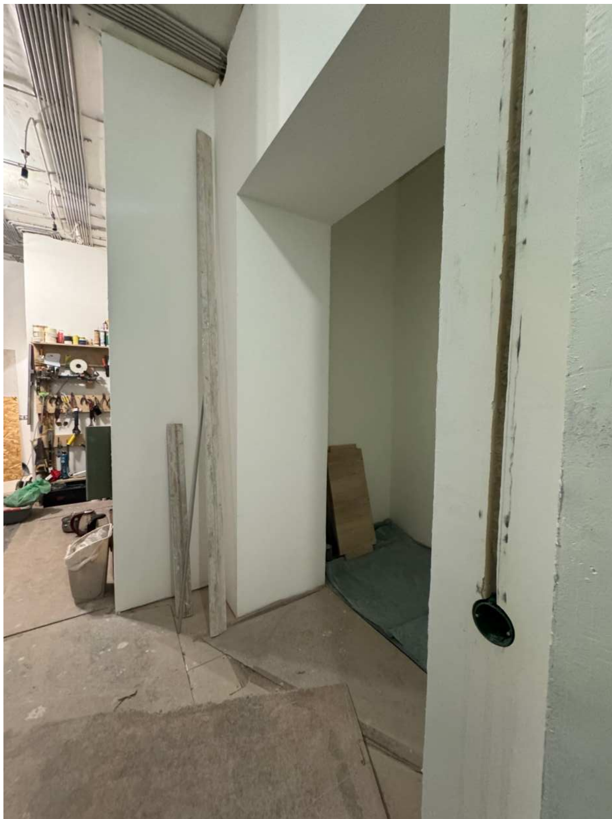
Фото 27. Вид на помещение квартиры № 39 объекта культурного наследия.
