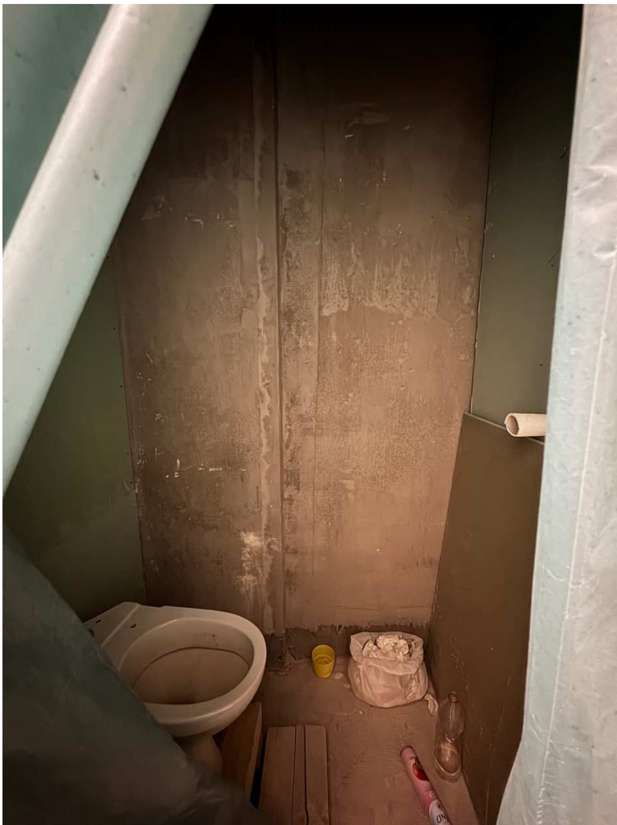
Фото 23. Вид на помещение квартиры № 39 объекта культурного наследия.
