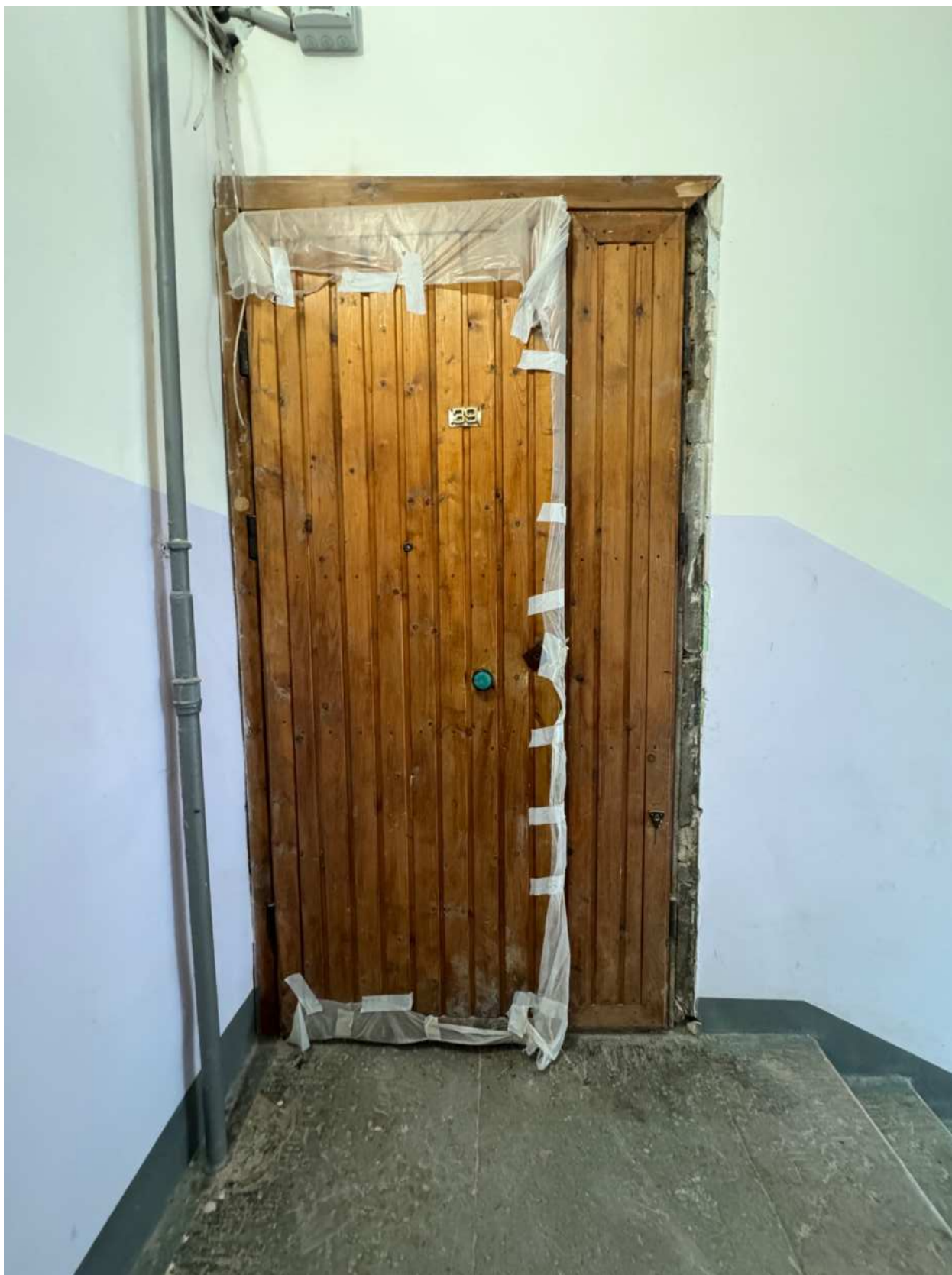
Фото 15. Дверное заполнение квартиры № 39 объекта культурного наследия.
