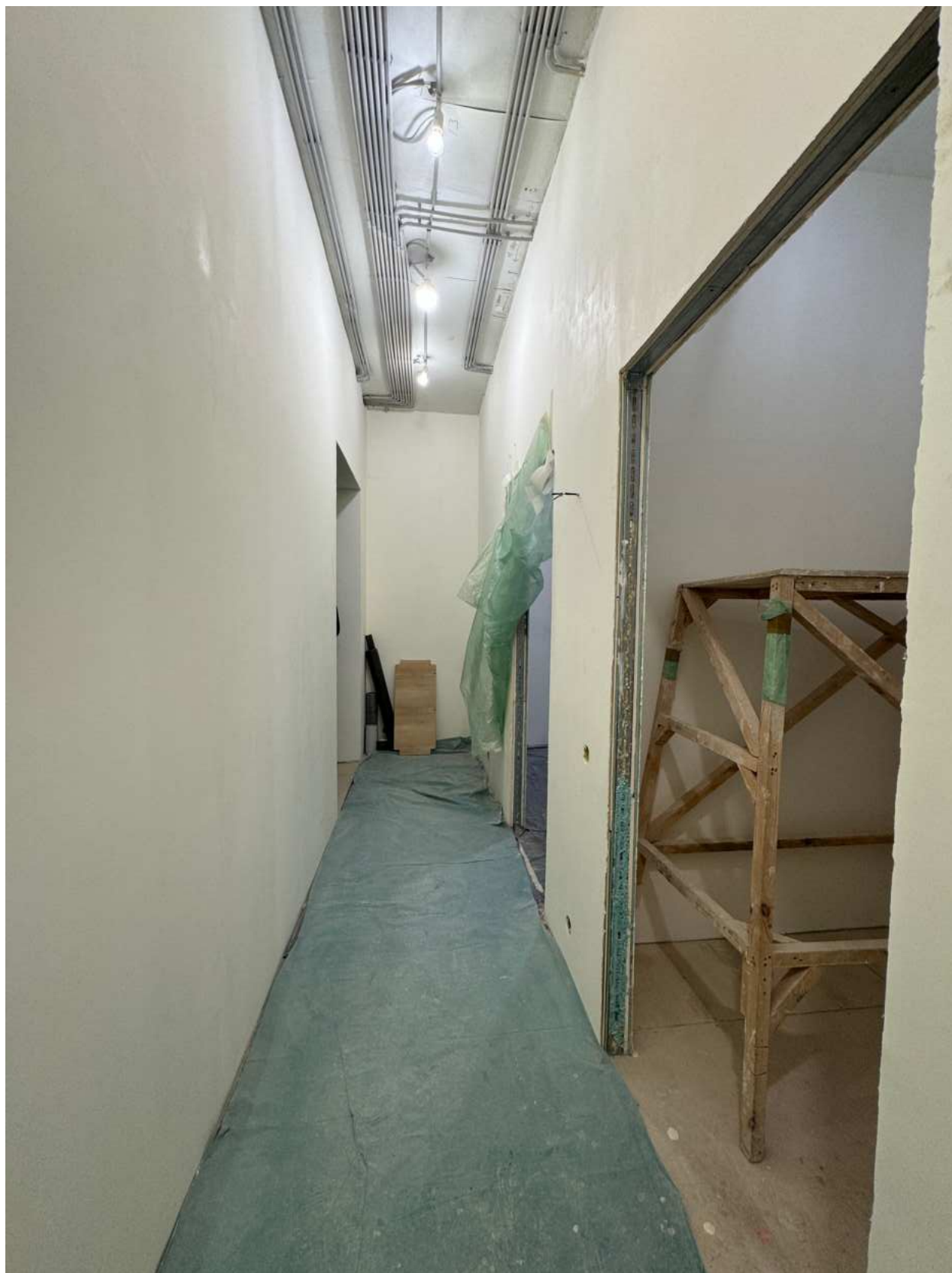
Фото 45. Вид на помещение квартиры № 39 объекта культурного наследия.
