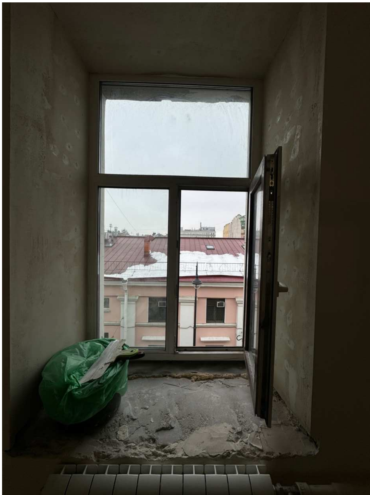
Фото 31. Вид на оконное заполнение квартиры № 39 объекта культурного наследия.
