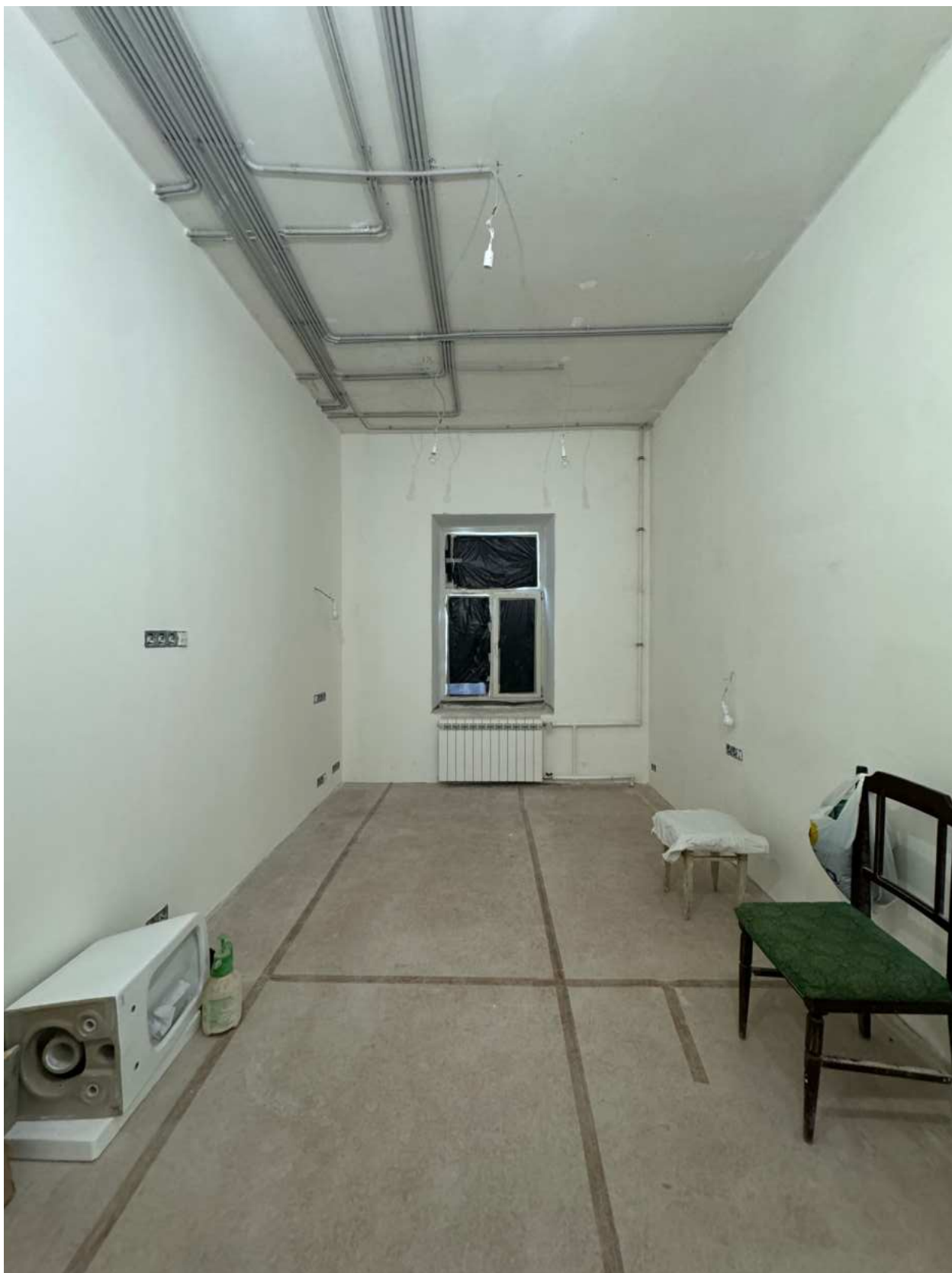
Фото 37. Вид на помещение квартиры № 39 объекта культурного наследия.
