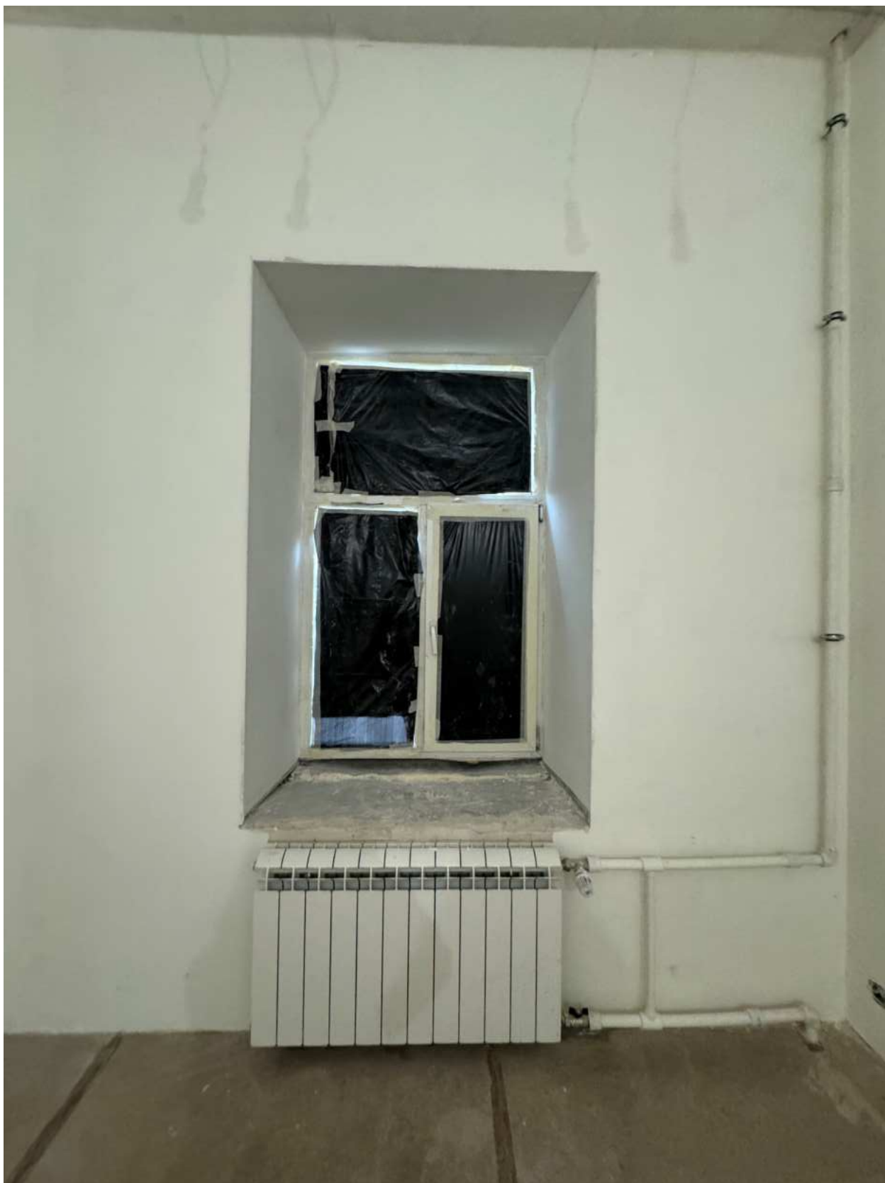
Фото 38. Вид на оконное заполнение квартиры № 39 объекта культурного наследия.
