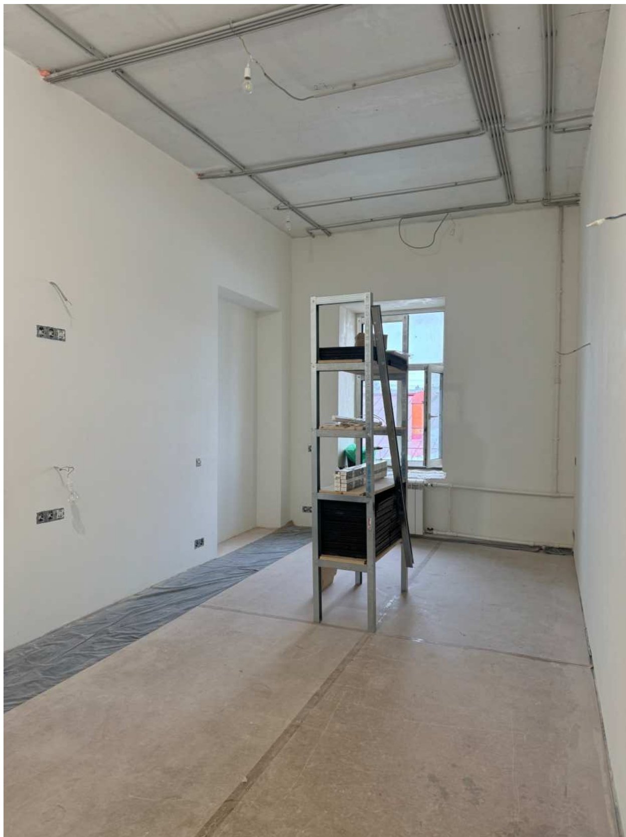
Фото 30. Вид на помещение квартиры № 39 объекта культурного наследия.
