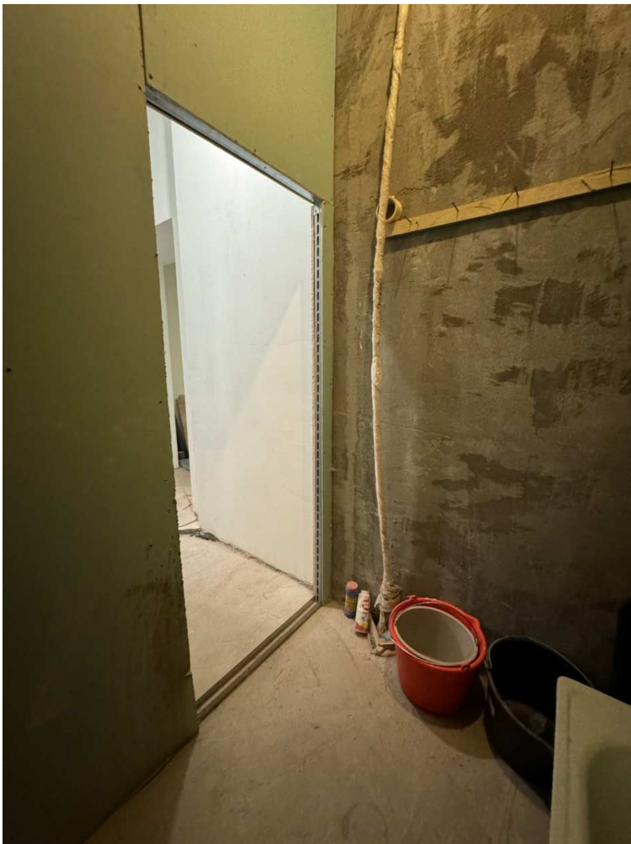
Фото 25. Вид на помещение квартиры № 39 объекта культурного наследия.
