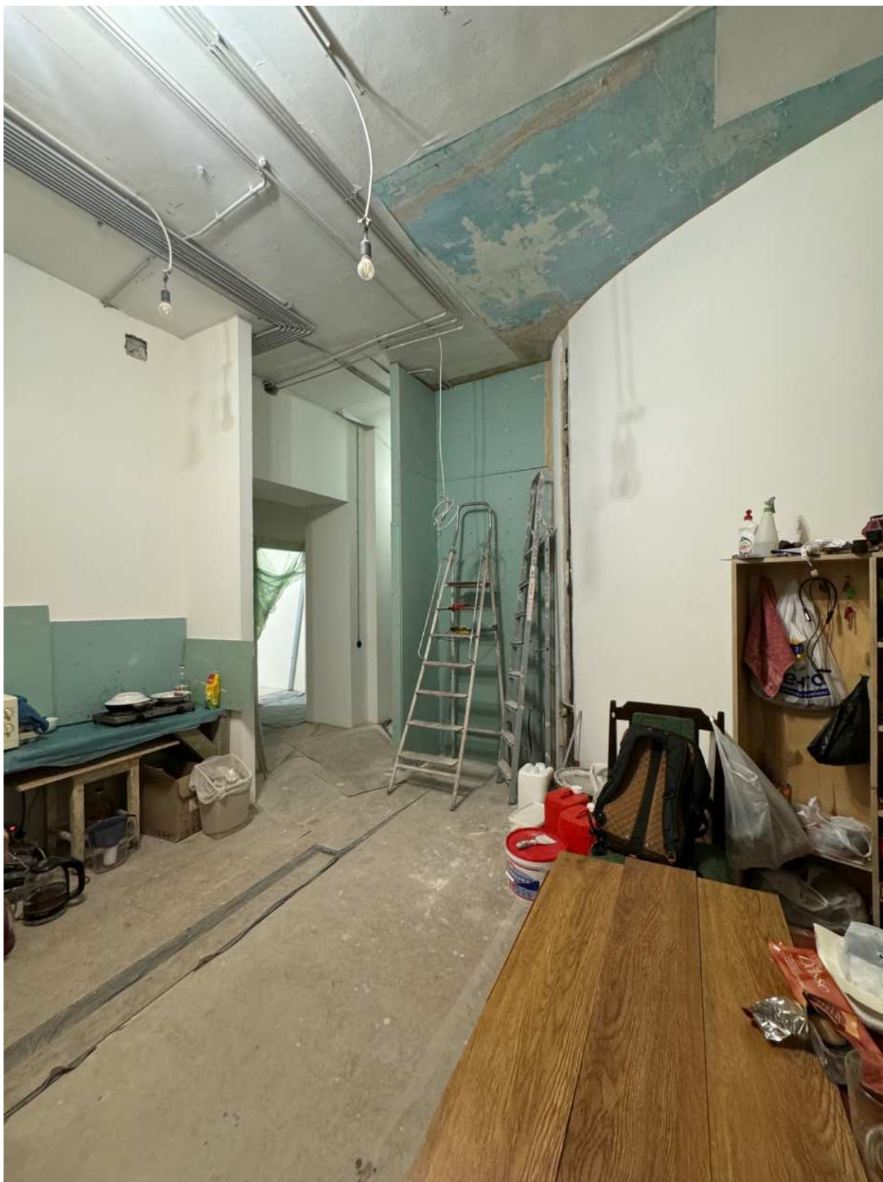
Фото 17. Вид на помещение квартиры № 39 объекта культурного наследия.
