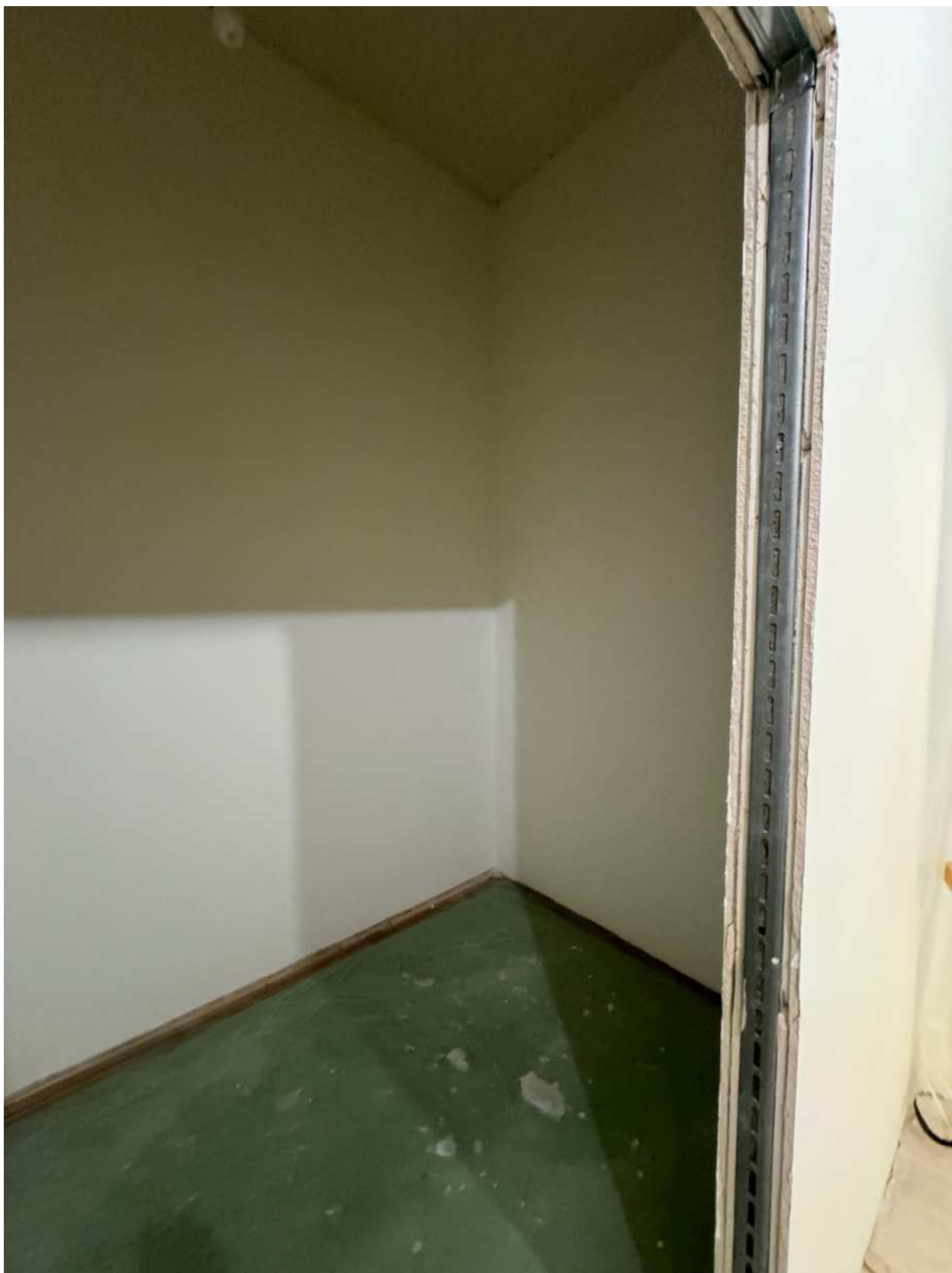
Фото 41. Вид на помещение квартиры № 39 объекта культурного наследия.
