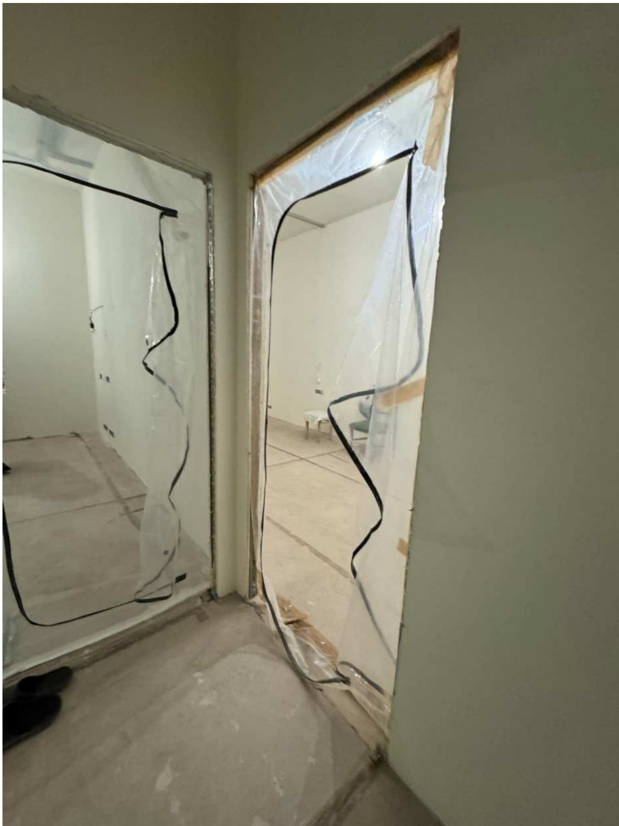
Фото 36. Вид на помещение квартиры № 39 объекта культурного наследия.
