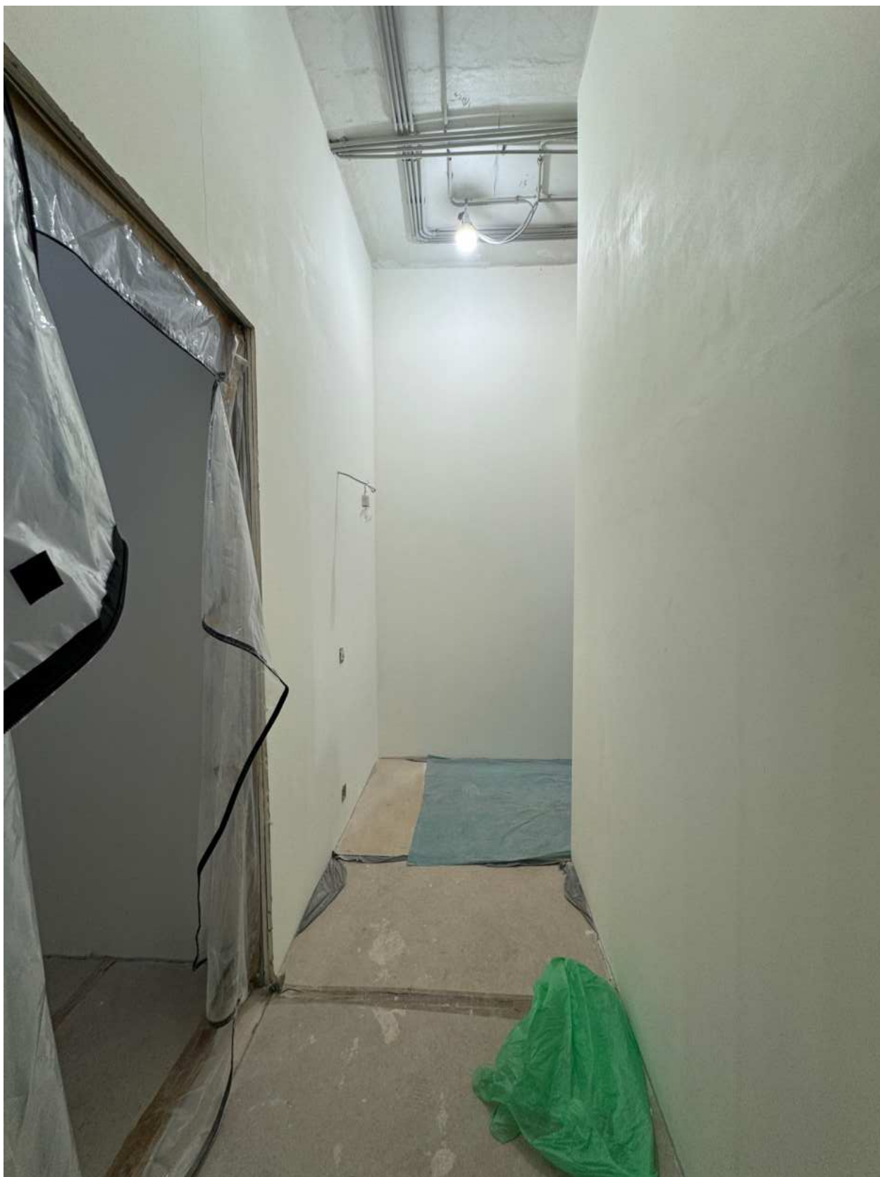
Фото 44. Вид на помещение квартиры № 39 объекта культурного наследия.
