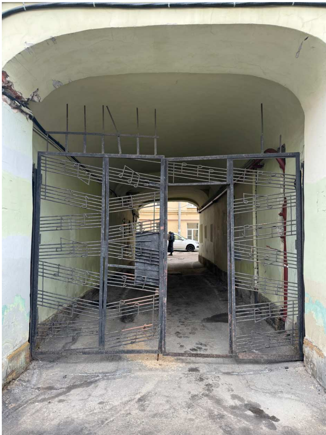
Фото 8. Вид на арку проезда объекта культурного наследия.
