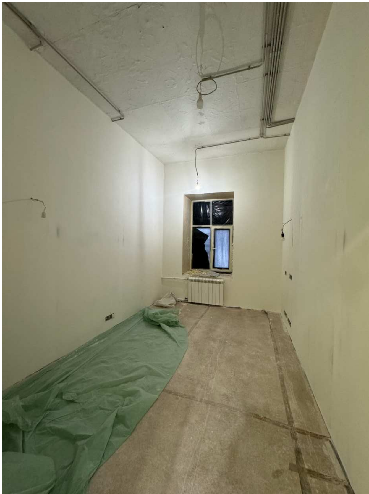
Фото 42. Вид на помещение квартиры № 39 объекта культурного наследия.
