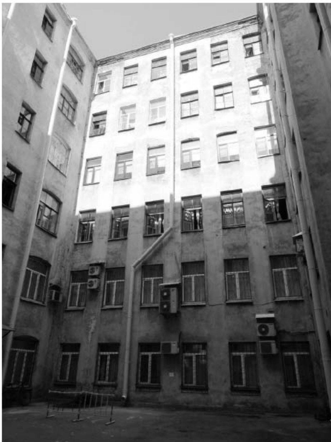
25. 12-я линия В.О., 15, лит. А. Доходный дом Н.В. Смирнова, входящий в состав ОКН «Доходный дом и особняк Н.В. Смирнова». Северо-восточный фасад западного двора.
