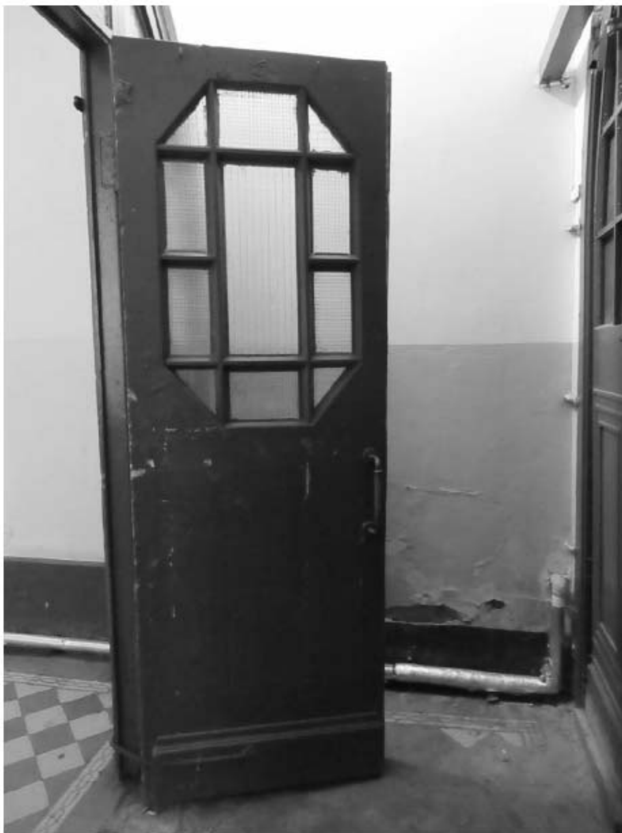
32. 12-я линия В.О., 15, лит. А. Доходный дом Н.В. Смирнова, входящий в состав ОКН «Доходный дом и особняк Н.В. Смирнова». Парадная лестница (4ЛК). Створка внутренней двери тамбура.
