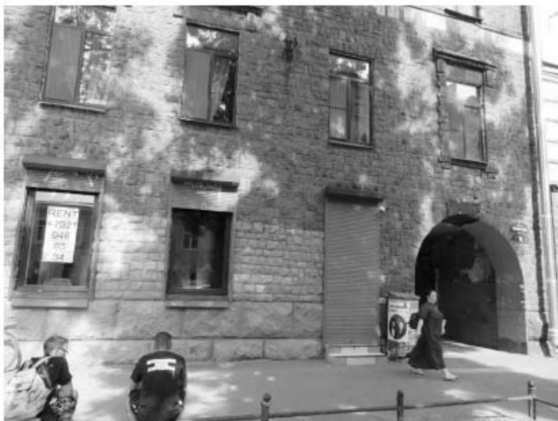
6. 12-я линия В.О., 15, лит. А. Доходный дом Н.В. Смирнова, входящий в состав ОКН «Доходный дом и особняк Н.В. Смирнова». Вид на южную часть лицевого фасада в уровне 1-2 этажей.
