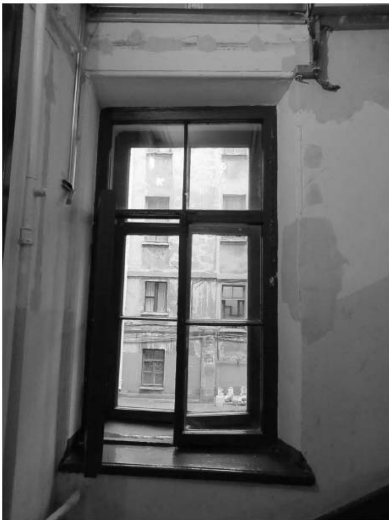
41. 12-я линия В.О., 15, лит. А. Доходный дом Н.В. Смирнова, входящий в состав ОКН «Доходный дом и особняк Н.В. Смирнова». Парадная лестница (4ЛК). Оконный проем с историческим заполнением, выходящий во внутренний двор.
