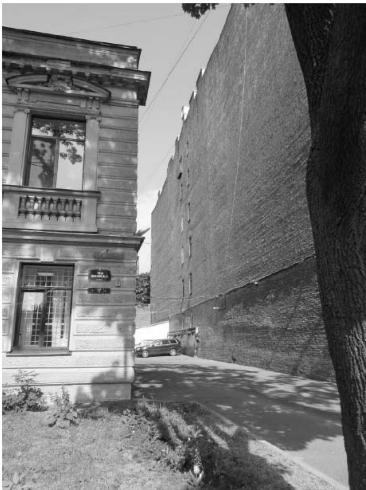
17. 12-я линия В.О., 15, лит. А. Доходный дом Н.В. Смирнова, входящий в состав ОКН «Доходный дом и особняк Н.В. Смирнова». Северо-западный брандмауэрный фасад, вид со стороны 12 линии.
