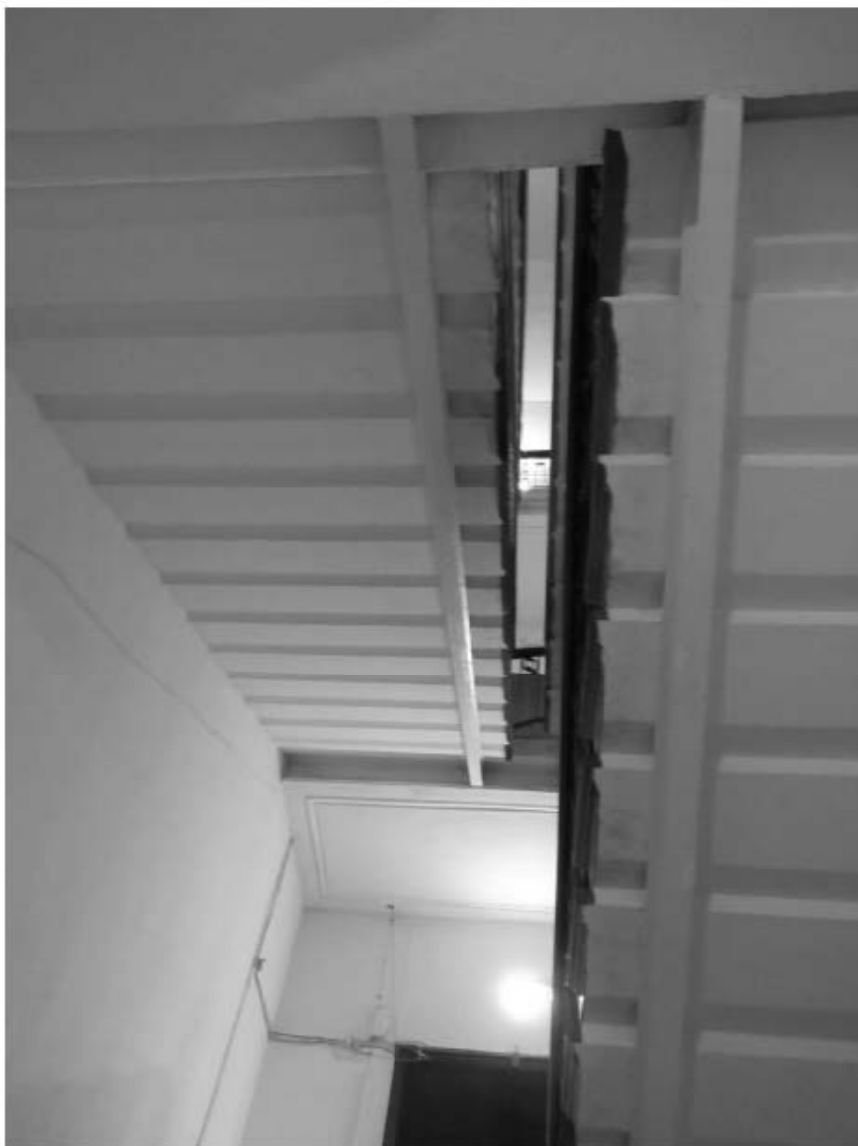
42. 12-я линия В.О., 15, лит. А. Доходный дом Н.В. Смирнова, входящий в состав ОКН «Доходный дом и особняк Н.В. Смирнова». Парадная лестница (4ЛК). Вид снизу на лестничные марши.
