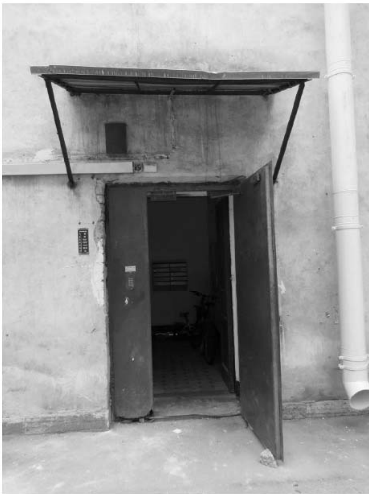
29. 12-я линия В.О., 15, лит. А. Доходный дом Н.В. Смирнова, входящий в состав ОКН «Доходный дом и особняк Н.В. Смирнова». Вход на лестницу ЗЛК.
