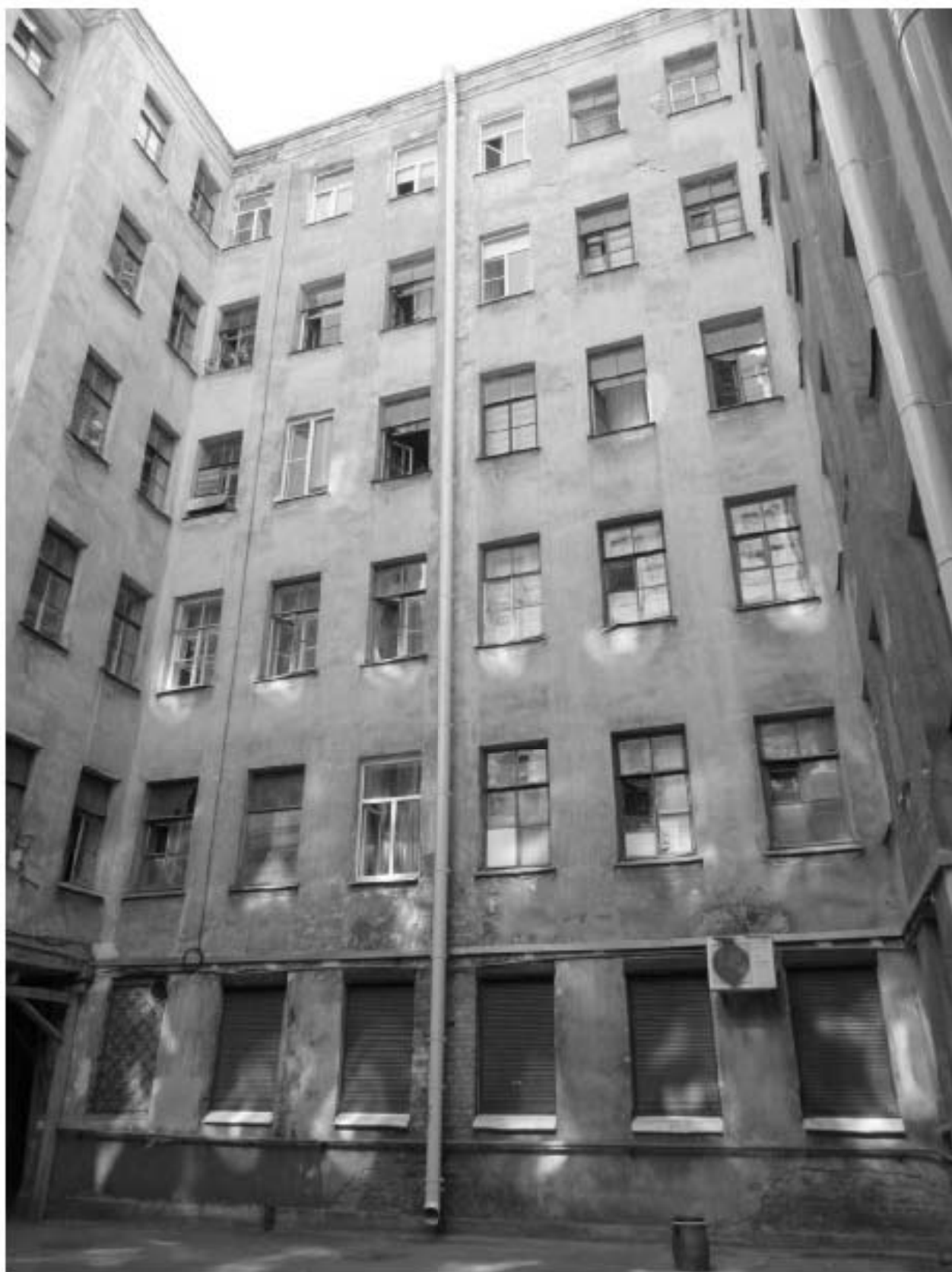
22. 12-я линия В.О., 15, лит. А. Доходный дом Н.В. Смирнова, входящий в состав ОКН «Доходный дом и особняк Н.В. Смирнова». Юго-западный фасад восточного двора.
