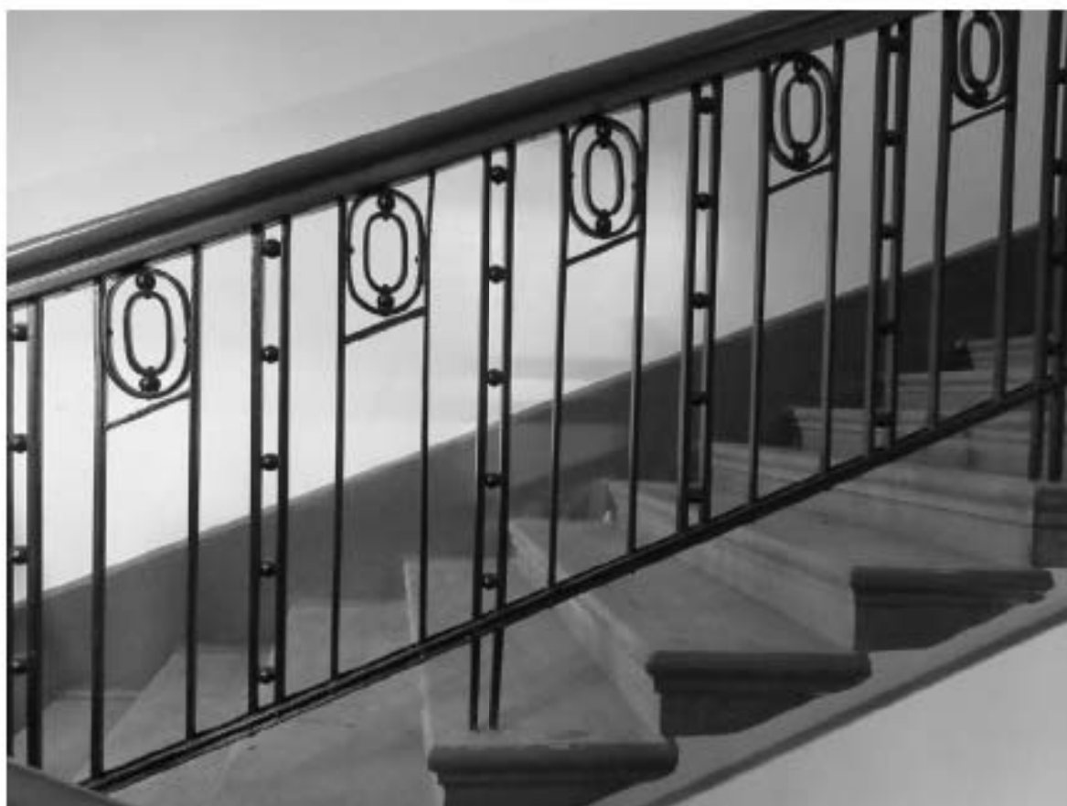
40. 12-я линия В.О., 15, лит. А. Доходный дом Н.В. Смирнова, входящий в состав ОКН «Доходный дом и особняк Н.В. Смирнова». Парадная лестница (4ЛК). Историческое металлическое лестничное ограждение с деревянными перилами.
