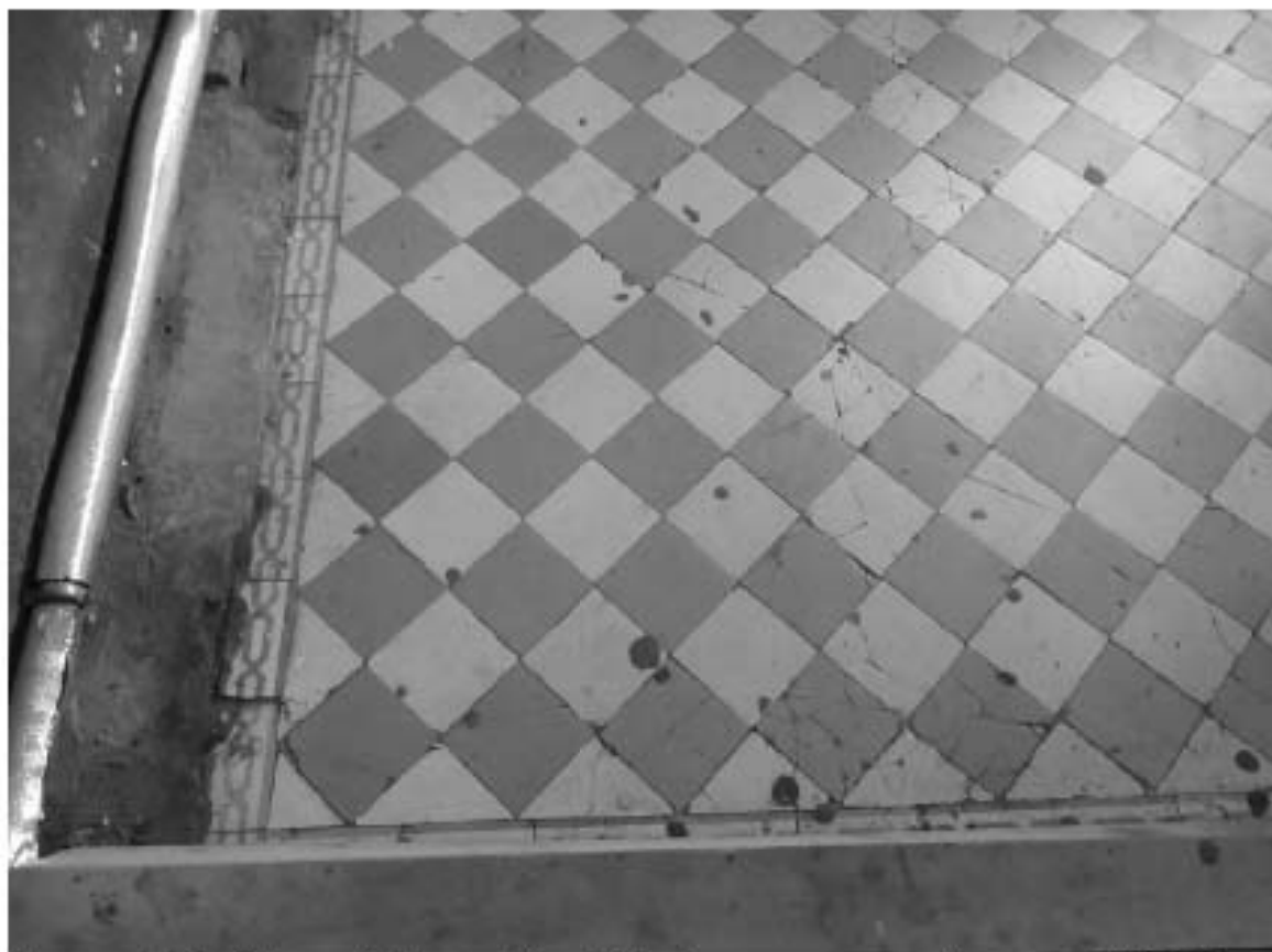
37. 12-я линия В.О., 15, лит. А. Доходный дом Н.В. Смирнова, входящий в состав ОКН «Доходный дом и особняк Н.В. Смирнова». Парадная лестница (4ЛК).
