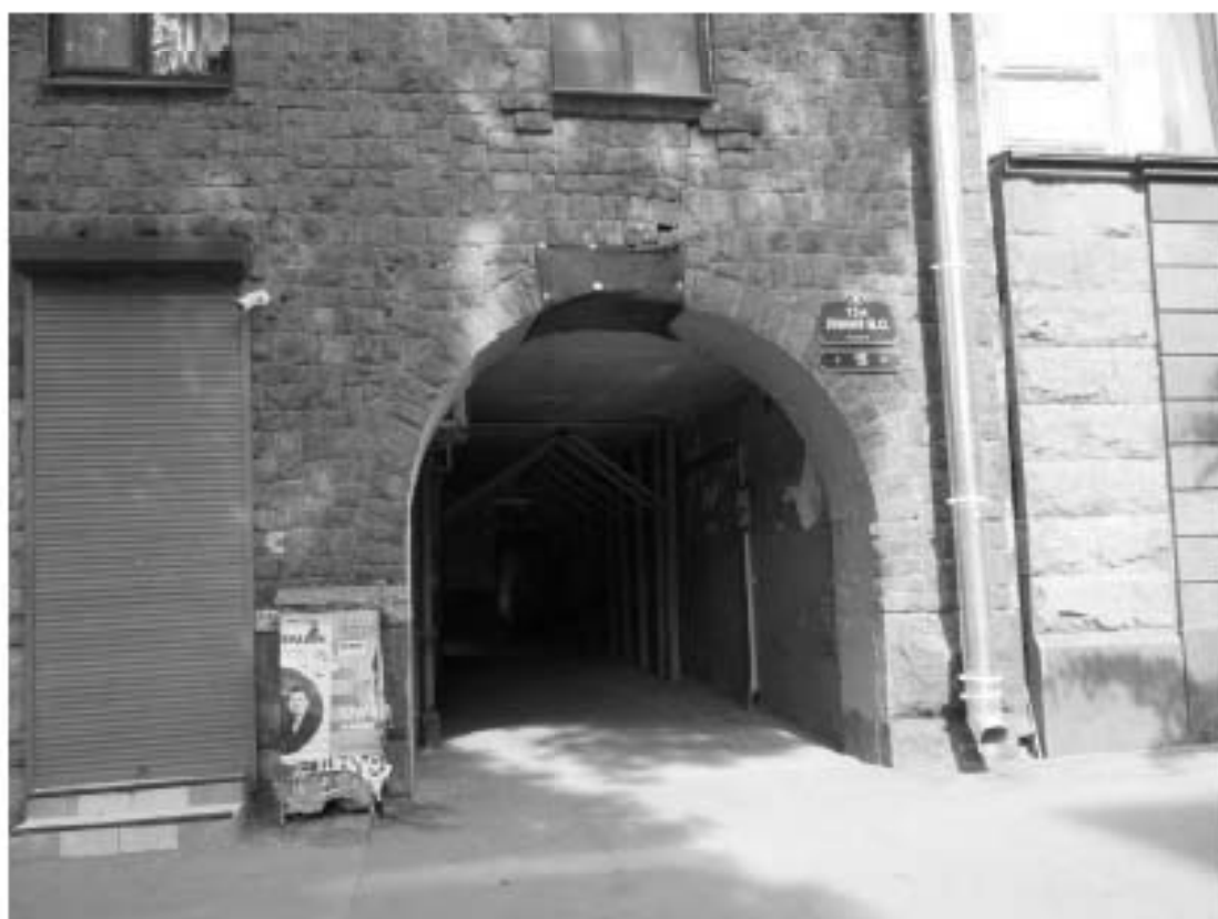
7. 12-я линия В.О., 15, лит. А. Доходный дом Н.В. Смирнова, входящий в состав ОКН «Доходный дом и особняк Н.В. Смирнова». Лицевой фасад, дворовый проезд.
