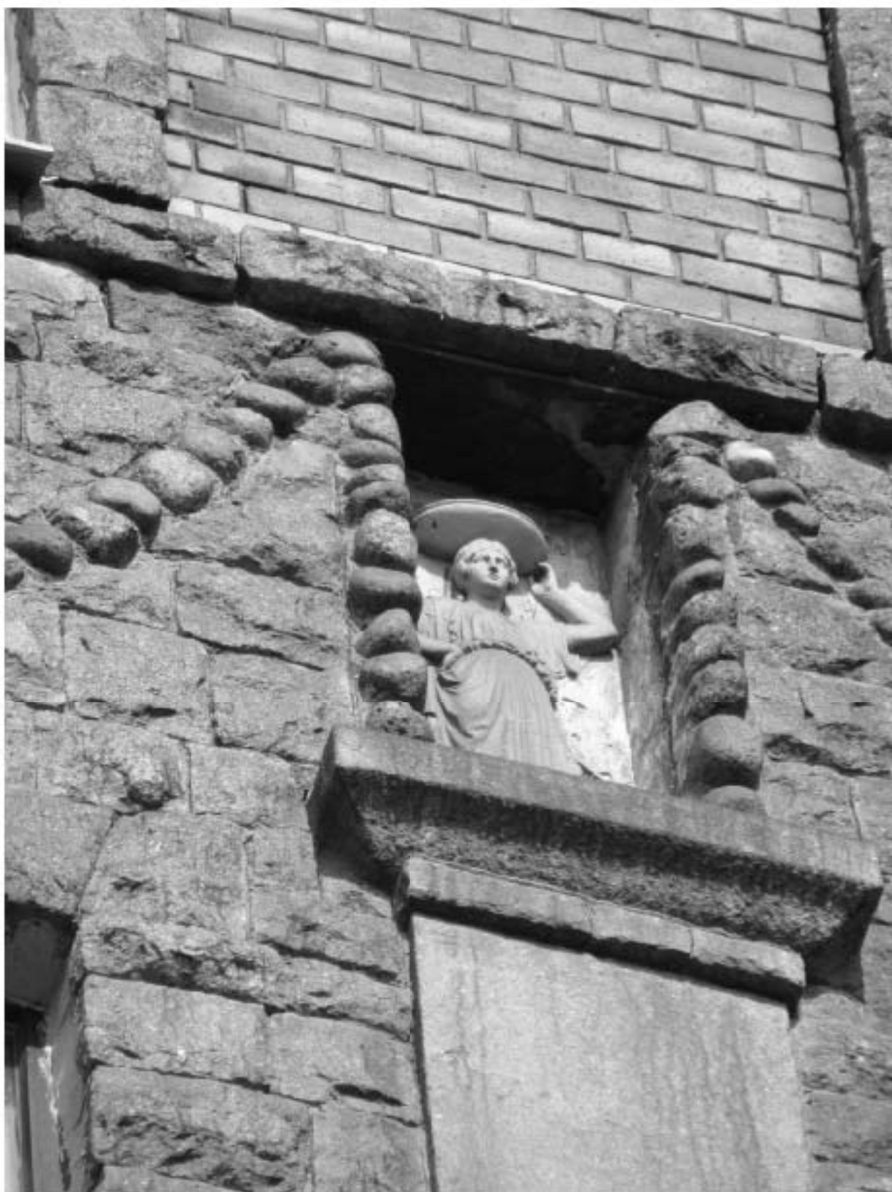
13. 12-я линия В.О., 15, лит. А. Доходный дом Н.В. Смирнова, входящий в состав ОКН «Доходный дом и особняк Н.В. Смирнова». Скульптура в нише над пилястром в центральной части лицевого фасада.
