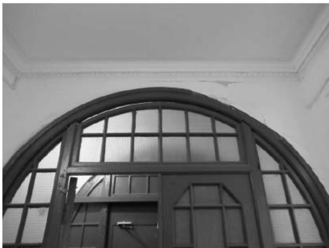
31. 12-я линия В.О., 15, лит. А. Доходный дом Н.В. Смирнова, входящий в состав ОКН «Доходный дом и особняк Н.В. Смирнова». Парадная лестница (4ЛК). Верхняя фрамуга внутренней двери тамбура.
