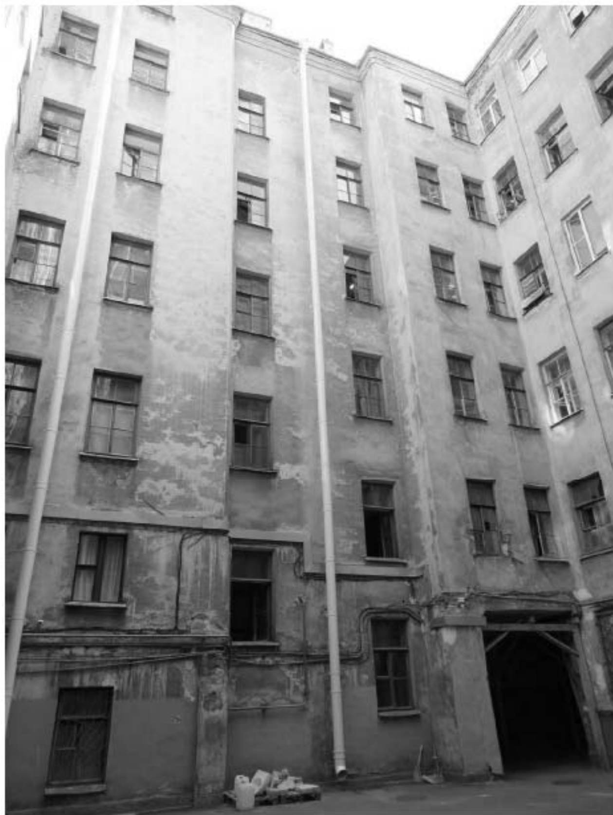
23. 12-я линия В.О., 15, лит. А. Доходный дом Н.В. Смирнова, входящий в состав ОКН «Доходный дом и особняк Н.В. Смирнова». Юго-восточный фасад восточного двора.
