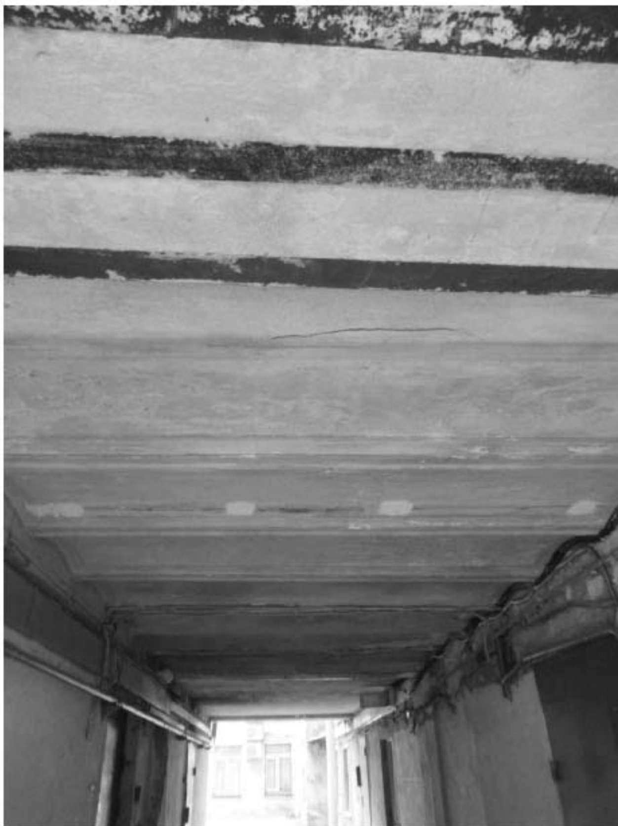
24. 12-я линия В.О., 15, лит. А. Доходный дом Н.В. Смирнова, входящий в состав ОКН «Доходный дом и особняк Н.В. Смирнова». Потолок с прусскими сводками проезда в западный двор.
