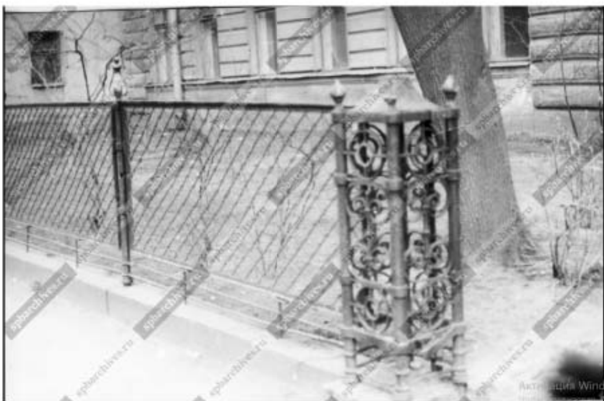
37. Вид части ограды возле палисадника дома № 17 по 12-й линии Васильевского острова (военный инженер Н.В.Смирнов, 1890-е годы). ЦГАКФФД СПб. Ар.225813. Фото 9 мая 1991.
