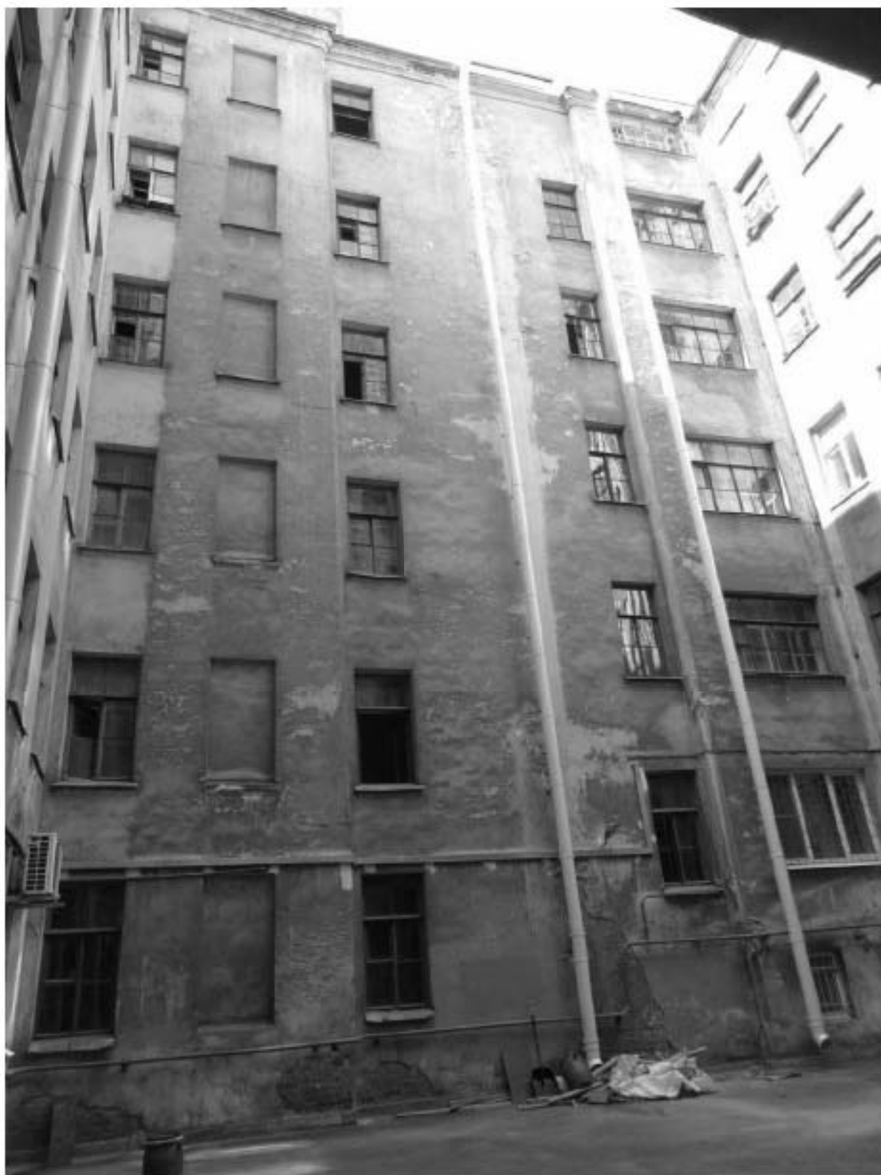
20. 12-я линия В.О., 15, лит. А. Доходный дом Н.В. Смирнова, входящий в состав ОКН «Доходный дом и особняк Н.В. Смирнова». Северо-западный фасад восточного двора.
