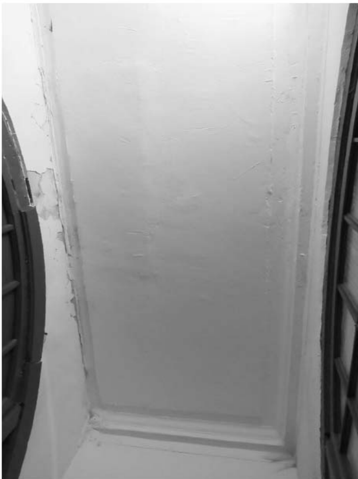
33. 12-я линия В.О., 15, лит. А. Доходный дом Н.В. Смирнова, входящий в состав ОКН «Доходный дом и особняк Н.В. Смирнова». Парадная лестница (4ЛК). Потолок тамбура.
