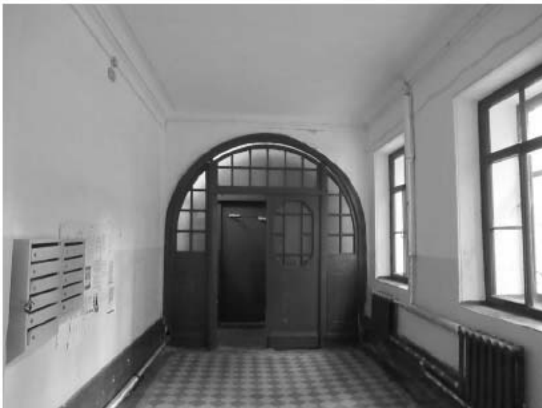
30. 12-я линия В.О., 15, лит. А. Доходный дом Н.В. Смирнова, входящий в состав ОКН «Доходный дом и особняк Н.В. Смирнова». Парадная лестница (4ЛК). Вестибюль, вид на тамбур.
