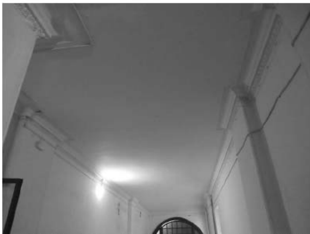
34. 12-я линия В.О., 15, лит. А. Доходный дом Н.В. Смирнова, входящий в состав ОКН «Доходный дом и особняк Н.В. Смирнова». Парадная лестница (4ЛК). Потолок вестибюля.
