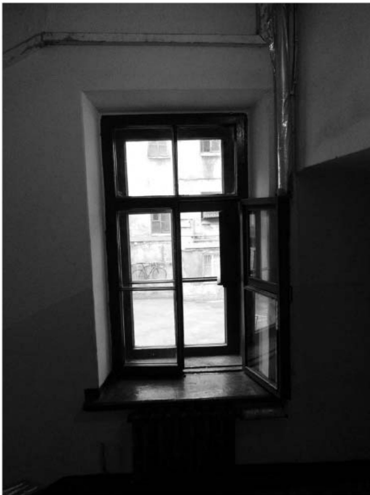
52. 12-я линия В.О., 15, лит. А. Доходный дом Н.В. Смирнова, входящий в состав ОКН «Доходный дом и особняк Н.В. Смирнова». ЗЛК, оконный проем с историческим заполнением, выходящий во внутренний двор.
