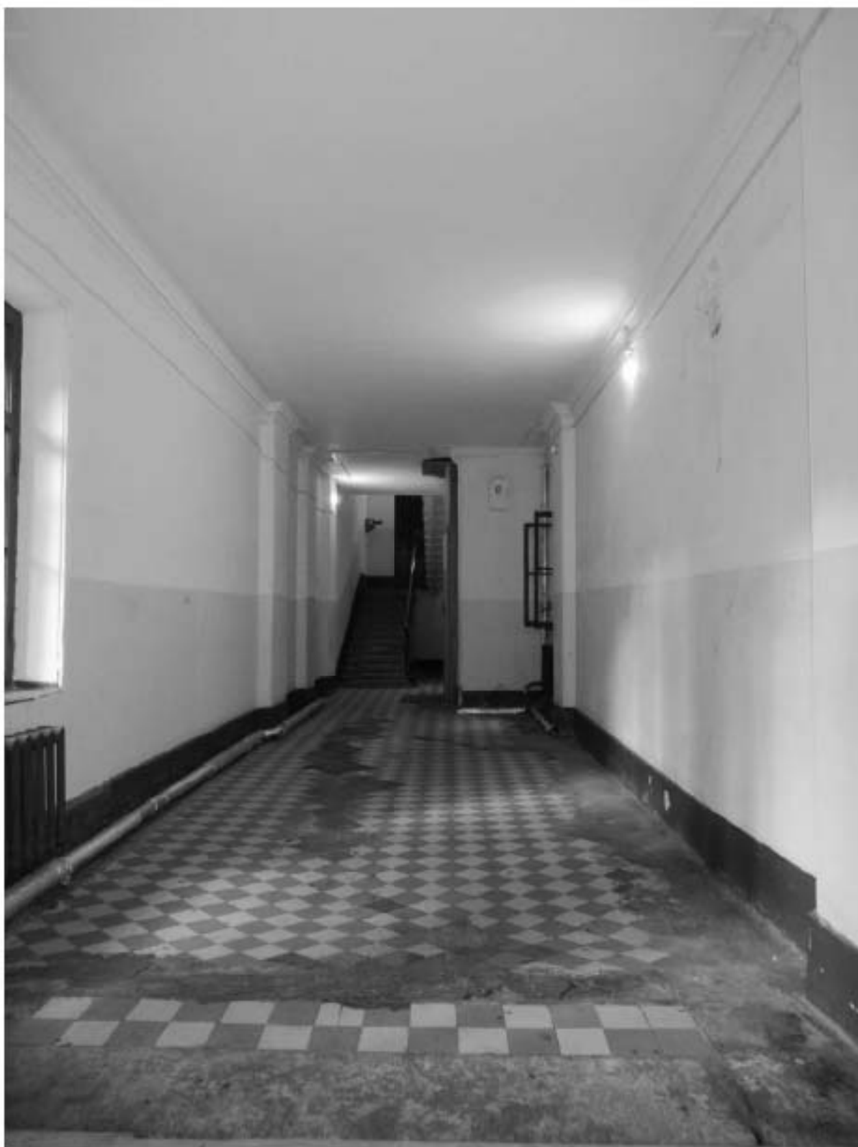
36. 12-я линия В.О., 15, лит. А. Доходный дом Н.В. Смирнова, входящий в состав ОКН «Доходный дом и особняк Н.В. Смирнова». Парадная лестница (4ЛК). Вид из вестибюля на лестницу.
