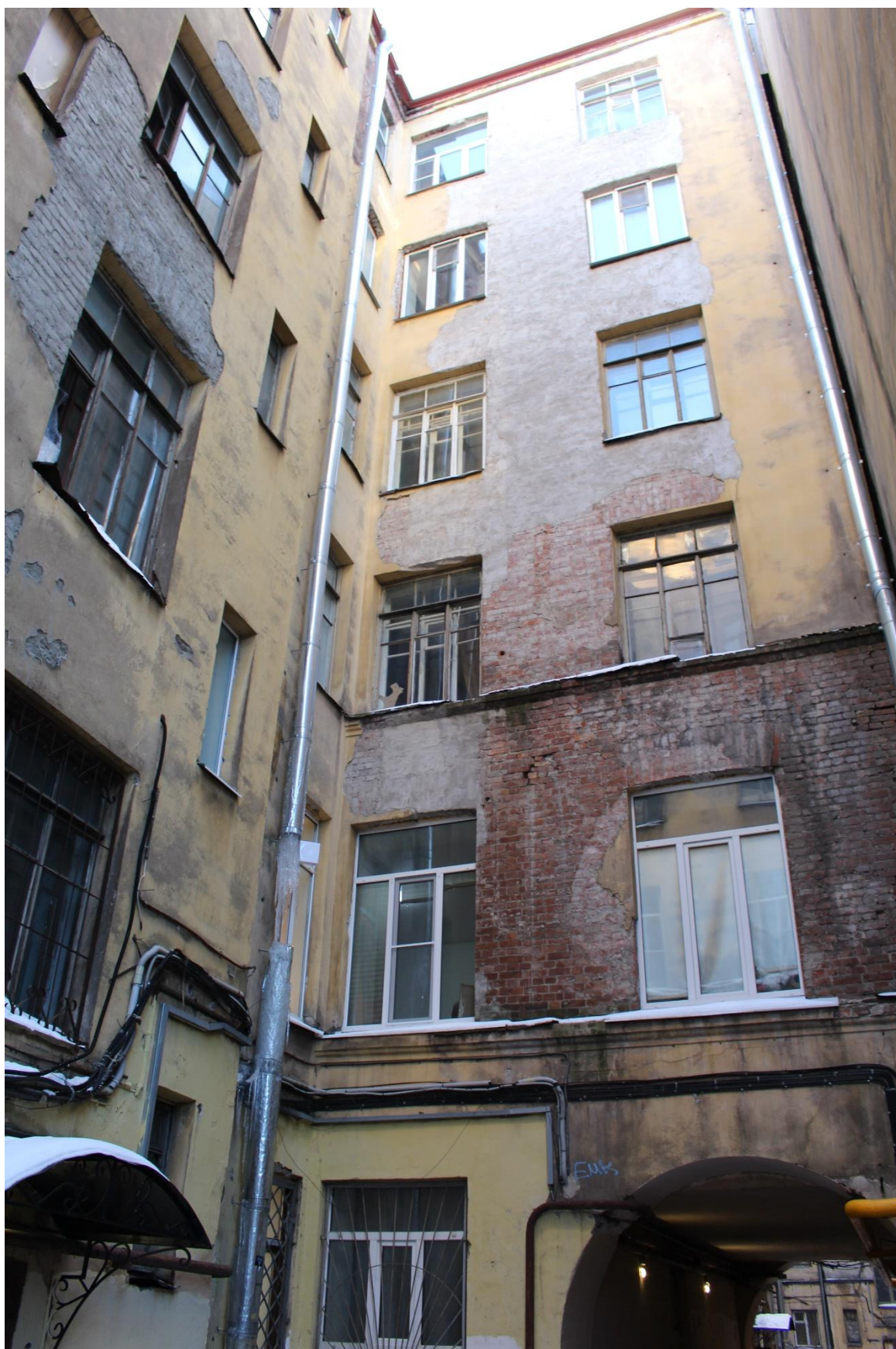
Фото 17. Вид на дворовые фасады южного корпуса объекта культурного наследия регионального значения «Дом, где в 1917 г. жил Джон Рид».
