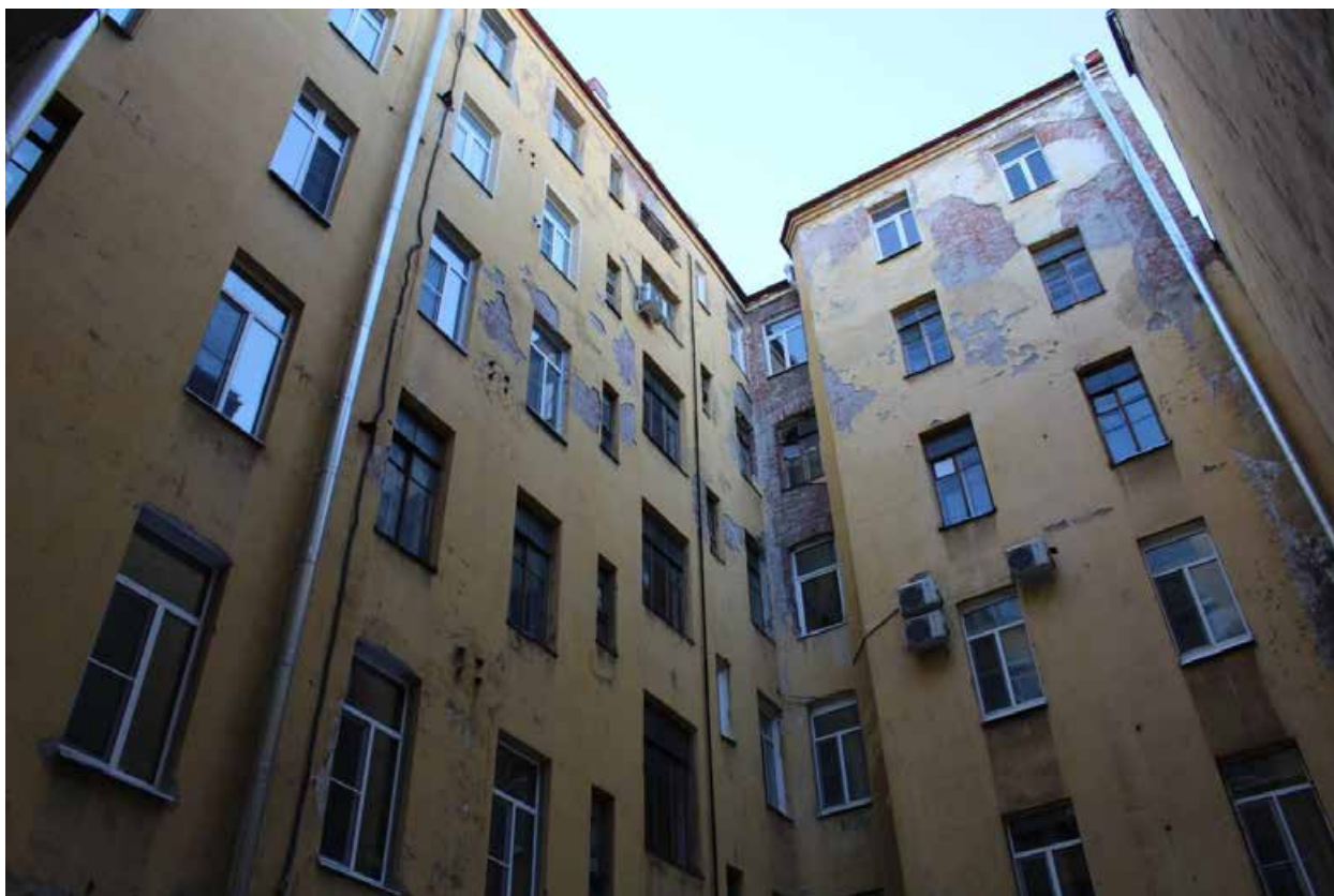
Фото 14. Вид на дворовые фасады западного корпуса объекта культурного наследия регионального значения «Дом, где в 1917 г. жил Джон Рид».
