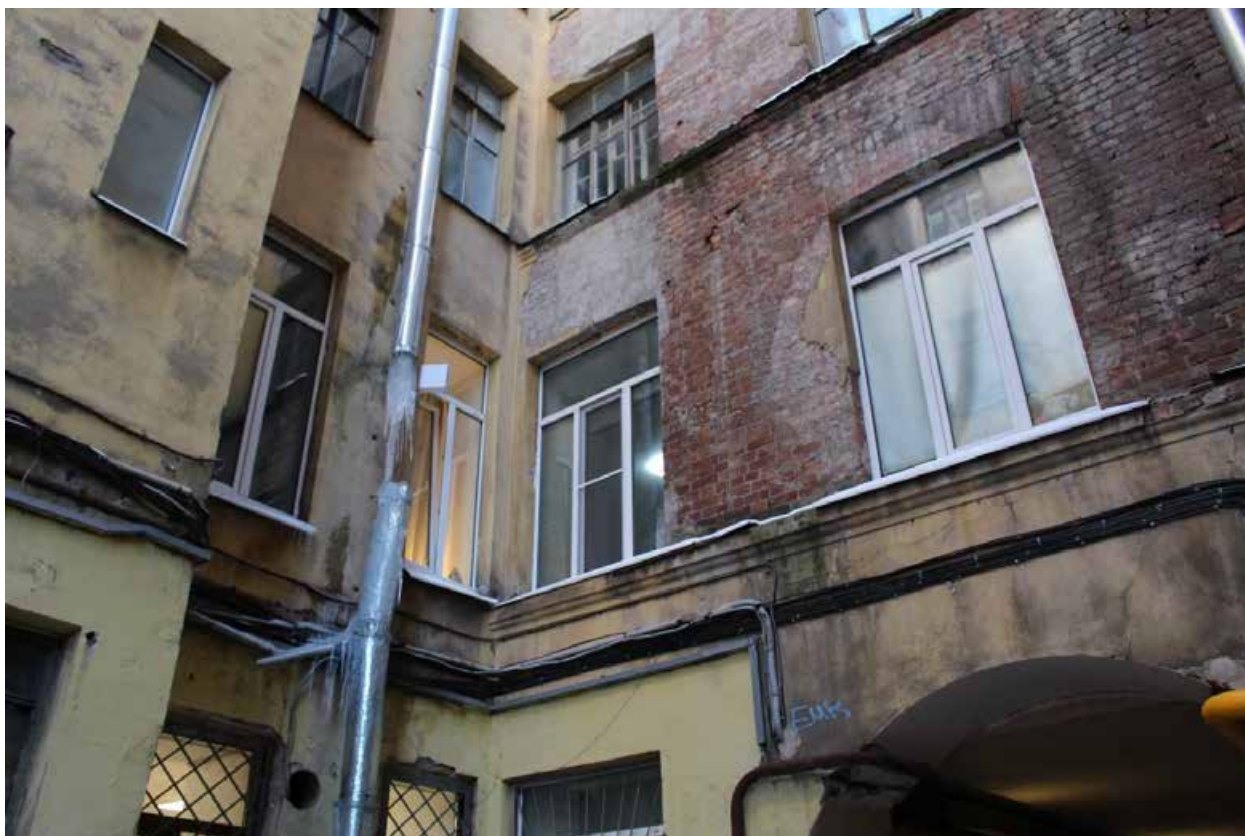
Фото 18. Вид на дворовые фасады южного корпуса объекта культурного наследия регионального значения «Дом, где в 1917 г. жил Джон Рид». Оконные проемы квартиры № 32.
