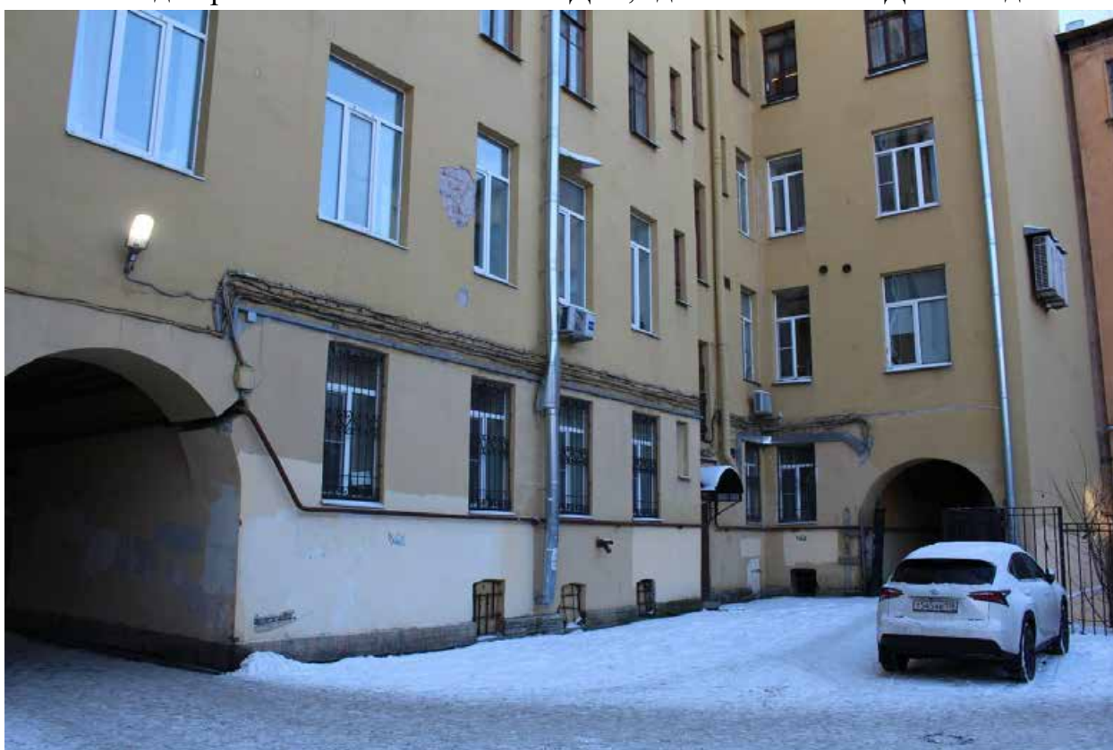
Фото 13. Вид на дворовые фасады западного корпуса объекта культурного наследия регионального значения «Дом, где в 1917 г. жил Джон Рид».
