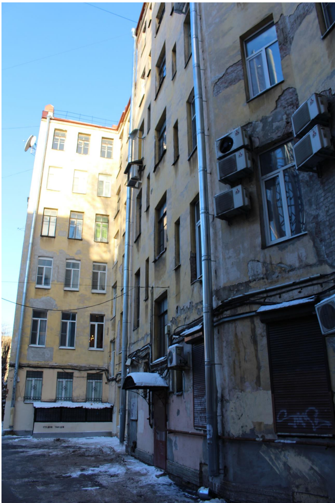
Фото 19. Вид на дворовые фасады южного корпуса объекта культурного наследия регионального значения «Дом, где в 1917 г. жил Джон Рид».
