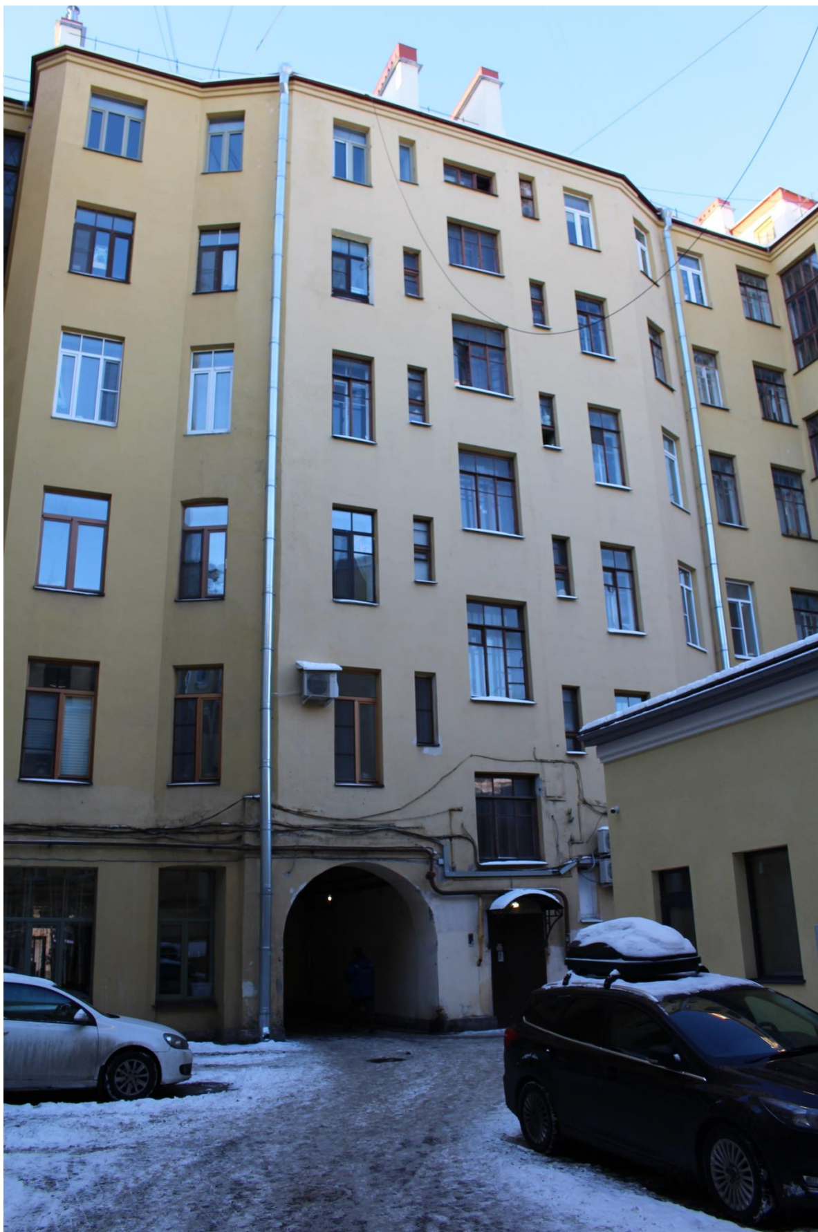
Фото 10. Вид на дворовые фасады северного корпуса объекта культурного наследия регионального значения «Дом, где в 1917 г. жил Джон Рид».
