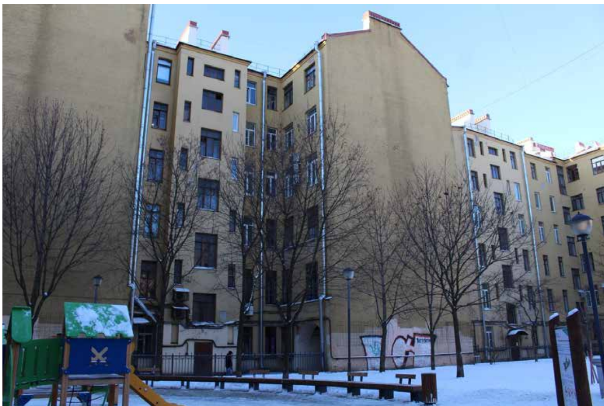
Фото 12. Вид на дворовые фасады северного корпуса объекта культурного наследия регионального значения «Дом, где в 1917 г. жил Джон Рид».
