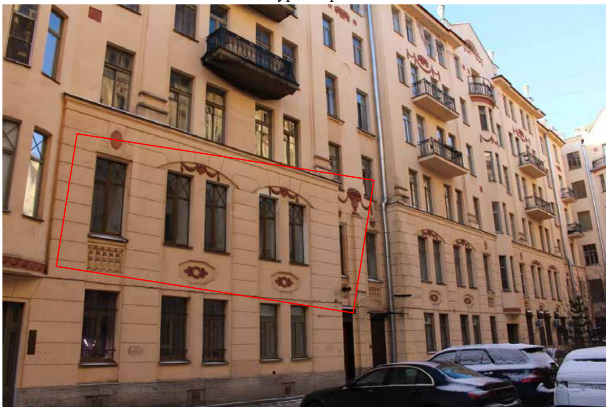
Фото 9. Вид на северный фасад южного корпуса объекта культурного наследия регионального значения «Дом, где в 1917 г. жил Джон Рид», обращенный в курдонер. Красным отмечены оконные проемы квартиры № 32.
