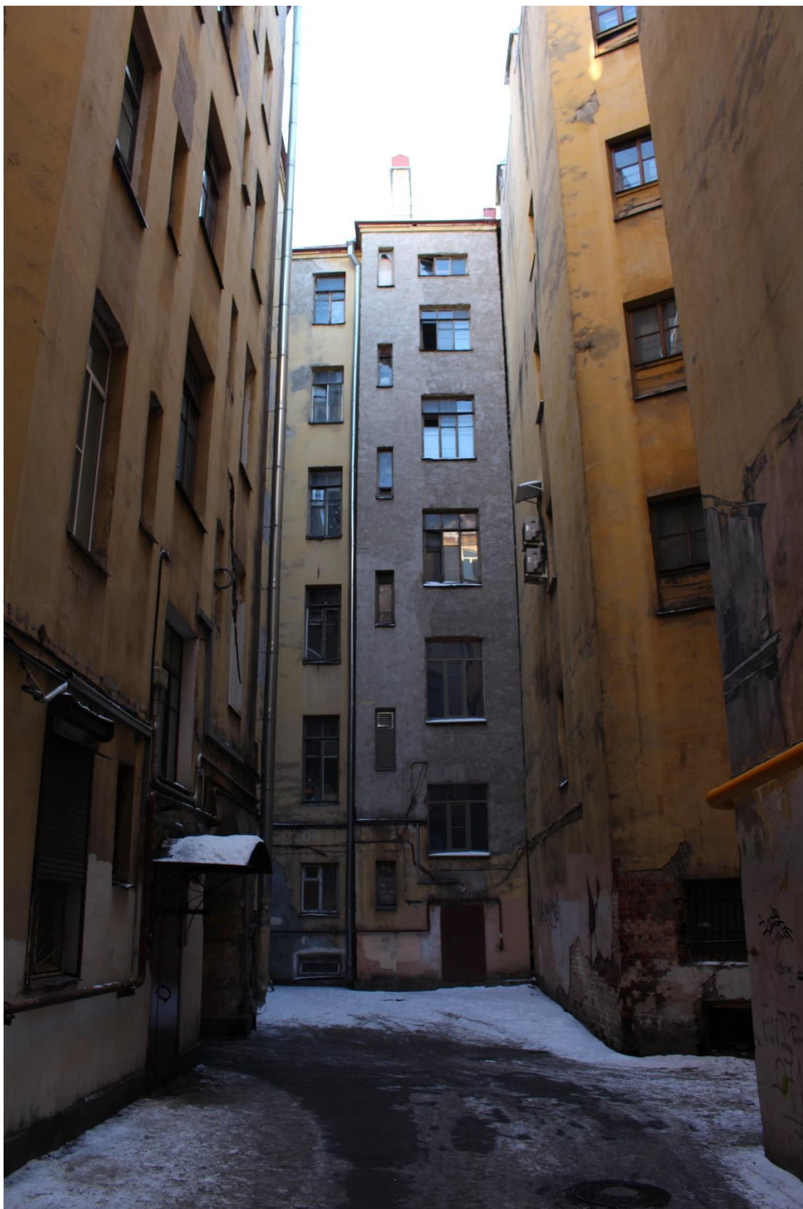
Фото 15. Вид на дворовые фасады южного корпуса объекта культурного наследия регионального значения «Дом, где в 1917 г. жил Джон Рид».
