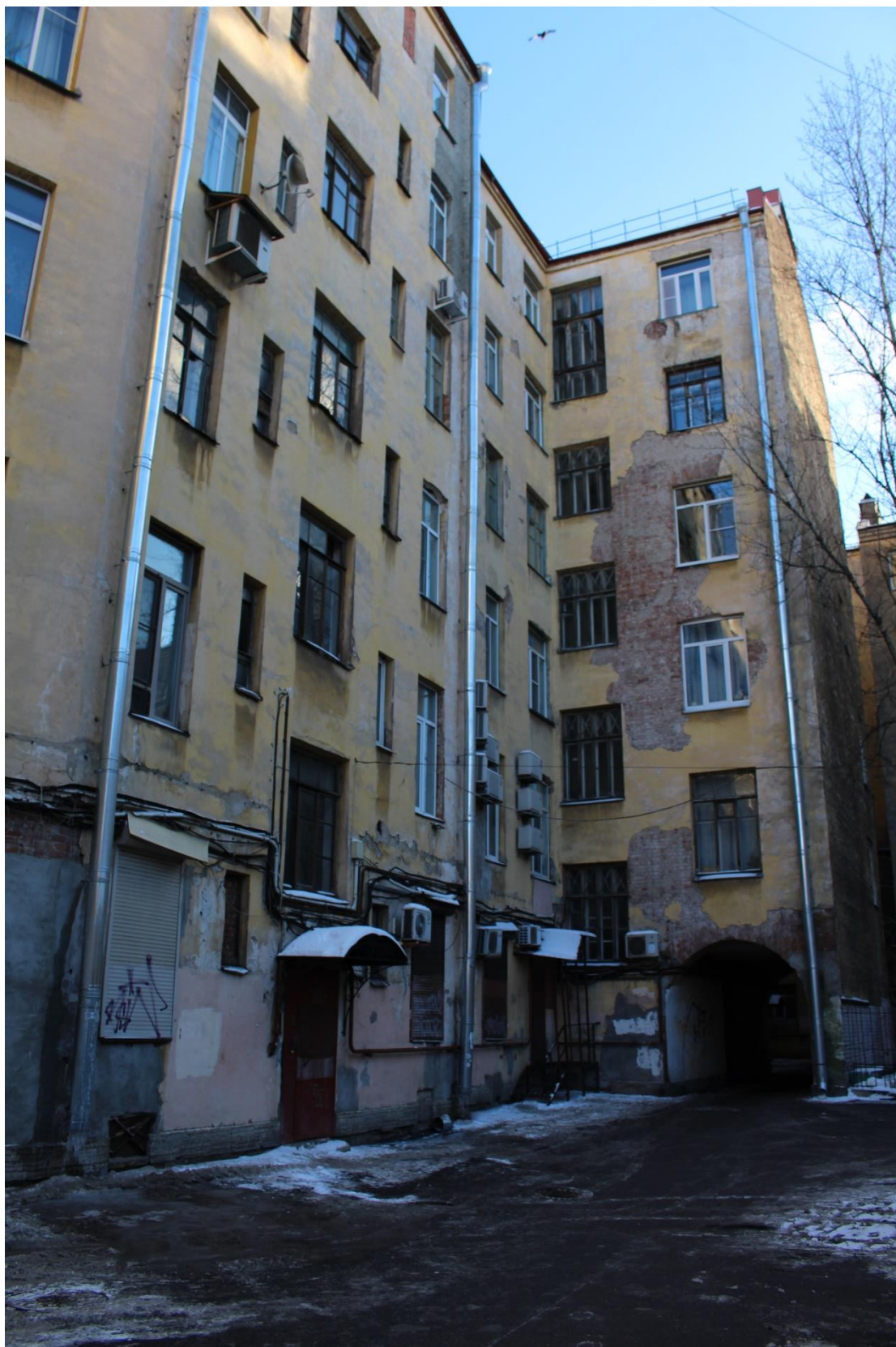
Фото 20. Вид на дворовые фасады южного корпуса объекта культурного наследия регионального значения «Дом, где в 1917 г. жил Джон Рид».
