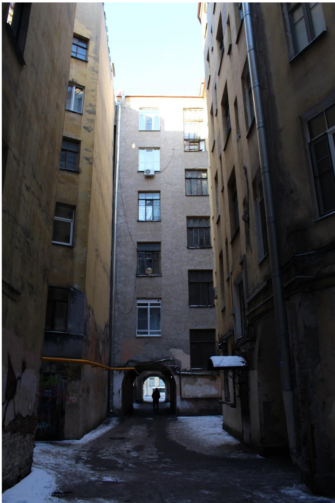
Фото 16. Вид на дворовые фасады южного корпуса объекта культурного наследия регионального значения «Дом, где в 1917 г. жил Джон Рид».
