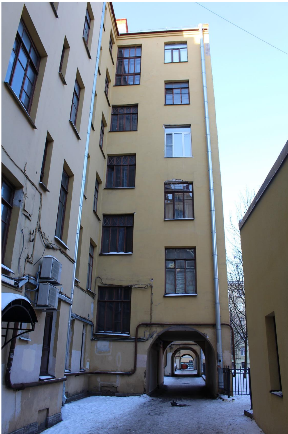
Фото 11. Вид на дворовые фасады северного корпуса объекта культурного наследия регионального значения «Дом, где в 1917 г. жил Джон Рид».
