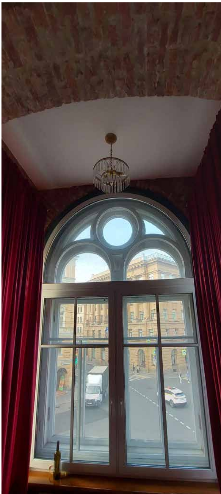
Фото 15. Выявленный объект культурного наследия «Дом М.А.Панова», Санкт-Петербург, Суворовский пр., 1/8, лит.А., квартира 3. Часть помещения 11 (по плану ПИБ). Оконное заполнение деревянное со стороны улицы, с двойными оконными рамами. Со стороны помещения дополнительно установлено оконное заполнение металлопластиковое.
