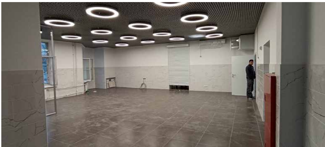
24. 1-й этаж, помещение 122.
