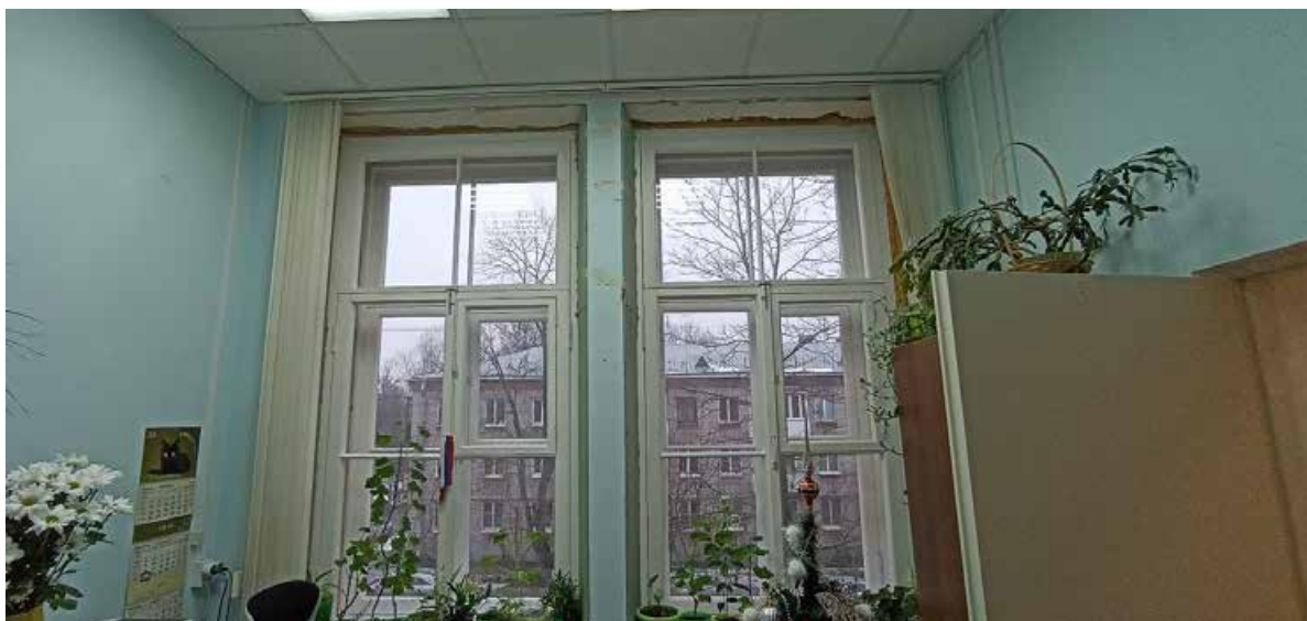
42. 2-й этаж, помещение 209.
