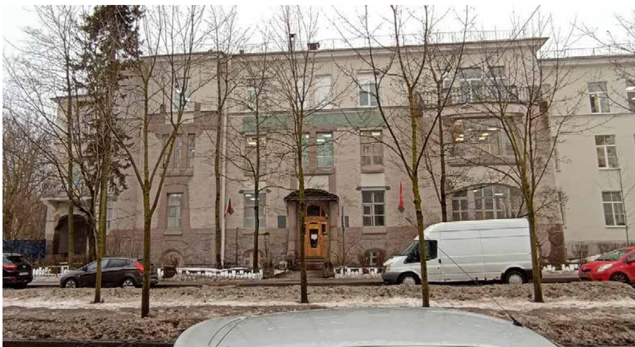
4. Вид на лицевой фасад старого корпуса.
