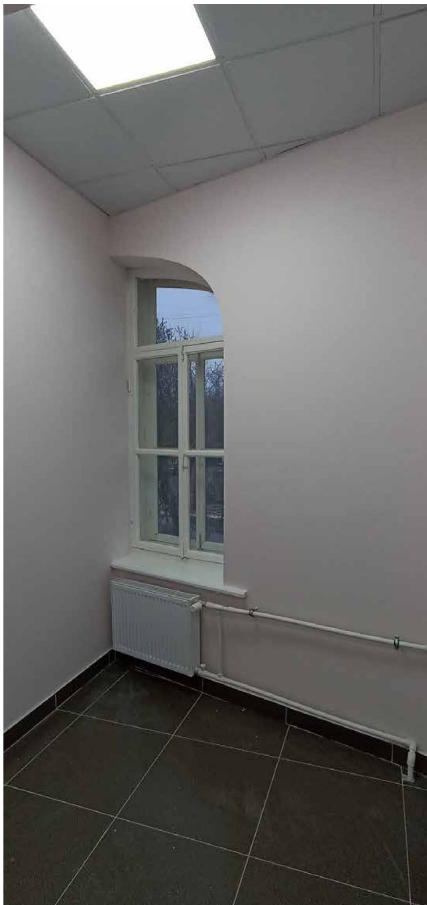
26. 1-й этаж, помещение 124.
