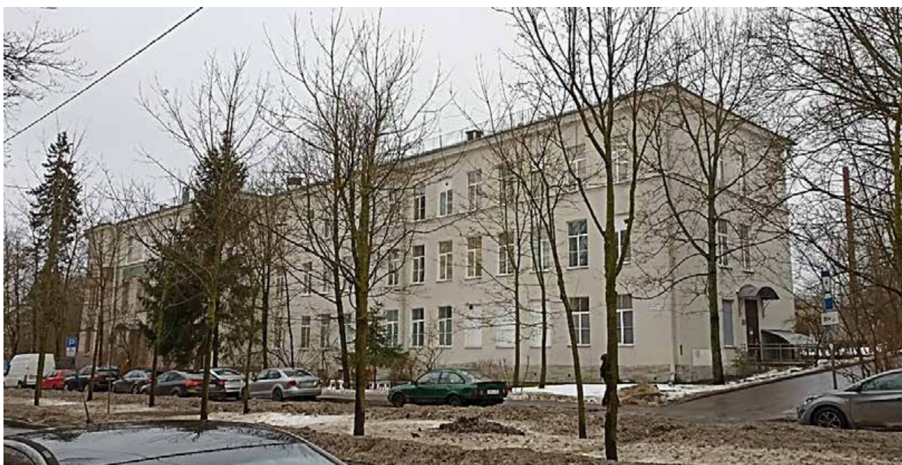
6. Общий вид на здание с северо-запада.
