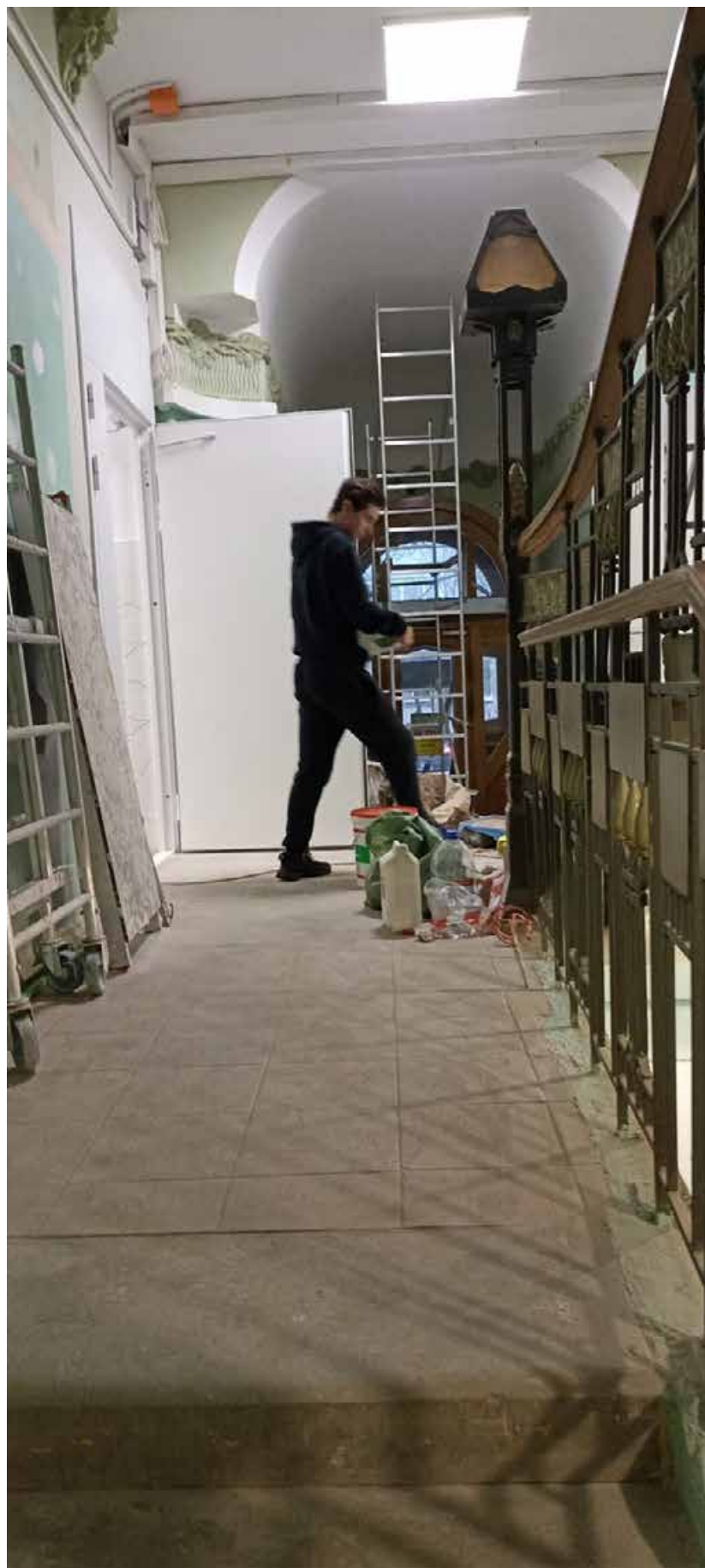
21. Площадка 1-го этажа парадной лестницы.
