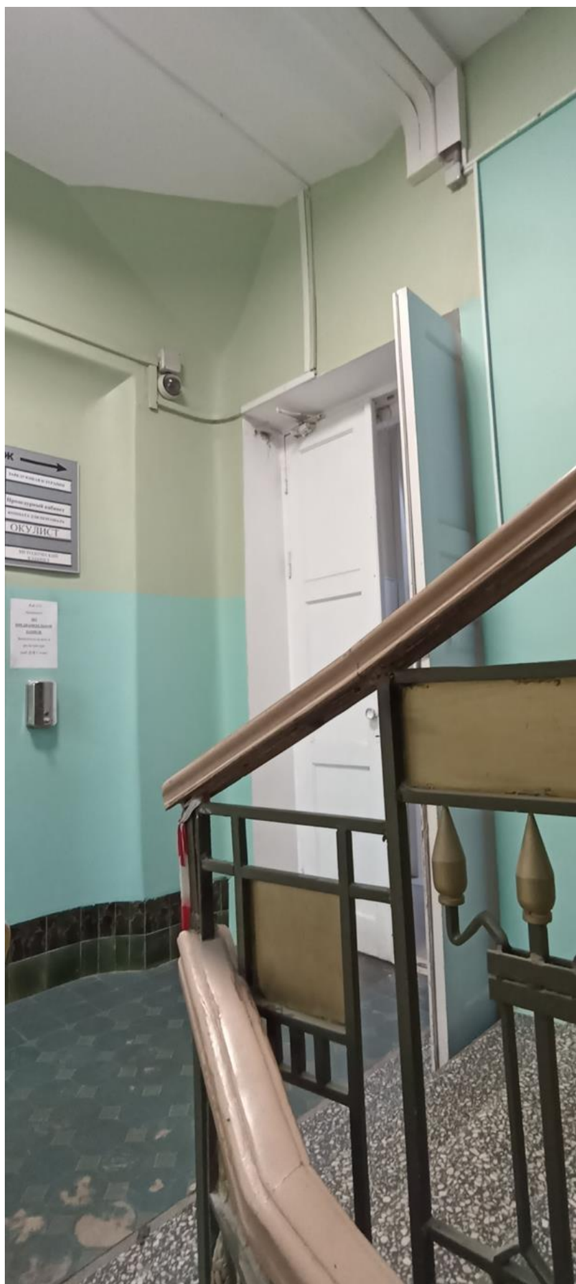
30. Площадка 2-го этажа парадной лестницы.
