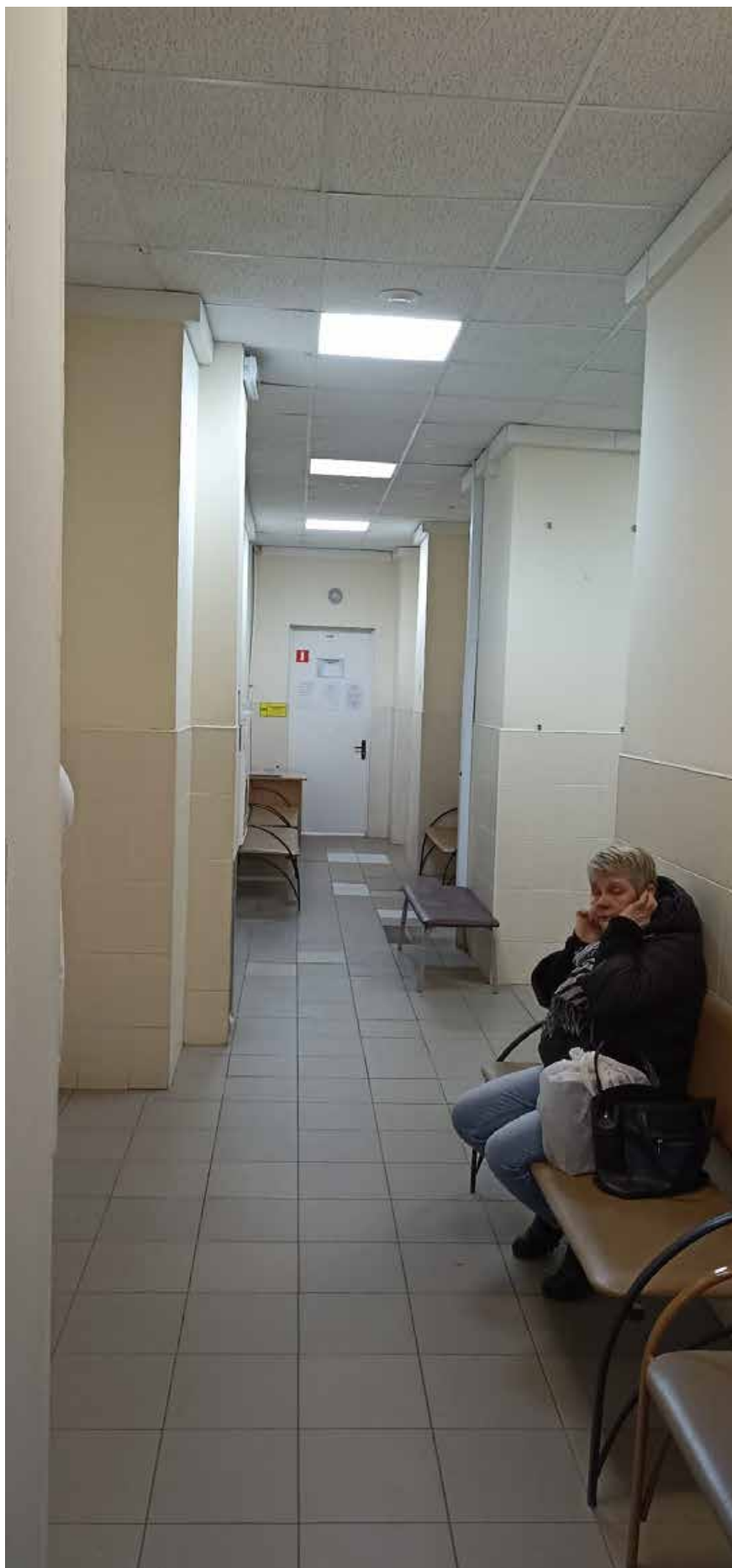
38. Коридор 2-го этажа.
