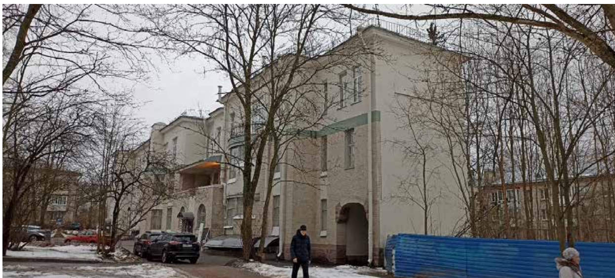
12. Вид на дворовой и юго-восточный (торцевой) фасады.
