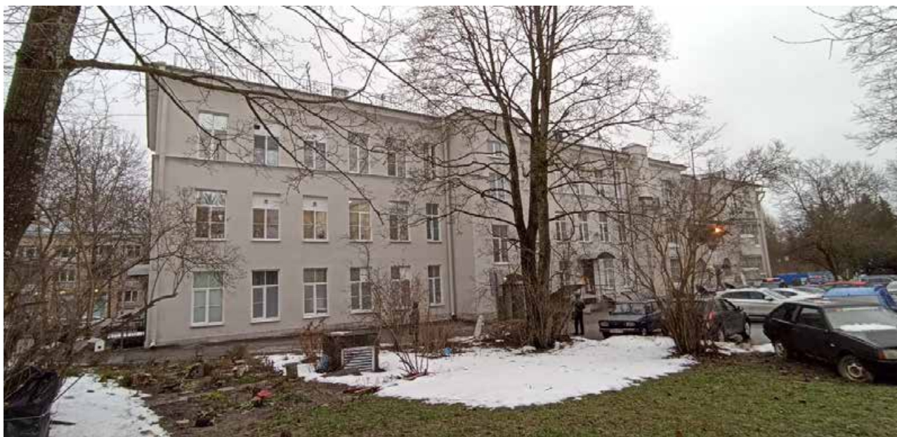
8. Общий вид на здание с юго-запада.
