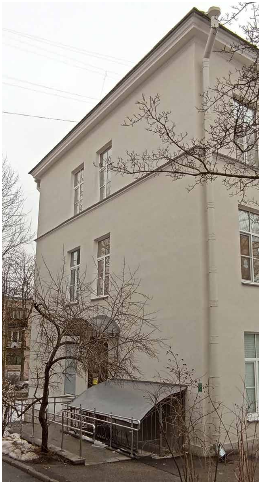
7. Северо-западный (торцевой) фасад здания, вид с юго-запада.
