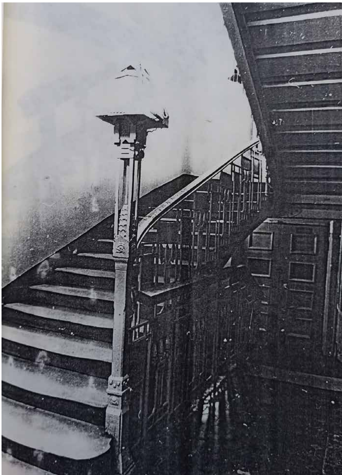
34. Фрагмент интерьера 1-го этажа. Общий вид парадной лестницы с площадки 1-го этажа. Фото 1989 г. Архив КГИОП. Историческая справка «Особняк Савицкой в Царском селе» (г. Пушкин, ул. Московская, 15). Автор: Г.В. Семенов. Л., 1989. Л.40.
