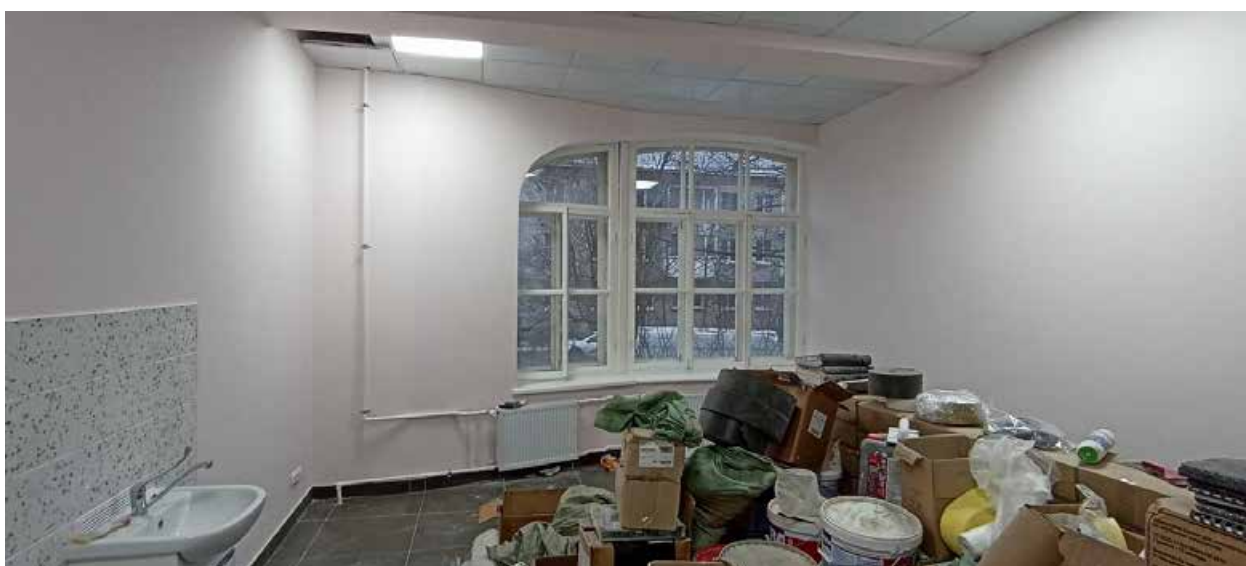
25. 1-й этаж, помещение 126.
