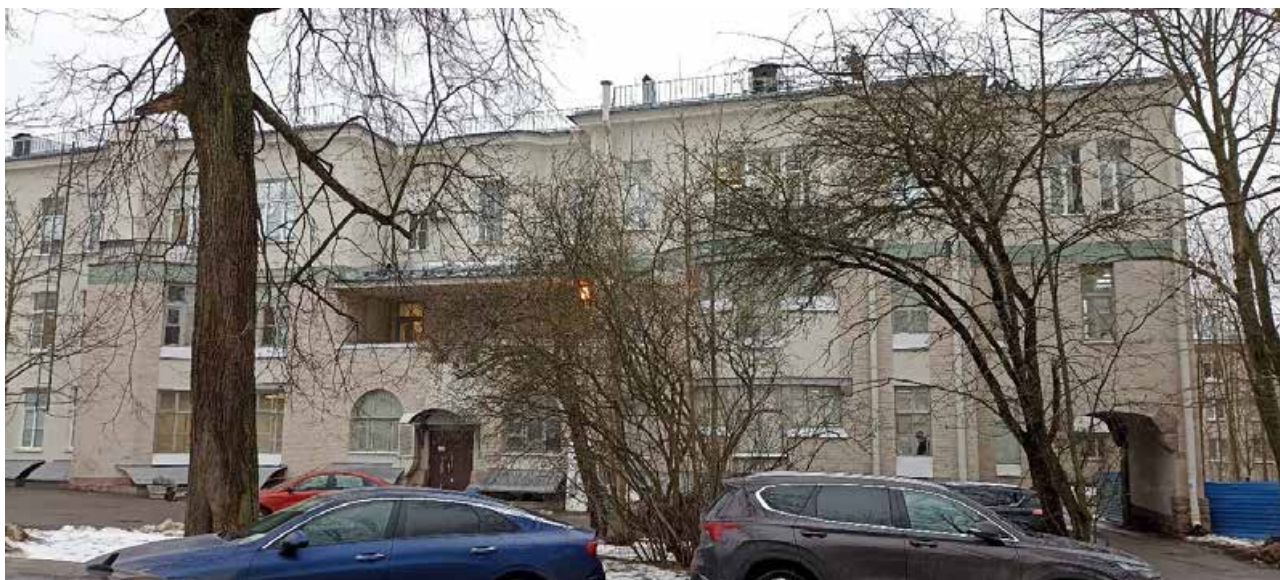
11. Вид на дворовой фасад старого корпуса с юга.
