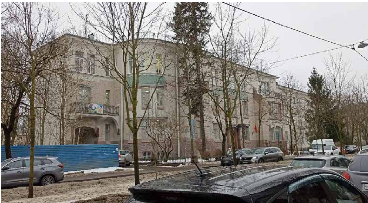
1. Общий вид на здание с северо-востока.
