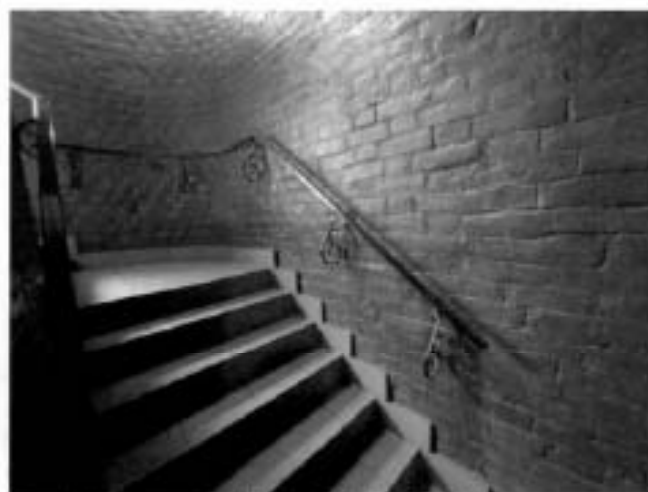
20. Лестница 1ЛК (II, IV, V, VI) объекта культурного наследия
