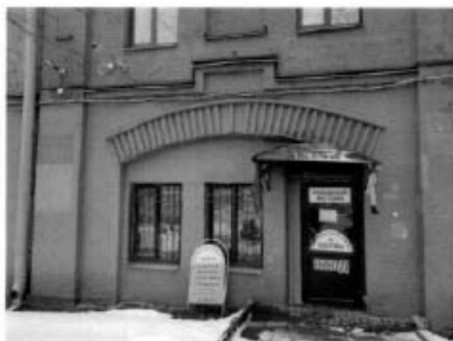
3. Фрагмент лицевого северного фасада объекта культурного наследия
