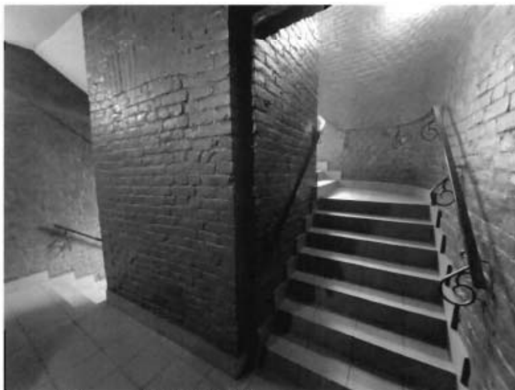
5. Лестница 1ЛК (II, IV, V, VI) объекта культурного наследия
