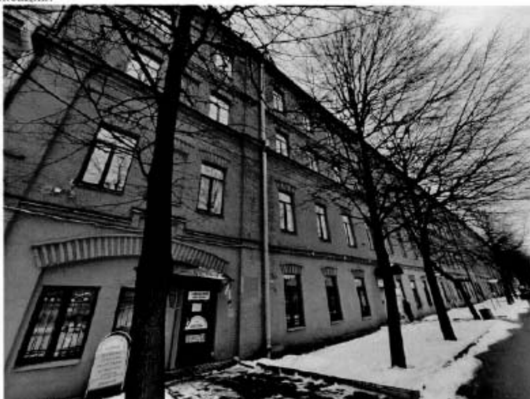
1. Общий вид на лицевой северный фасад объекта культурного наследия.
