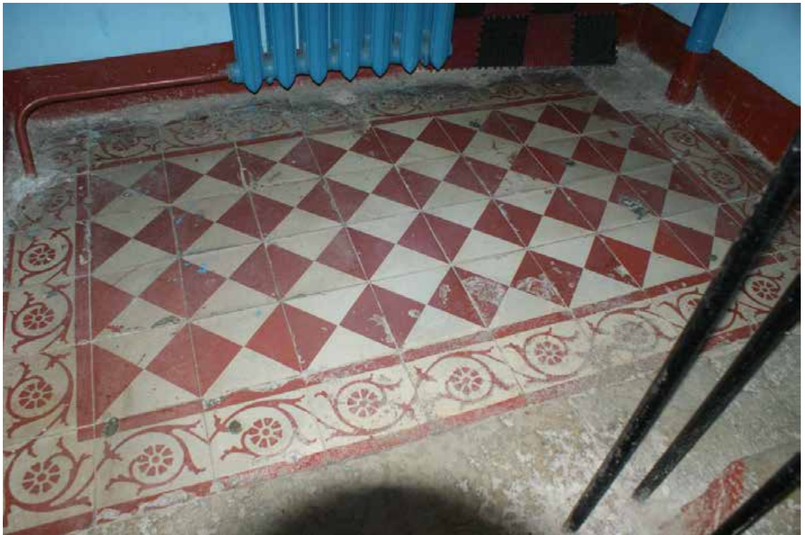
Фото 134. Лестница № 4. Площадка между 1-м и 2-м этажом. Покрытие пола. Съемка 19.04.2021 г. Трушковский В.Э.
