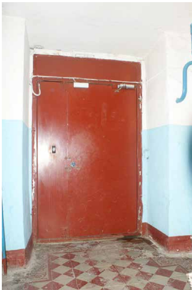
Фото 124. Лестница № 4. 1-й этаж. Вестибюль. Входная дверь. Съемка 19.04.2021 г. Трушковский В.Э.
