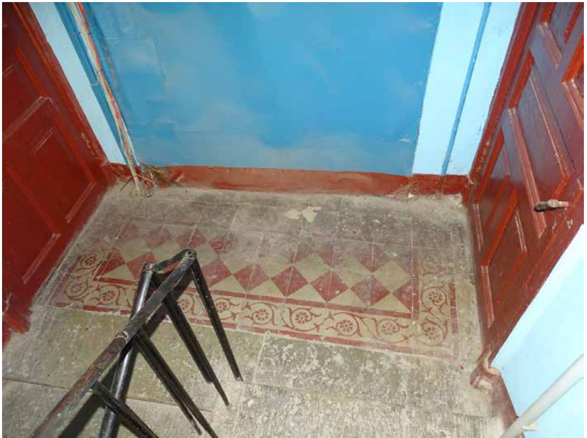
Фото 158. Лестница № 4. Площадка 6-го этажа. Покрытие пола. Съемка 19.04.2021 г. Трушковский В.Э.
