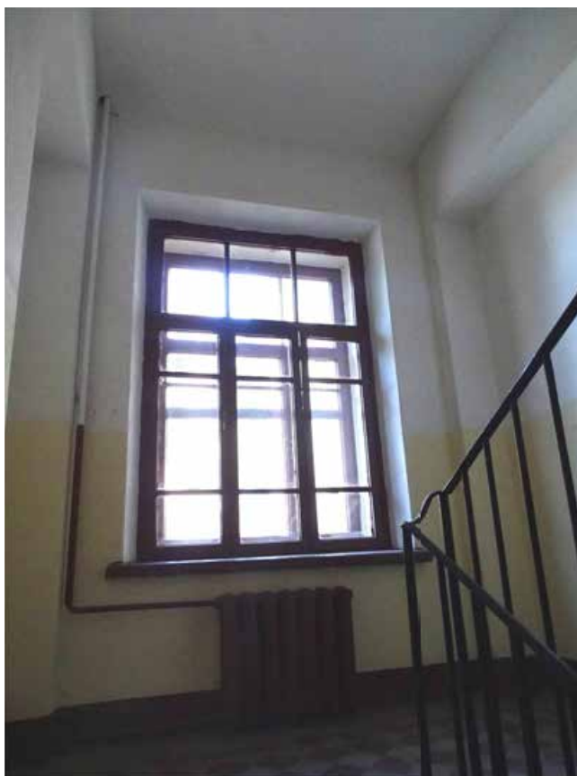
Фото 183. Лестница № 5. Вид на площадку между 4-м и 5-м этажом. Съемка 19.04.2021 г. Трушковский В.Э.
