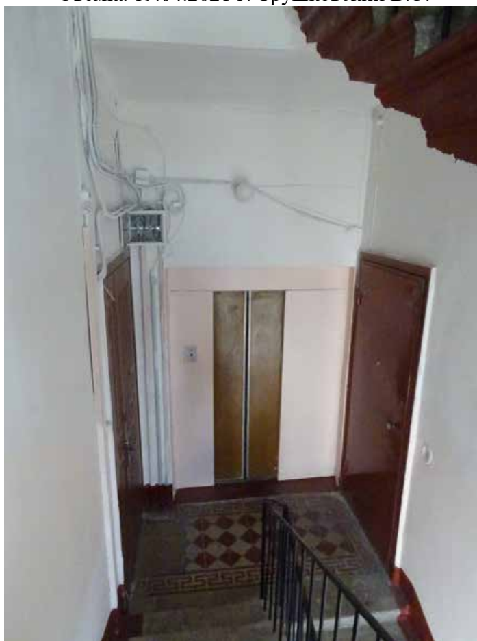
Фото 69. Лестница № 2. Вид на площадку 5-го этажа. Съемка 19.04.2021 г. Трушковский В.Э.
