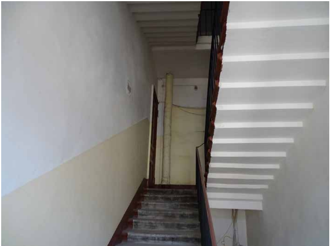
Фото 220. Лестница № 6. 6 этаж. Съёмка 19.04.2021 г. Трушковский В.Э.
