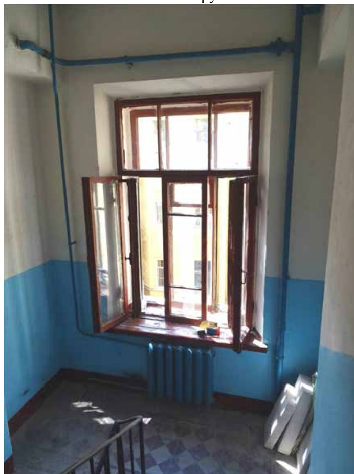
Фото 151. Лестница № 4. Вид на площадку между 4-м и 5-м этажом. Съемка 19.04.2021 г. Трушковский В.Э.
