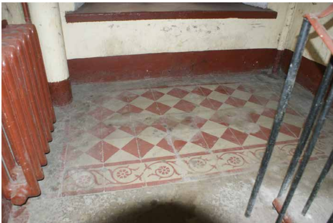
Фото 194. Лестница № 6. Вид на площадку между 1-м и 2-м этажом. Оформление пола. Съемка 19.04.2021 г. Трушковский В.Э.
