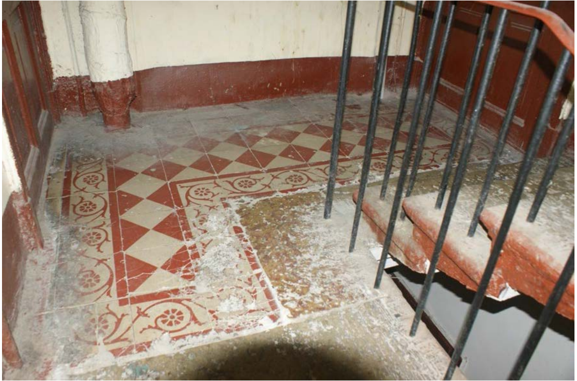
Фото 202. Лестница № 6. 3 этаж. Съемка 19.04.2021 г. Трушковский В.Э.
