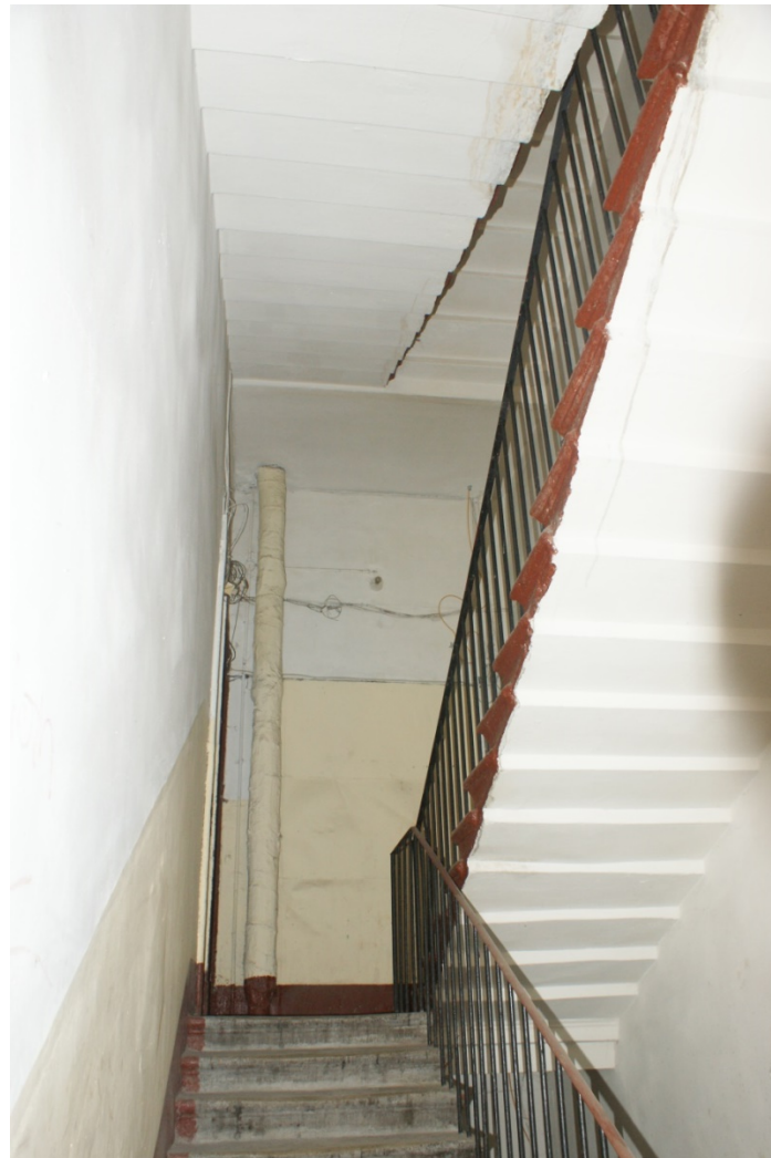
Фото 203. Лестница № 6. 3 этаж. Съемка 19.04.2021 г. Трушковский В.Э.
