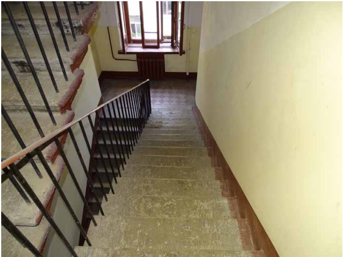
Фото 212. Лестница № 6. Вид на площадку между 4-м и 5-м этажом. Съемка 19.04.2021 г. Трушковский В.Э.
