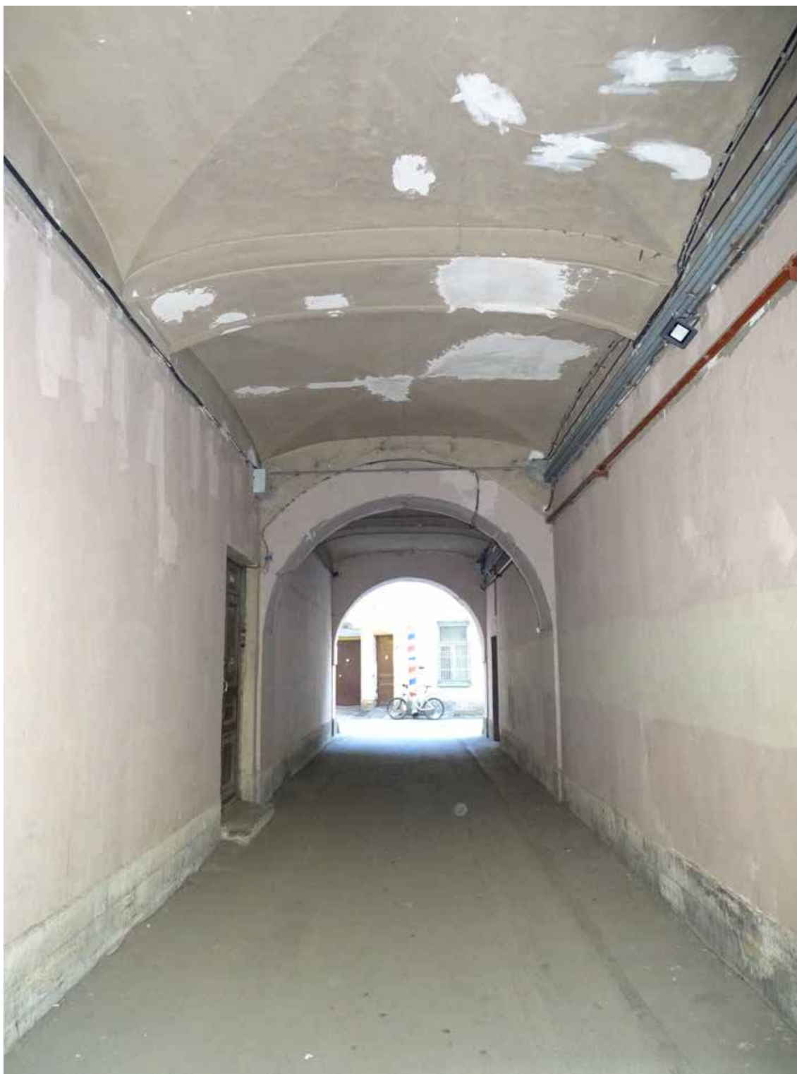
Фото 35. Здание по адресу: г. Санкт-Петербург, Средний пр. В. О., д. 11, литер А. Дворовой проезд поперечного корпуса. Оформление перекрытия. Съемка 19.04.2021 г. Трушковский В.Э.
