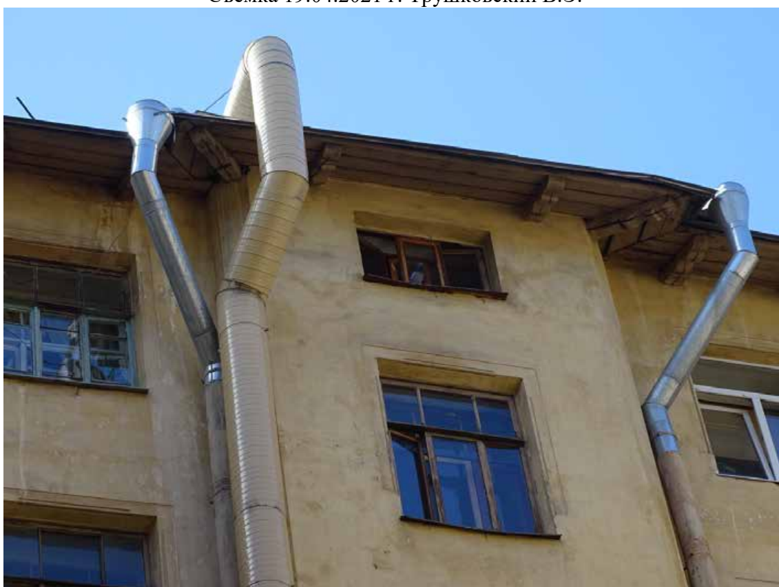
Фото 30. Здание по адресу: г. Санкт-Петербург, Средний пр. В. О., д. 11, литер А. Юго-восточный внутренний двор. Фрагмент фасада. 6-й этаж. Съемка 19.04.2021 г. Трушковский В.Э.
