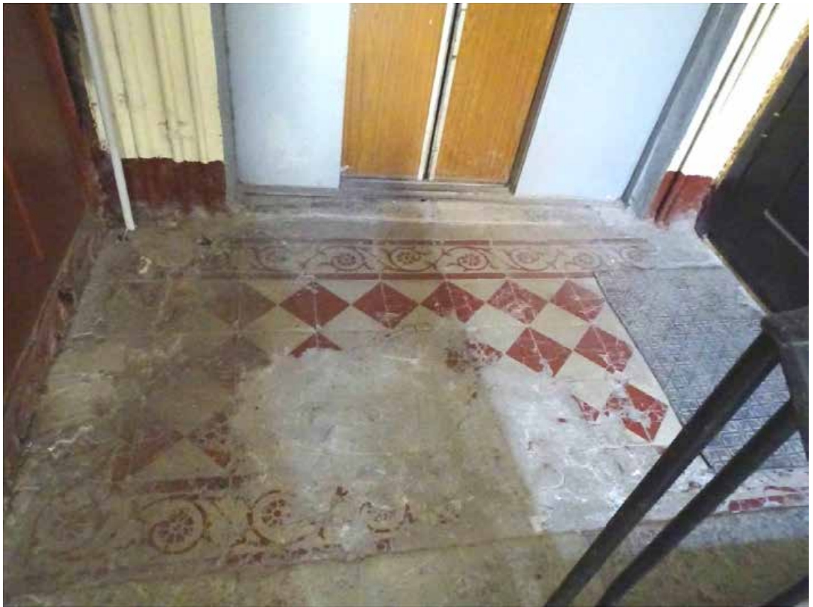
Фото 179. Лестница № 5. Площадка 3-го этажа. Покрытие пола. Съемка 19.04.2021 г. Трушковский В.Э.
