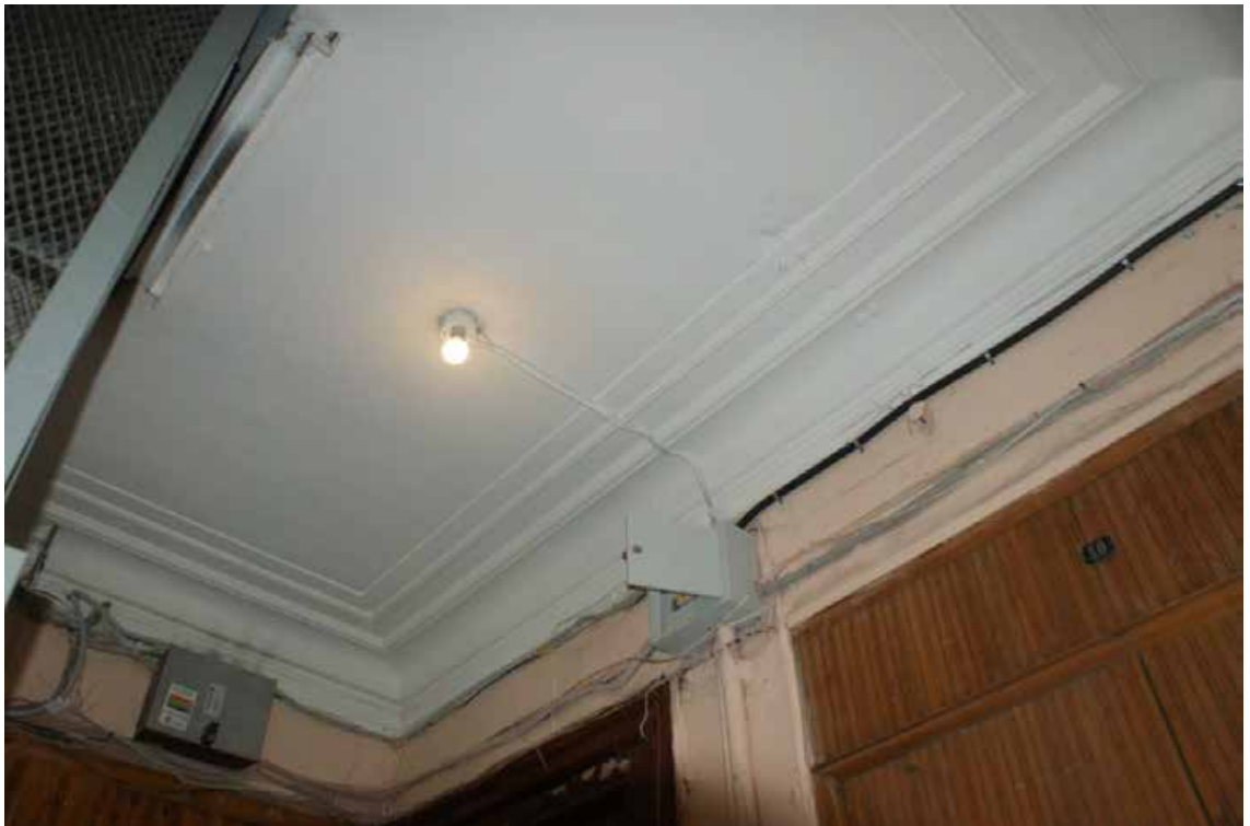
Фото 121. Лестница № 3. Площадка 6-го этажа. Оформление потолка. Съемка 19.04.2021 г. Трушковский В.Э.
