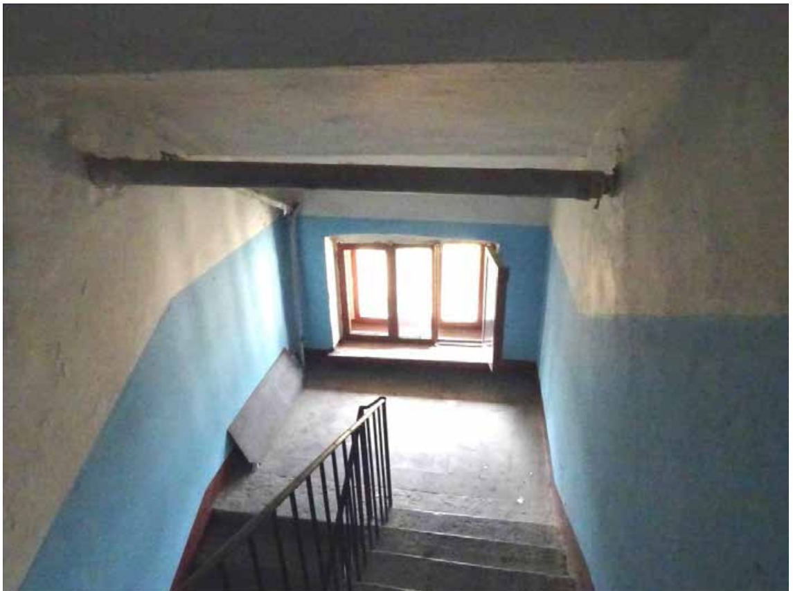
Фото 159. Лестница № 4. Вид на площадку между 6-м и чердачным этажом. Съемка 19.04.2021 г. Трушковский В.Э.
