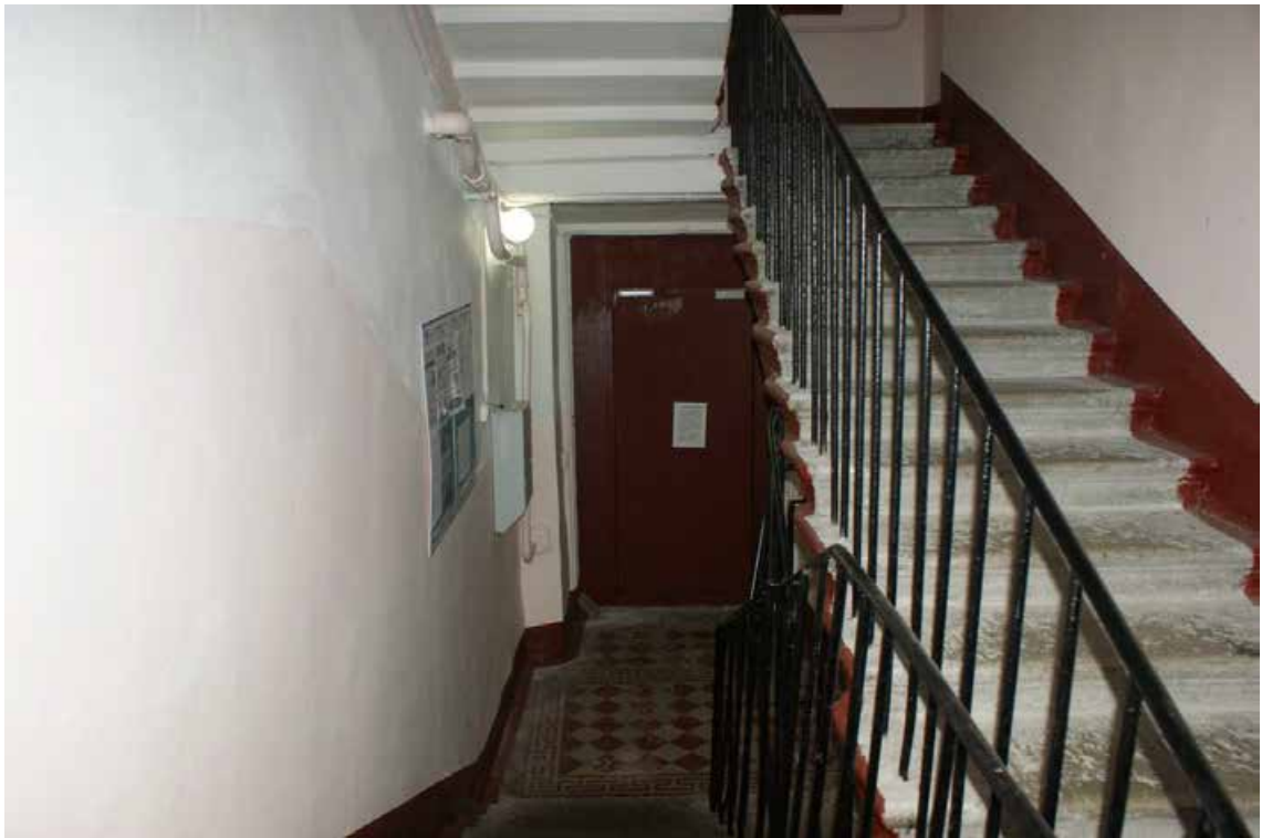
Фото 48. Лестница № 2. 1-й этаж. Вестибюль. Вид на входную дверь. Съемка 19.04.2021 г. Трушковский В.Э.
