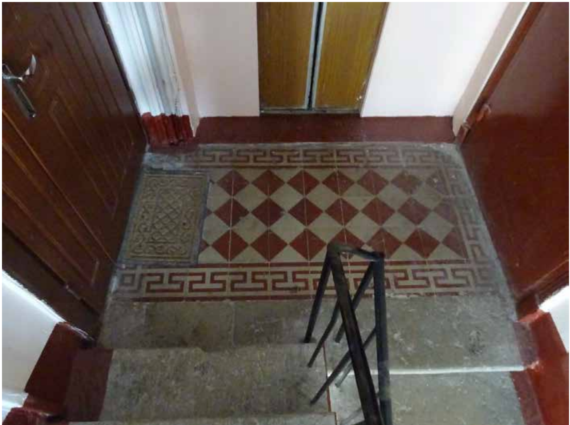
Фото 70. Лестница № 2. Площадка 5-го этажа. Покрытие пола. Съемка 19.04.2021 г. Трушковский В.Э.
