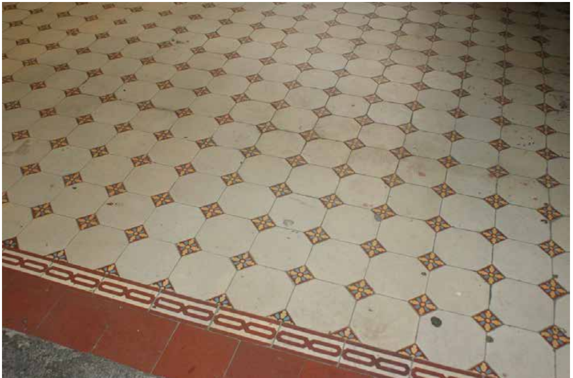
Фото 19. Лестница № 1. Площадка между 1-м и 2-м этажом. Покрытие пола. Съемка 19.04.2021 г. Трушковский В.Э.
