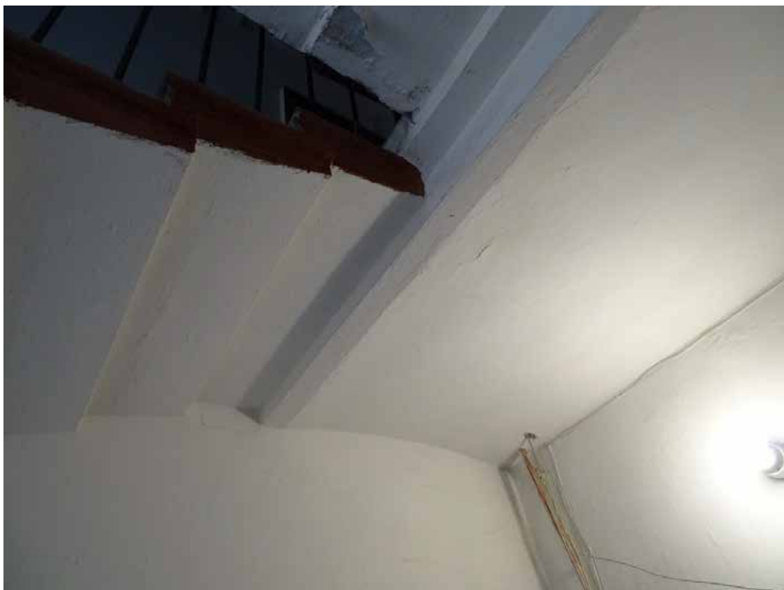
Фото 154. Лестница № 4. Площадка 5-го этажа. Съёмка 19.04.2021 г. Трушковский В.Э.
