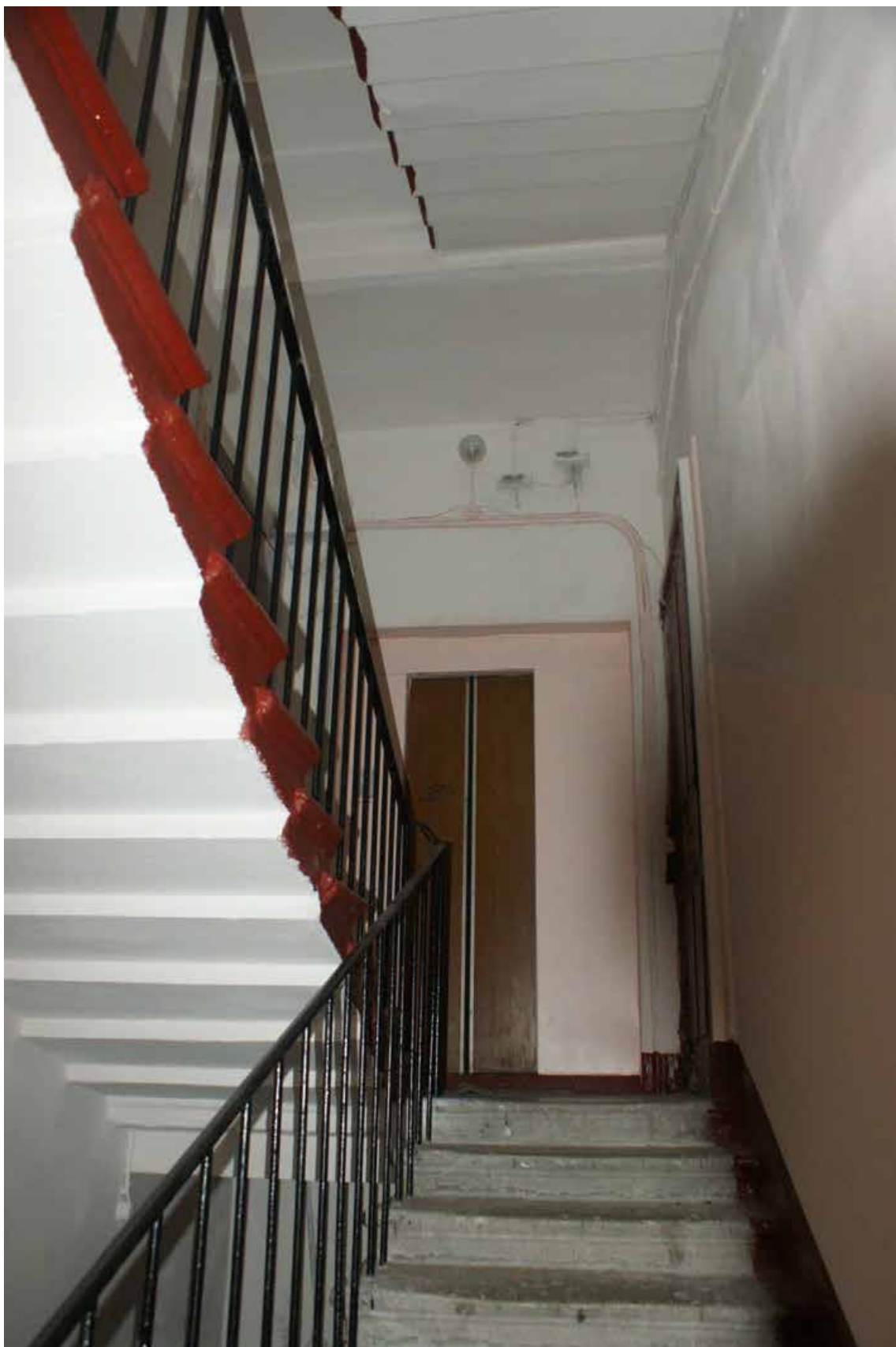
Фото 54. Лестница № 2. Вид на площадку 2-го этажа. Съемка 19.04.2021 г. Трушковский В.Э.
