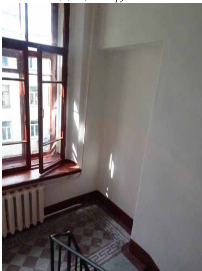
Фото 67. Лестница № 2. Вид на площадку между 4-м и 5-м этажом. Съемка 19.04.2021 г. Трушковский В.Э.
