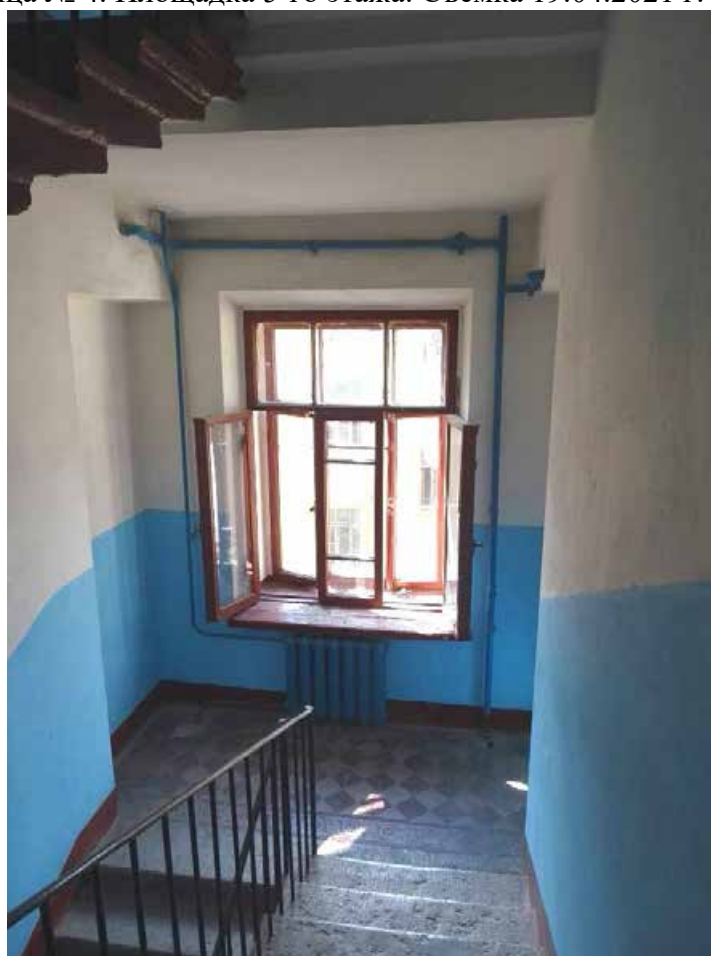
Фото 155. Лестница № 4. Вид на площадку между 5-м и 6-м этажом. Съёмка 19.04.2021 г. Трушковский В.Э.
