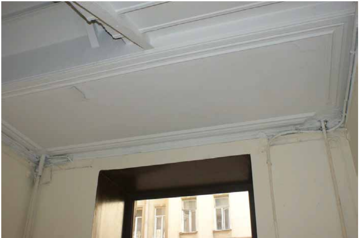
Фото 18. Лестница № 1. Площадка между 1-м и 2-м этажом. Оформление потолка. Съемка 19.04.2021 г. Трушковский В.Э.
