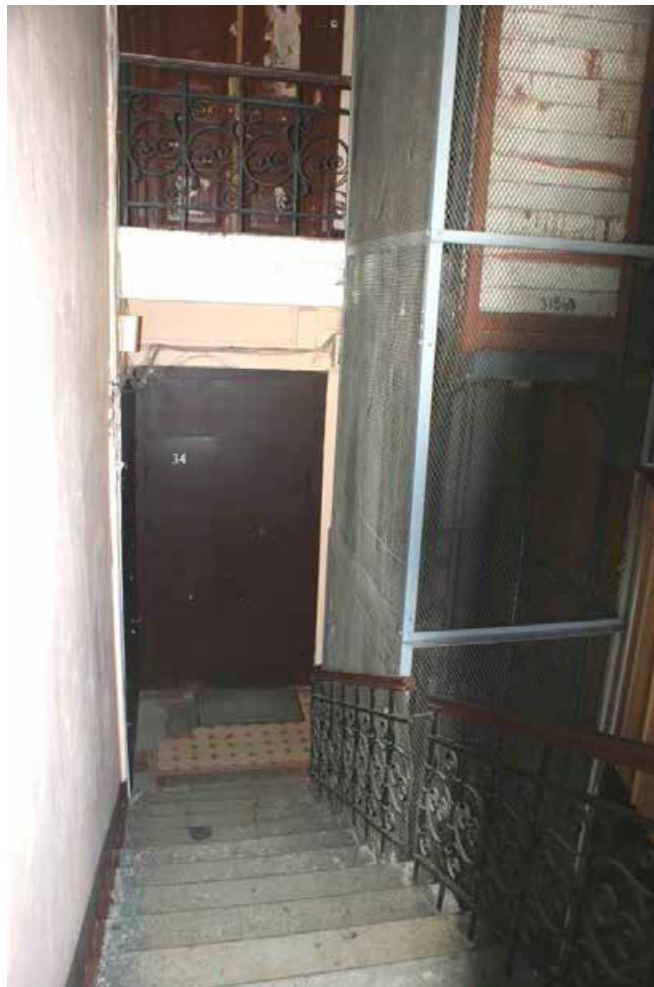
Фото 109. Лестница № 3. Вид на площадку 5-го этажа. Съемка 19.04.2021 г. Трушковский В.Э.
