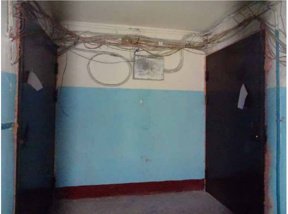
Фото 162. Лестница № 4. Площадка чердачного этажа. Съемка 19.04.2021 г. Трушковский В.Э.
