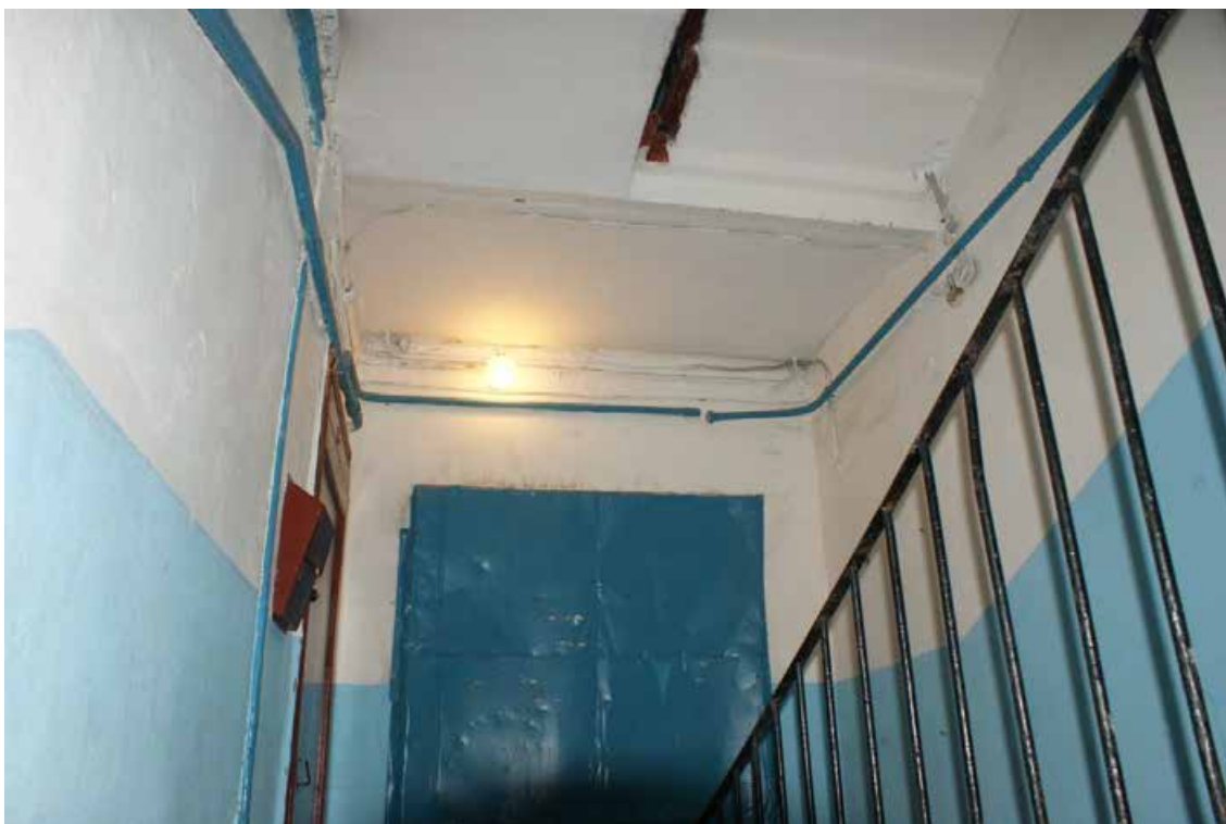
Фото 132. Лестница № 4. Площадка 1-го этажа. Съемка 19.04.2021 г. Трушковский В.Э.
