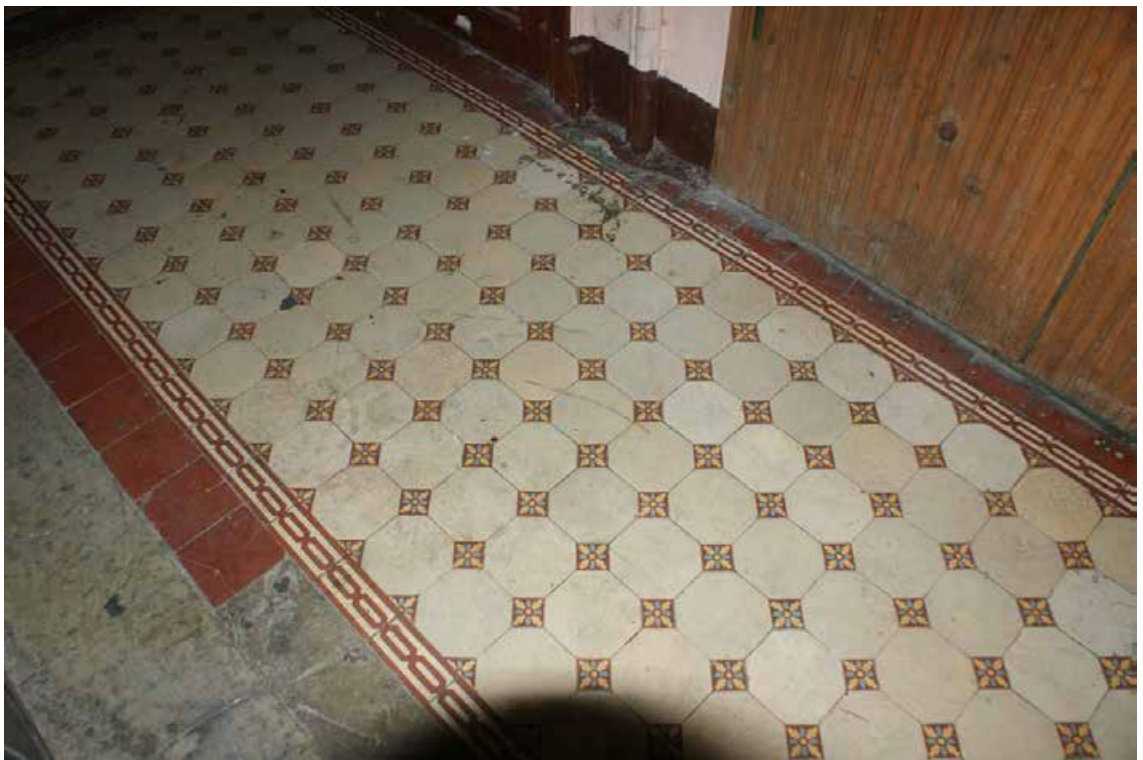
Фото 120. Лестница № 3. Площадка 6-го этажа. Покрытие пола. Съемка 19.04.2021 г. Трушковский В.Э.
