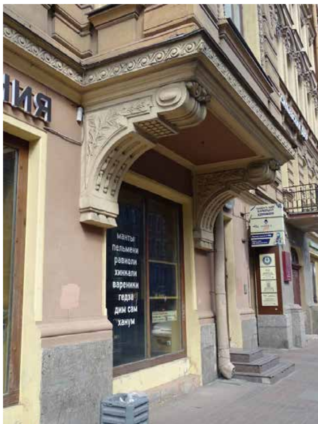
Фото 11. Здание по адресу: г. Санкт-Петербург, Средний пр. В. О., д. 11, литер А. Фрагмент лицевого фасада. Съемка 19.04.2021 г. Трушковский В.Э.
