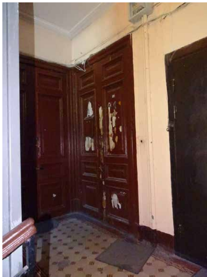
Фото 98. Лестница № 3. Площадка 3-го этажа. Съемка 19.04.2021 г. Трушковский В.Э.
