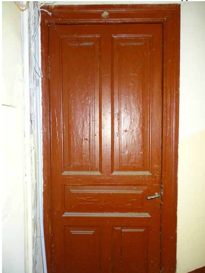
Фото 221. Лестница № 6. 6 этаж. Дверное заполнение. Съёмка 19.04.2021 г. Трушковский В.Э.
