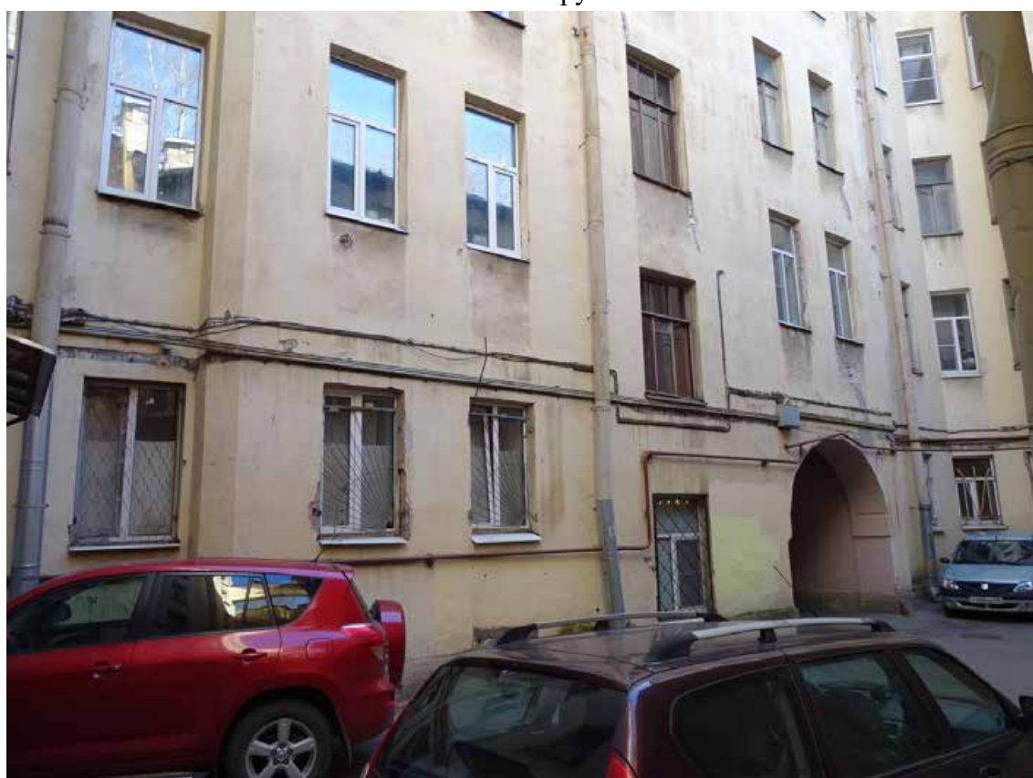
Фото 37. Здание по адресу: г. Санкт-Петербург, Средний пр. В. О., д. 11, литер А. Фрагмент фасада поперечного корпуса. Северо-западный двор. Съемка 19.04.2021 г. Трушковский В.Э.
