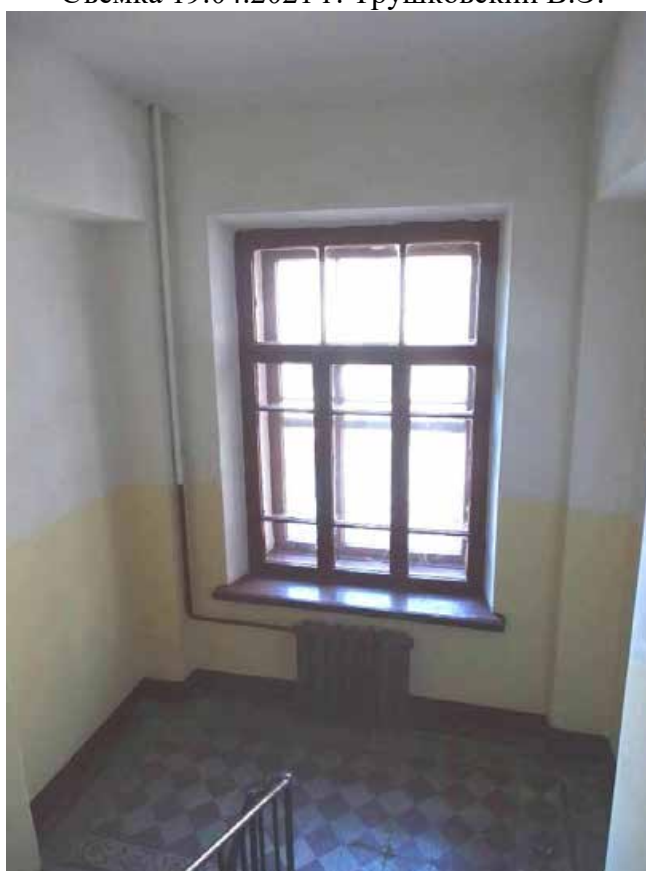
Фото 184. Лестница № 5. Вид на площадку между 4-м и 5-м этажом. Съемка 19.04.2021 г. Трушковский В.Э.
