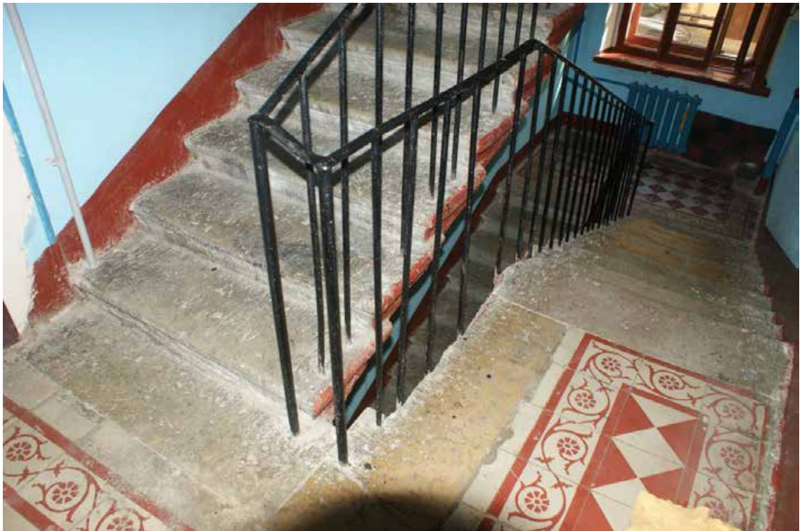
Фото 139. Лестница № 4. Площадка 2-го этажа. Покрытие пола. Съемка 19.04.2021 г. Трушковский В.Э.
