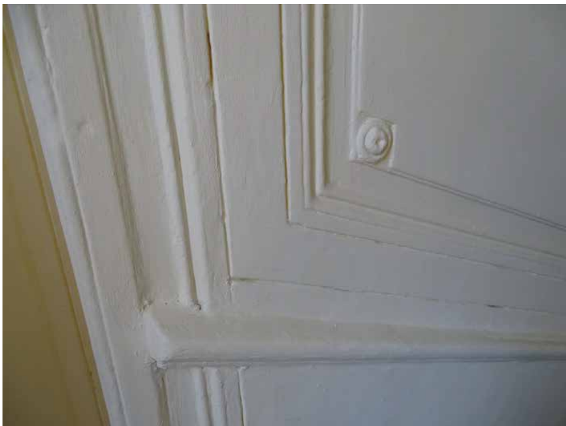
Фото 38. Лестница № 1. 5-й этаж. Профилированные рамы стен. Съемка 19.04.2021 г. Трушковский В.Э.
