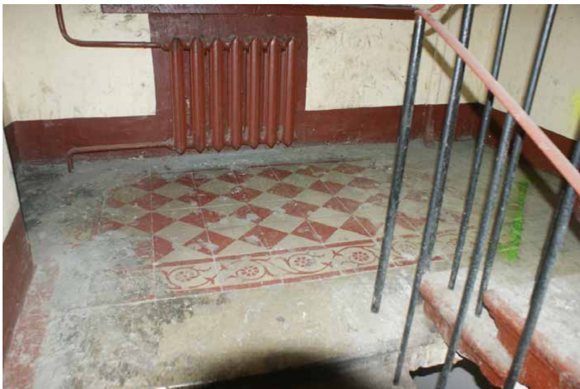
Фото 200. Лестница № 6. Вид на площадку между 2-м и 3-м этажом. Оформление пола. Съемка 19.04.2021 г. Трушковский В.Э.
