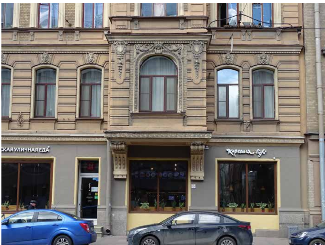
Фото 5. Здание по адресу: г. Санкт-Петербург, Средний пр. В. О., д. 11, литер А. Фрагмент лицевого фасада. 1-й, 2-й этаж. Съемка 19.04.2021 г. Трушковский В.Э.
