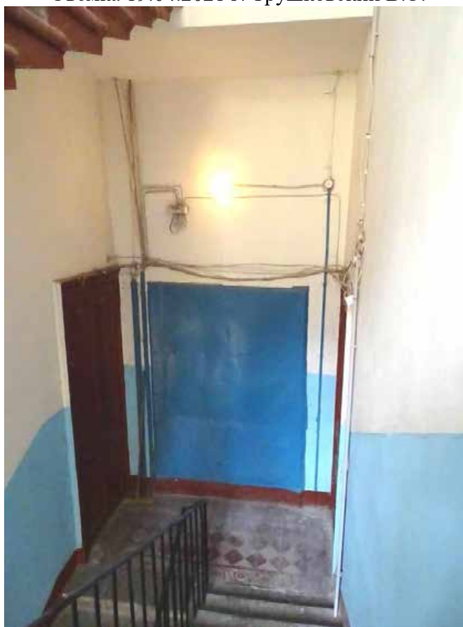
Фото 149. Лестница № 4. Вид на площадку 4-го этажа. Съемка 19.04.2021 г. Трушковский В.Э.
