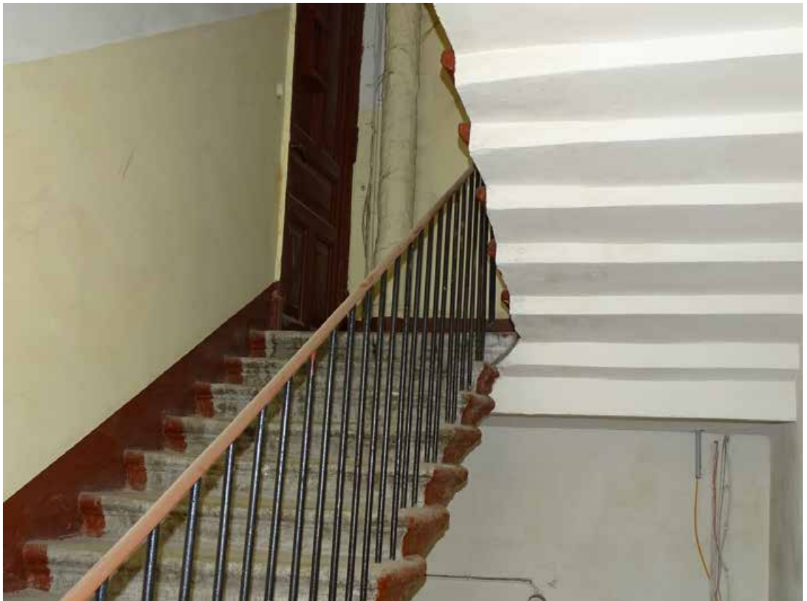
Фото 211. Лестница № 6. 5 этаж. Съёмка 19.04.2021 г. Трушковский В.Э.
