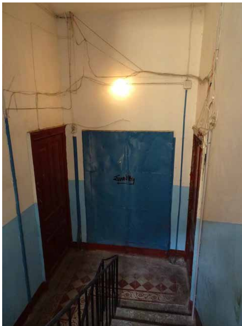
Фото 144. Лестница № 4. Площадка 3-го этажа. Съемка 19.04.2021 г. Трушковский В.Э.
