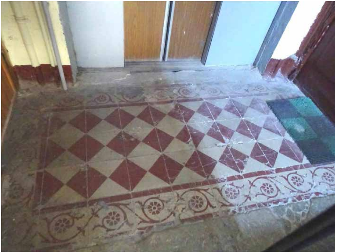
Фото 185. Лестница № 5. Площадка 5-го этажа. Покрытие пола. Съемка 19.04.2021 г. Трушковский В.Э.
