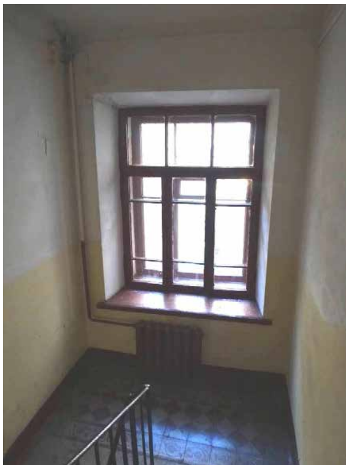
Фото 171. Лестница № 5. Вид на площадку между 1-м и 2-м этажом. Съемка 19.04.2021 г. Трушковский В.Э.
