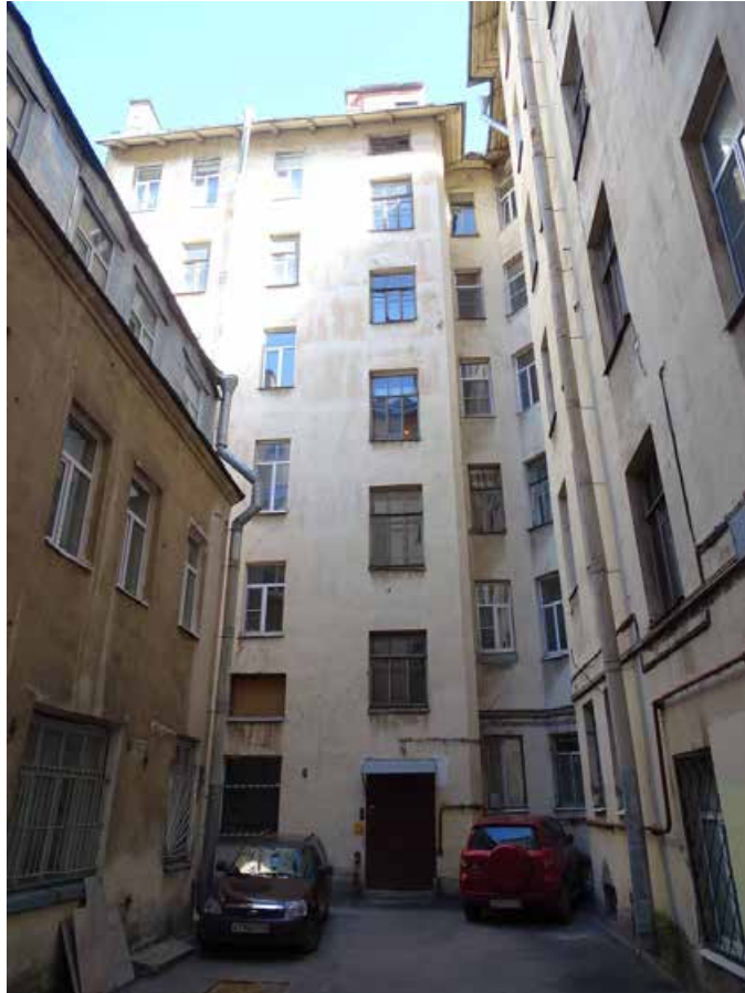
Фото 48. Здание по адресу: г. Санкт-Петербург, Средний пр. В. О., д. 11, литер А. Фрагмент фасада. Северо-западный двор. Съемка 19.04.2021 г. Трушковский В.Э.
