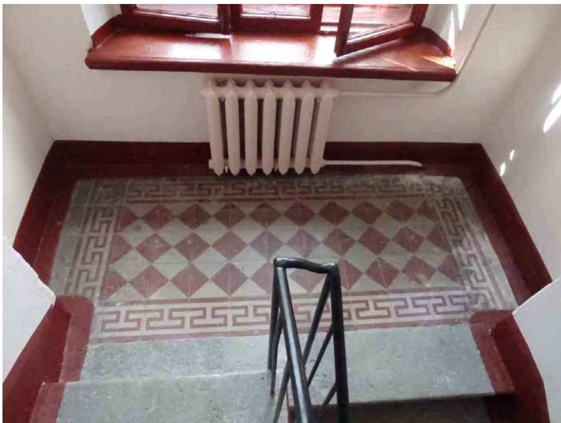
Фото 68. Лестница № 2. Вид на площадку между 4-м и 5-м этажом. Покрытие пола. Съемка 19.04.2021 г. Трушковский В.Э.
