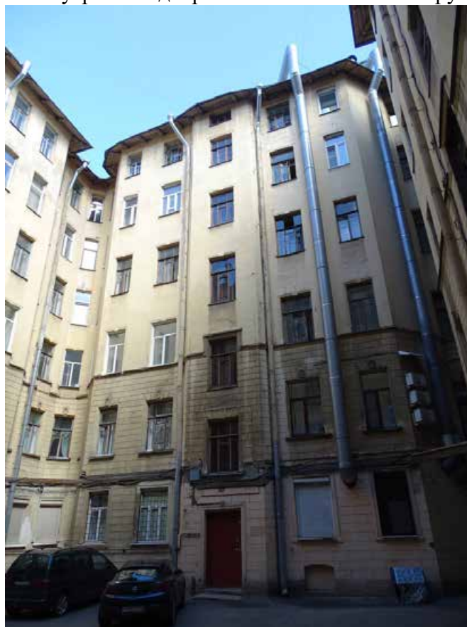
Фото 26. Здание по адресу: г. Санкт-Петербург, Средний пр. В. О., д. 11, литер А. Юго-восточный внутренний двор. Фрагмент фасада. Съемка 19.04.2021 г. Трушковский В.Э.
