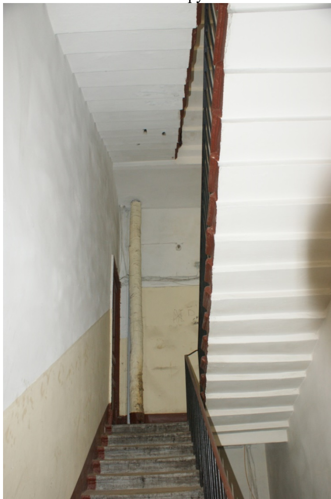
Фото 207. Лестница № 6. 4 этаж. Съемка 19.04.2021 г. Трушковский В.Э.
