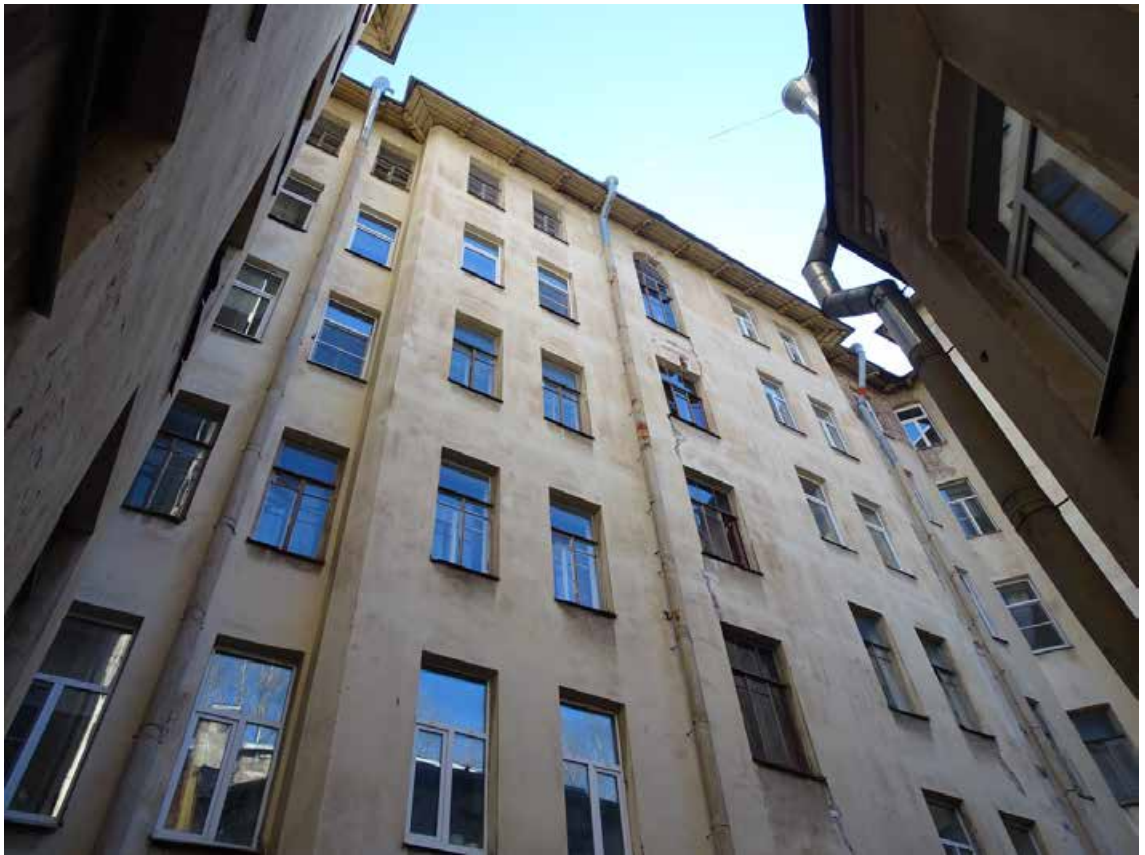
Фото 38. Здание по адресу: г. Санкт-Петербург, Средний пр. В. О., д. 11, литер А. Фрагмент фасада поперечного корпуса. Северо-западный двор. Съемка 19.04.2021 г. Трушковский В.Э.
