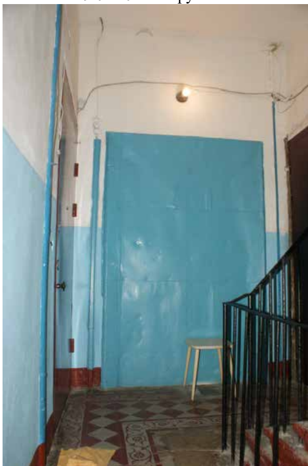
Фото 137. Лестница № 4. Площадка 2-го этажа. Съемка 19.04.2021 г. Трушковский В.Э.
