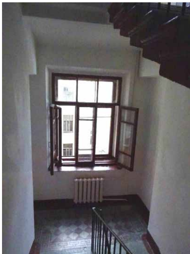
Фото 624. Лестница № 2. Вид на площадку между 3-м и 4-м этажом. Съемка 19.04.2021 г. Трушковский В.Э.
