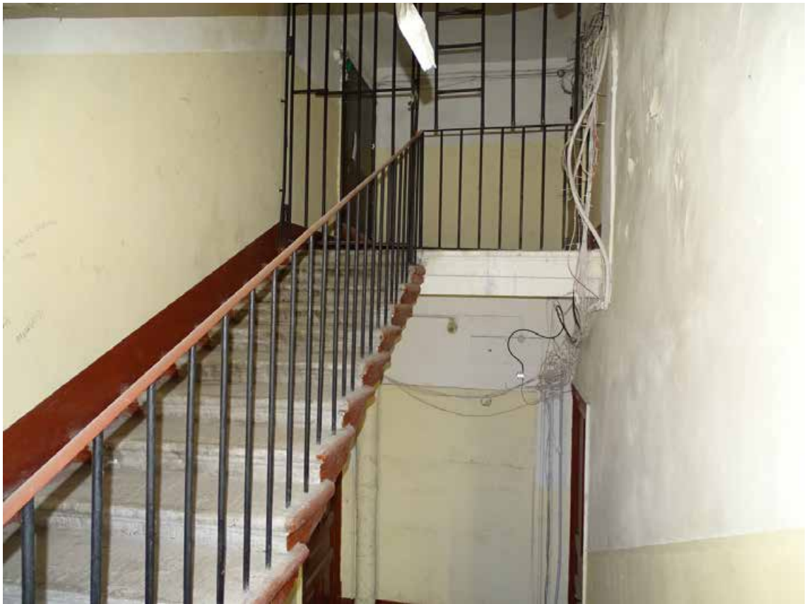
Фото 224. Лестница № 6. Чердачный этаж. Съемка 19.04.2021 г. Трушковский В.Э.
