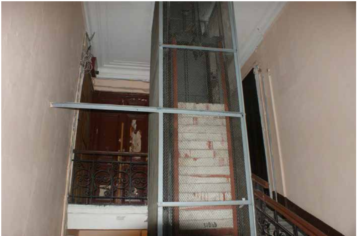
Фото 119. Лестница № 3. Вид на площадку 6-го этажа. Съемка 19.04.2021 г. Трушковский В.Э.
