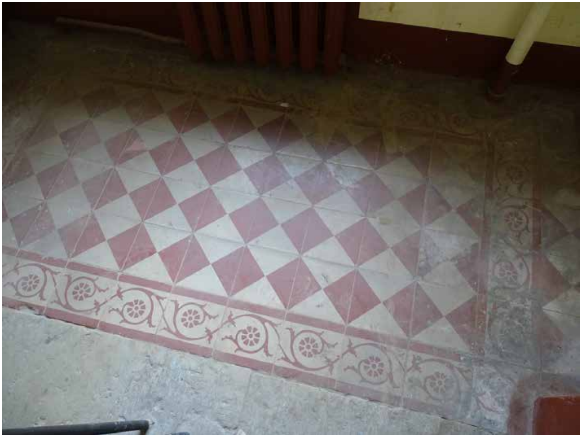
Фото 214. Лестница № 6. Вид на площадку между 4-м и 5-м этажом. Оформление пола. Съемка 19.04.2021 г. Трушковский В.Э.
