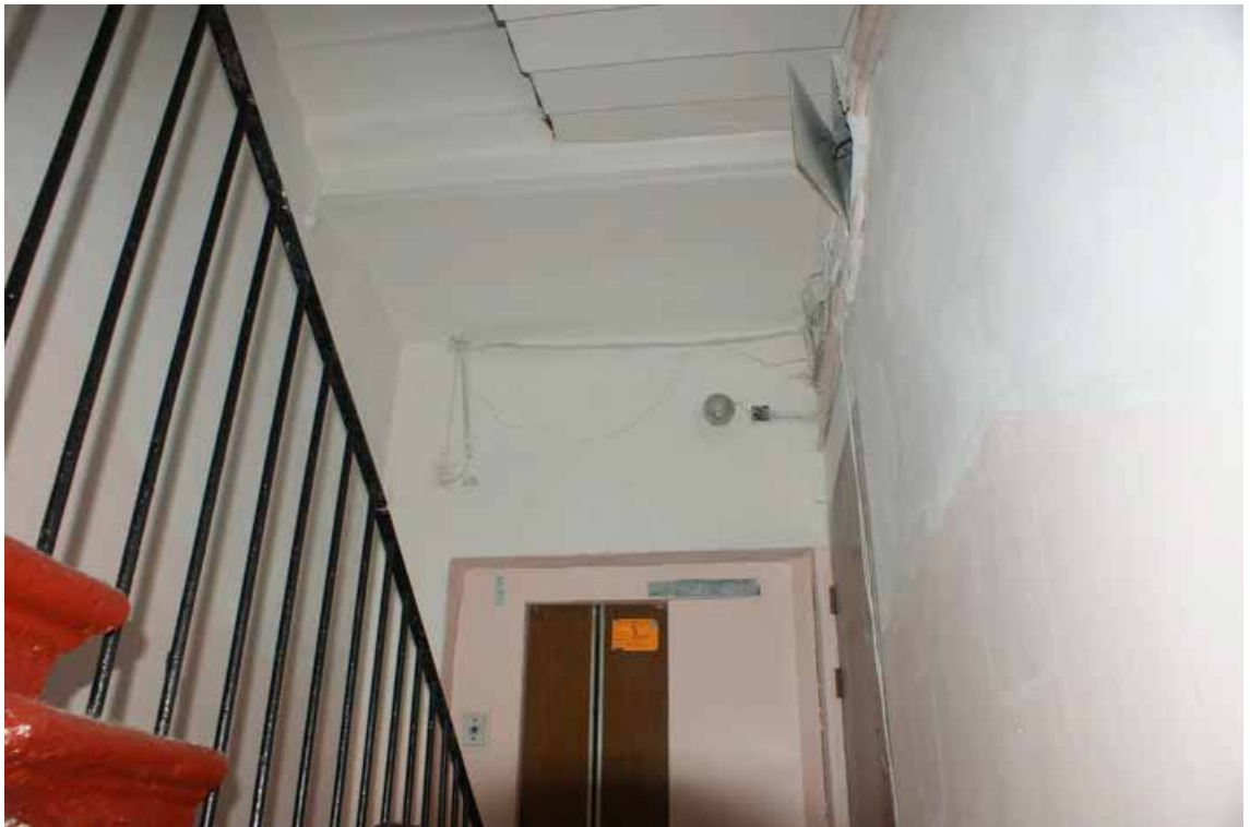
Фото 51. Лестница № 2. Площадка 1-го этажа. Съемка 19.04.2021 г. Трушковский В.Э.
