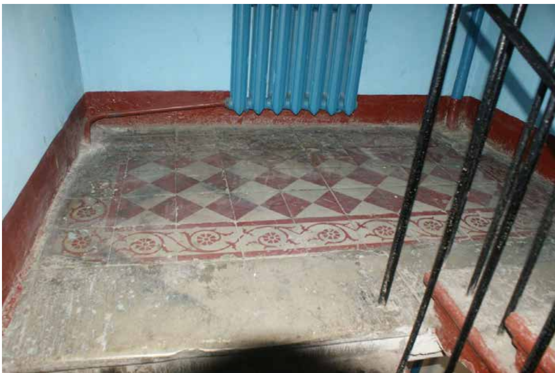
Фото 142. Лестница № 4. Площадка между 2-м и 3-м этажом. Покрытие пола. Съемка 19.04.2021 г. Трушковский В.Э.
