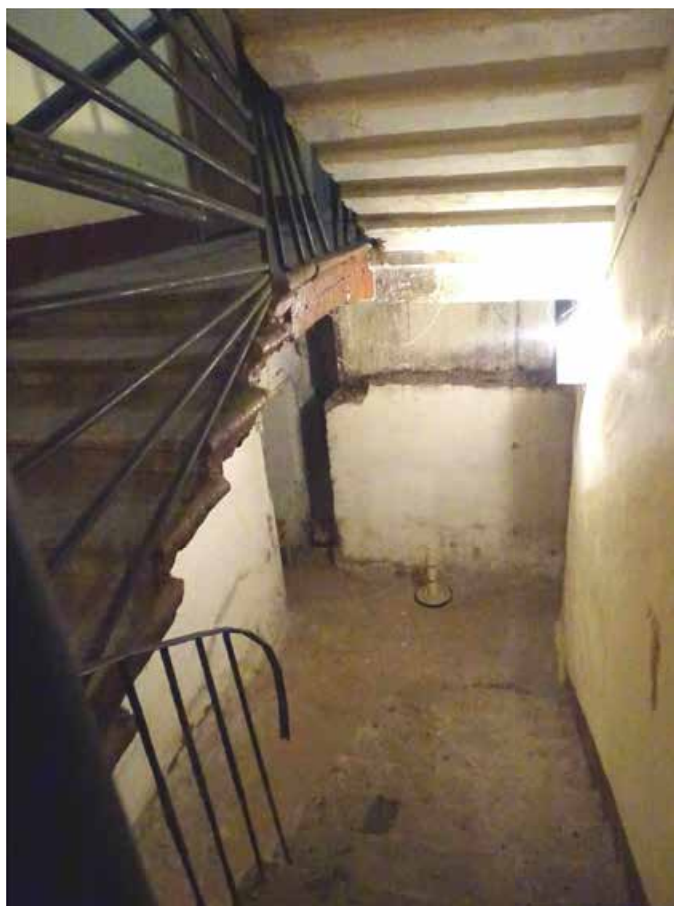
Фото 167. Лестница № 5. Подвальный этаж. Съемка 19.04.2021 г. Трушковский В.Э.
