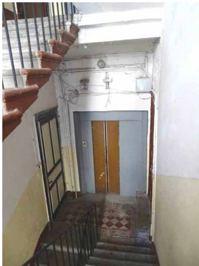
Фото 173. Лестница № 5. Вид на площадку 2-го этажа. Съемка 19.04.2021 г. Трушковский В.Э.
