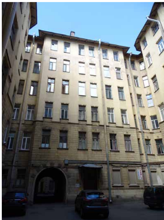
Фото 17. Здание по адресу: г. Санкт-Петербург, Средний пр. В. О., д. 11, литер А. Юго-восточный внутренний двор. Фрагмент фасада. Съемка 19.04.2021 г. Трушковский В.Э.
