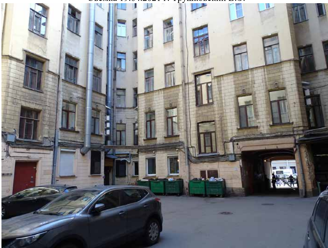
Фото 32. Здание по адресу: г. Санкт-Петербург, Средний пр. В. О., д. 11, литер А. Юго-восточный внутренний двор. Фрагмент лицевого фасада. Съемка 19.04.2021 г. Трушковский В.Э.
