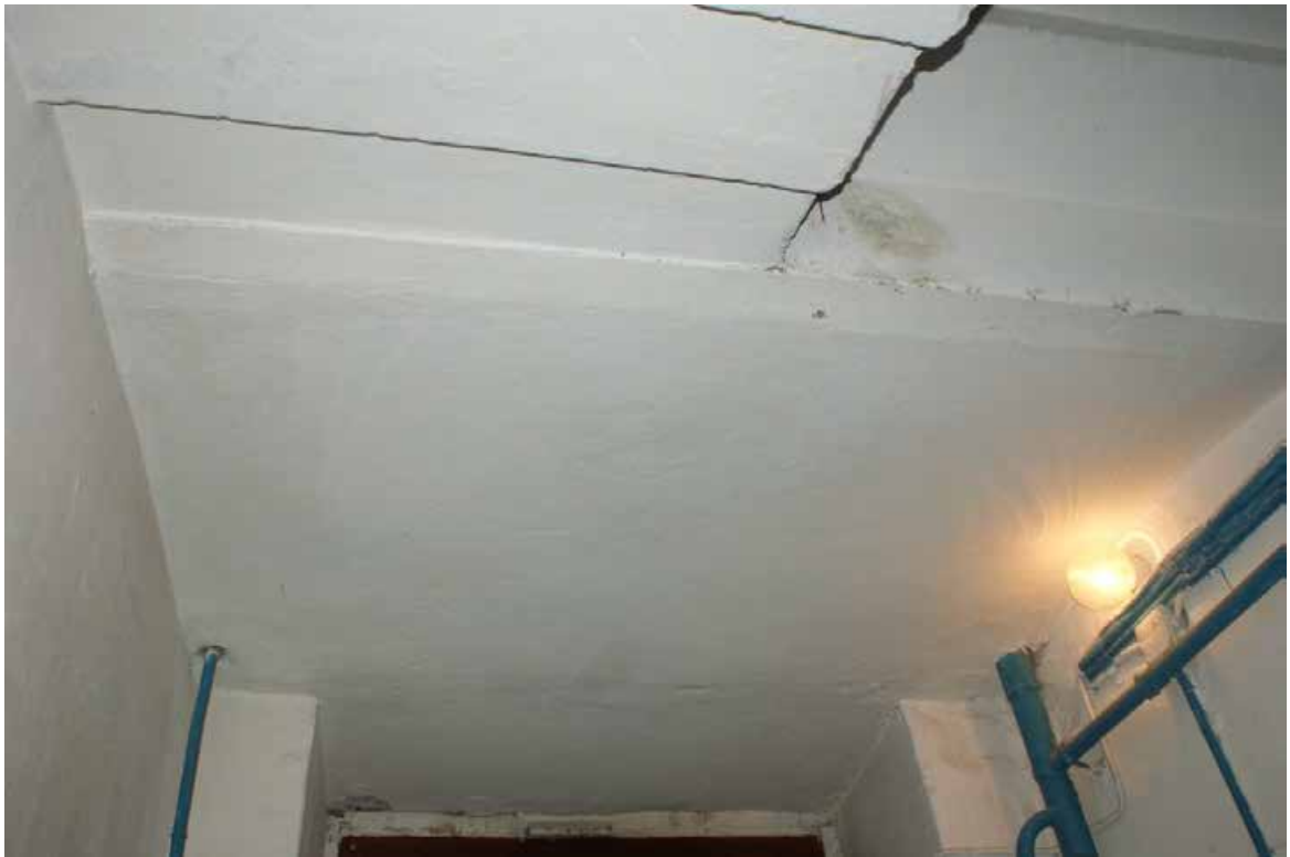
Фото 126. Лестница № 4. 1-й этаж. Вестибюль. Перекрытие. Съемка 19.04.2021 г. Трушковский В.Э.
