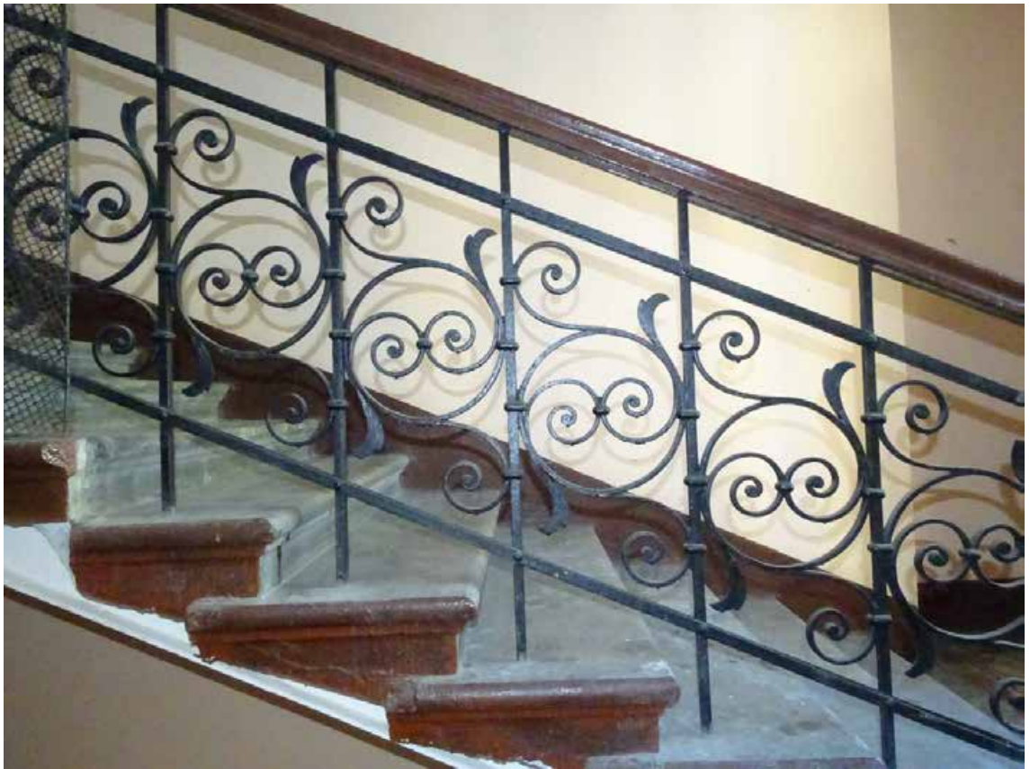
Фото 100. Лестница № 3. Лестничное ограждение. Съемка 19.04.2021 г. Трушковский В.Э.
