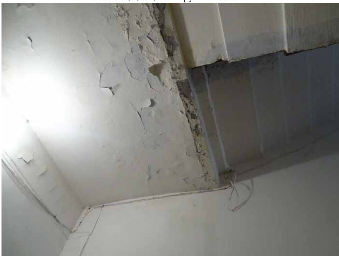
Фото 170. Лестница № 5. Площадка 1-го этажа. Съемка 19.04.2021 г. Трушковский В.Э.
