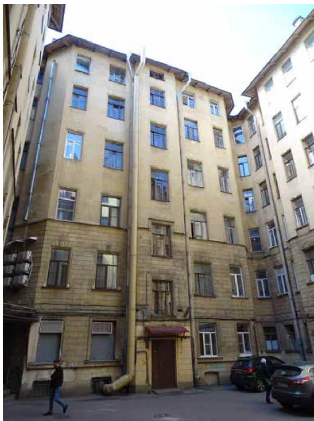
Фото 29. Здание по адресу: г. Санкт-Петербург, Средний пр. В. О., д. 11, литер А. Юго-восточный внутренний двор. Фрагмент фасада. Съемка 19.04.2021 г. Трушковский В.Э.
