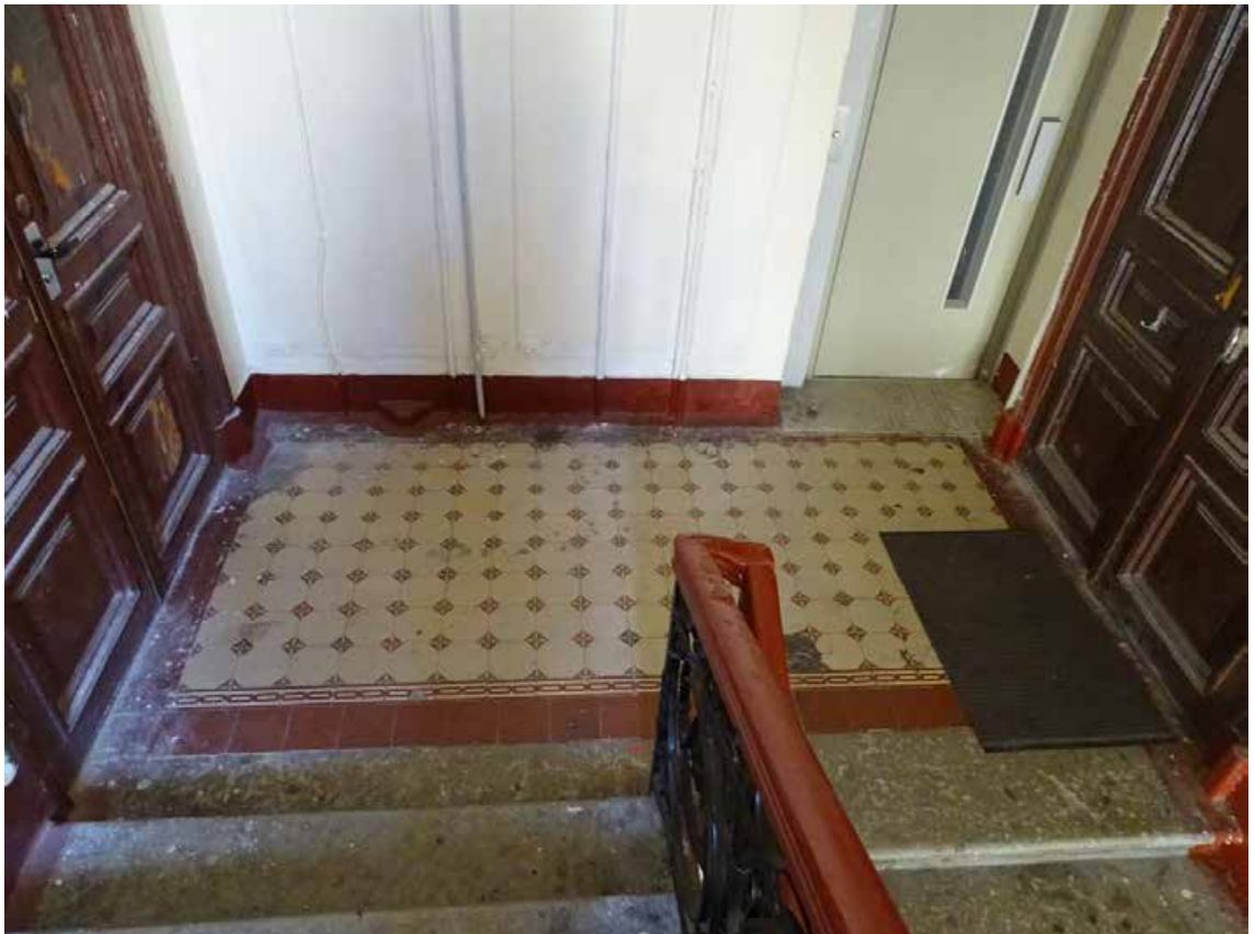
Фото 30. Лестница № 1. Площадка 4-го этажа. Покрытие пола. Съемка 19.04.2021 г. Трушковский В.Э.
