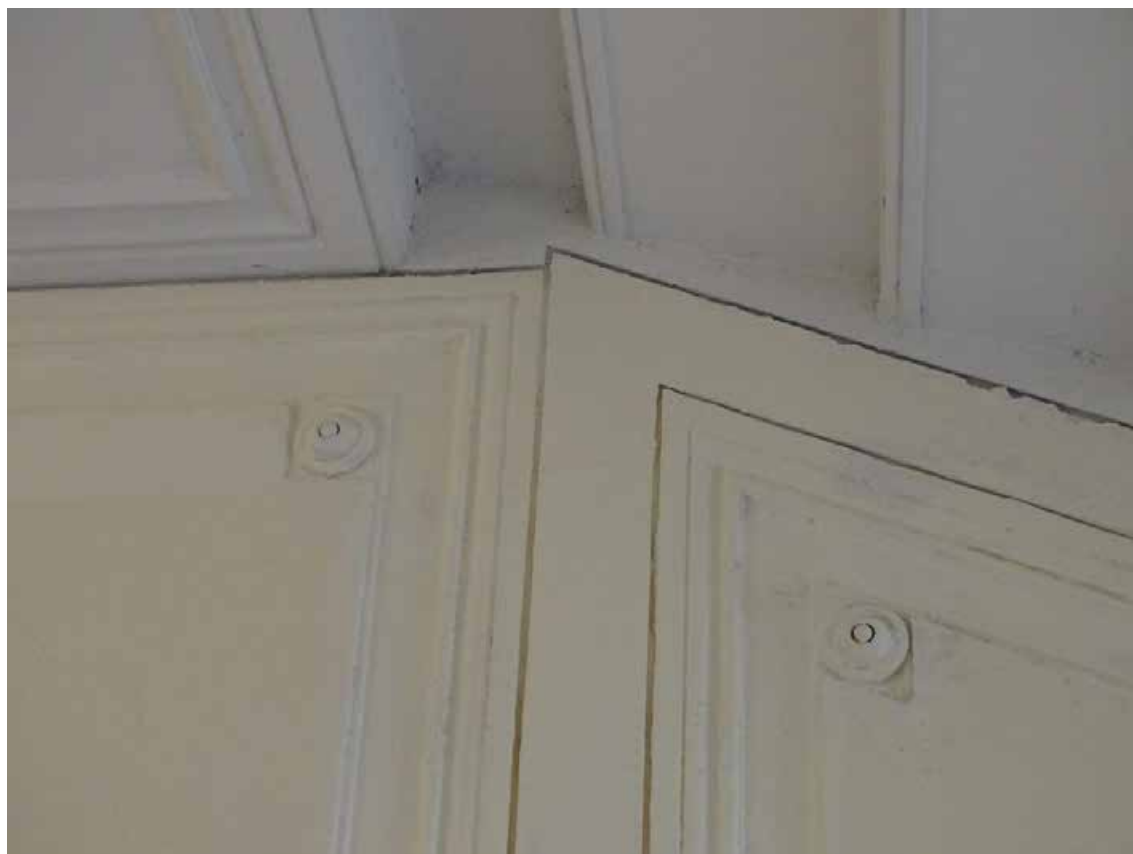
Фото 25. Лестница № 1. Площадка 3-го этажа. Профилированные рамы стен. Съемка 19.04.2021 г. Трушковский В.Э.
