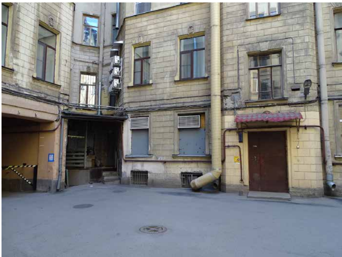
Фото 31. Здание по адресу: г. Санкт-Петербург, Средний пр. В. О., д. 11, литер А. Юго-восточный внутренний двор. Фрагмент фасада. 6-й этаж. Съемка 19.04.2021 г. Трушковский В.Э.
