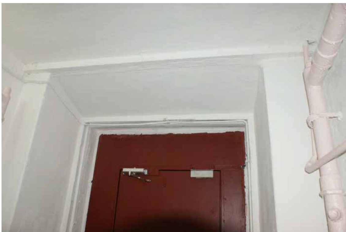
Фото 44. Лестница № 2. 1-й этаж. Вестибюль. Входная дверь. Съемка 19.04.2021 г. Трушковский В.Э.
