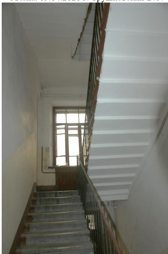
Фото 199. Лестница № 6. Вид на площадку между 2-м и 3-м этажом. Съемка 19.04.2021 г. Трушковский В.Э.
