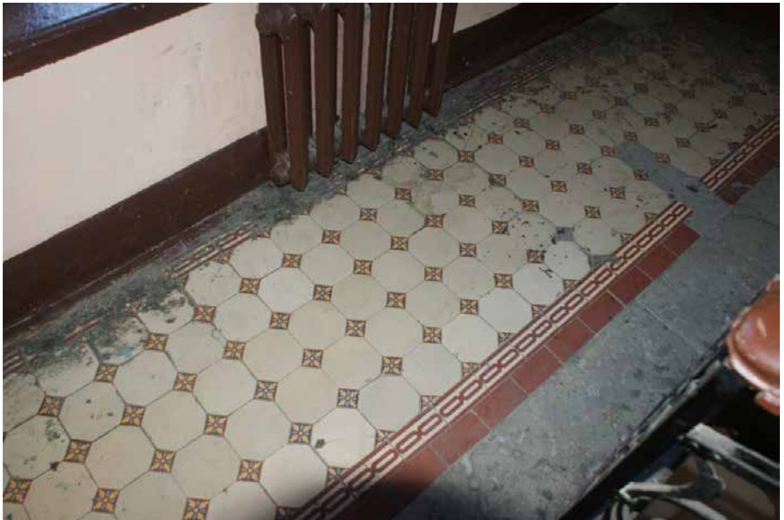
Фото 108. Лестница № 3. Площадка между 4-м и 5-м этажом. Покрытие пола. Съемка 19.04.2021 г. Трушковский В.Э.
