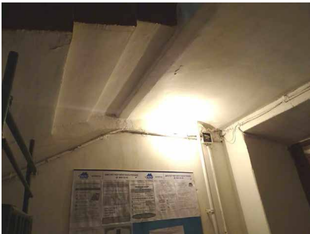
Фото 165. Лестница № 5. 1-й этаж. Вестибюль. Перекрытие. Съемка 19.04.2021 г. Трушковский В.Э.
