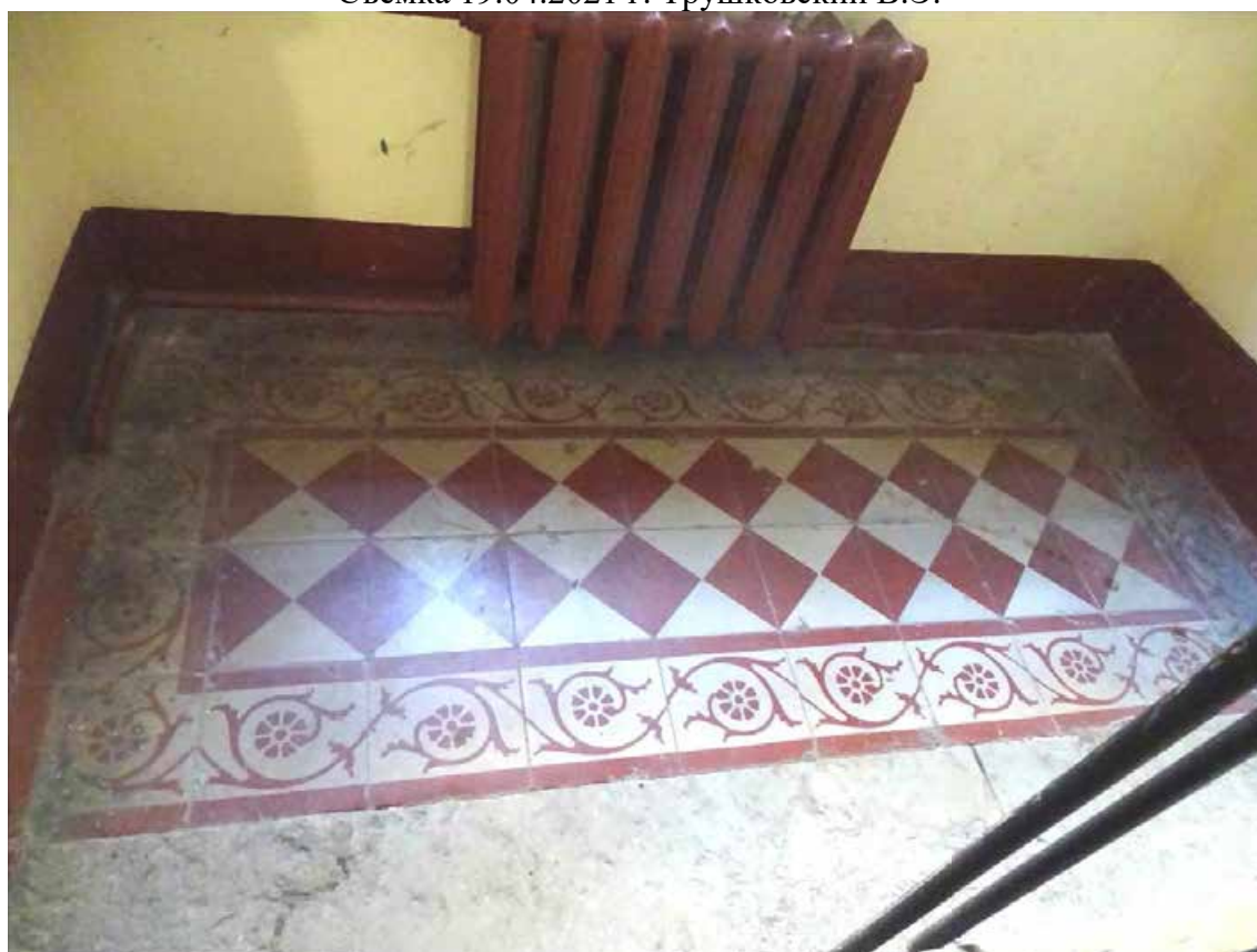
Фото 172. Лестница № 5. Площадка между 1-м и 2-м этажом. Покрытие пола. Съемка 19.04.2021 г. Трушковский В.Э.
