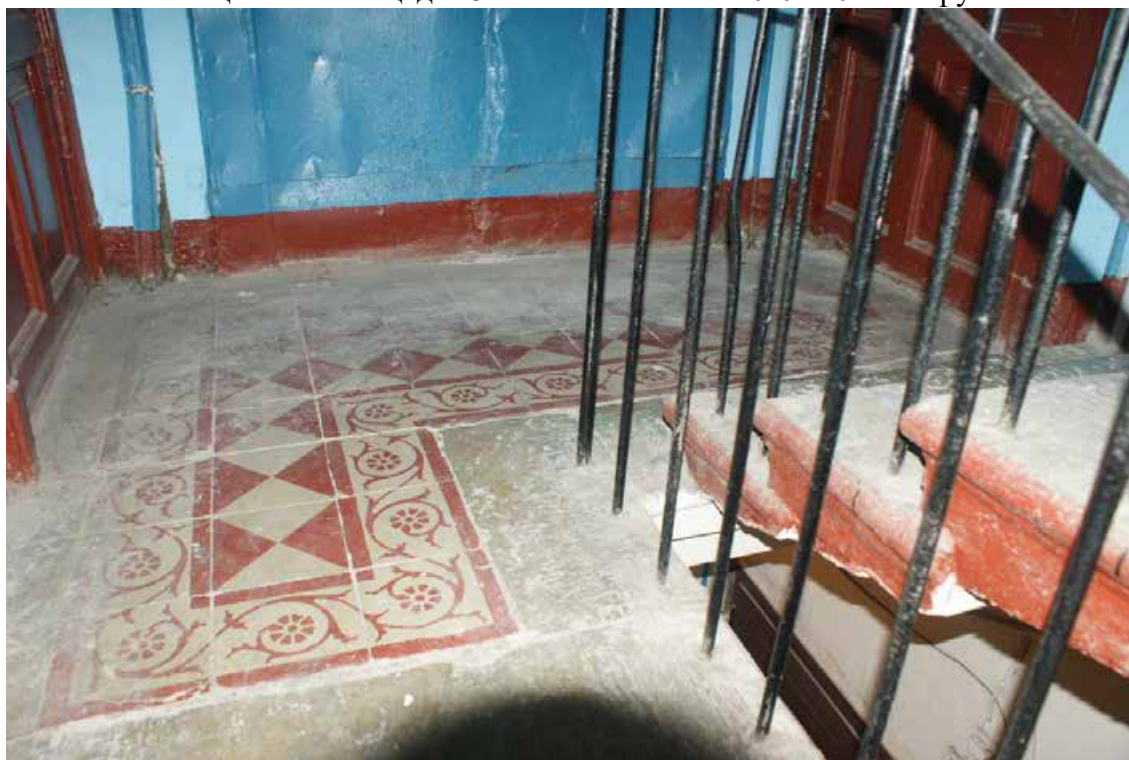
Фото 145. Лестница № 4. Площадка 3-го этажа. Покрытие пола. Съемка 19.04.2021 г. Трушковский В.Э.
