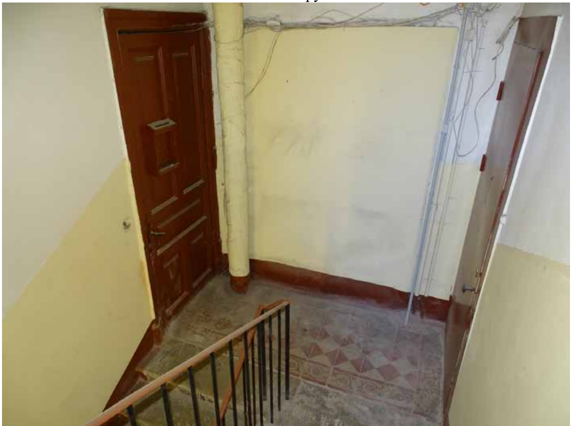
Фото 215. Лестница № 6. 5 этаж. Съемка 19.04.2021 г. Трушковский В.Э.
