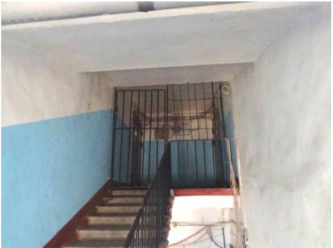
Фото 161. Лестница № 4. Вид на площадку чердачного этажа. Съемка 19.04.2021 г. Трушковский В.Э.
