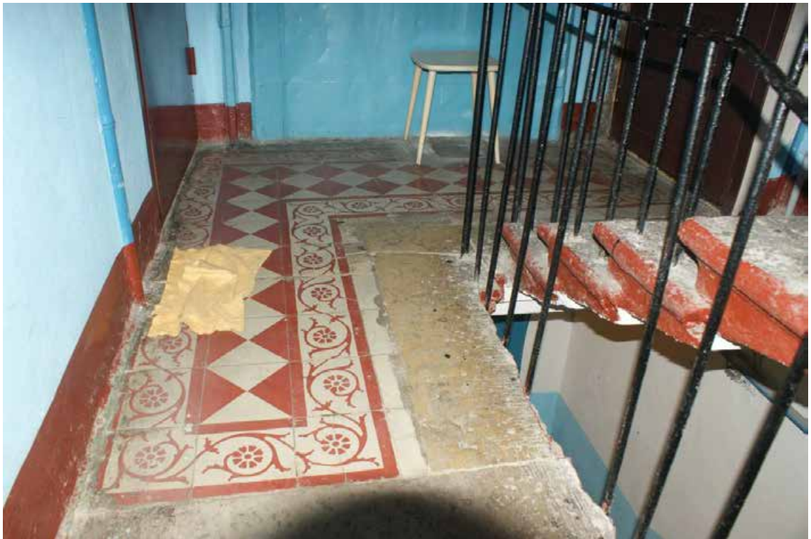
Фото 138. Лестница № 4. Площадка 2-го этажа. Покрытие пола. Съемка 19.04.2021 г. Трушковский В.Э.
