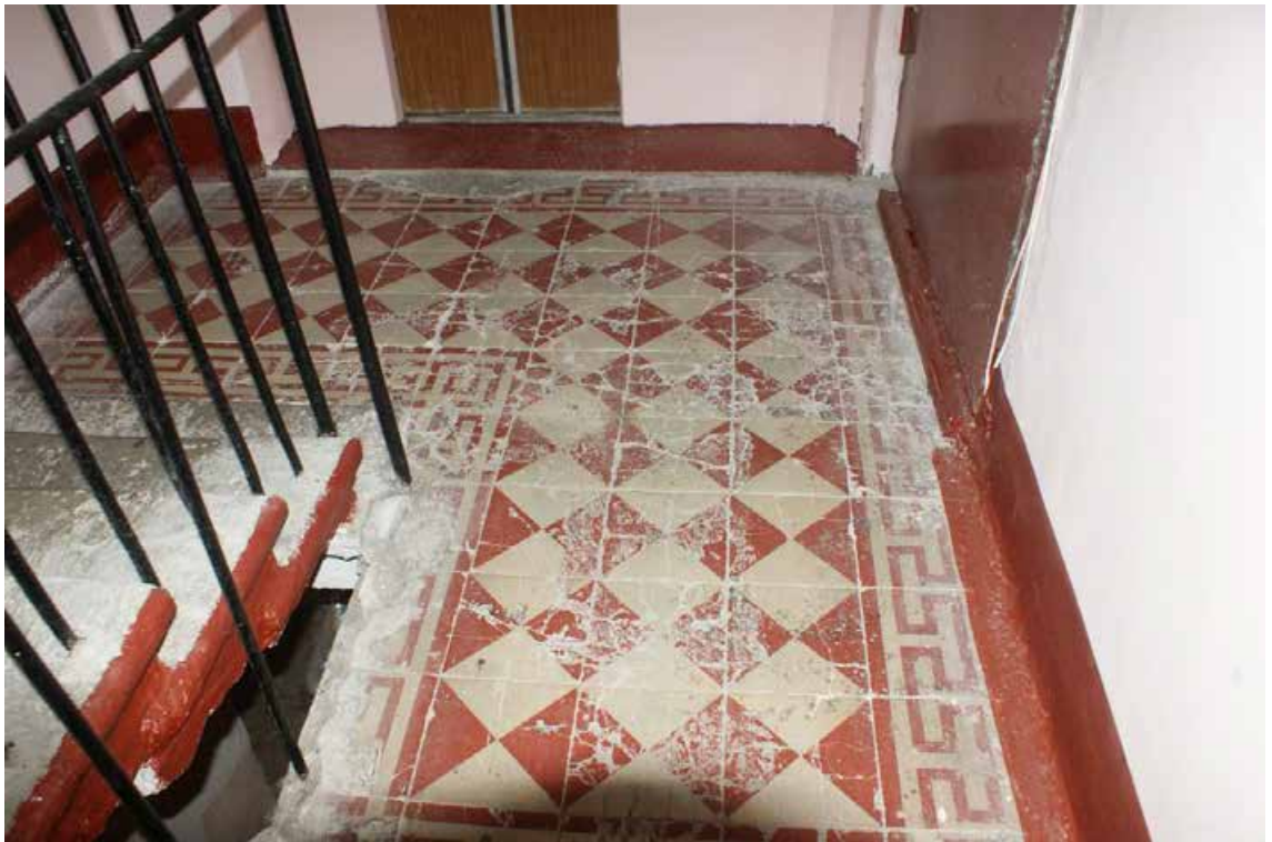
Фото 50. Лестница № 2. Площадка 1-го этажа. Покрытие пола. Съемка 19.04.2021 г. Трушковский В.Э.
