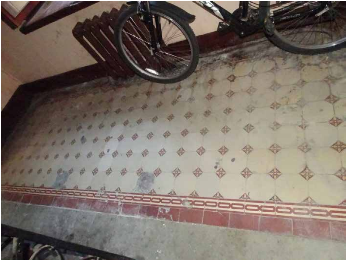
Фото 92. Лестница № 3. Площадку между 1-м и 2-м этажом. Покрытие пола. Съемка 19.04.2021 г. Трушковский В.Э.
