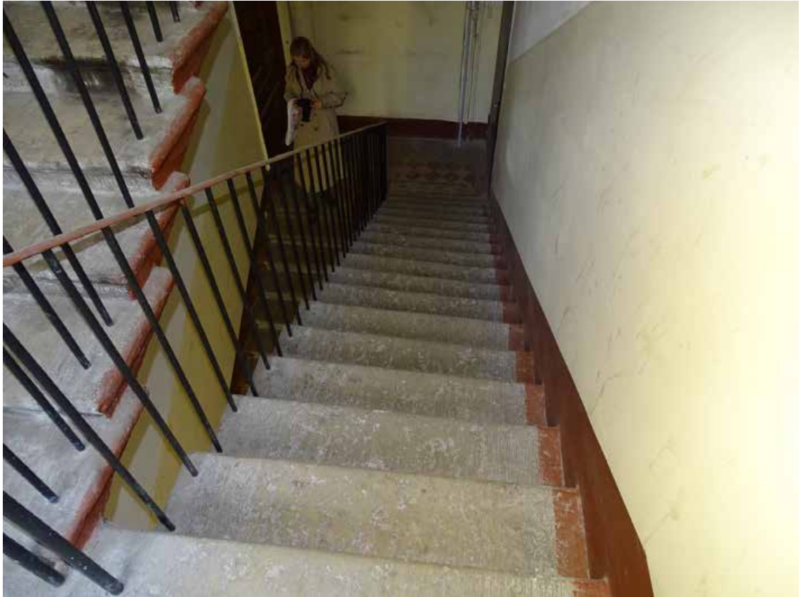
Фото 210. Лестница № 6. 4 этаж. Съёмка 19.04.2021 г. Трушковский В.Э.
