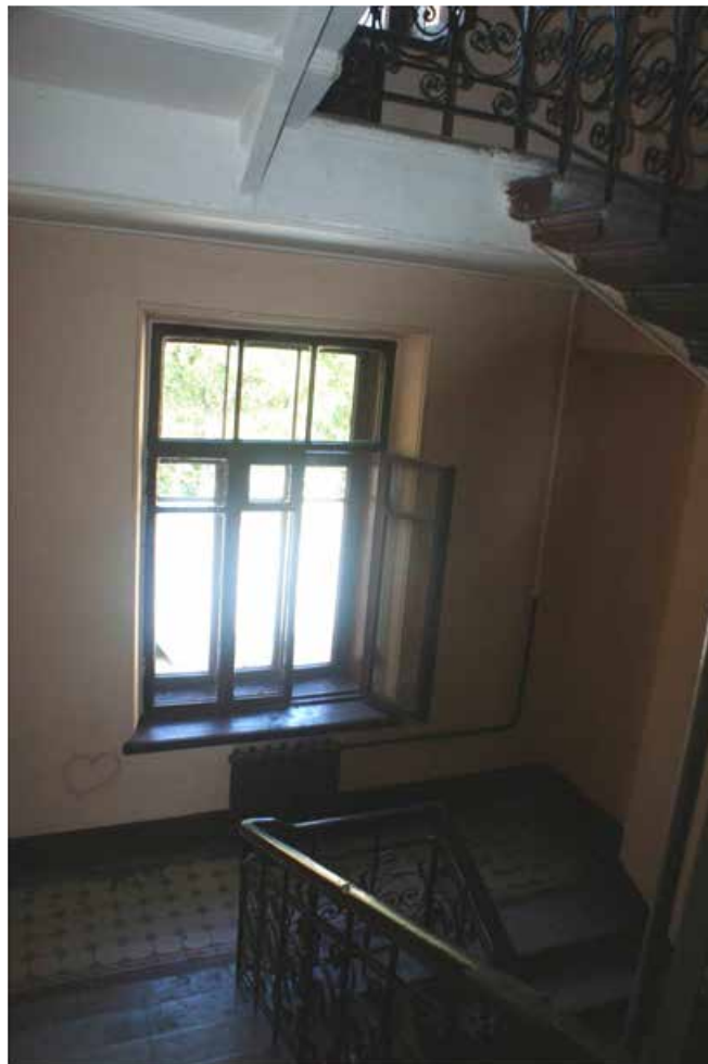
Фото 105. Лестница № 3. Вид на площадку между 4-м и 5-м этажом. Съемка 19.04.2021 г. Трушковский В.Э.
