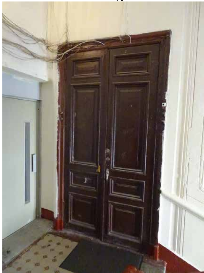
Фото 31. Лестница № 1. Площадка 4-го этажа. Заполнение дверного проема. Съемка 19.04.2021 г. Трушковский В.Э.
