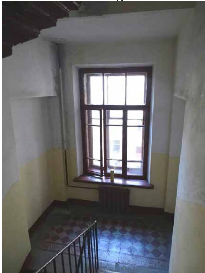
Фото 176. Лестница № 5. Вид на площадку между 2-м и 3-м этажом. Съемка 19.04.2021 г. Трушковский В.Э.
