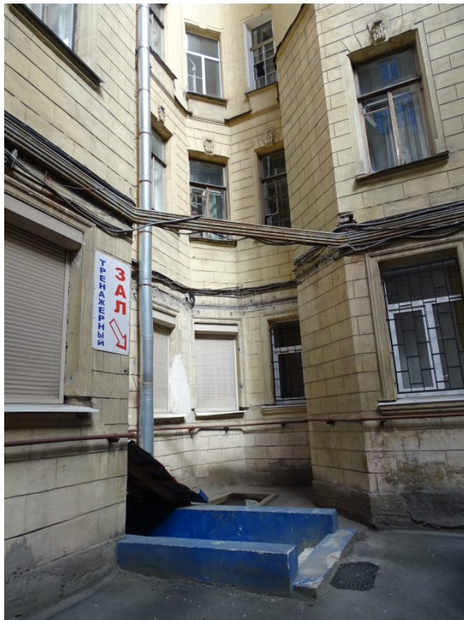
Фото 22. Здание по адресу: г. Санкт-Петербург, Средний пр. В. О., д. 11, литер А. Юго-восточный внутренний двор. Съемка 19.04.2021 г. Трушковский В.Э.
