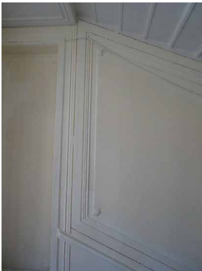
Фото 34. Лестница № 1. Площадка между 4-м и 5-м этажом. Профилированные рамы стен. Съемка 19.04.2021 г. Трушковский В.Э.
