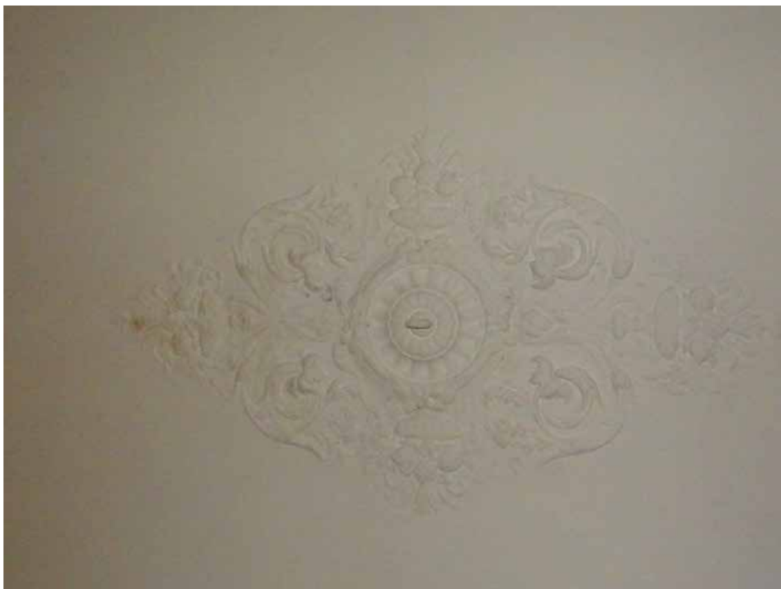
Фото 84. Лестница № 3. 1-й этаж. Вестибюль. Розетка. Съемка 19.04.2021 г. Трушковский В.Э.
