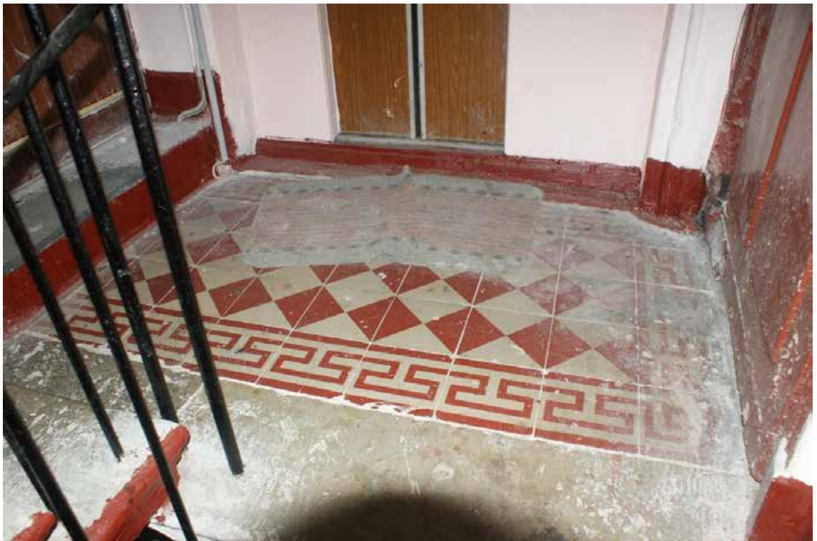
Фото 56. Лестница № 2. Площадка 2-го этажа. Покрытие пола. Съемка 19.04.2021 г. Трушковский В.Э.
