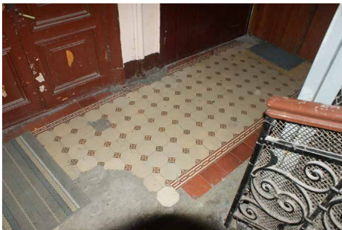
Фото 103. Лестница № 3. Площадка 4-го этажа. Покрытие пола. Съемка 19.04.2021 г. Трушковский В.Э.
