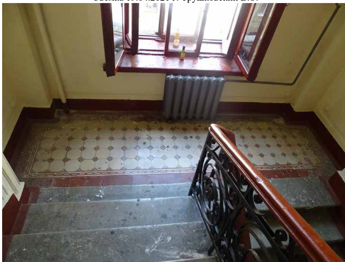
Фото 33. Лестница № 1. Площадка между 4-м и 5-м этажом. Покрытие пола. Съемка 19.04.2021 г. Трушковский В.Э.
