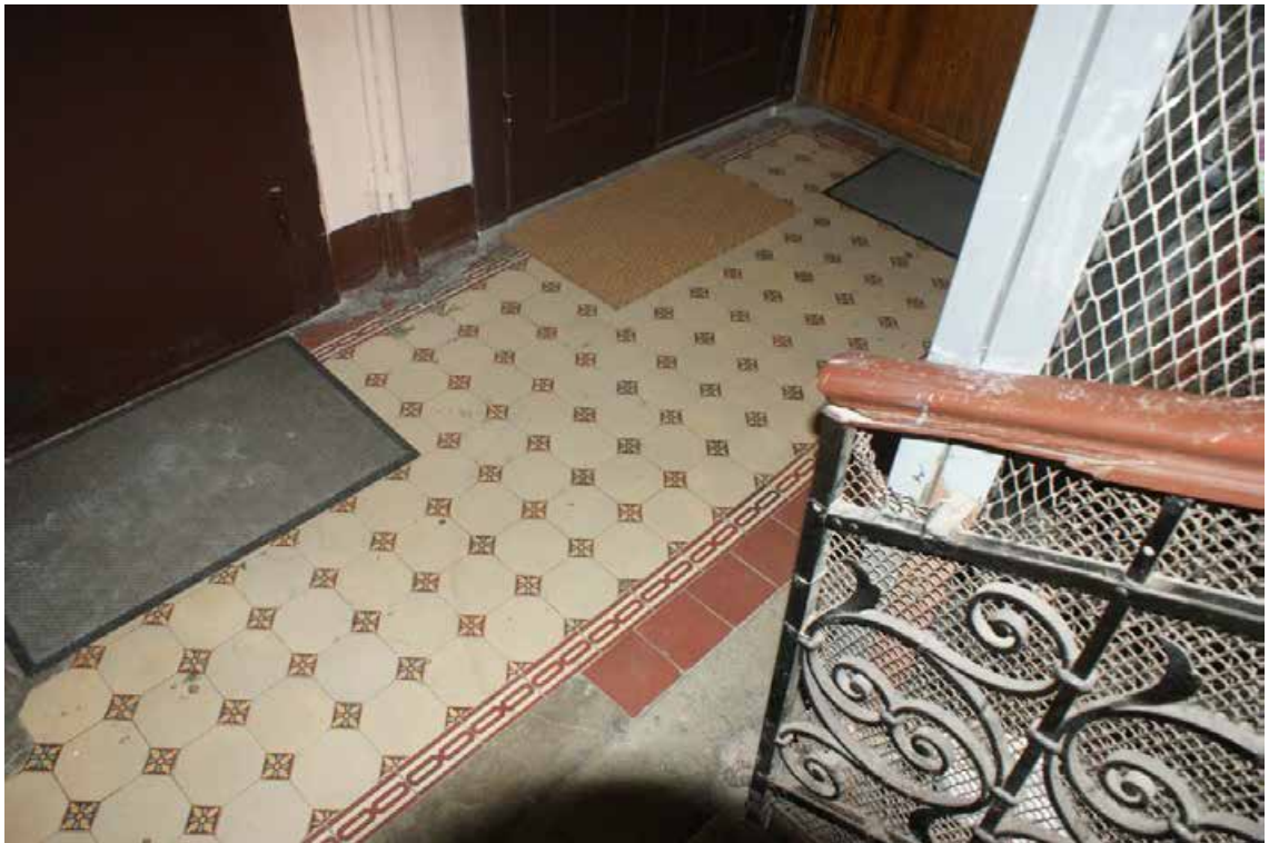
Фото 110. Лестница № 3. Площадка 5-го этажа. Покрытие пола. Съемка 19.04.2021 г. Трушковский В.Э.
