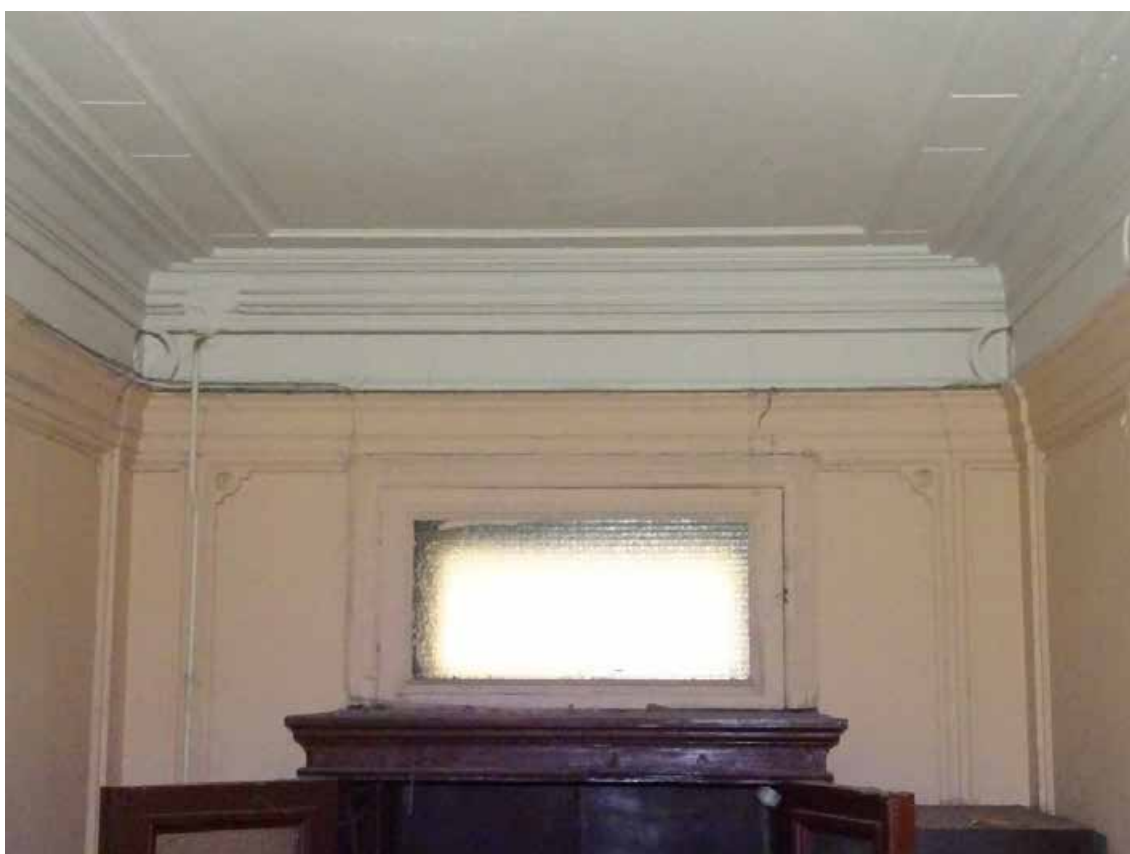
Фото 77. Лестница № 3. 1-й этаж. Вестибюль. Съёмка 19.04.2021 г. Трушковский В.Э.
