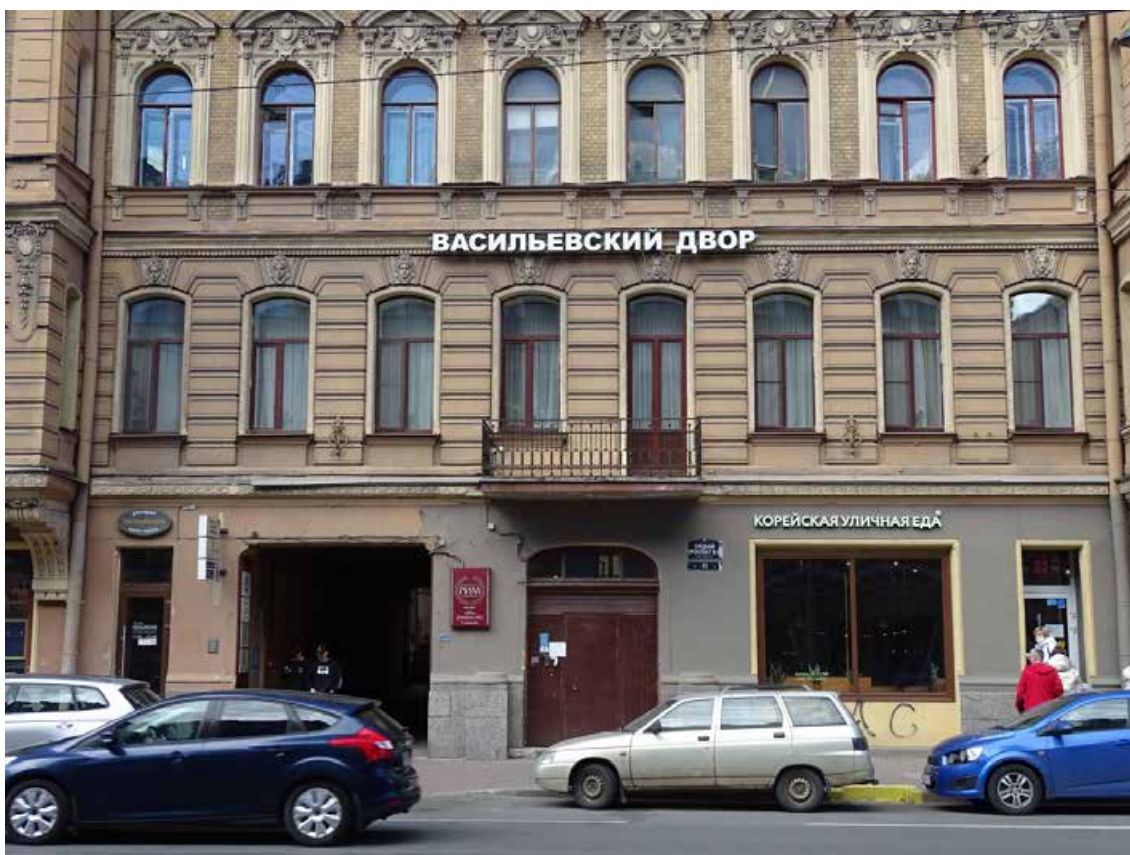
Фото 6. Здание по адресу: г. Санкт-Петербург, Средний пр. В. О., д. 11, литер А. Фрагмент лицевого фасада. Съемка 19.04.2021 г. Трушковский В.Э.
