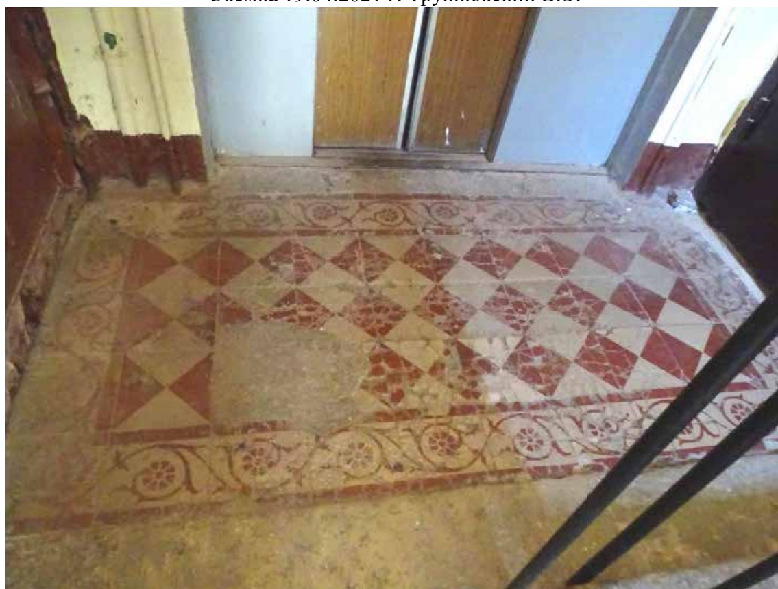
Фото 182. Лестница № 5. Площадка 4-го этажа. Покрытие пола. Съемка 19.04.2021 г. Трушковский В.Э.
