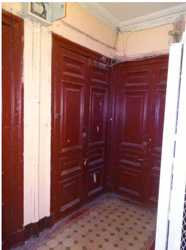
Фото 96. Лестница № 3. Площадка 2-го этажа. Съемка 19.04.2021 г. Трушковский В.Э.
