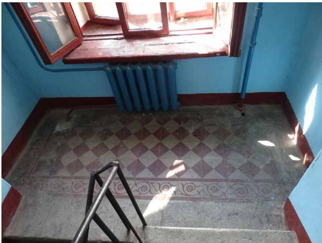
Фото 156. Лестница № 4. Площадка между 5-м и 6-м этажом. Покрытие пола. Съемка 19.04.2021 г. Трушковский В.Э.
