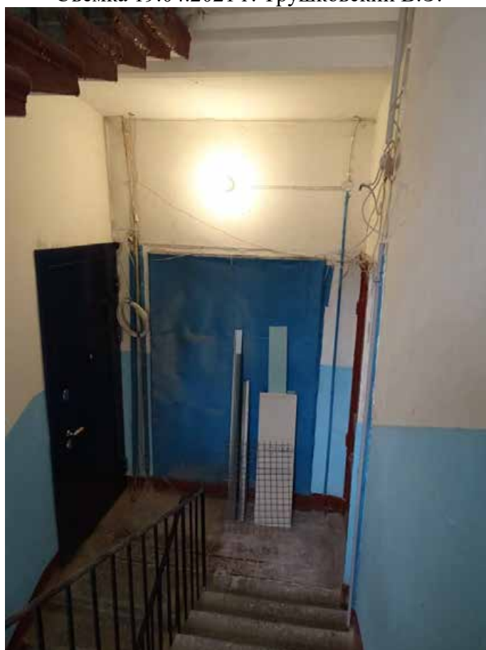
Фото 153. Лестница № 4. Вид на площадку 5-го этажа. Съемка 19.04.2021 г. Трушковский В.Э.
