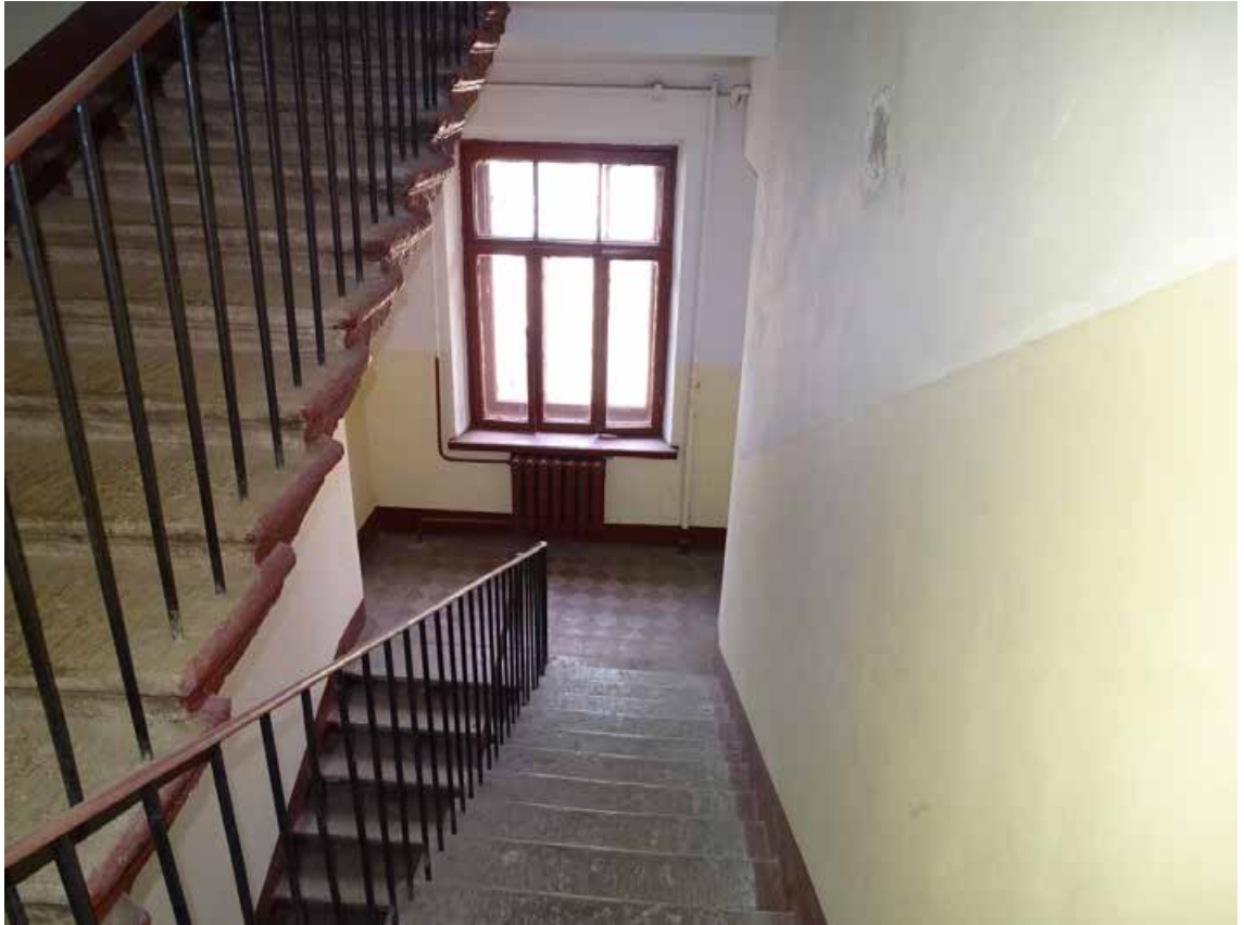
Фото 218. Лестница № 6. Вид на площадку между 5-м и 6-м этажом. Съемка 19.04.2021 г. Трушковский В.Э.
