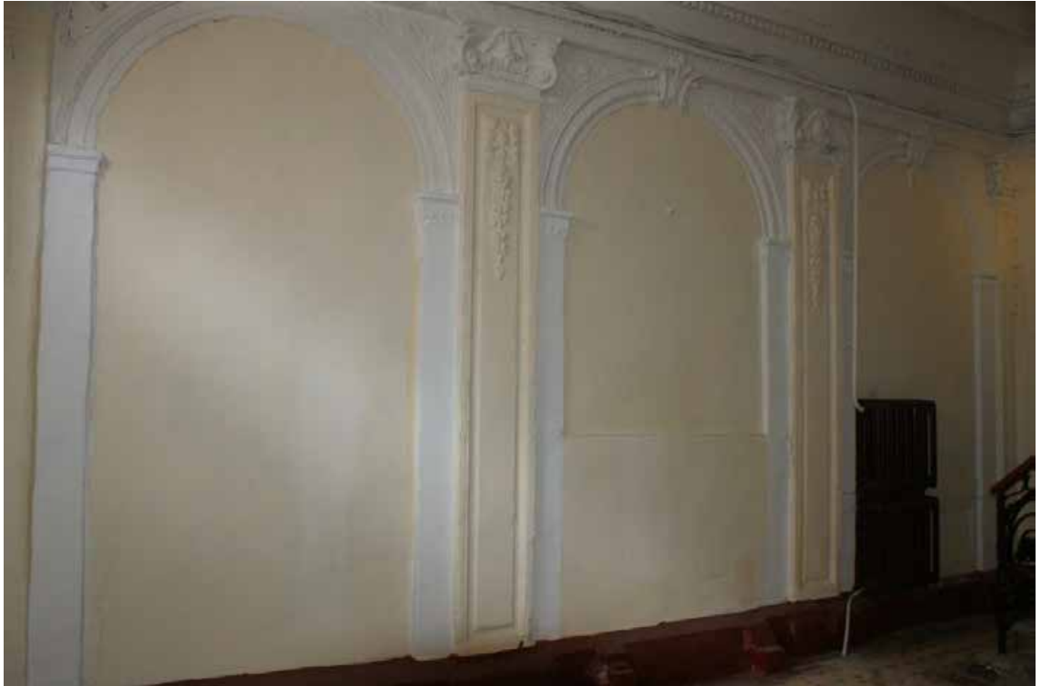
Фото 5. Лестница № 1. 1-й этаж. Вестибюль. Лепной декор стен. Съемка 19.04.2021 г. Трушковский В.Э.
