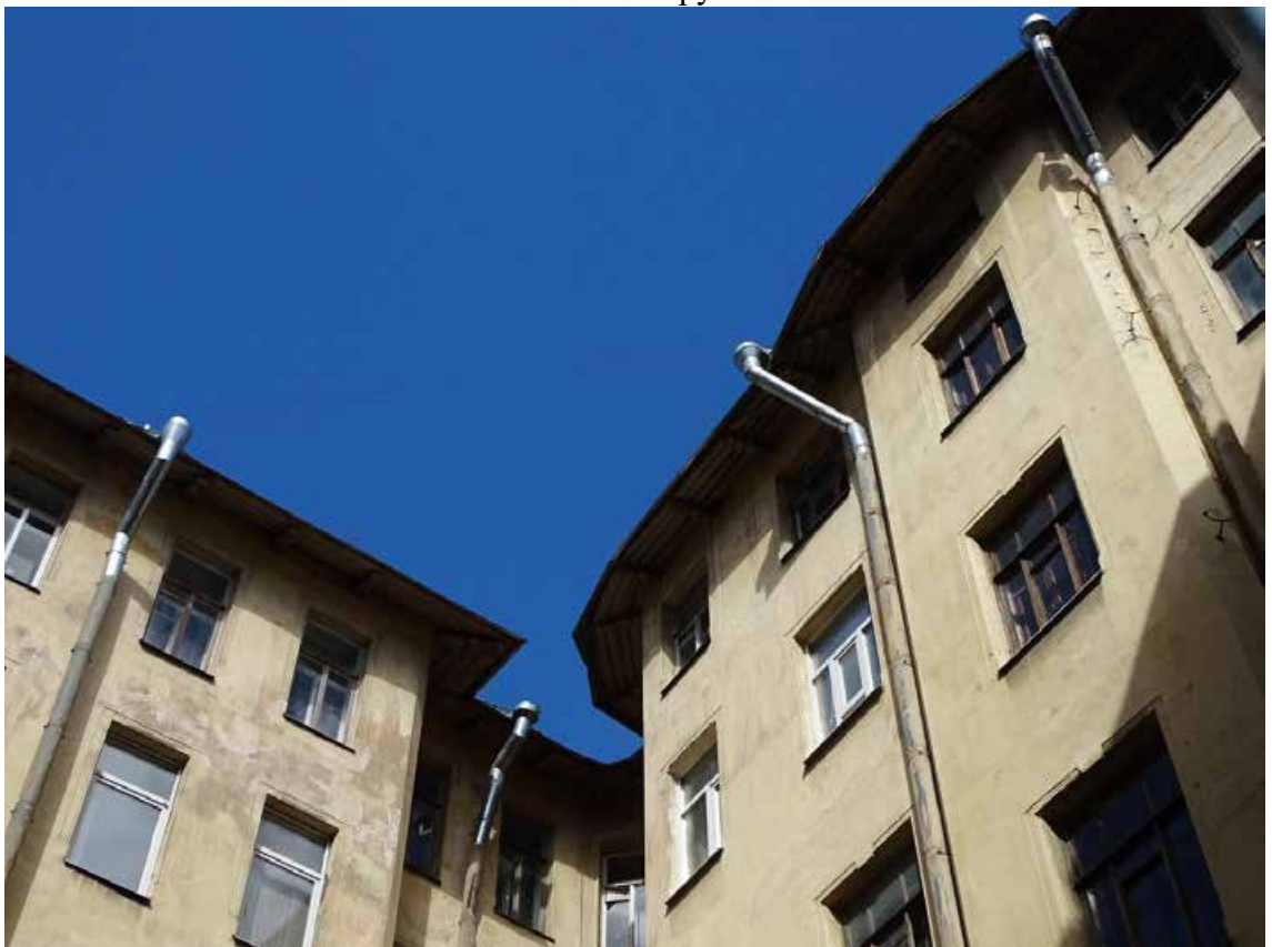
Фото 28. Здание по адресу: г. Санкт-Петербург, Средний пр. В. О., д. 11, литер А. Юго-восточный внутренний двор. Фрагмент фасада. Съемка 19.04.2021 г. Трушковский В.Э.
