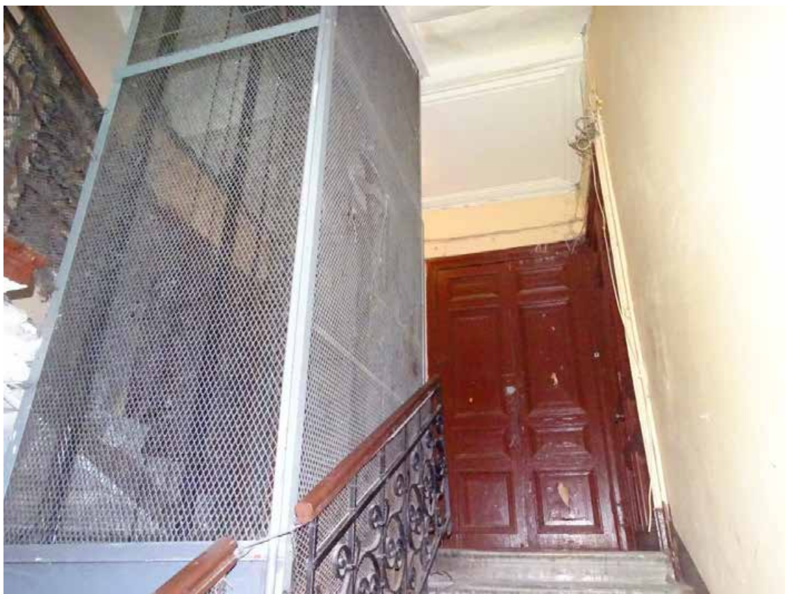
Фото 94. Лестница № 3. Вид на площадку 2-го этажа. Съемка 19.04.2021 г. Трушковский В.Э.
