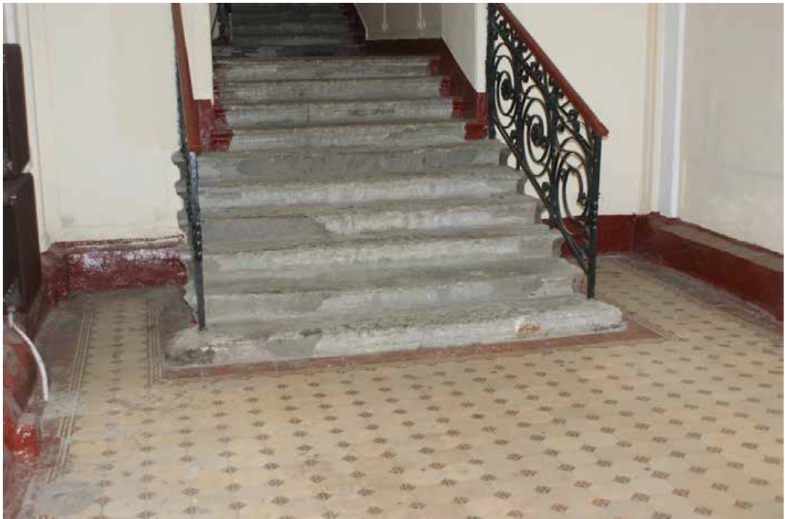
Фото 10. Лестница № 1. 1-й этаж. Вестибюль. Ступени. Съемка 19.04.2021 г. Трушковский В.Э.
