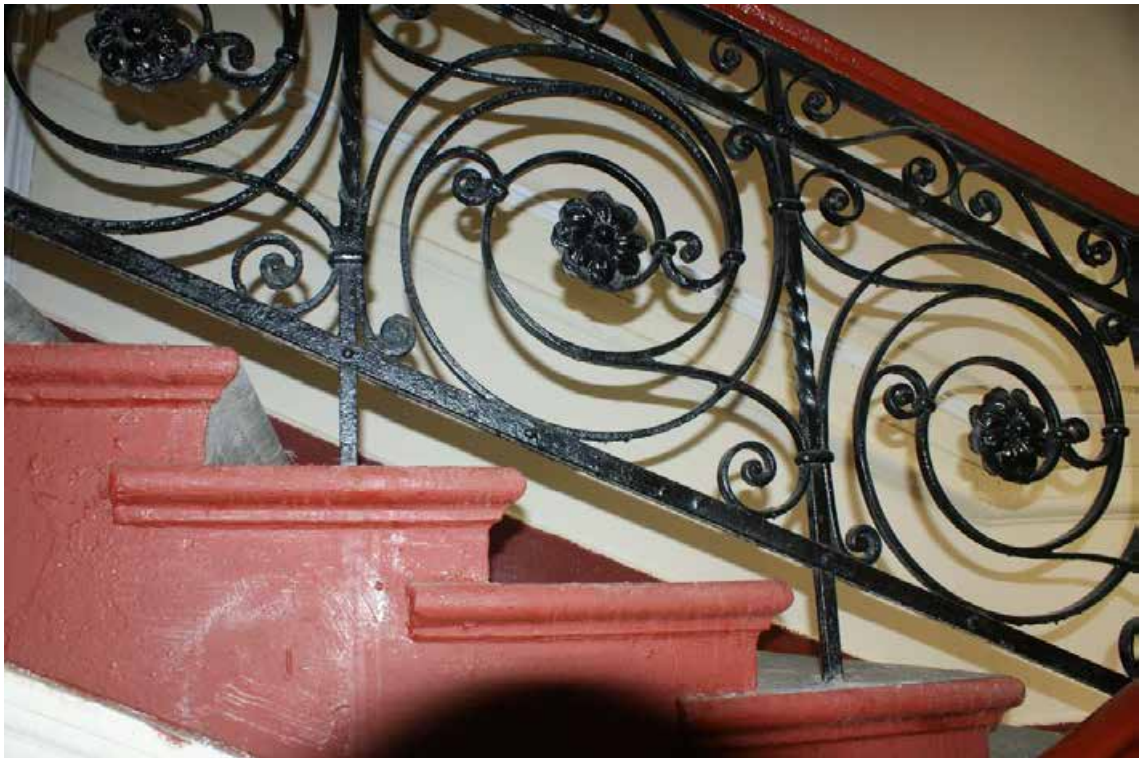
Фото 16. Лестница № 1. 1-й этаж. Вестибюль. Лестничное ограждение. Съемка 19.04.2021 г. Трушковский В.Э.
