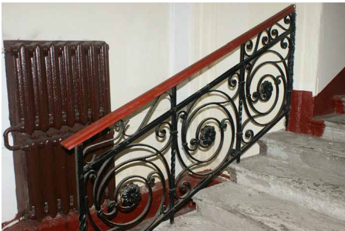
Фото 7. Лестница № 1. 1-й этаж. Вестибюль. Лестничное ограждение. Съемка 19.04.2021 г. Трушковский В.Э.
