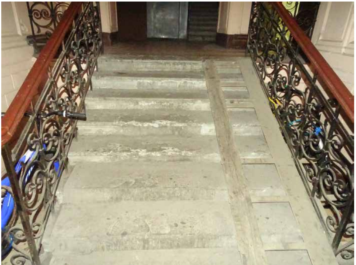
Фото 87. Лестница № 3. 1-й этаж. Вестибюль. Ступени. Съемка 19.04.2021 г. Трушковский В.Э.
