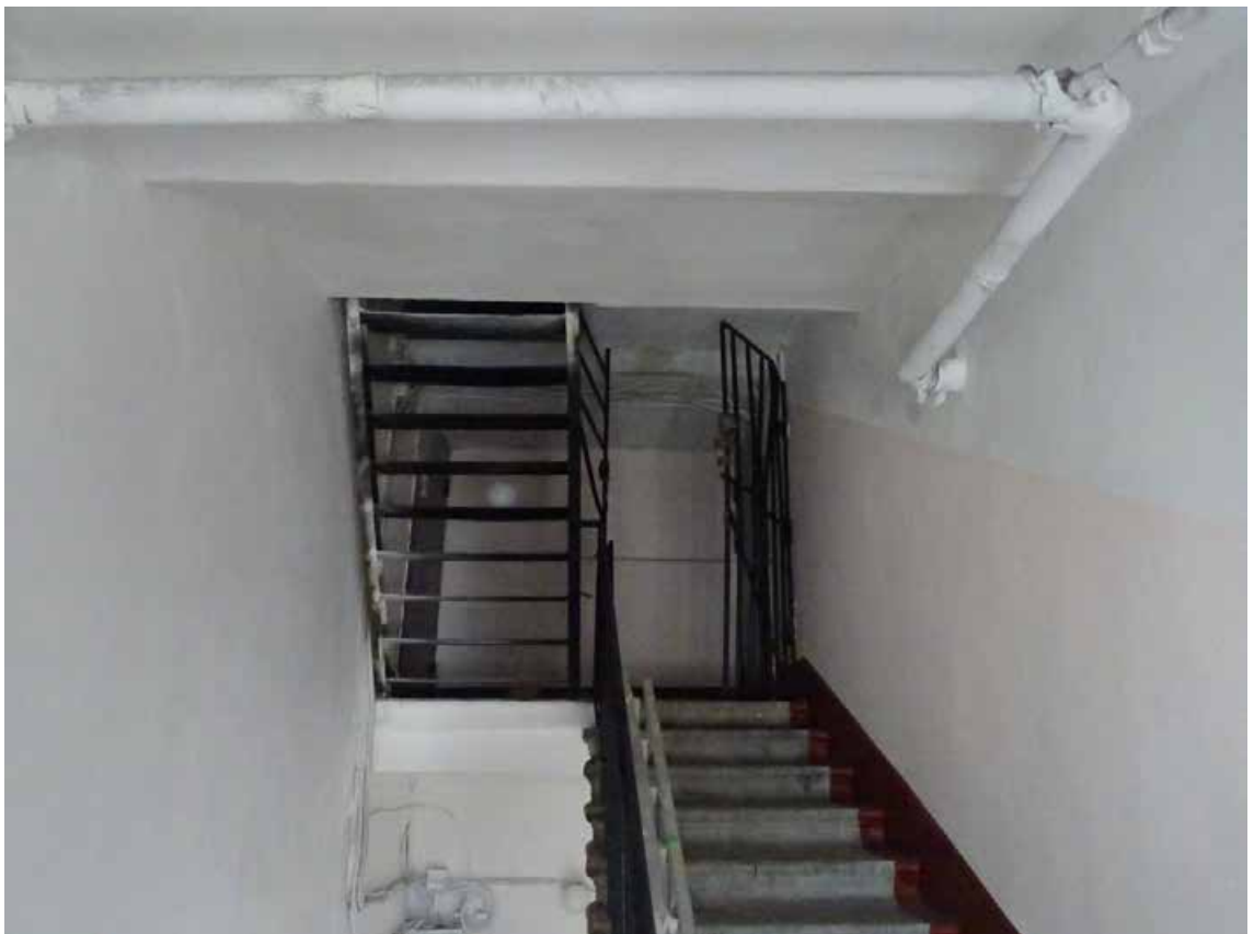
Фото 75. Лестница № 2. Чердачный этаж. Съемка 19.04.2021 г. Трушковский В.Э.
