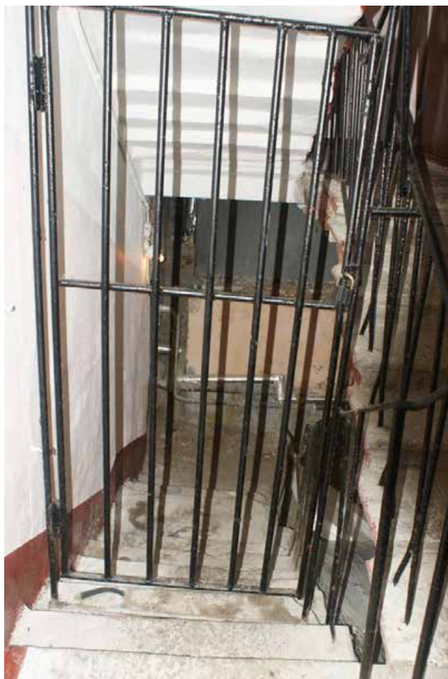
Фото 46. Лестница № 2. Подвальный этаж. Съемка 19.04.2021 г. Трушковский В.Э.
