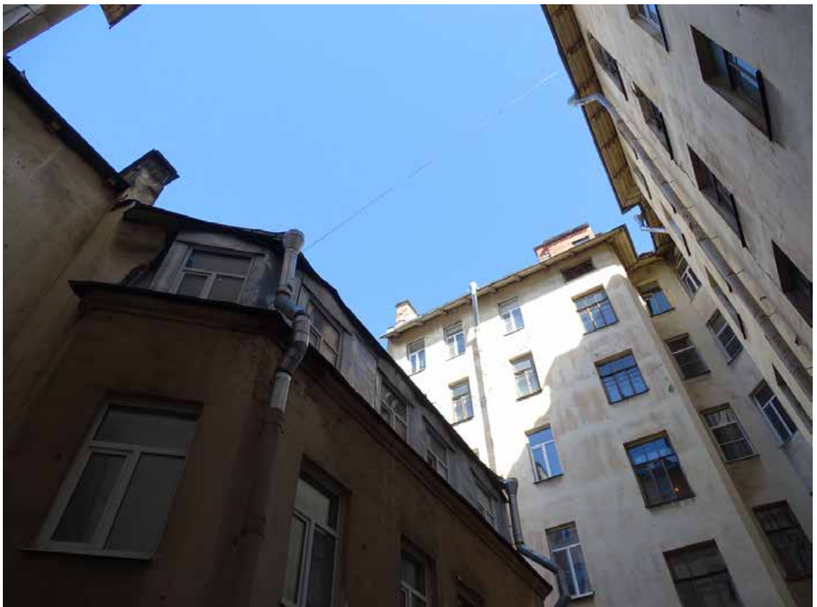
Фото 44. Здание по адресу: г. Санкт-Петербург, Средний пр. В. О., д. 11, литер А. Фрагмент фасада. Северо-западный двор. Съемка 19.04.2021 г. Трушковский В.Э.
