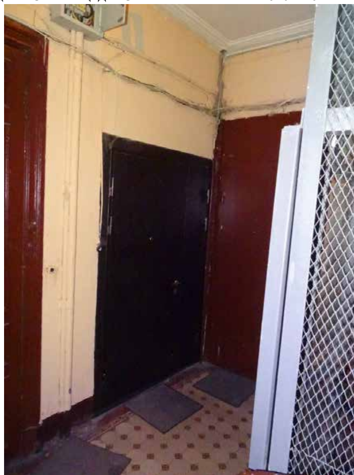
Фото 99. Лестница № 3. Площадка 3-го этажа. Съемка 19.04.2021 г. Трушковский В.Э.
