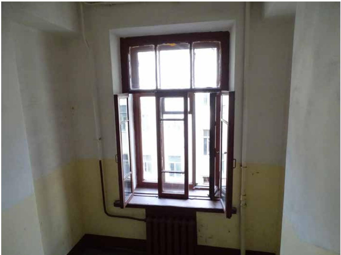
Фото 213. Лестница № 6. Вид на площадку между 4-м и 5-м этажом. Оконное заполнение. Съемка 19.04.2021 г. Трушковский В.Э.
