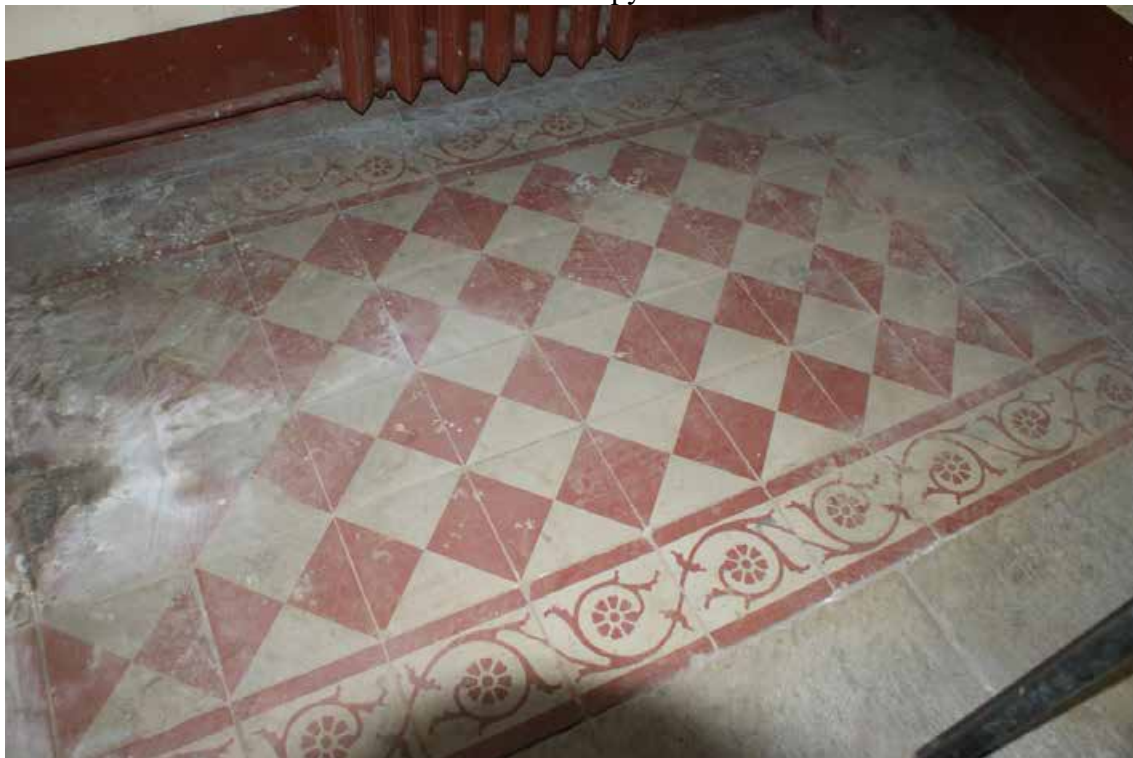
Фото 206. Лестница № 6. Вид на площадку между 3-м и 4-м этажом. Оформление пола. Съемка 19.04.2021 г. Трушковский В.Э.
