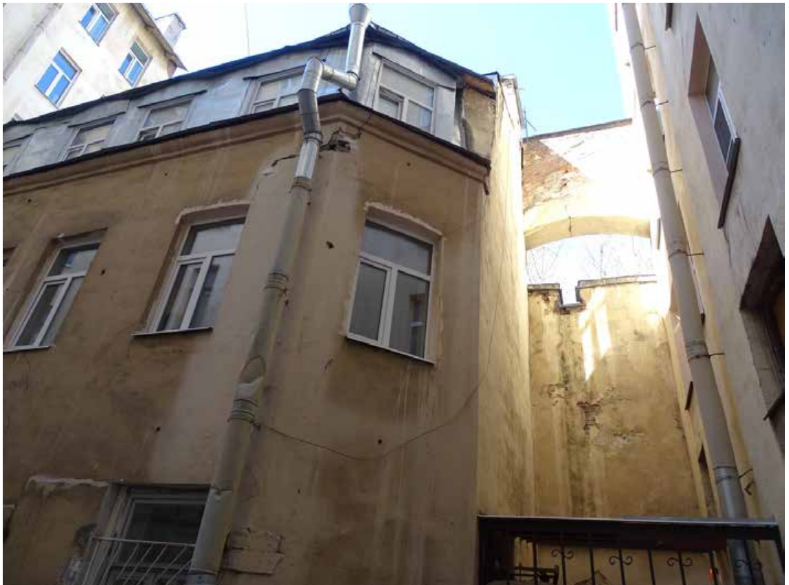
Фото 45. Здание по адресу: г. Санкт-Петербург, Средний пр. В. О., д. 11, литер А. Фрагмент фасада. Северо-западный двор. Съемка 19.04.2021 г. Трушковский В.Э.
