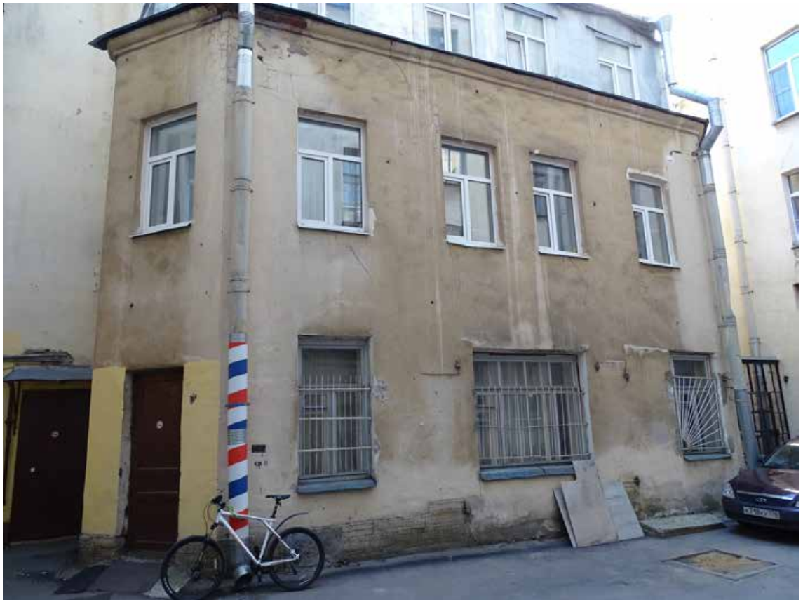
Фото 43. Здание по адресу: г. Санкт-Петербург, Средний пр. В. О., д. 11, литер А. Флигель. Северо-западный двор. Съемка 19.04.2021 г. Трушковский В.Э.
