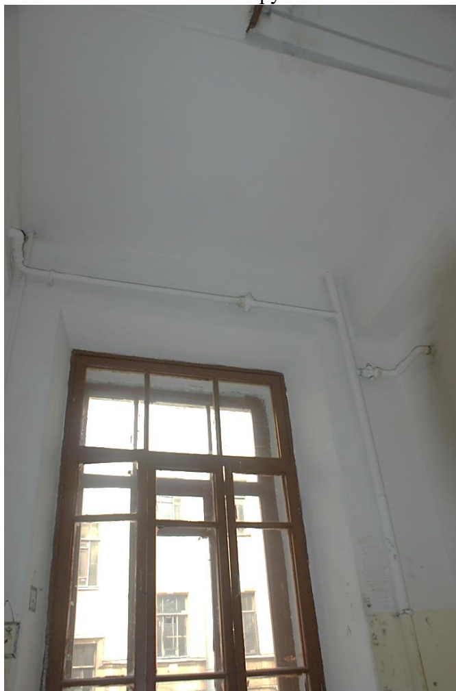
Фото 201. Лестница № 6. Вид на площадку между 2-м и 3-м этажом. Оконное заполнение. Съемка 19.04.2021 г. Трушковский В.Э.
