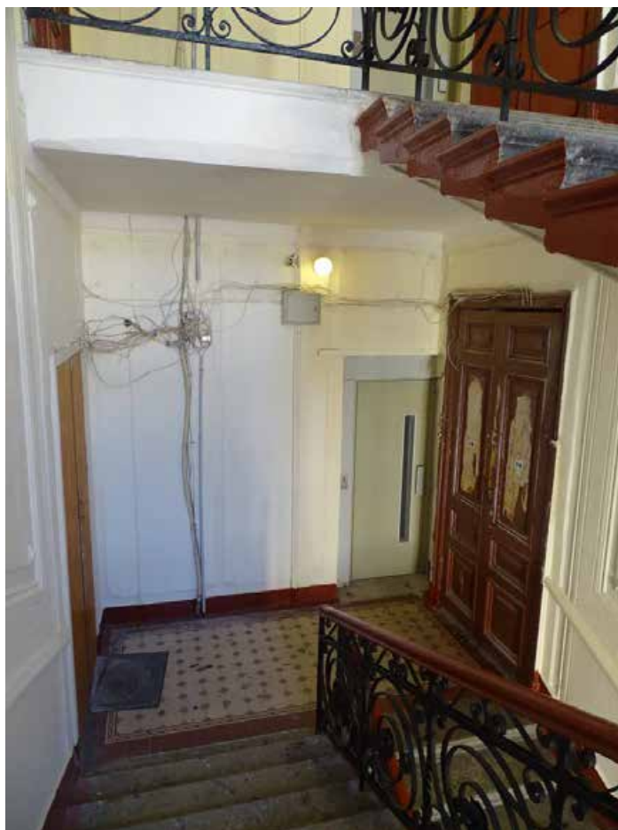
Фото 36. Лестница № 1. Вид на площадку 5-го этажа. Съемка 19.04.2021 г. Трушковский В.Э.
