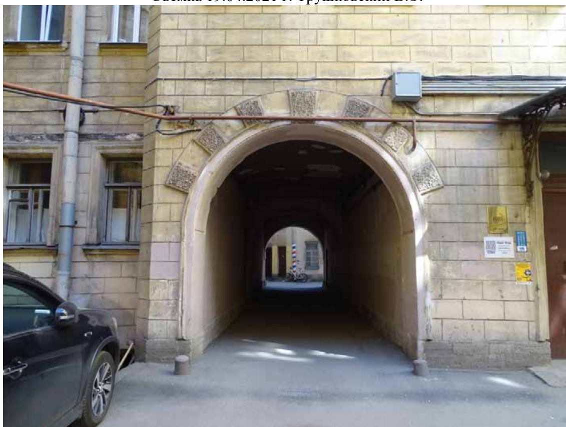
Фото 18. Здание по адресу: г. Санкт-Петербург, Средний пр. В. О., д. 11, литер А. Юго-восточный внутренний двор. Воротный проезд поперечного корпуса. Съемка 19.04.2021 г. Трушковский В.Э.
