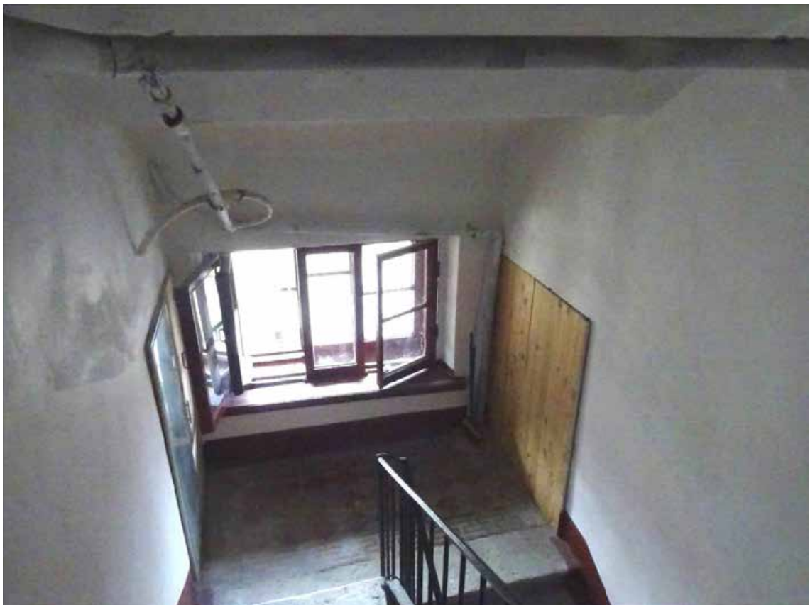
Фото 71. Лестница № 2. Вид на площадку между 5-м и 6-м этажом. Съемка 19.04.2021 г. Трушковский В.Э.
