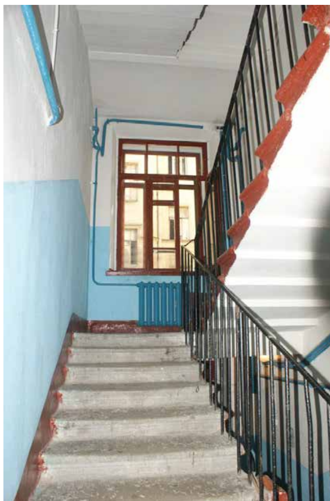
Фото 133. Лестница № 4. Вид на площадку между 1-м и 2-м этажом. Съемка 19.04.2021 г. Трушковский В.Э.
