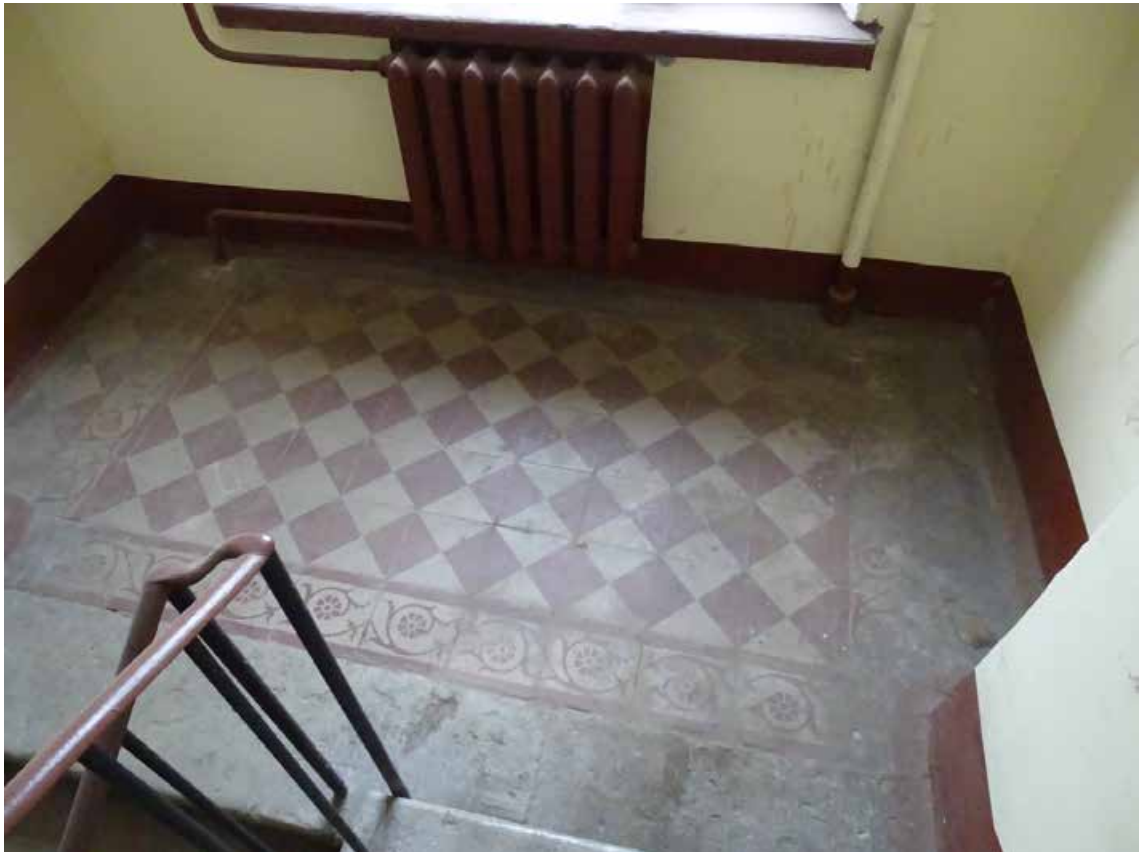
Фото 219. Лестница № 6. Вид на площадку между 5-м и 6-м этажом. Оформление пола. Съемка 19.04.2021 г. Трушковский В.Э.
