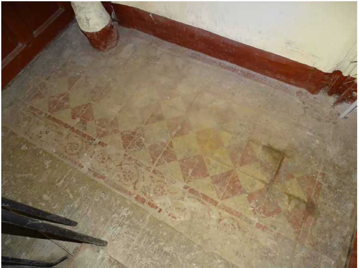
Фото 222. Лестница № 6. 6 этаж. Оформление пола. Съемка 19.04.2021 г. Трушковский В.Э.
