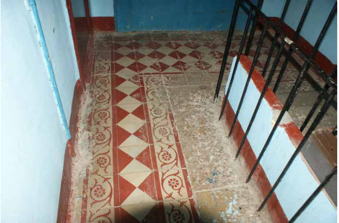
Фото 130. Лестница № 4. Площадка 1-го этажа. Покрытие пола. Съемка 19.04.2021 г. Трушковский В.Э.
