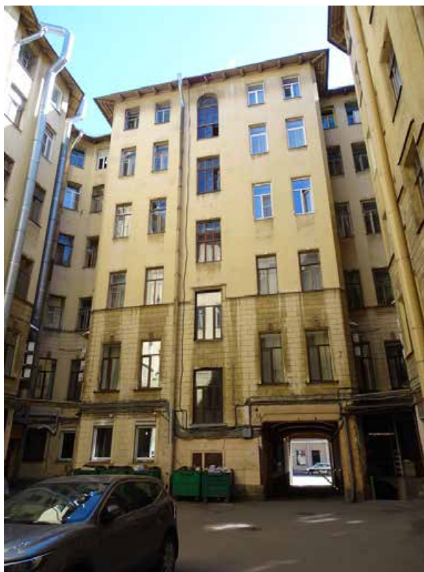
Фото 33. Здание по адресу: г. Санкт-Петербург, Средний пр. В. О., д. 11, литер А. Юго-восточный внутренний двор. Дворовой фасад лицевого корпуса. Съемка 19.04.2021 г. Трушковский В.Э.
