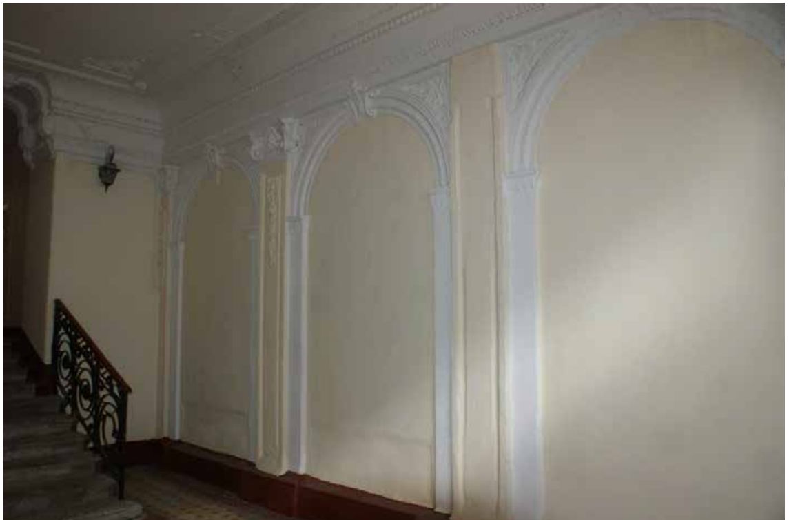
Фото 4. Лестница № 1. 1-й этаж. Вестибюль. Лепной декор стен. Съемка 19.04.2021 г. Трушковский В.Э.
