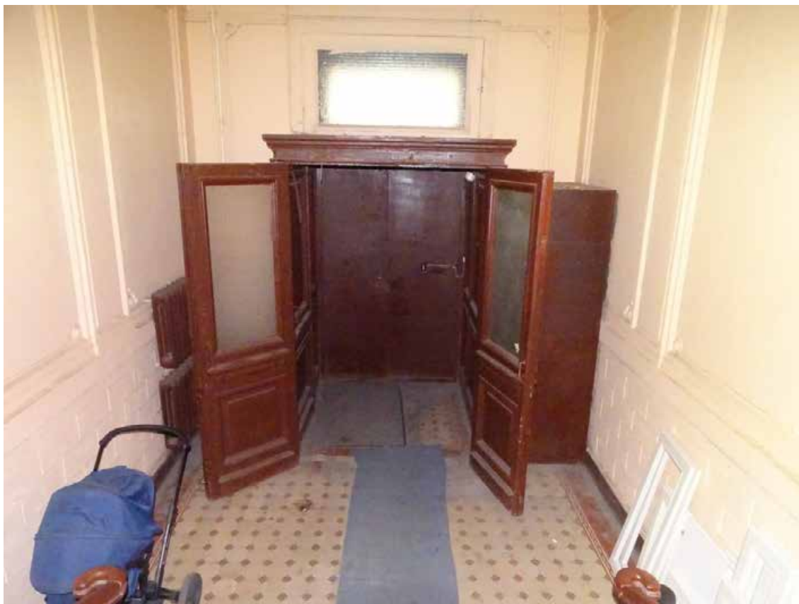
Фото 76. Лестница № 3. 1-й этаж. Вестибюль. Съёмка 19.04.2021 г. Трушковский В.Э.
