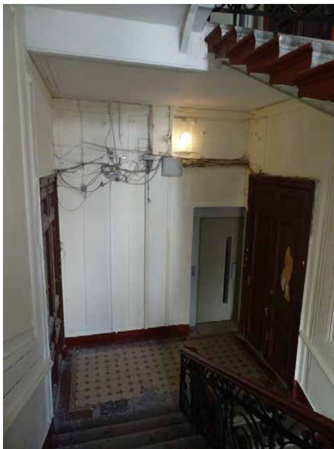
Фото 24. Лестница № 1. Вид на площадку 3-го этажа. Съемка 19.04.2021 г. Трушковский В.Э.
