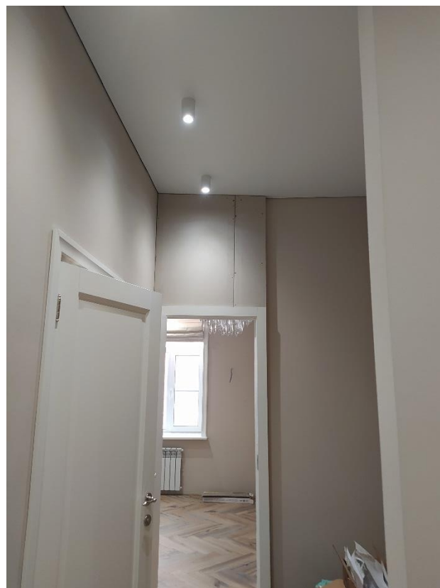
Фото 15. Вид на часть коридора (пом. 1) и вход в душевую (слева, пом. 4) и вход на кухню (прямо, пом. 5).
