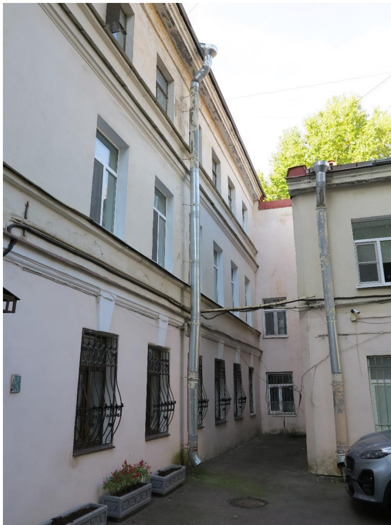
Фото 6. Вид на северо-восточный дворовый фасад трёхэтажного западного корпуса здания.
