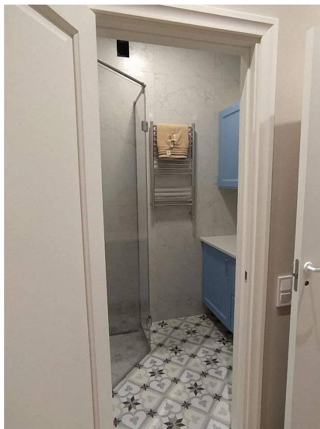
Фото 13. Вид на пом. душевой (пом. 4)
