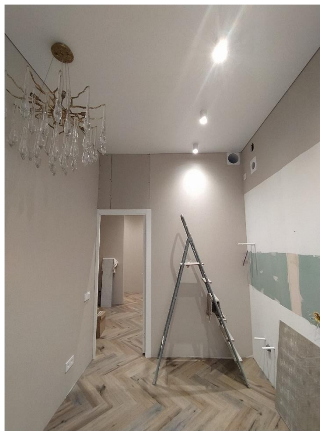
Фото 17. Вид на кухню (пом. 1) от окна.
