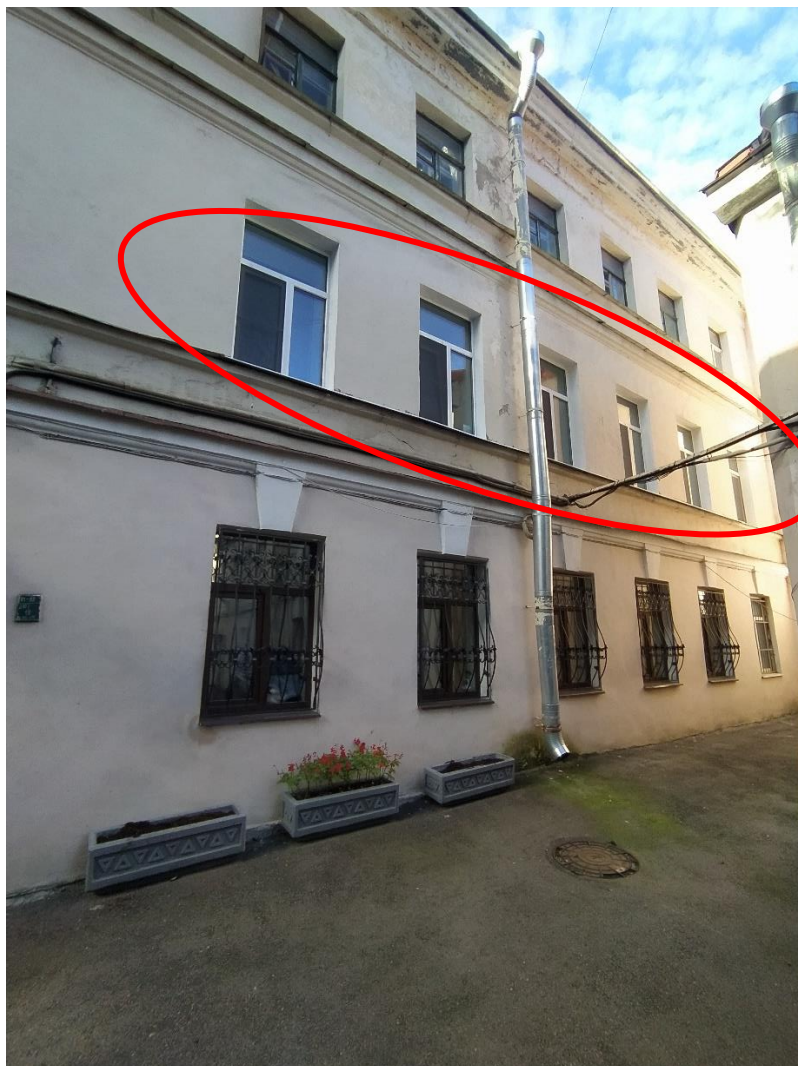
Фото 7. Вид на окна квартиры № 63 на фасаде трёхэтажного западного корпуса здания.
