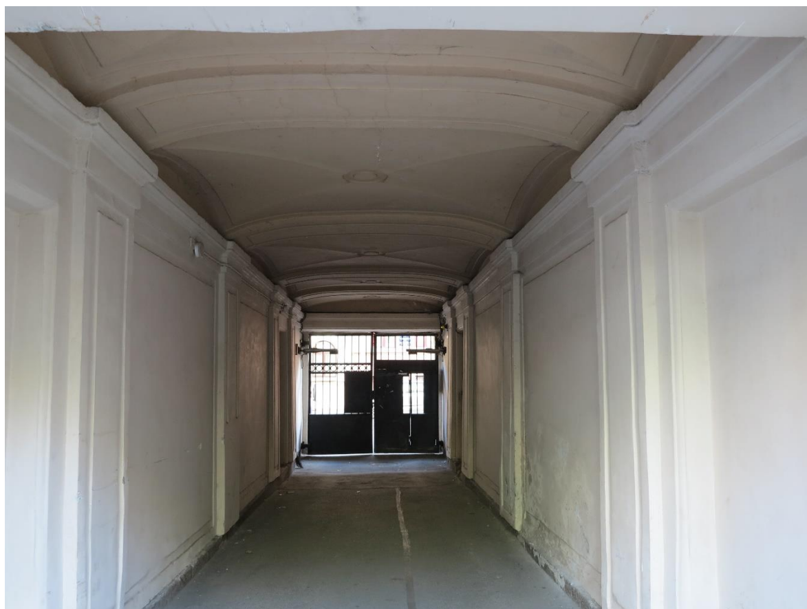
Фото 3. Воротный проезд. Вид со стороны дворового фасада здания.
