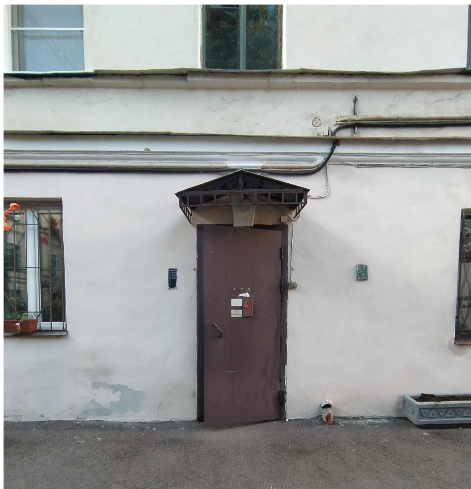
Фото 8. Северо-восточный фасад трёхэтажного дворового корпуса здания. Вход в подъезд (ЛК № 4).
