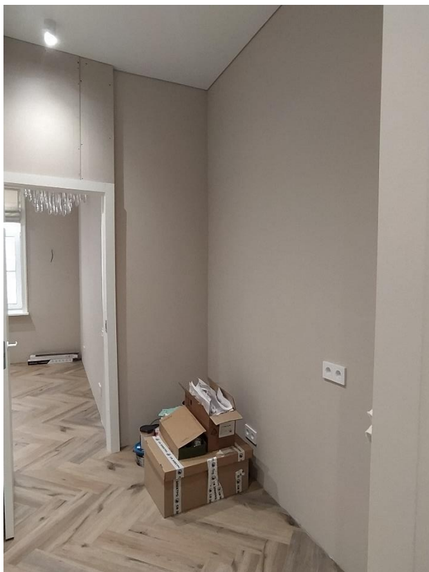
Фото 14. Вид на нишу и коридоре (пом. 1).
