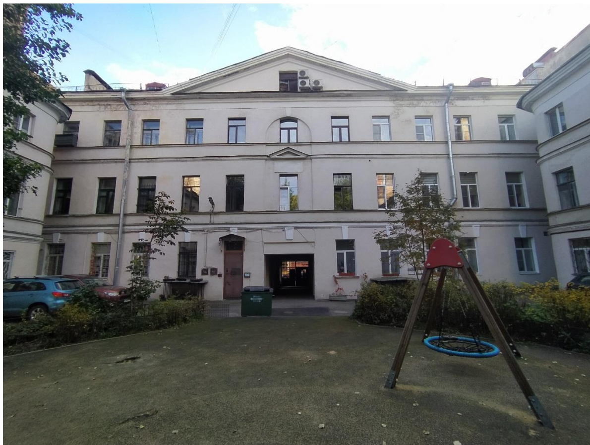
Фото 2. Северный фасад лицевого корпуса здания (со стороны двора).
