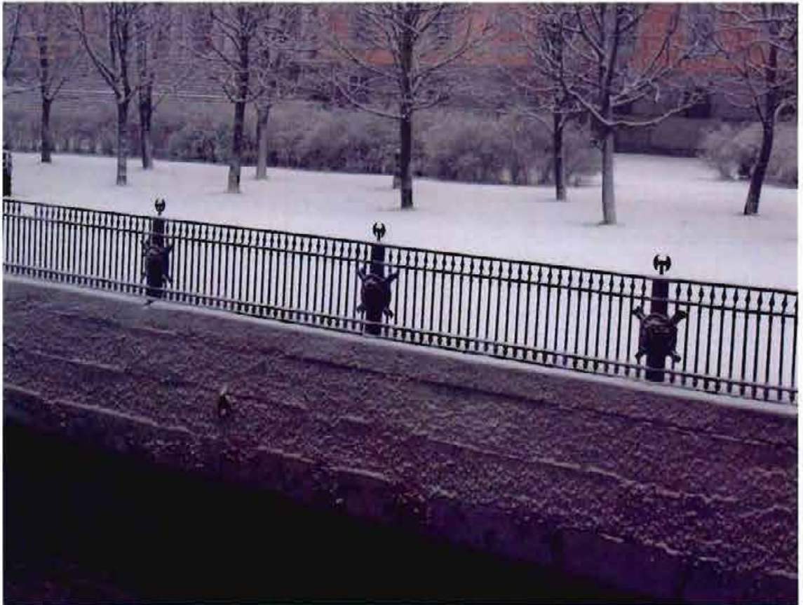
3. Ограждение набережной со стороны Михайловского (Инженерного) замка
