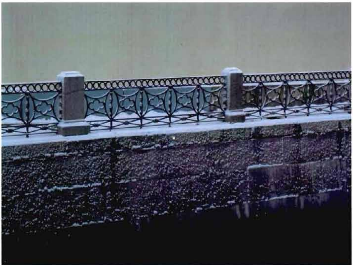
6. Ограждение набережной. Левобережная стенка
