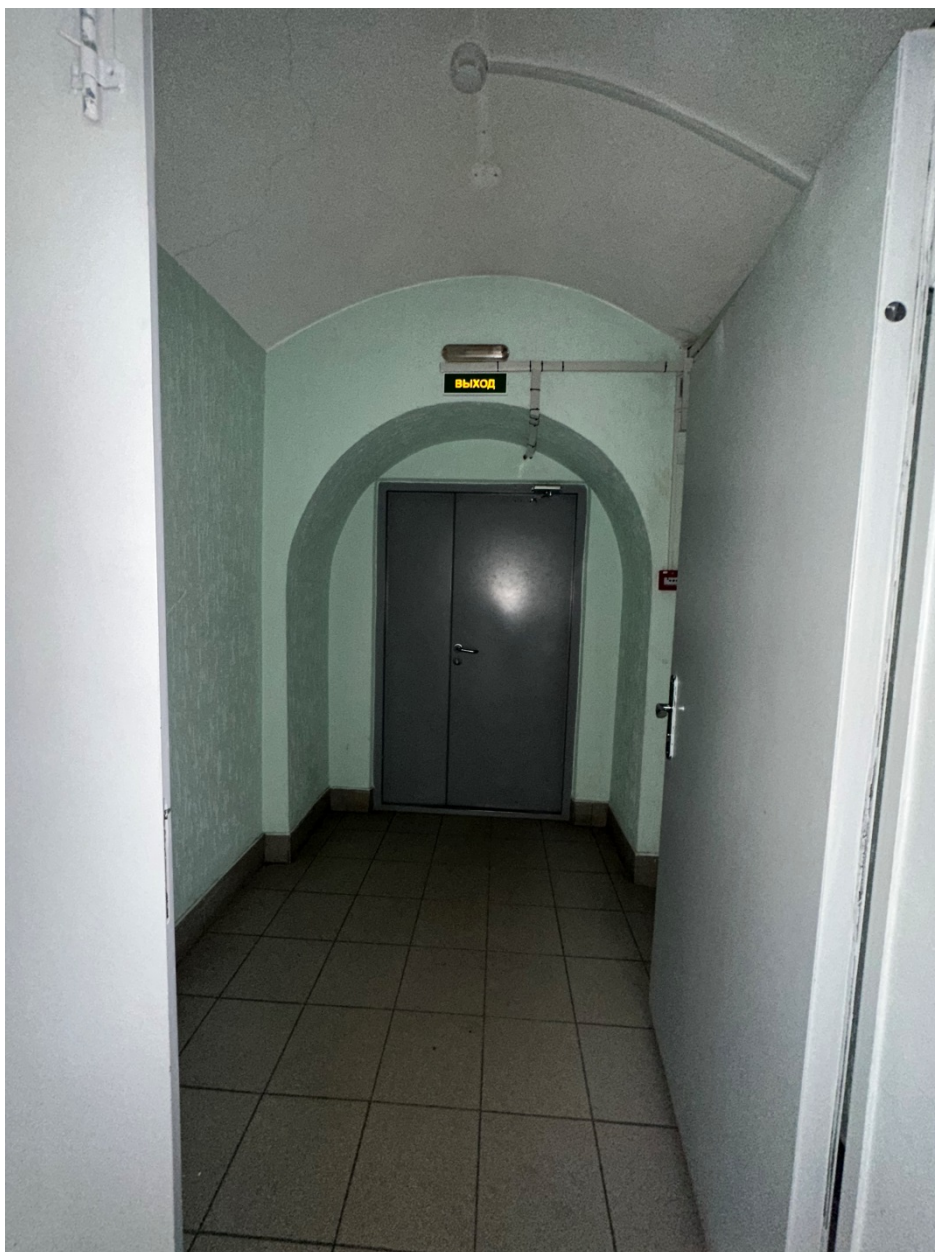
Фото 46. 4-ый этаж. Пом. 4.18. Южная часть помещения. Фото с севера. Дата съемки: 28.02.2025 г. Автор съемки: Глинская Н.Б.
