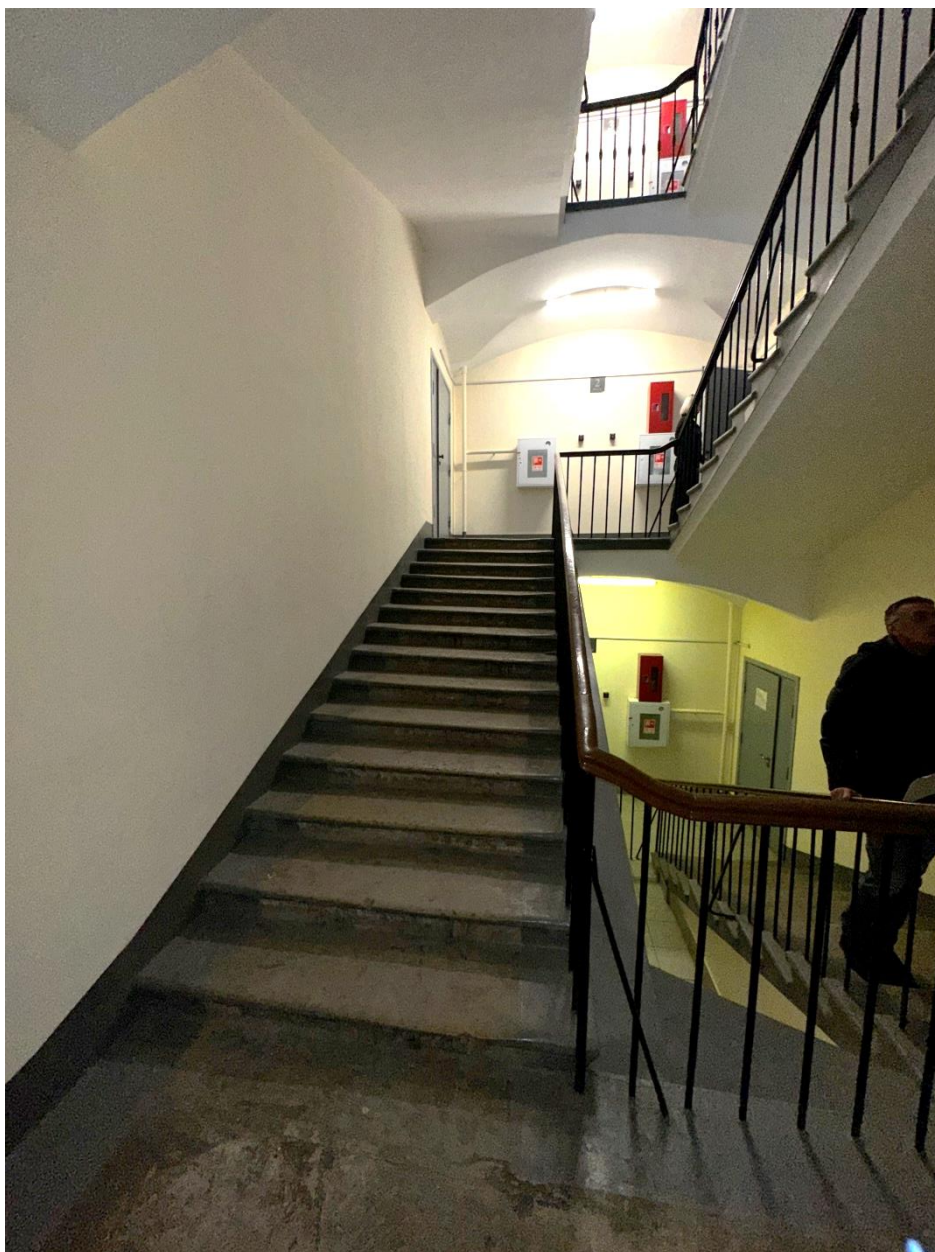
Фото 65. Между 2-ым и 3-им этажами. ЛК-2. Общий вид лестничной клетки с востока. Дата съемки: 28.02.2025 г. Автор съемки: Глинская Н.Б.
