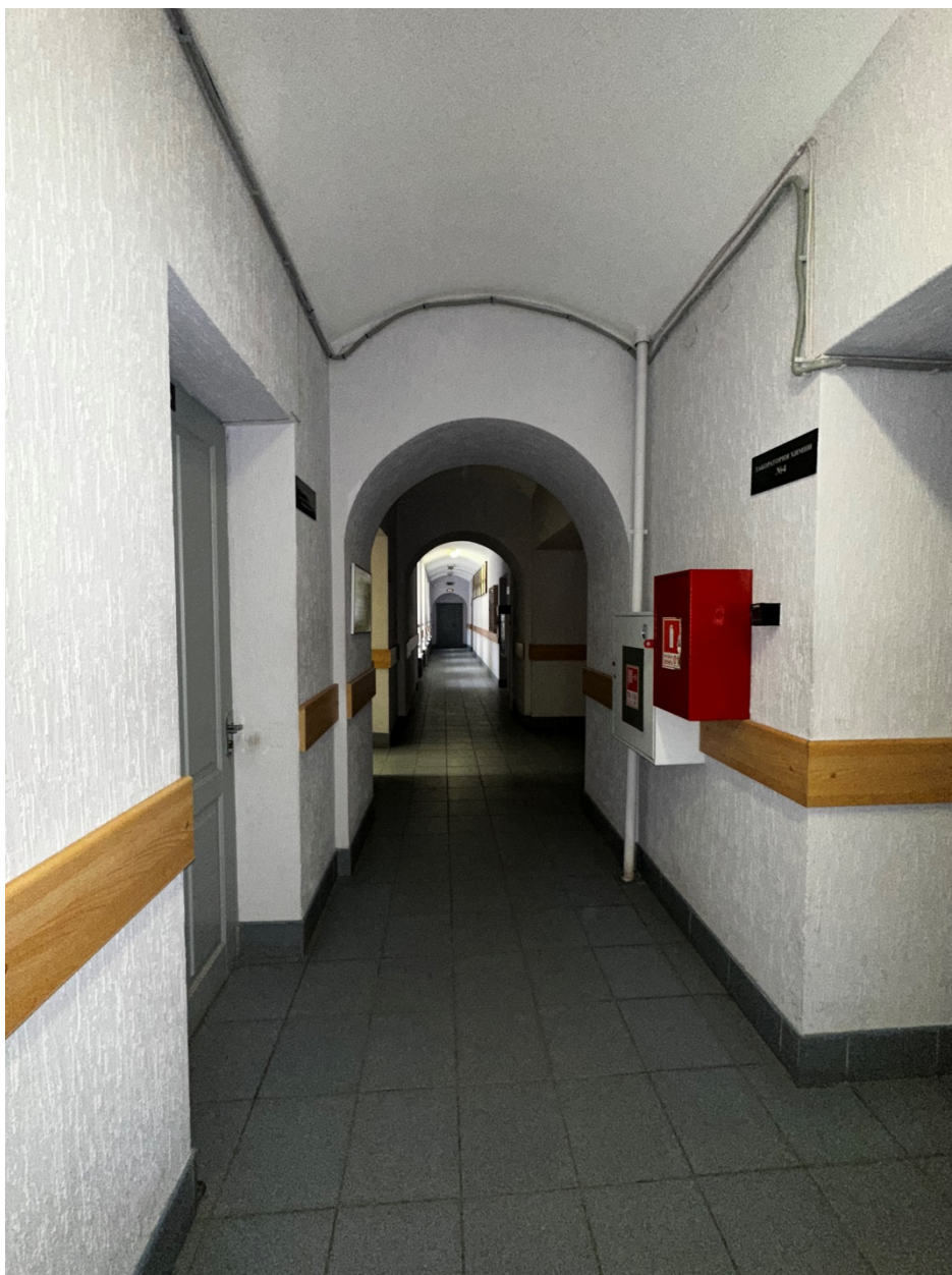
Фото 13. 1-ый этаж. Пом. 1.21. Общий вид помещения с юга. Дата съемки: 28.02.2025 г. Автор съемки: Глинская Н.Б.
