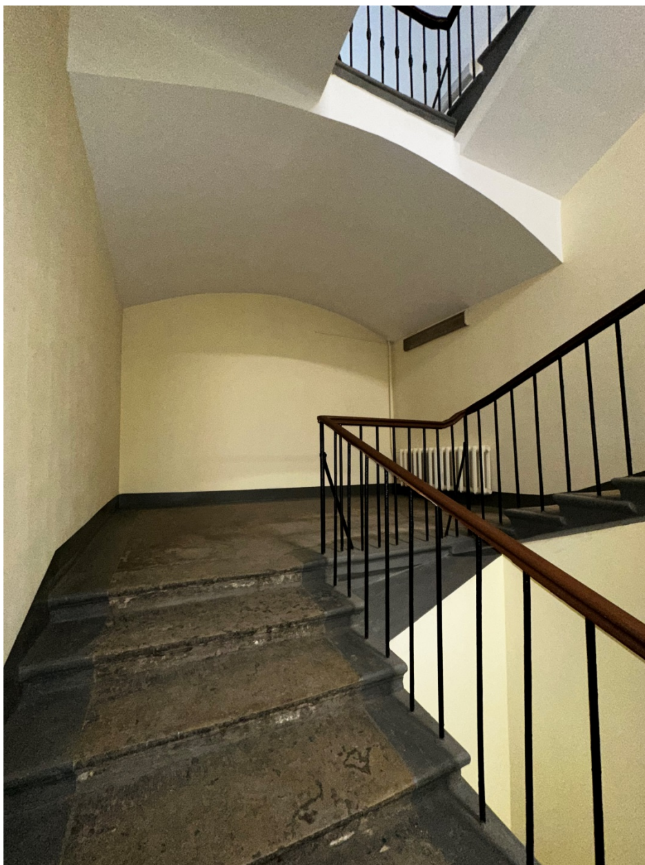
Фото 64. 2-ой этаж. ЛК-2. Общий вид лестничной клетки с северо-запада. Дата съемки: 28.02.2025 г. Автор съемки: Глинская Н.Б.
