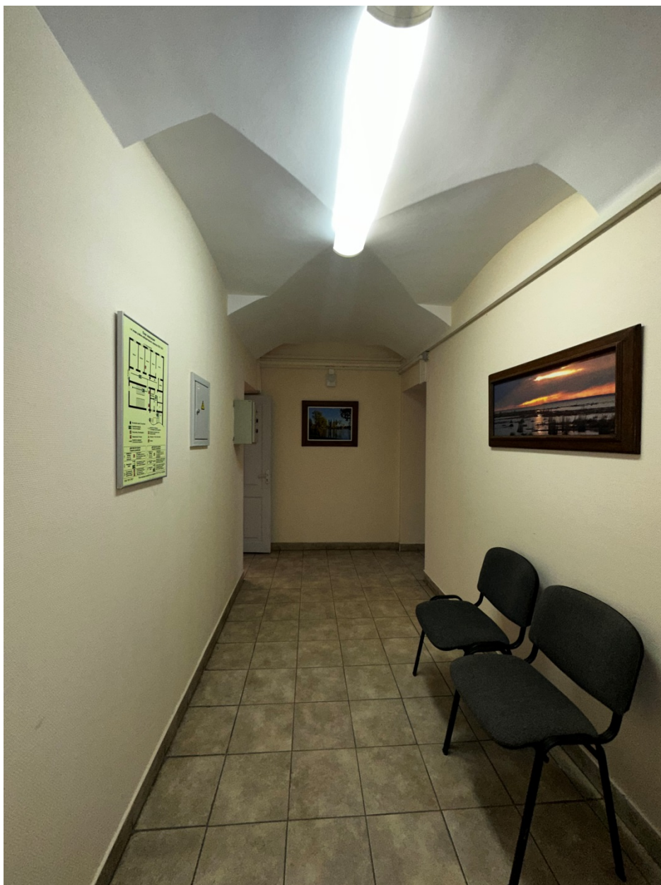
Фото 45. 4-ый этаж. Пом. 4.1. Западная часть помещения. Фото с востока. Дата съемки: 28.02.2025 г. Автор съемки: Глинская Н.Б.
