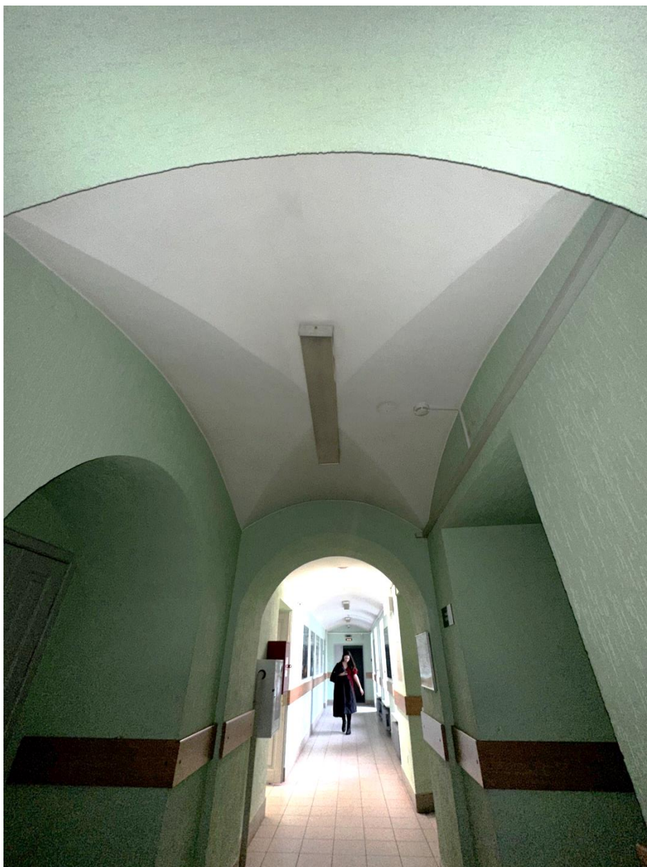
Фото 49. 4-ый этаж. Пом. 4.21. Общий вид помещения с севера. Дата съемки: 28.02.2025 г. Автор съемки: Глинская Н.Б.
