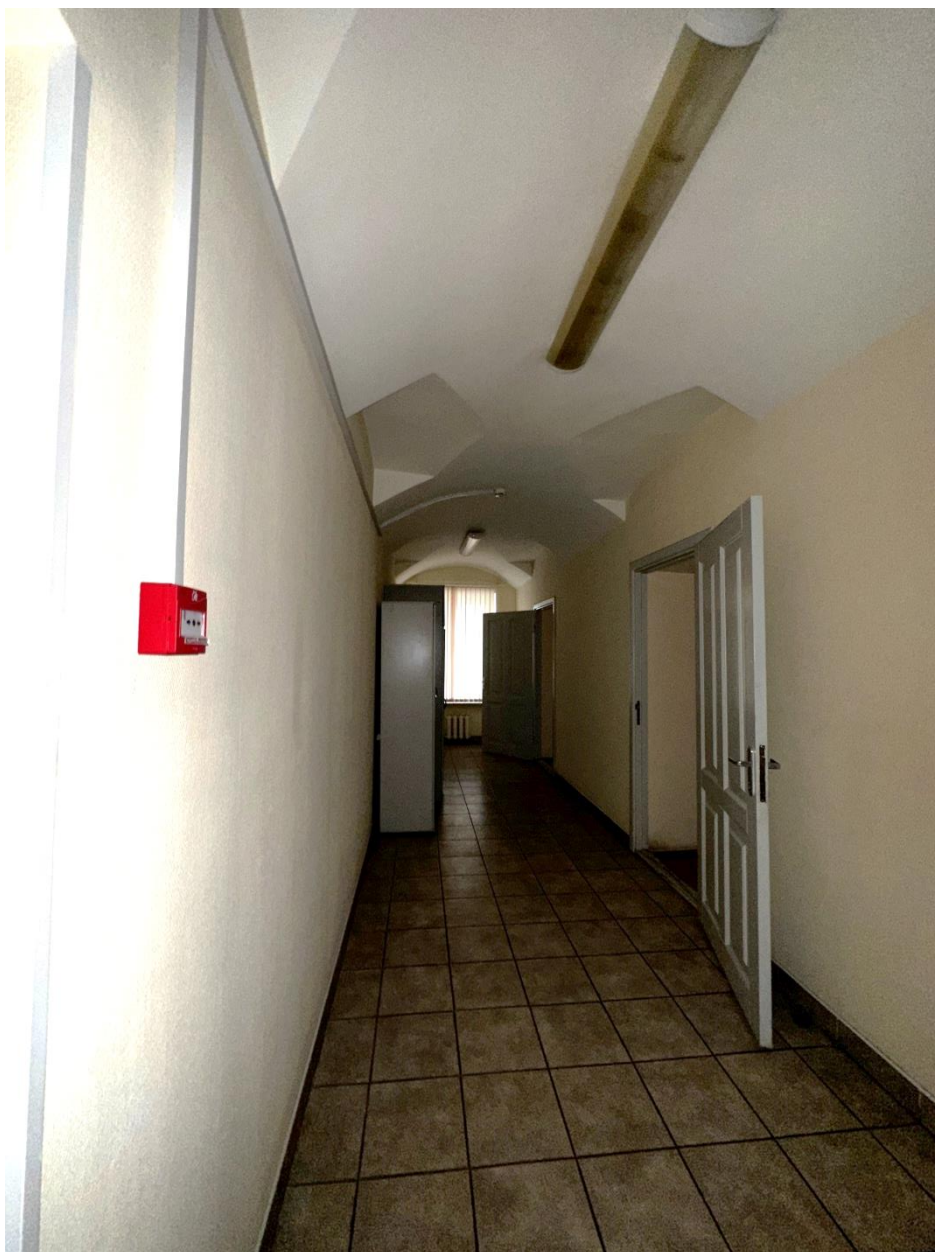
Фото 22. 2-ой этаж. Пом. 2.1. Общий вид помещения с запада. Дата съемки: 28.02.2025 г. Автор съемки: Глинская Н.Б.
