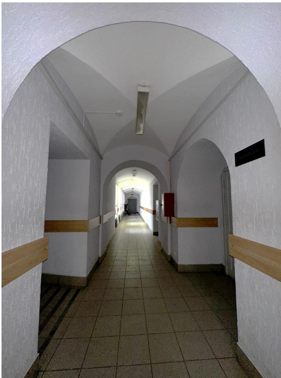
Фото 39. 3-ий этаж. Пом. 3.23. Общий вид помещения с юга. Дата съемки: 28.02.2025 г. Автор съемки: Глинская Н.Б.
