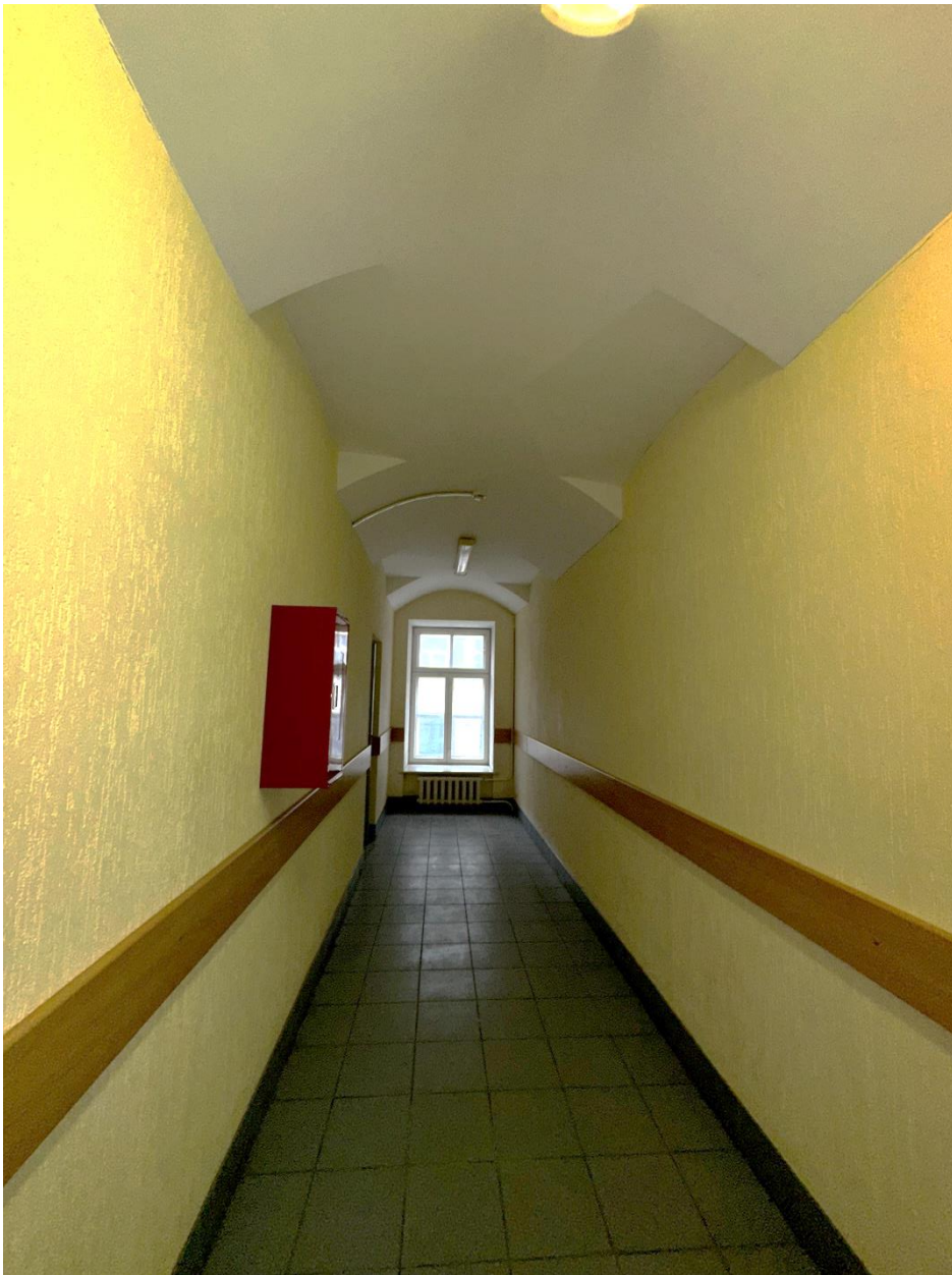
Фото 20. 1-ый этаж. Пом. 1.31. Общий вид помещения с запада. Дата съемки: 28.02.2025 г. Автор съемки: Глинская Н.Б.
