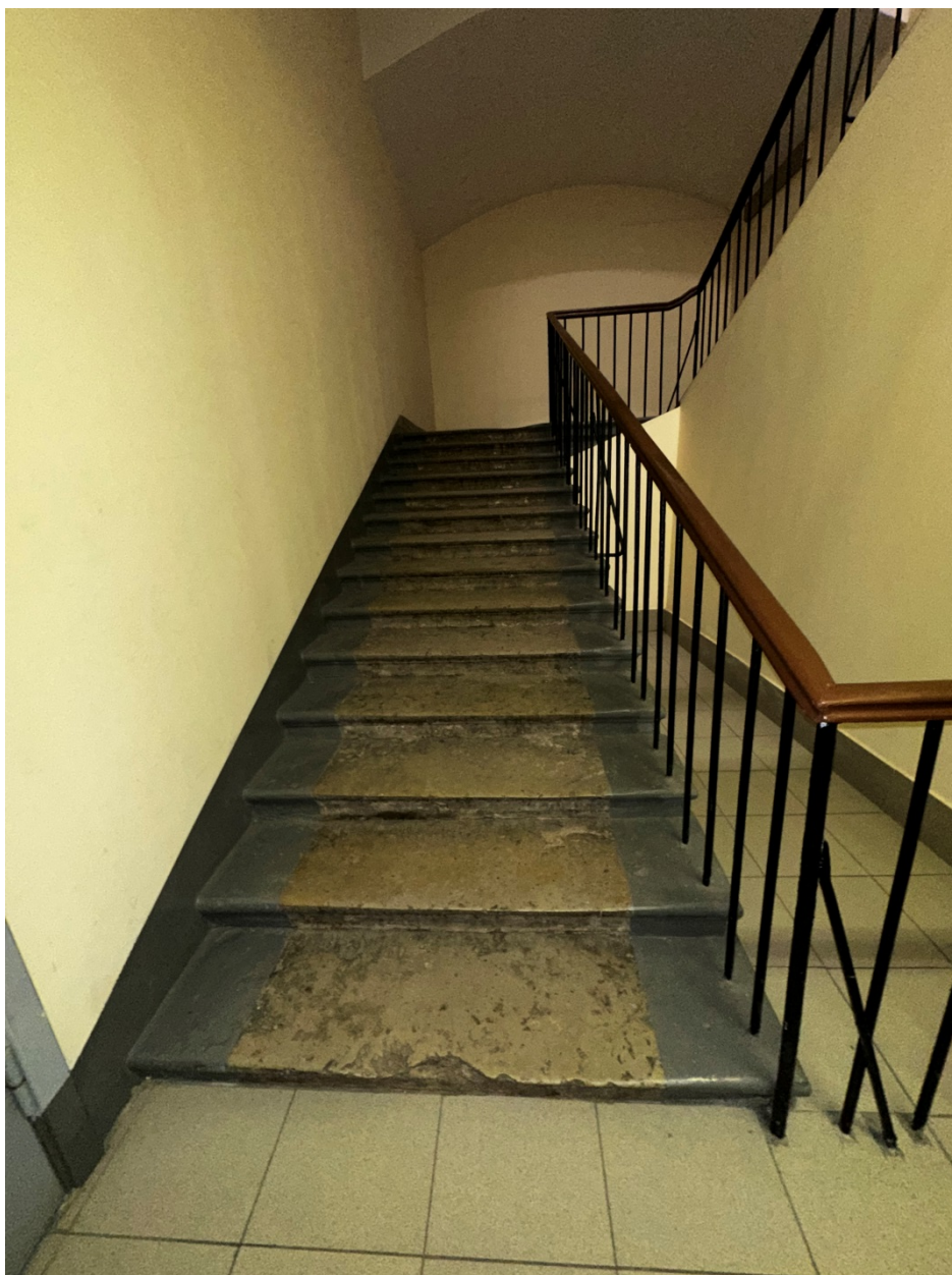
Фото 63. 1-ый этаж. ЛК-2. Общий вид лестницы. Подъем на 2-ой этаж. Фото с запада. Дата съемки: 28.02.2025 г. Автор съемки: Глинская Н.Б.
