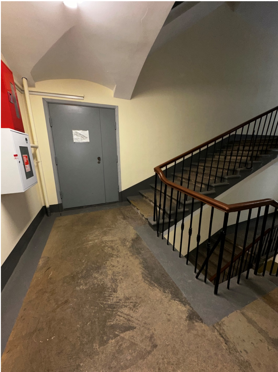
Фото 66. 3-ий этаж. ЛК-2. Лестничная клетка. Фото с юга. Дата съемки: 28.02.2025 г. Автор съемки: Глинская Н.Б.
