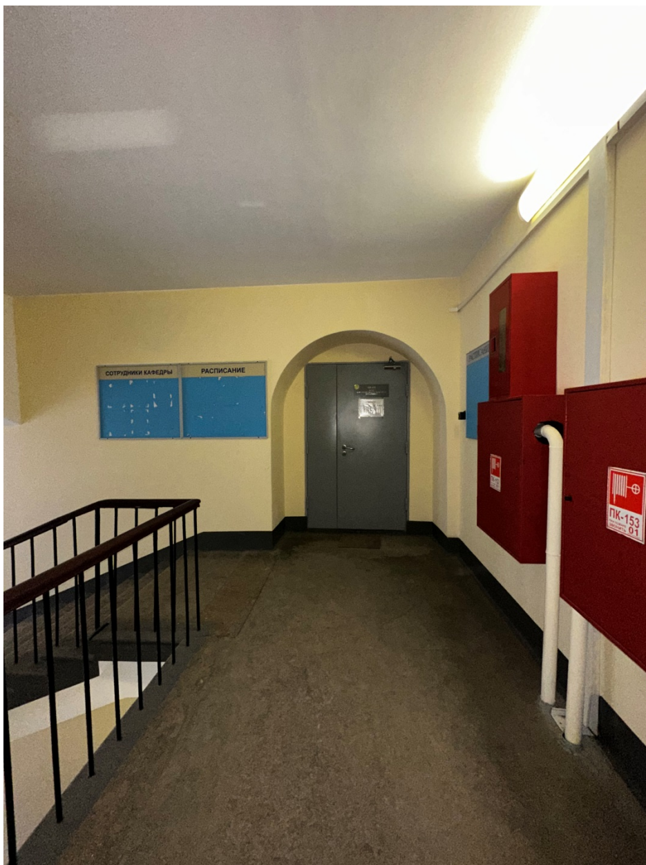
Фото 60. 4-ый этаж. ЛК-1. Верхняя лестничная площадка. Фото с севера. Дата съемки: 28.02.2025 г. Автор съемки: Глинская Н.Б.
