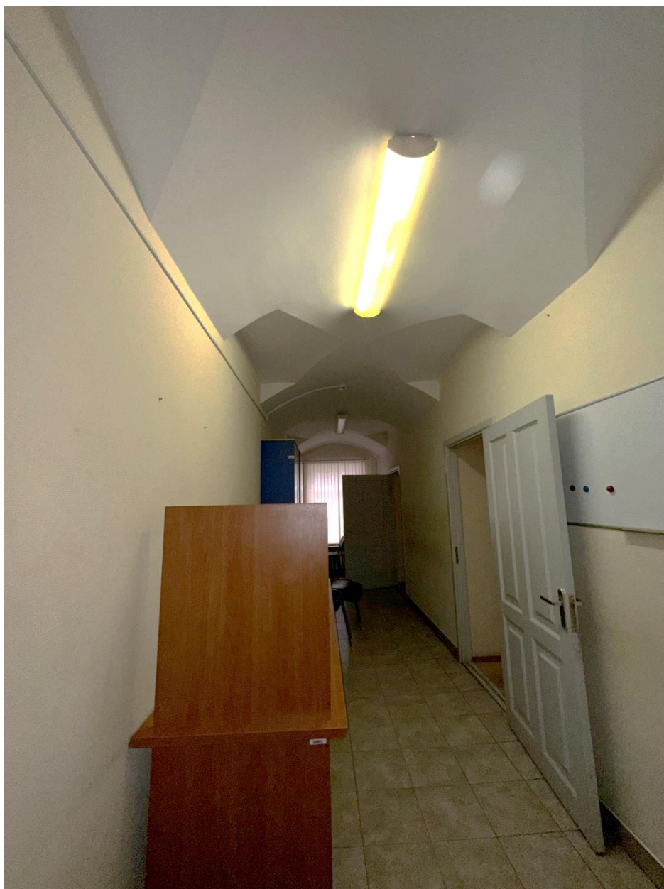
Фото 36. 3-ий этаж. Пом. 3.1. Общий вид помещения с запада. Дата съемки: 28.02.2025 г. Автор съемки: Глинская Н.Б.
