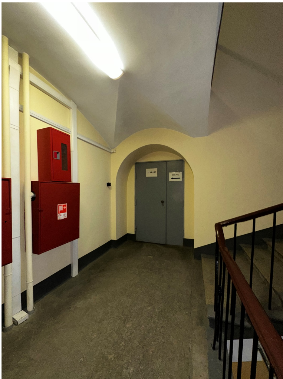
Фото 59. 3-ий этаж. ЛК-1. Лестничная площадка. Фото с юга. Дата съемки: 28.02.2025 г. Автор съемки: Глинская Н.Б.
