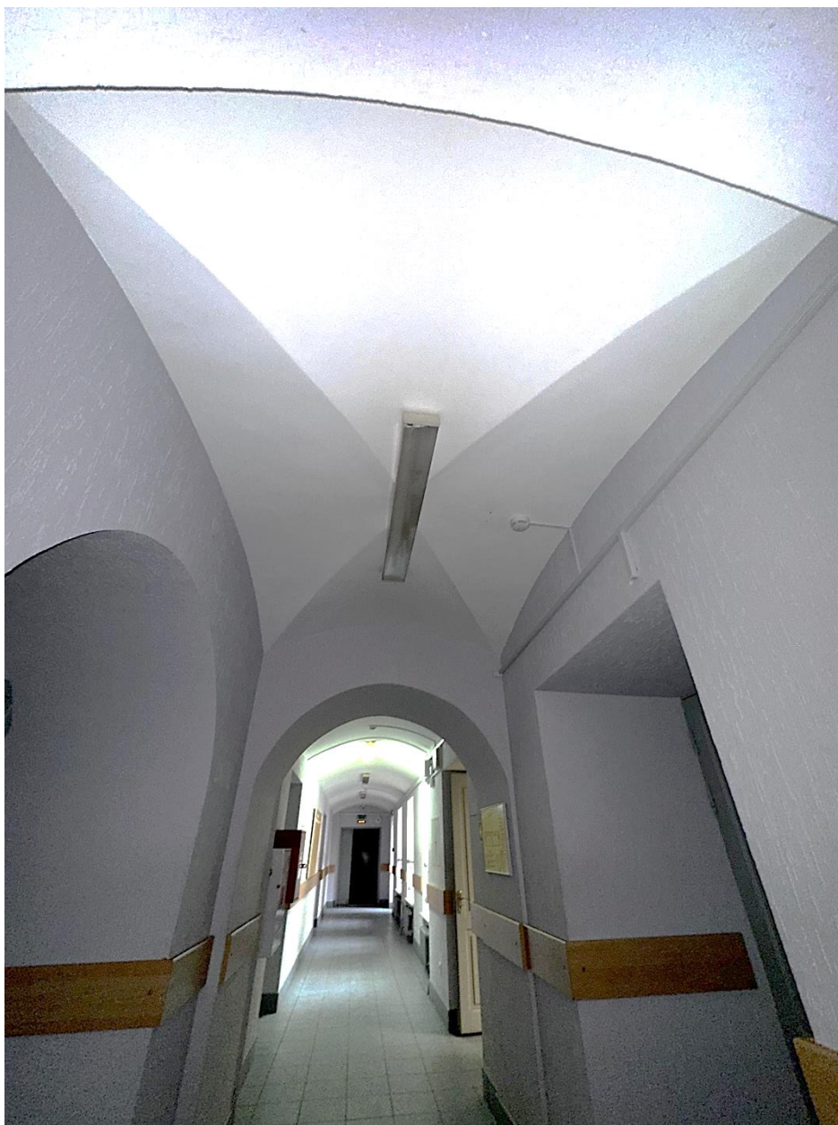
Фото 28. 2-ой этаж. Пом. 2.22. Общий вид помещения с юга. Дата съемки: 28.02.2025 г. Автор съемки: Глинская Н.Б.
