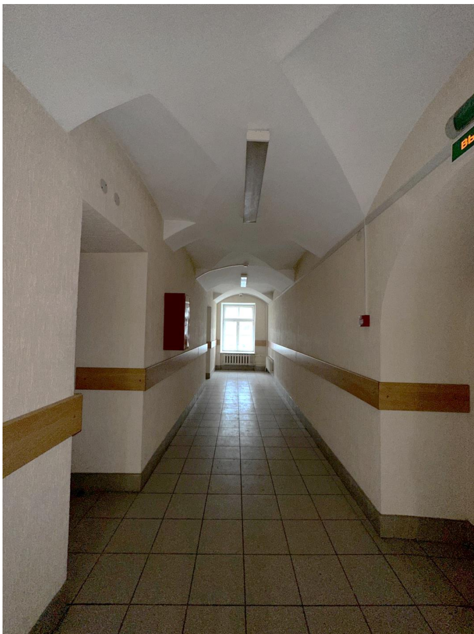
Фото 51. 4-ый этаж. Пом. 4.26. Общий вид помещения с запада. Дата съемки: 28.02.2025 г. Автор съемки: Глинская Н.Б.
