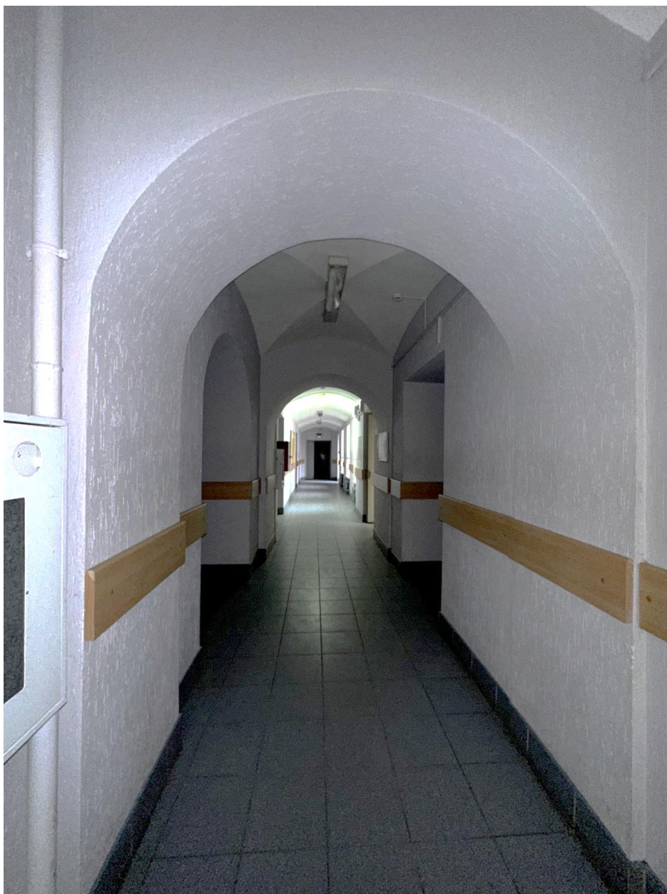
Фото 31. 2-ой этаж. Пом. 2.25. Вид на пом. 2.19 с севера. Дата съемки: 28.02.2025 г. Автор съемки: Глинская Н.Б.
