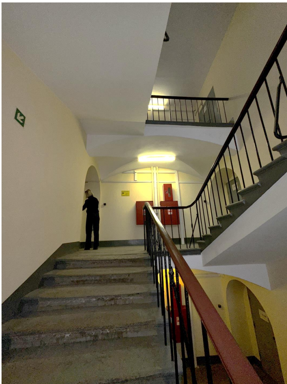
Фото 58. 3-ий этаж. ЛК-1. Общий вид лестничной клетки с востока. Дата съемки: 28.02.2025 г. Автор съемки: Глинская Н.Б.
