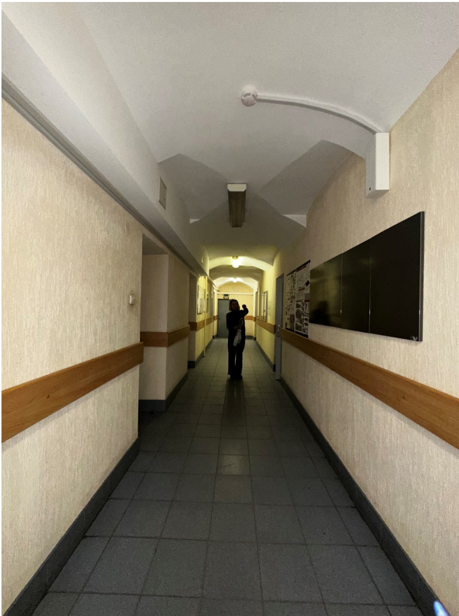
Фото 33. 2-ой этаж. Пом. 2.28. Общий вид помещения с востока. Дата съемки: 28.02.2025 г. Автор съемки: Глинская Н.Б.
