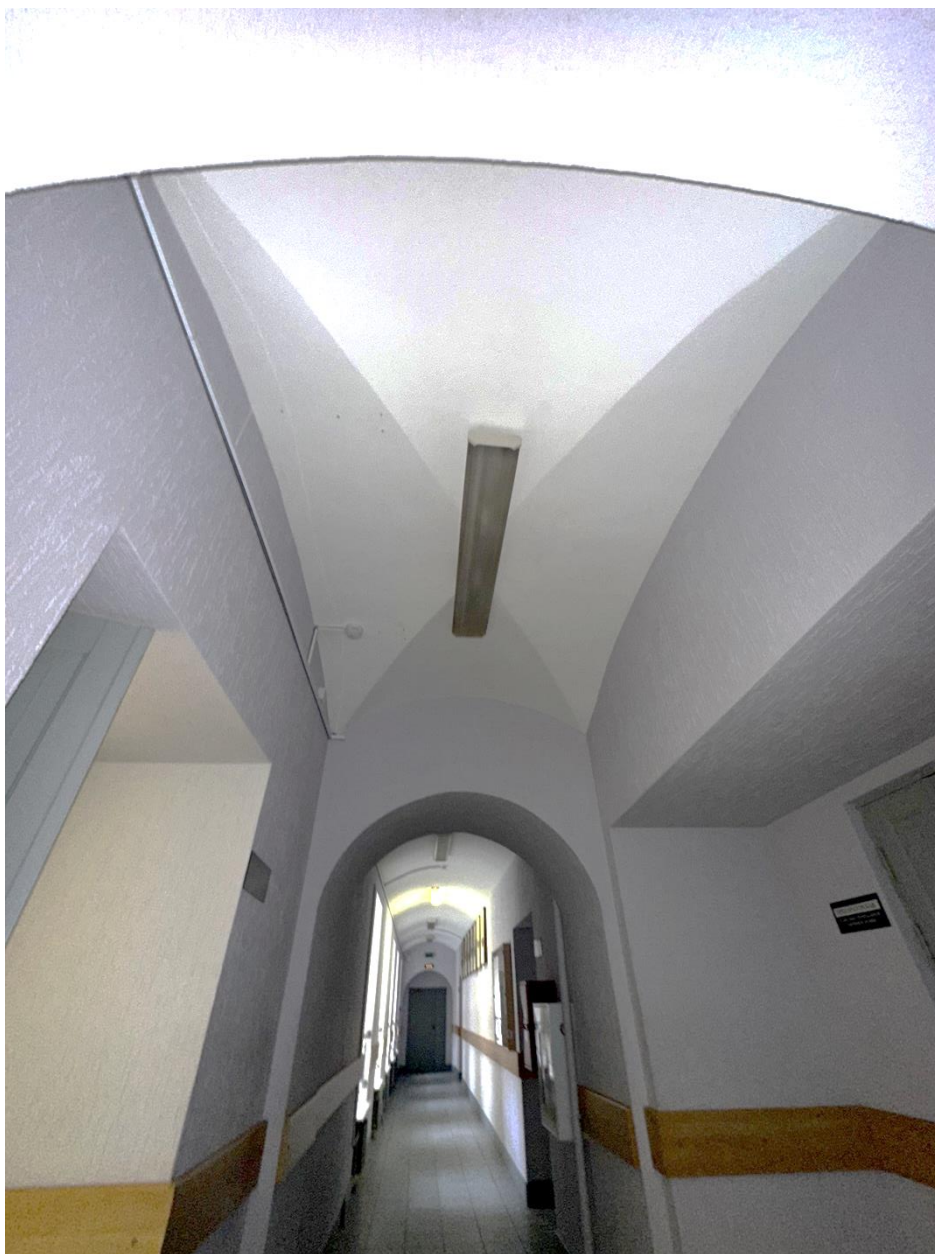
Фото 16. 1-ый этаж. Пом. 1.25. Общий вид помещения с юга. Дата съемки: 28.02.2025 г. Автор съемки: Глинская Н.Б.
