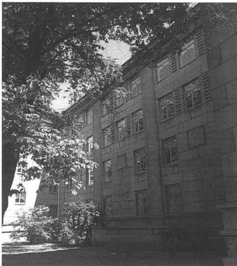
2. Фрагмент западного фасада
