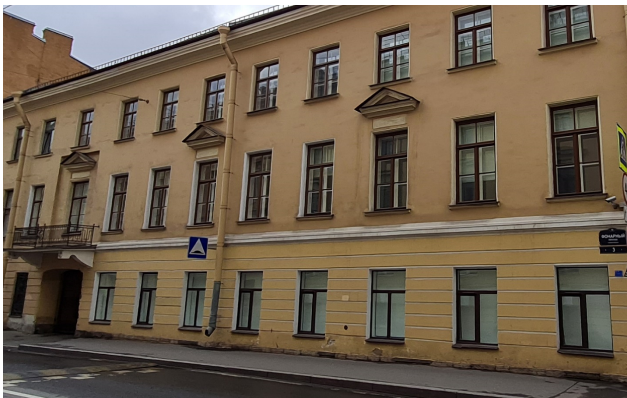
15. 2021 г. Фрагмент фасада по пер. Фонарный, д. 3. Фото
