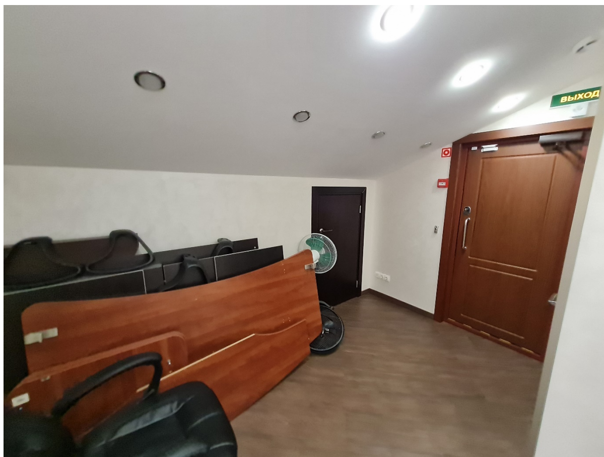
32. Входная зона офисных помещений 4 этажа. (кв.№31).
