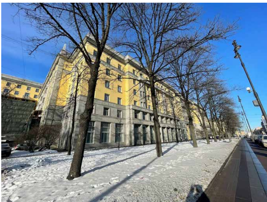
Фото 10. Фрагмент лицевого фасада объекта культурного наследия регионального значения «Жилой дом»
