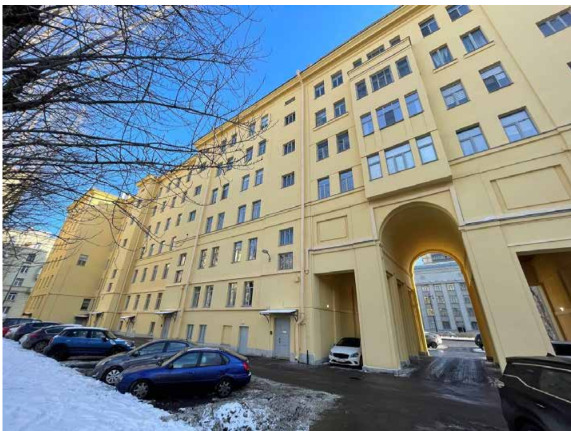
Фото 6. Фрагмент дворового фасада объекта культурного наследия регионального значения «Жилой дом»
