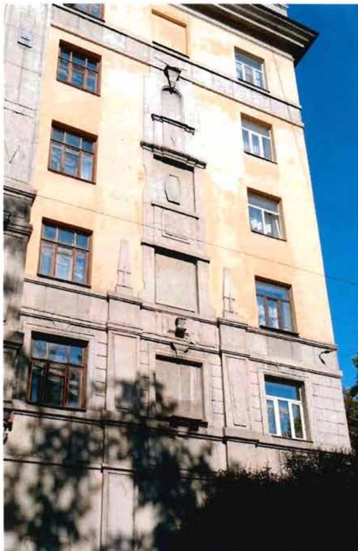
13. Фрагмент. Северный фасад северного флигеля.
