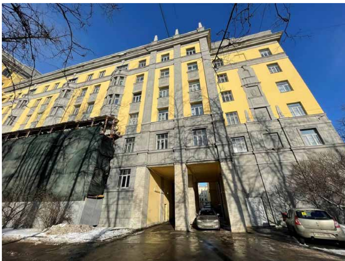
Фото 8. Фрагмент лицевого фасада объекта культурного наследия регионального значения «Жилой дом»
