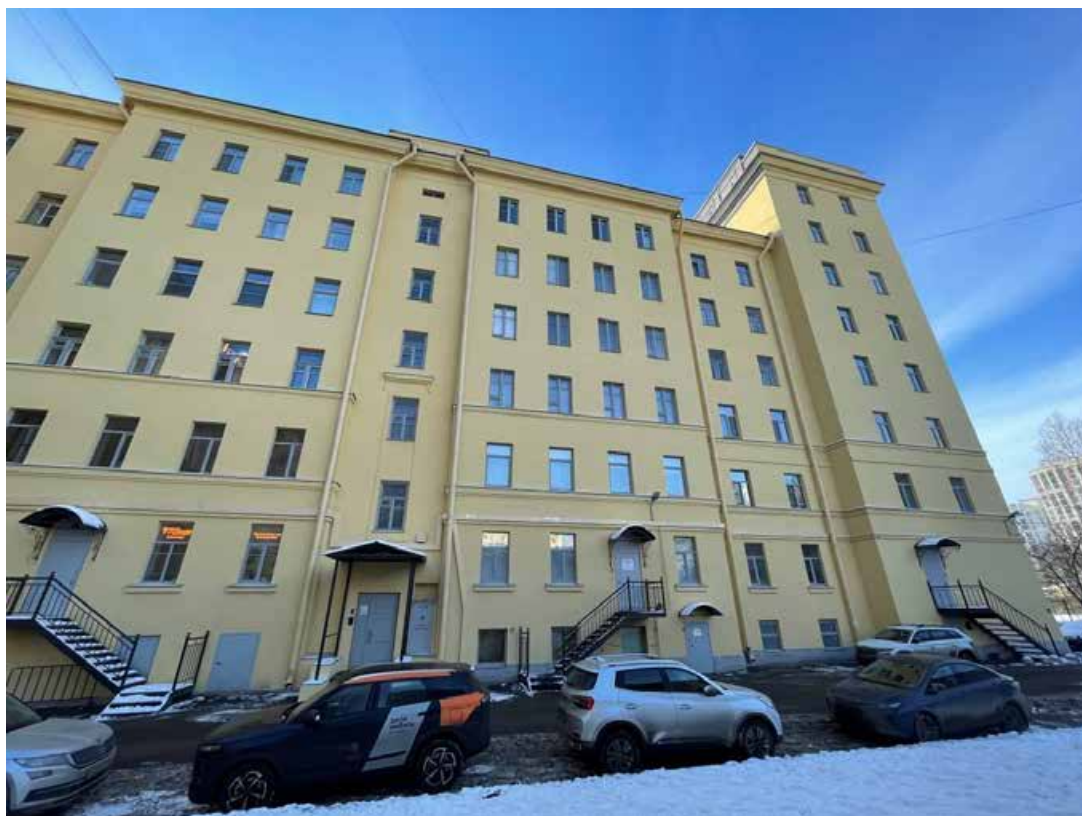
Фото 7. Фрагмент дворового фасада объекта культурного наследия регионального значения «Жилой дом»
