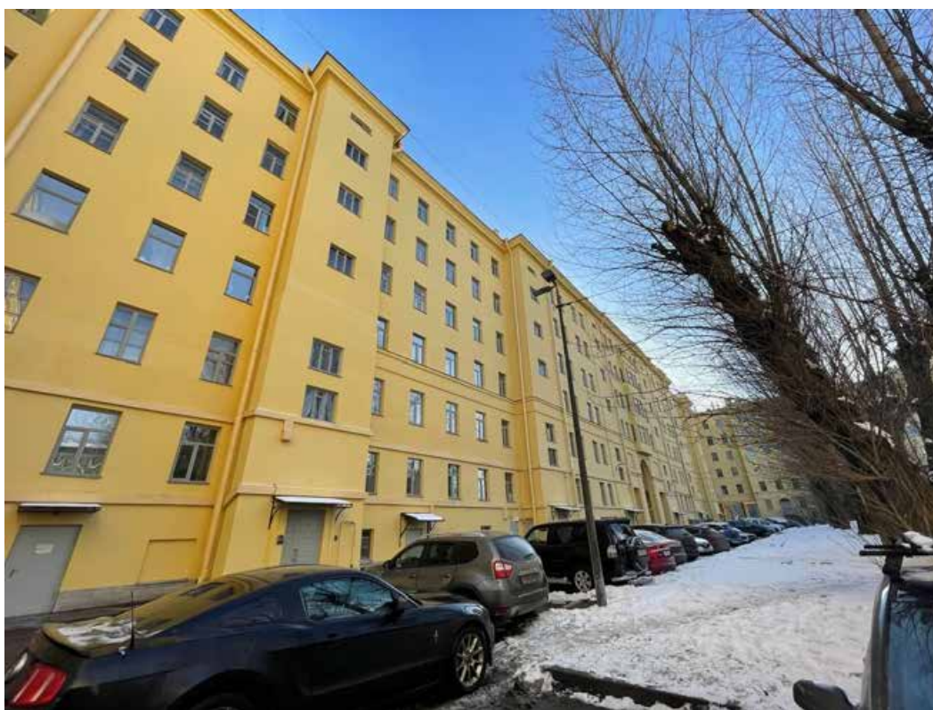
Фото 4. Фрагмент дворового фасада объекта культурного наследия регионального значения «Жилой дом»
