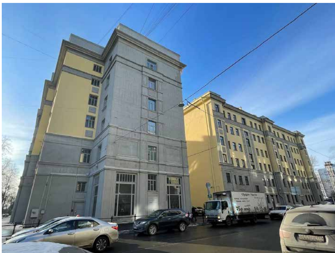
Фото 2. Фрагмент лицевого фасада объекта культурного наследия регионального значения «Жилой дом»
