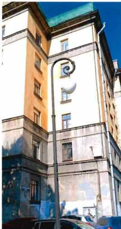
7. Фрагмент. Северный фасад южного флигеля.
