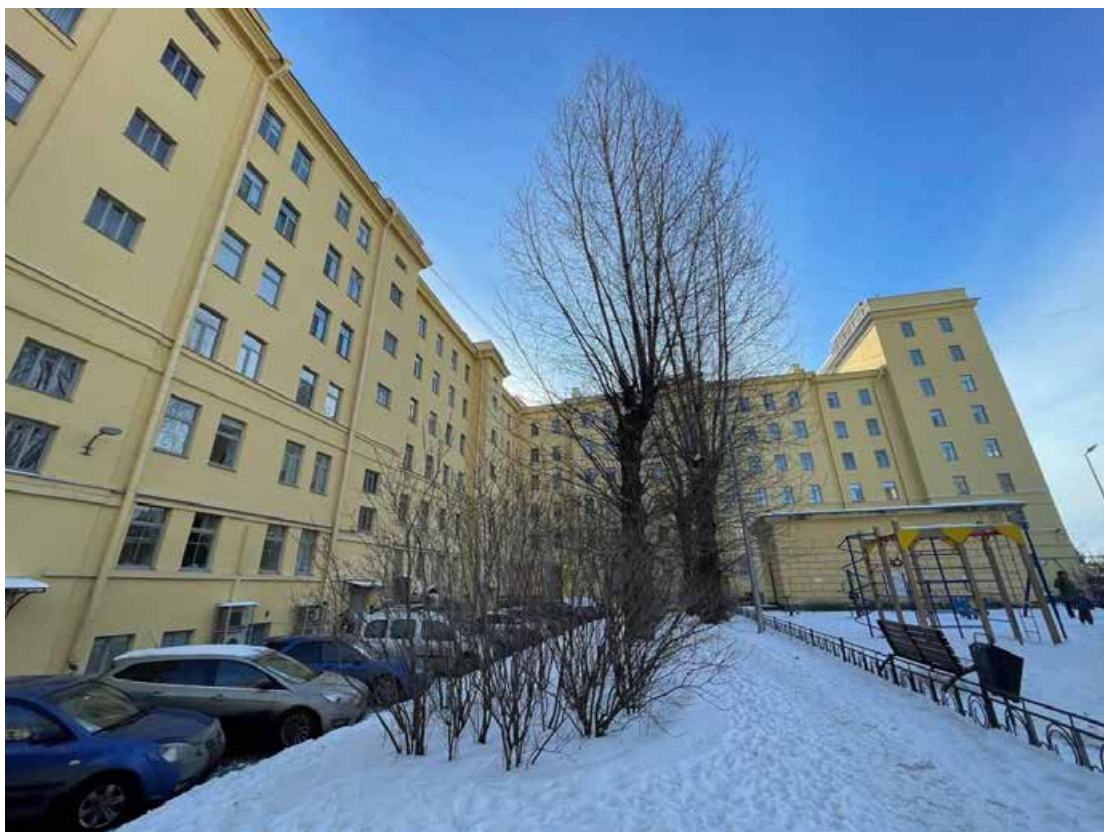
Фото 5. Фрагмент дворового фасада объекта культурного наследия регионального значения «Жилой дом»
