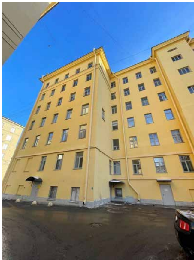
Фото 3. Фрагмент дворового фасада объекта культурного наследия регионального значения «Жилой дом»
