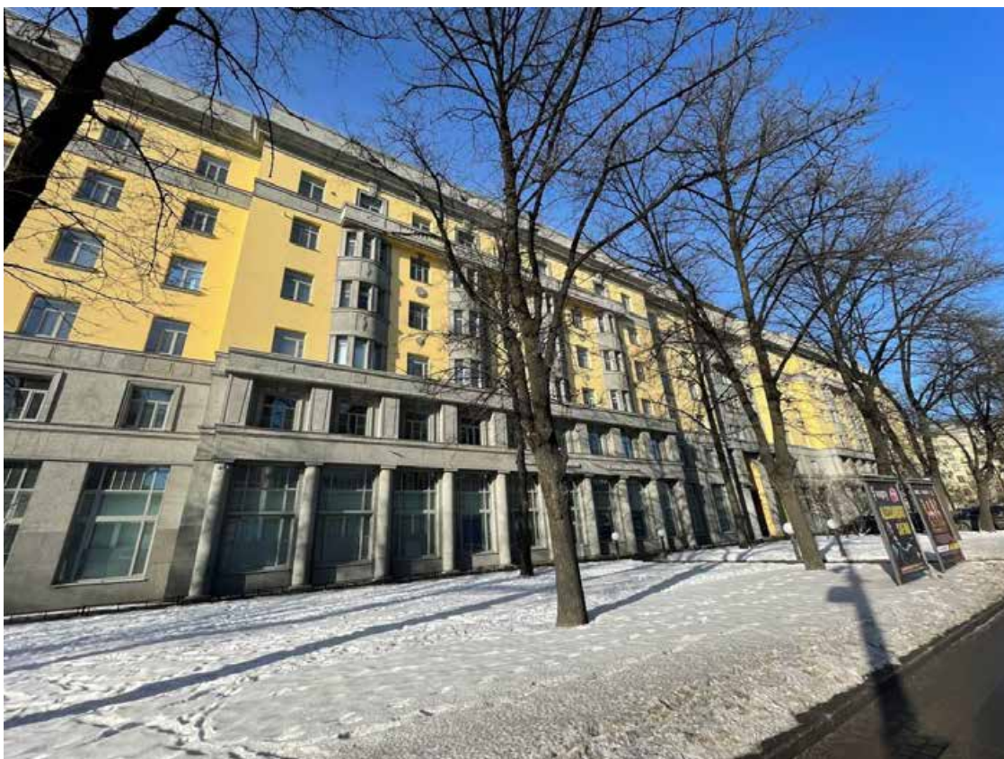
Фото 11. Фрагмент лицевого фасада объекта культурного наследия регионального значения «Жилой дом»
