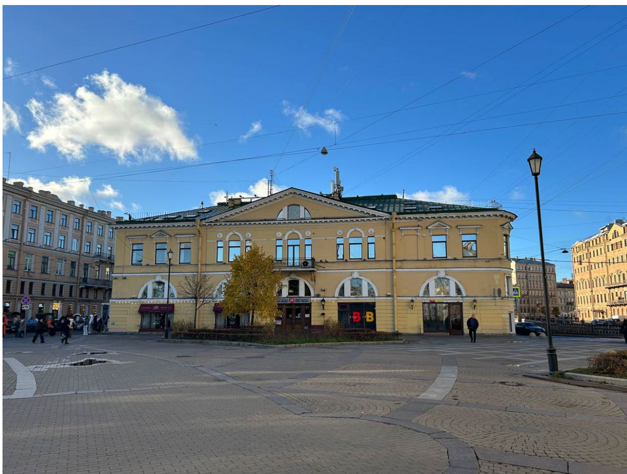
1. Вид на северо-восточный фасад выявленного объекта культурного наследия «Дом Терешиных», расположенного по адресу: г. Санкт-Петербург, наб. кан. Грибоедова, д. 56-58, литера А. 01.10.2024
