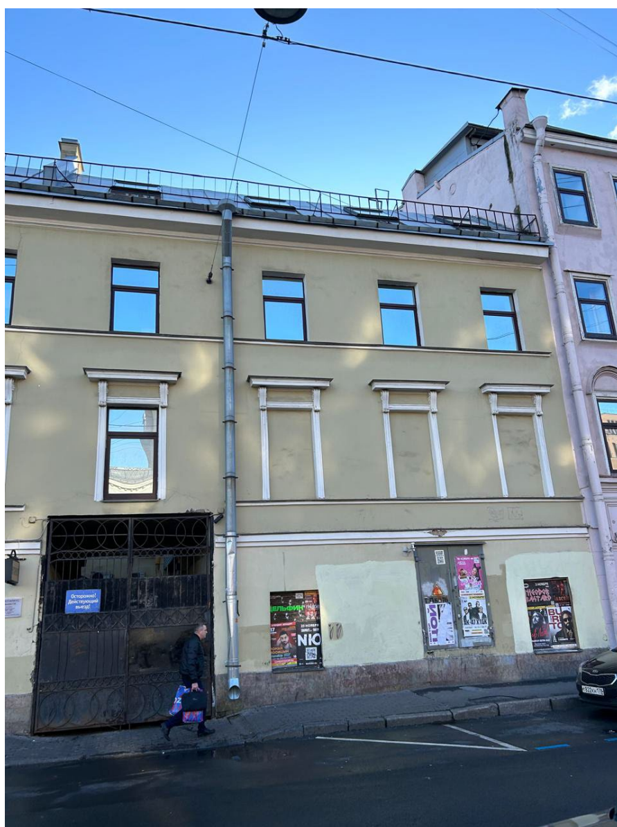
10. Вид на северо-западный фасад выявленного объекта культурного наследия «Дом Фалевых», расположенного по адресу: г. Санкт-Петербург, наб. кан. Грибоедова, д. 56-58, литера А. Фрагмент. 01.10.2024
