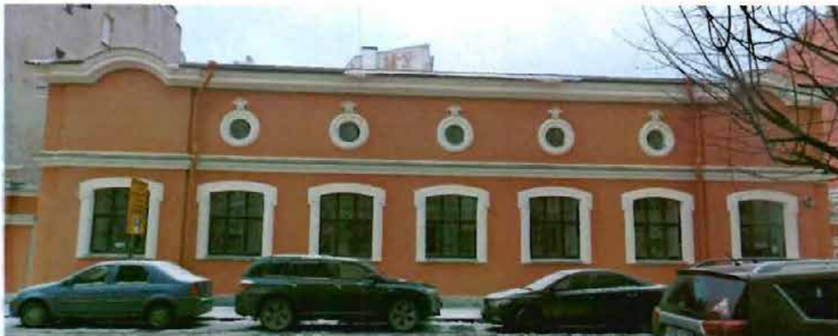
23. Общий вид Флигеля со стороны внутреннего двора.
