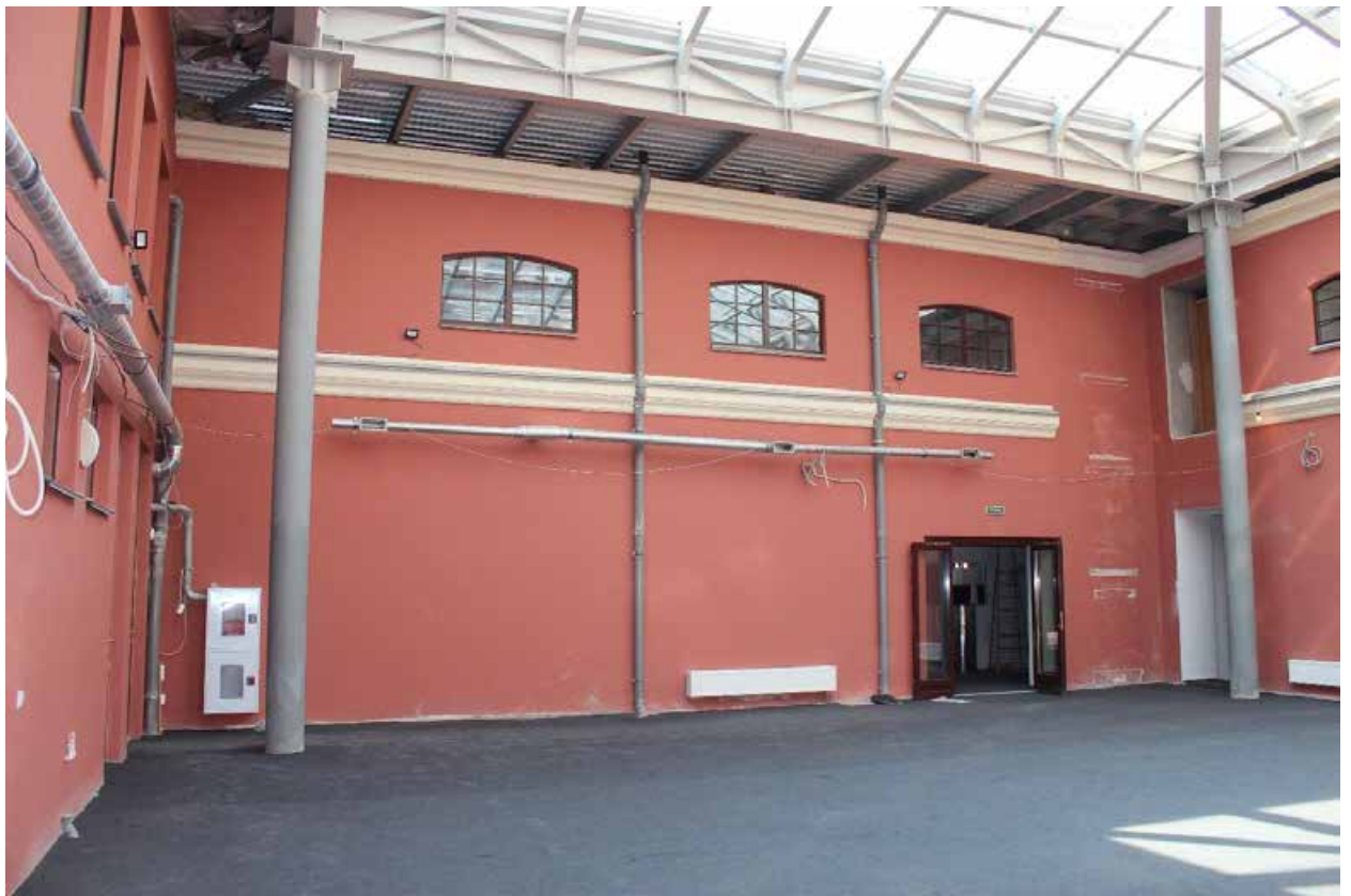
Фото 2. Дворовой фасад здания.
