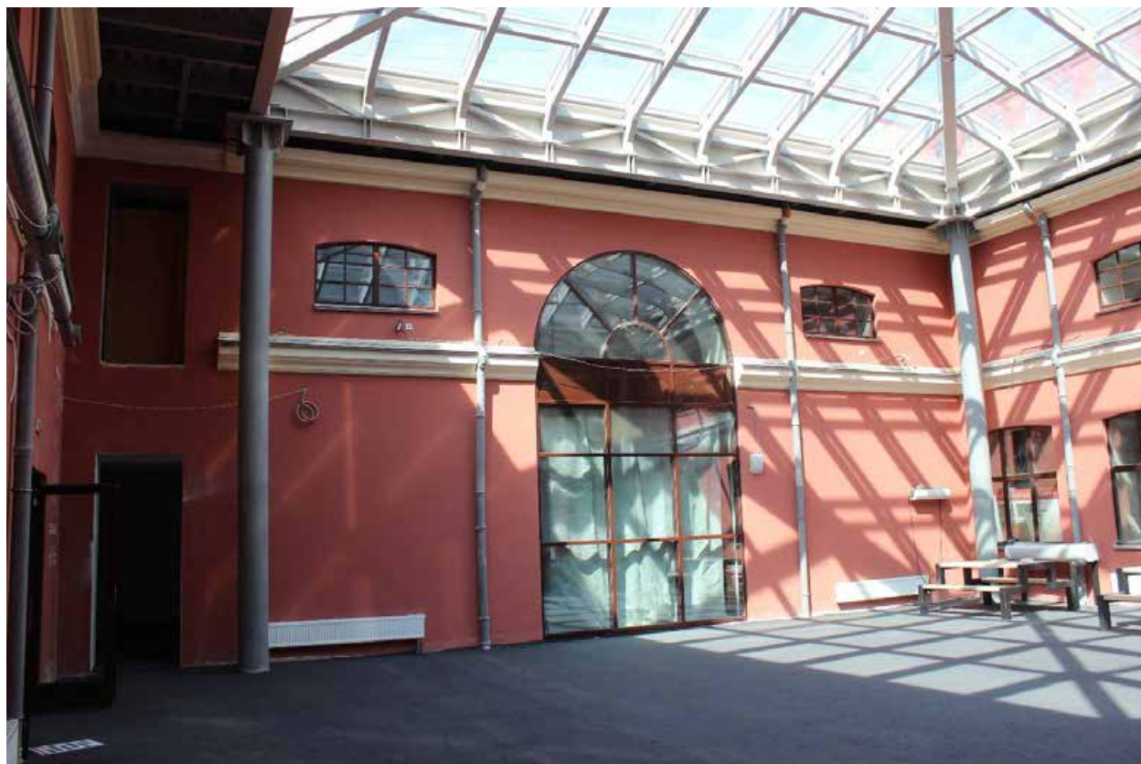
Фото 1. Дворовой фасад здания.
