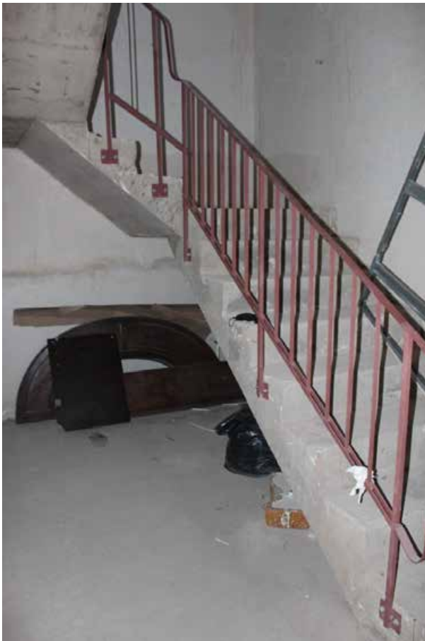
Фото 11. Трехмаршевая лестница на 2 этаж..
