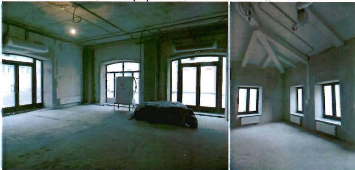
26, 27. Интерьеры помещений без чистовой отделки.
