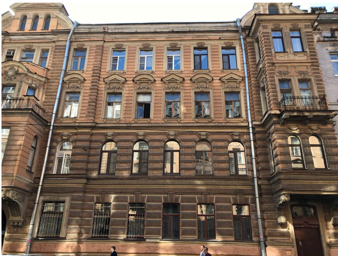
1. Вид на лицевой фасад с ул. Коломенская
