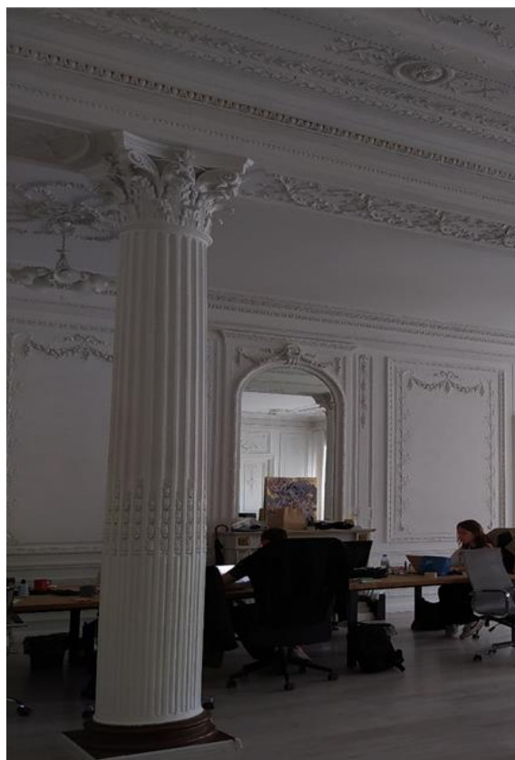
Фото 36. Колонна в помещении № 12.
