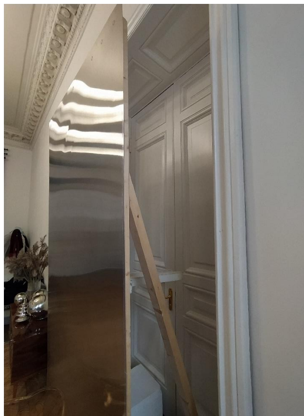
Фото 39. Дверь между помещениями № 12 и № 13.
