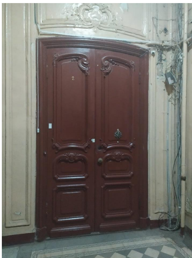
Фото 7. Входная дверь в кв. № 2.
