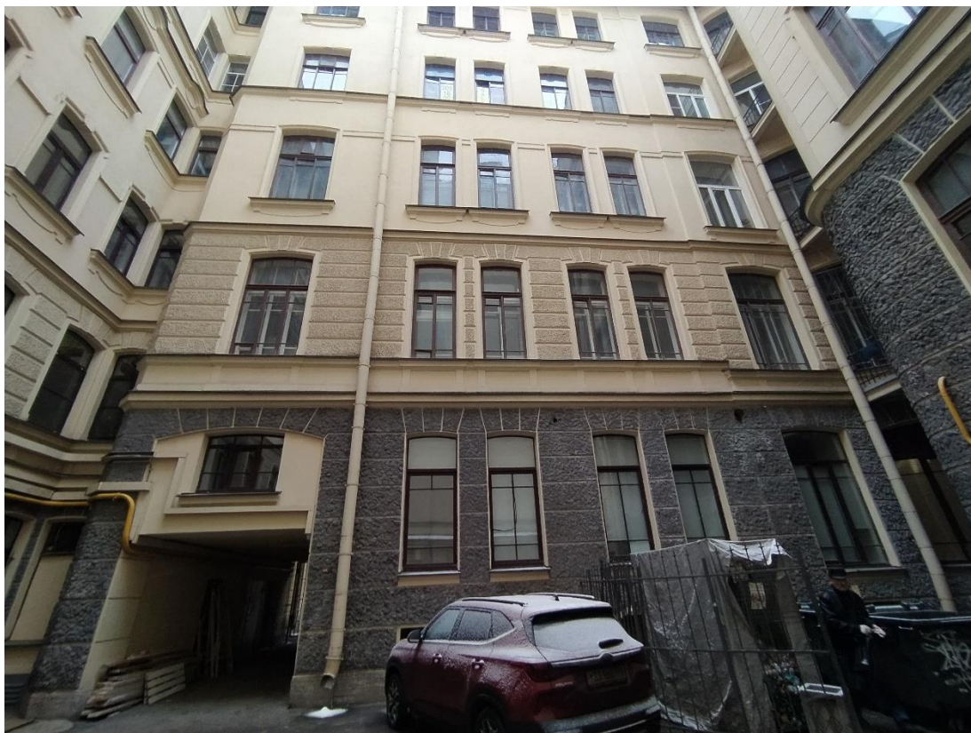
Фото 5. Западный фасад дворового корпуса здания
