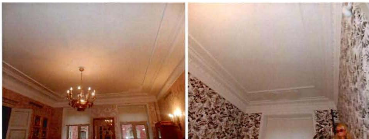
27, 28. Сводчатые потолки в уровне 1 этажа здания (кв. 24)
