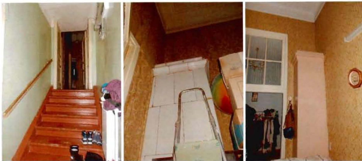
54, 55, 56. Лестница Л-5 (вход со стороны внутреннего двора)
