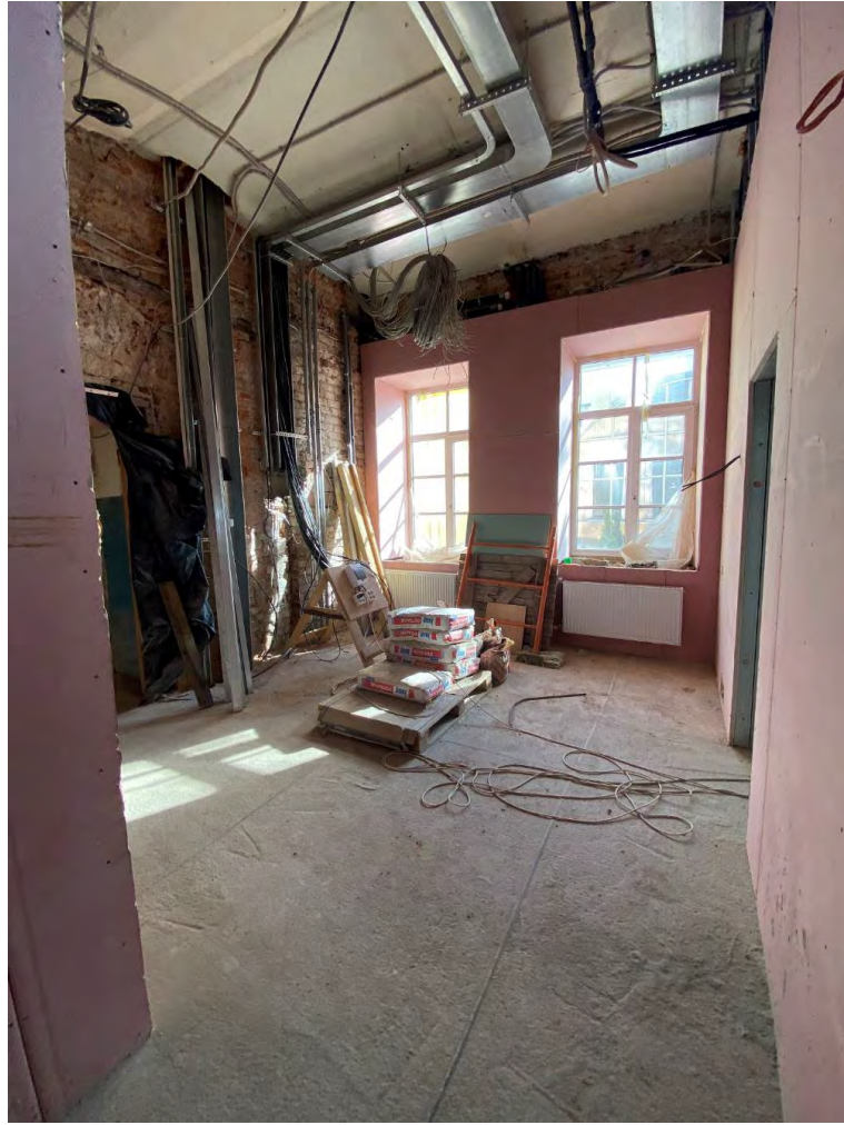
Фото №10. Помещение первого этажа. Сентябрь 2024г.
