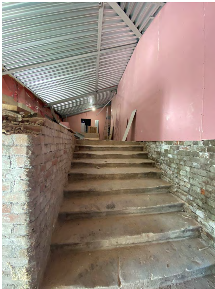
Фото №30. Лестница по правой оси с третьего этажа на мансарду. Сентябрь 2024г.
