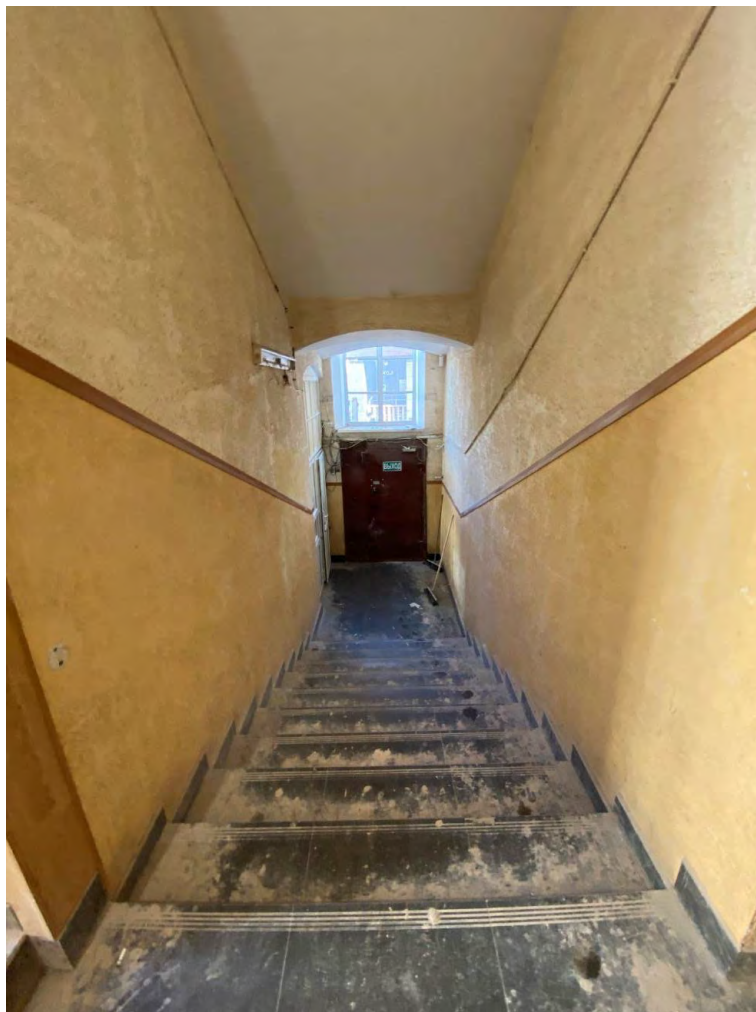
Фото №42. Лестница по левой оси с первого этажа на улицу. Сентябрь 2024г.
