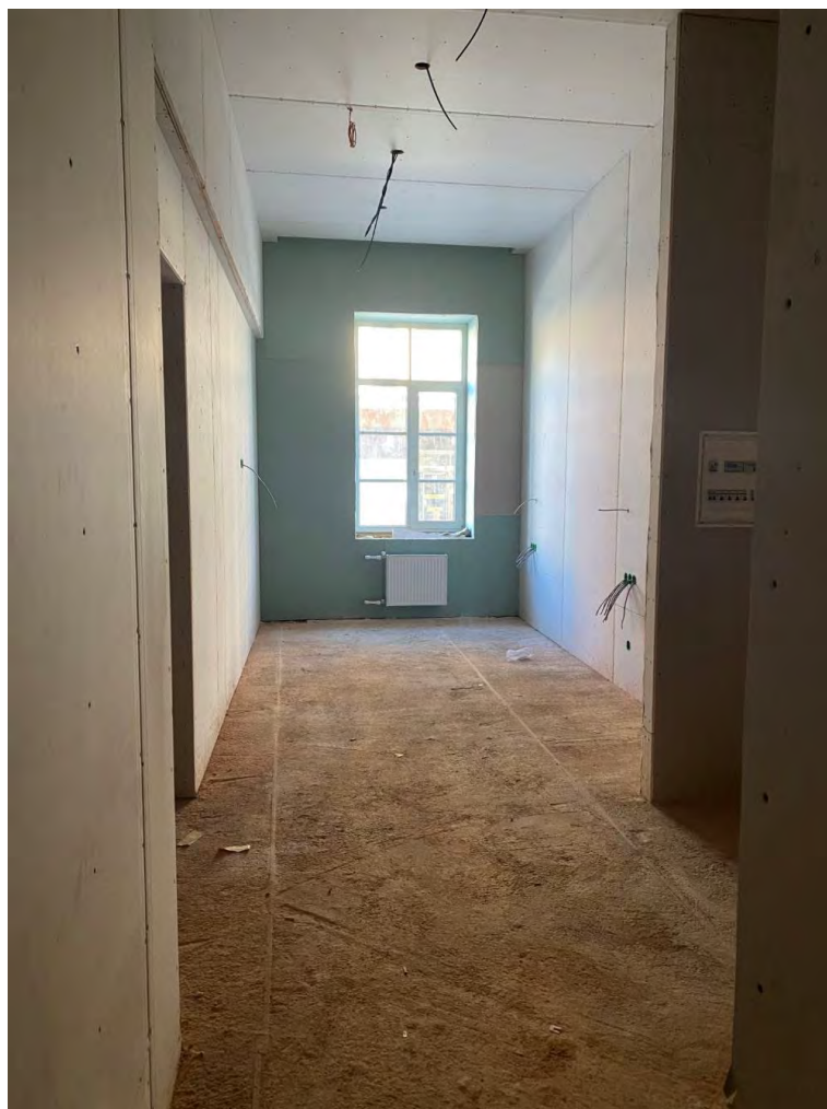
Фото №7. Помещение первого этажа. Сентябрь 2024г.
