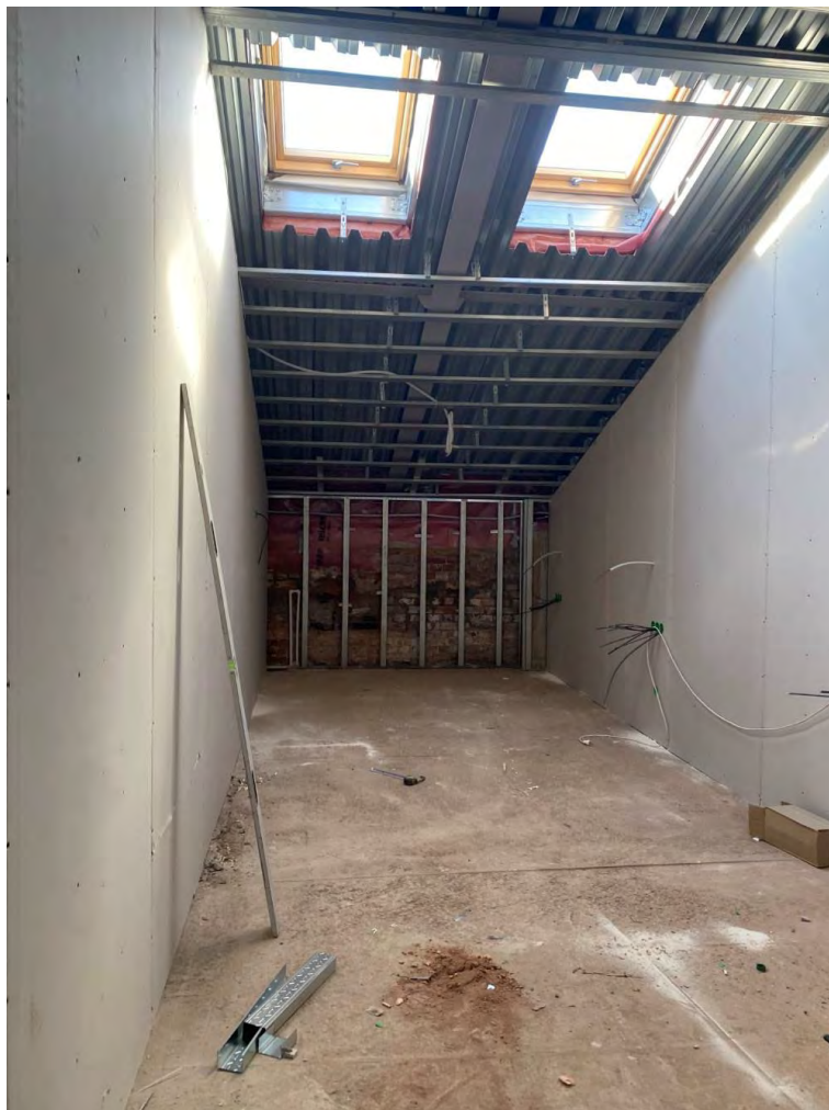
Фото №36. Помещение на мансарде. Сентябрь 2024г.
