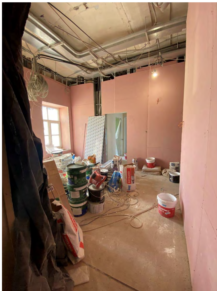
Фото №14. Помещение на втором этаже. Сентябрь 2024г.
