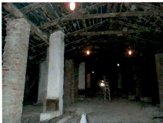
10, 11. Общий вид чердака.
