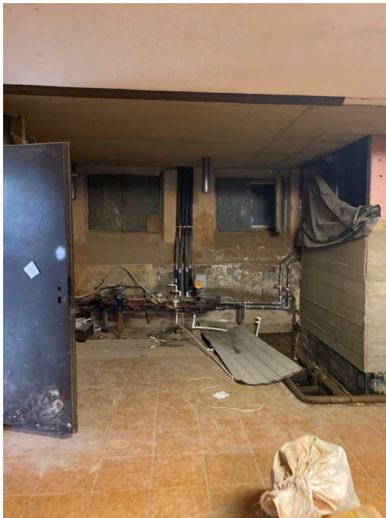
Фото №43. Коридор цокольного этажа. Сентябрь 2024г.
