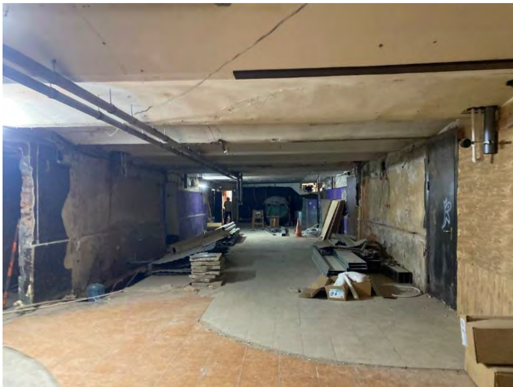
Фото №45 Коридор цокольного этажа. Сентябрь 2024г.
