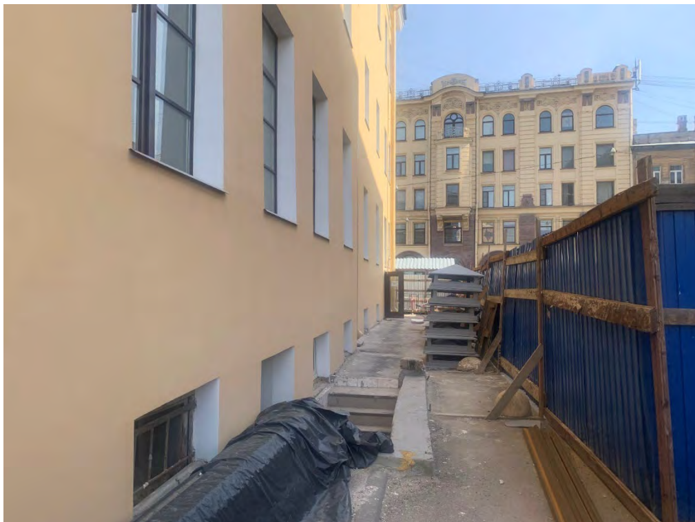
Фото №3. Фрагмент дворового фасада. Сентябрь 2024г.
