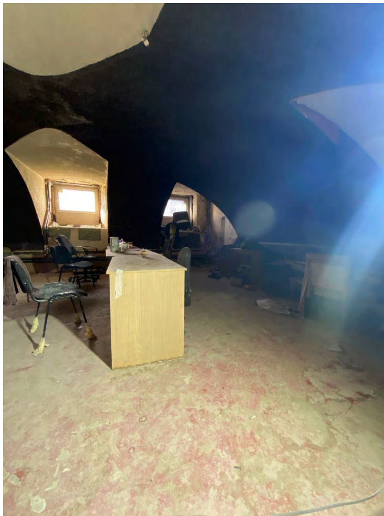
Фото №44. Помещение цокольного этажа. Сентябрь 2024г.
