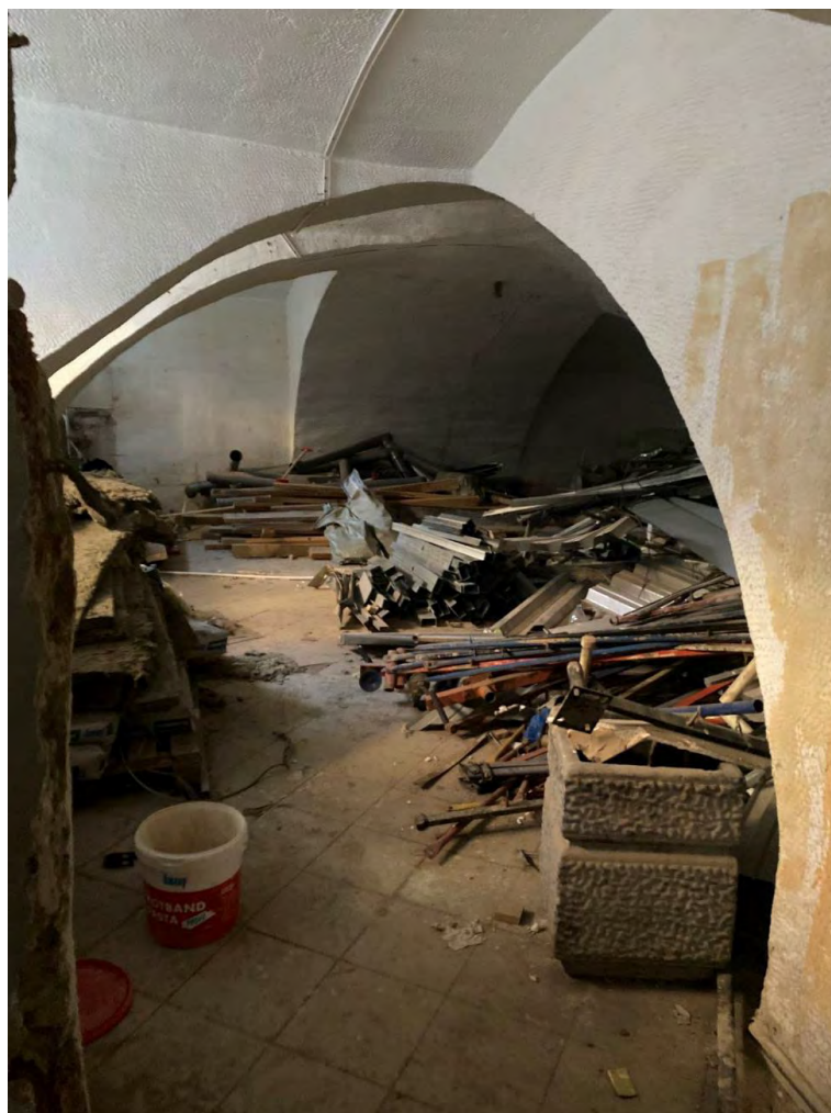
Фото №47. Помещение цокольного этажа. Сентябрь 2024г.
