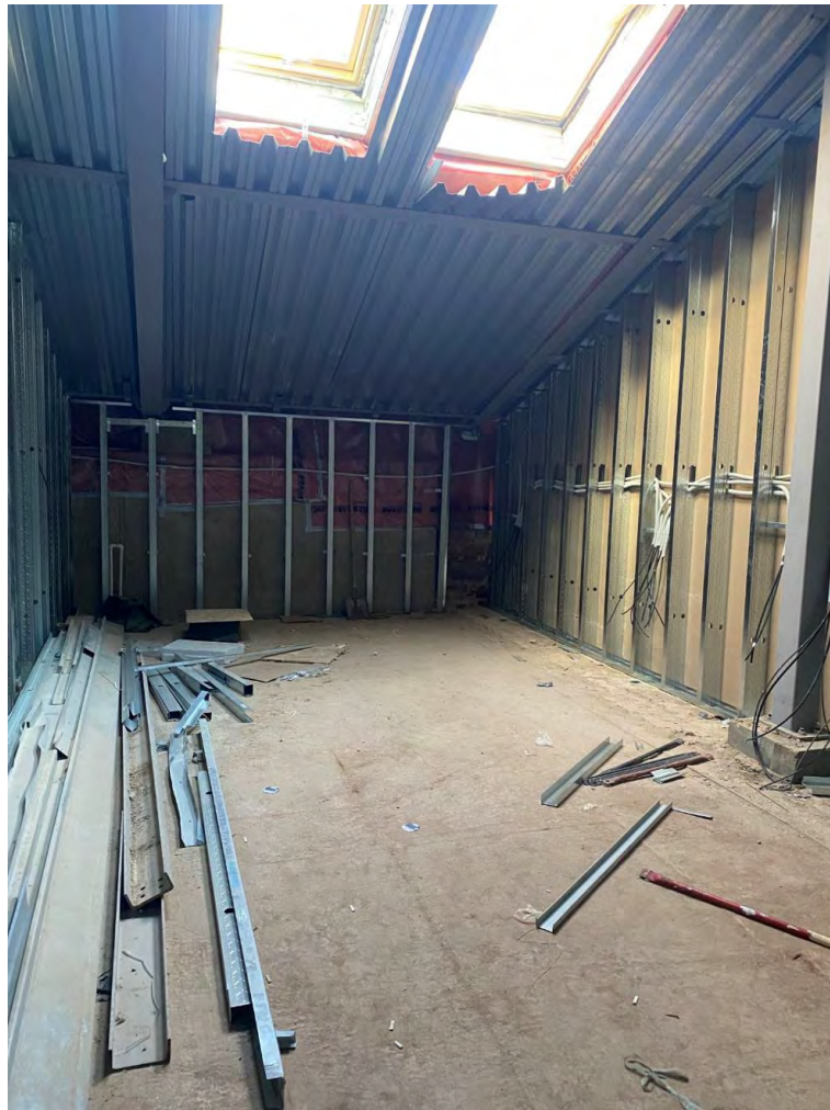
Фото №34. Помещение на мансарде. Сентябрь 2024г.
