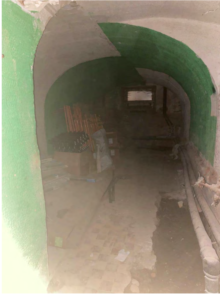
Фото №49. Помещение цокольного этажа. Сентябрь 2024г.
