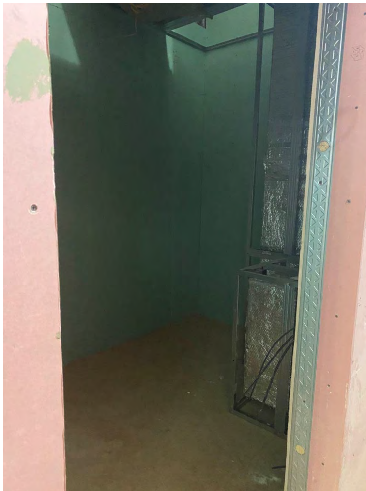
Фото №8. Помещение первого этажа. Сентябрь 2024г.
