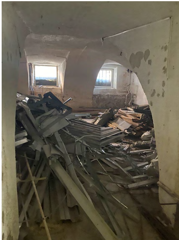
Фото №48. Помещение цокольного этажа. Сентябрь 2024г.
