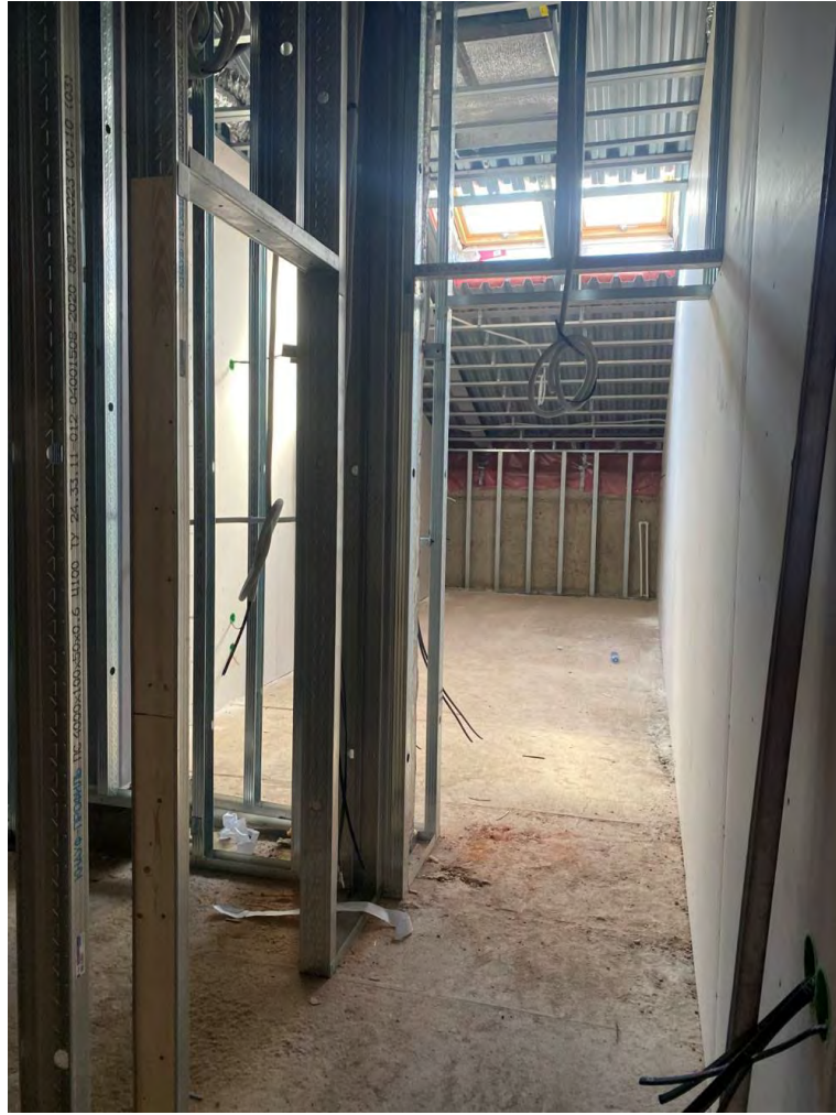
Фото №38. Помещение на мансарде. Сентябрь 2024г.
