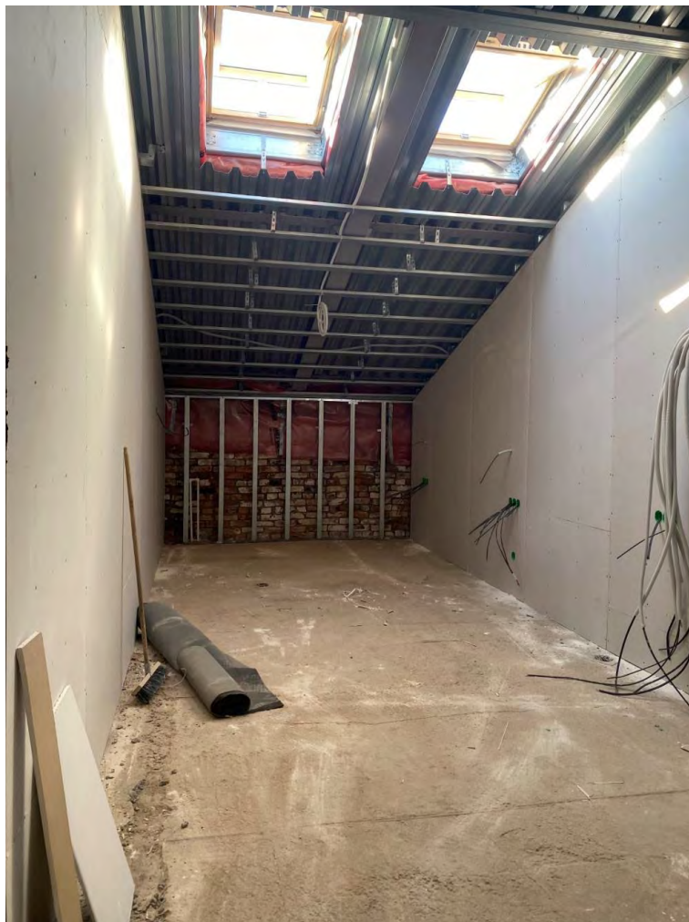
Фото №35. Помещение на мансарде. Сентябрь 2024г.
