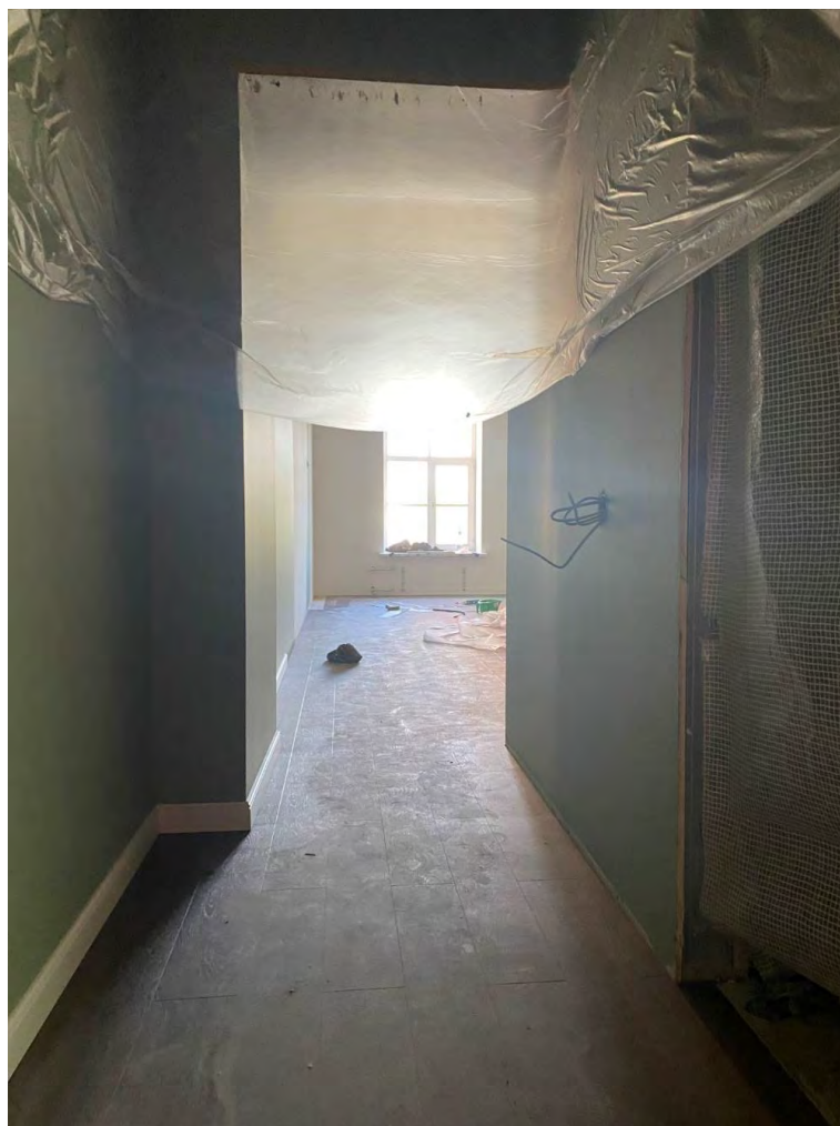
Фото №15. Помещение на втором этаже. Сентябрь 2024г.
