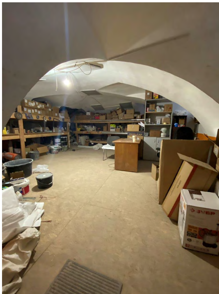
Фото №51. Помещение цокольного этажа. Сентябрь 2024г.
