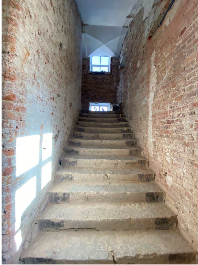
Фото №12. Лестница по правой оси с первого этажа на второй. Сентябрь 2024г.
