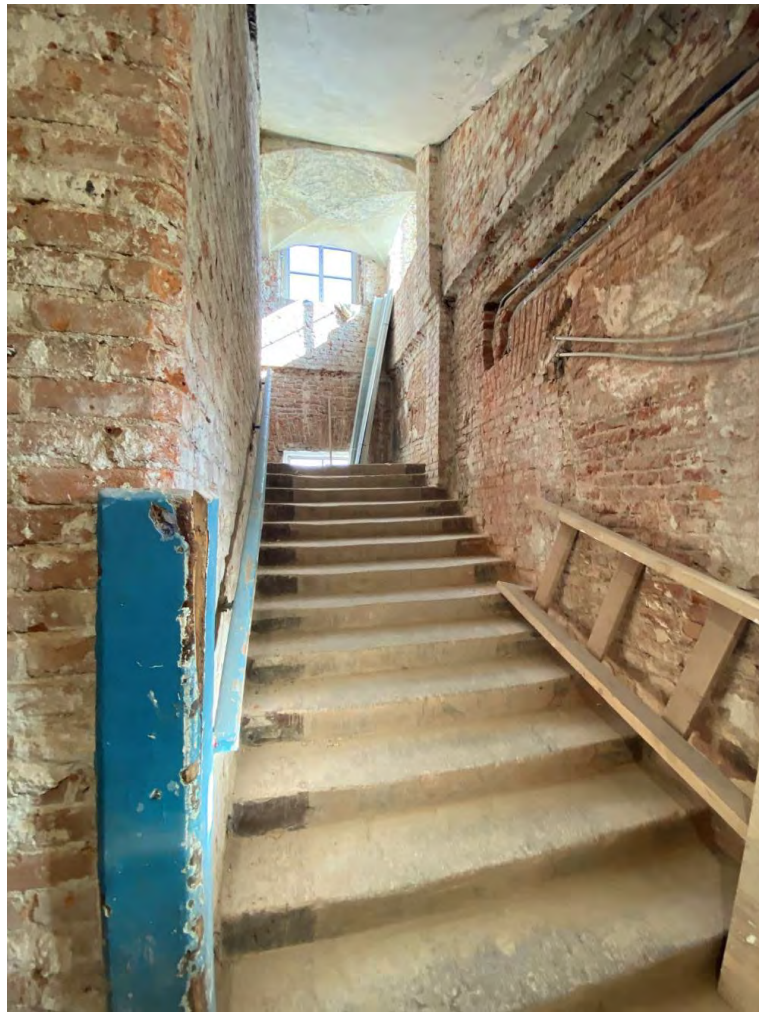
Фото №20 Лестница по правой оси со второго на третий этаж. Сентябрь 2024г.
