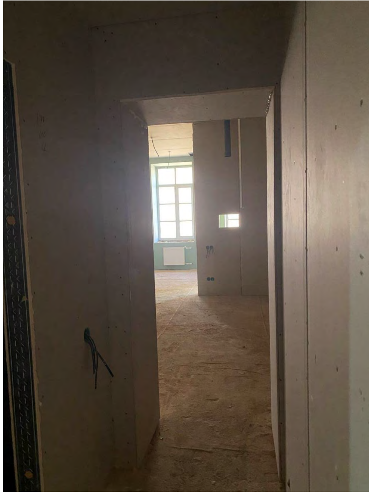
Фото №25. Помещение на третьем этаже. Сентябрь 2024г.
