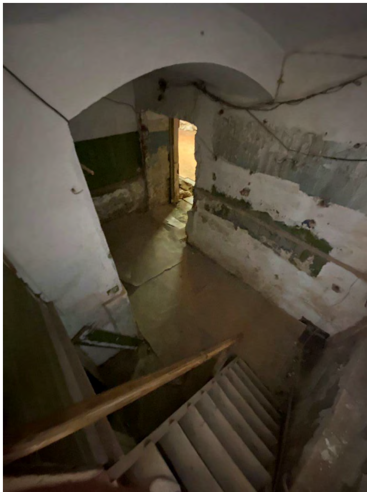
Фото №52. Лестница с первого этажа на цокольный. Сентябрь 2024г.
