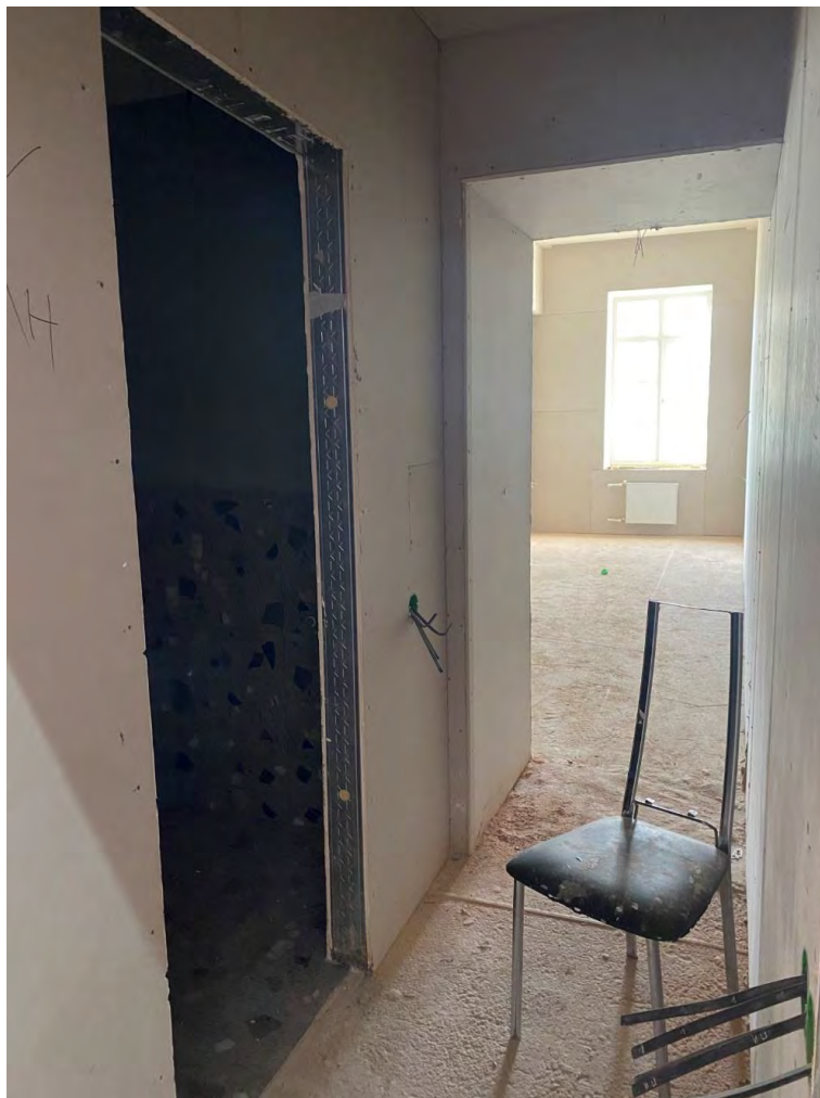
Фото №9. Помещение первого этажа. Сентябрь 2024г.
