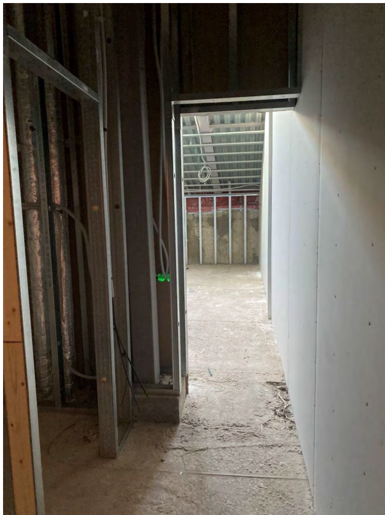
Фото №37. Помещение на мансарде. Сентябрь 2024г.
