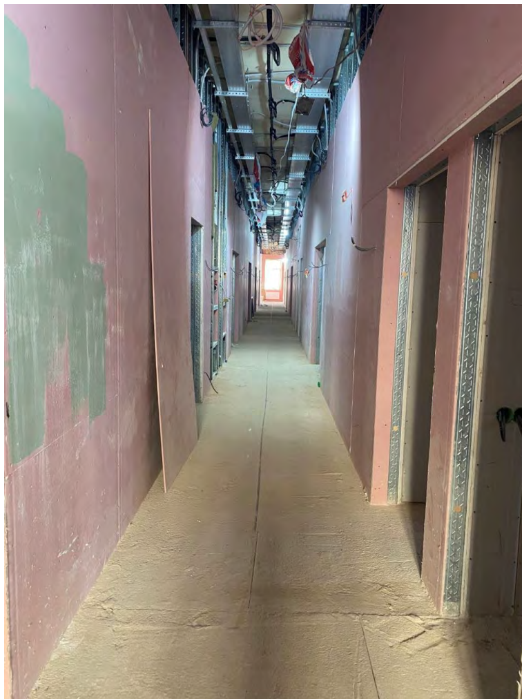
Фото №5 Коридор первого этажа. Сентябрь 2024г.
