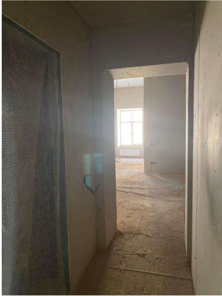
Фото №17. Помещение на втором этаже. Сентябрь 2024г.
