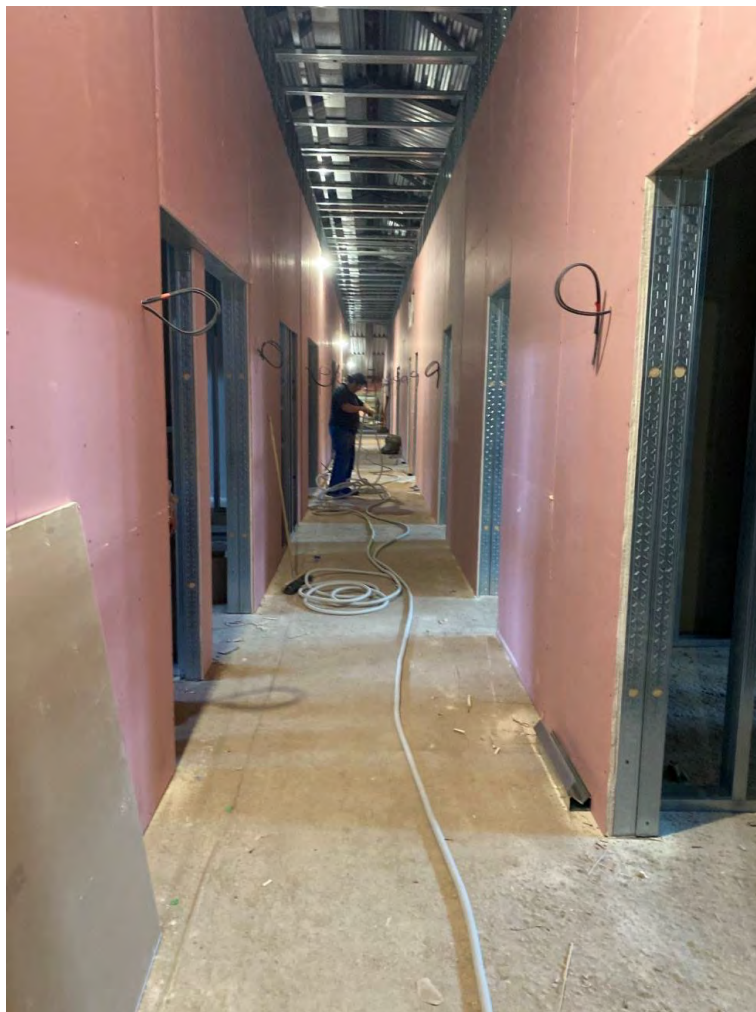
Фото №39. Коридор в мансарде. Сентябрь 2024г.
