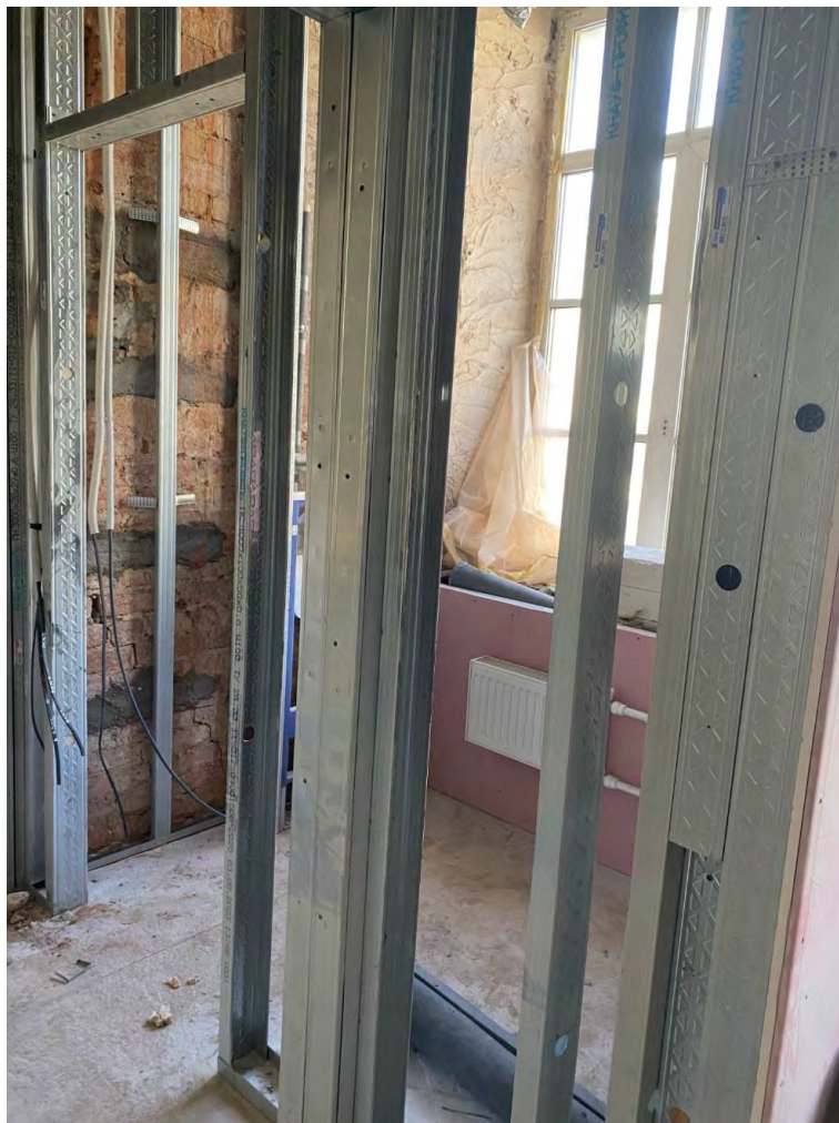
Фото №28. Помещение на третьем этаже. Сентябрь 2024г.
