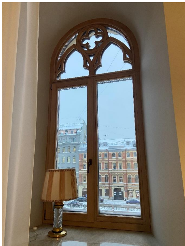
Фото 7. Заполнение оконного проема.
