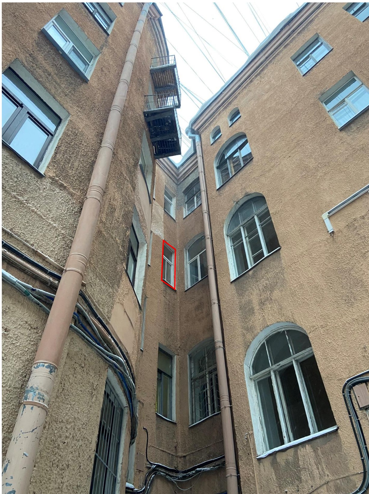
Фото 4. Вид на дворовый фасад.
