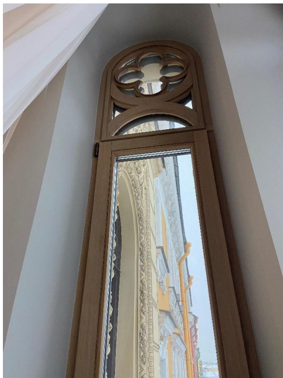
Фото 9. Заполнение оконного проема.
