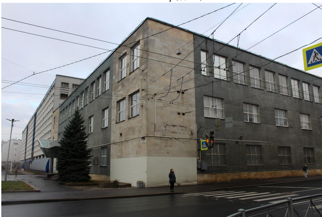
Фото 12. Вид на юго-восточный угол нежилого здания по адресу: Большой Сампсониевский пр., д. 32, лит. А.
