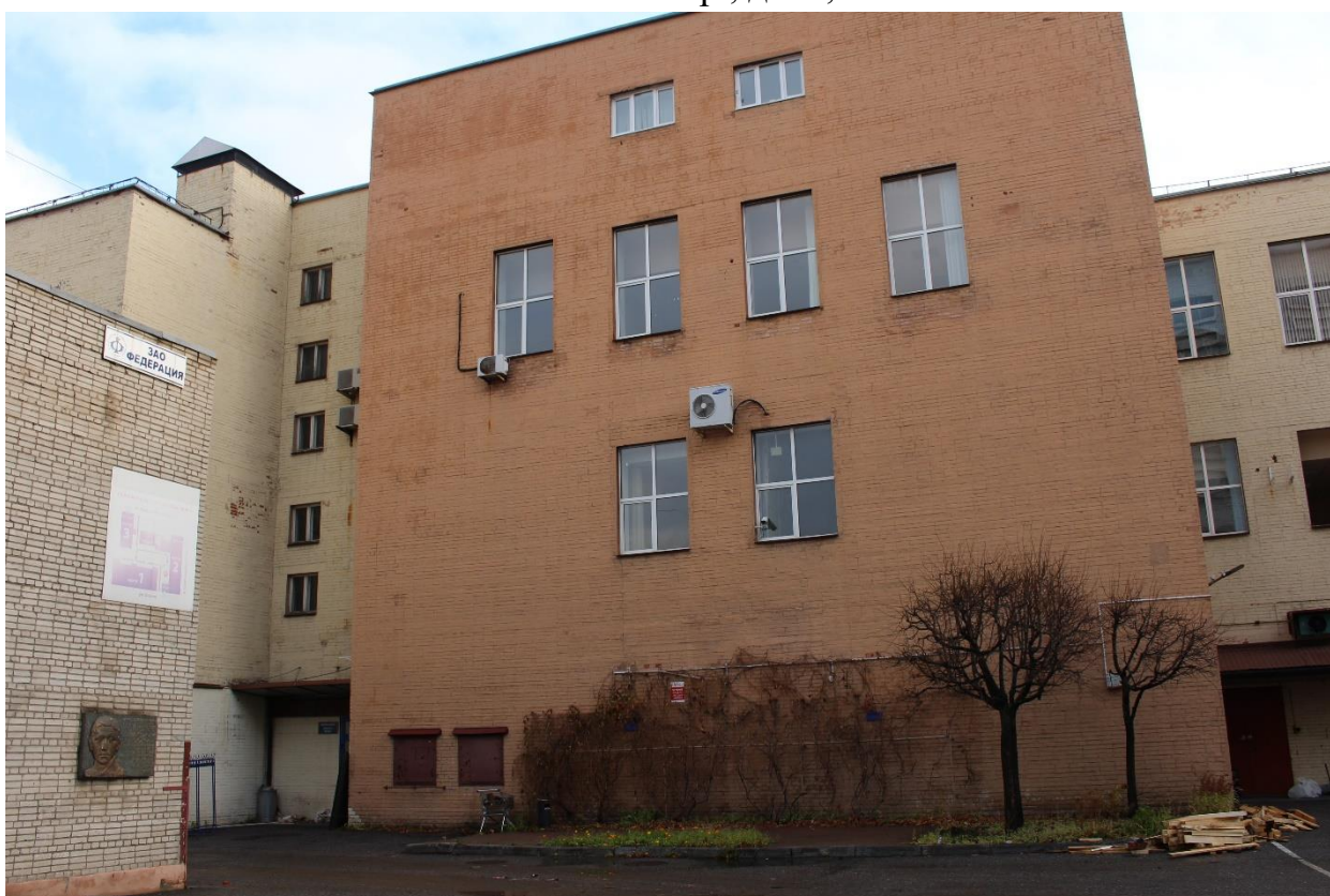
Фото 18. Вид на западный фасад нежилого здания по адресу: Большой Сампсониевский пр., д. 32, лит. А.
