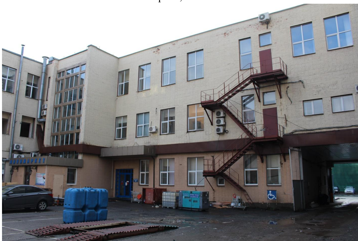
Фото 16. Вид на северный фасад юго-западной части нежилого здания по адресу: Большой Сампсониевский пр., д. 32, лит. А.
