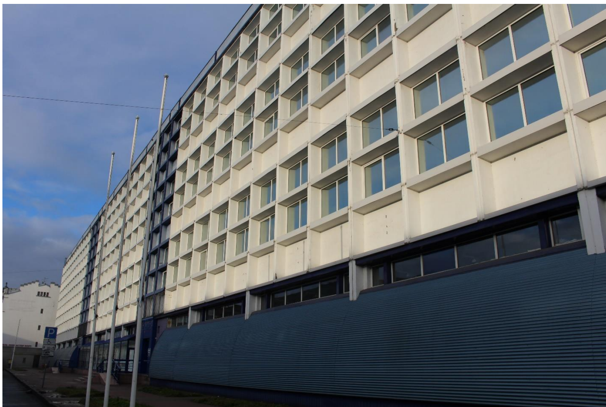
Фото 15. Вид на южный фасад нежилого здания по адресу: ул. Фокина, д. 1, корп. 1, лит. А.
