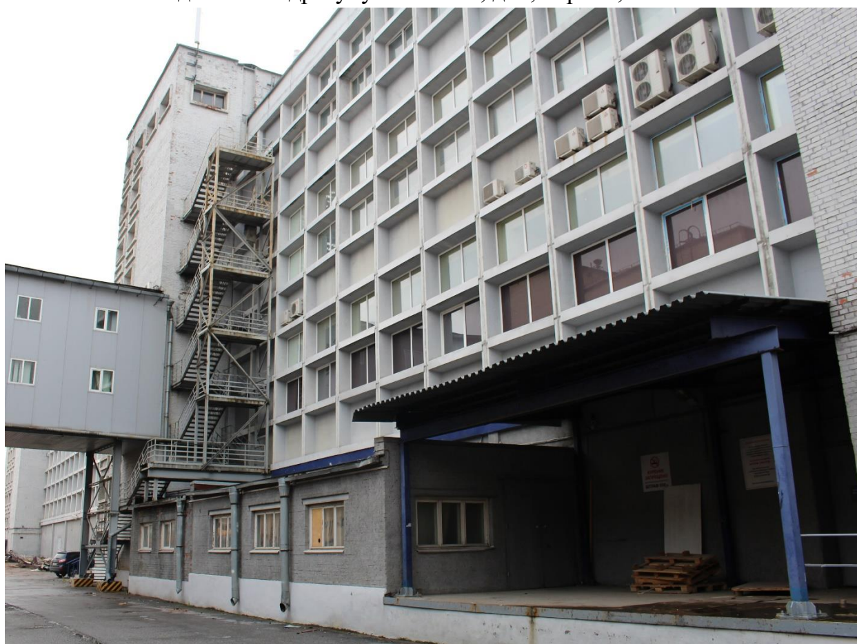
Фото 20. Вид на северный фасад нежилого здания по адресу: ул. Фокина, д. 1, корп. 1, лит. А.
