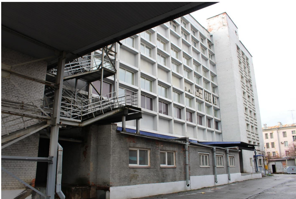
Фото 21. Вид на северный фасад нежилого здания по адресу: ул. Фокина, д. 1, корп. 1, лит. А.
