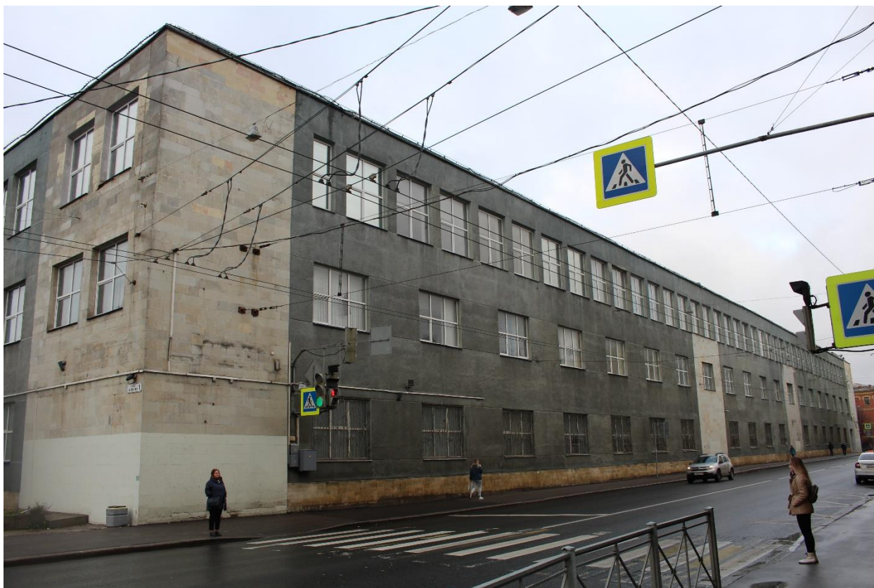
Фото 11. Вид на восточный фасад нежилого здания по адресу: Большой Сампсониевский пр., д. 32, лит. А.
