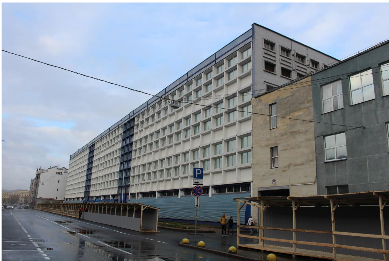
Фото 13. Вид на южный фасад нежилого здания по адресу: ул. Фокина, д. 1, корп. 1, лит. А.
