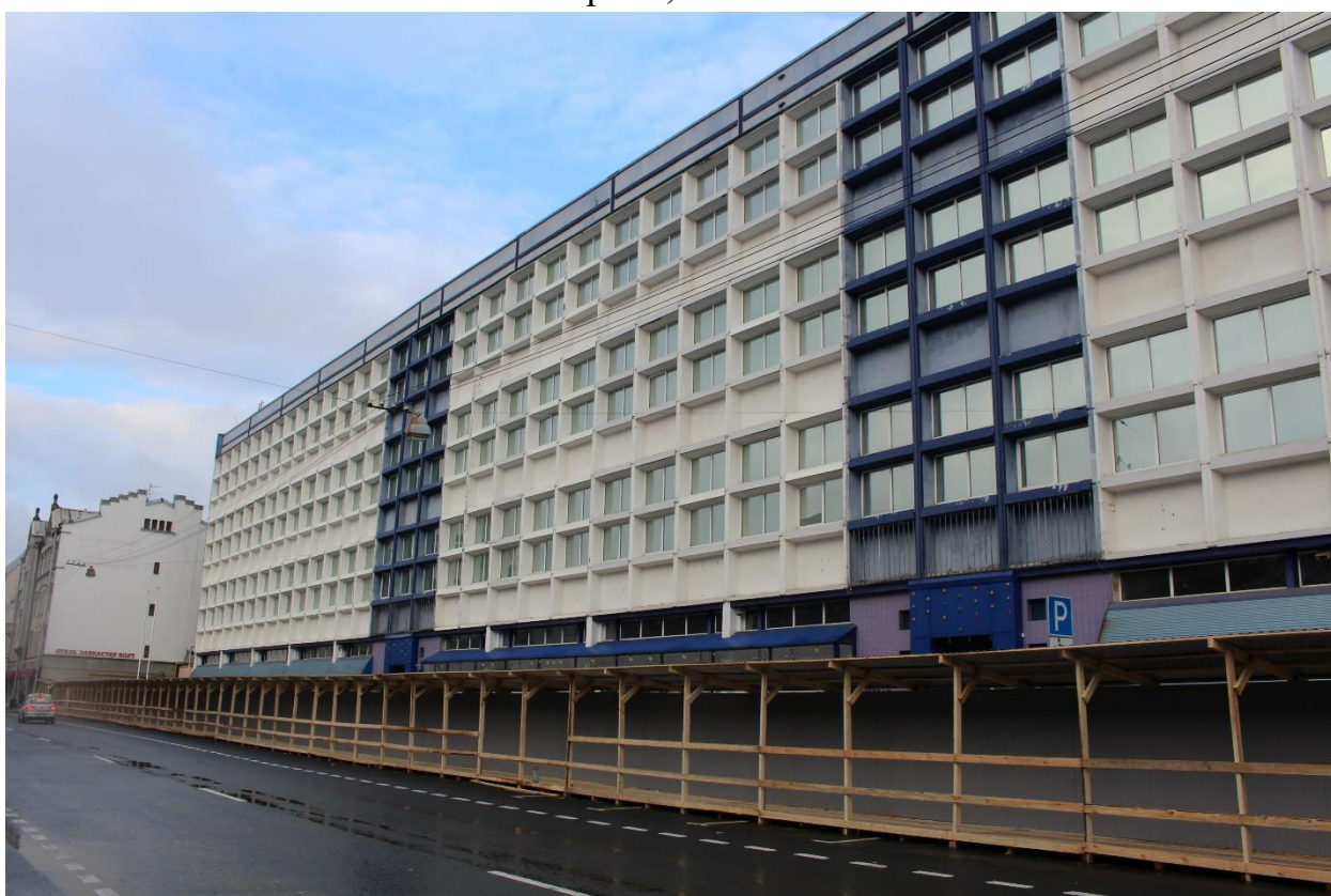
Фото 14. Вид на южный фасад нежилого здания по адресу: ул. Фокина, д. 1, корп. 1, лит. А.
