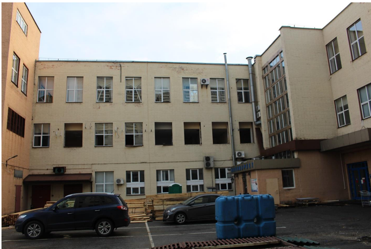
Фото 17. Вид на западный фасад нежилого здания по адресу: Большой Сампсониевский пр., д. 32, лит. А.
