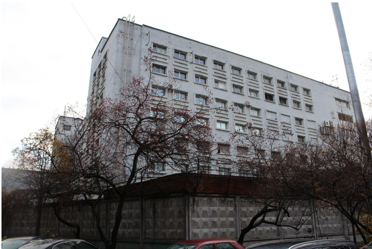
Фото 7. Вид на западный фасад нежилого здания по адресу: ул. Фокина, д. 1, корп. 1, лит. А.
