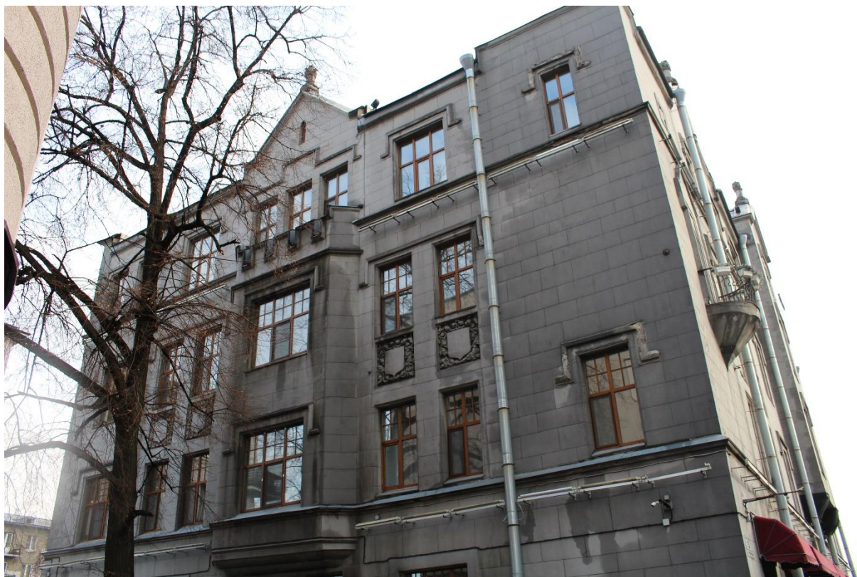
Фото 5. Вид на западный фасад выявленного объекта культурного наследия «Жилое и конторское здание Товарищества Сампсониевской бумагопрядильной мануфактуры».
