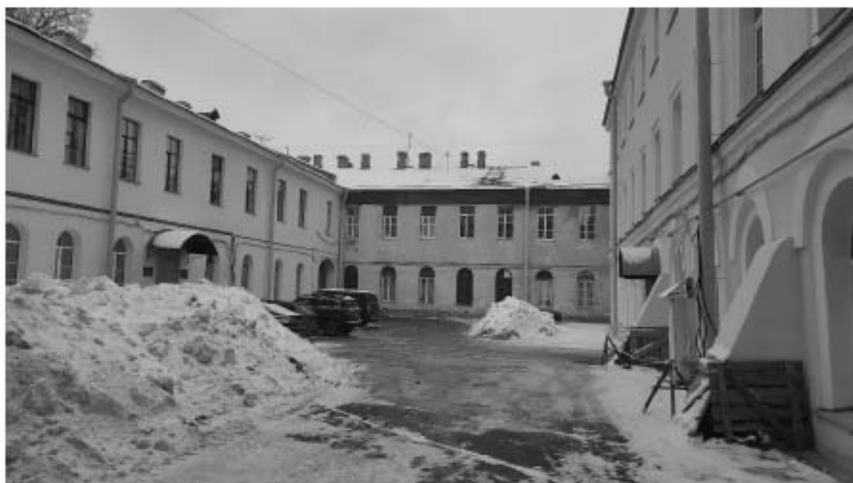
Фото 39. Дворовое пространство объекта культурного наследия федерального значения
