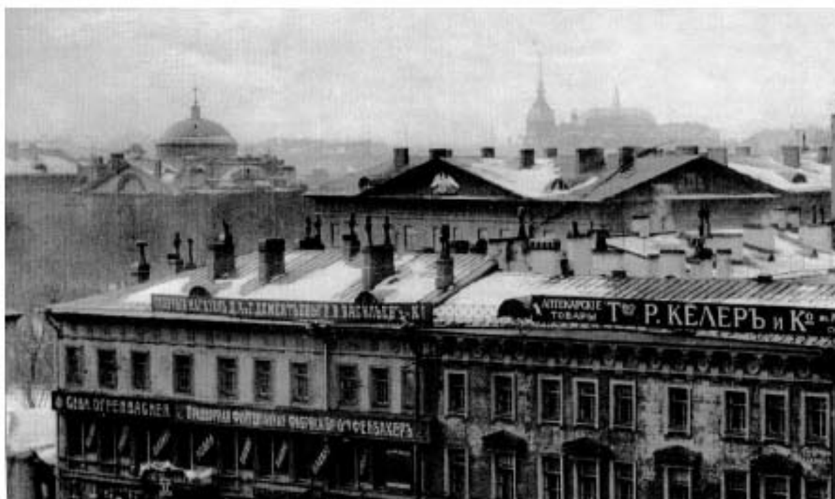
15. Санкт-Петербургский Императорский Воспитательный дом (Санкт-Петербургский Сиротский Институт Императора Николая I). Церковь Покрова Пресвятой Богородицы. Фотография. Начало XX в. http://www.citywalls.ru .
