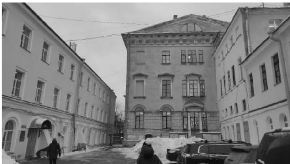
Фото 38. Дворовое пространство объекта культурного наследия федерального значения
