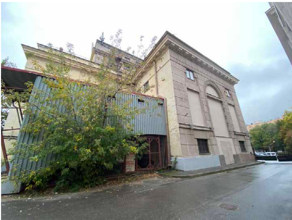
Фото 1. Вид части объекта культурного наследия регионального значения «Александровский парк (парк им.В.И.Ленина)» (участок проведения работ)
