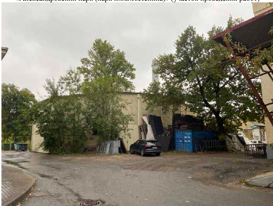
Фото 2. Вид части объекта культурного наследия регионального значения «Александровский парк (парк им.В.И.Ленина)» (участок проведения работ)
