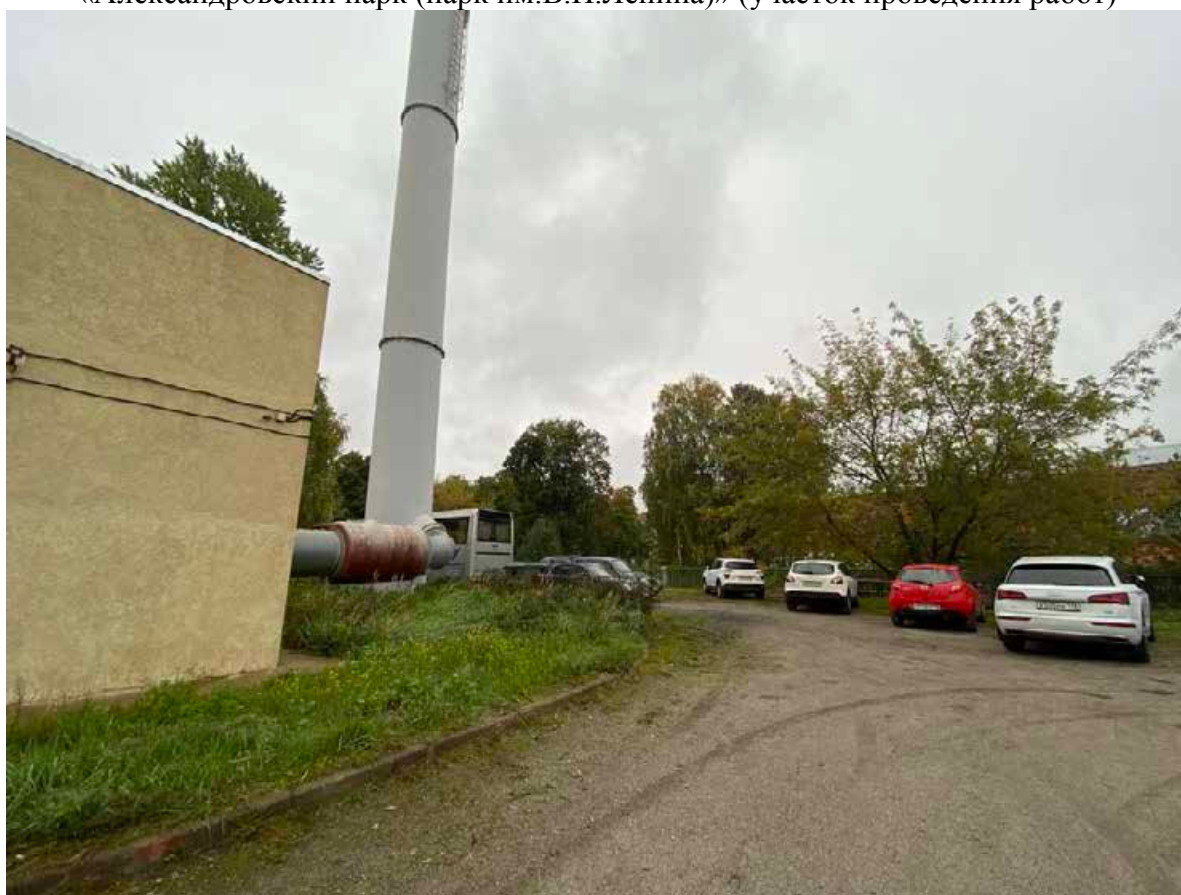
Фото 14. Вид части объекта культурного наследия регионального значения «Александровский парк (парк им.В.И.Ленина)» (участок проведения работ)
