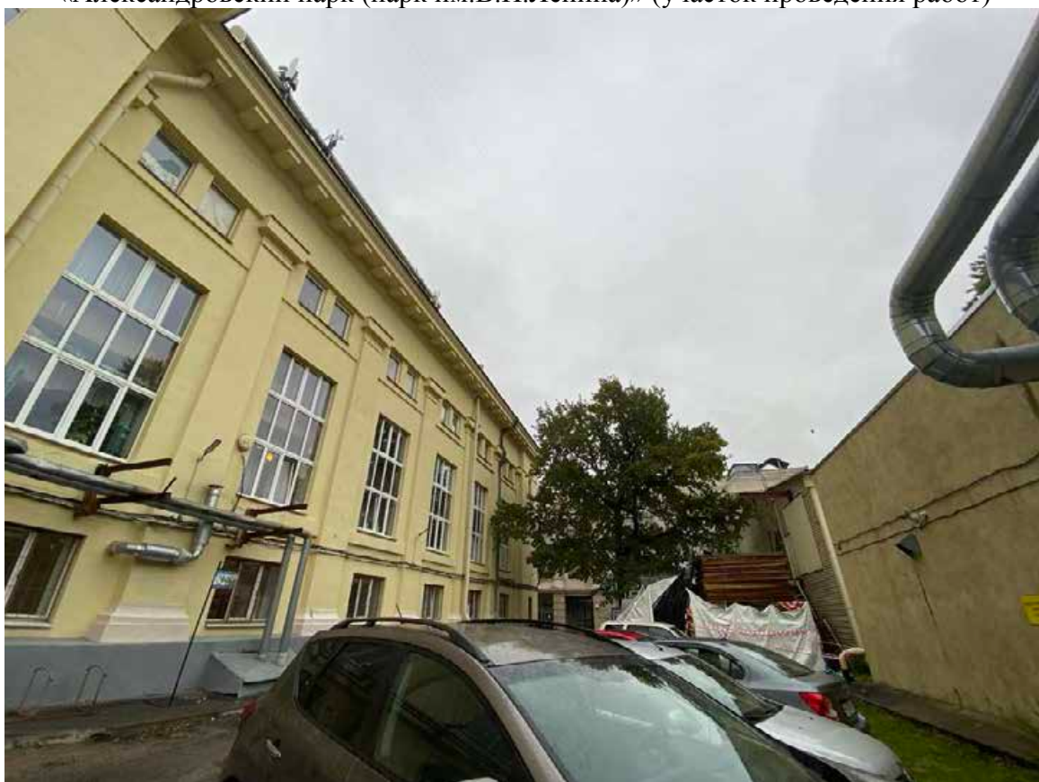
Фото 6. Вид части объекта культурного наследия регионального значения «Александровский парк (парк им.В.И.Ленина)» (участок проведения работ)
