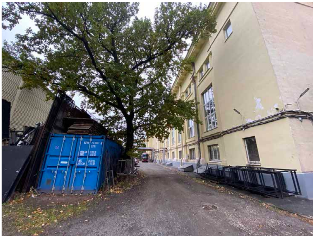
Фото 5. Вид части объекта культурного наследия регионального значения «Александровский парк (парк им.В.И.Ленина)» (участок проведения работ)
