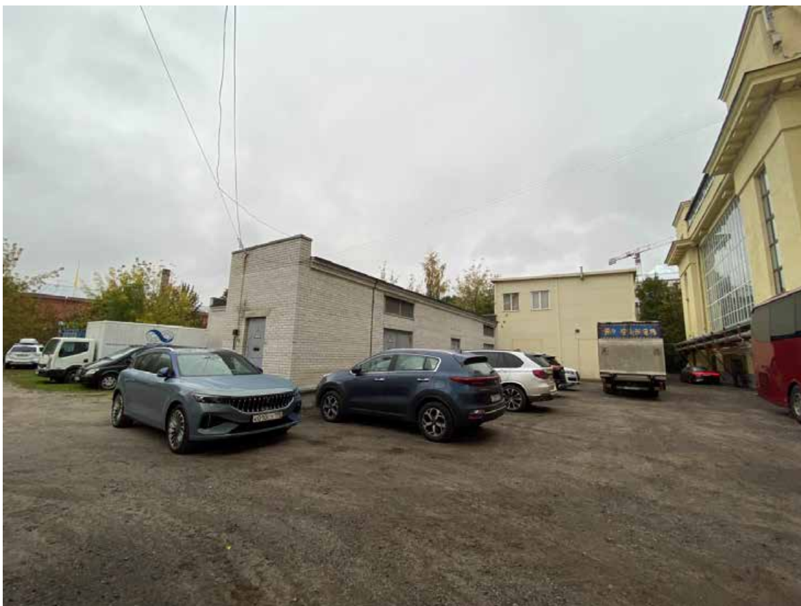
Фото 7. Вид части объекта культурного наследия регионального значения «Александровский парк (парк им.В.И.Ленина)» (участок проведения работ)
