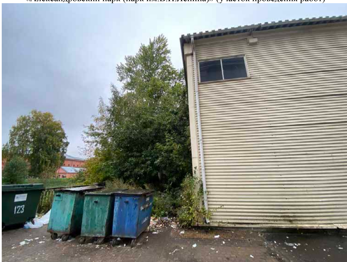
Фото 4. Вид части объекта культурного наследия регионального значения «Александровский парк (парк им.В.И.Ленина)» (участок проведения работ)
