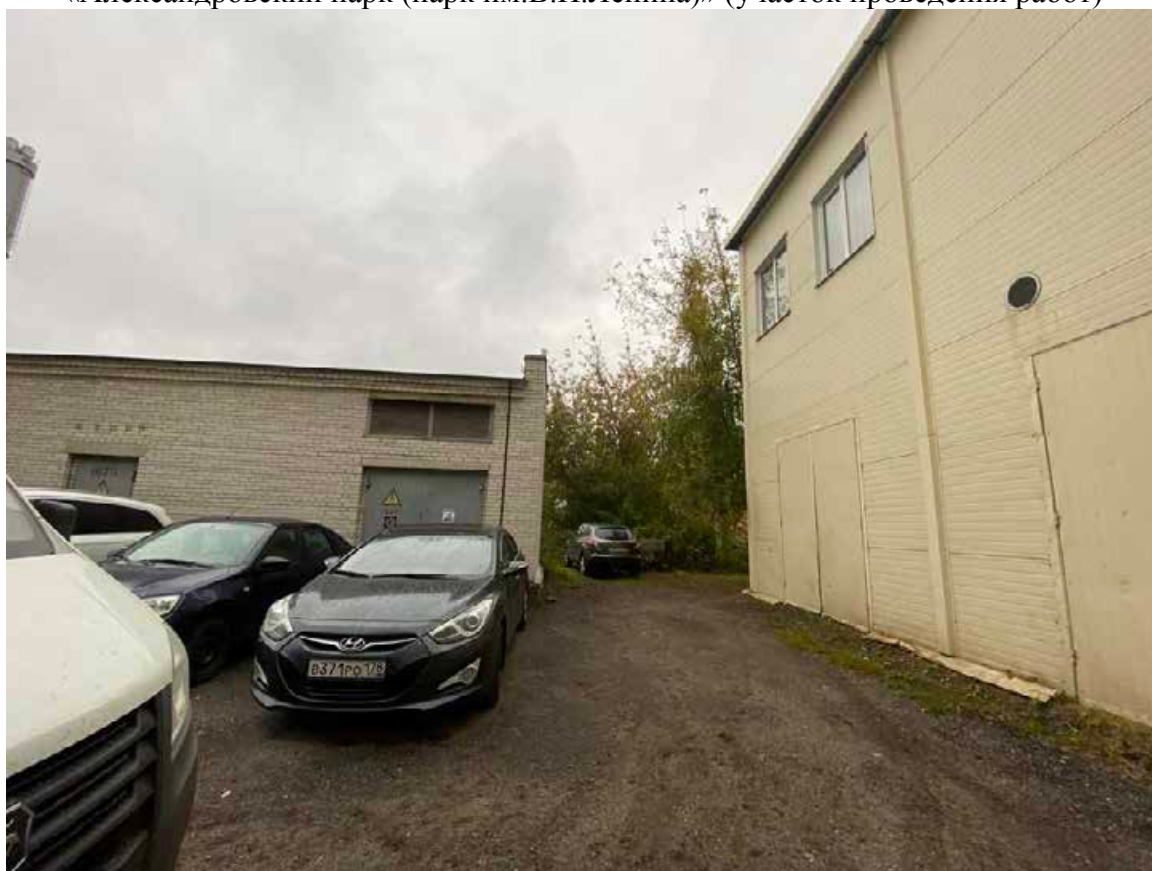
Фото 8. Вид части объекта культурного наследия регионального значения «Александровский парк (парк им.В.И.Ленина)» (участок проведения работ)
