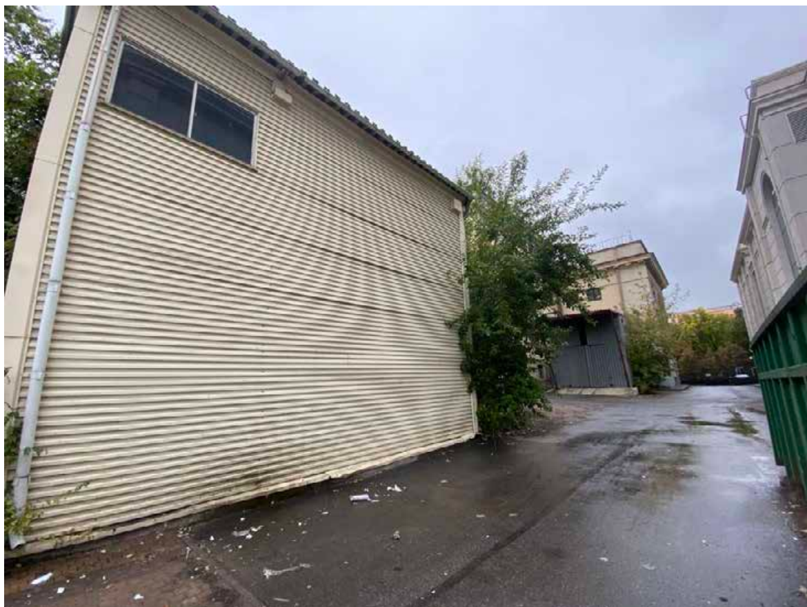
Фото 3. Вид части объекта культурного наследия регионального значения «Александровский парк (парк им.В.И.Ленина)» (участок проведения работ)
