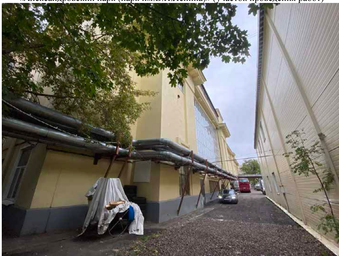
Фото 10. Вид части объекта культурного наследия регионального значения «Александровский парк (парк им.В.И.Ленина)» (участок проведения работ)
