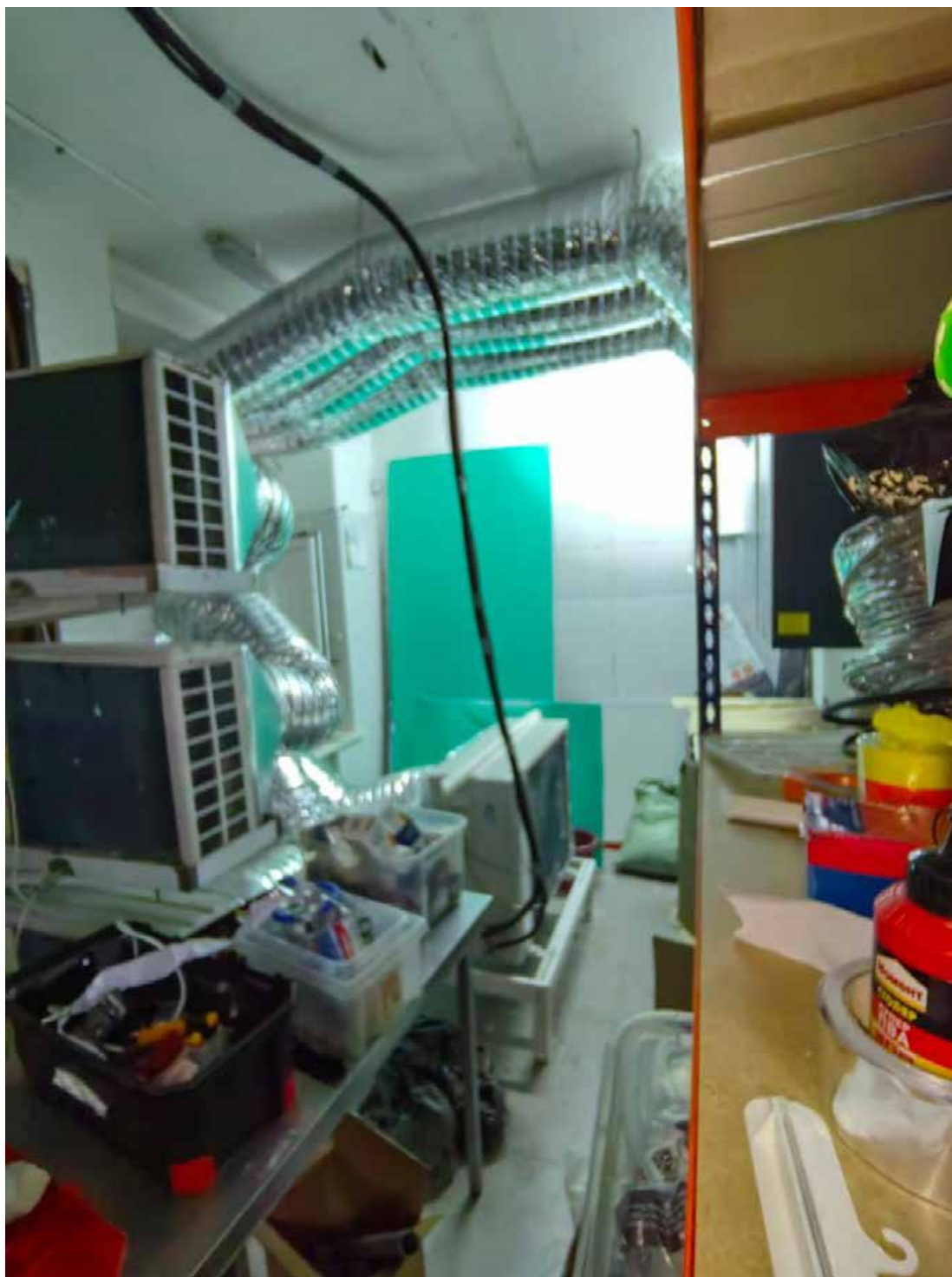
28. «Дом П.Г.Гулина». Санкт-Петербург, Средний пр., дом 11, литера А. Фрагмент помещения 1-Н. (предоставлено заказчиком) Фото: 13.01.2025.
