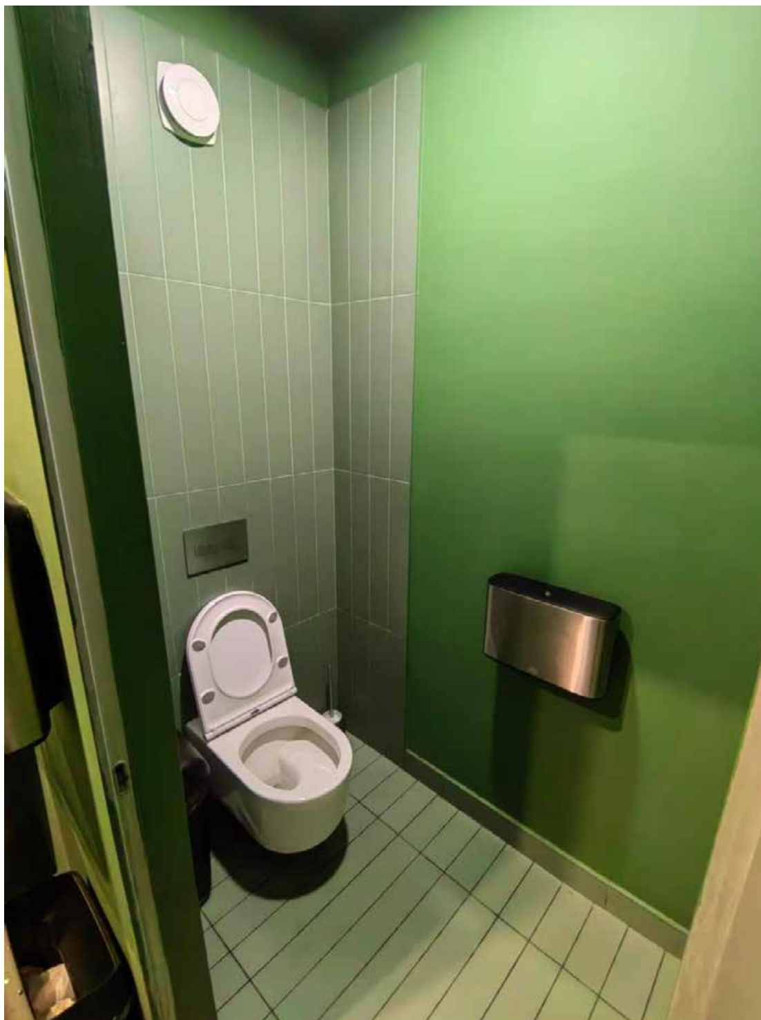
20. «Дом П.Г.Гулина». Санкт-Петербург, Средний пр., дом 11, литера А. Фрагмент помещения 1-Н. (предоставлено заказчиком) Фото: 13.01.2025.
