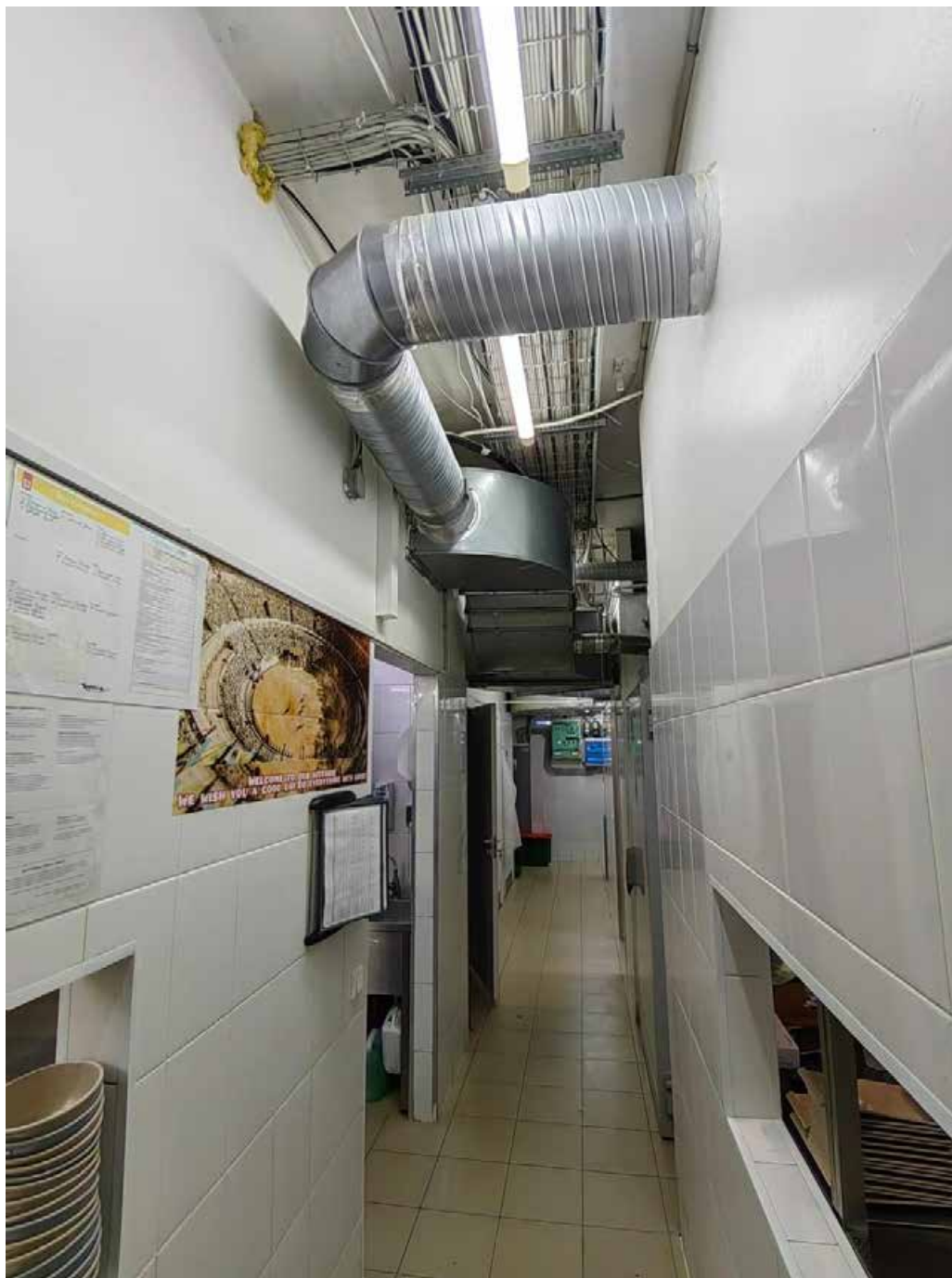
23. «Дом П.Г.Гулина». Санкт-Петербург, Средний пр., дом 11, литера А. Фрагмент помещения 1-Н. (предоставлено заказчиком) Фото: 13.01.2025.
