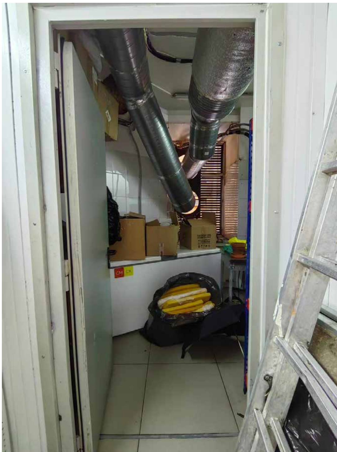
27. «Дом П.Г.Гулина». Санкт-Петербург, Средний пр., дом 11, литера А. Фрагмент помещения 1-Н. (предоставлено заказчиком) Фото: 13.01.2025.
