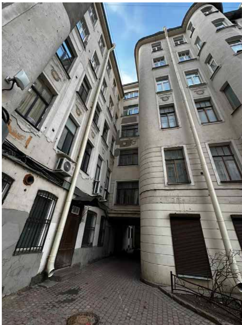
53. Дворовой фасад. Общий вид. Дата съемки: 10.03.2025
