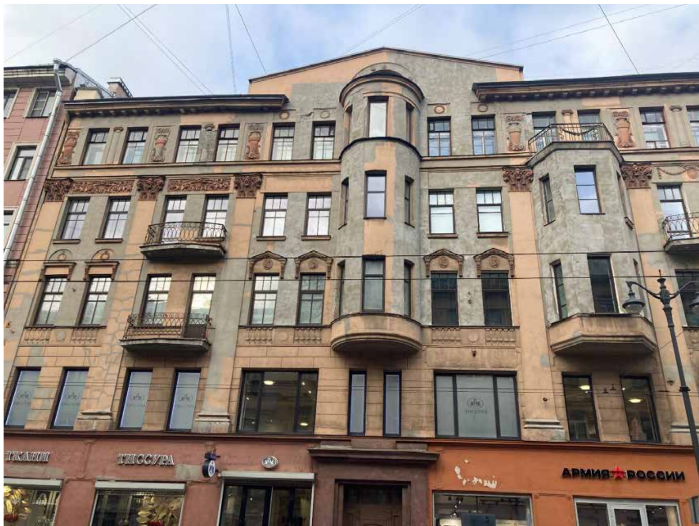
58. Лицевой фасад. Общий вид. Дата съемки: 10.03.2025
