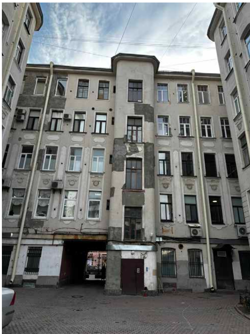
52. Дворовой фасад. Общий вид. Дата съемки: 10.03.2025
