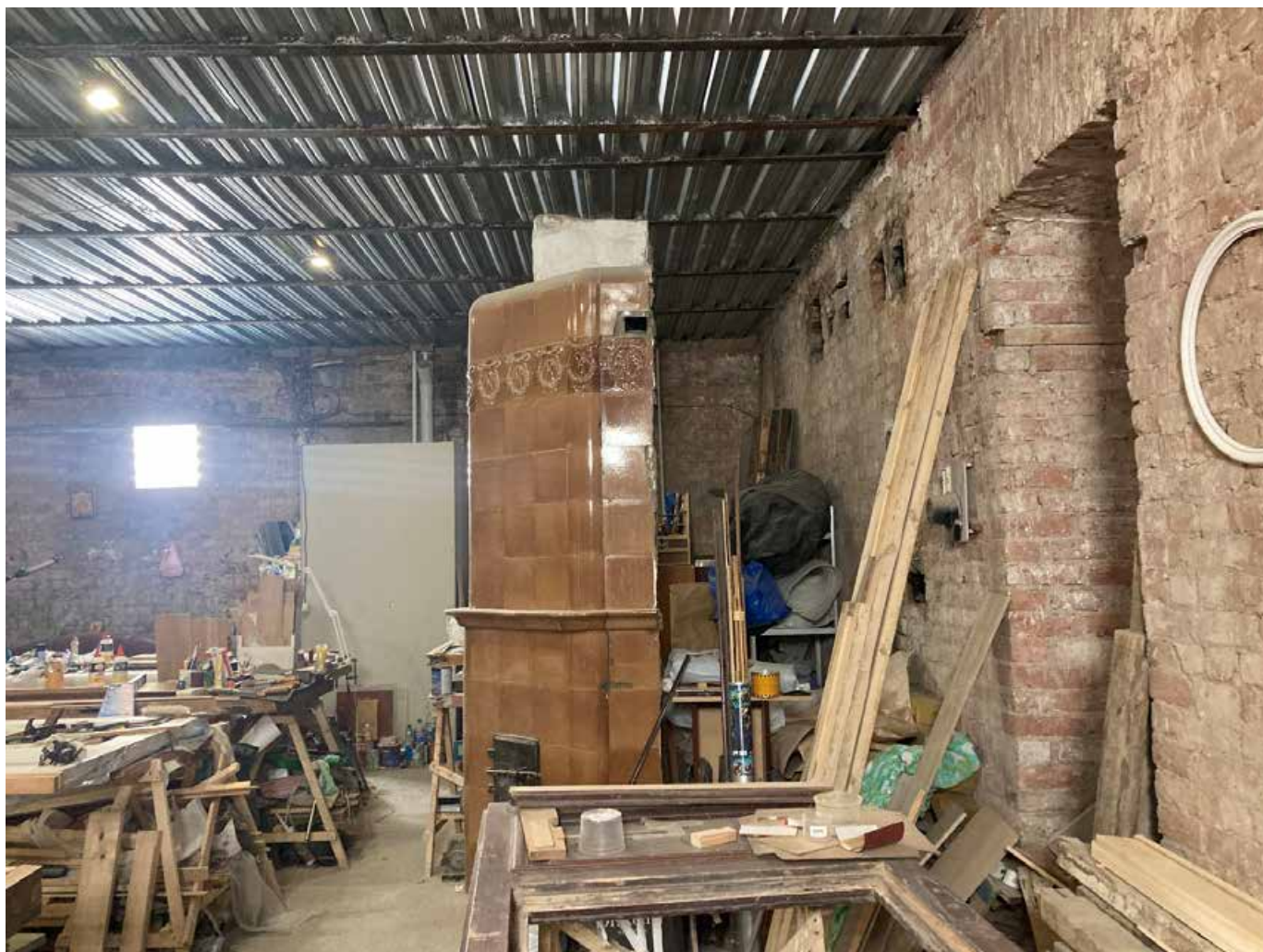
44. Помещение в квартире №15-16. Общий вид. Дата съемки: 10.03.2025
