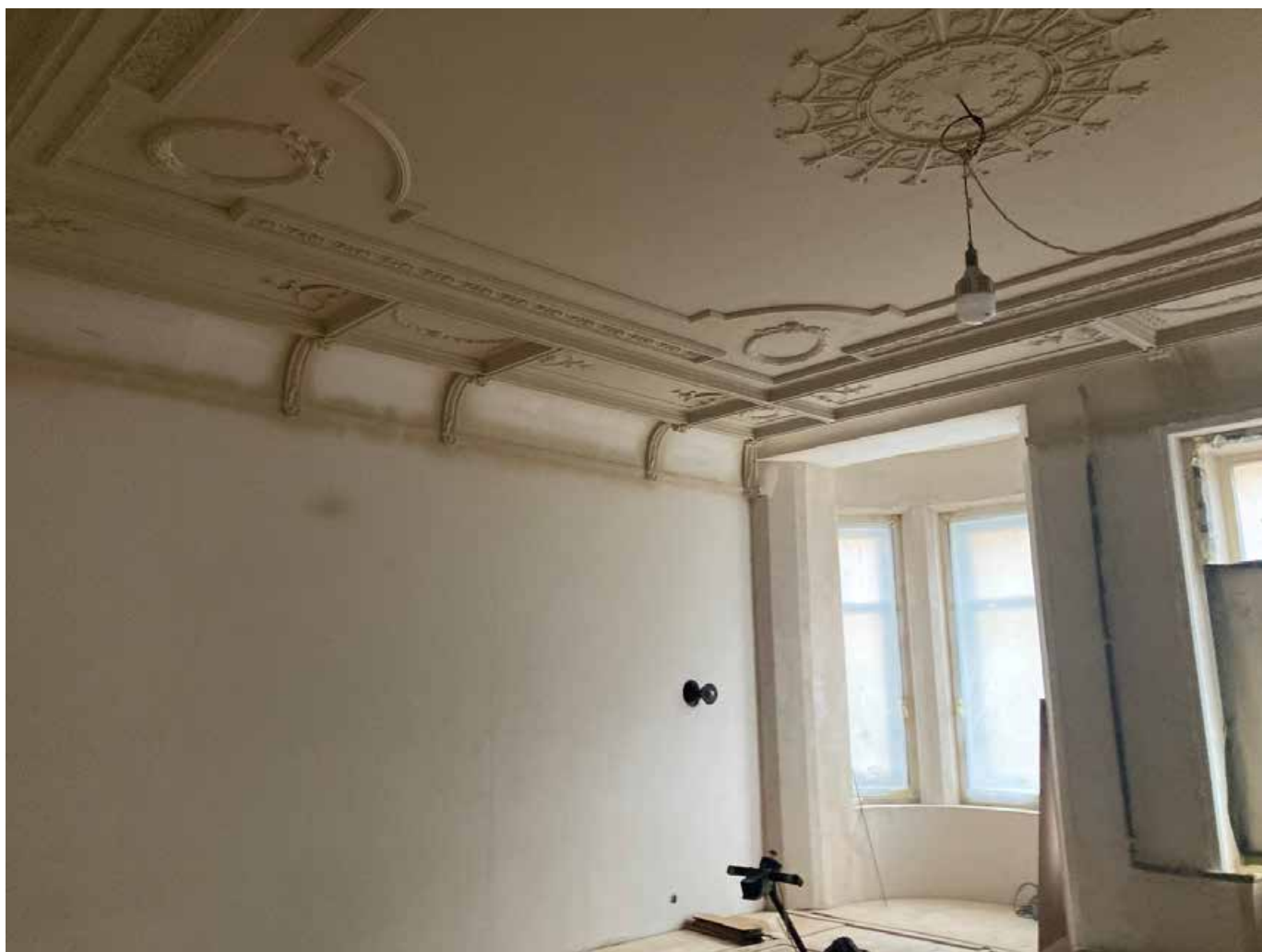
35. Помещение в квартире №17. Общий вид. Дата съемки: 10.03.2025
