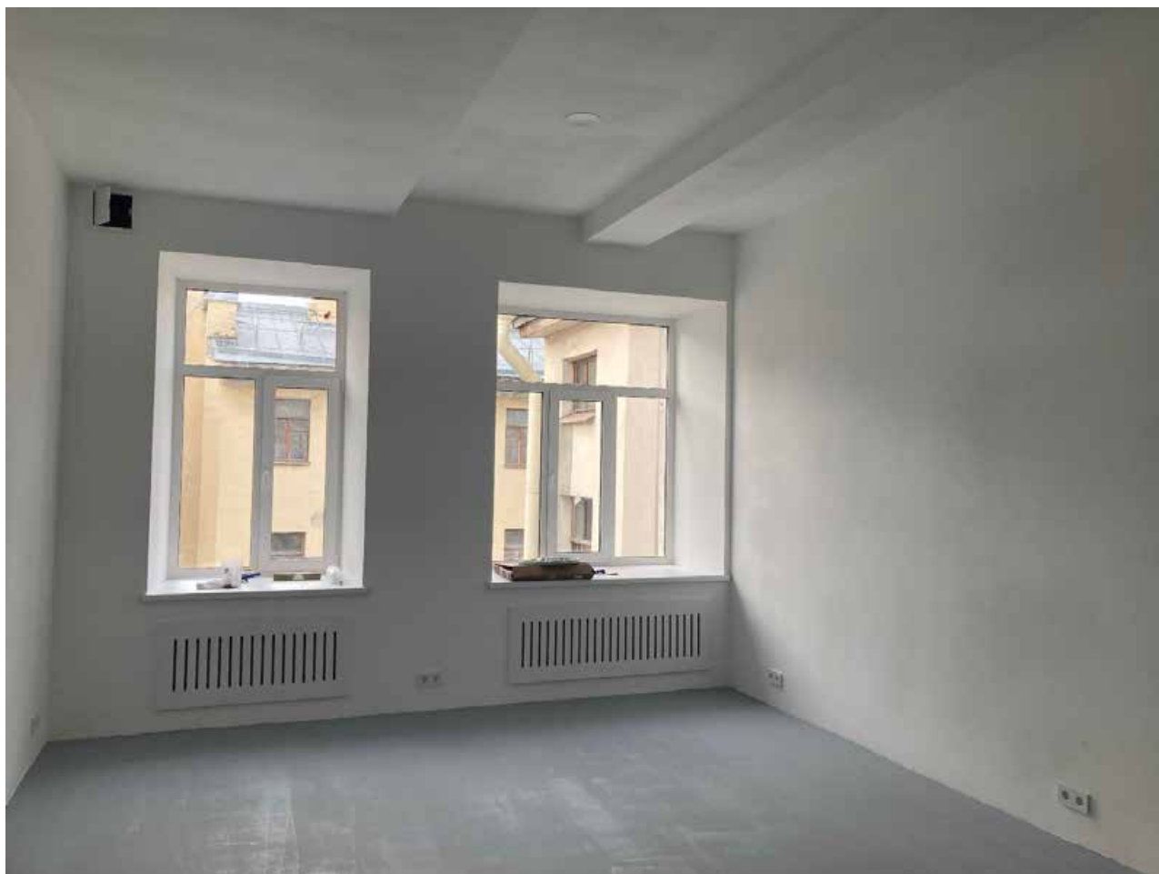
13. Помещение в квартире №25. Общий вид. Дата съемки: 10.03.2025
