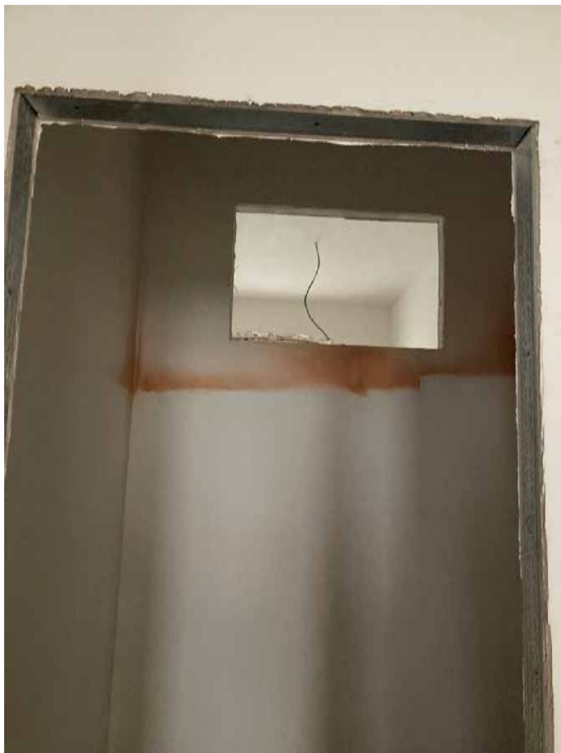
43. Помещение в квартире №17. Общий вид. Дата съемки: 10.03.2025
