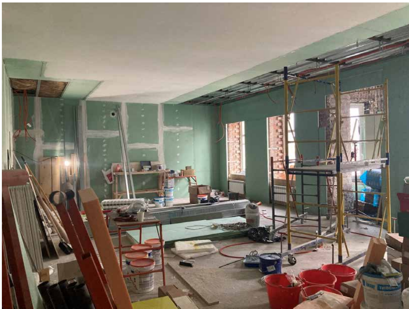
19. Помещение в квартире №22. Общий вид. Дата съемки: 10.03.2025
