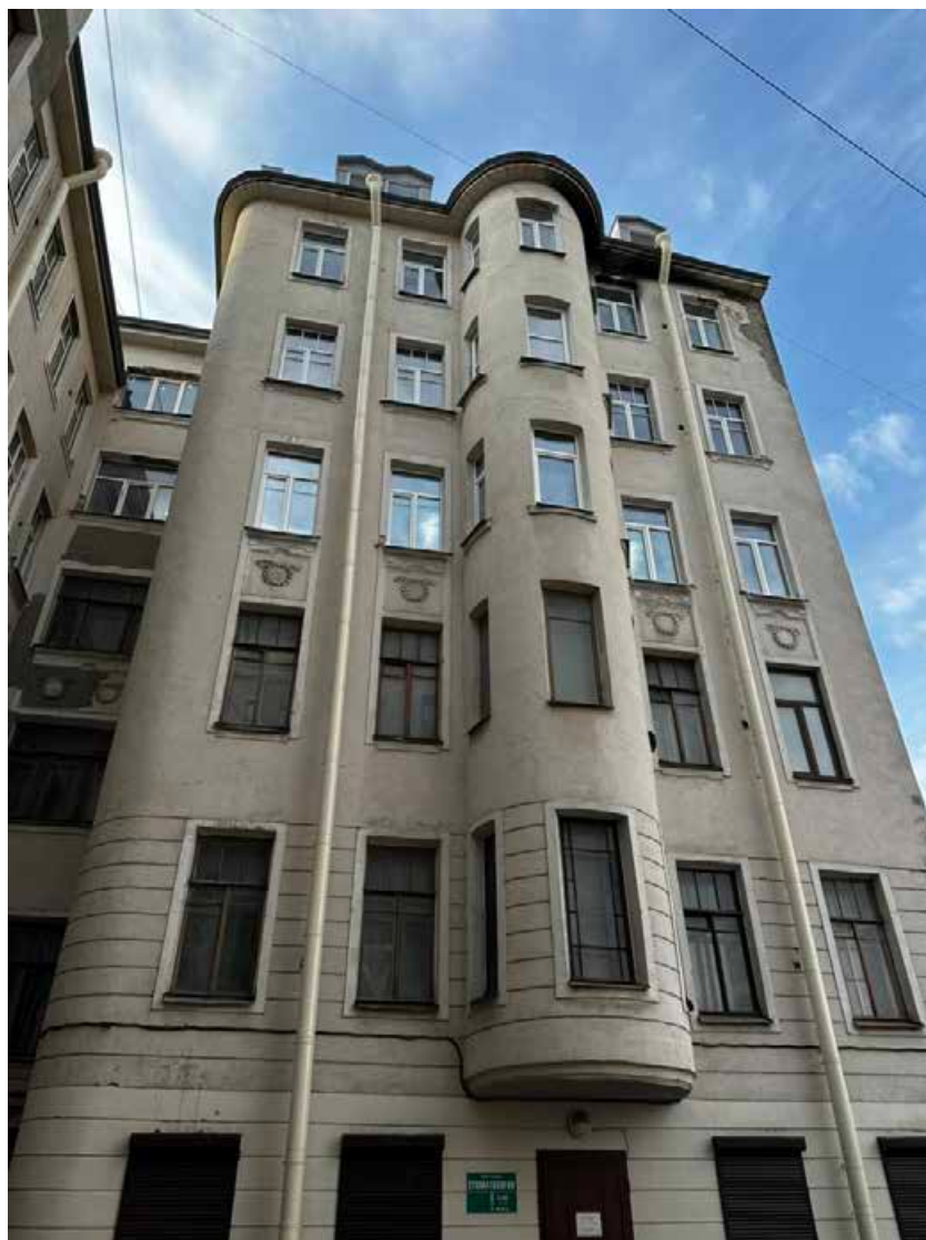
51. Дворовой фасад. Общий вид. Дата съемки: 10.03.2025
