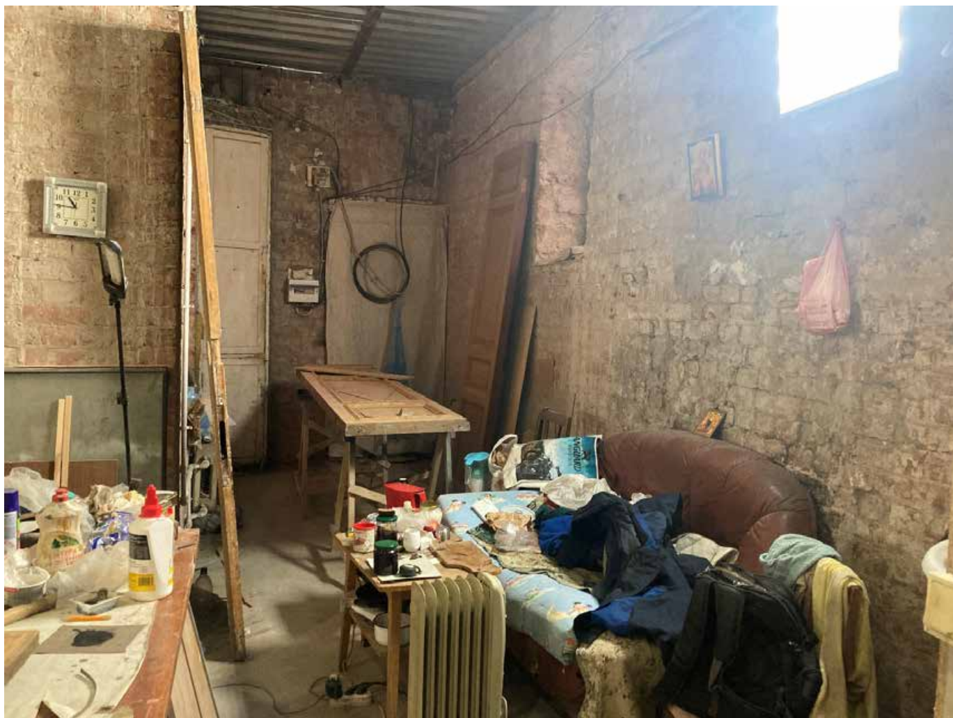
45. Помещение в квартире №15-16. Общий вид. Дата съемки: 10.03.2025
