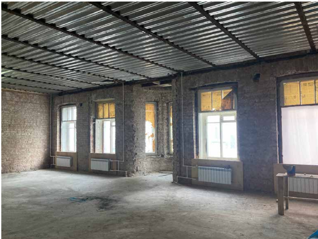
28. Помещение в квартире №19. Общий вид. Дата съемки: 10.03.2025
