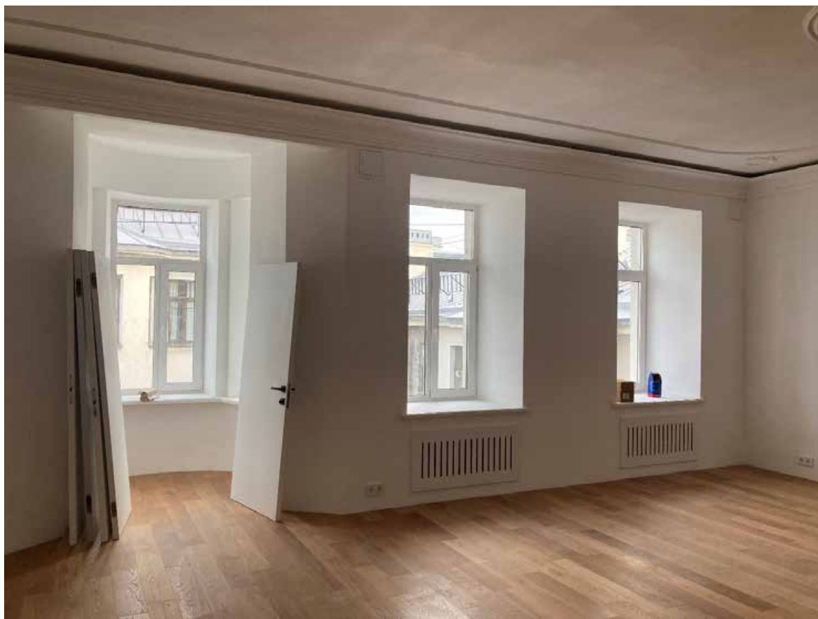
15. Помещение в квартире №25. Общий вид. Дата съемки: 10.03.2025
