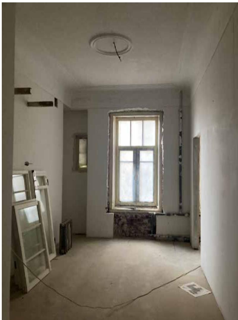
41. Помещение в квартире №17. Общий вид. Дата съемки: 10.03.2025
