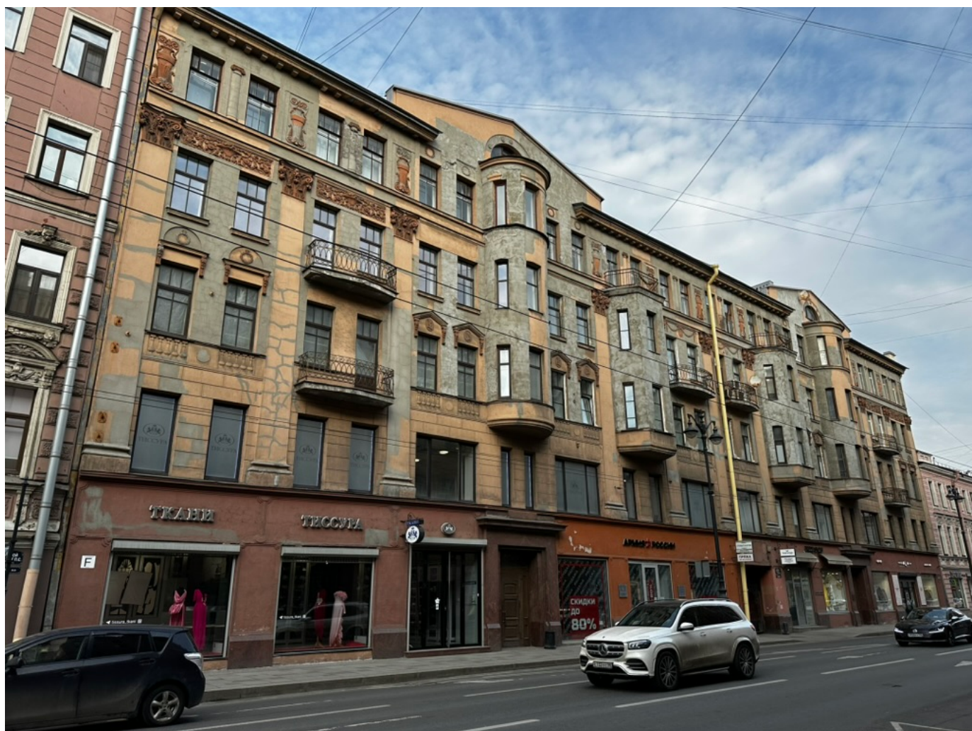
57. Лицевой фасад. Общий вид. Дата съемки: 10.03.2025
