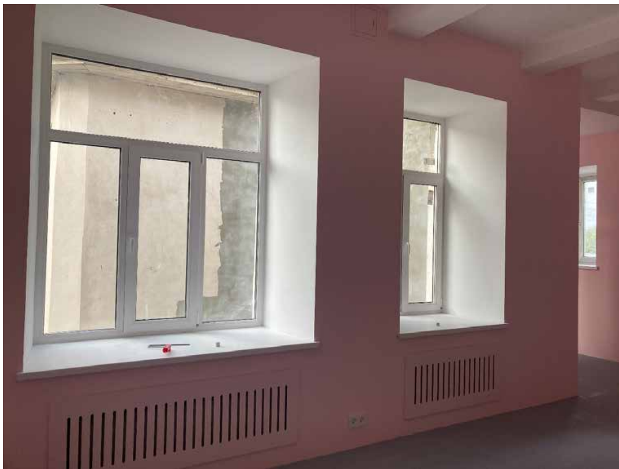
16. Помещение в квартире №25. Общий вид. Дата съемки: 10.03.2025
