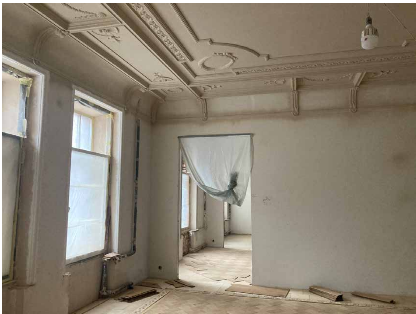
37. Помещение в квартире №17. Общий вид. Дата съемки: 10.03.2025
