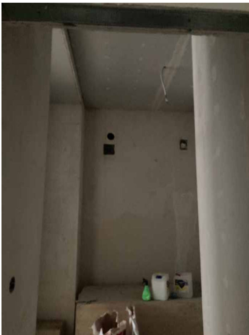
40. Помещение в квартире №17. Общий вид. Дата съемки: 10.03.2025
