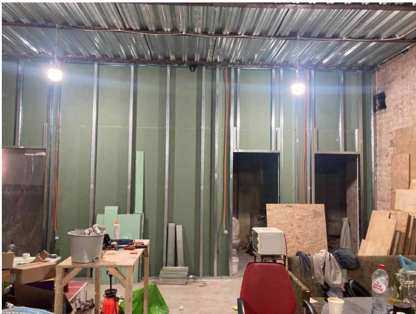
50. Помещение в квартире №12. Общий вид. Дата съемки: 10.03.2025
