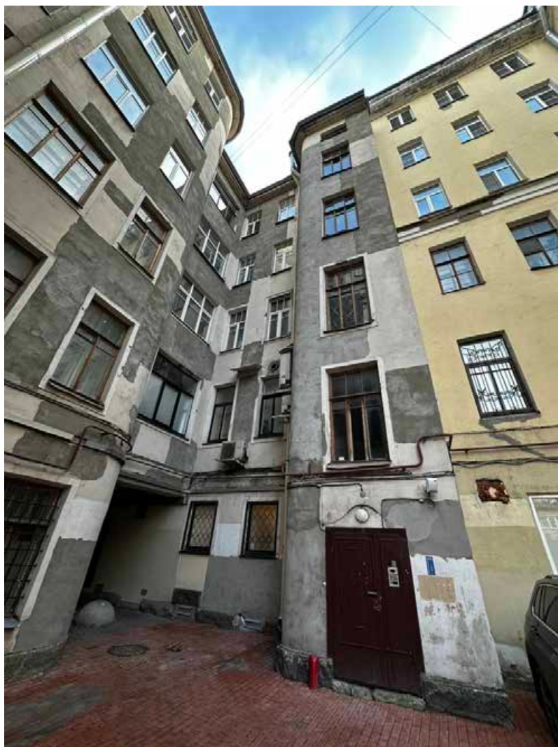
54. Дворовой фасад. Общий вид. Дата съемки: 10.03.2025
