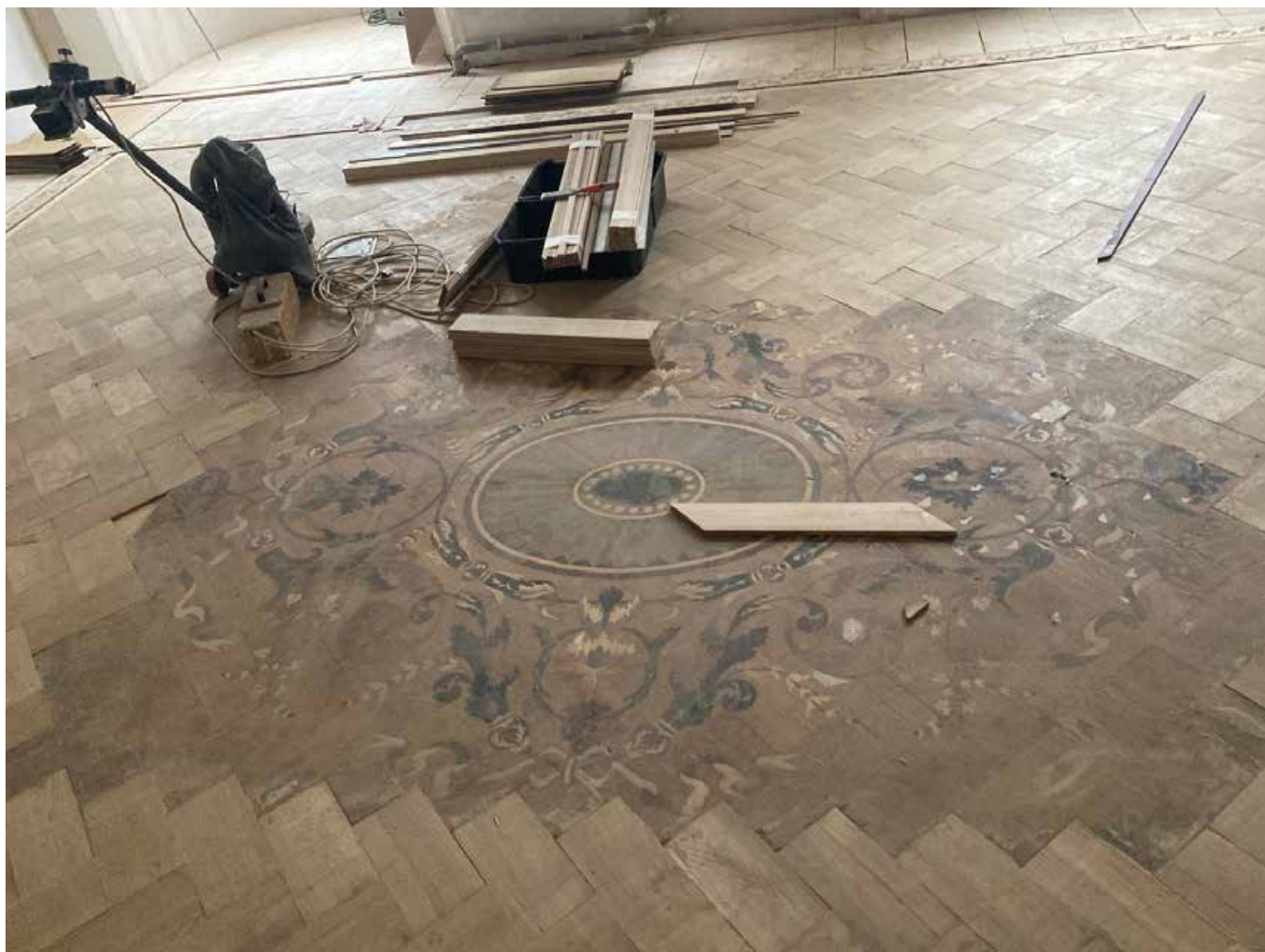
36. Помещение в квартире №17. Общий вид. Дата съемки: 10.03.2025
