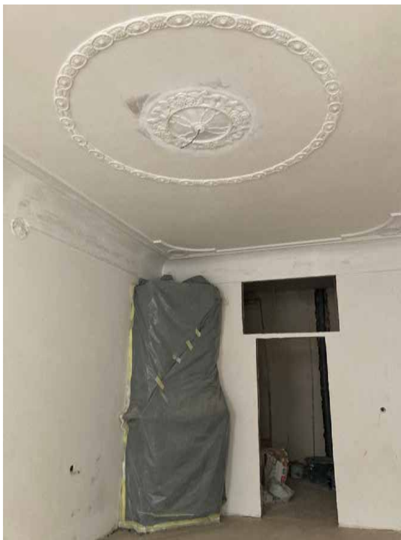
39. Помещение в квартире №17. Общий вид. Дата съемки: 10.03.2025
