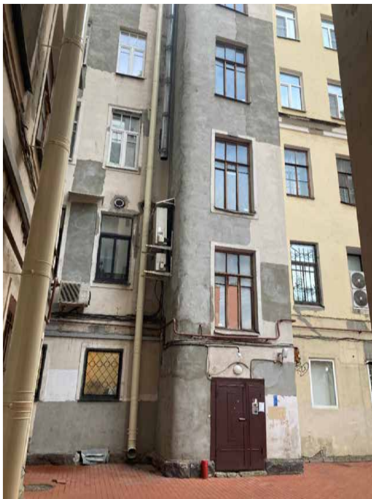
56. Дворовой фасад. Общий вид. Дата съемки: 10.03.2025
