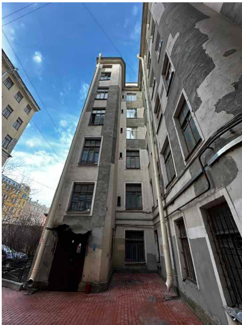
55. Дворовой фасад. Общий вид. Дата съемки: 10.03.2025
