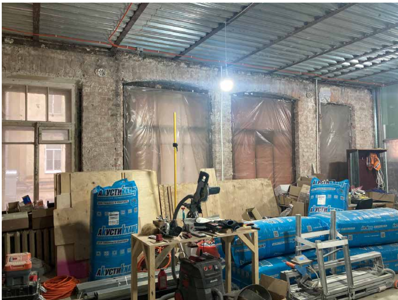
47. Помещение в квартире №12. Общий вид. Дата съемки: 10.03.2025
