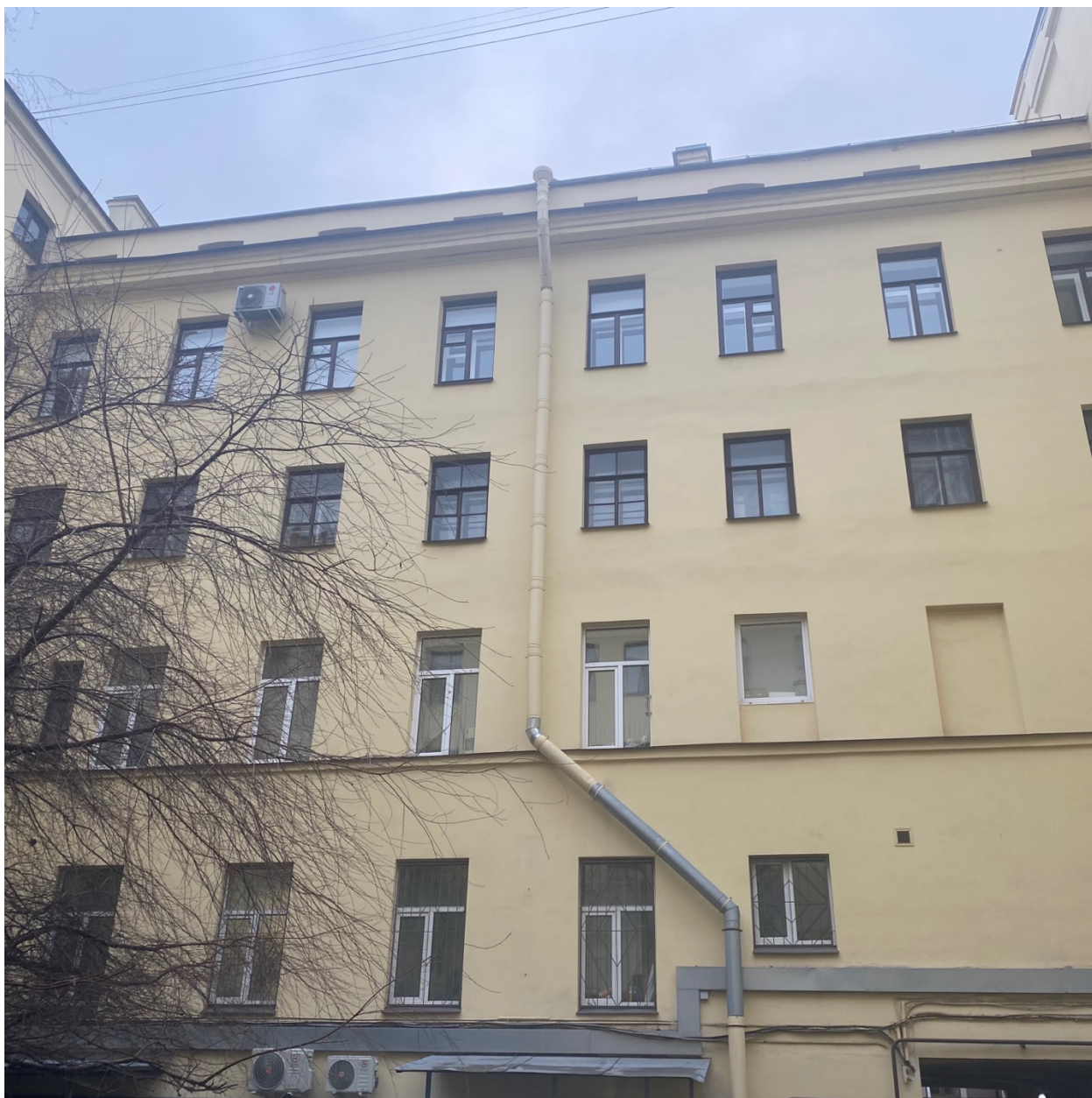
Фото 7. Общий вид на дворовой фасад объекта.
