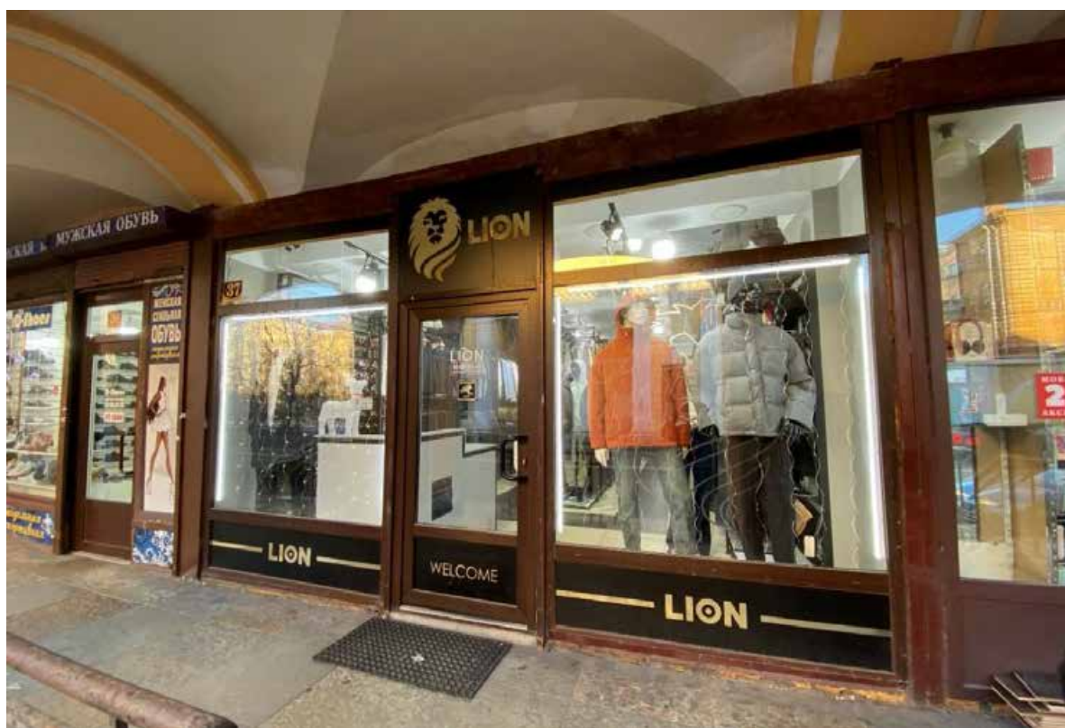
Фото 12. Позднее заполнение витрины с входной дверью в помещении 68-Н (быв. лавка № 21) корпуса 1. Вид со стороны галереи.
