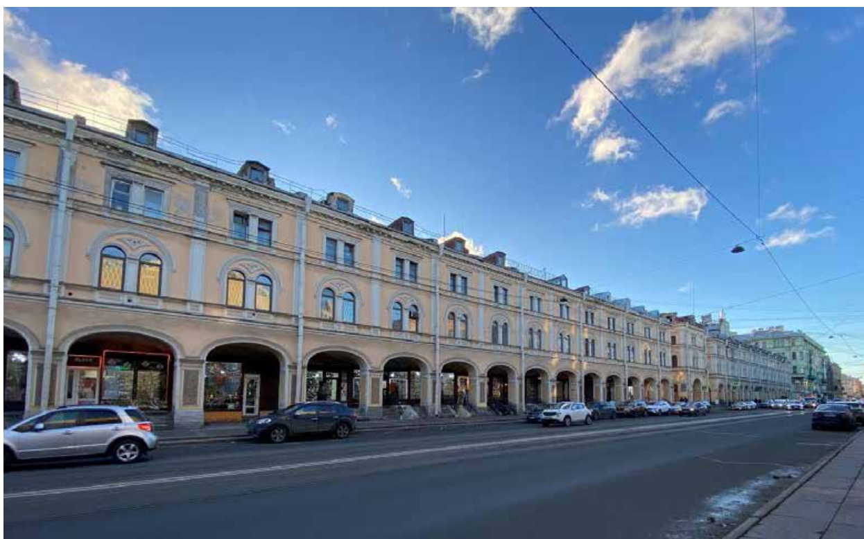
Фото 4. Лицевой северо-западный фасад корпуса 1 по быв. Александровской линии.
