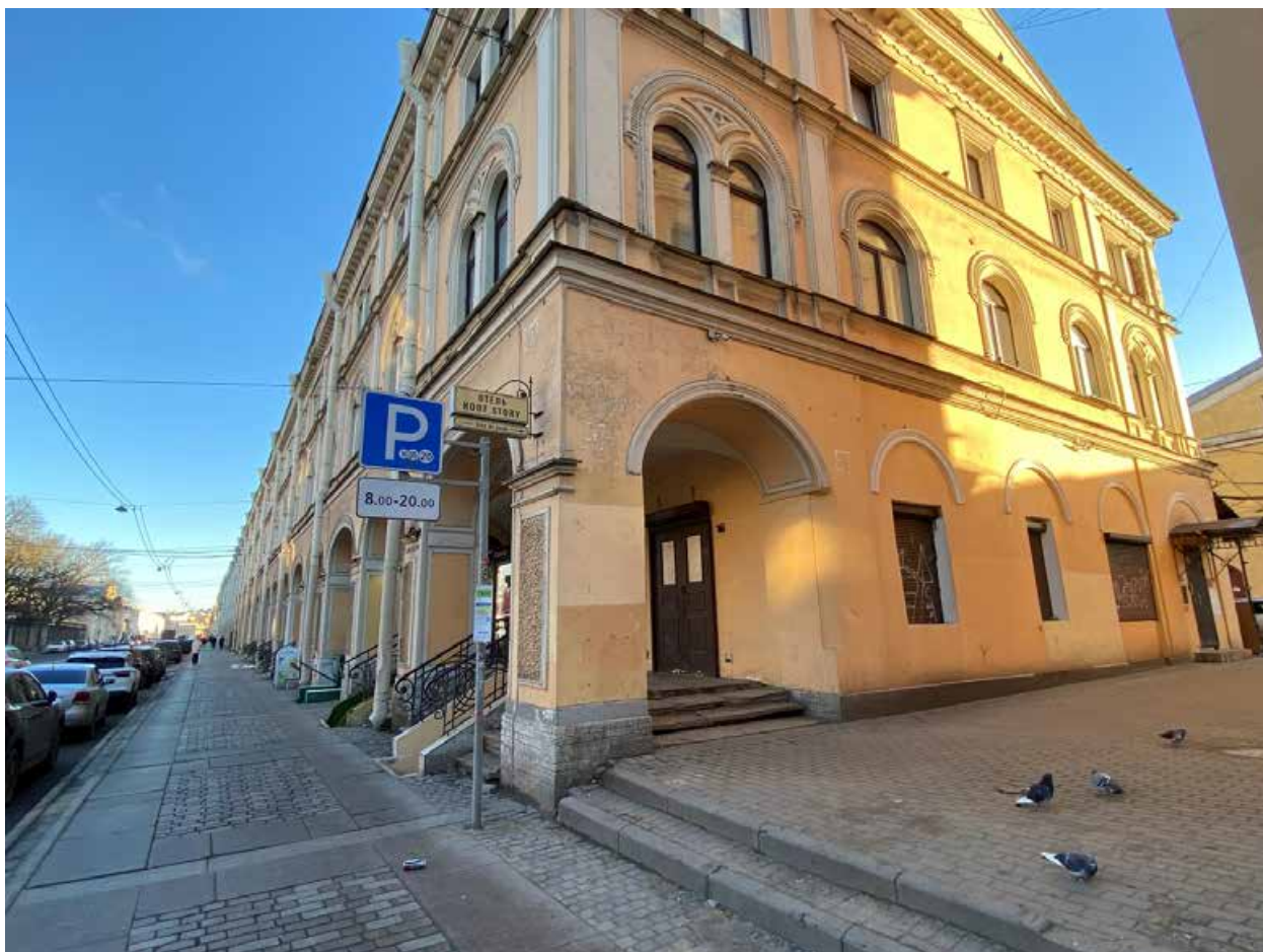
Фото 5. Вид части корпуса 1 с запада, в створе Банковского переулка.
