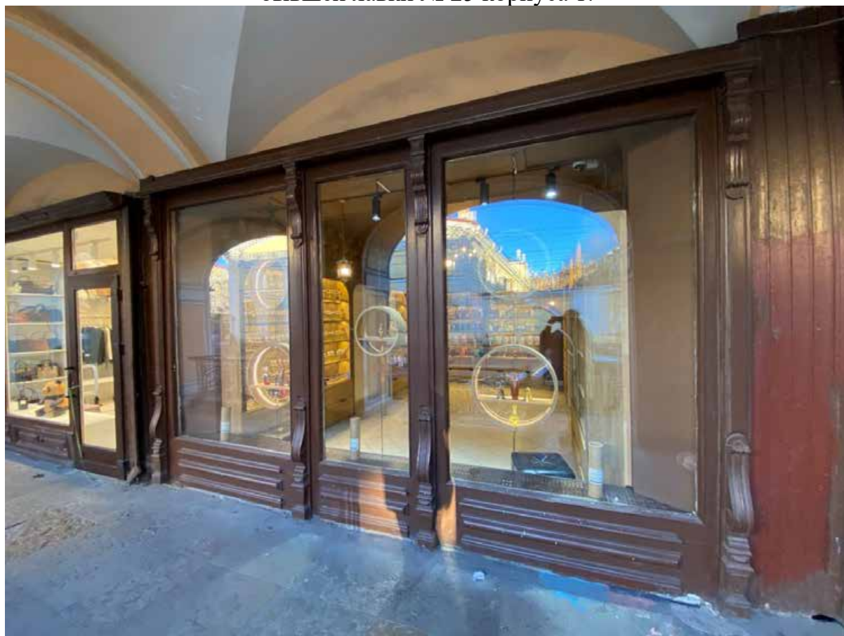
Фото 10. Столярное заполнение помещения бывшей лавки № 24 корпуса 1.
