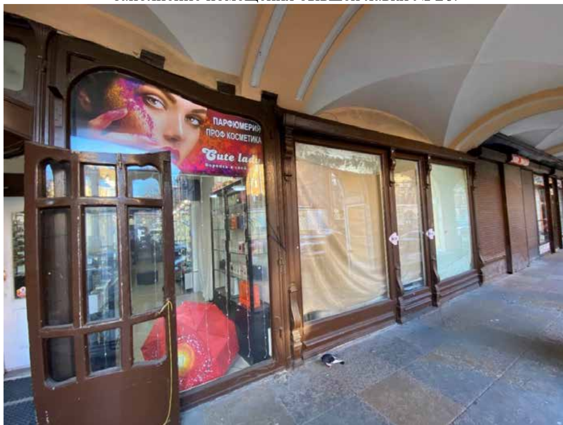
Фото 8. Деревянные заполнения витрин в помещениях корпуса 1 (быв. лавки № 25 и № 26).
