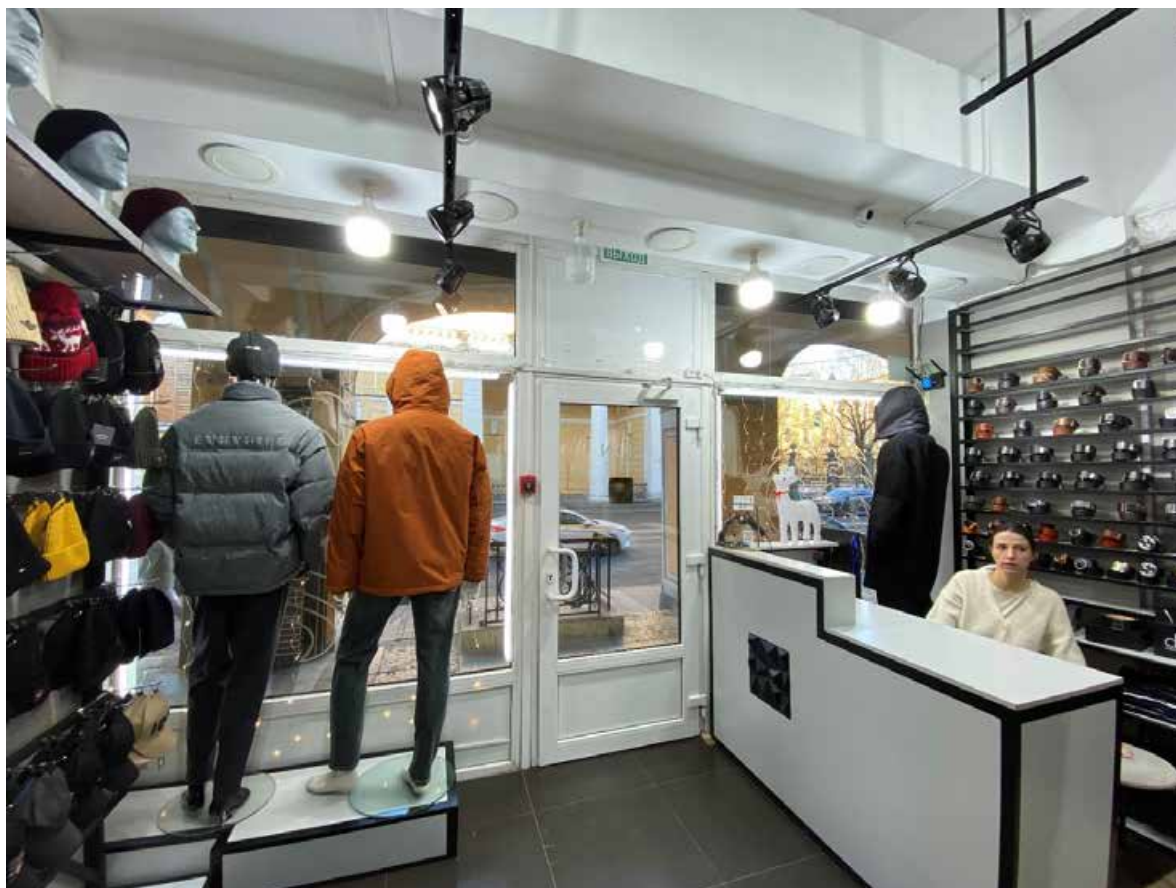
Фото 15. Позднее оконно-дверное заполнение в помещении 68-Н корпуса 1. Вид со стороны торгового зала.
