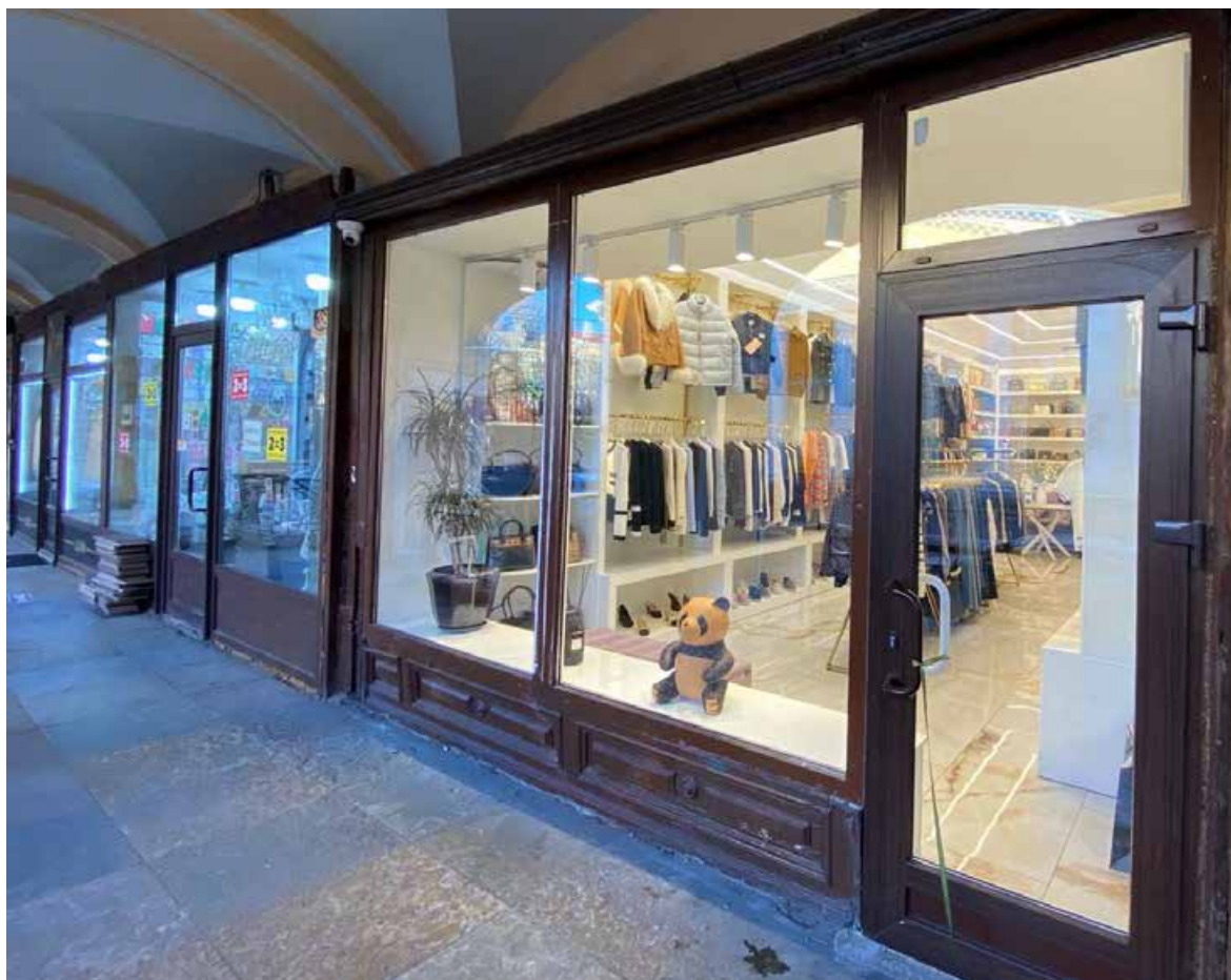
Фото 11. Позднее оконно-дверное заполнение в помещении бывшей лавки № 23 с деревянным декором в оформлении нижней части витрины.
