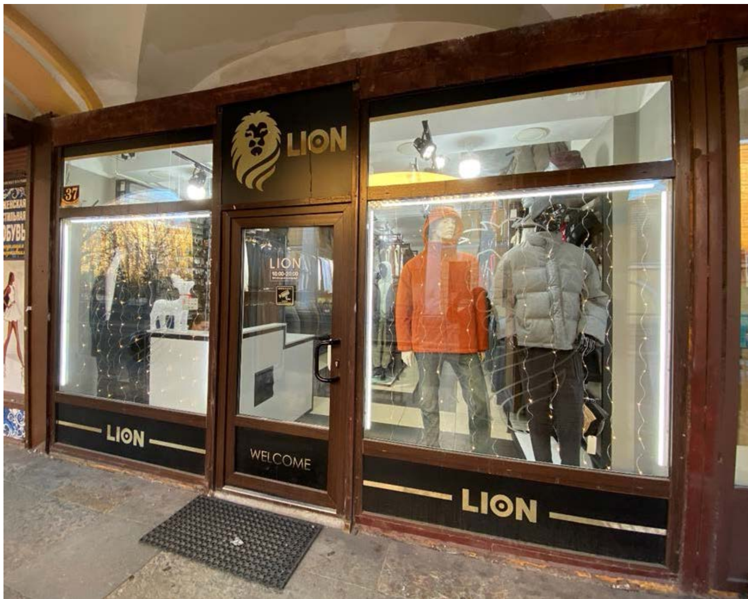
Фото 14. Позднее оконно-дверное заполнение в помещении 68-Н корпуса 1. Вид со стороны галереи.
