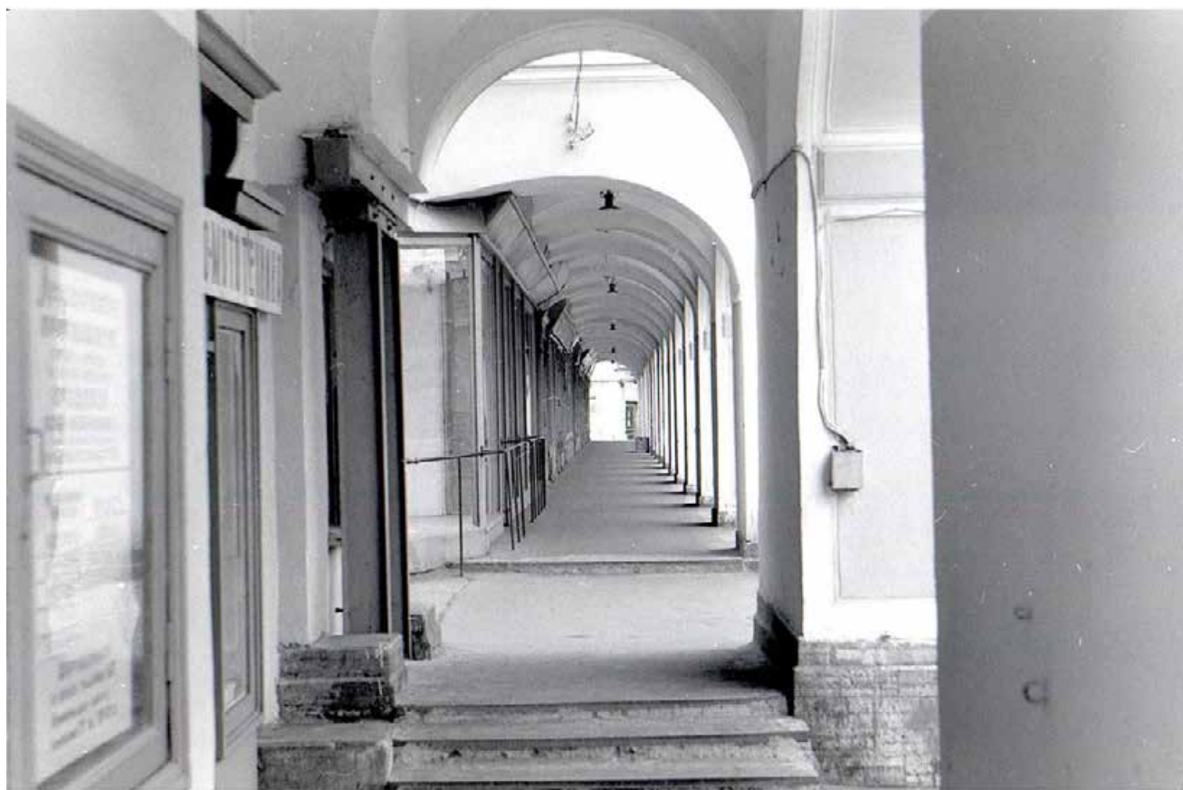
Илл. 50. Галерея со стороны Садовой улицы в сторону Апраксина переулка. 1986 г. автор фото: Беяков М.И. Источник: https://pastvu.com/p/1150316 .
