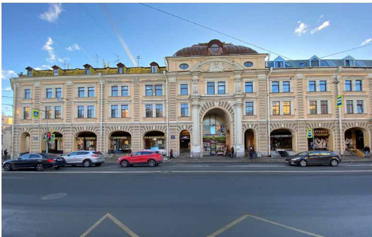
Фото 2. Фрагмент лицевого северо-западного фасада корпуса 1 (левый фланг северной части фасада). Вид с ул. Садовой.
