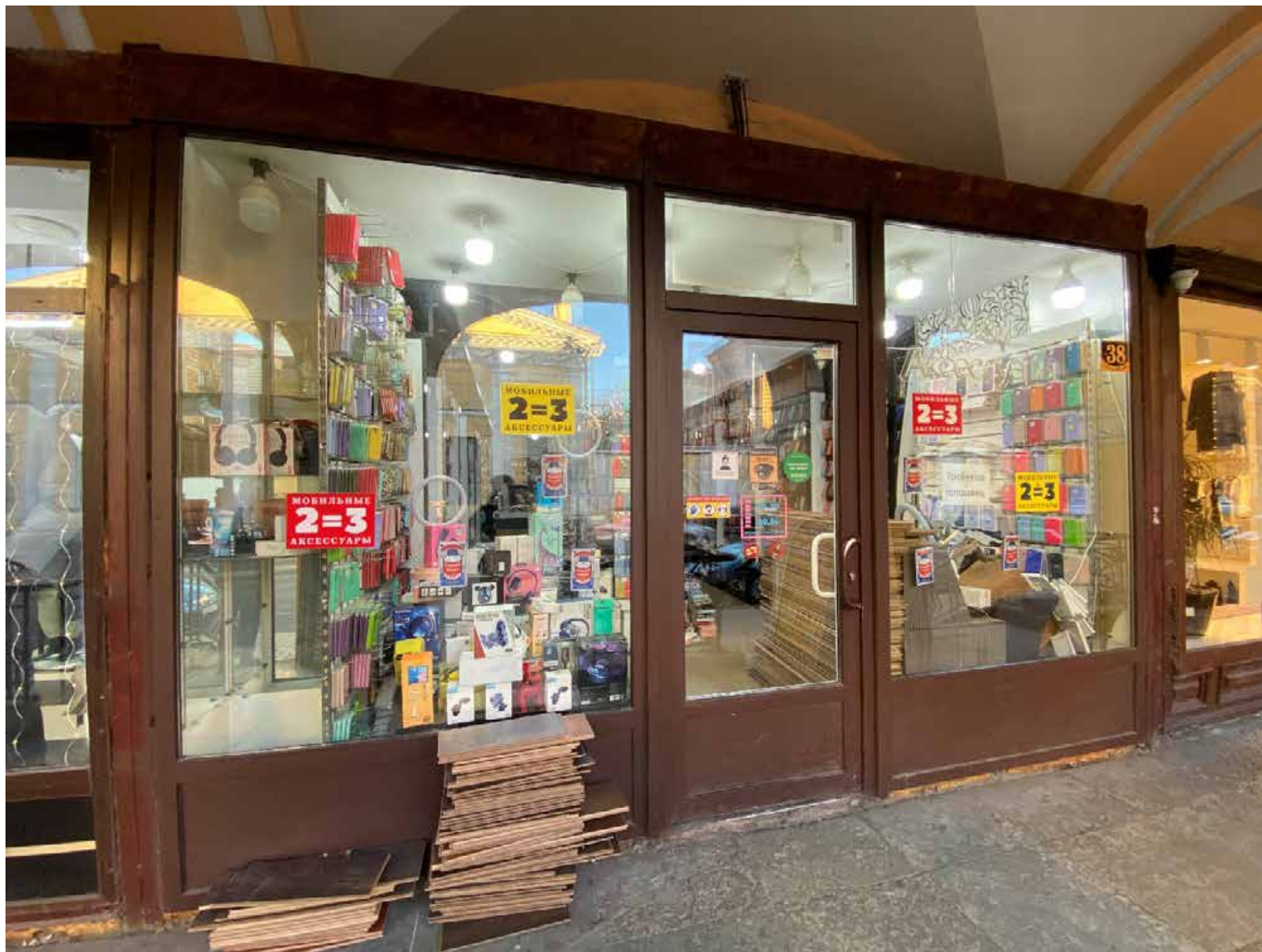
Фото 12. Позднее металлопластиковое заполнение витрины с входной центральной дверью в части помещения 139-Н – исторически торговая лавка № 22. Вид со стороны галереи.
