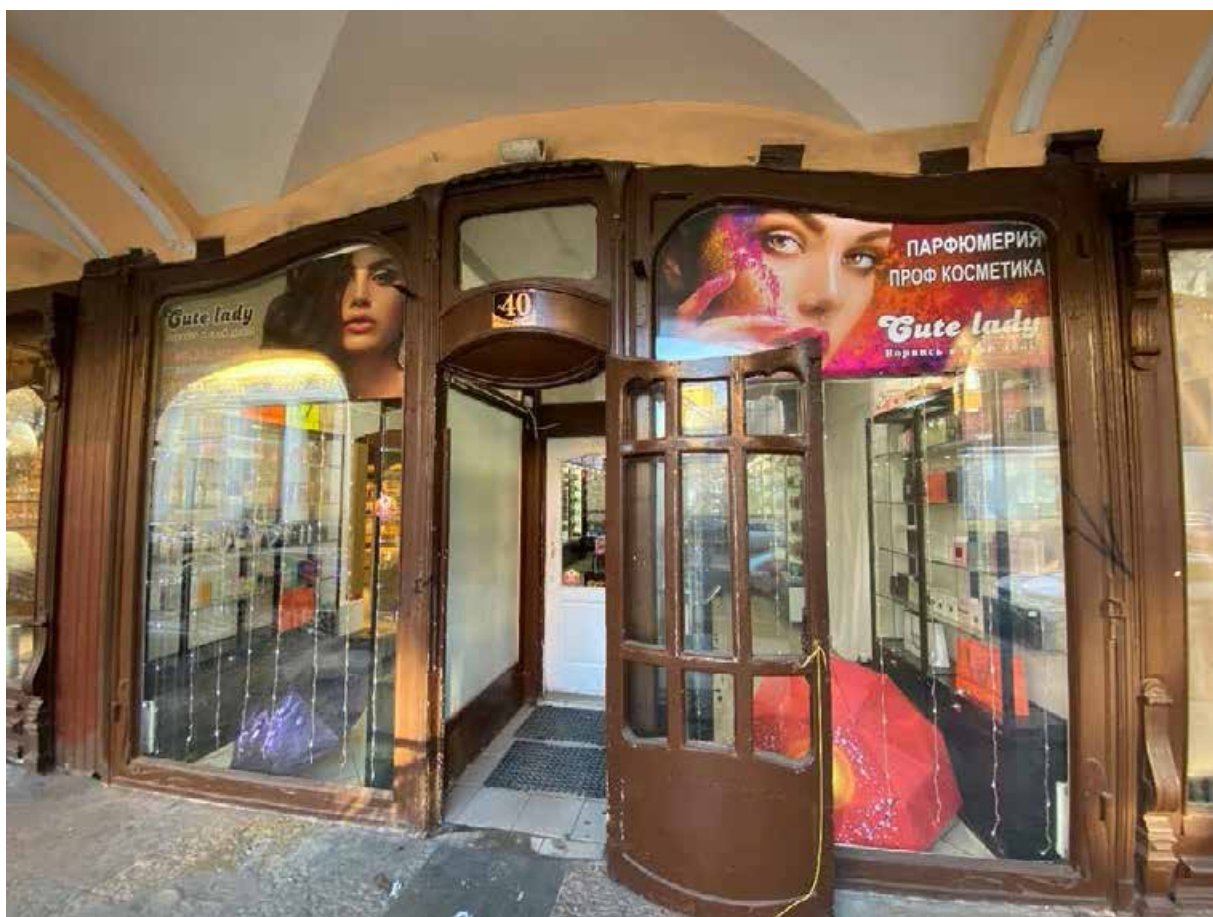
Фото 9. Деревянное заполнение витрины с входной дверью в помещении бывшей лавки № 25 корпуса 1.
