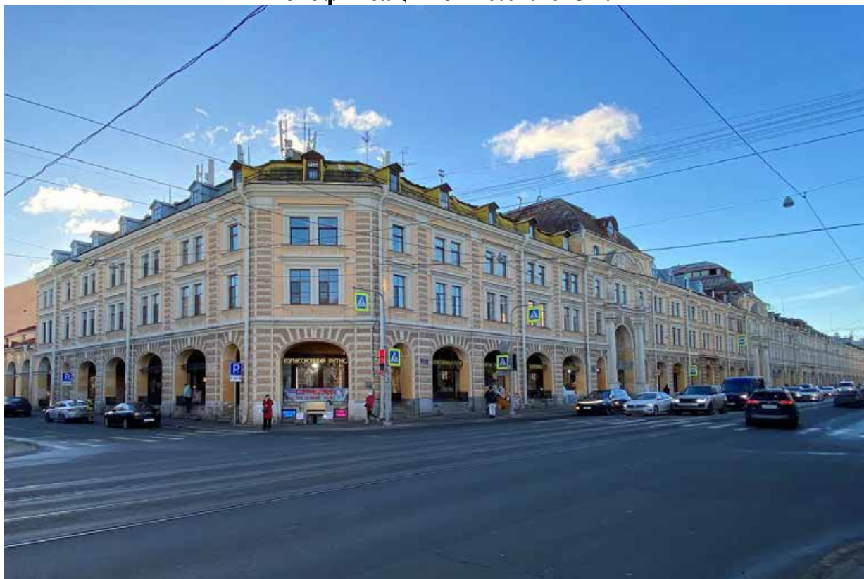
Фото 1. Корпус 1 на пересечении ул. Садовой и Ломоносова по быв. Мариинской и Суконной линиям. Общий вид с севера.
