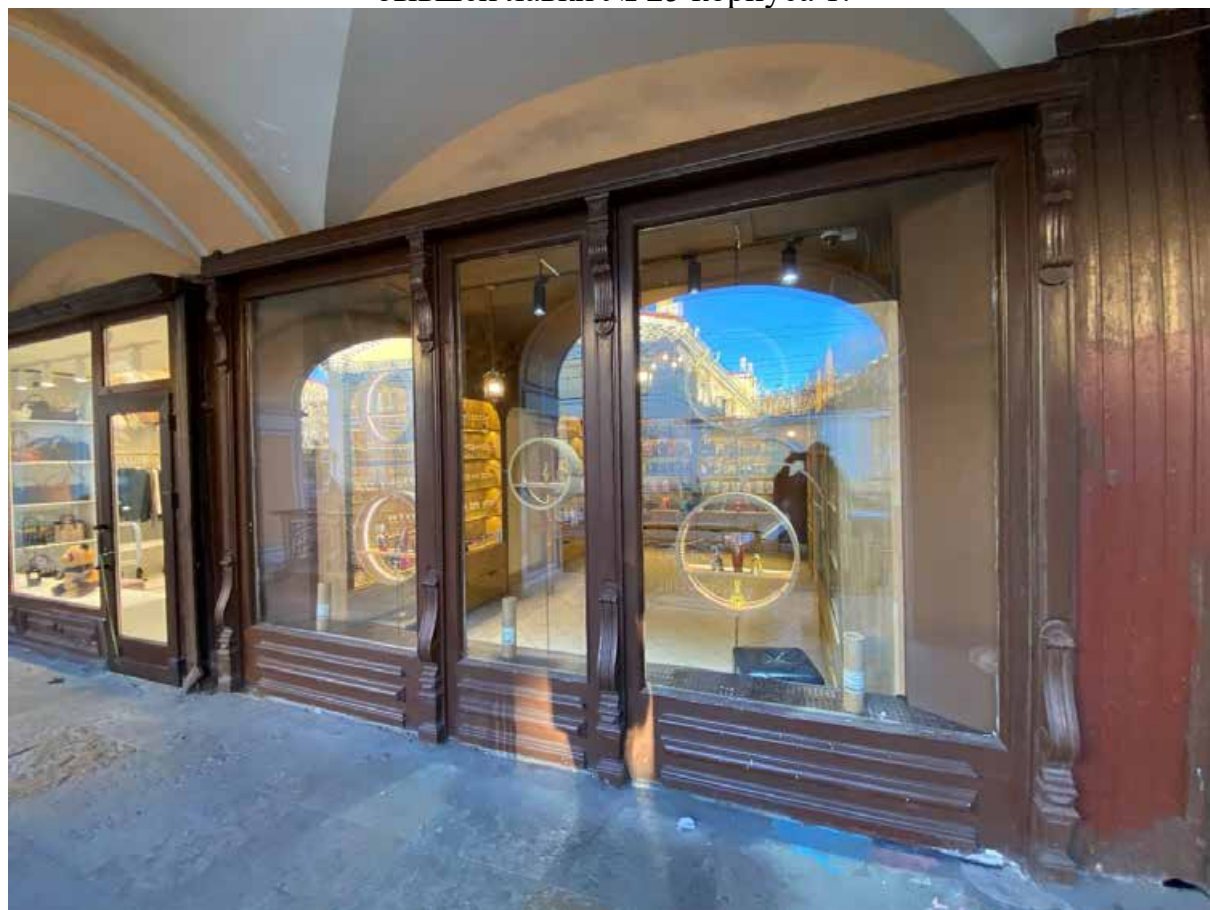
Фото 10. Столярное заполнение помещения бывшей лавки № 24 корпуса 1.
