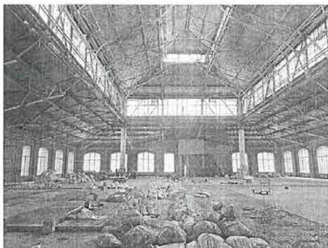
22. Помещение второго этажа (двухэтажного дворового корпуса)
