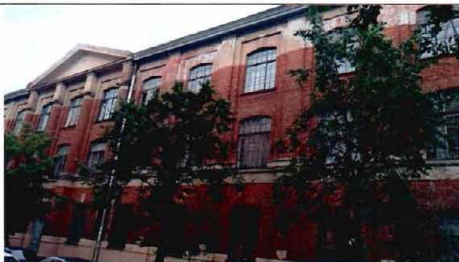
1. Фрагмент северо-восточного фасада
