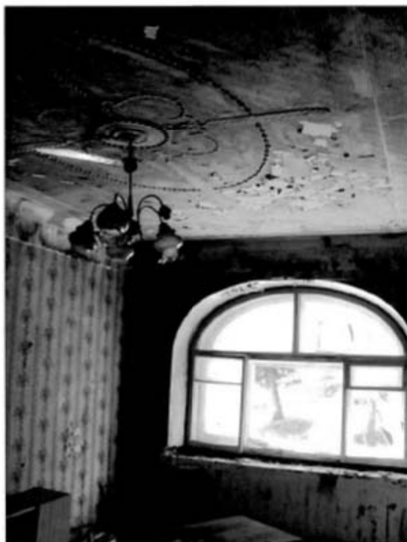
18. Помещение без номера, площадью 18,0 кв.м, по лицевому фасаду. Второй этаж.
