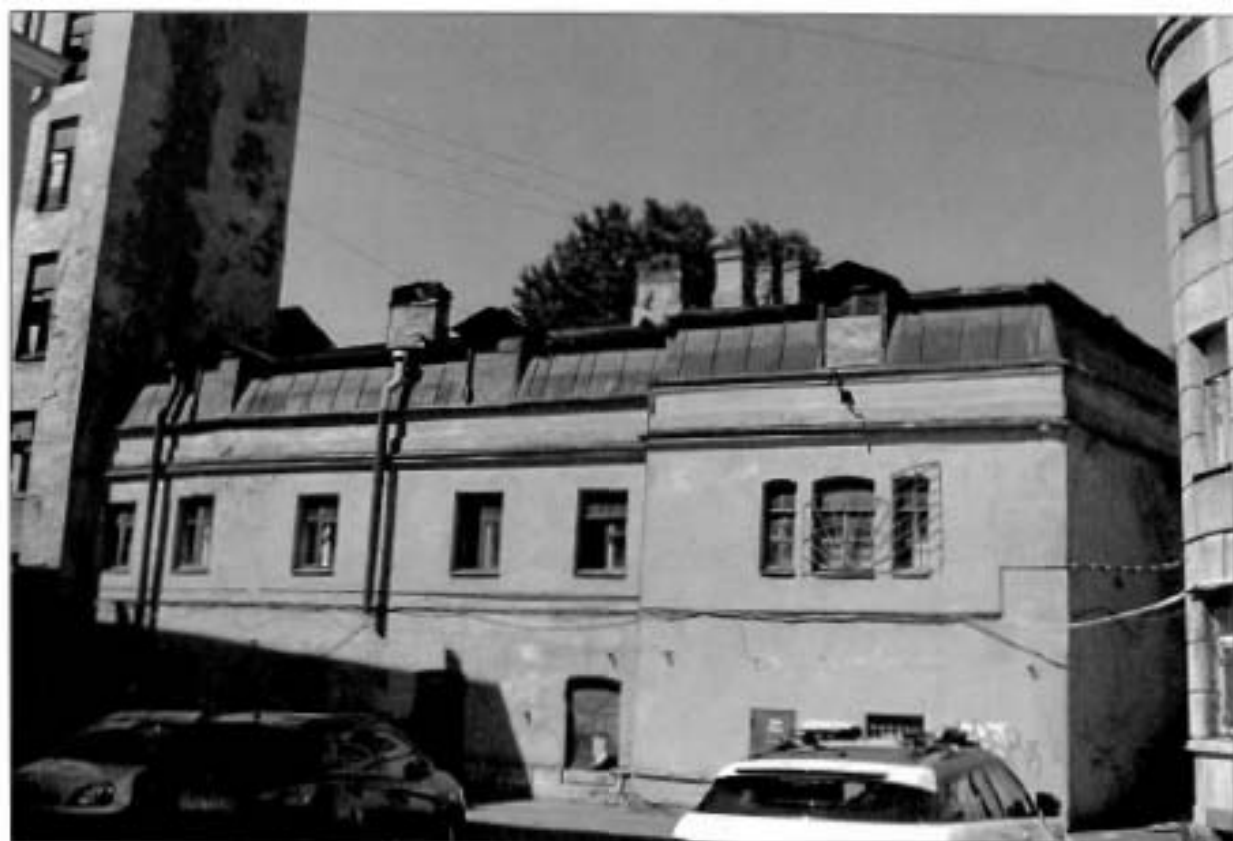
3. «Дом и службы». Дворовые фасады. Вид с юго-востока.
