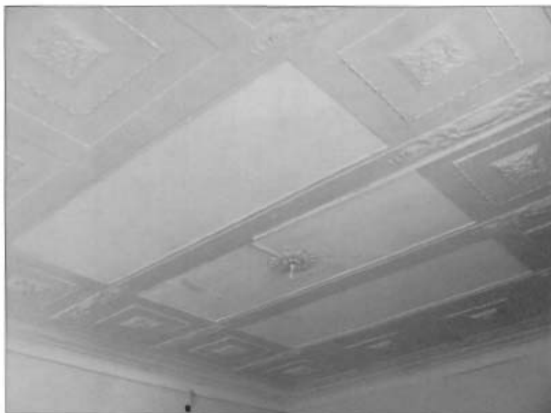
14. Оформление потолка (пом. без номера в северо-западной части лицевого корпуса). Первый этаж.
