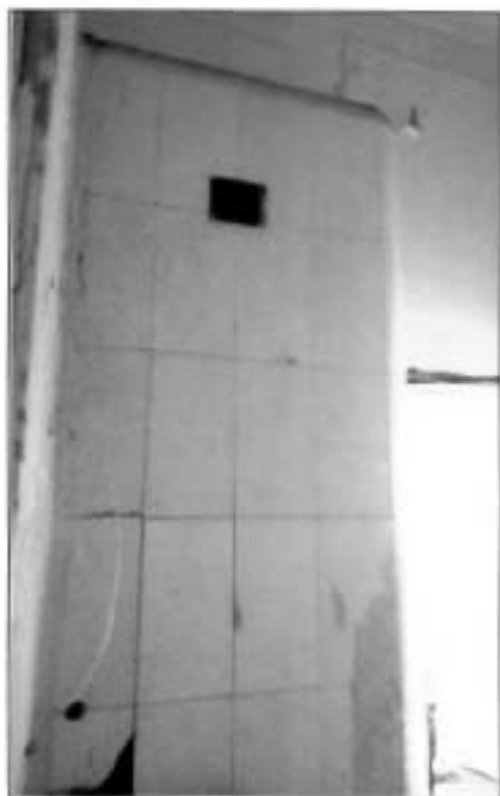
19. Печь (коридор, помещение № 10). Третий этаж. Фрагмент.
