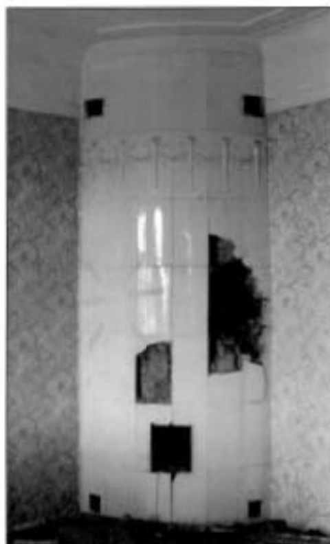
25. Печь угловая (помещение № 1). Пятый этаж.
