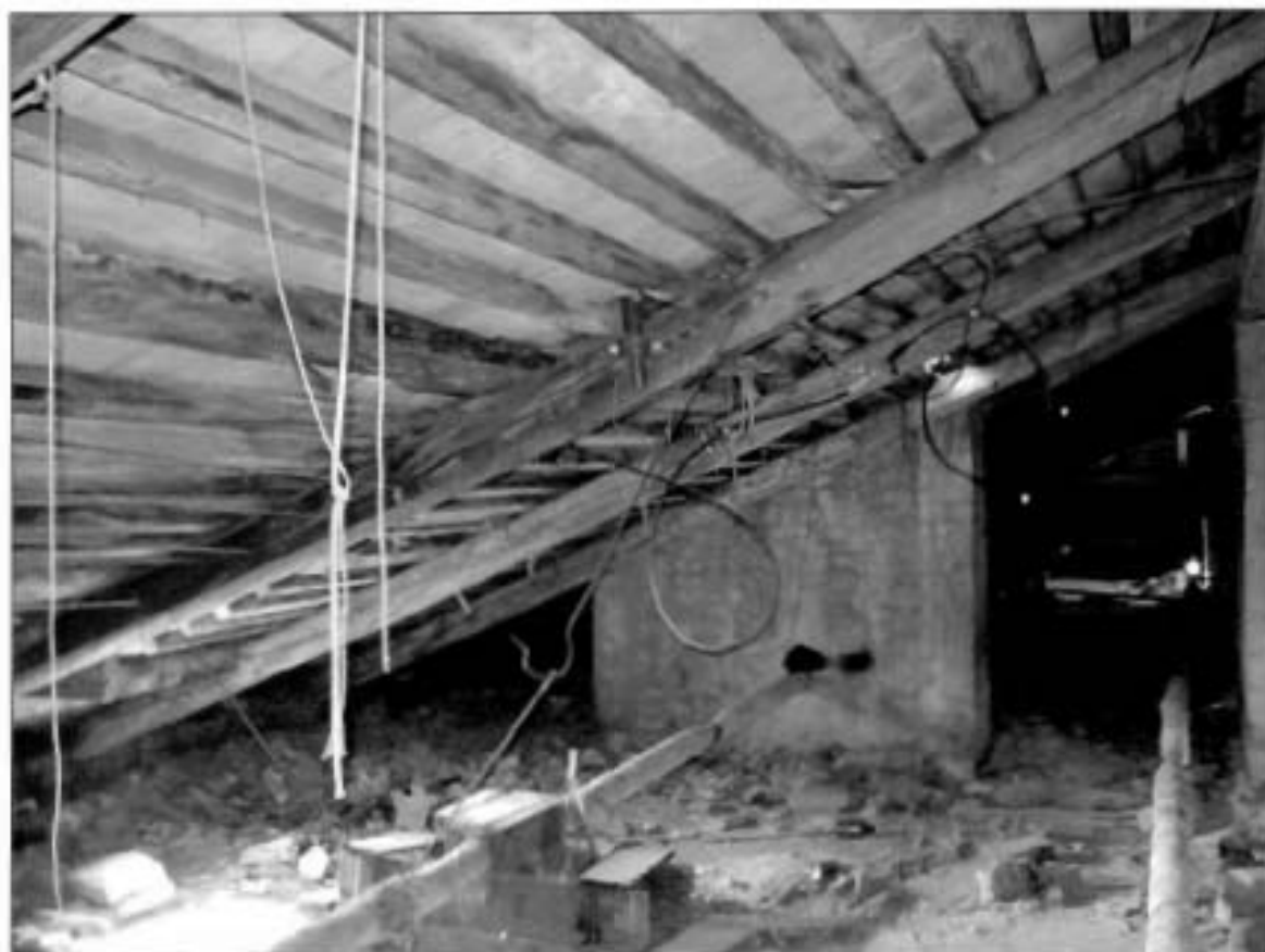
9. Чердак. Стропильная система.
