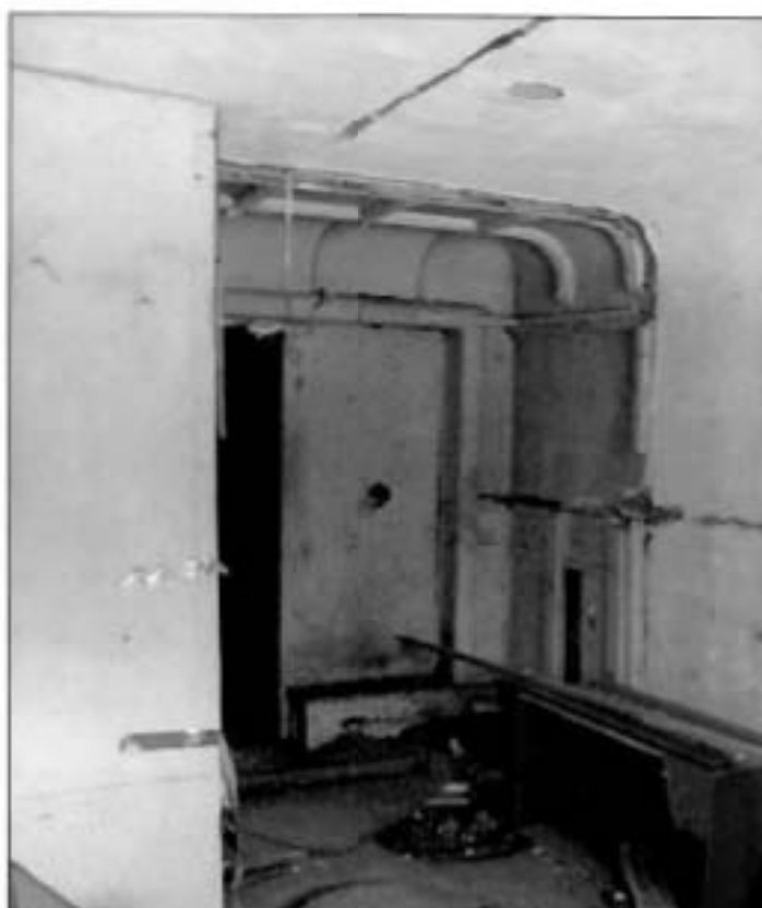
15. Тамбур (помещение 12-Н). Второй этаж.
