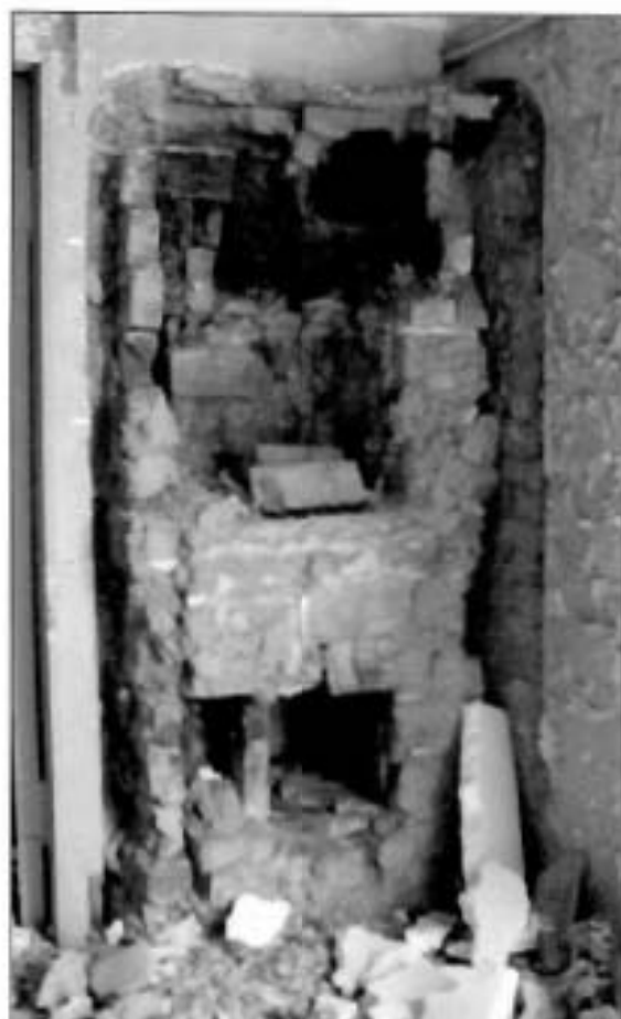
23. Печь (помещение без номера, площадью 16,2 кв. м, по дворовому фасаду). Четвертый этаж.
