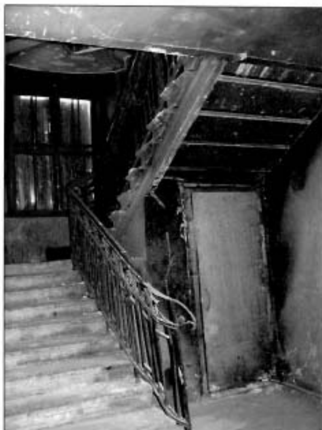
11. Парадная лестница в уровне первого этажа.
