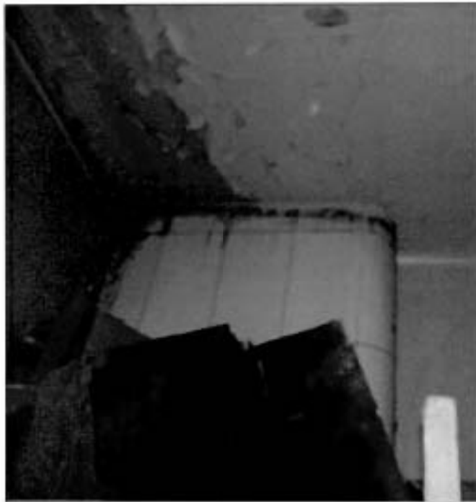
33. Печь (коридор, помещение без номера). Пятый этаж. Фрагмент.
