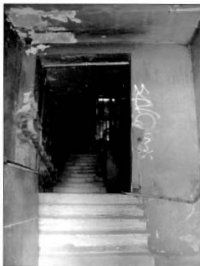
10. Вестибюль парадной лестницы.
