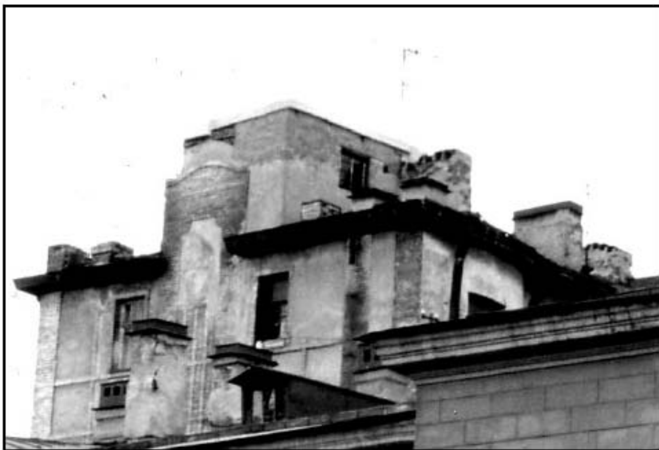
32. Фрагмент южного фасада доходного дома. Фото 1998 г. Фотограф В.Ф. Егоровский. Архив КГИОП
