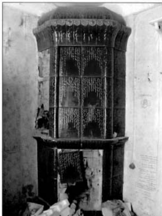
35. Печь (помещение № 4). Шестой этаж.
