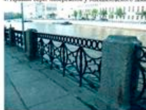
6. Решетка перильного ограждения
