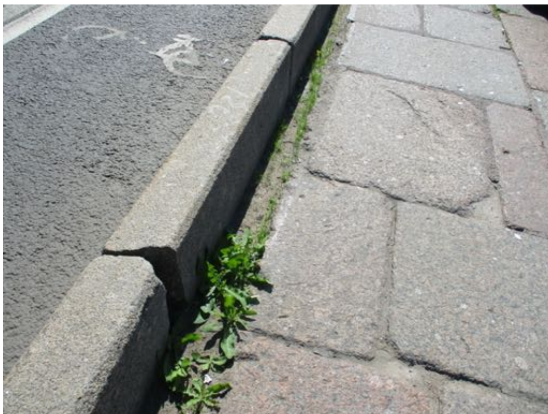
Фото 2. Гранитные плиты мощения, бордюрный камень между проезжей частью и мощением набережной.
