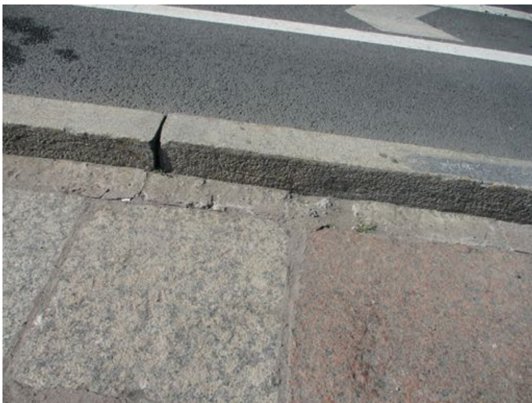
Фото 8. Гранитные плиты мощения, бордюрный камень между проезжей частью и мощением набережной.
