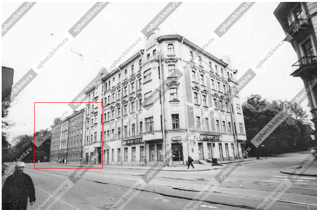
Илл.12. Общий вид фасада жилого дома на углу Большого Сампсониевского проспекта и улицы Тобольской, № 57/2 (1910 г. – арх. М.И.Сегаль). 1993 г. ЦГАКФФД СПб. Фотодокументы. Опись 1АР-156. Ед.хр.222313.
