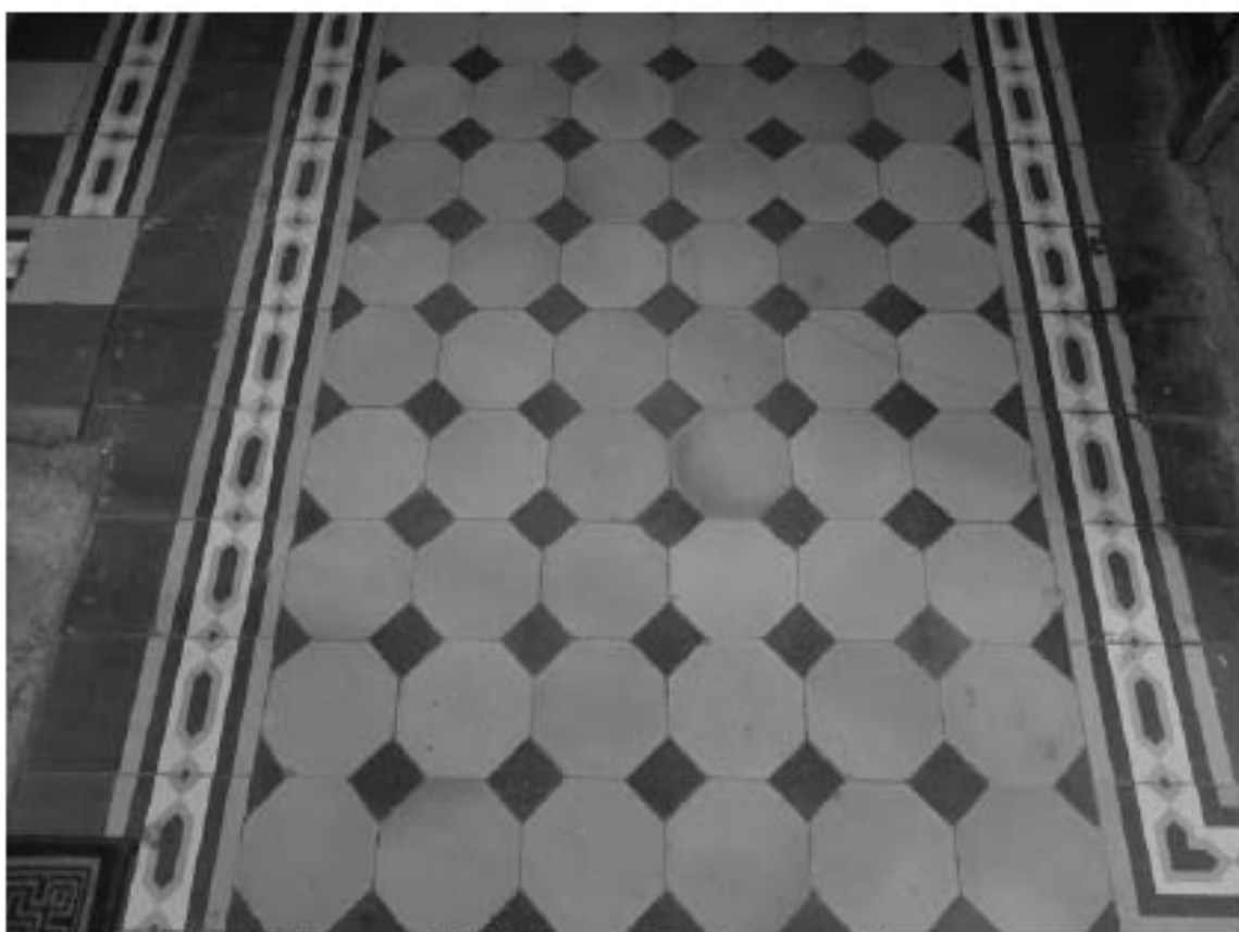
Фото 55. Лестница № 1: Площадка 1-го этажа. Покрытие пола. Съемка 19.04.2021 г. Михайловская Г. В.
