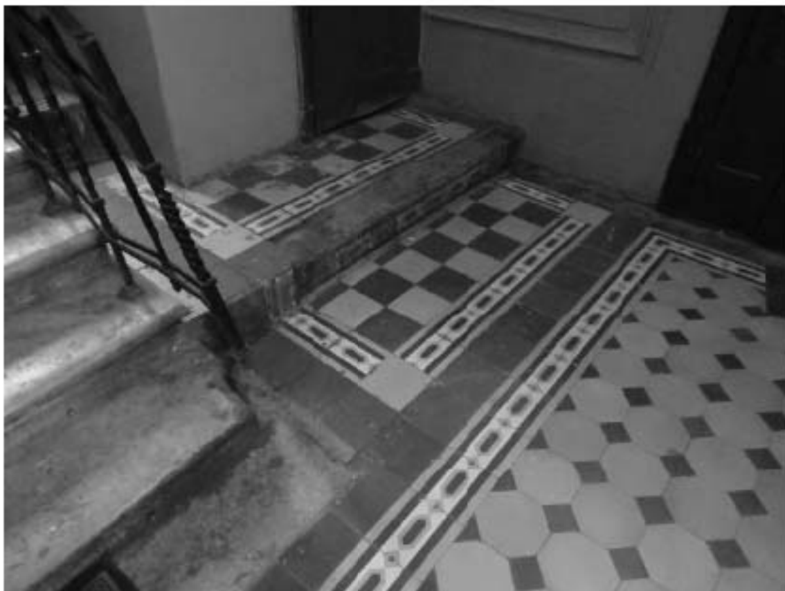
Фото 52. Лестница № 1: Площадка 1-го этажа. Покрытие пола. Съемка 19.04.2021 г. Михайловская Г. В.
