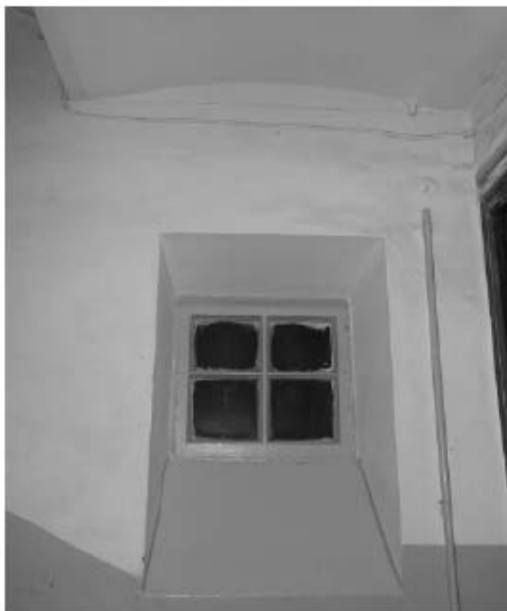
Фото 119. Лестница № 2(3): 4-й этаж. Съемка 19.04.2021 г. Михайловская Г. В.
