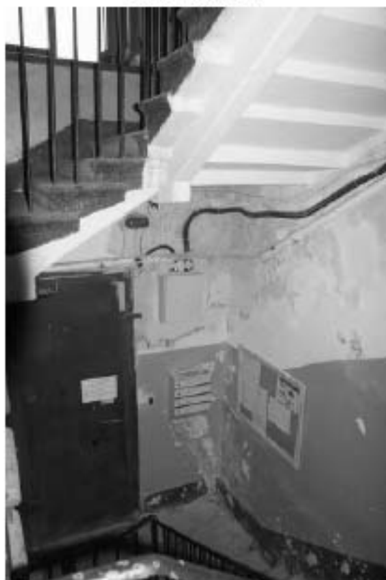
Фото 131. Лестница №4: 1-й этаж. Съемка 19.04.2021 г. Михайловская Г. В.
