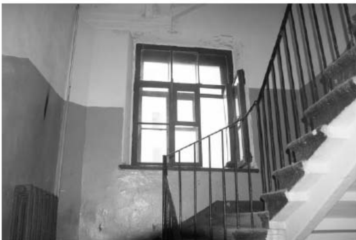
Фото 135. Лестница №4: Площадка м/у 2-м и 3-м этажом. Съемка 19.04.2021 г. Михайловская Г. В.
