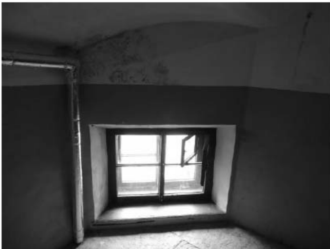
Фото 127. Лестница №4: Площадка м/у 5-м и 6-м этажом. Оформление оконного проема. Съемка 19.04.2021 г. Михайловская Г. В.
