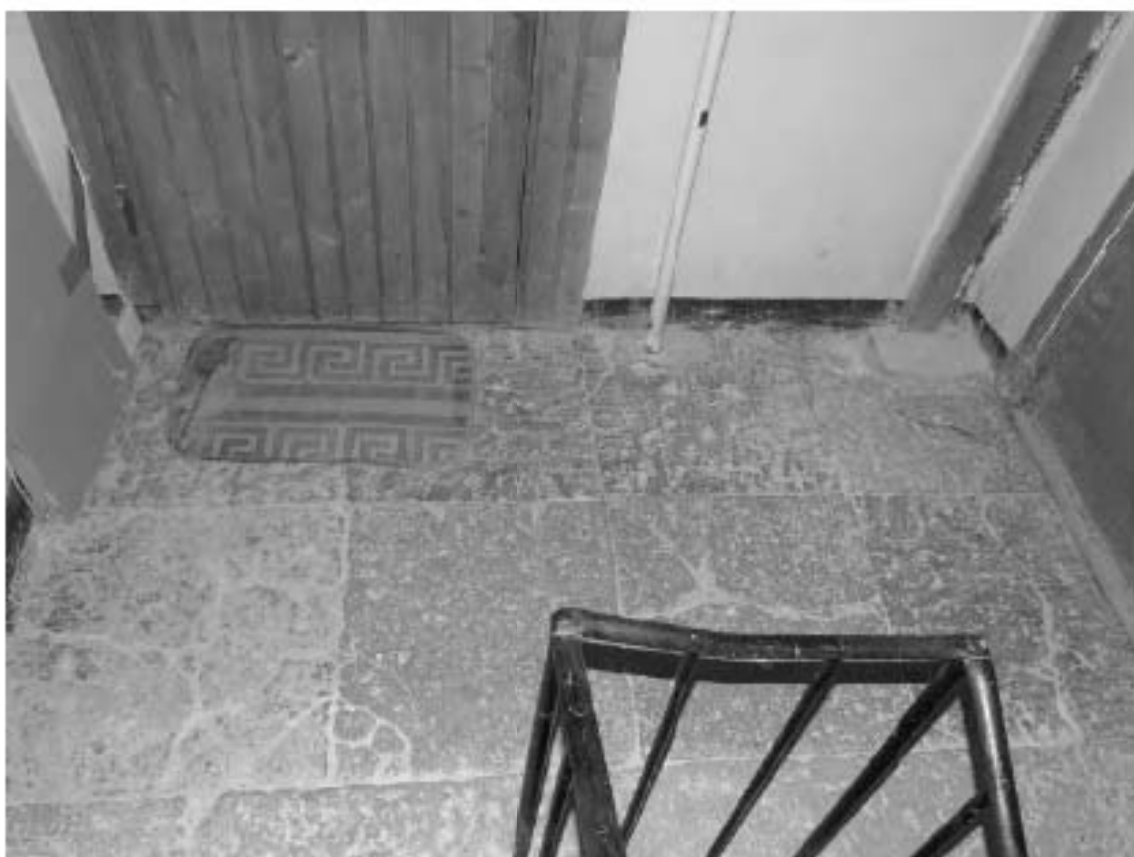
Фото 124. Лестница № 2(3): 5-й этаж. Известняковые плиты. Съемка 19.04.2021 г. Михайловская Г. В.
