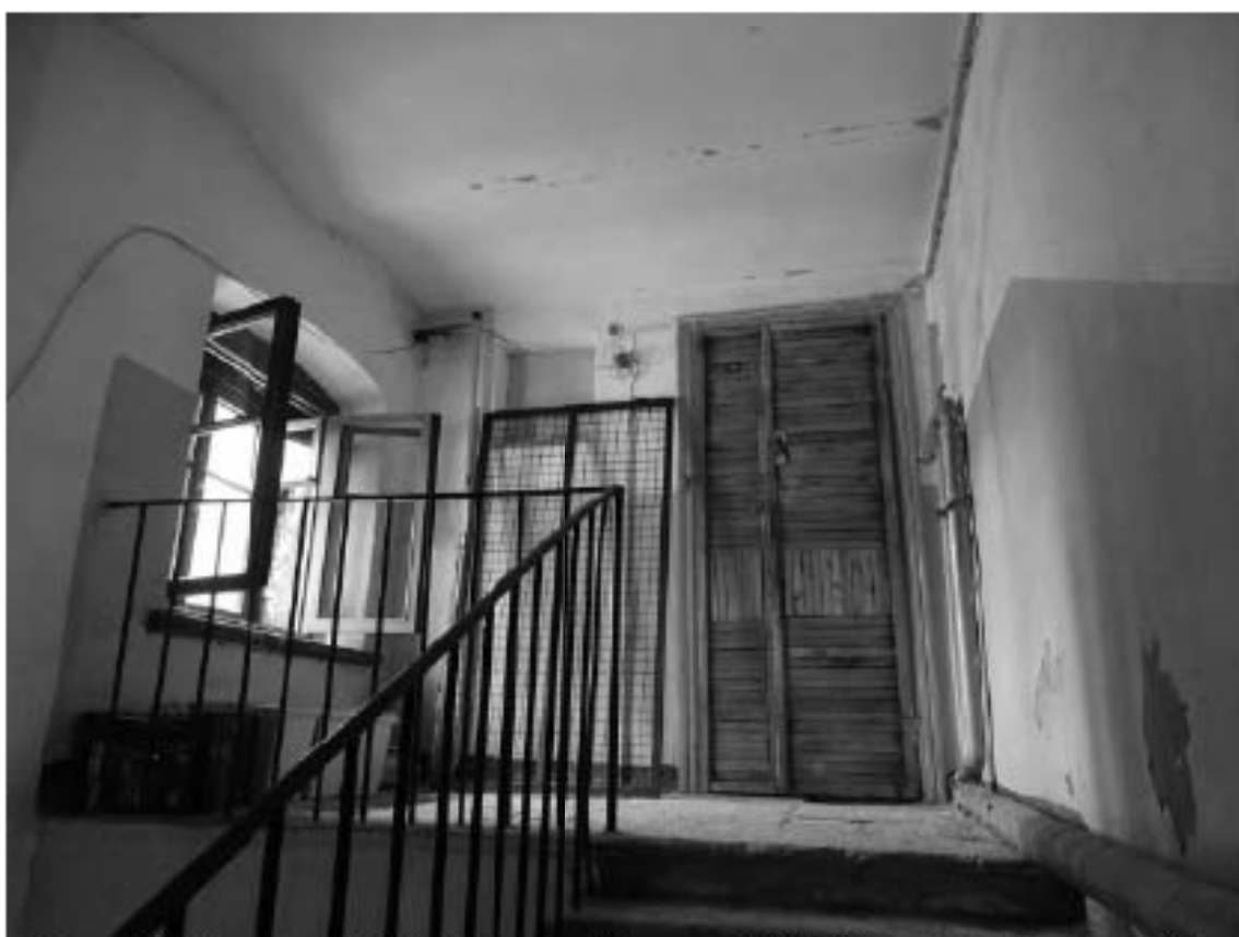
Фото 133. Лестница № 2(3): 6-й этаж. Съемка 19.04.2021 г. Михайловская Г. В.
