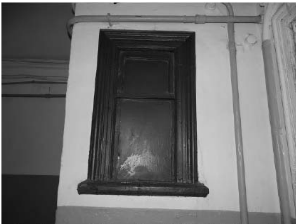
Фото 122. Лестница №4: 5-й этаж. Съемка 19.04.2021 г. Михайловская Г. В.
