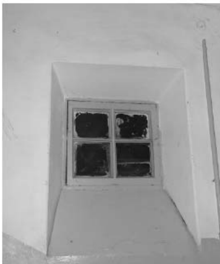
Фото 112. Лестница № 2(3): 3-й этаж. Съемка 19.04.2021 г. Михайловская Г. В.
