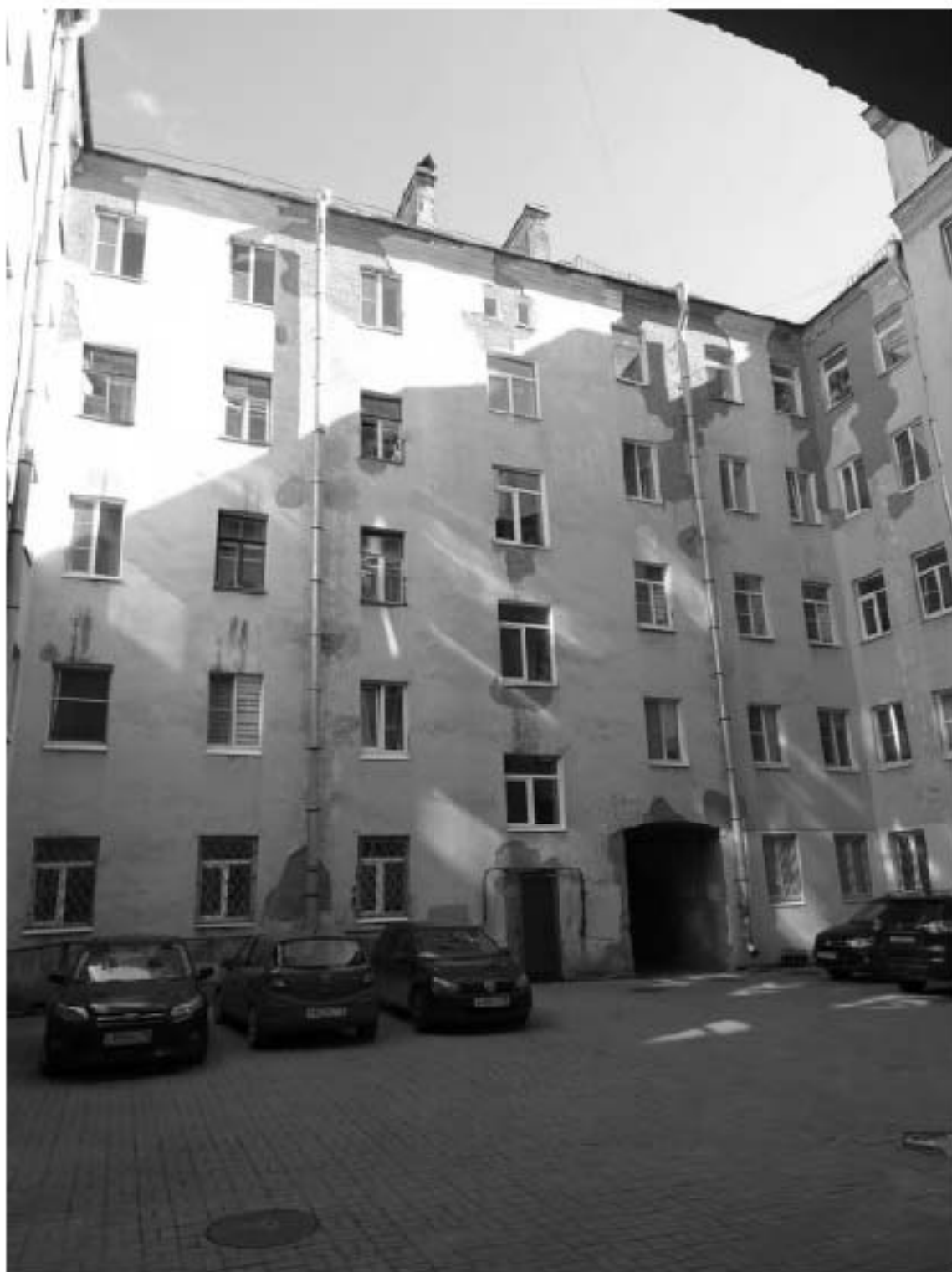
Фото 17. Здание по адресу: г. Санкт-Петербург, Большой проспект П.С., дом 45, литера А. Южный внутренний двор. Съемка 19.04.2021 г. Михайловская Г. В.
