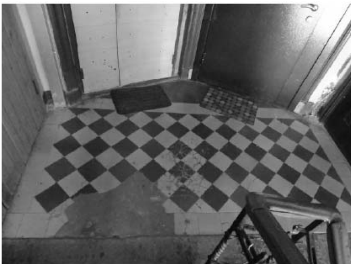
Фото 59. Лестница № 2(2): 4-й этаж. Съемка 19.04.2021 г. Михайловская Г. В.
