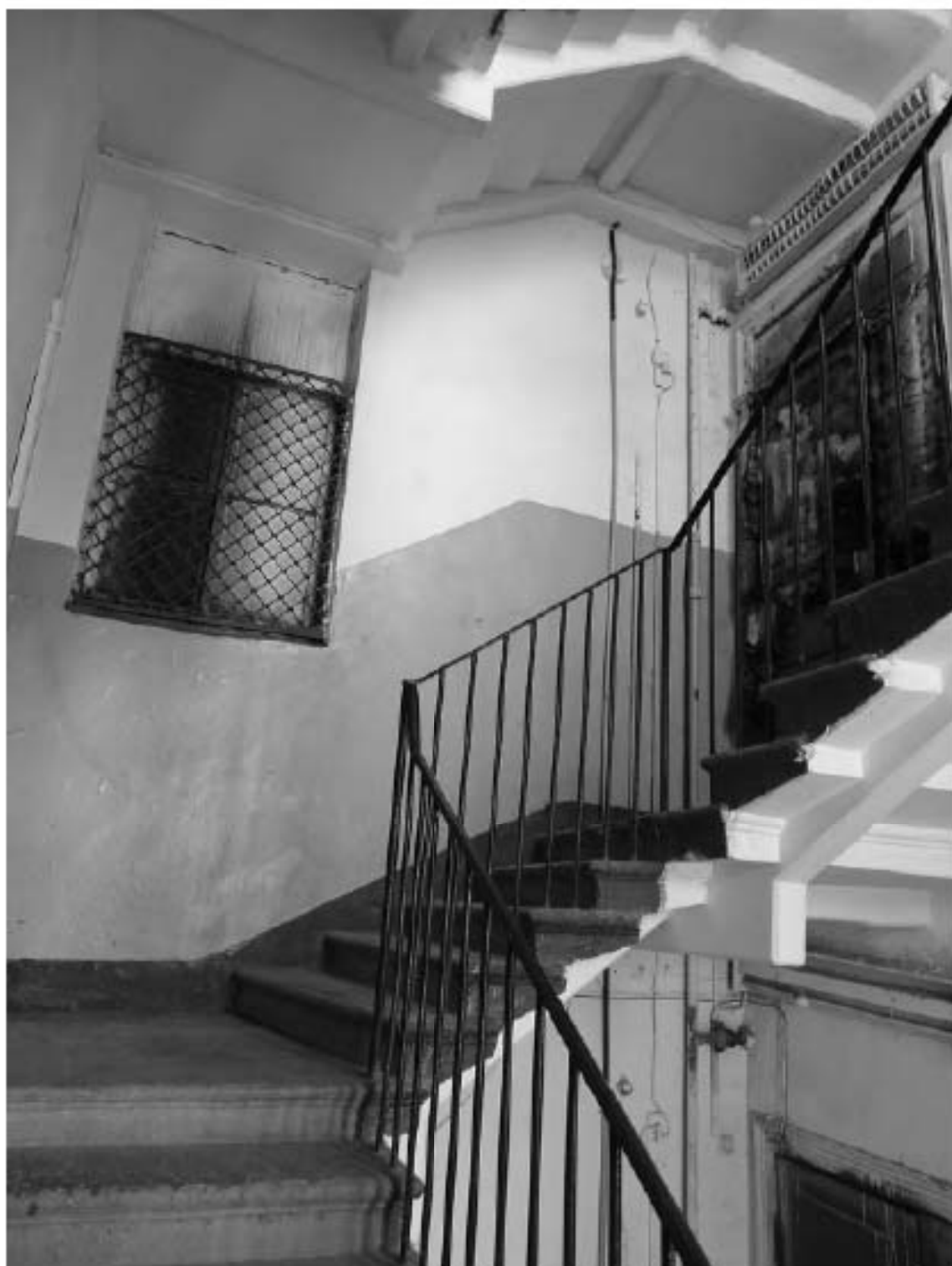
Фото 143. Лестница №4: 5-й этаж. Съемка 19.04.2021 г. Михайловская Г. В.
