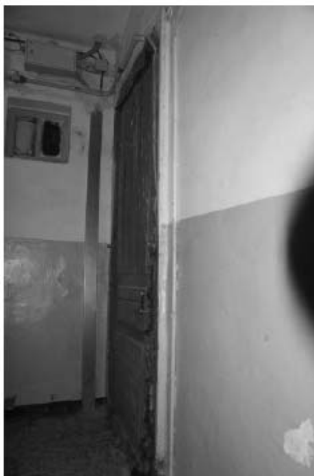
Фото 108. Лестница № 2(3): Площадка 2-го этажа. Съемка 19.04.2021 г. Михайловская Г. В.
