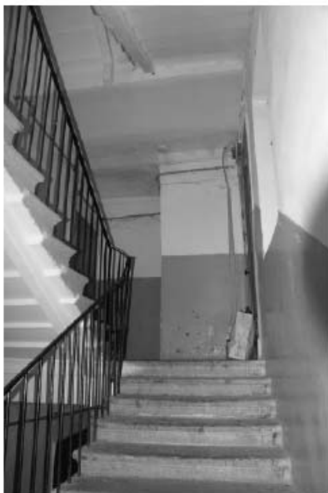
Фото 99. Лестница №4: 2-й этаж. Съемка 19.04.2021 г. Михайловская Г. В.
