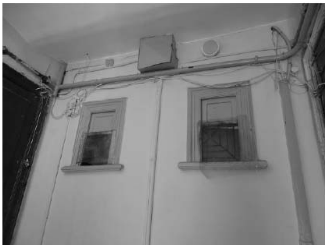
Фото 157. Лестница №3(1): 2-й этаж. Съемка 19.04.2021 г. Михайловская Г. В.
