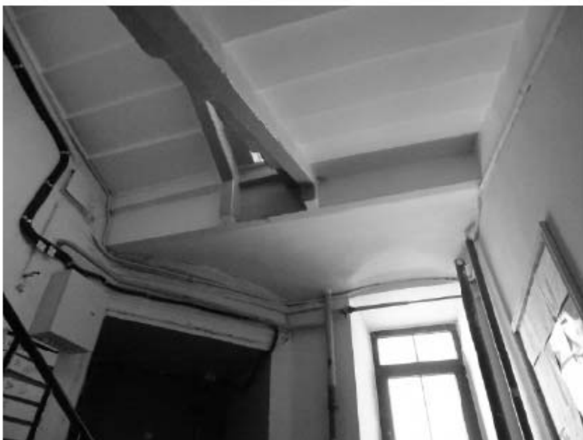
Фото 147. Лестница №3(1): 1-й этаж. Коробовый свод с распалубками. Съемка 19.04.2021 г. Михайловская Г. В.
