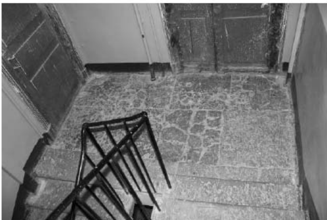
Фото 88. Лестница № 2(3): Площадка 4-го этажа. Покрытие пола. Съемка 19.04.2021 г. Михайловская Г. В.
