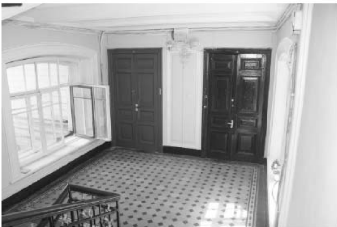
Фото 102. Лестница №1: 2-й этаж. Съемка 19.04.2021 г. Михайловская Г. В.
