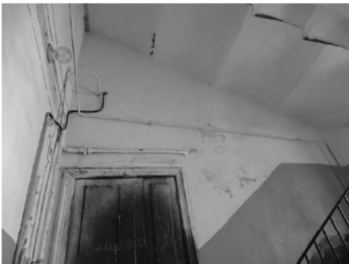
Фото 148. Лестница №4: 6-й этаж. Своды. Съемка 19.04.2021 г. Михайловская Г. В.
