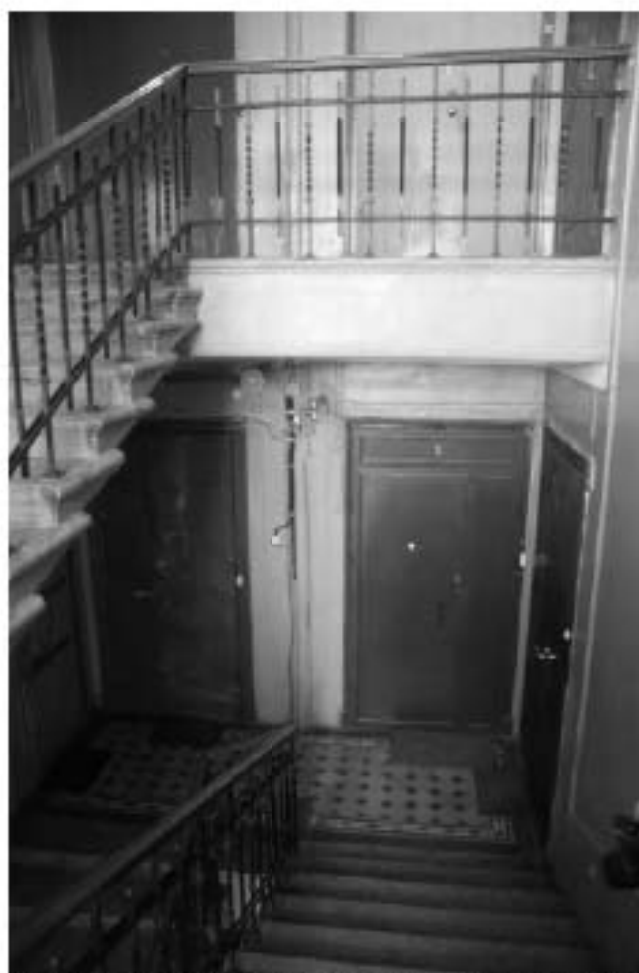
Фото 74. Лестница № 1: Площадка 3-го этажа. Съемка 19.04.2021 г. Михайловская Г. В.
