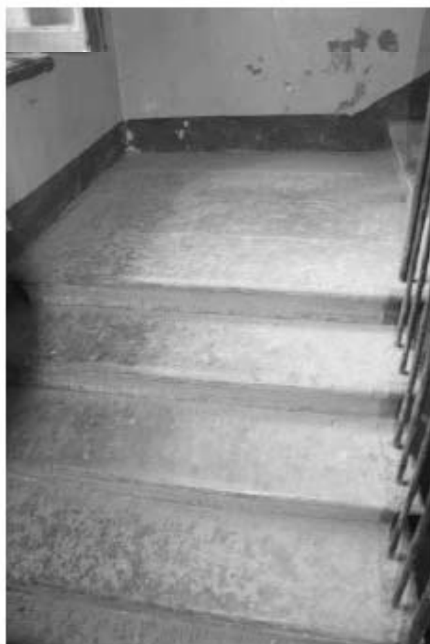
Фото 136. Лестница №4: Ступени и площадка м/у 2-м и 3-м этажом. Съемка 19.04.2021 г. Михайловская Г. В.
