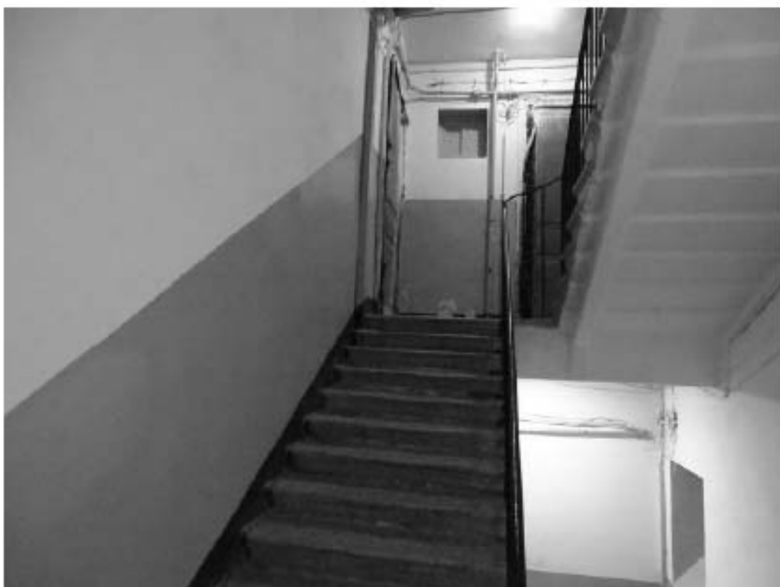
Фото 80. Лестница № 2(3): Площадка 3-го этажа. Съемка 19.04.2021 г. Михайловская Г. В.
