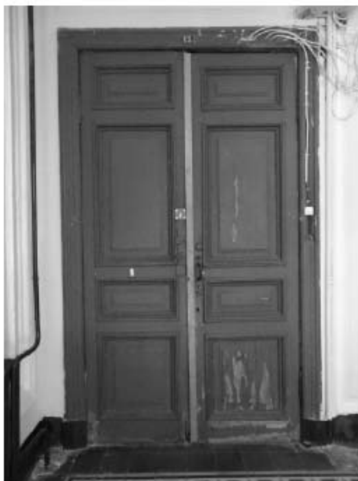
Фото 116. Лестница №1: 4-й этаж. Съемка 19.04.2021 г. Михайловская Г. В.
