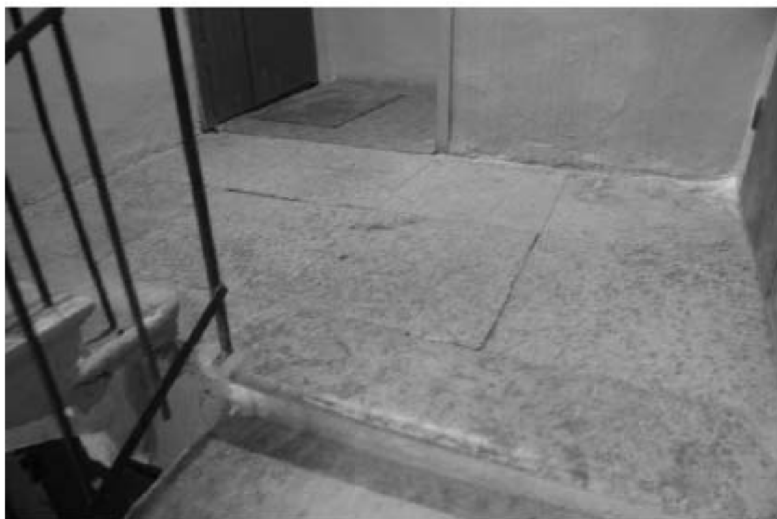
Фото 92. Лестница №4: 1-й этаж. Известняковые плиты. Съемка 19.04.2021 г. Михайловская Г. В.
