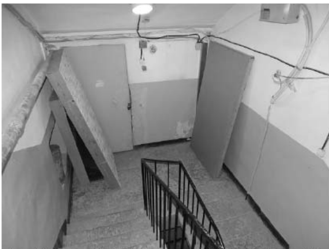
Фото 131. Лестница № 2(3): 6-й этаж. Съемка 19.04.2021 г. Михайловская Г. В.
