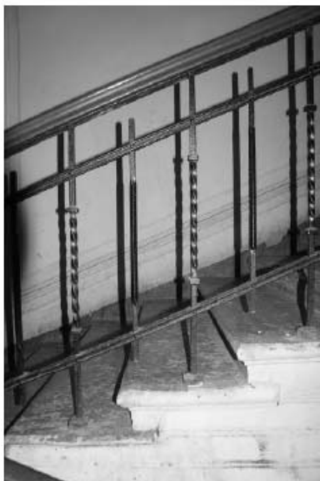
Фото 134. Лестница №2(1): Фрагмент лестничного ограждения. Съемка 19.04.2021 г. Михайловская Г. В.
