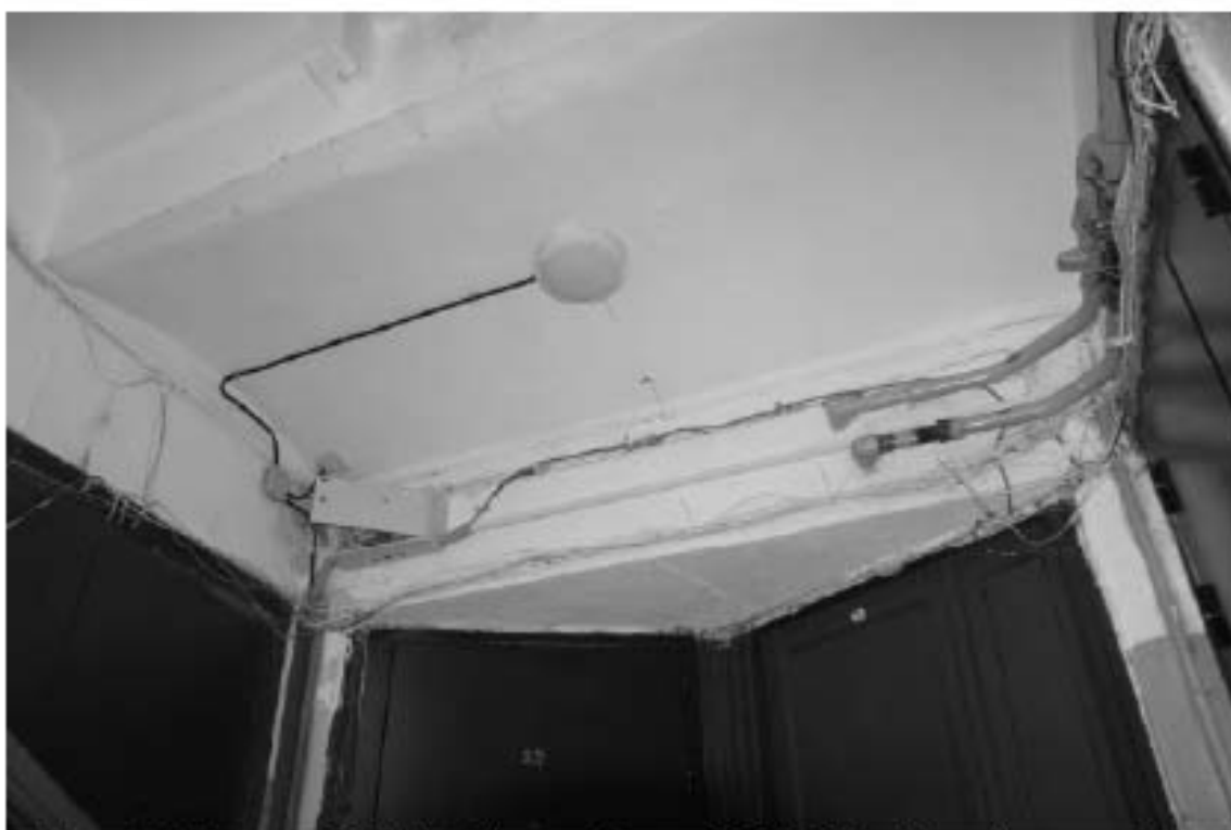
Фото 52. Лестница № 2(2): 2-й этаж. Съемка 19.04.2021 г. Михайловская Г. В.
