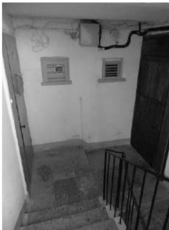
Фото 150. Лестница №3(1): 1-й этаж. Съемка 19.04.2021 г. Михайловская Г. В.
