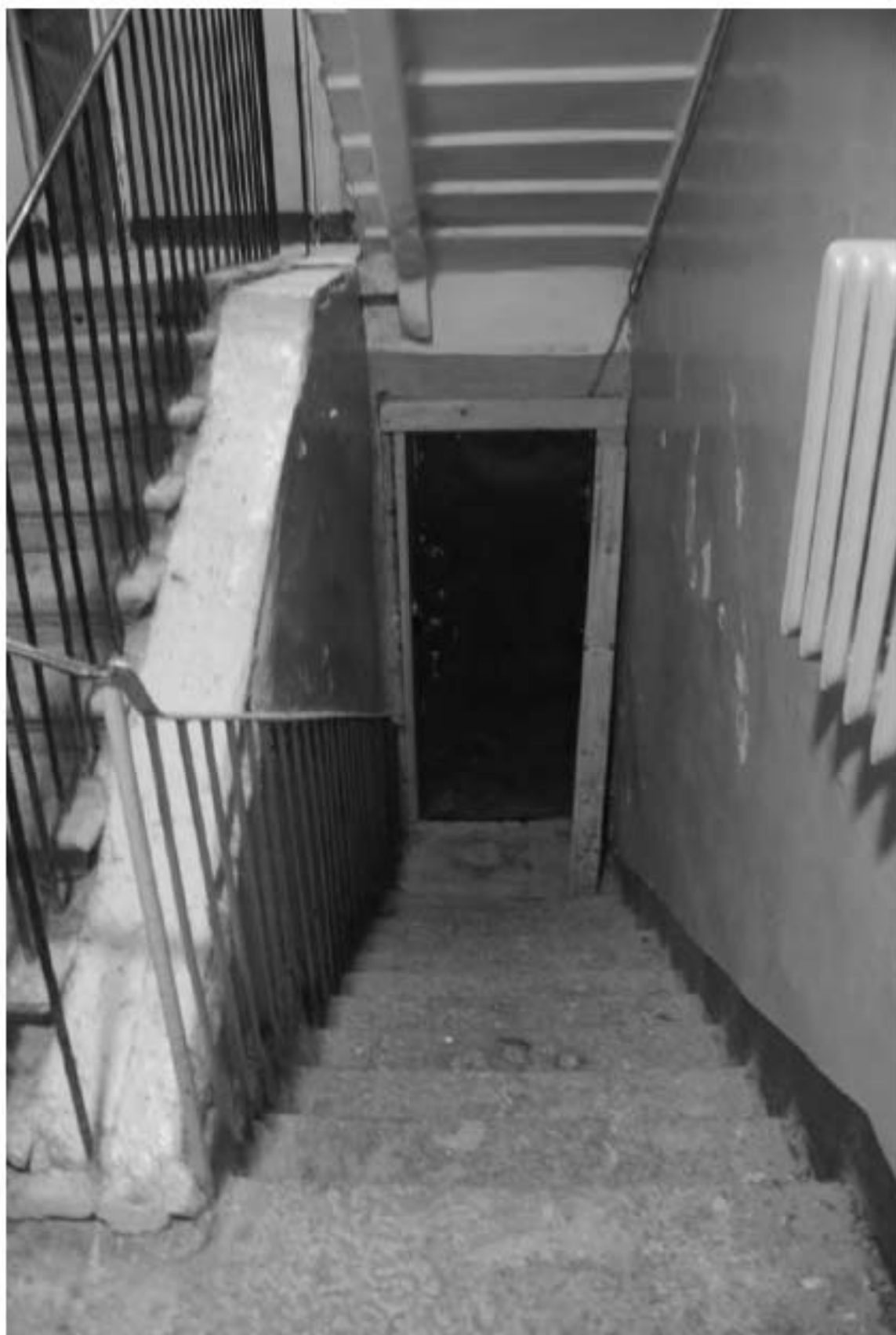
Фото 65. Лестница № 2(3): Вестибюль 1-го этажа. Вход в подвал. Съемка 19.04.2021 г. Михайловская Г. В.
