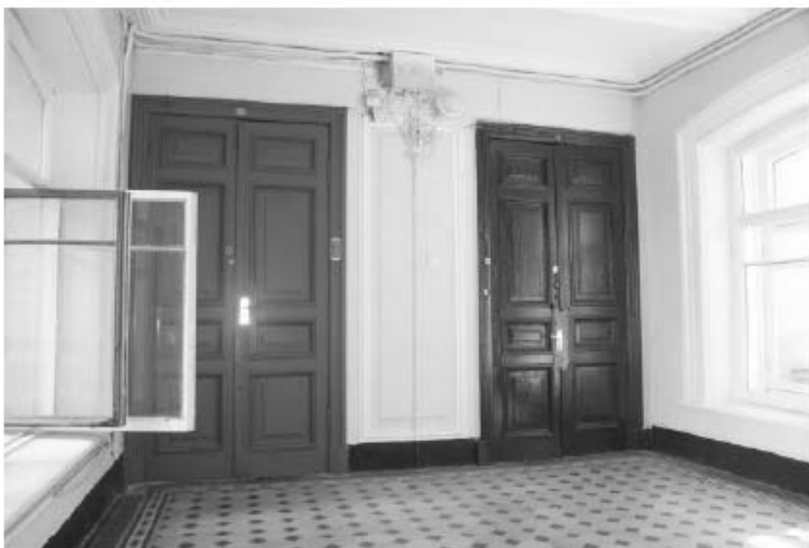
Фото 100. Лестница №1: 2-й этаж. Съемка 19.04.2021 г. Михайловская Г. В.
