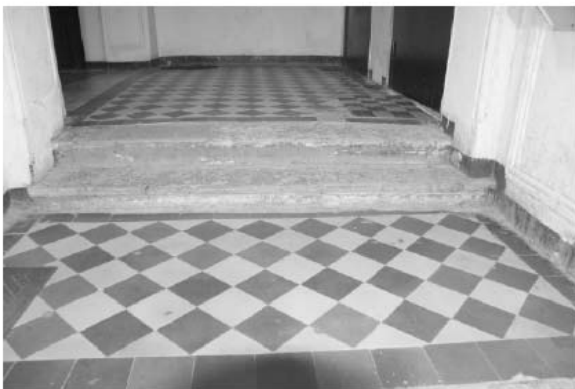
Фото 129. Лестница №2(1): 1-й этаж. Покрытие пола. Съемка 19.04.2021 г. Михайловская Г. В.
