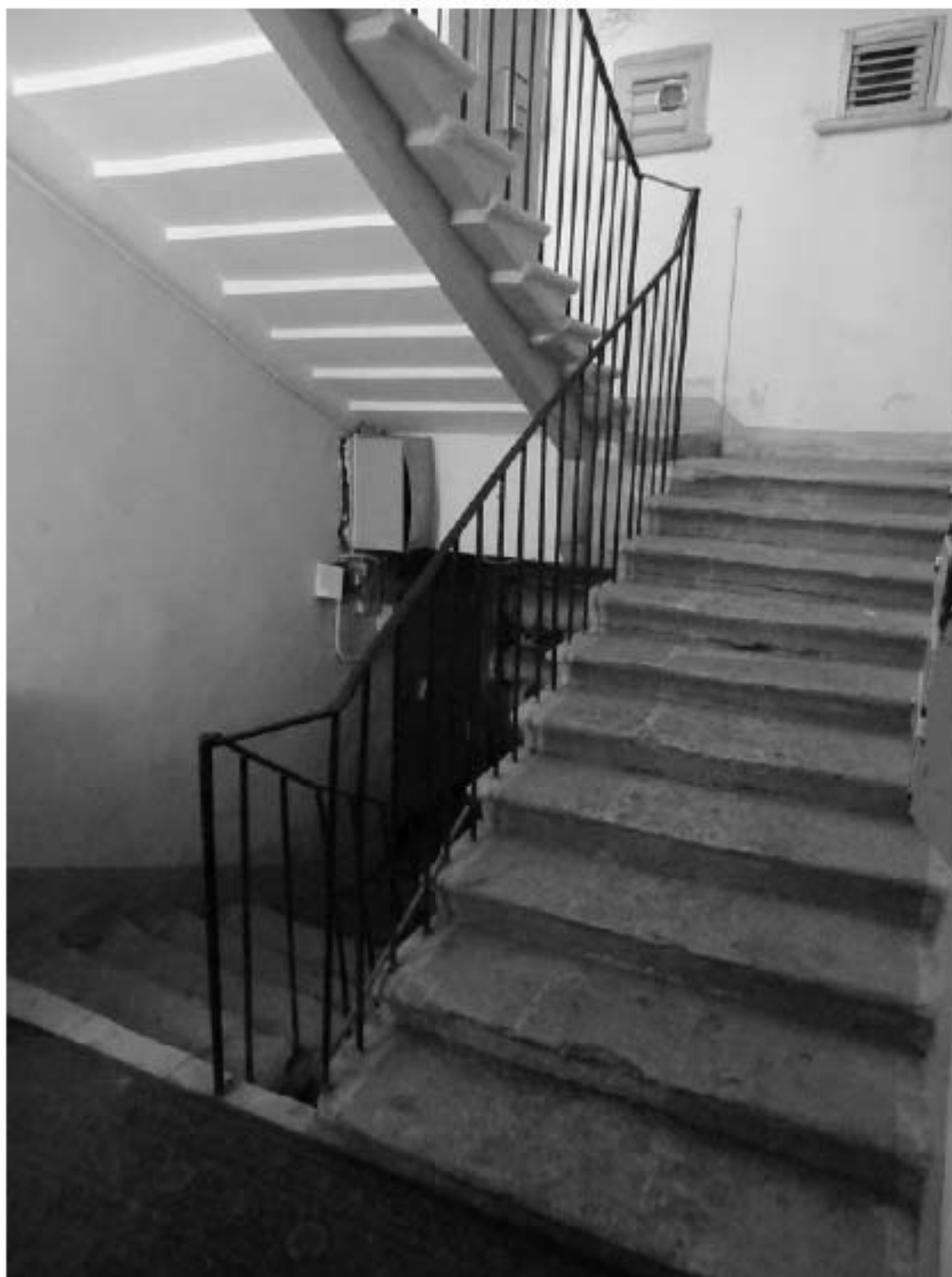
Фото 144. Лестница №3(1): 1-й этаж. Съемка 19.04.2021 г. Михайловская Г. В.
