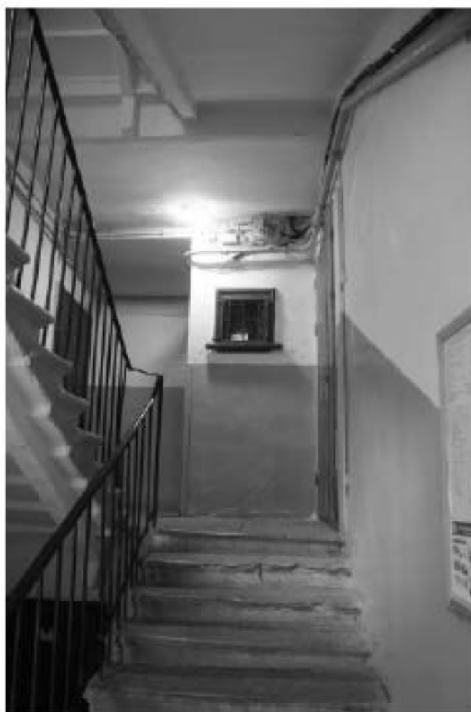
Фото 91. Лестница №4: 1-й этаж. Съемка 19.04.2021 г. Михайловская Г. В.
