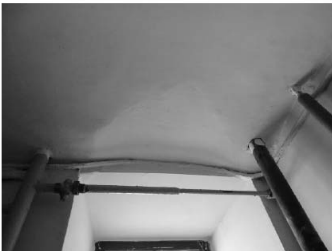
Фото 149. Лестница №3(1): 1-й этаж. Коробовый свод с распалубками. Съемка 19.04.2021 г. Михайловская Г. В.
