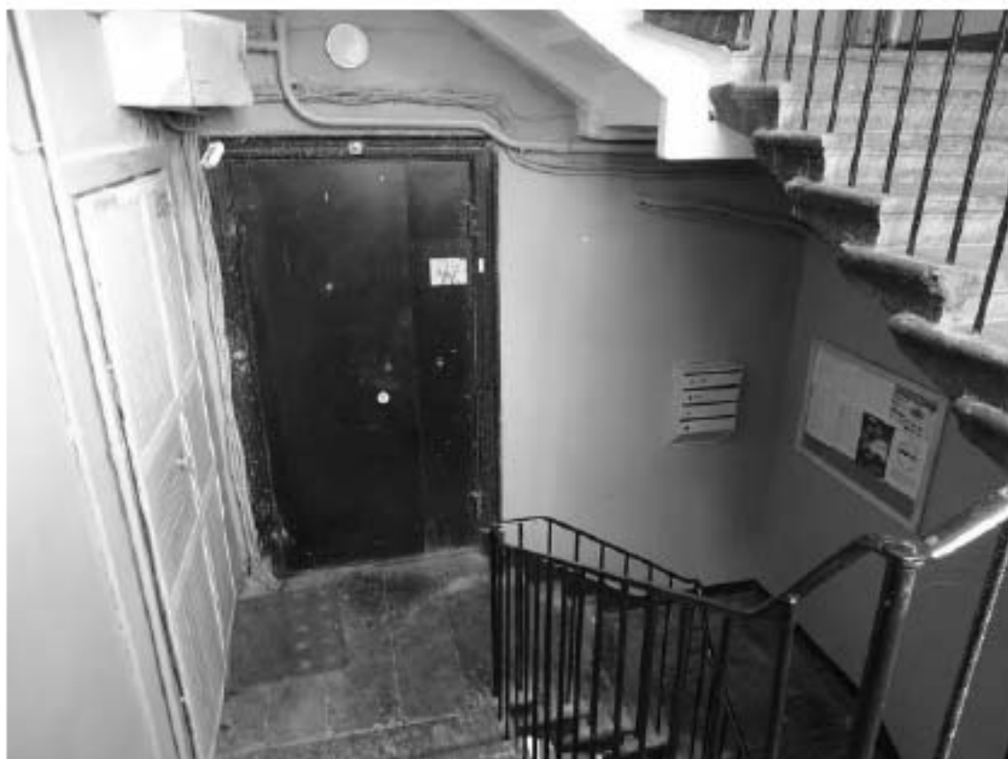
Фото 157. Лестница №6: 2-й этаж. Съемка 19.04.2021 г. Михайловская Г. В.
