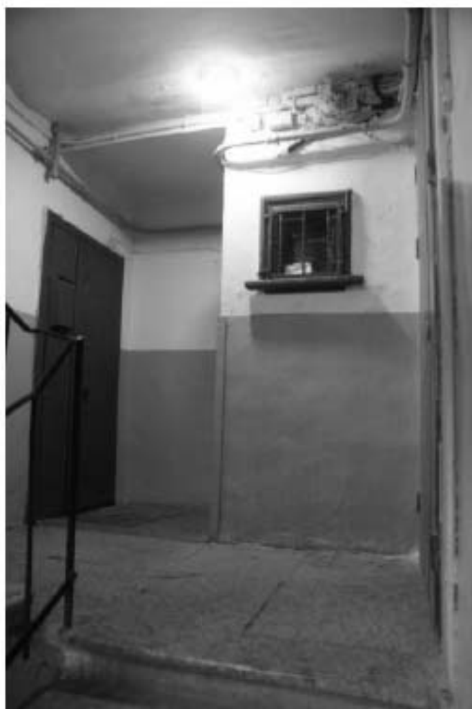
Фото 93. Лестница №4: 1-й этаж. Съемка 19.04.2021 г. Михайловская Г. В.
