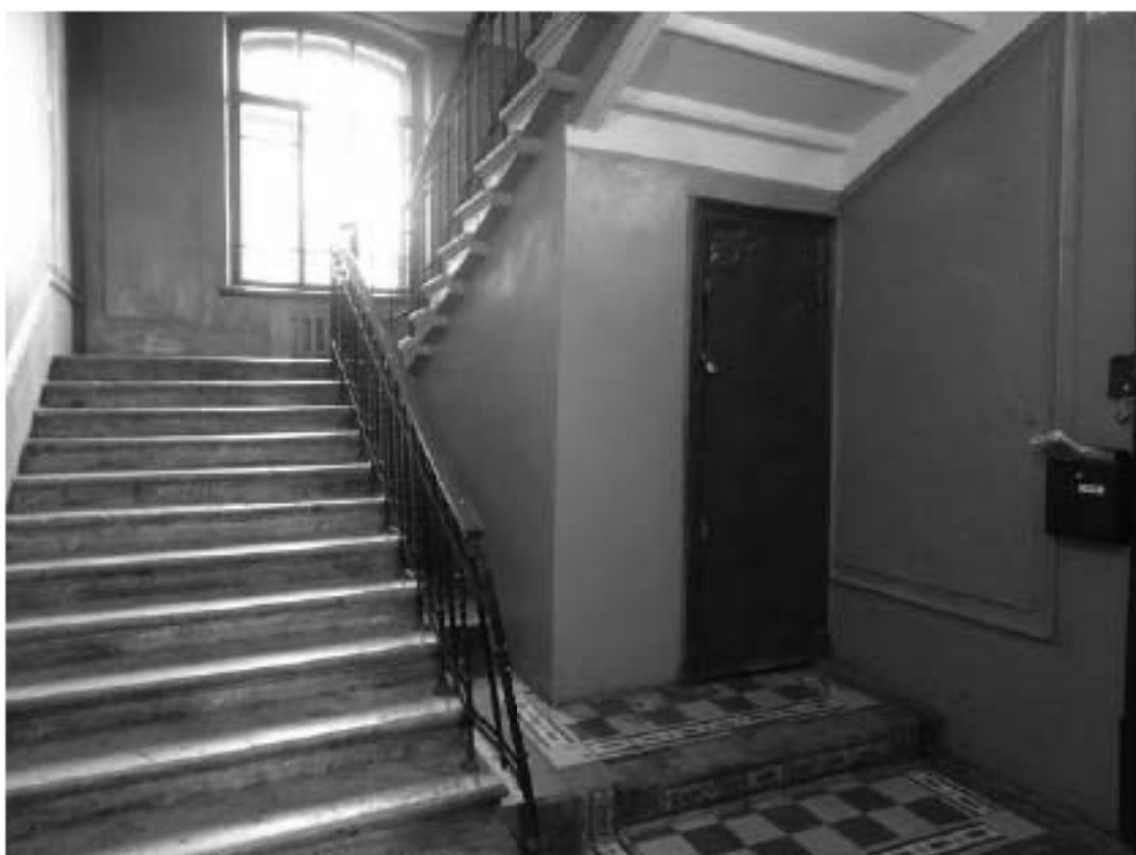
Фото 59. Лестница № 1: Вид на площадку между 1-м и 2м этажом. Съемка 19.04.2021 г. Михайловская Г. В.
