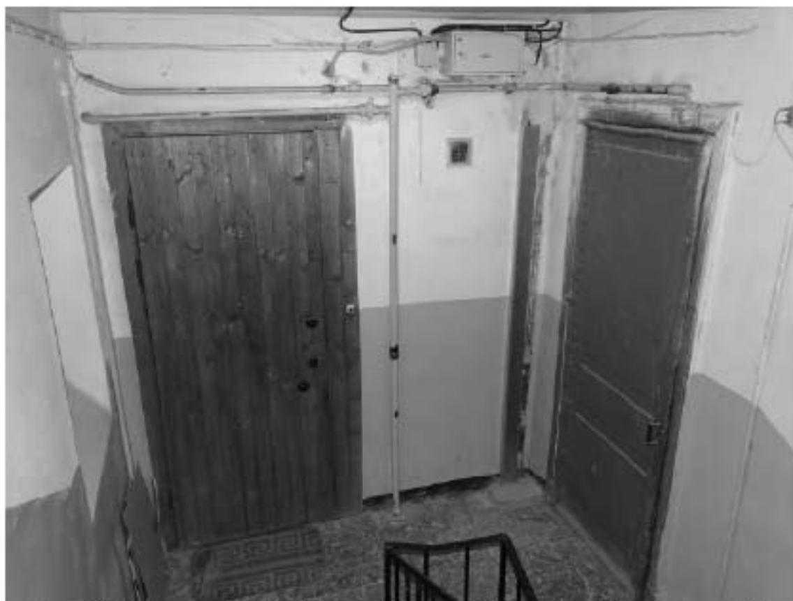
Фото 123. Лестница № 2(3): 5-й этаж. Съемка 19.04.2021 г. Михайловская Г. В.
