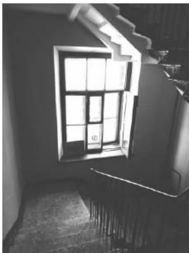
Фото 161. Лестница №6: Площадка м/у 3-м и 4-м этажом. Съемка 19.04.2021 г. Михайловская Г. В.
