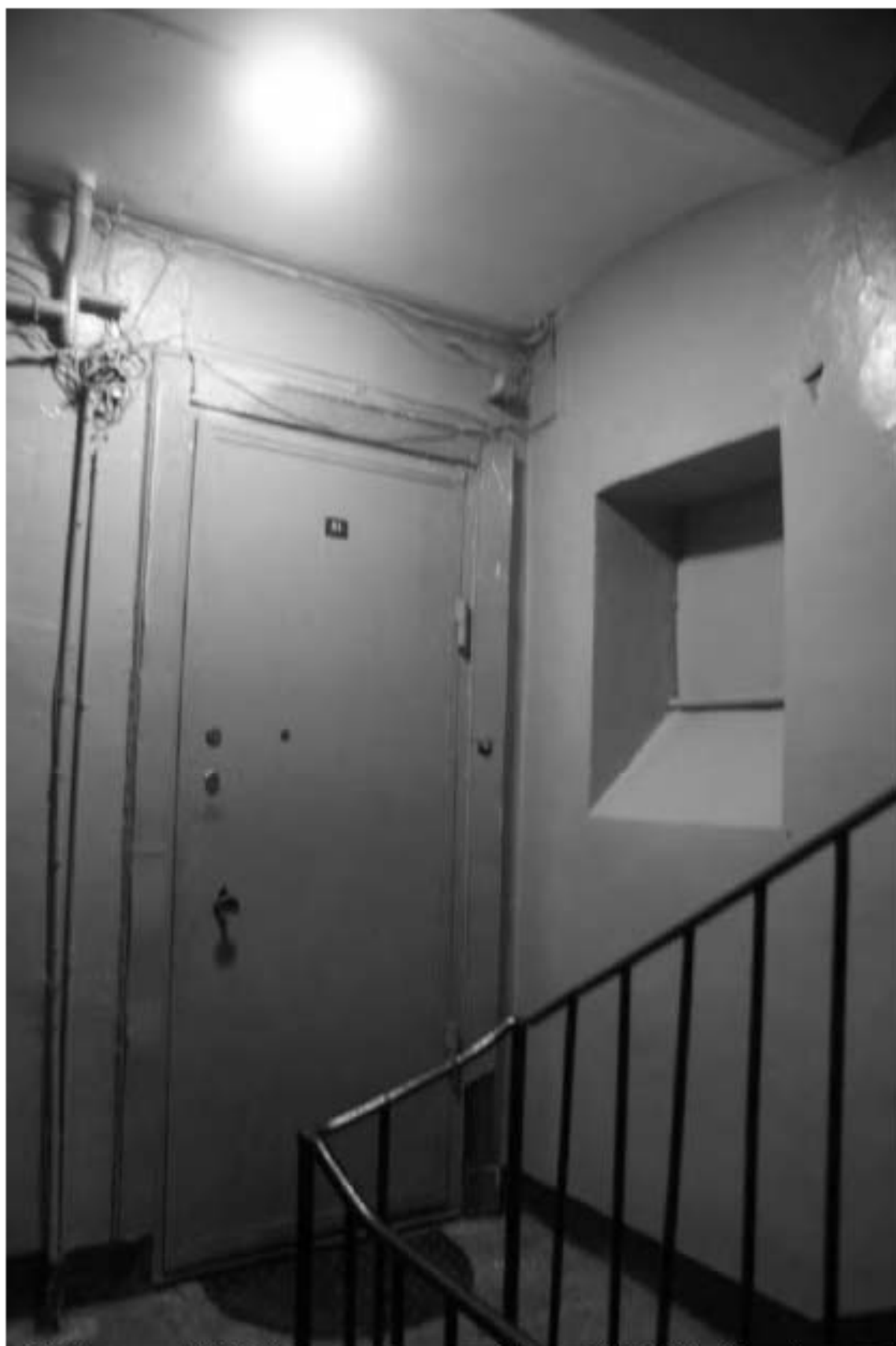
Фото 69. Лестница № 2(3): Площадка 1-го этажа. Съемка 19.04.2021 г Михайловская Г. В.
