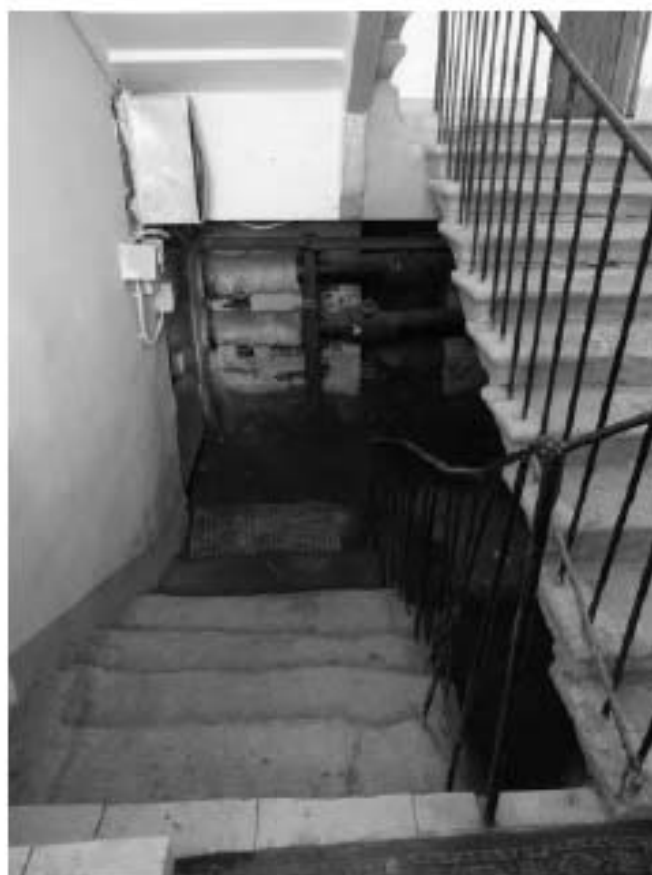
Фото 145. Лестница №3(1)1-й этаж. Спуск в подвал. Съемка 19.04.2021 г. Михайловская Г. В.
