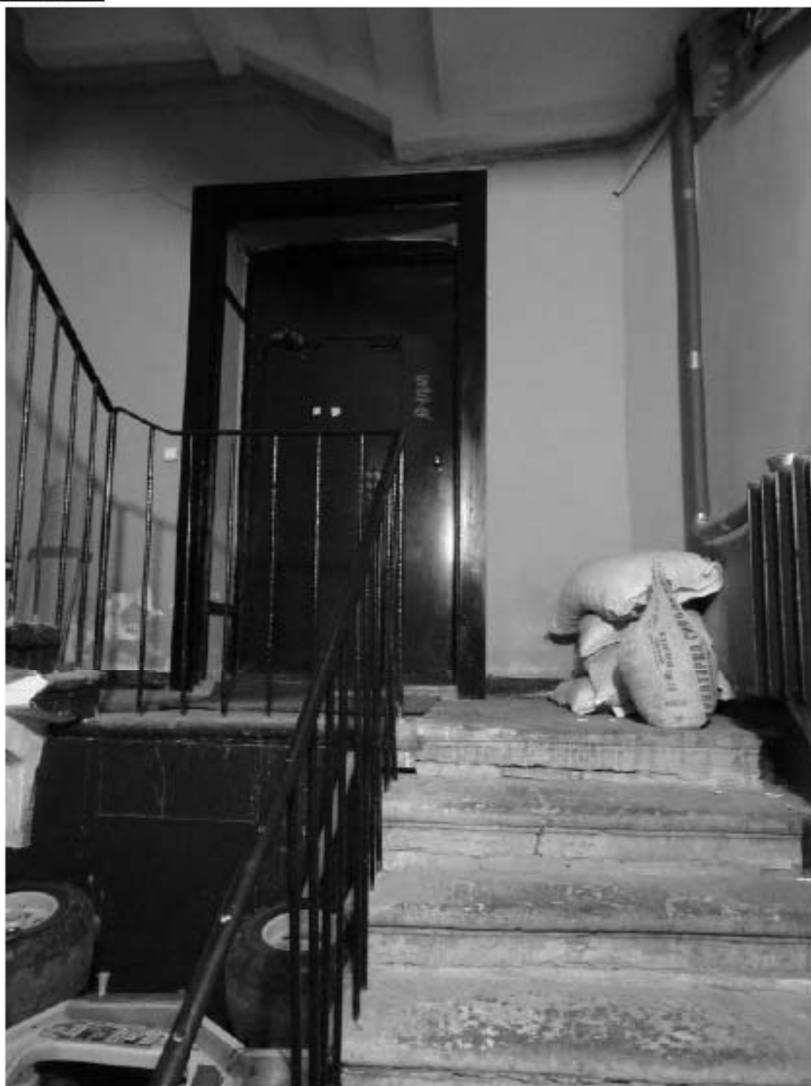
Фото 152. Лестница №6: 1-й этаж. Съемка 19.04.2021 г. Михайловская Г. В.
