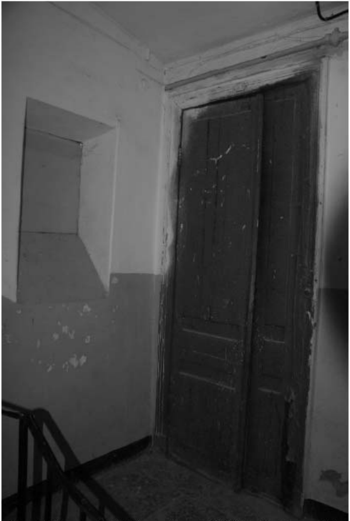
Фото 102. Лестница № 2(3): 1-й этаж. Съемка 19.04.2021 г. Михайловская Г. В.
