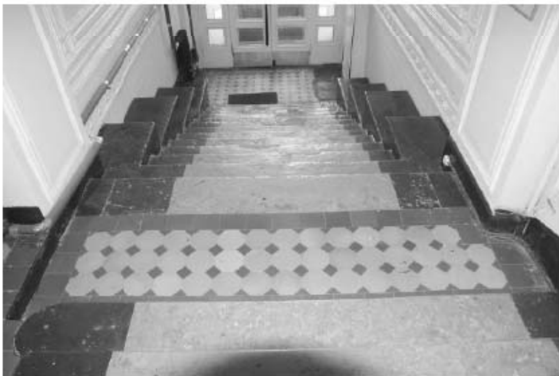
Фото 95. Лестница №1: 1-й этаж. Парадная. Съемка 19.04.2021 г. Михайловская Г. В.
