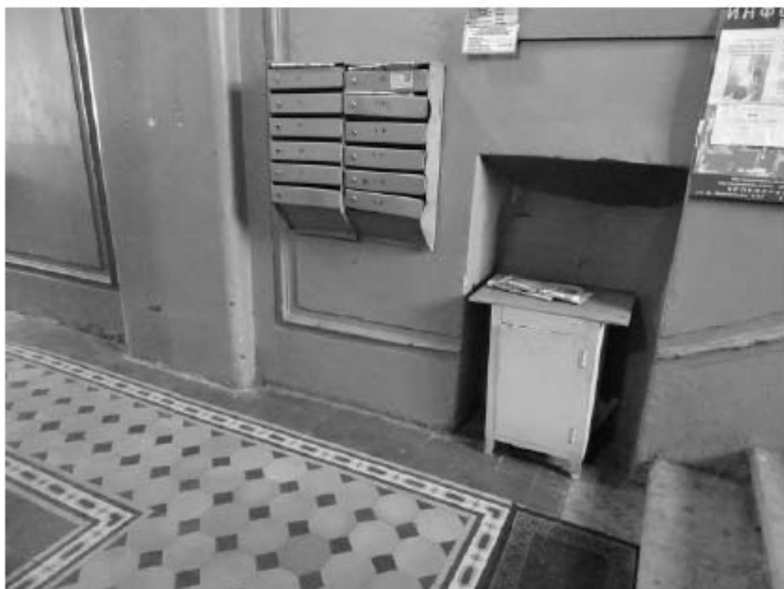
Фото 56. Лестница № 1: Площадка 1-го этажа. Съемка 19.04.2021 г. Михайловская Г. В.
