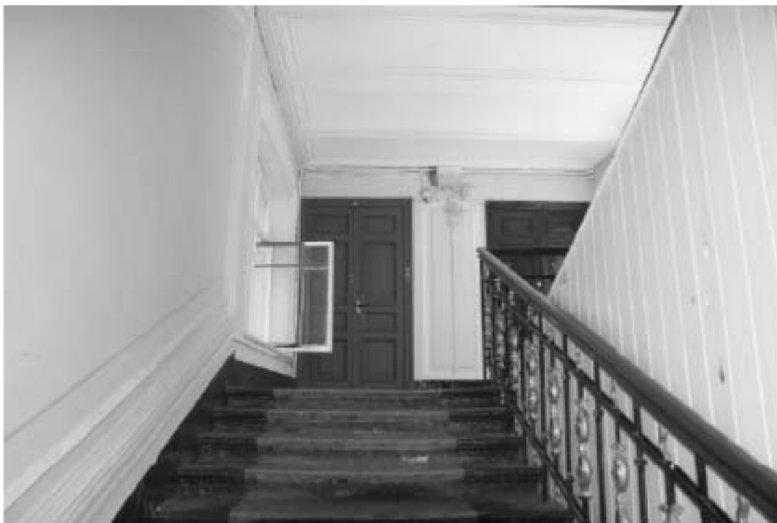
Фото 99. Лестница №1: 2-й этаж. Съемка 19.04.2021 г. Михайловская Г. В.
