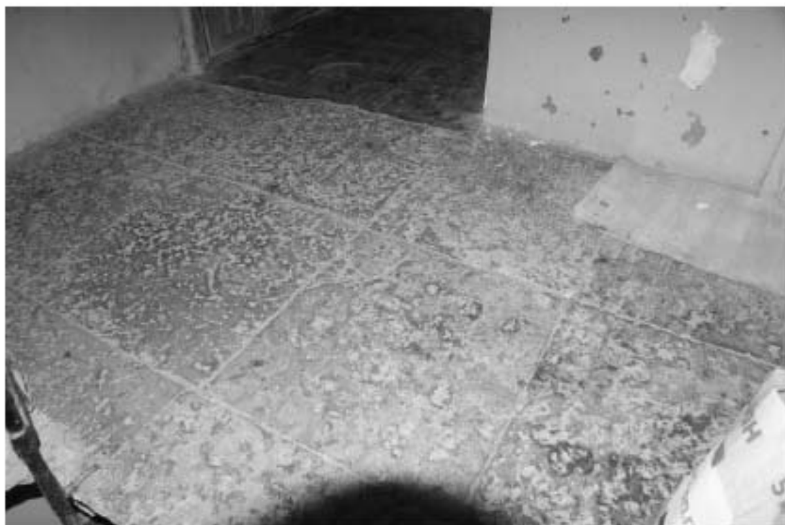
Фото 100. Лестница №4: 2-й этаж. Известняковые плиты. Съемка 19.04.2021 г. Михайловская Г. В.
