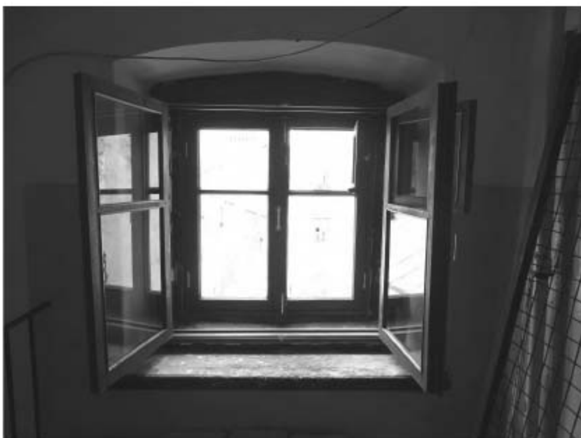
Фото 135. Лестница № 2(3): Площадка 6-го этажа. Оформление окна. Съёмка 19.04.2021 г. Михайловская Г. В.
