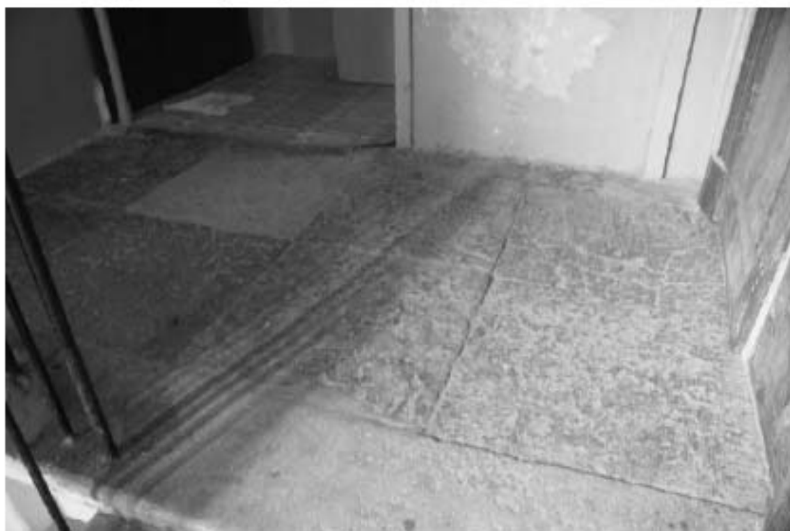
Фото 108. Лестница №4: 3-й этаж. Известняковые плиты. Съемка 19.04.2021 г. Михайловская Г. В.
