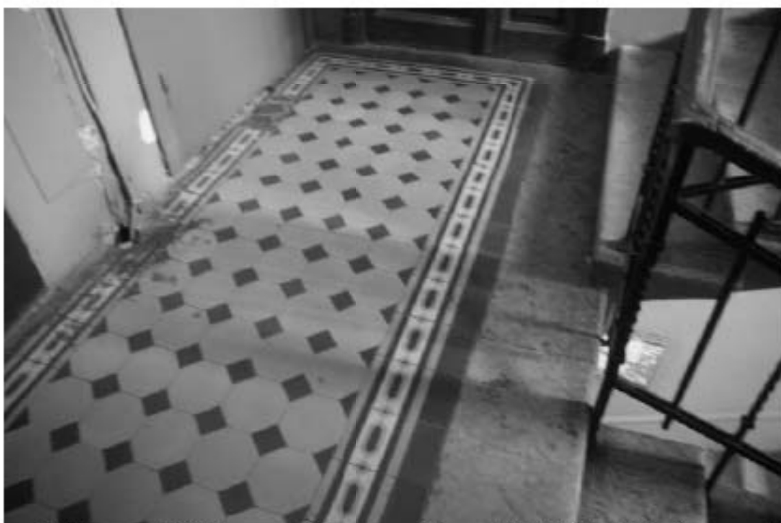
Фото 69. Лестница № 1: Площадка 2-го этажа. Съемка 19.04.2021 г. Михайловская Г. В.
