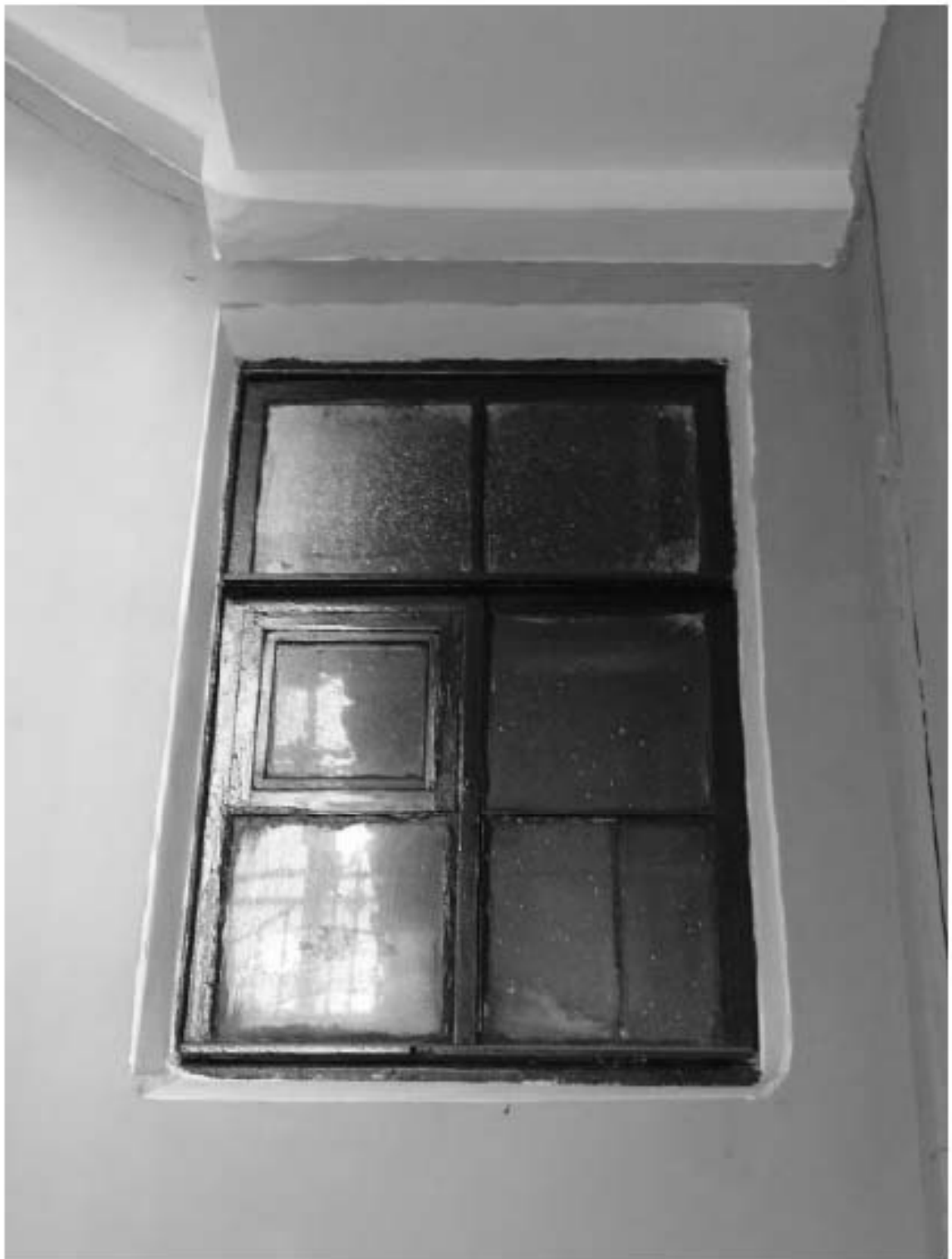
Фото 164. Лестница №6: 4-й этаж. Съемка 19.04.2021 г. Михайловская Г. В.
