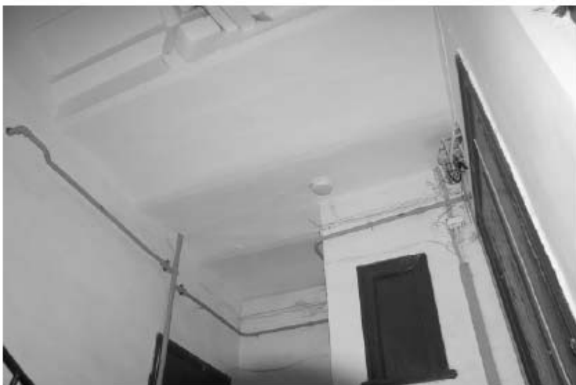
Фото 109. Лестница №4: 3-й этаж. Своды. Съемка 19.04.2021 г. Михайловская Г. В.
