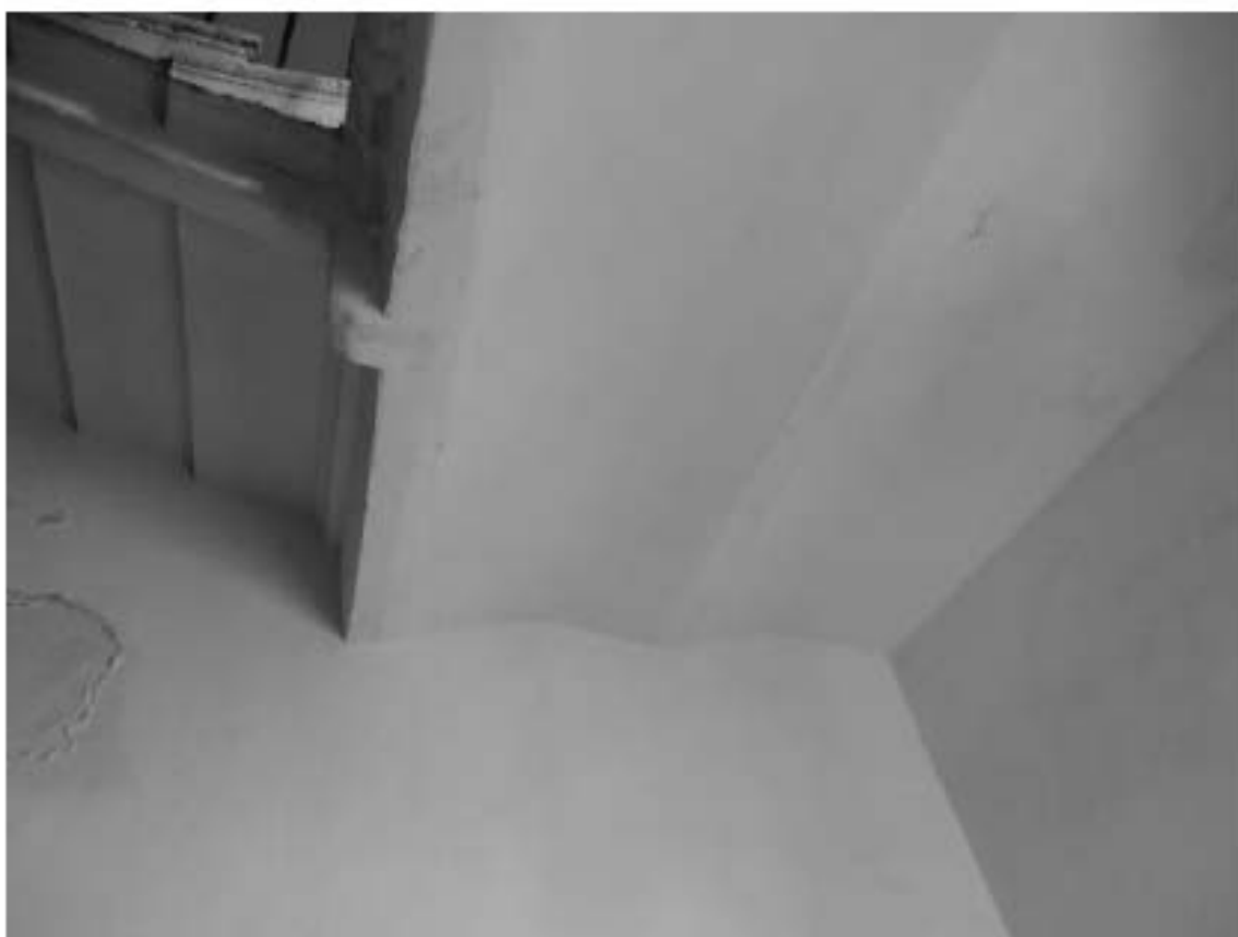
Фото 115. Лестница №4: 4-й этаж. Своды. Съемка 19.04.2021 г. Михайловская Г. В.
