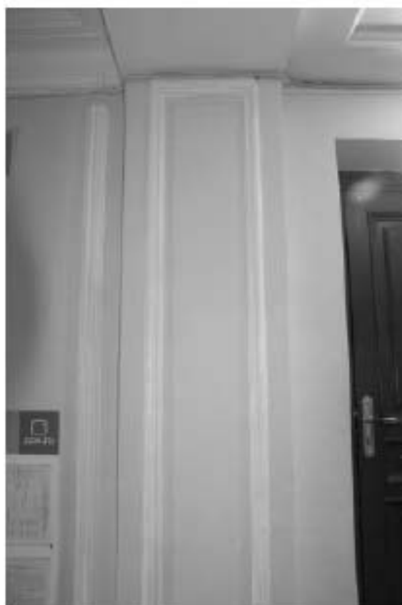
Фото 96. Лестница №1: 1-й этаж. Парадная. Зеркала в штукатурном профилированном обрамлении. Съемка 19.04.2021 г. Михайловская Г. В.
