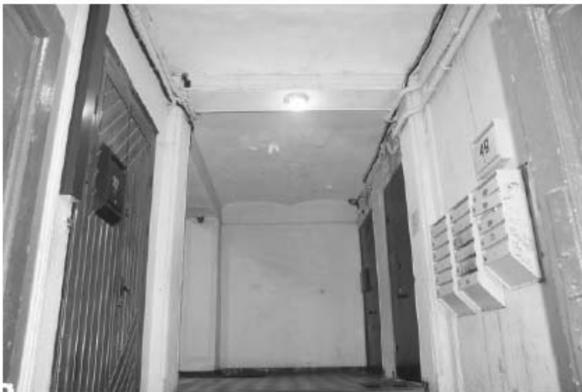
Фото 128. Лестница №2(1): 1-й этаж. Съемка 19.04.2021 г. Михайловская Г. В.
