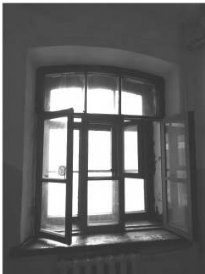
Фото 116. Лестница № 2(3): Площадка между 3-м и 4-м этажом. Оформление оконного проема. Съемка 19.04.2021 г. Михайловская Г. В.
