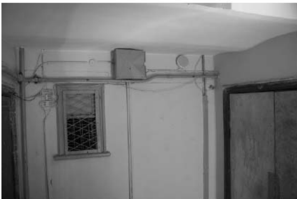
Фото 164. Лестница №3(1): 4-й этаж. Съемка 19.04.2021 г. Михайловская Г. В.
