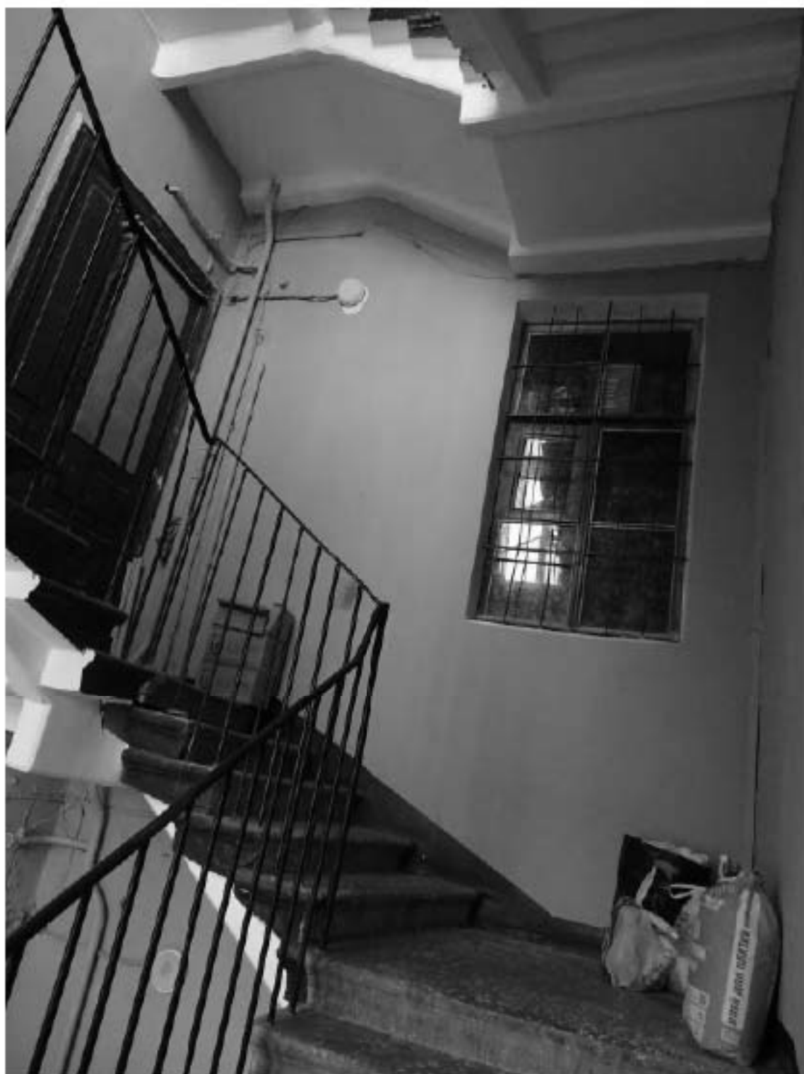
Фото 166. Лестница №6: 5-й этаж. Съемка 19.04.2021 г. Михайловская Г. В.
