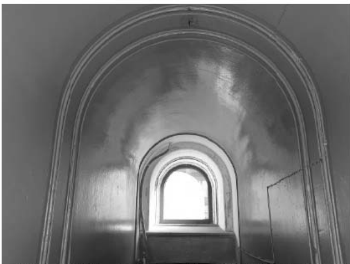
Фото 49. Лестница № 1: Вестибюль 1-го этажа. Съемка 19.04.2021 г. Михайловская Г. В.
