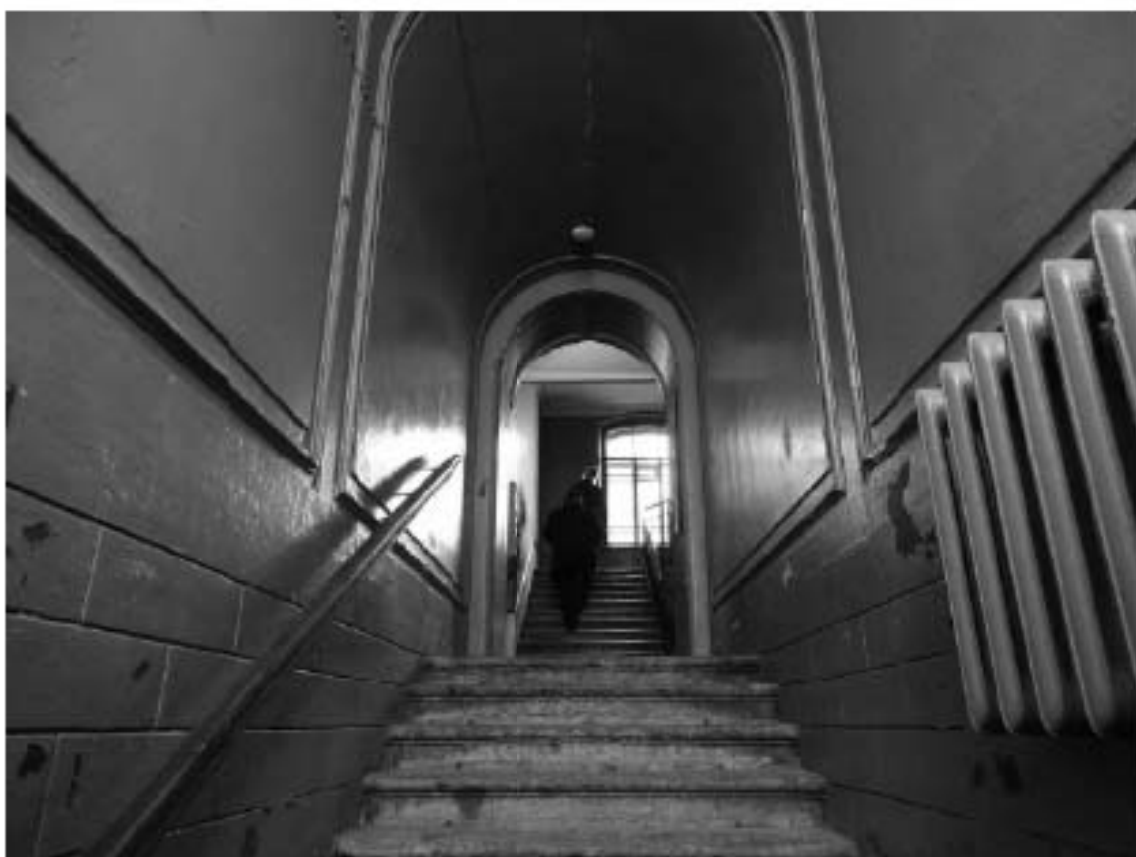
Фото 46. Лестница № 1: Вестибюль 1-й этаж. Съемка 19.04.2021 г. Михайловская Г. В.
