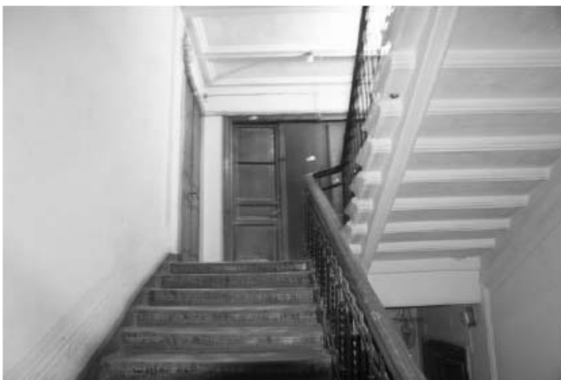
Фото 141. Лестница №2(1): 4-й этаж. Съемка 19.04.2021 г. Михайловская Г. В.
