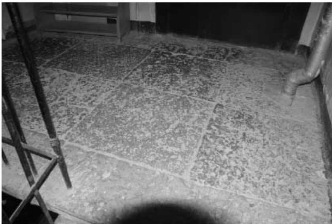
Фото 105. Лестница № 2(3): Площадка между 1-м и 2-м этажом. Известняковые плиты. Съемка 19.04.2021 г. Михайловская Г. В.
