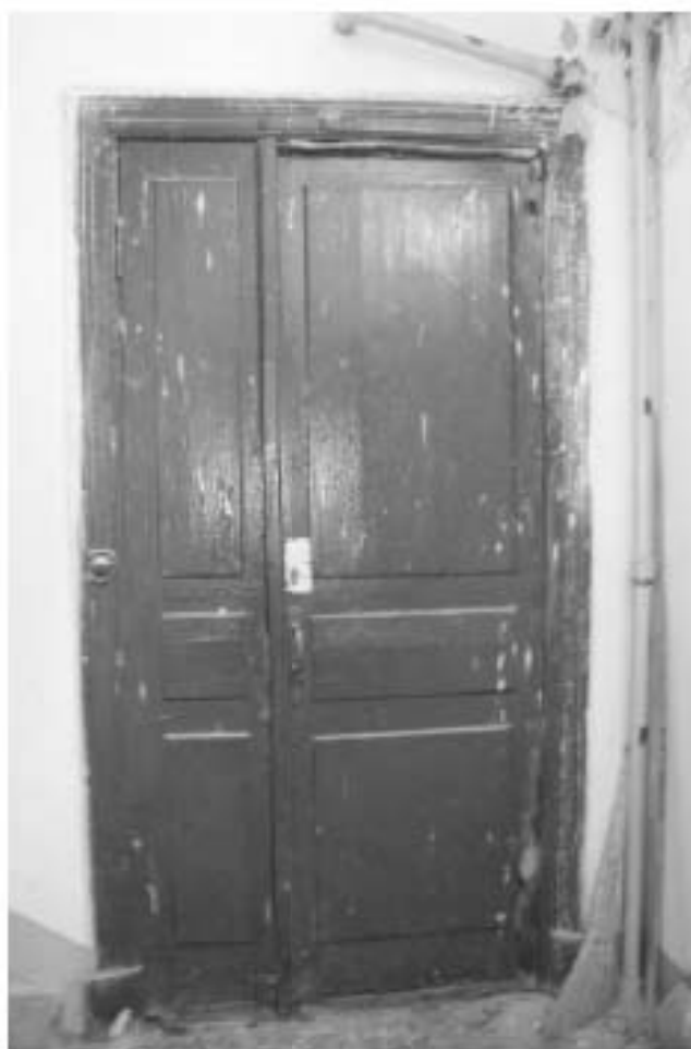
Фото 168. Лестница №3(1): 5-й этаж. Съемка 19.04.2021 г. Михайловская Г. В.
