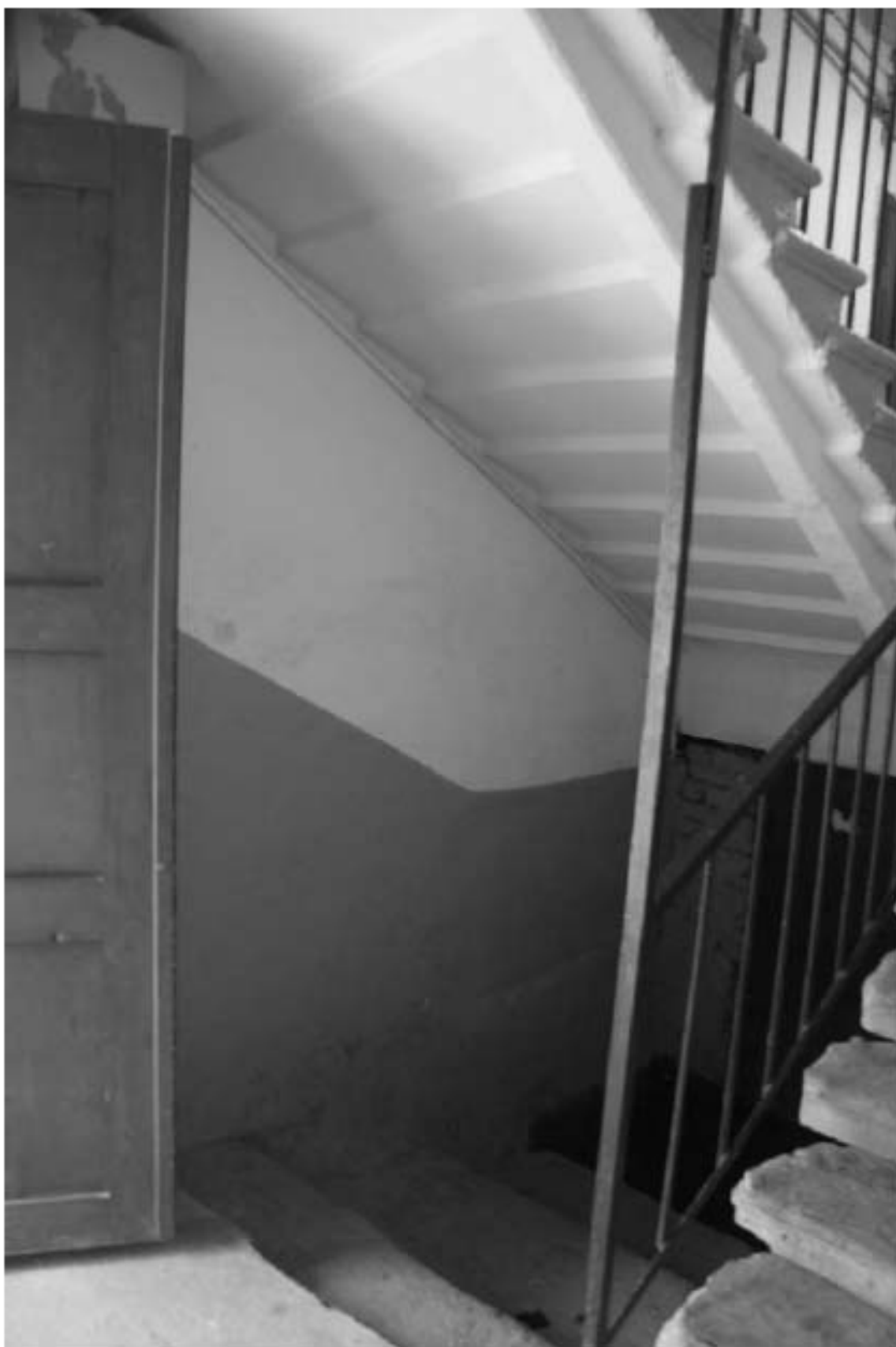
Фото 88. Лестница №4: 1-й этаж. Съемка 19.04.2021 г. Михайловская Г. В.
