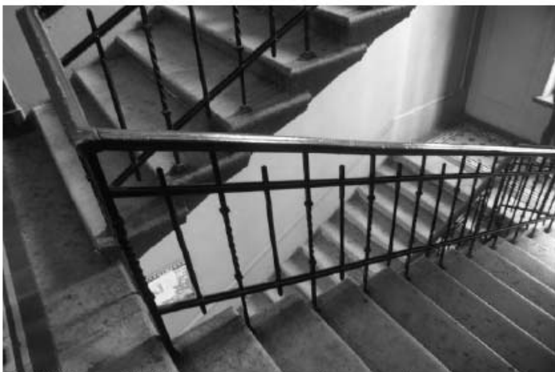
Фото 66. Лестница № 1: Площадка между 1-м и 2-м этажом. Лестничное ограждение. Съемка 19.04.2021 г. Михайловская Г. В.
