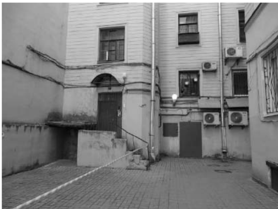
Фото 12. Здание по адресу: г. Санкт-Петербург, Большой проспект П.С., дом 45, литера А. Западный внутренний двор. Съемка 19.04.2021 г. Михайловская Г. В.
