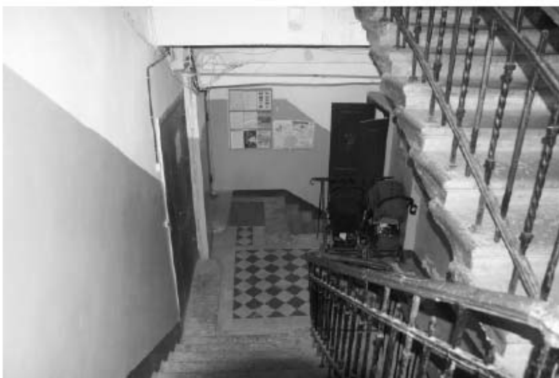
Фото 49. Лестница № 2(2): 1-й этаж. Съемка 19.04.2021 г. Михайловская Г. В.
