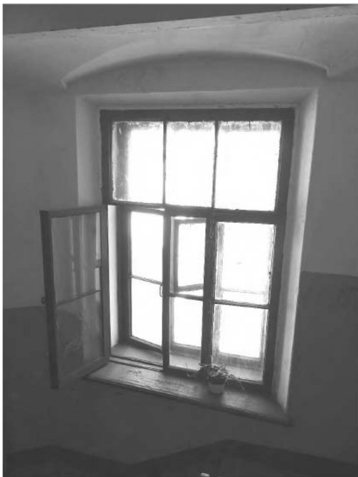
Фото 144. Лестница №4: Площадка м/у 5-м и 6-м этажом. Съемка 19.04.2021 г. Михайловская Г. В.
