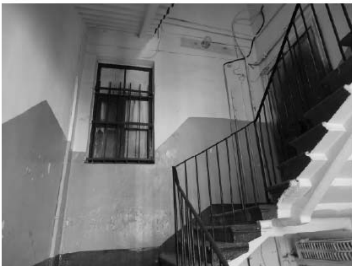
Фото 146. Лестница №4: 6-й этаж. Съемка 19.04.2021 г. Михайловская Г. В.
