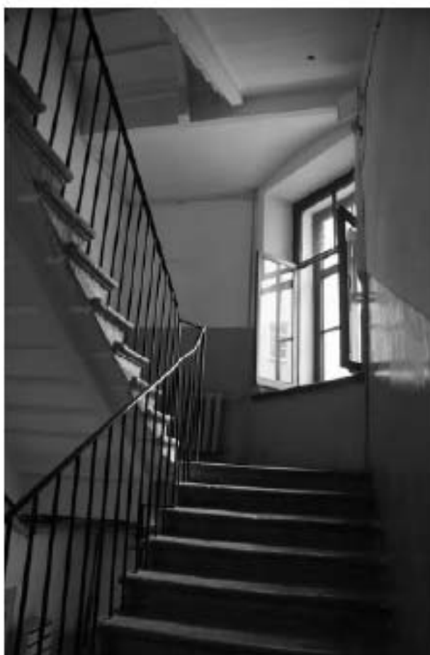
Фото 95. Лестница №4: Площадка м/у 1-м и 2-м этажом. Съемка 19.04.2021 г. Михайловская Г. В.
