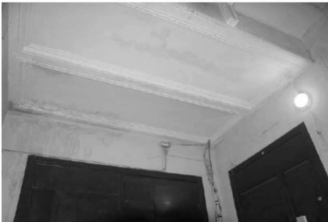
Фото 138. Лестница №2(1): 3-й этаж. Оформление потолка. Съемка 19.04.2021 г. Михайловская Г. В.
