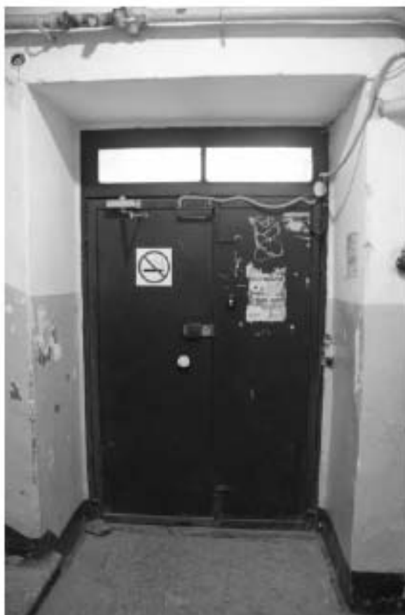
Фото 94. Лестница № 3(2): 1-й этаж. Входная дверь. Съемка 19.04.2021 г. Михайловская Г. В.
