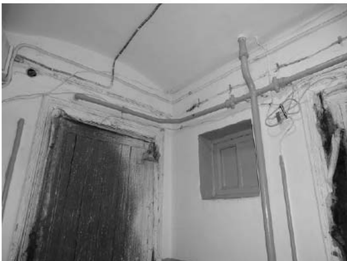
Фото 82. Лестница № 2(3): Площадка 3-го этажа. Съёмка 19.04.2021 г. Михайловская Г. В.
