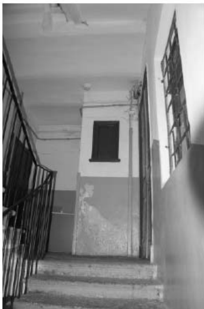
Фото 107. Лестница №4: 3-й этаж. Съемка 19.04.2021 г. Михайловская Г. В.
