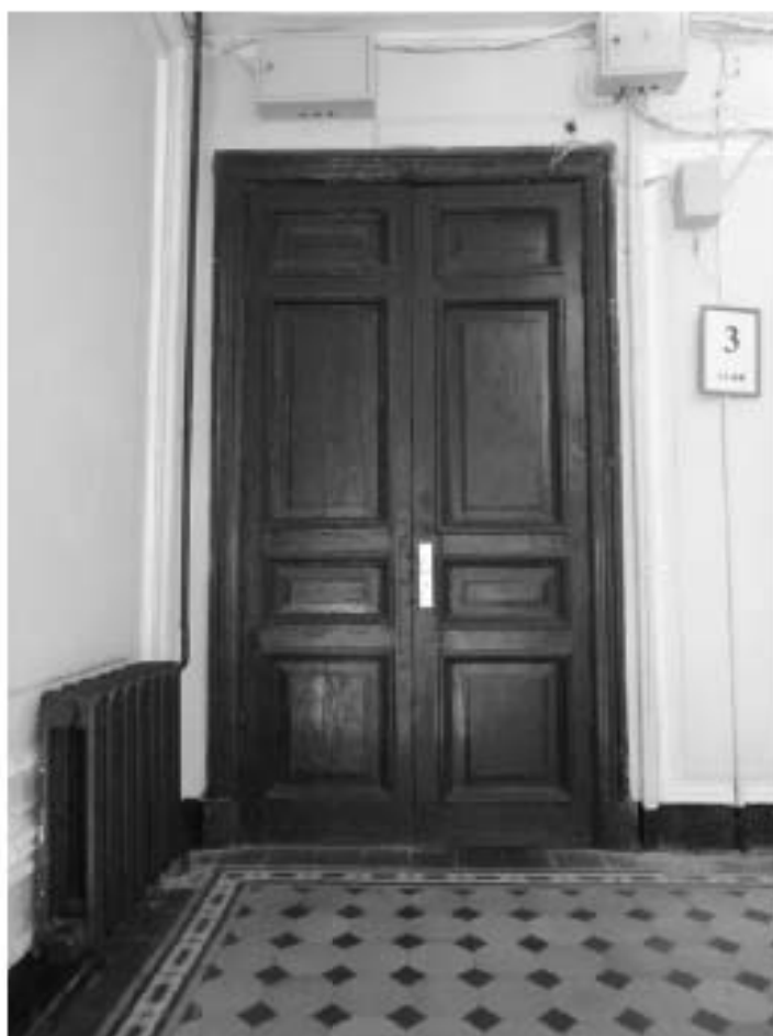
Фото 112. Лестница №1: 3-й этаж. Съемка 19.04.2021 г. Михайловская Г. В.
