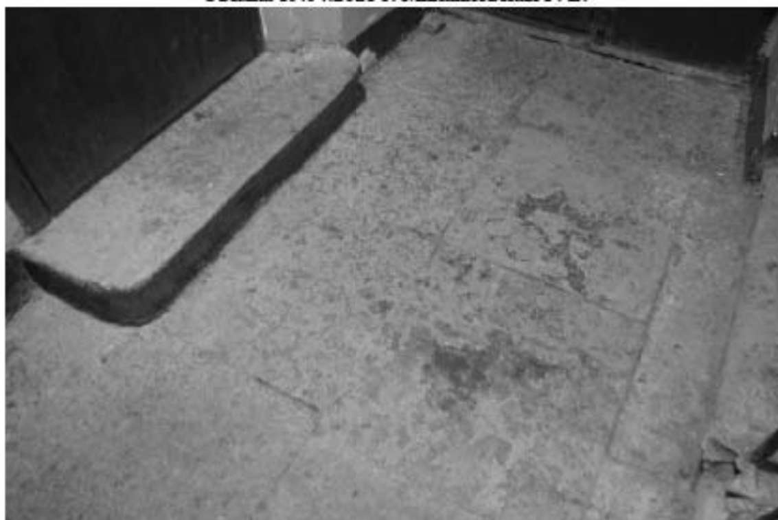
Фото 64. Лестница № 2(3): Вестибюль 1-го этажа. Покрытие пола. Съемка 19.04.2021 г Михайловская Г. В.
