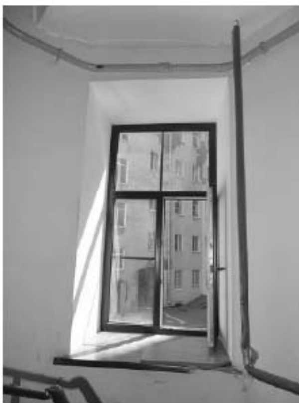
Фото 154. Лестница №3(1): Площадка м/у 1-м и 2-м этажом. Съемка 19.04.2021 г. Михайловская Г. В.
