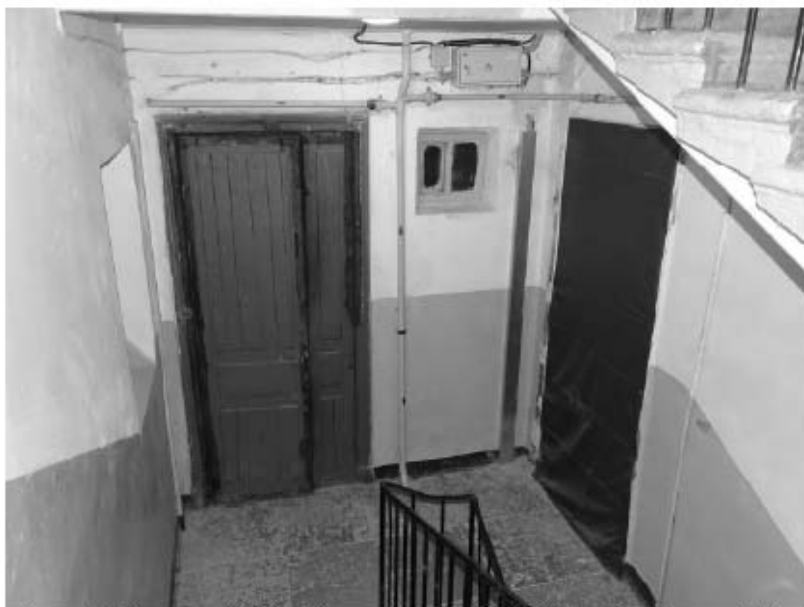
Фото 117. Лестница № 2(3): 4-й этаж. Съемка 19.04.2021 г. Михайловская Г. В.
