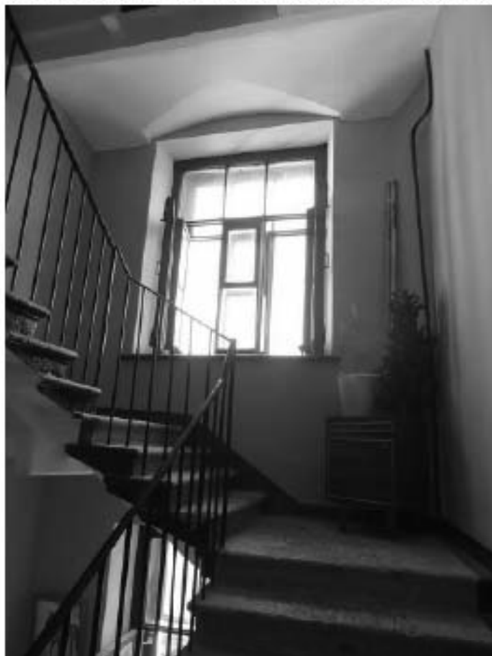
Фото 169. Лестница №6: Площадка м/у 5-м и 6-м этажом. Съемка 19.04.2021 г. Михайловская Г. В.
