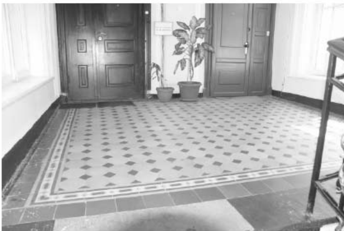
Фото 110. Лестница №1: 3-й этаж. Съемка 19.04.2021 г. Михайловская Г. В.
