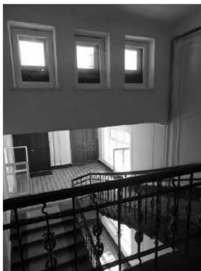
Фото 119. Лестница №1: 5-й этаж. Съемка 19.04.2021 г. Михайловская Г. В.
