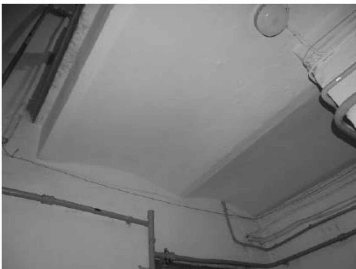
Фото 124. Лестница №4: 5-й этаж. Своды. Съемка 19.04.2021 г. Михайловская Г. В.
