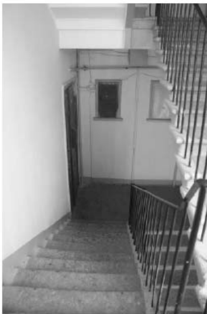
Фото 160. Лестница №3(1): 3-й этаж. Съемка 19.04.2021 г. Михайловская Г. В.
