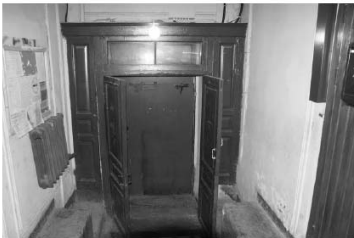
Фото 127. Лестница №2(1): 1-й этаж. Входной тамбур. Съемка 19.04.2021 г. Михайловская Г. В.
