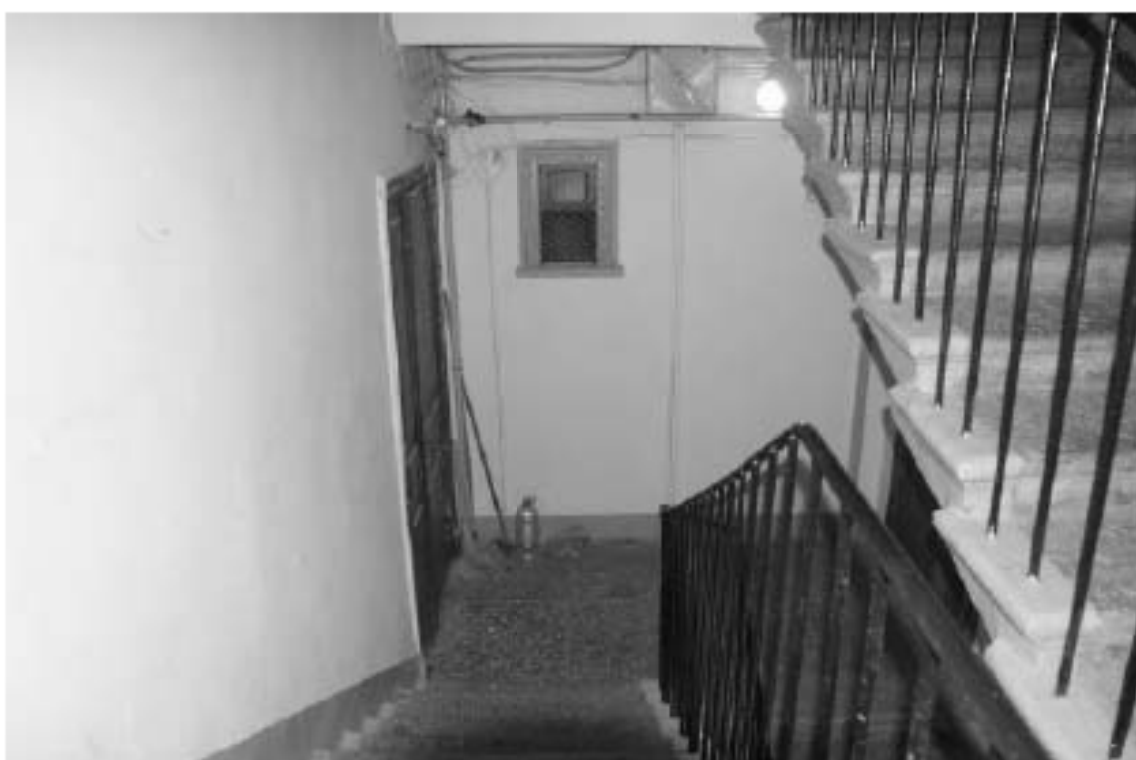
Фото 167. Лестница №3(1): 5-й этаж. Съемка 19.04.2021 г. Михайловская Г. В.
