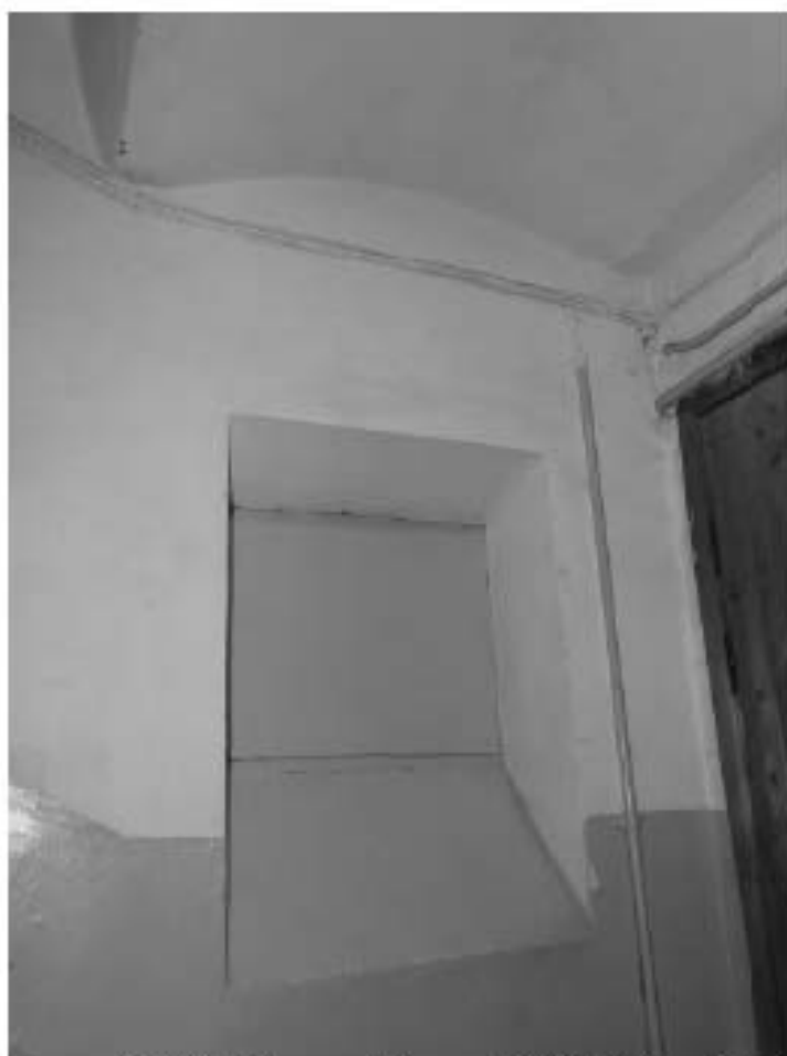
Фото 126. Лестница № 2(3): 5-й этаж. Съемка 19.04.2021 г. Михайловская Г. В.
