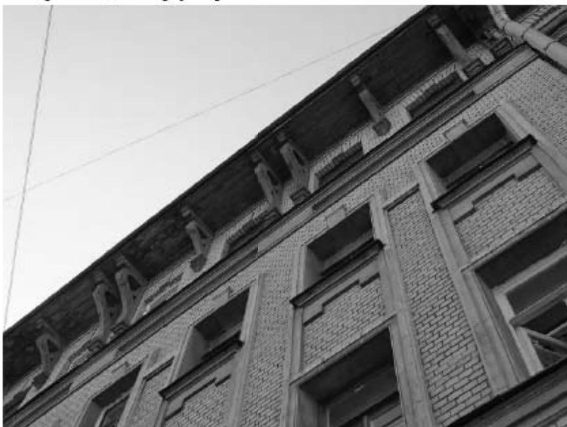
Фото 32. Здание по адресу: г. Санкт-Петербург, Большая Пушкарская улица, дом 38, литера А. Лицевой корпус. Фрагмент. Съемка 19.04.2021 г. Михайловская Г. В.
