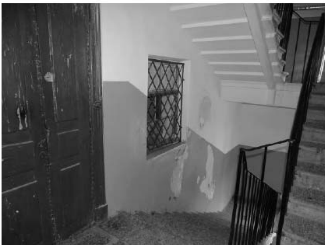
Фото 123. Лестница №4: 5-й этаж. Съемка 19.04.2021 г. Михайловская Г. В.
