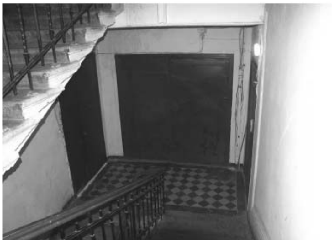
Фото 137. Лестница №2(1): 3-й этаж. Съемка 19.04.2021 г. Михайловская Г. В.
