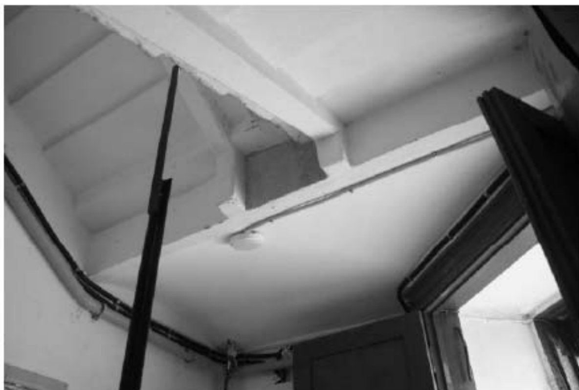
Фото 87. Лестница №4: 1-й этаж. Съемка 19.04.2021 г. Михайловская Г. В.
