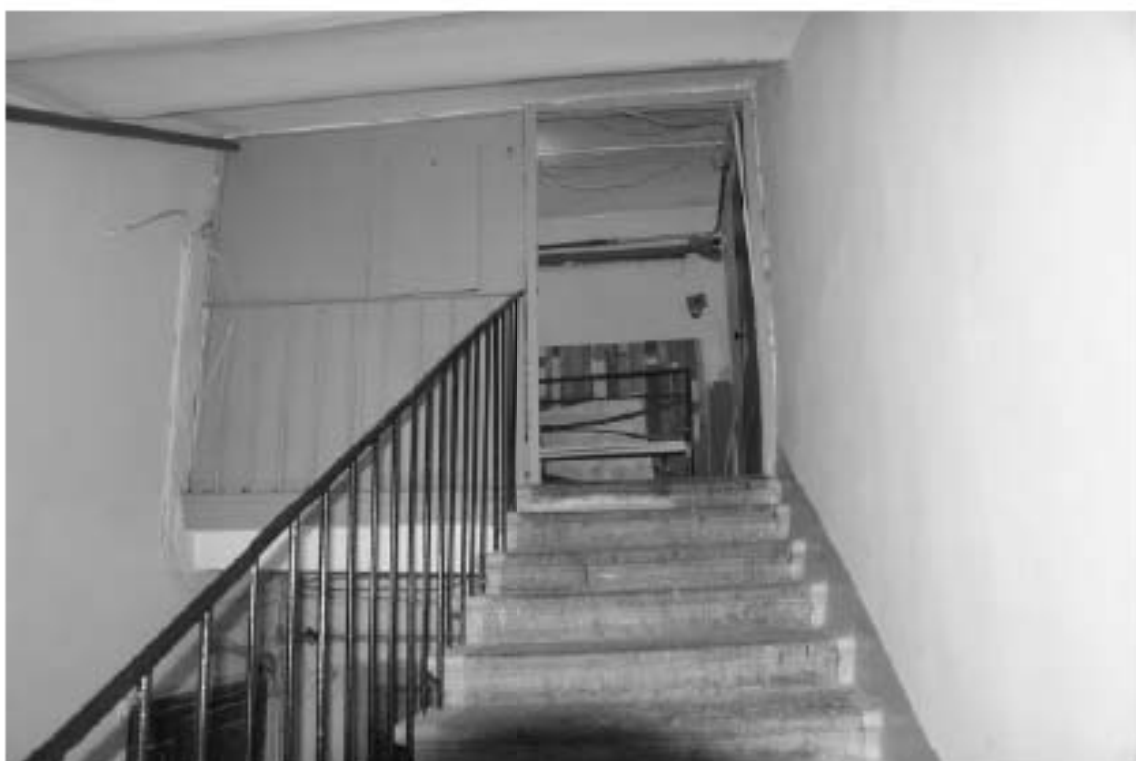
Фото 170. Лестница №3(1): 6-й этаж. Съемка 19.04.2021 г. Михайловская Г. В.
