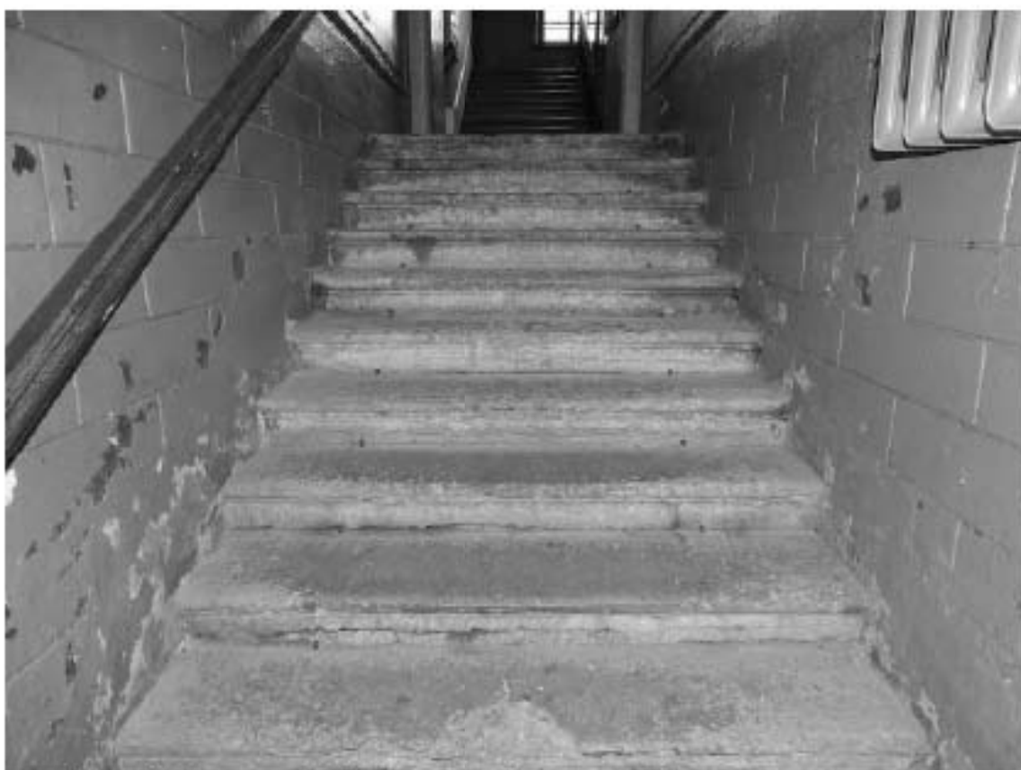
Фото 47. Лестница № 1: Вестибюль 1-го этажа. Одномаршевая лестница. Съемка 19.04.2021 г. Михайловская Г. В.
