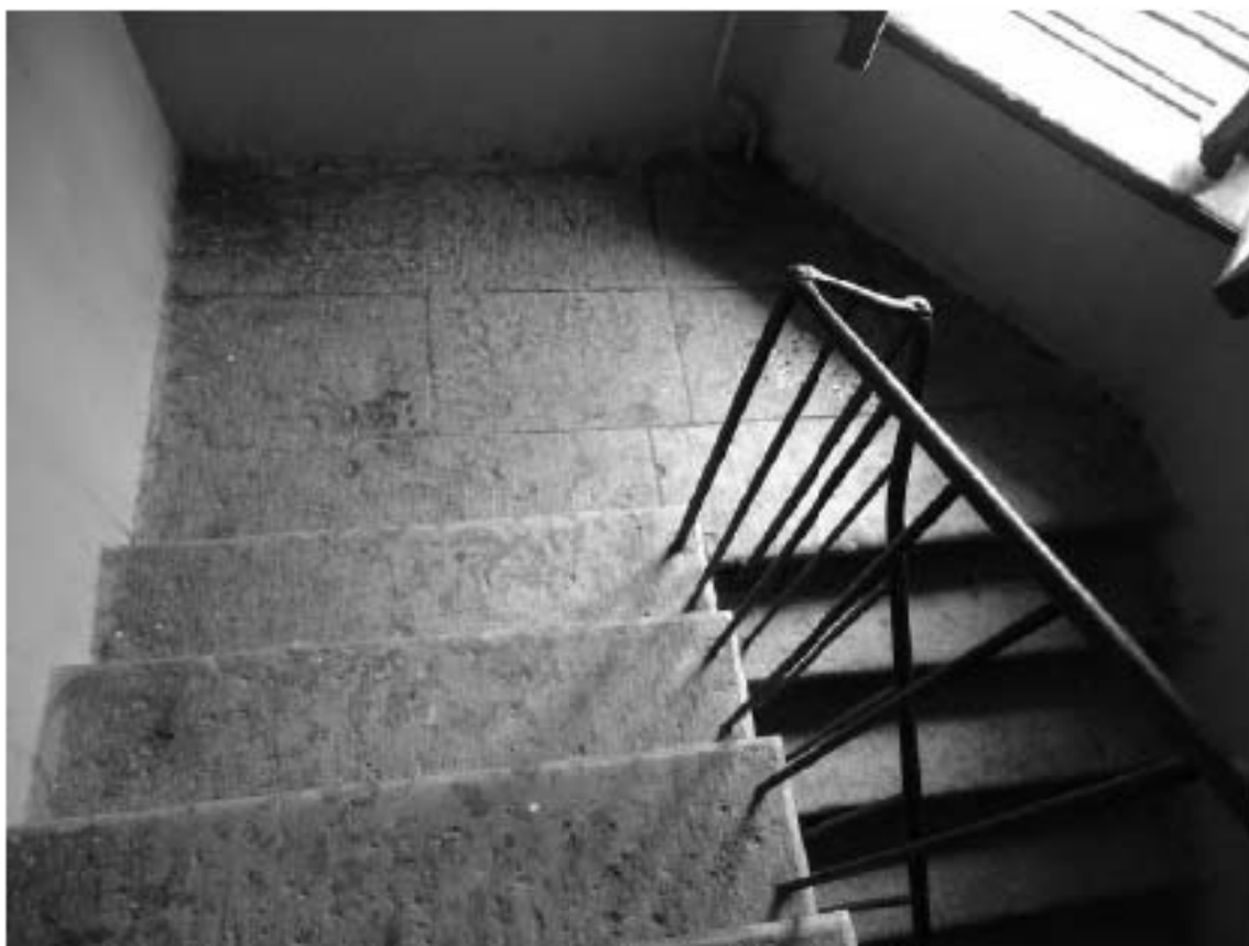
Фото 118. Лестница №4: Площадка м/у 4-м и 5-м этажом. Известняковые плиты. Съемка 19.04.2021 г. Михайловская Г. В.
