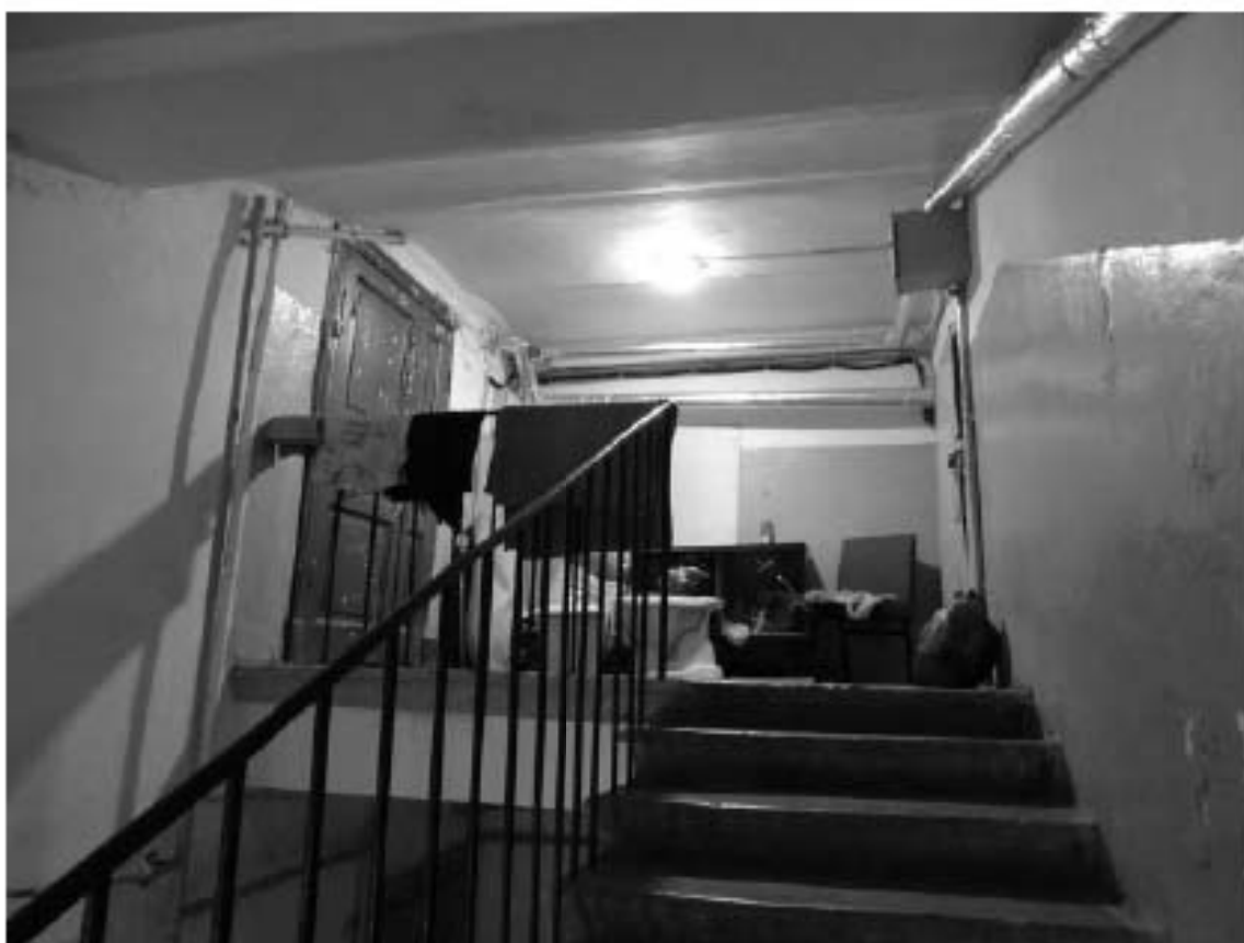
Фото 129. Лестница №4: 6-й этаж. Съемка 19.04.2021 г. Михайловская Г. В.
