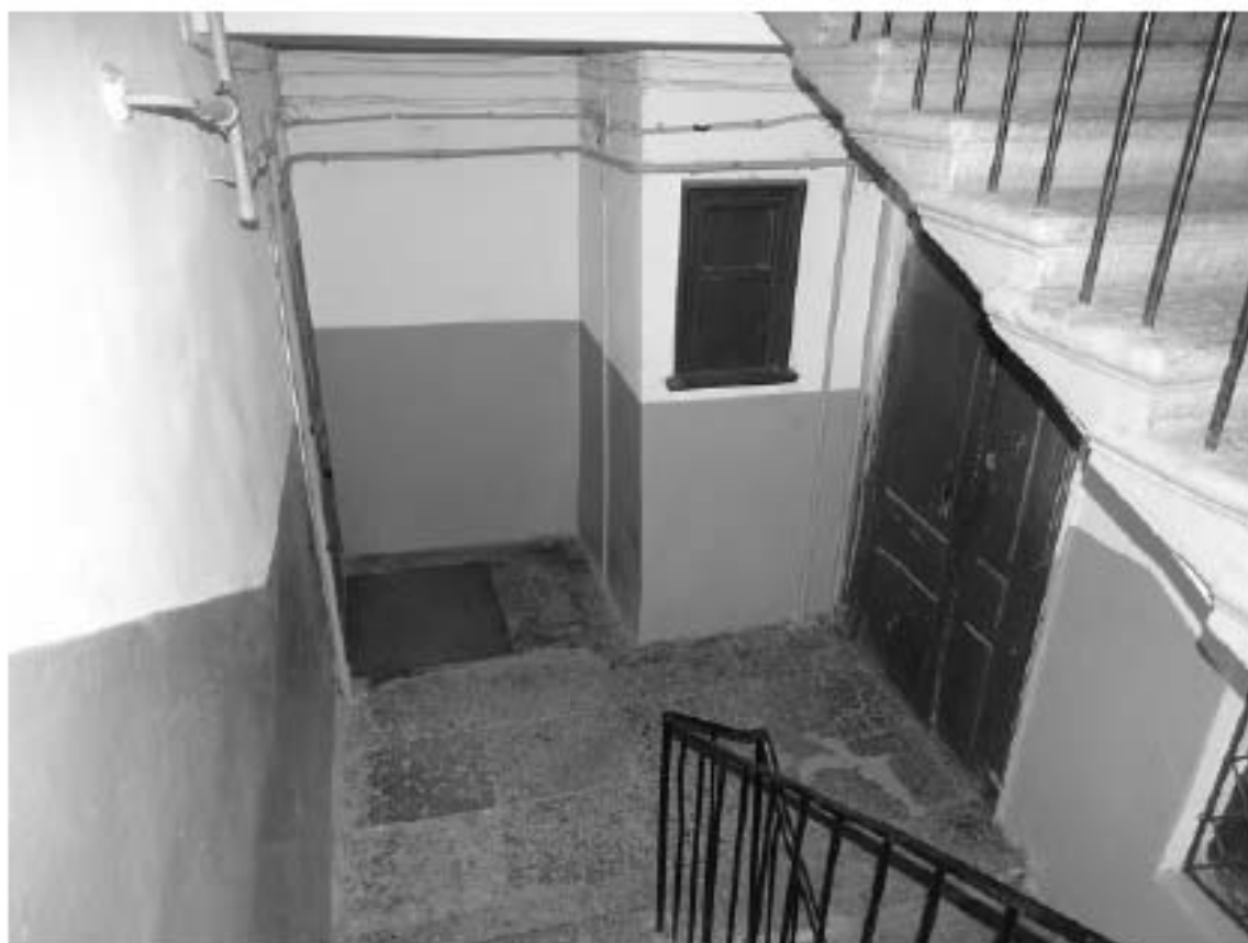
Фото 120. Лестница №4: 5-й этаж. Съемка 19.04.2021 г. Михайловская Г. В.
