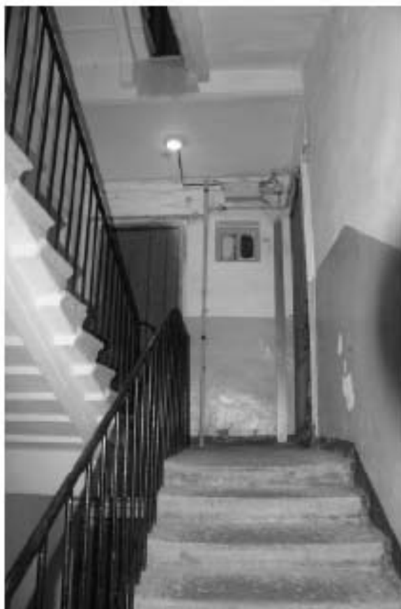
Фото 106. Лестница № 2(3): Вид на площадку 2-го этажа. Съемка 19.04.2021 г. Михайловская Г. В.
