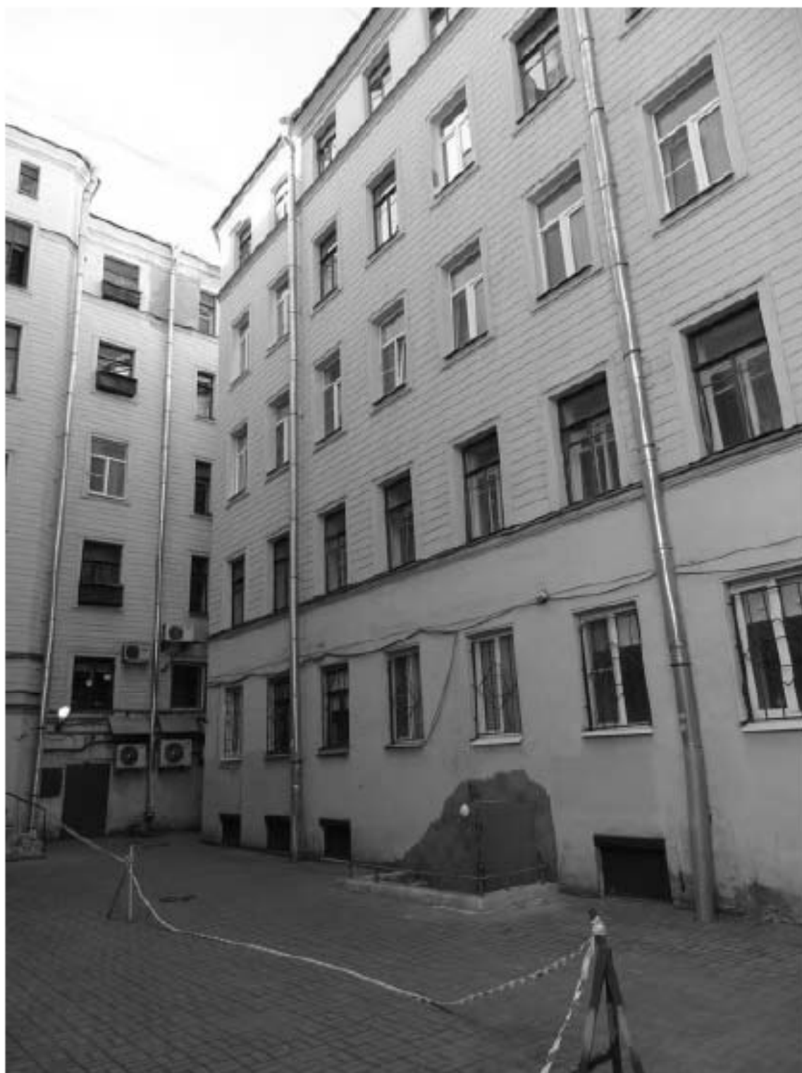
Фото 14. Здание по адресу: г. Санкт-Петербург, Большой проспект П.С., дом 45, литера А. Западный внутренний двор. Съемка 19.04.2021 г. Михайловская Г. В.
