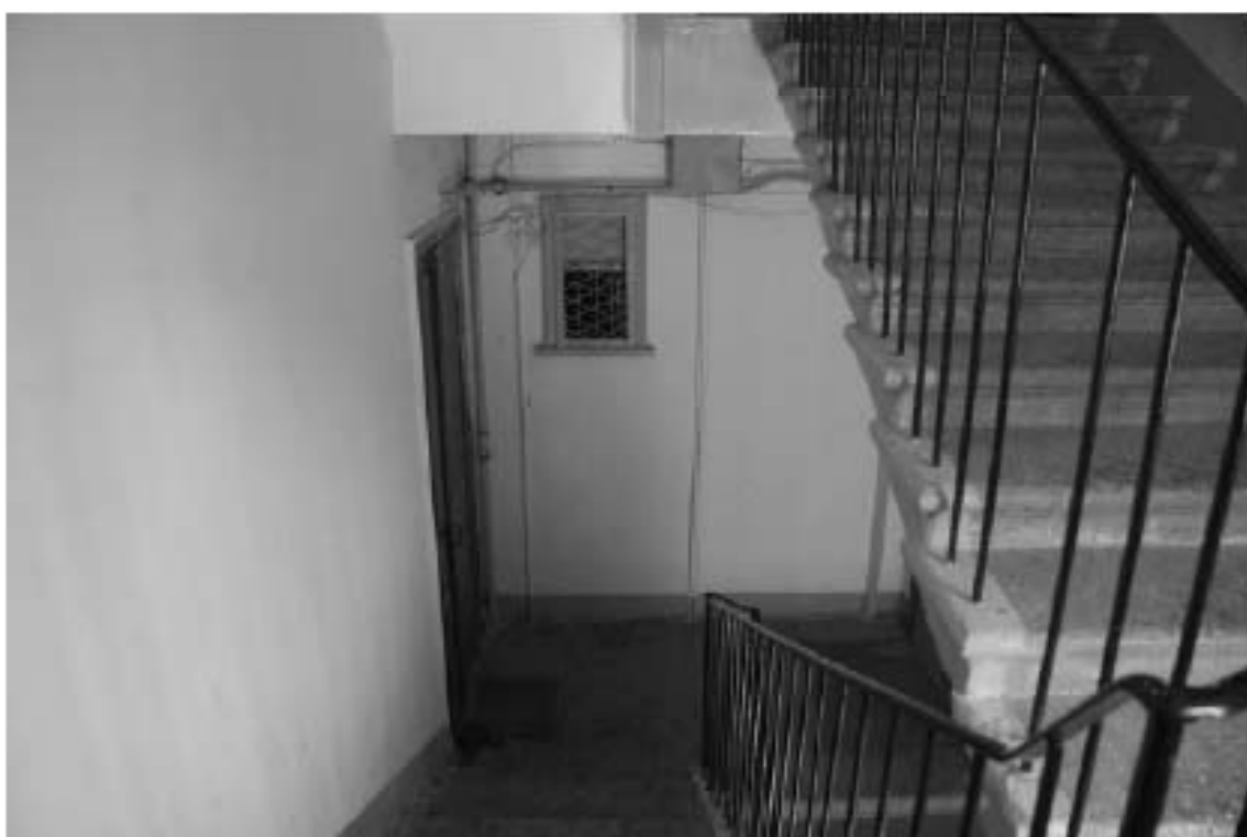
Фото 163. Лестница №3(1): 4-й этаж. Съемка 19.04.2021 г. Михайловская Г. В.
