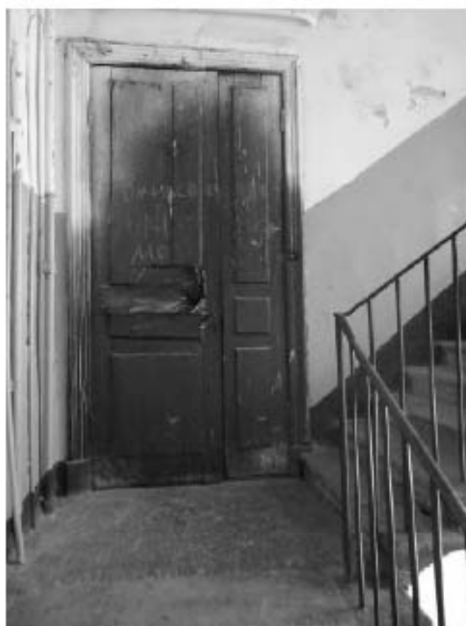
Фото 147. Лестница №4: 6-й этаж. Съемка 19.04.2021 г. Михайловская Г. В.
