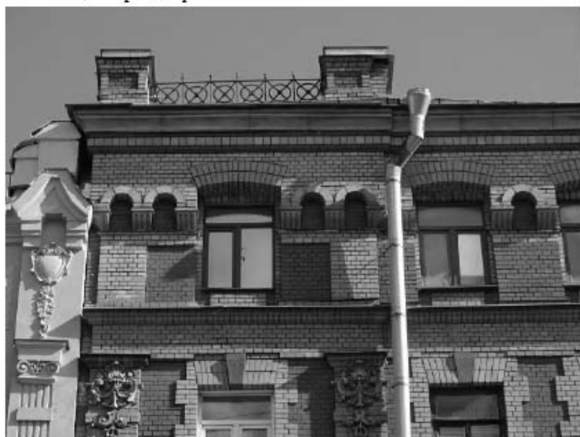
Фото 5. Здание по адресу: г. Санкт-Петербург, Большой проспект П.С., дом 45, литера А. Лицевой фасад. Фрагмент. Съемка 19.04.2021 г. Михайловская Г. В.
