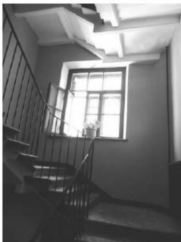
Фото 158. Лестница №6: Площадка м/у 2-м и 3-м этажом. Съемка 19.04.2021 г. Михайловская Г. В.
