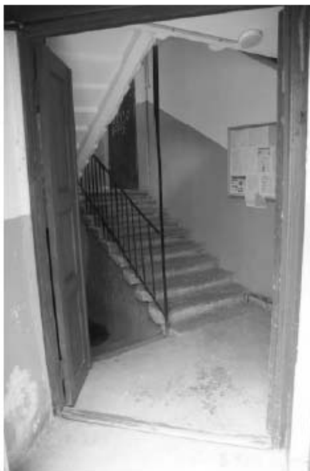
Фото 86. Лестница №4: 1-й этаж. Съемка 19.04.2021 г. Михайловская Г. В.
