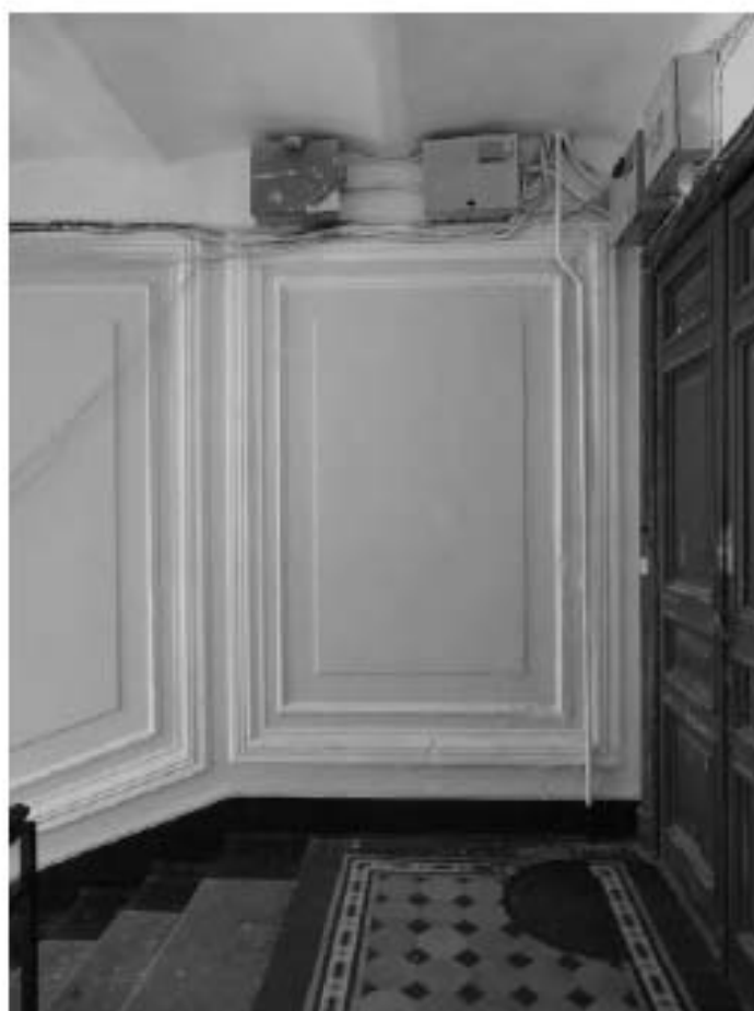
Фото 125. Лестница №1: 5-й этаж. Съемка 19.04.2021 г. Михайловская Г. В.
