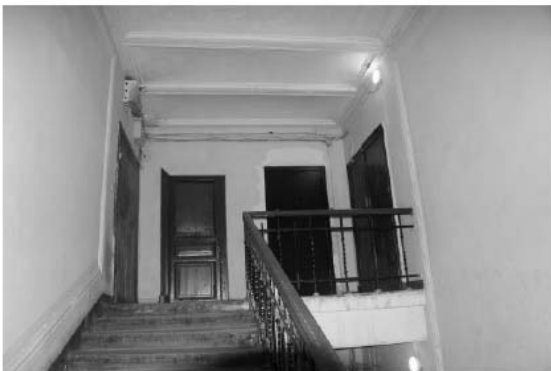
Фото 143. Лестница №2(1): 5-й этаж. Съемка 19.04.2021 г. Михайловская Г. В.
