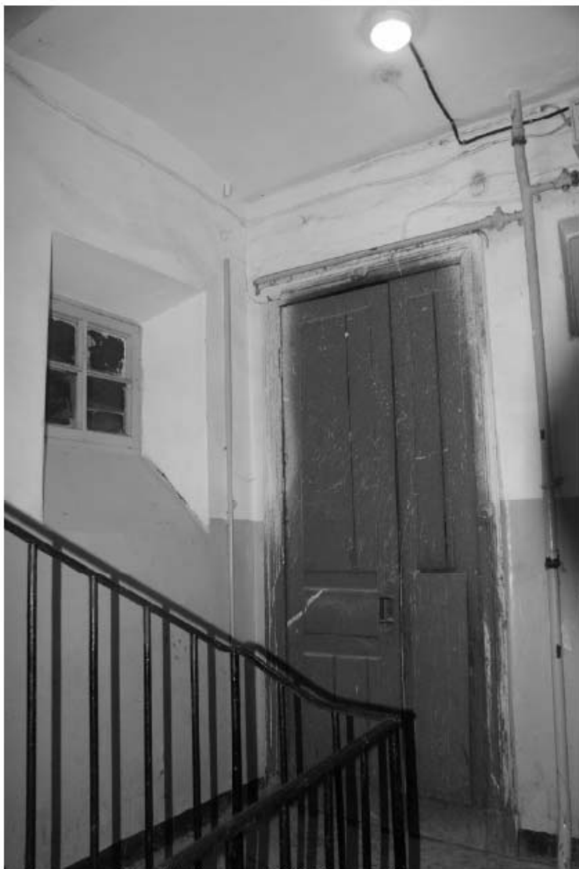
Фото 107. Лестница № 2(3): Площадка 2-го этажа. Съемка 19.04.2021 г. Михайловская Г. В.
