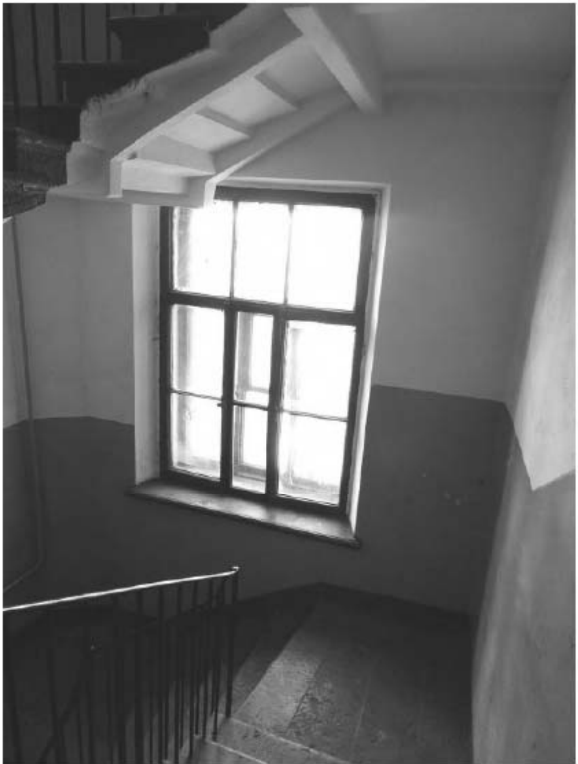
Фото 142. Лестница №4: Площадка м/у 4-м и 5-м этажом. Съемка 19.04.2021 г. Михайловская Г. В.
