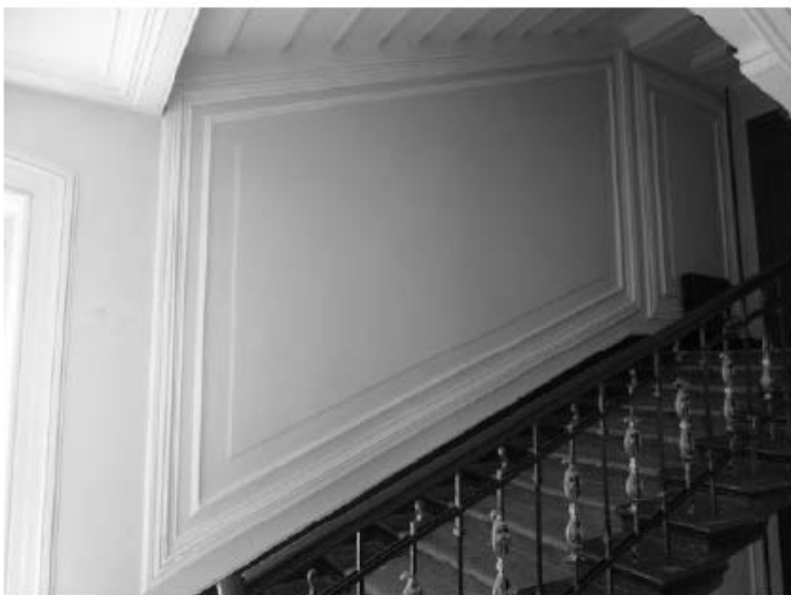
Фото 118. Лестница №1: 4-й этаж. Съемка 19.04.2021 г. Михайловская Г. В.
