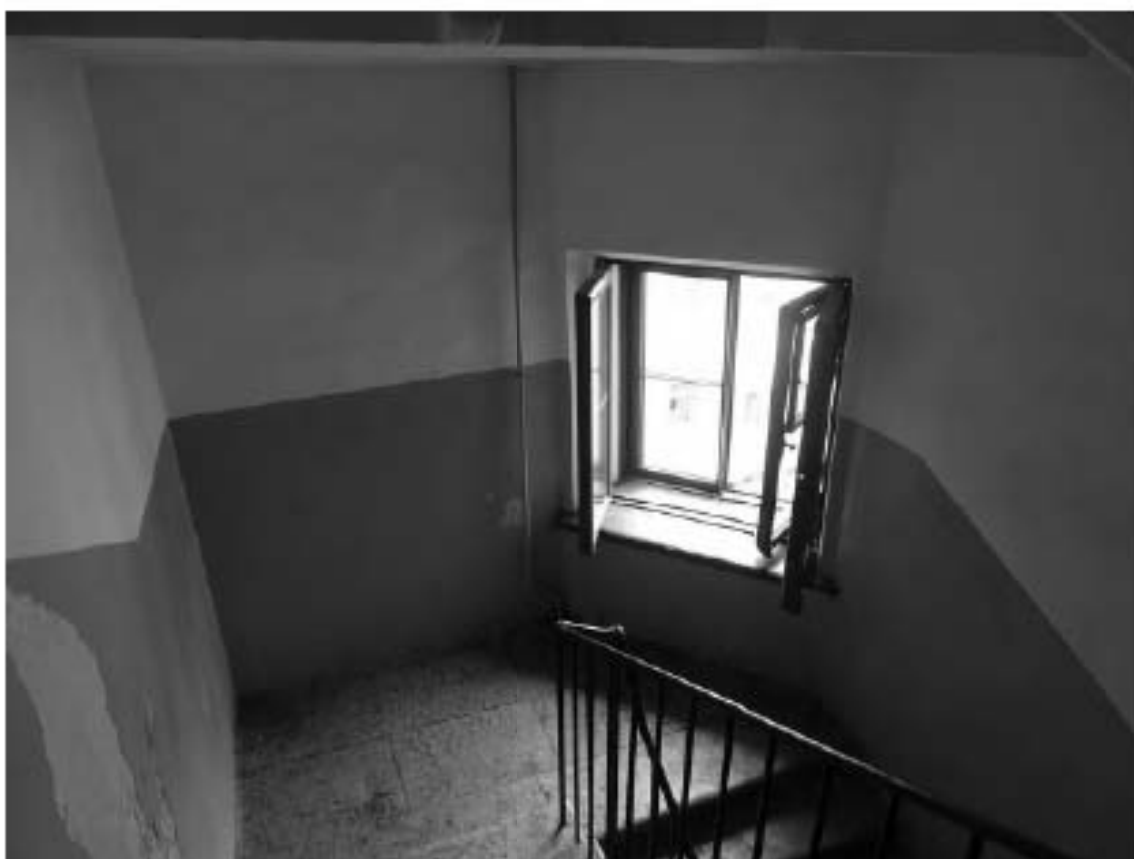
Фото 117. Лестница №4: Площадка м/у 4-м и 5-м этажом. Съемка 19.04.2021 г. Михайловская Г. В.
