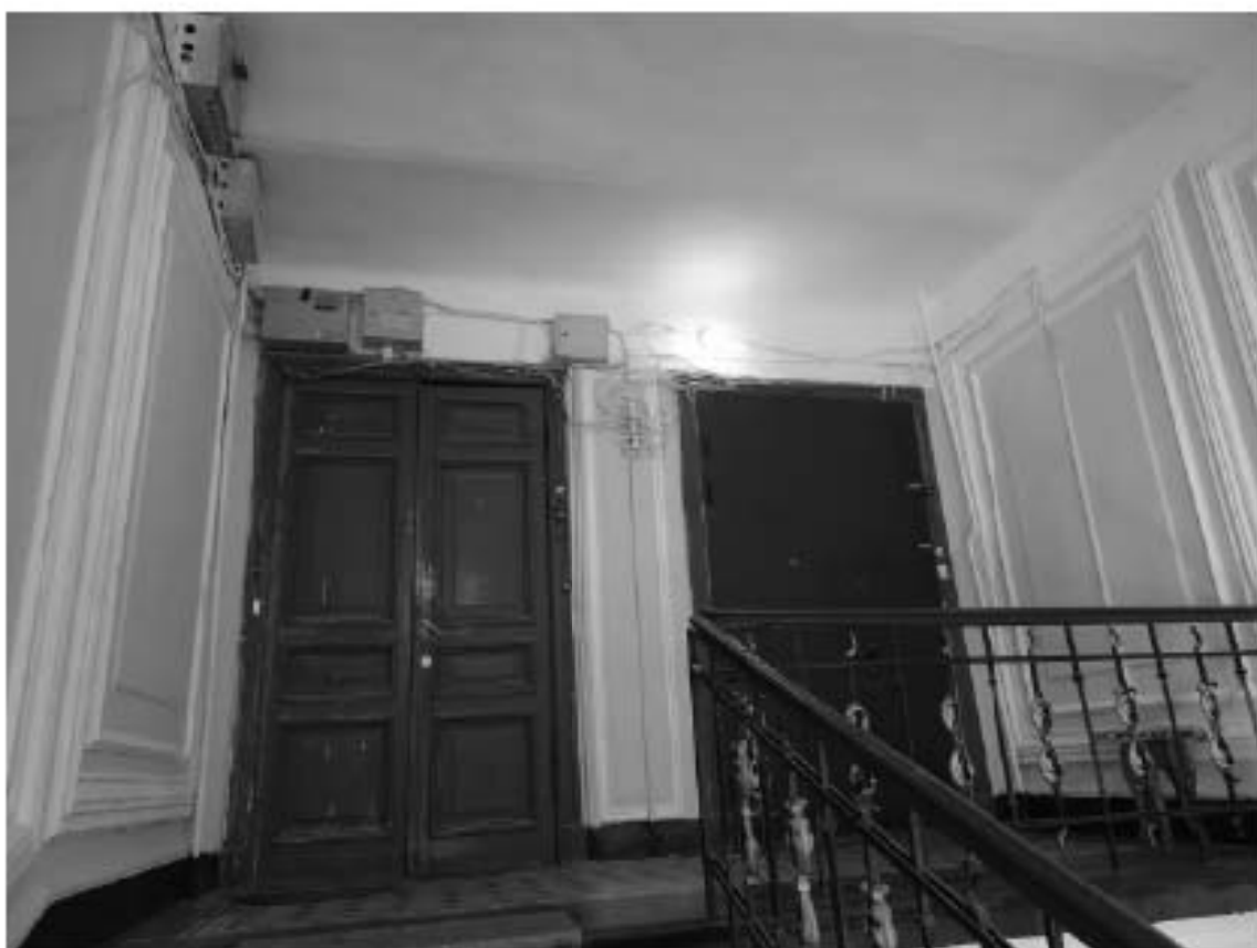
Фото 123. Лестница №1: 5-й этаж. Съемка 19.04.2021 г. Михайловская Г. В.
