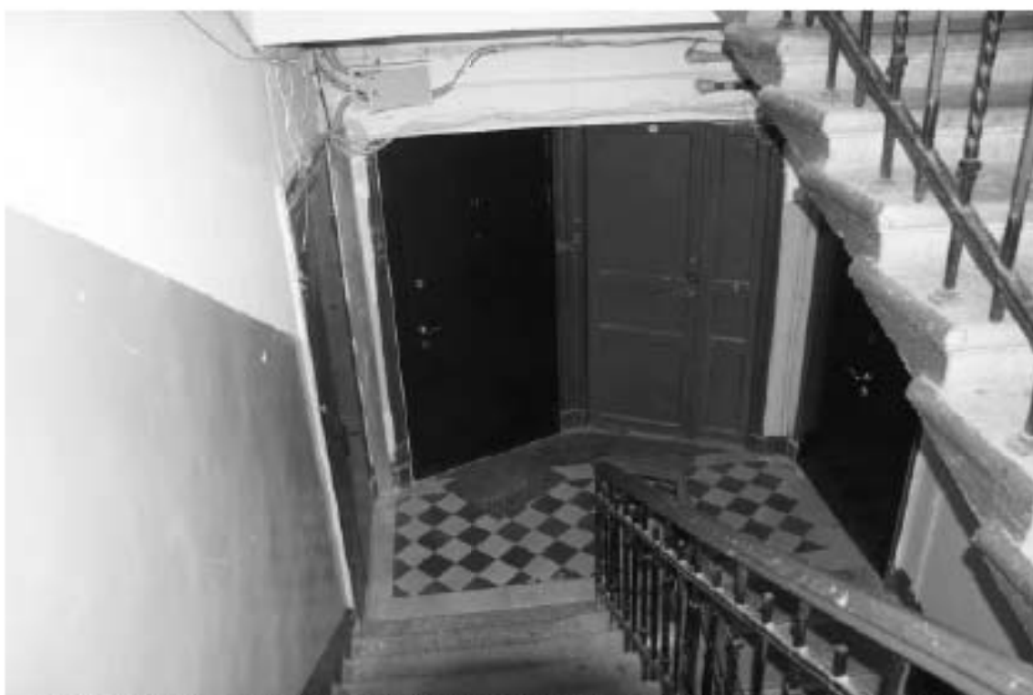
Фото 53. Лестница № 2(2): 2-й этаж. Съемка 19.04.2021 г. Михайловская Г. В.
