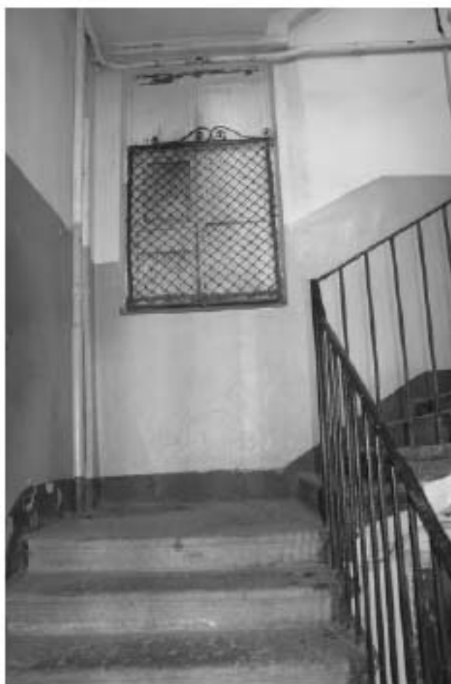
Фото 137. Лестница №4: 3-й этаж. Съемка 19.04.2021 г. Михайловская Г. В.
