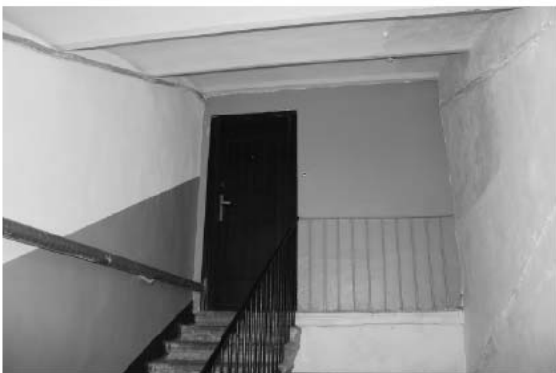
Фото 93. Лестница № 2(3): 5-й этаж. Съемка 19.04.2021 г. Михайловская Г. В.
