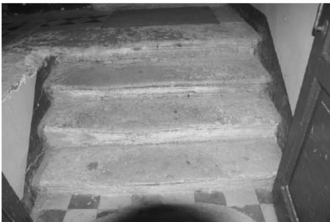
Фото 44. Лестница № 2(2): 1-й этаж. Съемка 19.04.2021 г. Михайловская Г. В.
