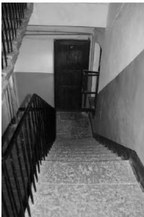
Фото 89. Лестница № 2(3): Вид на площадку между 4-м и 5-м этажом. Съемка 19.04.2021 г. Михайловская Г. В.
