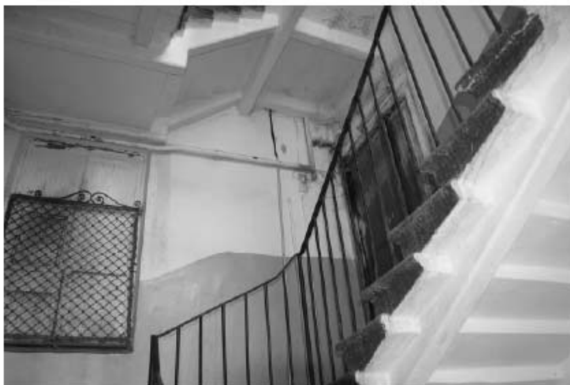
Фото 138. Лестница №4: 3-й этаж. Съемка 19.04.2021 г. Михайловская Г. В.
