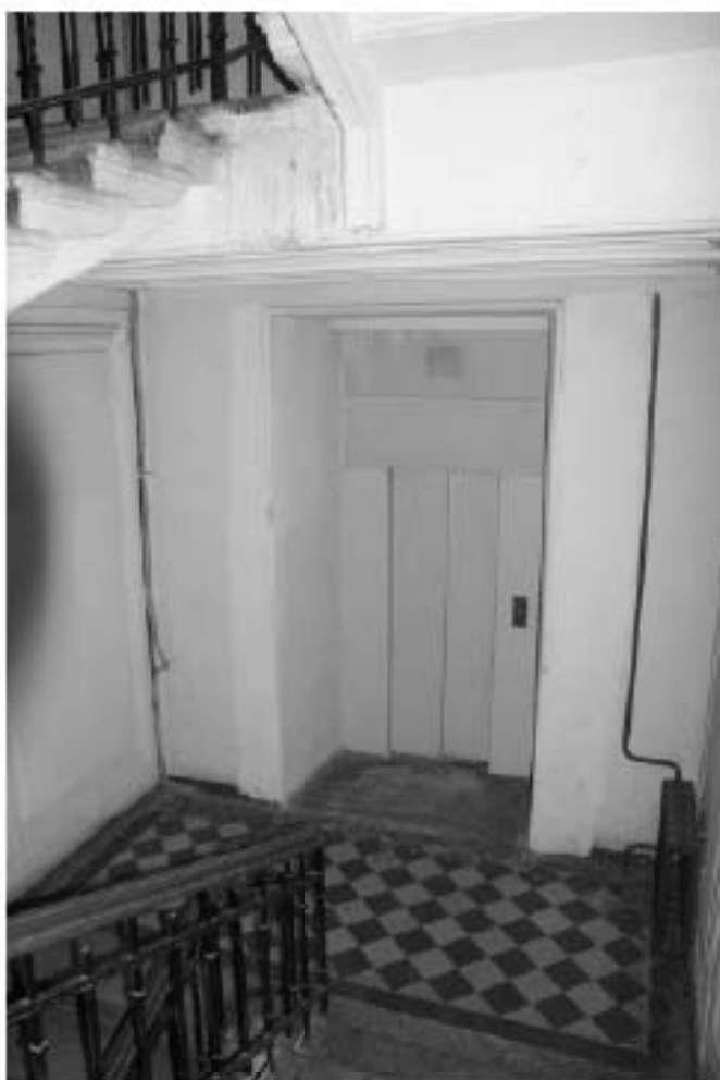
Фото 136. Лестница №2(1): Площадка м/у 2-м и 3-м этажом. Съемка 19.04.2021 г. Михайловская Г. В.
