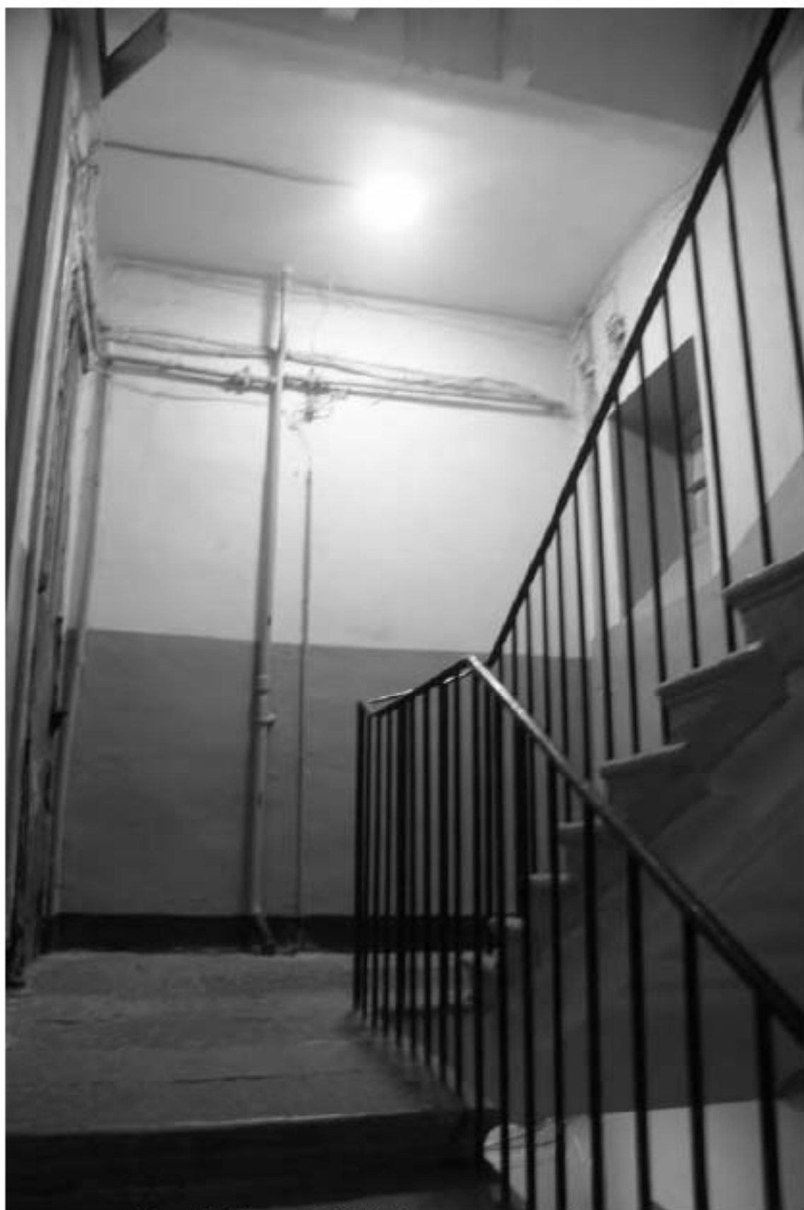
Фото 73. Лестница № 2(3): Вид на площадку 2-го этажа. Съемка 19.04.2021 г. Михайловская Г. В.
