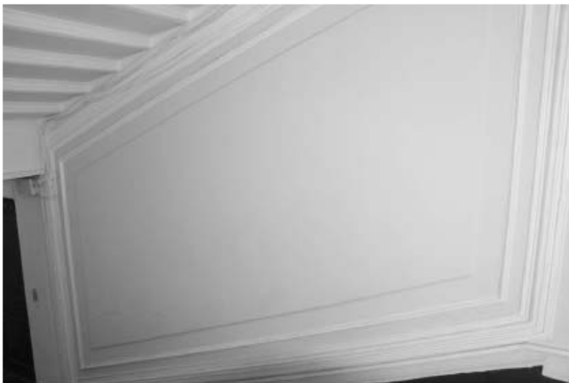
Фото 104. Лестница №1: Оформление стен лестничной клетки. Зеркала в штукатурном профилированном обрамлении. Съемка 19.04.2021 г. Михайловская Г. В.
