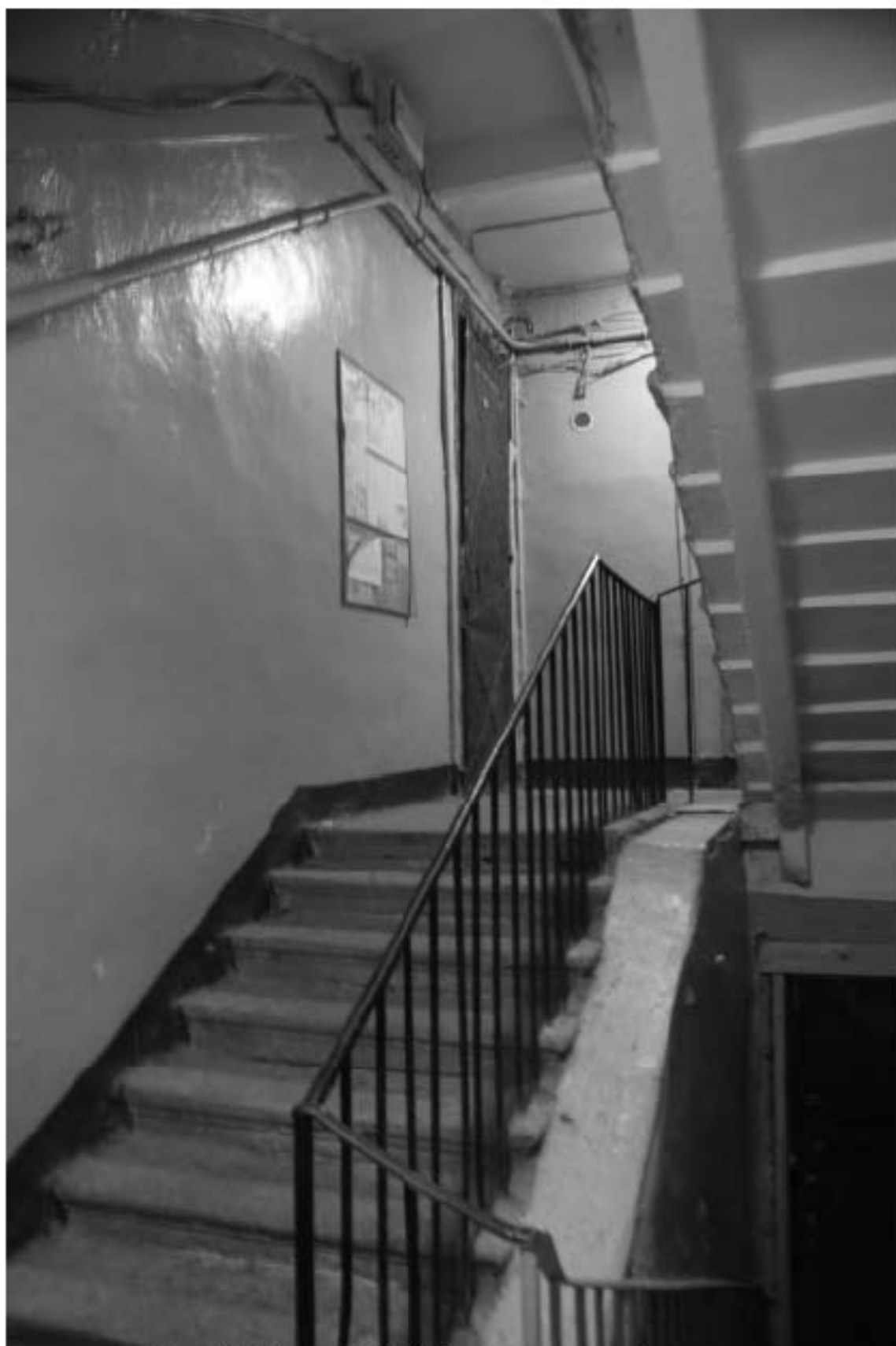
Фото 66. Лестница № 2(3): Вид на площадку 1-го этажа. Съемка 19.04.2021 г. Михайловская Г. В.
