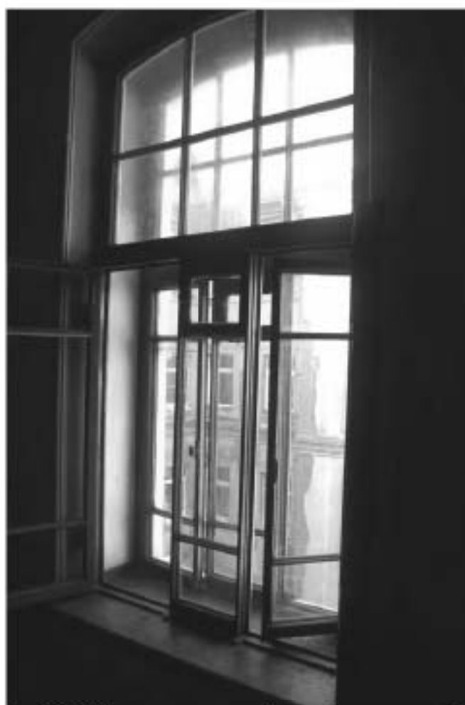
Фото 77. Лестница № 1: Площадка между 3-м и 4-м этажом. Оформление окна. Съемка 19.04.2021 г. Михайловская Г. В.
