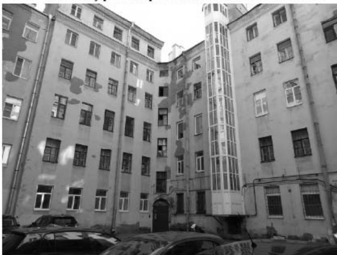
Фото 20. Здание по адресу: г. Санкт-Петербург, Большой проспект П.С., дом 45, литера А. Южный внутренний двор. Съемка 19.04.2021 г. Михайловская Г. В.
