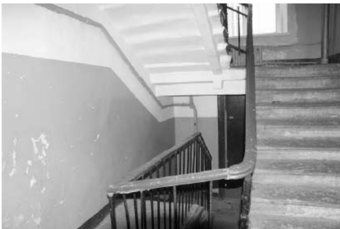
Фото 47. Лестница № 2(2): 1-й этаж. Съемка 19.04.2021 г. Михайловская Г. В.
