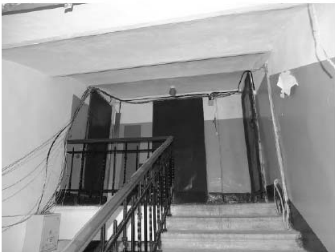
Фото 62. Лестница № 2(2): 5-й этаж. Съемка 19.04.2021 г. Михайловская Г. В.
