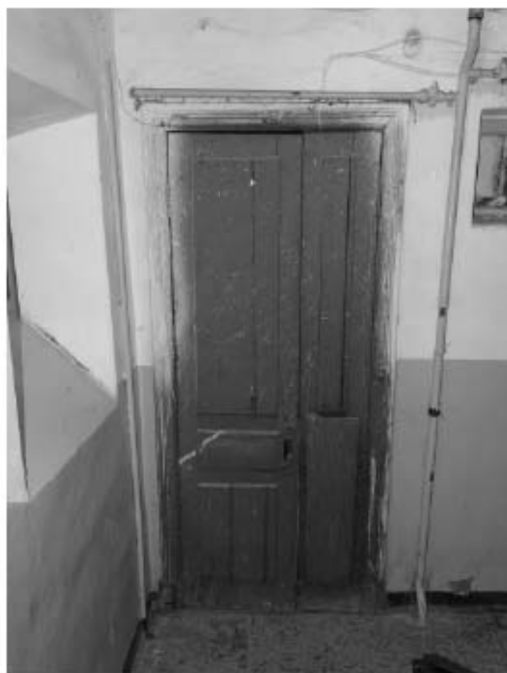
Фото 111. Лестница № 2(3): 3-й этаж. Съемка 19.04.2021 г. Михайловская Г. В.
