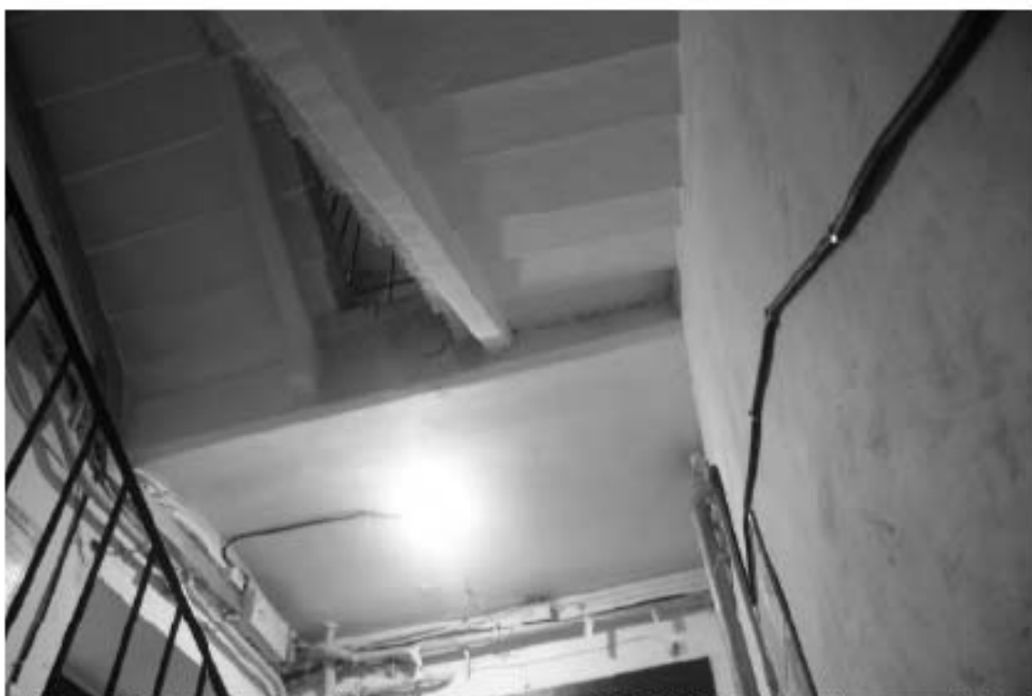
Фото 98. Лестница № 2(3): 1-й этаж. Съёмка 19.04.2021 г. Михайловская Г. В.
