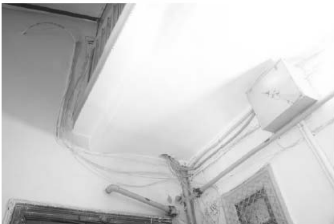
Фото 166. Лестница №3(1): 5-й этаж. Съемка 19.04.2021 г. Михайловская Г. В.
