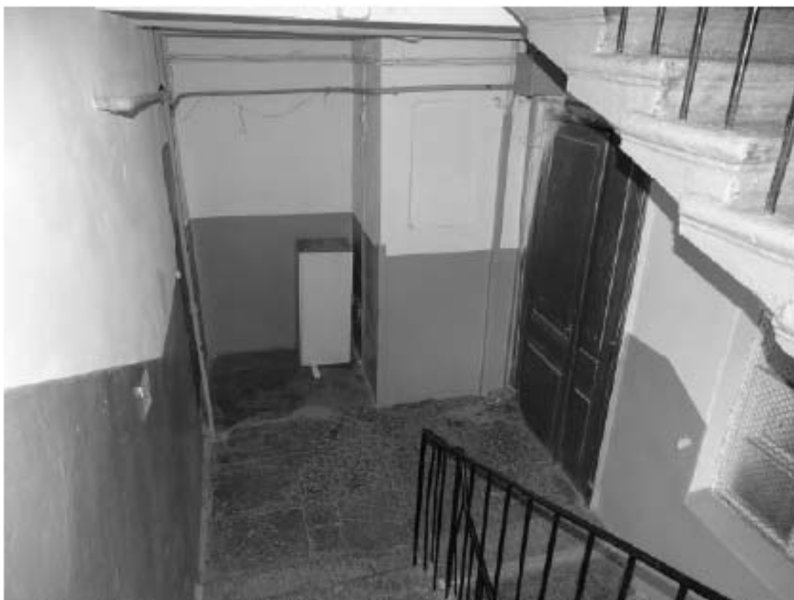
Фото 114. Лестница №4: 4-й этаж. Съемка 19.04.2021 г. Михайловская Г. В.
