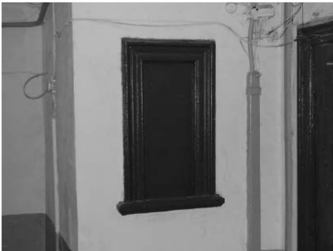
Фото 111. Лестница №4: 3-й этаж. Съемка 19.04.2021 г. Михайловская Г. В.
