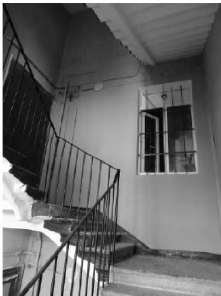
Фото 171. Лестница №б: 6-й этаж. Съемка 19.04.2021 г. Михайловская Г. В.
