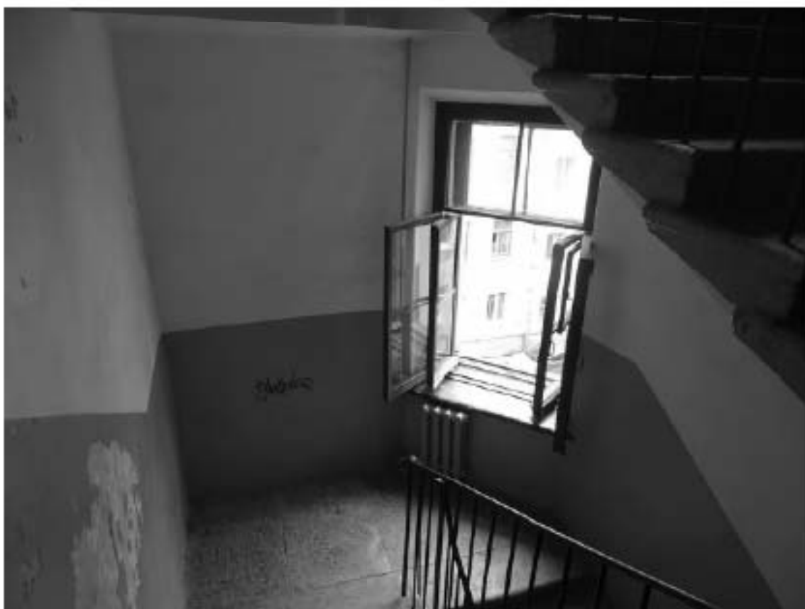
Фото 112. Лестница №4: Площадка м/у 3-м и 4-м этажом. Съемка 19.04.2021 г. Михайловская Г. В.
