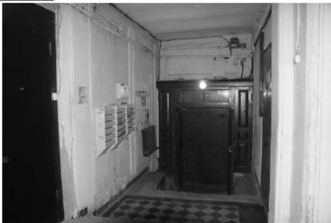
Фото 126. Лестница №2(1): 1-й этаж. Съемка 19.04.2021 г. Михайловская Г. В.
