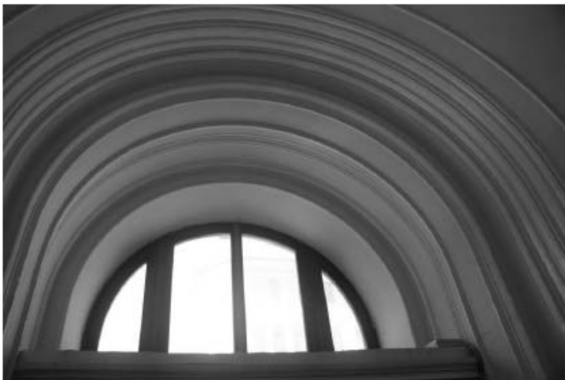
Фото 88. Лестница №1: 1-й этаж. Парадная. Профилированная полуциркульная ниша. Съемка 19.04.2021 г. Михайловская Г. В.
