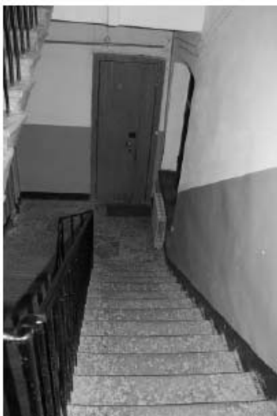
Фото 76. Лестница № 2(3): Вид на площадку между 2-м и 3-м этажом. Съемка 19.04.2021 г. Михайловская Г. В.
