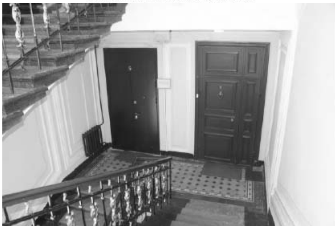
Фото 108. Лестница №1: 2-й этаж. Съемка 19.04.2021 г. Михайловская Г. В.
