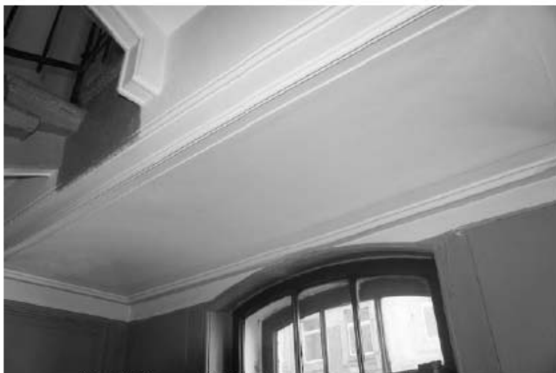
Фото 73. Лестница № 1: Площадка между 2-м и 3-м этажом. Съемка 19.04.2021 г. Михайловская Г. В.
