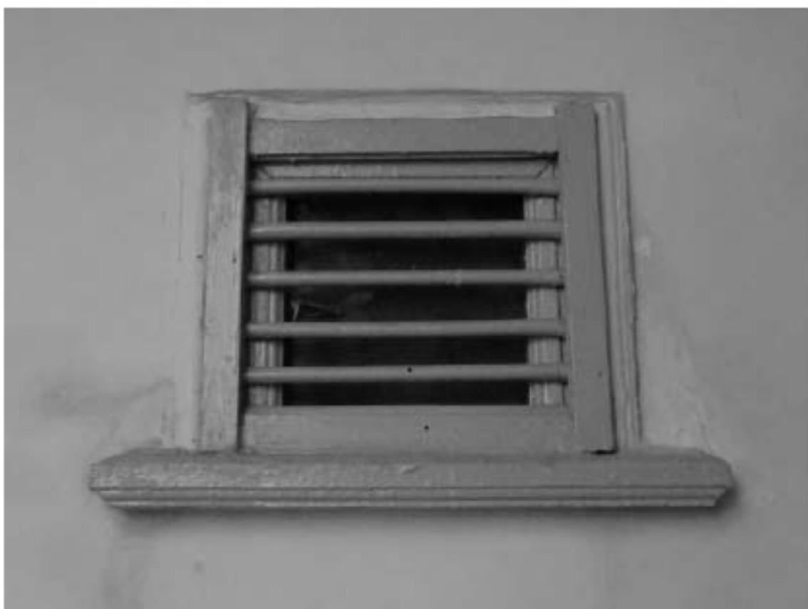
Фото 151. Лестница №3(1): 1-й этаж. Съемка 19.04.2021 г. Михайловская Г. В.
