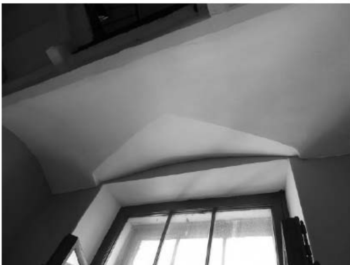
Фото 170. Лестница №б: Площадка м/у 5-м и 6-м этажом. Съемка 19.04.2021 г. Михайловская Г. В.
