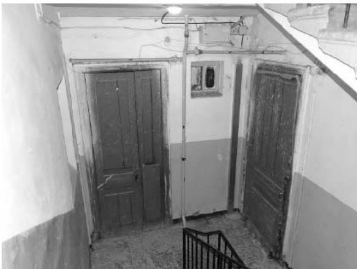
Фото 110. Лестница № 2(3): Площадка 3-го этажа. Съемка 19.04.2021 г. Михайловская Г. В.
