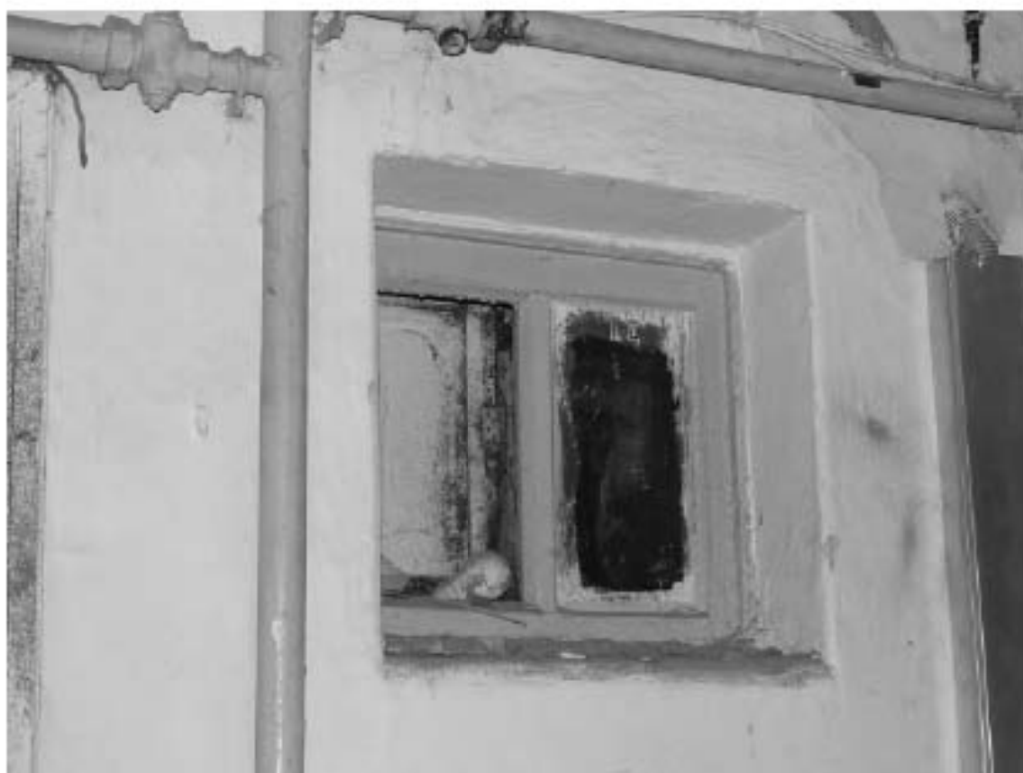
Фото 113. Лестница № 2(3): 3-й этаж. Съемка 19.04.2021 г. Михайловская Г. В.
