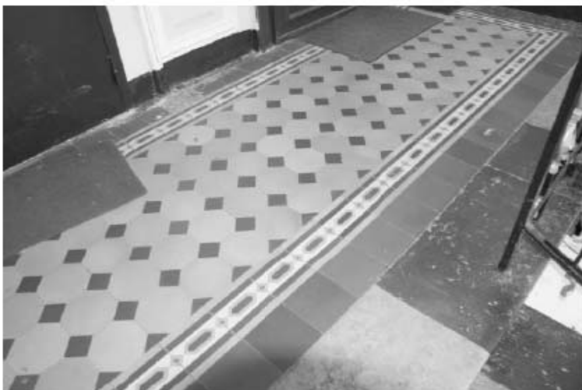
Фото 106. Лестница №1: 2-й этаж. Покрытие пола. Съемка 19.04.2021 г. Михайловская Г. В.
