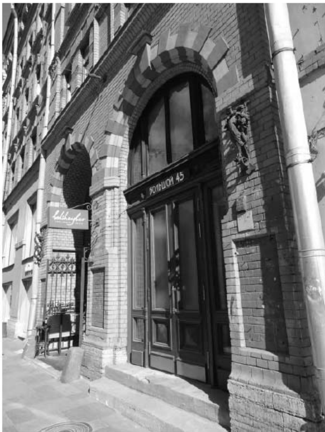
Фото 6. Здание по адресу: г. Санкт-Петербург, Большой проспект П.С., дом 45, литера А. Лицевой фасад. Фрагмент. Съемка 19.04.2021 г. Михайловская Г. В.
