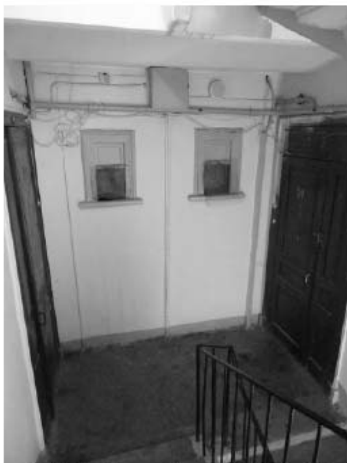
Фото 156. Лестница №3(1): 2-й этаж. Съемка 19.04.2021 г. Михайловская Г. В.
