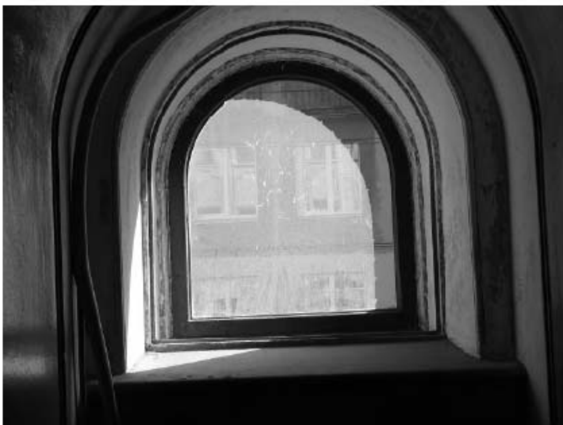
Фото 50. Лестница № 1: Вестибюль 1-го этажа. Съемка 19.04.2021 г. Михайловская Г. В.
