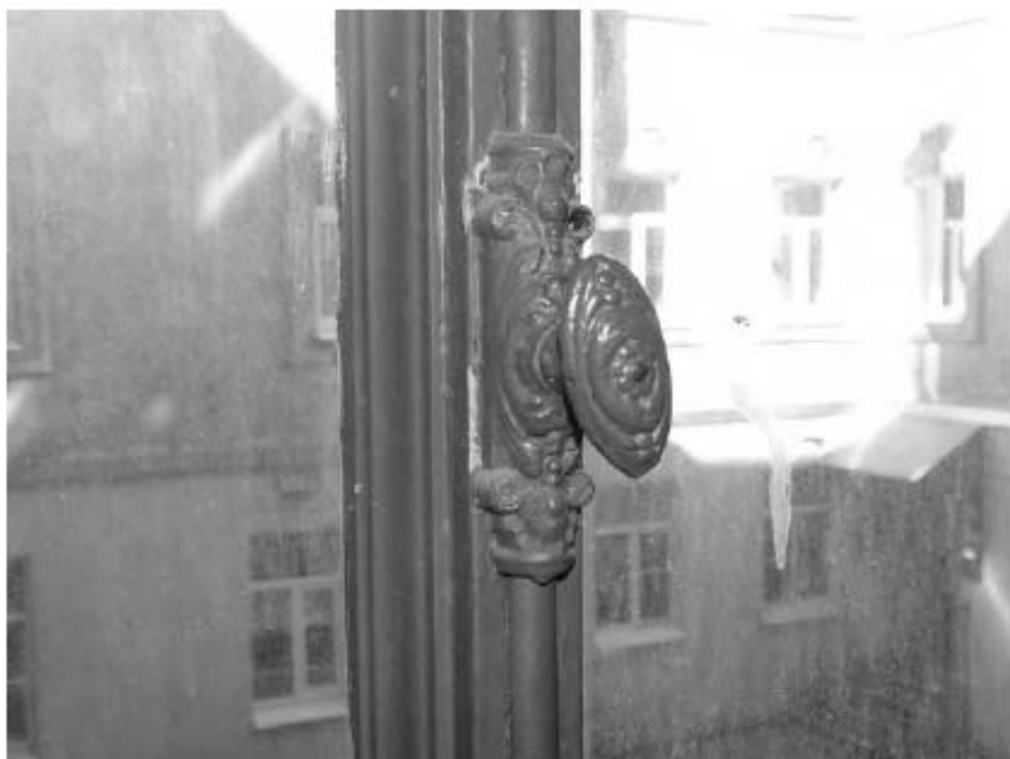
Фото 62. Лестница № 1: Площадка между 1-м и 2-м этажом. Съемка 19.04.2021 г. Михайловская Г. В.
