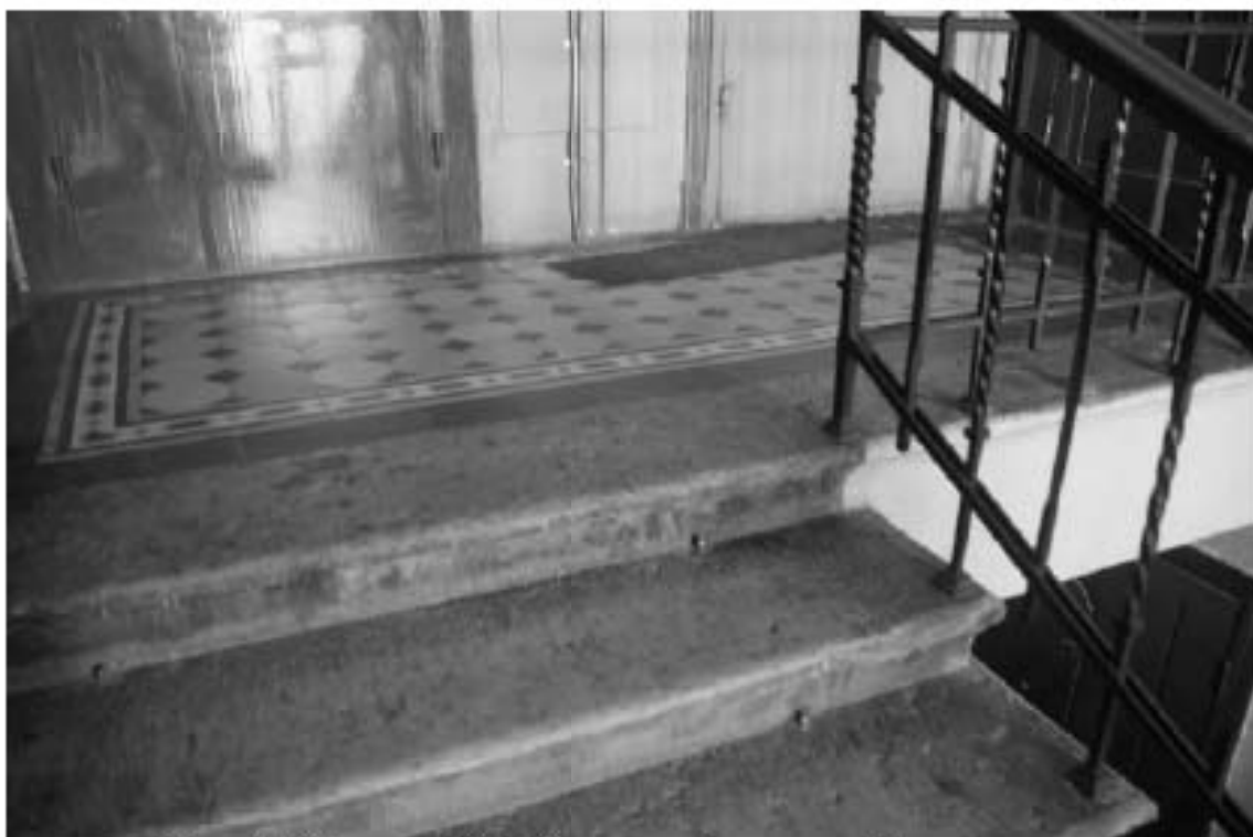
Фото 80. Лестница № 1: Площадка 4-го этажа. Покрытие пола. Съемка 19.04.2021 г. Михайловская Г. В.
