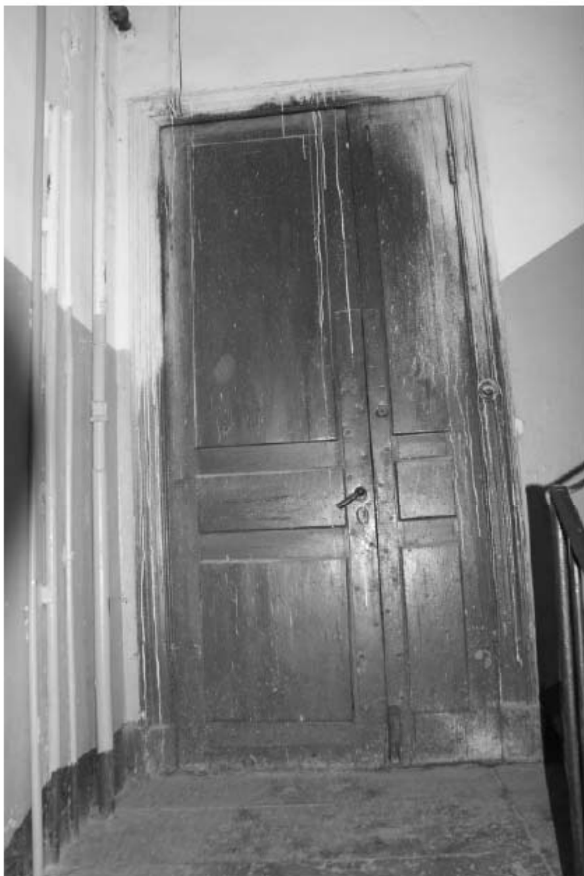
Фото 141. Лестница №4: 4-й этаж. Съемка 19.04.2021 г. Михайловская Г. В.
