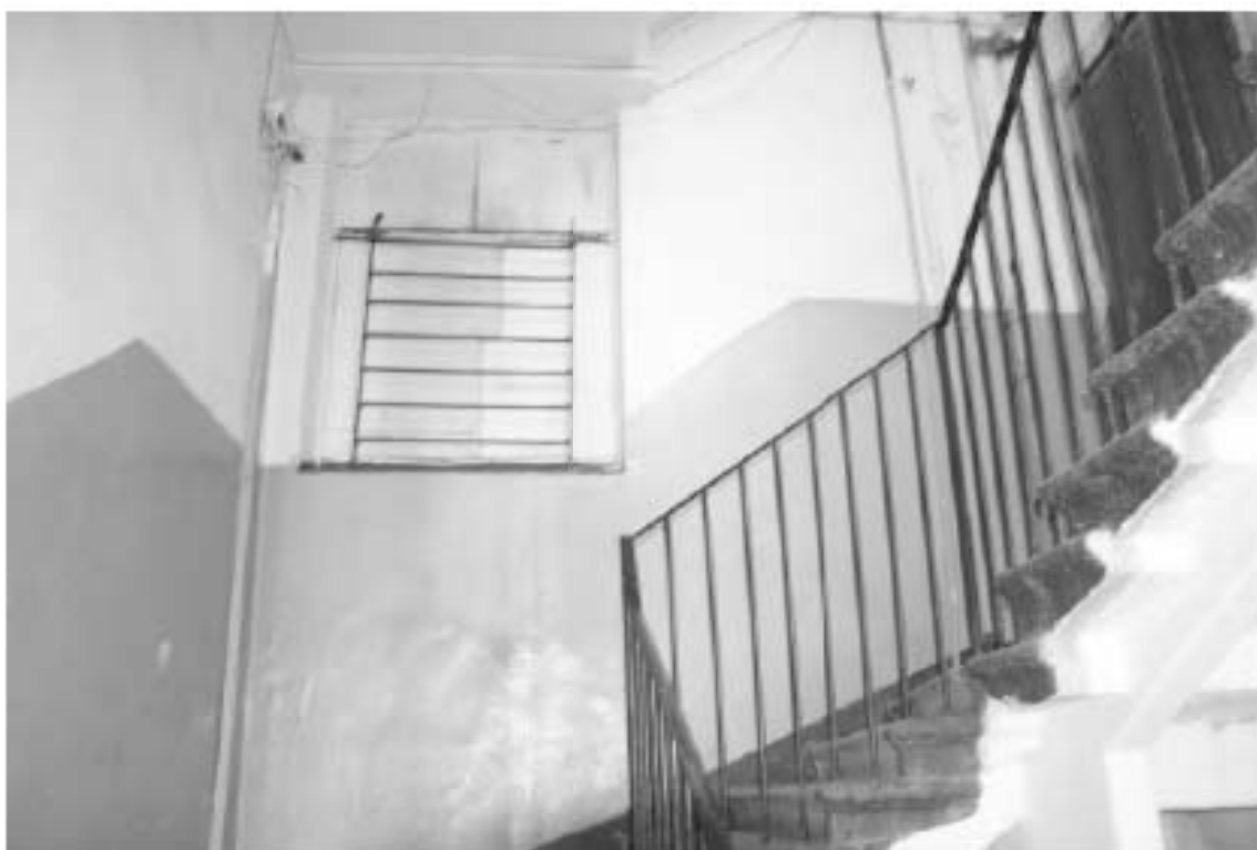
Фото 140. Лестница №4: 4-й этаж. Съемка 19.04.2021 г. Михайловская Г. В.
