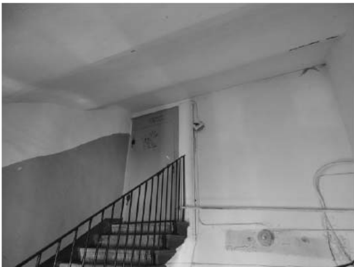
Фото 151. Лестница №4: Чердачный этаж. Съемка 19.04.2021 г. Михайловская Г. В.
