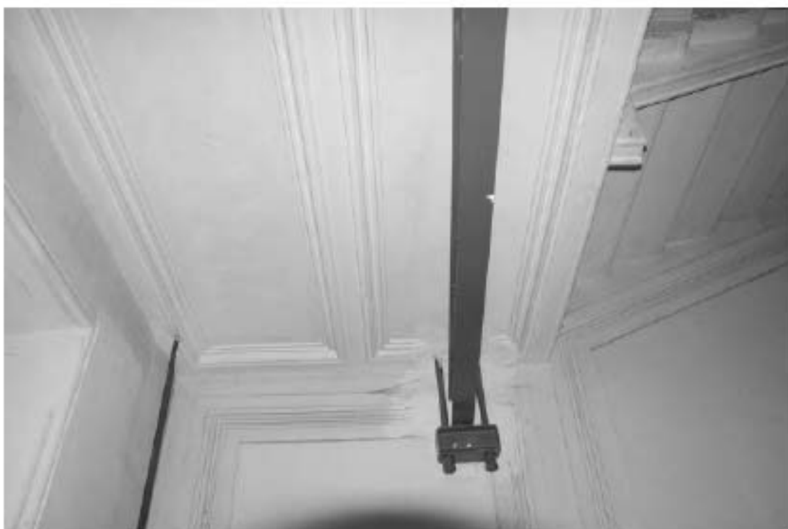
Фото 140. Лестница №2(1): Площадка м/у 3-м и 4-м этажом. Съемка 19.04.2021 г. Михайловская Г. В.
