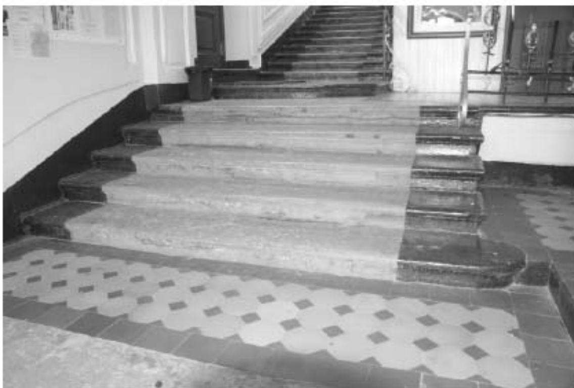
Фото 90. Лестница №1: 1-й этаж. Парадная. Съемка 19.04.2021 г. Михайловская Г. В.
