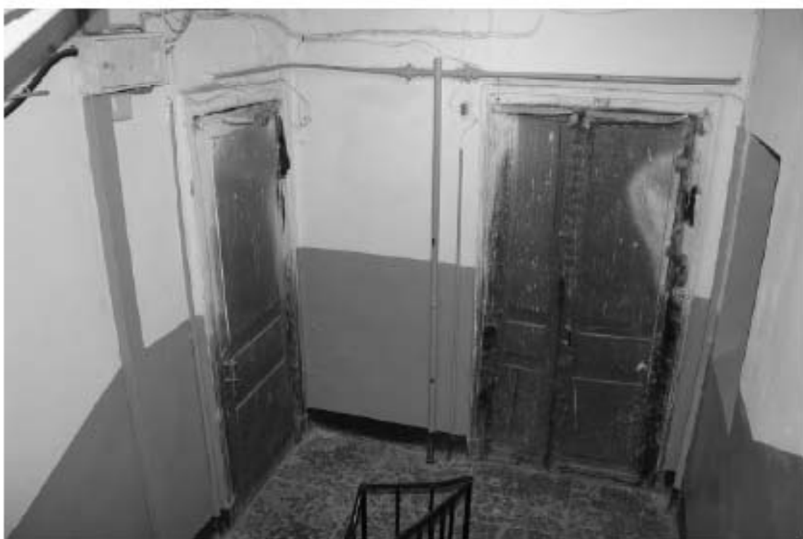
Фото 87. Лестница № 2(3): Площадка 4-го этажа. Съемка 19.04.2021 г. Михайловская Г. В.
