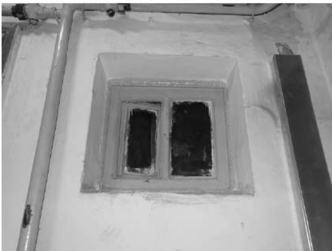
Фото 118. Лестница № 2(3): 4-й этаж. Съемка 19.04.2021 г. Михайловская Г. В.
