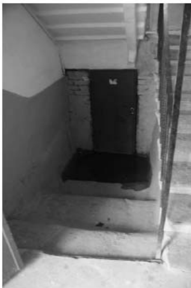
Фото 89. Лестница №4: 1-й этаж. Вход в подвал. Съемка 19.04.2021 г. Михайловская Г. В.
