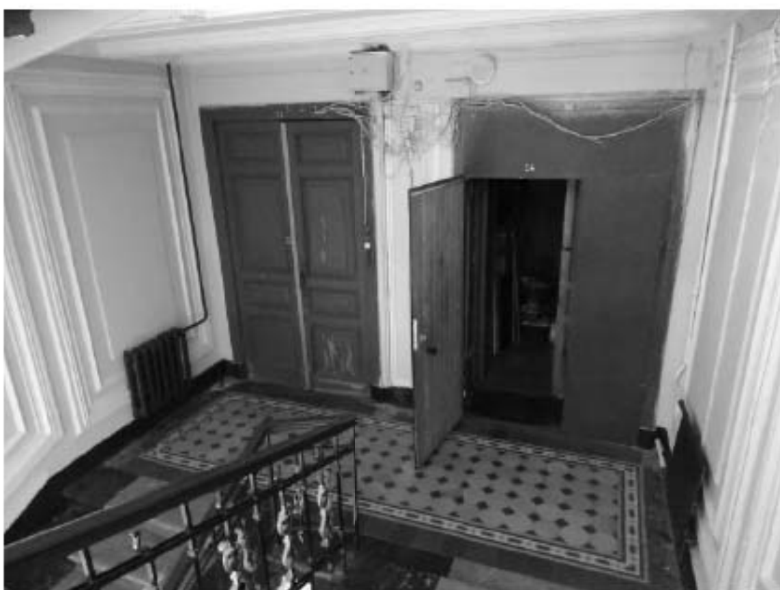
Фото 115. Лестница №1: 4-й этаж. Съемка 19.04.2021 г. Михайловская Г. В.
