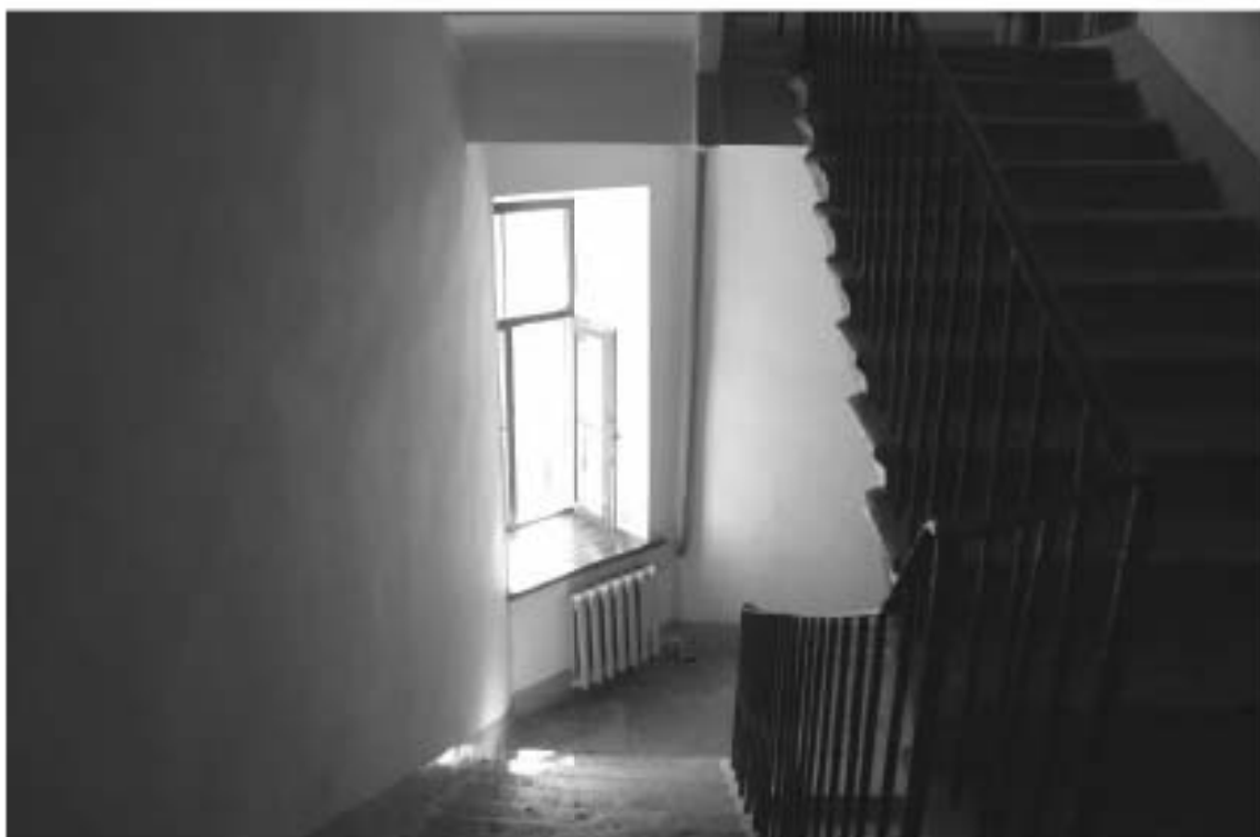
Фото 162. Лестница №3(1): Площадка м/у 3-м и 4-м этажом. Съемка 19.04.2021 г. Михайловская Г. В.
