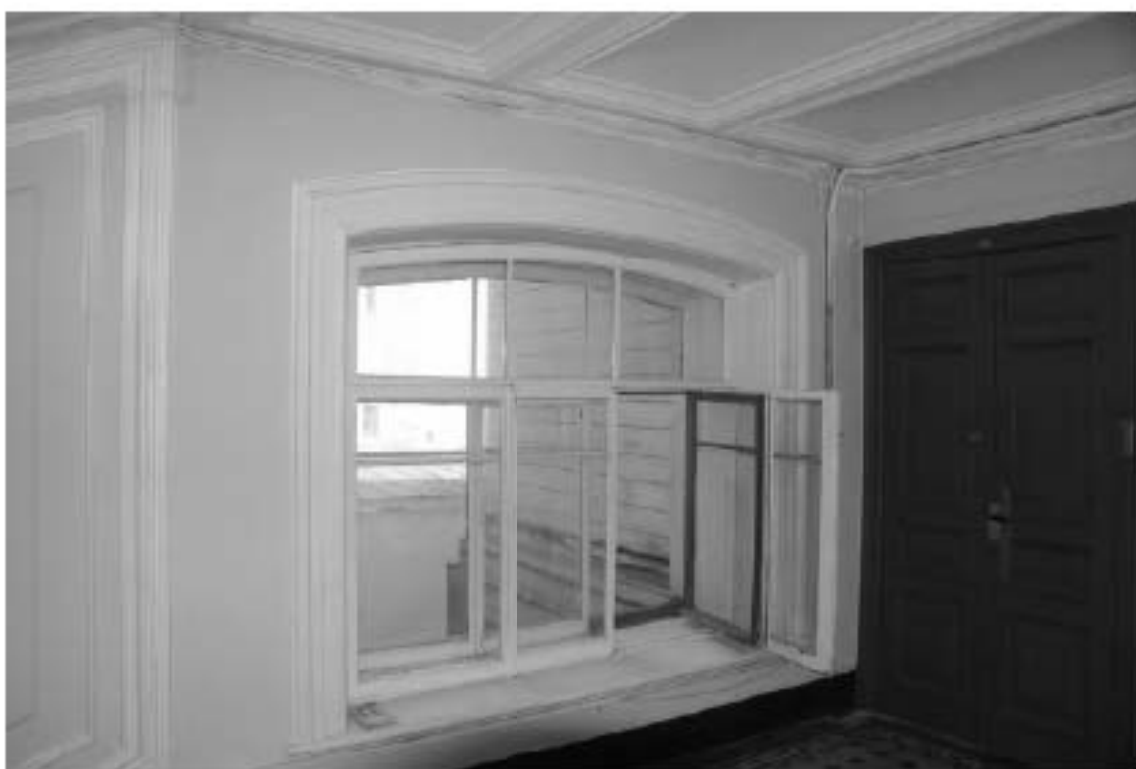
Фото 101. Лестница №1: 1-й этаж. Съемка 19.04.2021 г. Михайловская Г. В.
