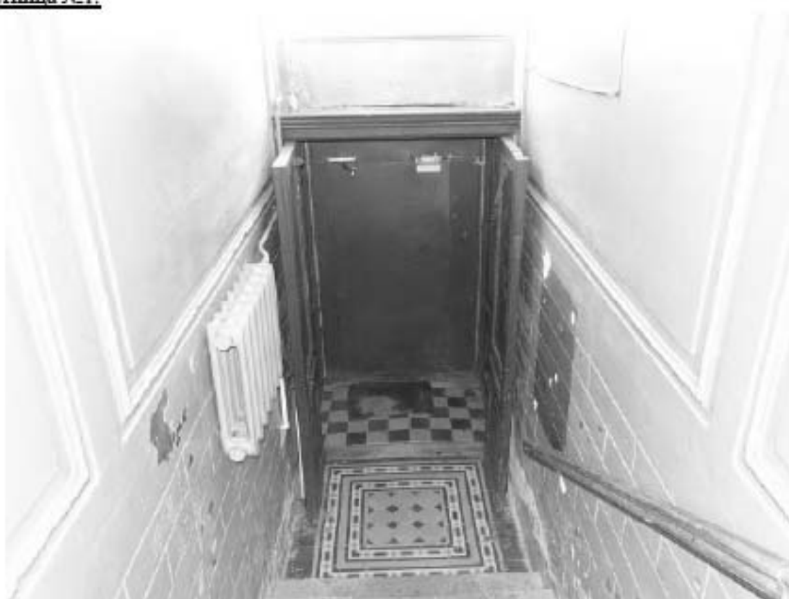
Фото 42. Лестница № 1: Вестибюль 1-й этаж. Входная дверь. Съемка 19.04.2021 г. Михайловская Г. В.
