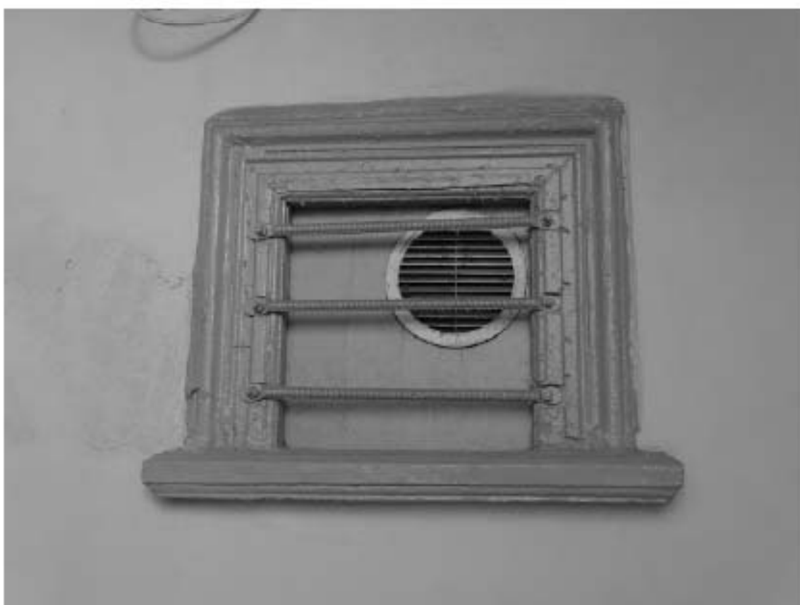
Фото 152. Лестница №3(1): 1-й этаж. Съемка 19.04.2021 г. Михайловская Г. В.
