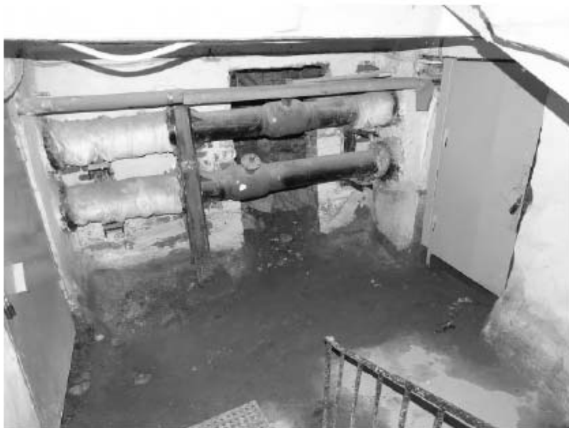
Фото 146. Лестница №3(1): Подвальный этаж. Съемка 19.04.2021 г. Михайловская Г. В.
