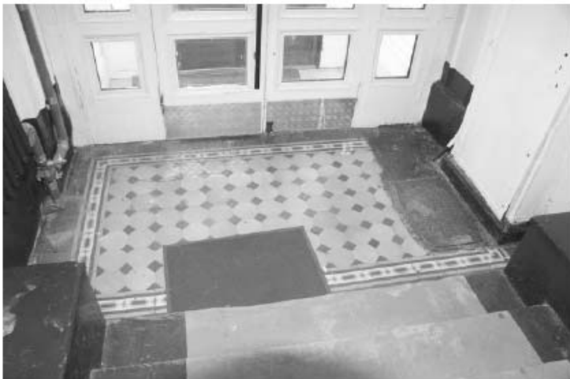
Фото 89. Лестница №1: 1-й этаж. Парадная. Покрытие пола. Съемка 19.04.2021 г. Михайловская Г. В.
