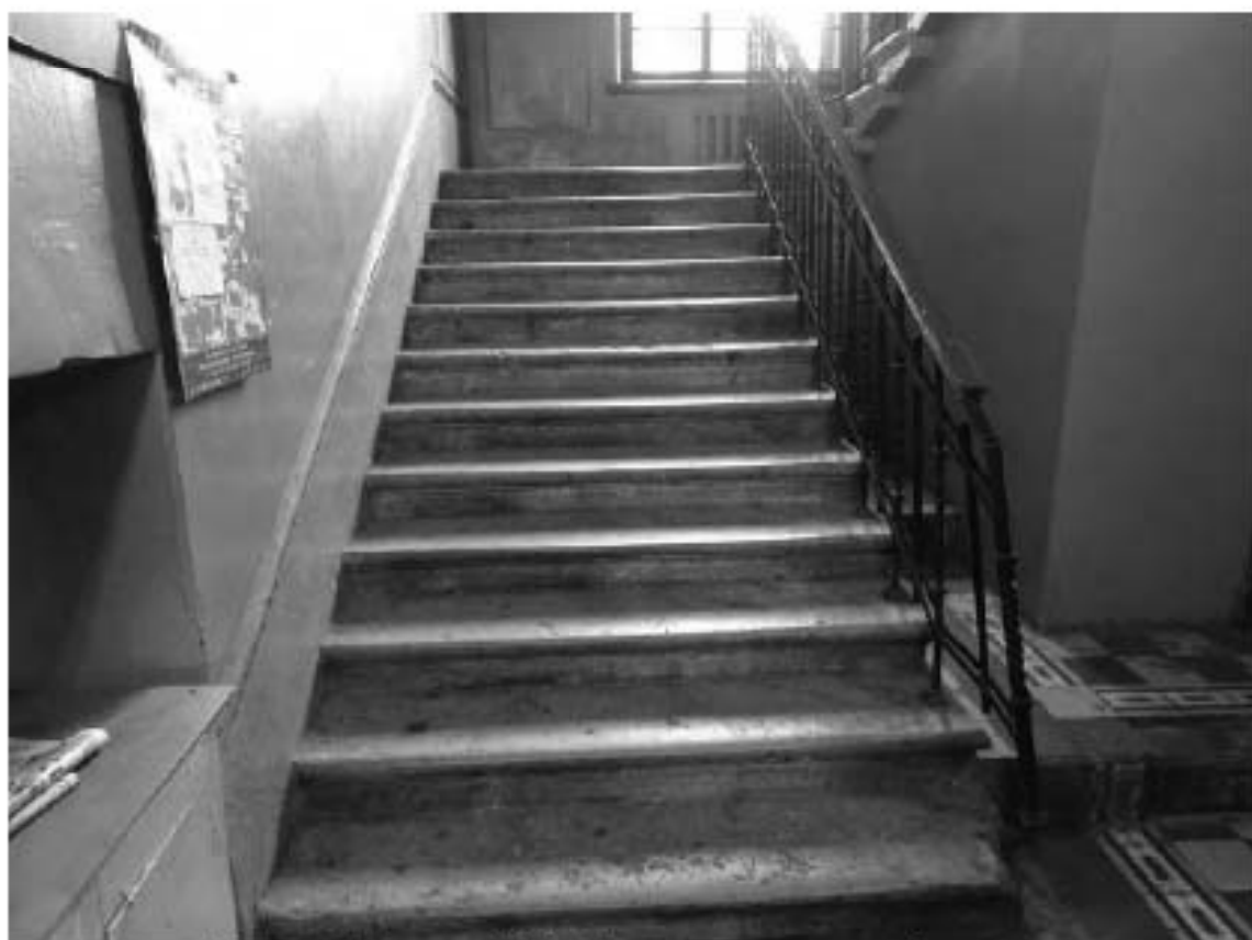
Фото 57. Лестница № 1: Площадка 1-го этажа. Лестница. Съемка 19.04.2021 г. Михайловская Г. В.
