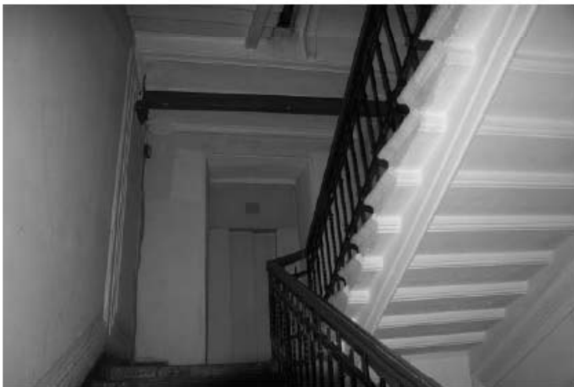
Фото 139. Лестница №2(1): Площадка м/у 3-м и 4-м этажом. Съемка 19.04.2021 г. Михайловская Г. В.
