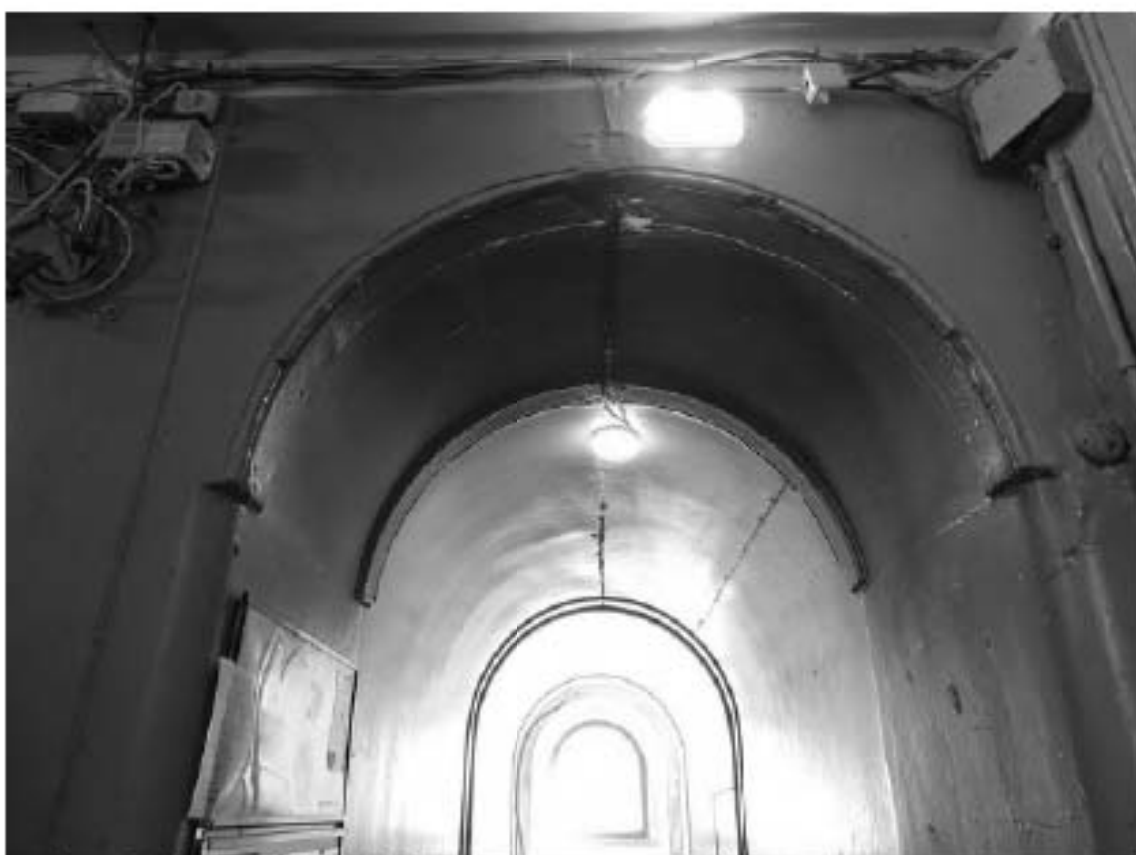
Фото 51. Лестница № 1: Площадка 1-го этажа. Оформление арочного проема. Съемка 19.04.2021 г. Михайловская Г. В.
