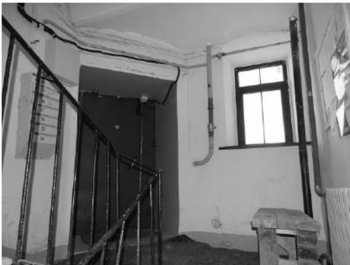
Фото 148. Лестница №3(1): 1-й этаж. Съемка 19.04.2021 г. Михайловская Г. В.
