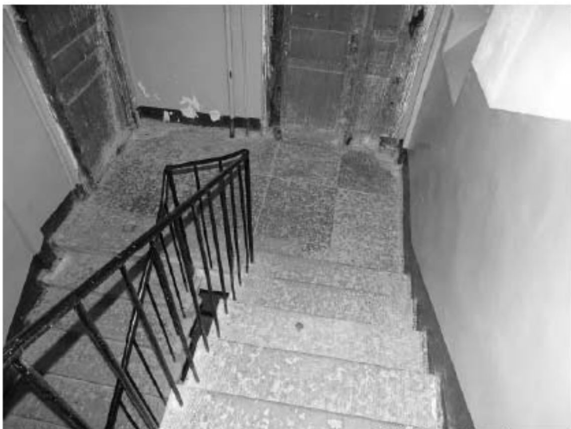
Фото 81. Лестница № 2(3): Площадка 3-го этажа. Съемка 19.04.2021 г. Михайловская Г. В.
