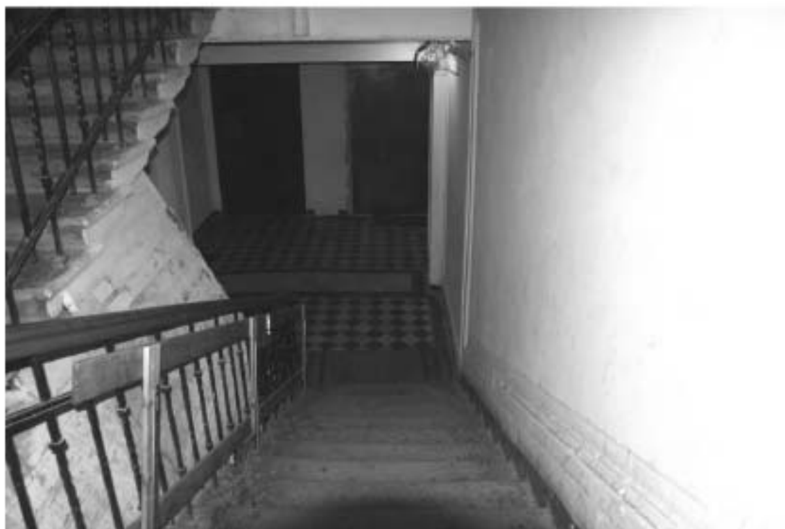
Фото 135. Лестница №2(1): 2-й этаж. Съемка 19.04.2021 г. Михайловская Г. В.
