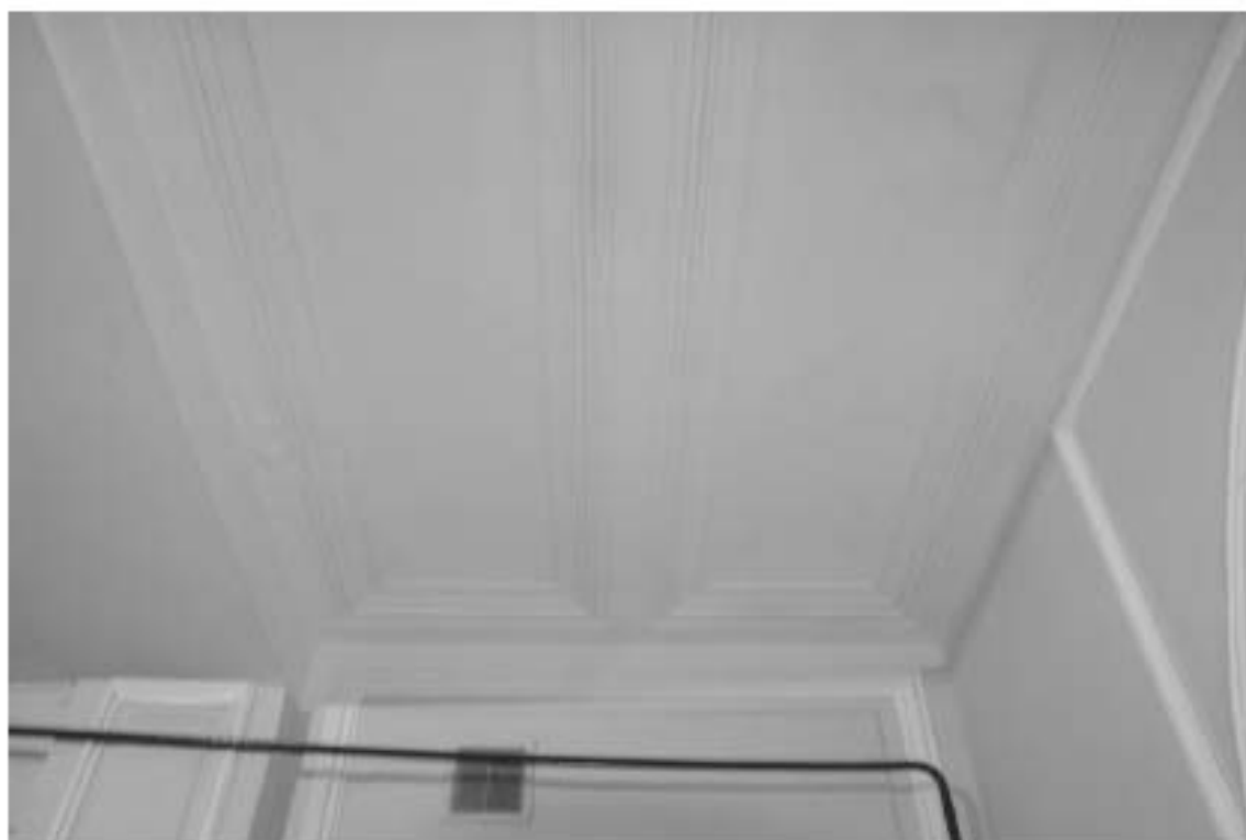
Фото 97. Лестница №1: 1-й этаж. Парадная. Съемка 19.04.2021 г. Михайловская Г. В.
