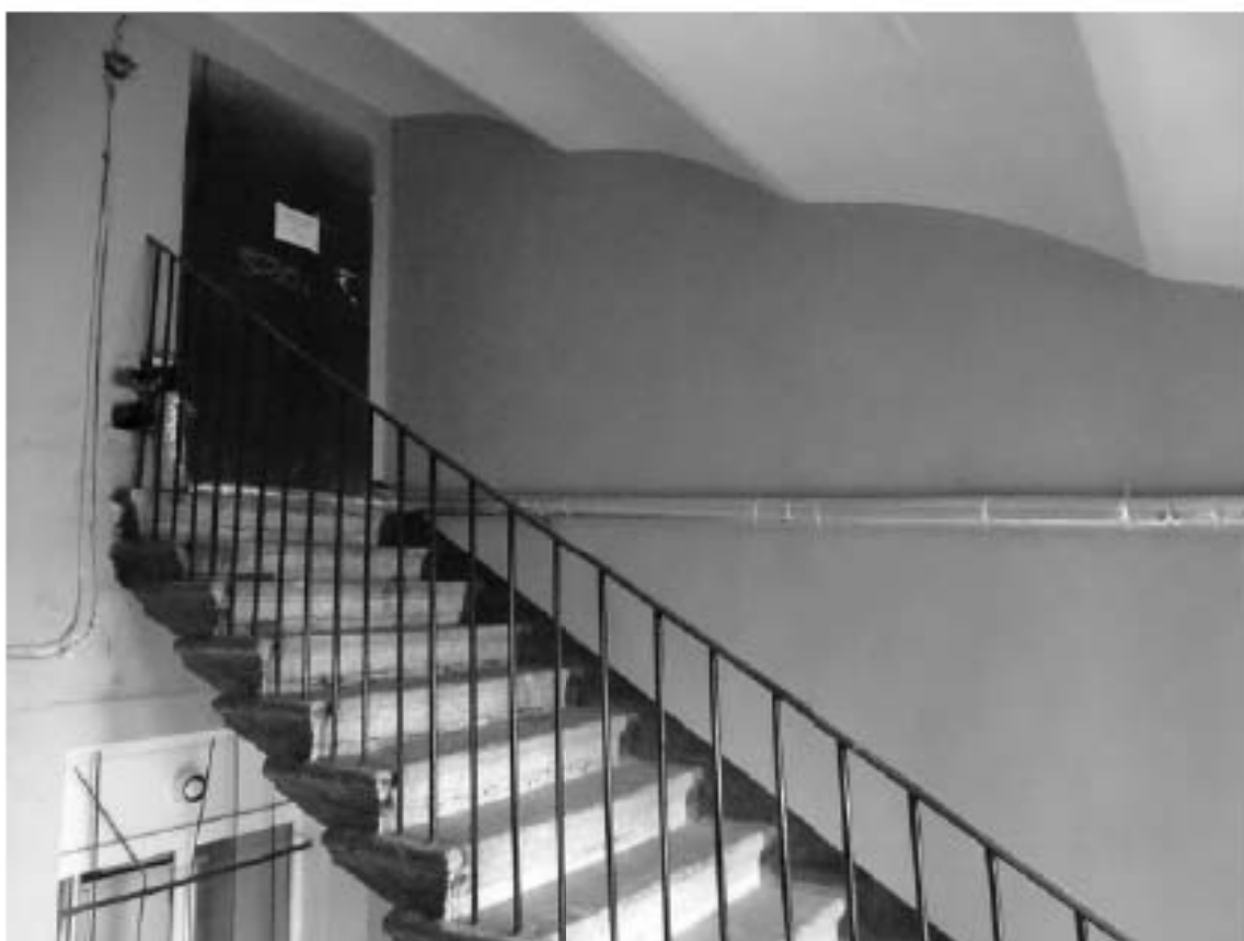
Фото 174. Лестница №6: Чердачный этаж. Съемка 19.04.2021 г. Михайловская Г. В.
