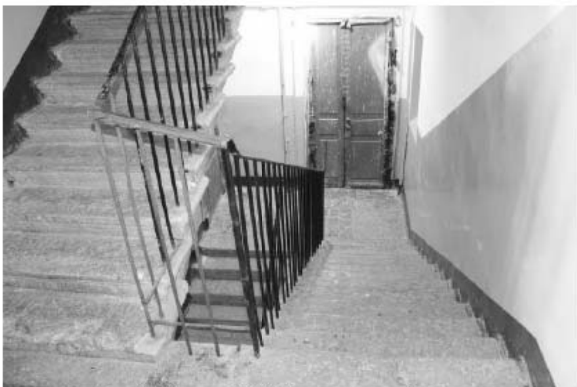
Фото 86. Лестница № 2(3): Вид на площадку 4-го этажа. Съемка 19.04.2021 г. Михайловская Г. В.
