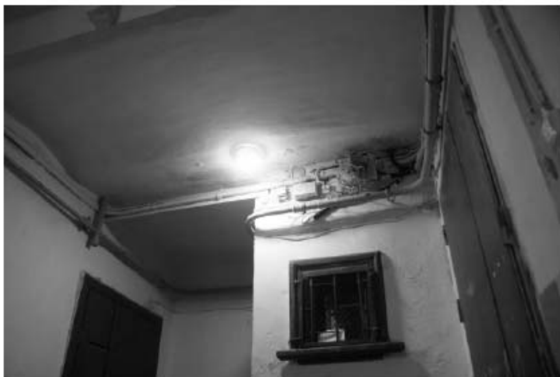
Фото 94. Лестница №4: 1-й этаж. Своды. Съемка 19.04.2021 г. Михайловская Г. В.
