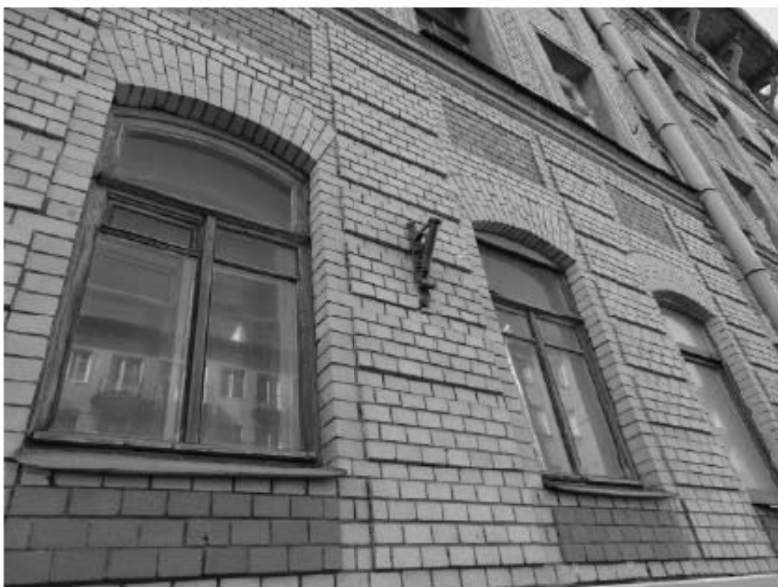
Фото 31. Здание по адресу: г. Санкт-Петербург, Большая Пушкарская улица, дом 38, литера А. Лицевой корпус. Фрагмент. Съемка 19.04.2021 г. Михайловская Г. В.
