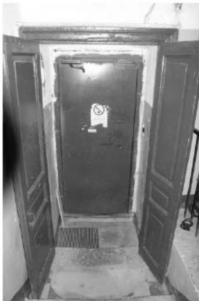
Фото 42. Лестница № 2(2): 1-й этаж. Съемка 19.04.2021 г. Михайловская Г. В.
