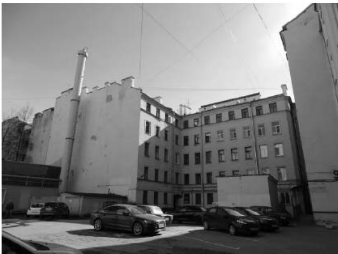
Фото 8. Здание по адресу: г. Санкт-Петербург, Большой проспект П.С., дом 45, литера А. Восточный внутренний двор. Съемка 19.04.2021 г. Михайловская Г. В.
