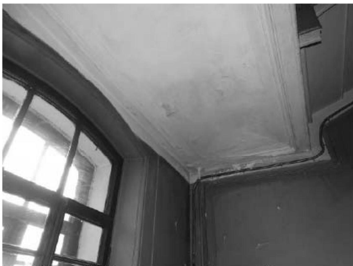
Фото 65. Лестница № 1: Площадка между 1-м и 2-м этажом. Оформление потолка. Съемка 19.04.2021 г. Михайловская Г. В.
