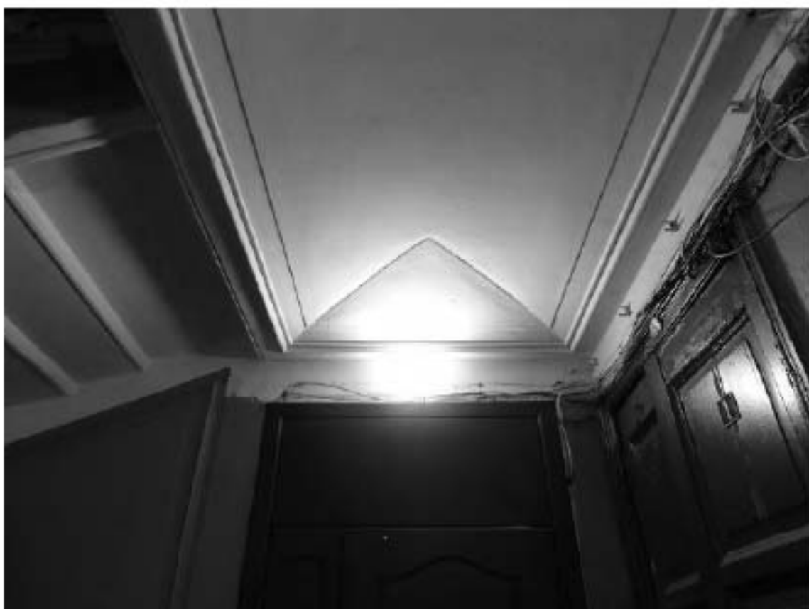
Фото 54. Лестница № 1: Площадка 1-го этажа. Съемка 19.04.2021 г. Михайловская Г. В.
