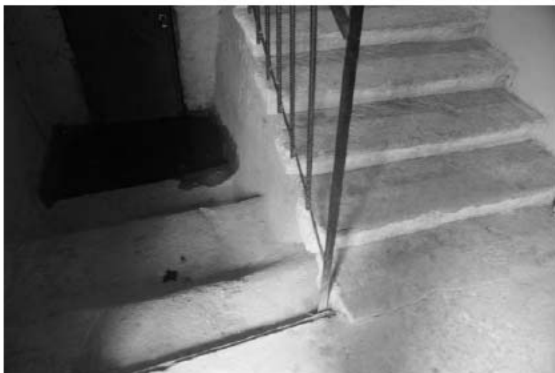
Фото 90. Лестница №4: 1-й этаж. Съемка 19.04.2021 г. Михайловская Г. В.
