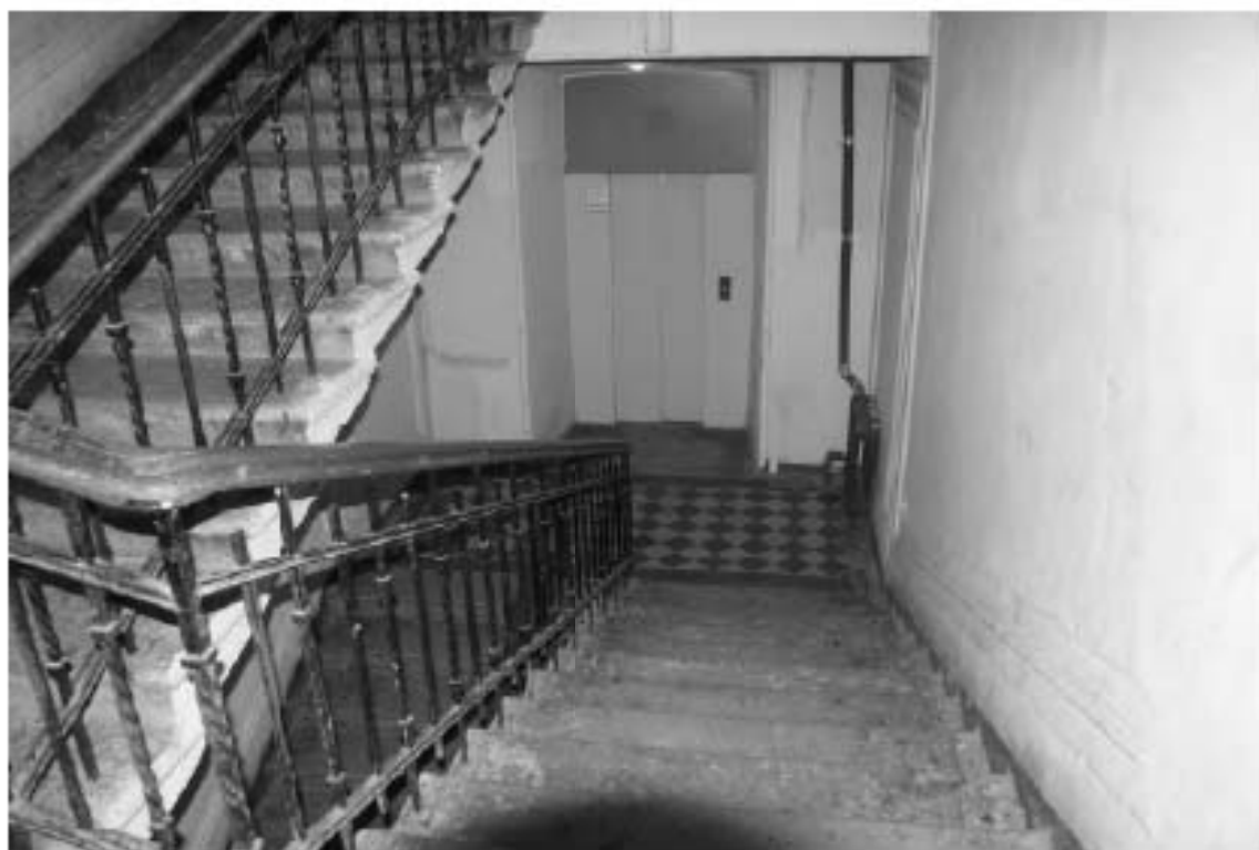
Фото 133. Лестница №2(1): Площадка м/у 1-м и 2-м этажом. Съемка 19.04.2021 г. Михайловская Г. В.
