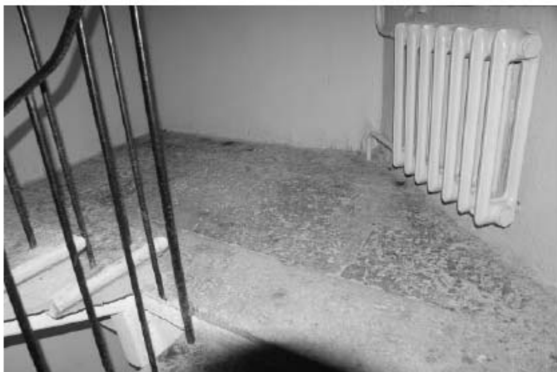
Фото 104. Лестница №4: Площадка м/у 2-м и 3-м этажом. Известняковые плиты. Съемка 19.04.2021 г. Михайловская Г. В.
