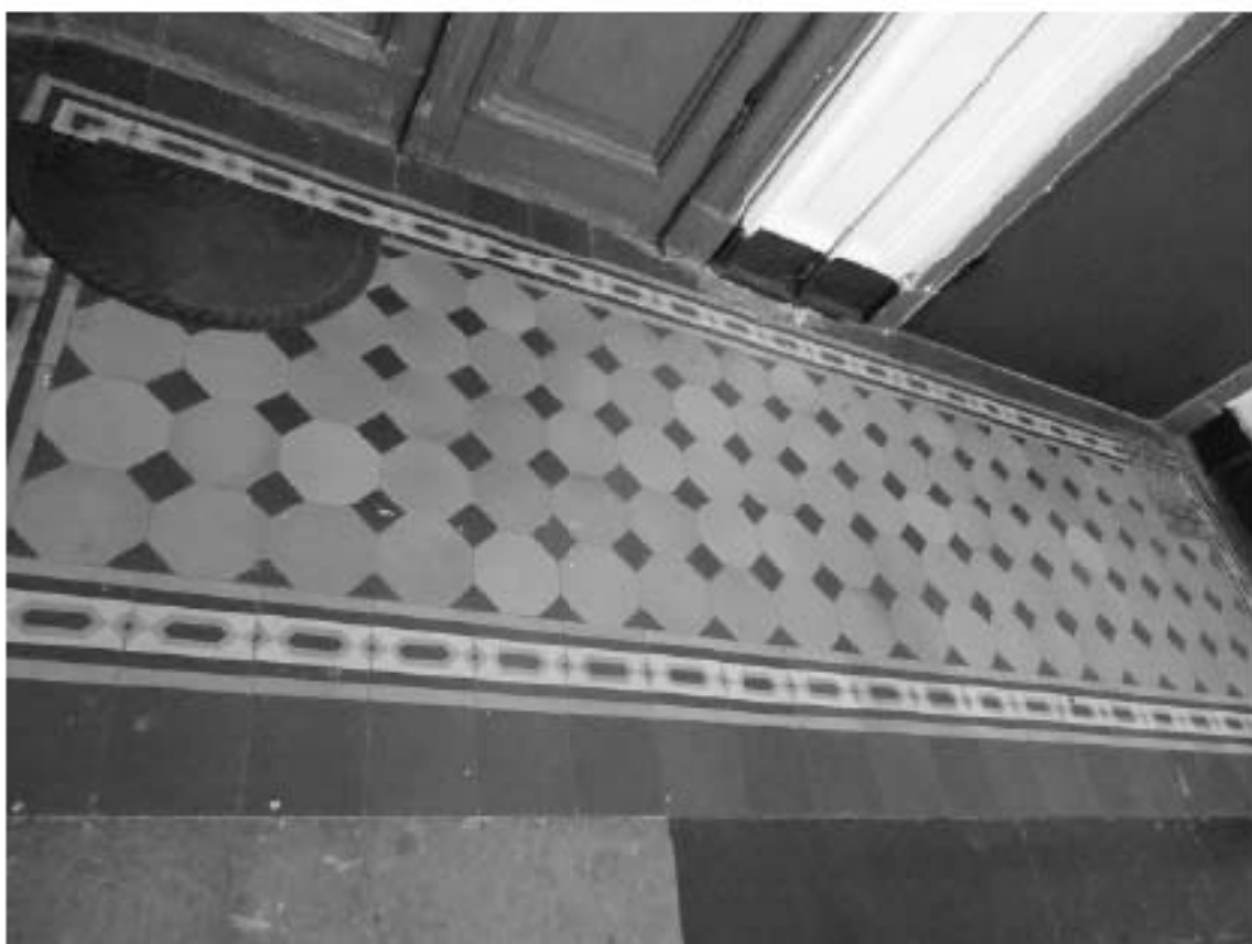
Фото 124. Лестница №1: 5-й этаж. Съемка 19.04.2021 г. Михайловская Г. В.
