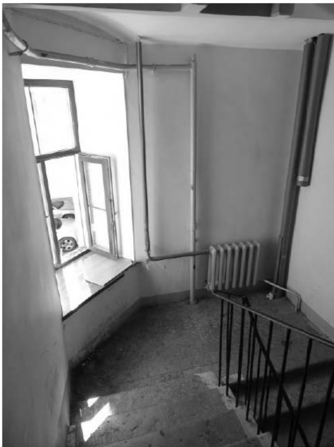
Фото 153. Лестница №3(1): Площадка м/у 1-м и 2-м этажом. Съемка 19.04.2021 г. Михайловская Г. В.
