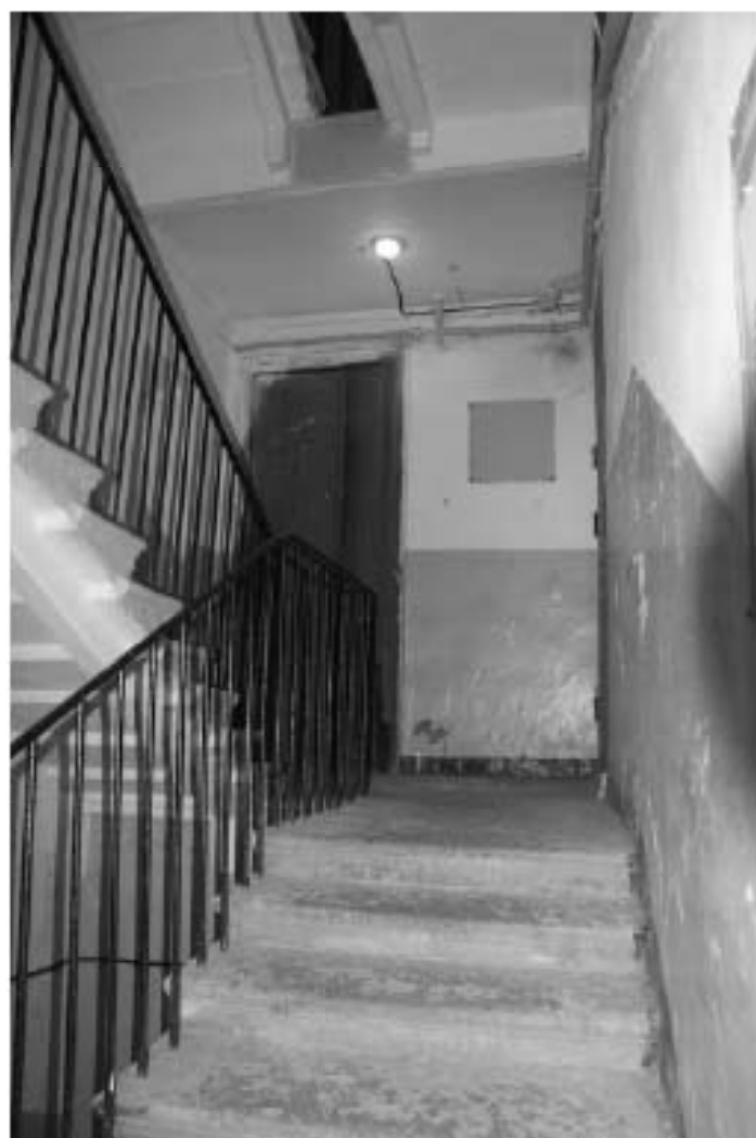
Фото 99. Лестница № 2(3): 1-й этаж. Съёмка 19.04.2021 г. Михайловская Г. В.
