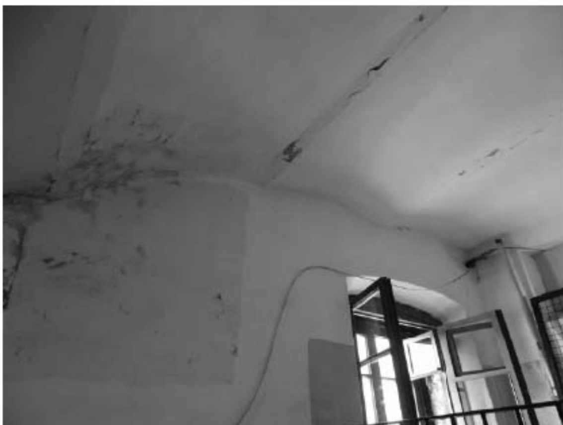
Фото 134. Лестница № 2(3): 6-й этаж. Съёмка 19.04.2021 г. Михайловская Г. В.
