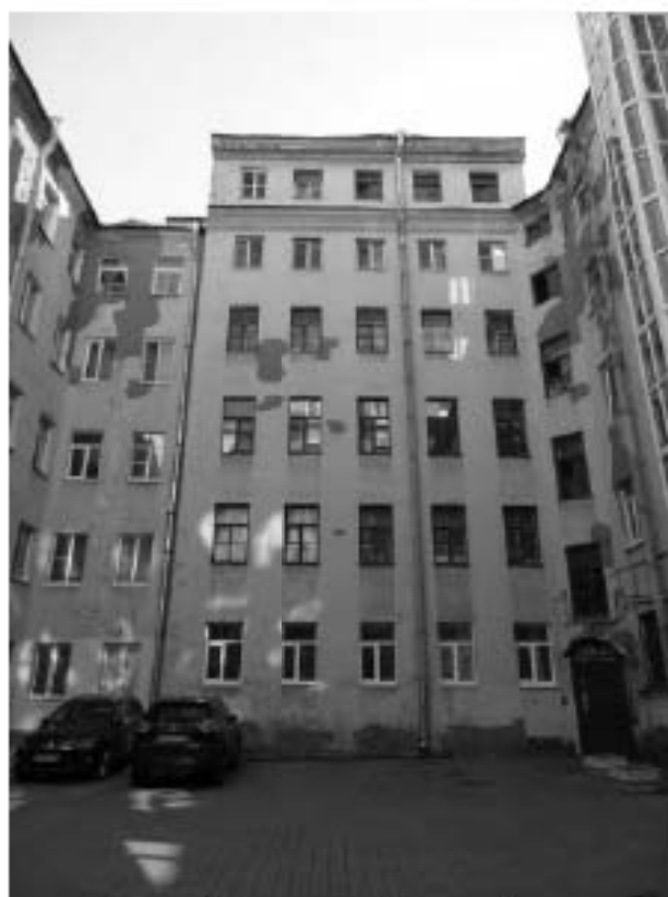
Фото 19. Здание по адресу: г. Санкт-Петербург, Большой проспект П.С., дом 45, литера А. Южный внутренний двор. Съемка 19.04.2021 г. Михайловская Г. В.
