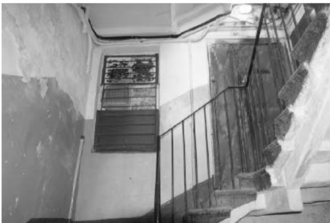
Фото 133. Лестница №4: 2-й этаж. Съемка 19.04.2021 г. Михайловская Г. В.
