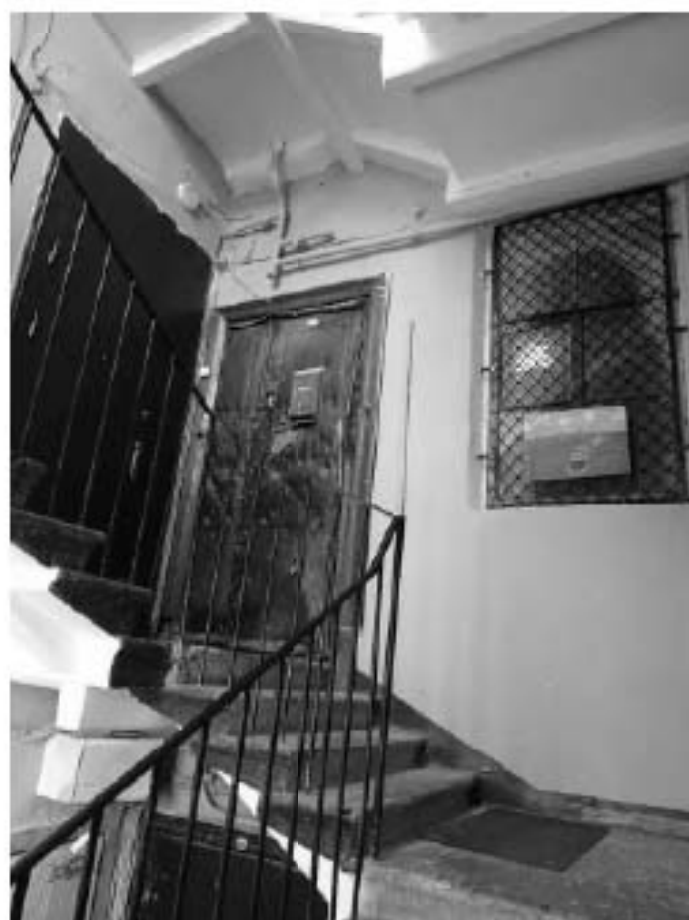
Фото 160. Лестница №6: 3-й этаж. Съемка 19.04.2021 г. Михайловская Г. В.
