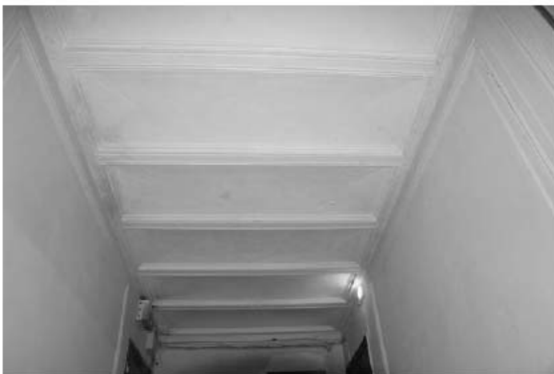
Фото 142. Лестница №2(1): Площадка м/у 4-м и 5-м этажом. Оформление потолка. Съемка 19.04.2021 г. Михайловская Г. В.
