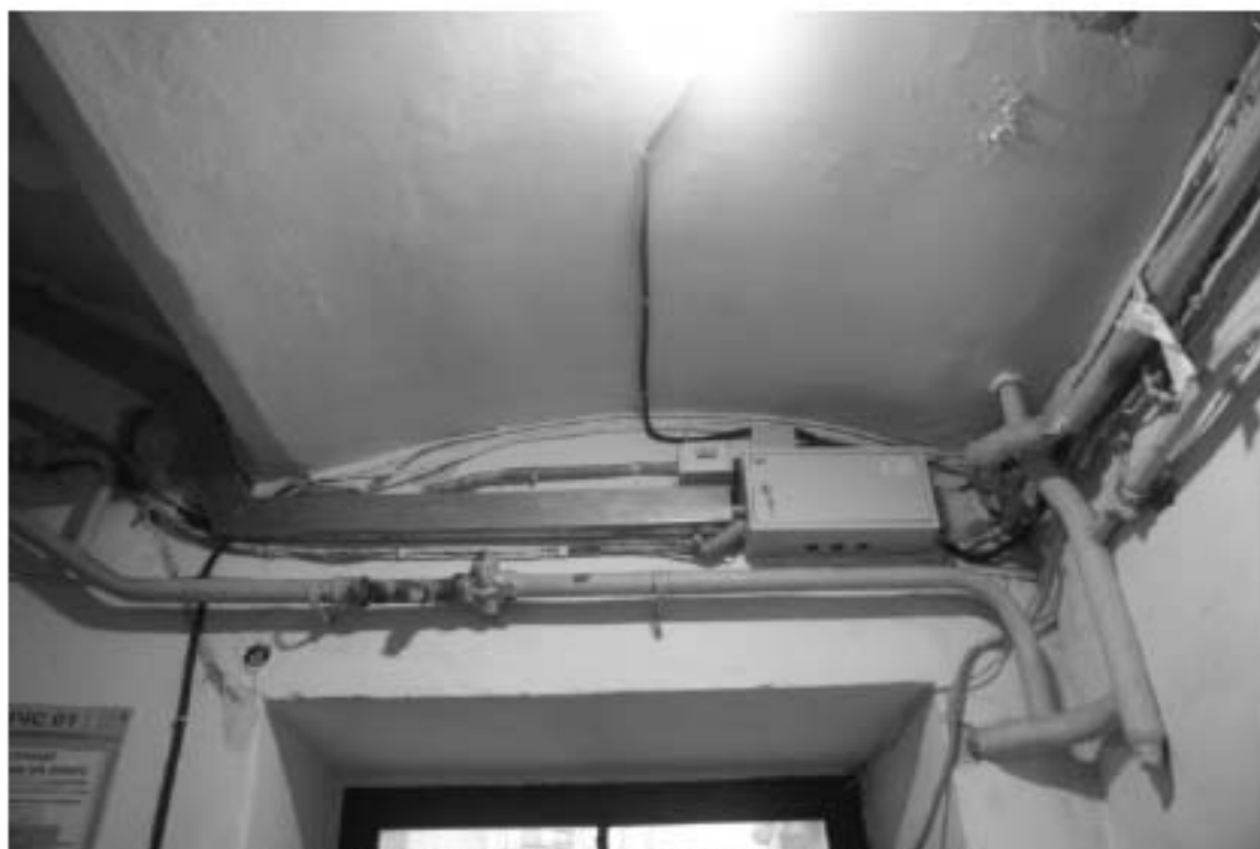
Фото 95. Лестница № 2(3): 1-й этаж. Перекрытие. Съемка 19.04.2021 г. Михайловская Г. В.
