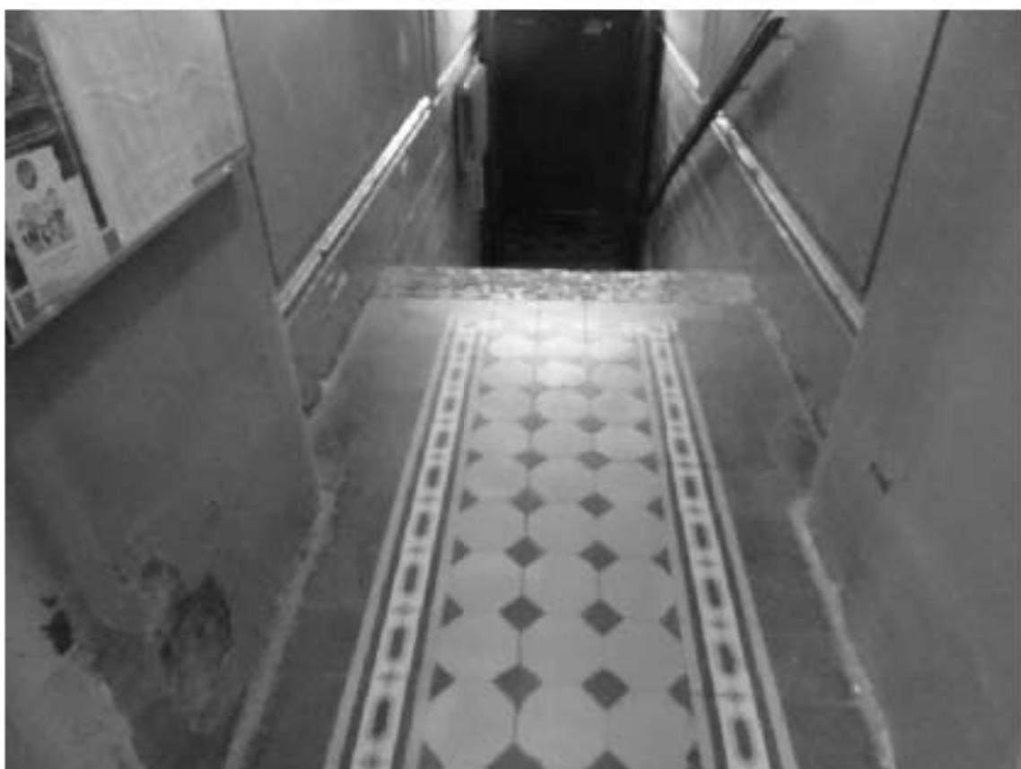
Фото 48. Лестница № 1: Вестибюль 1-го этажа. Покрытие пола. Съемка 19.04.2021 г. Михайловская Г. В.
