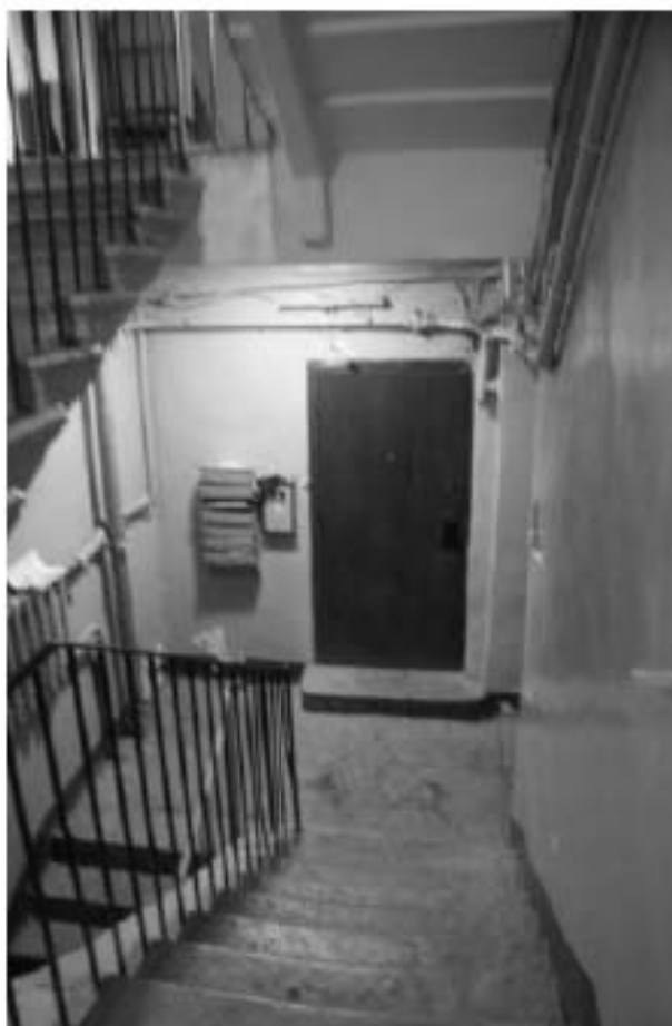
Фото 63. Лестница № 2(3): Вестибюль 1-го этажа. Съемка 19.04.2021 г. Михайловская Г. В.
