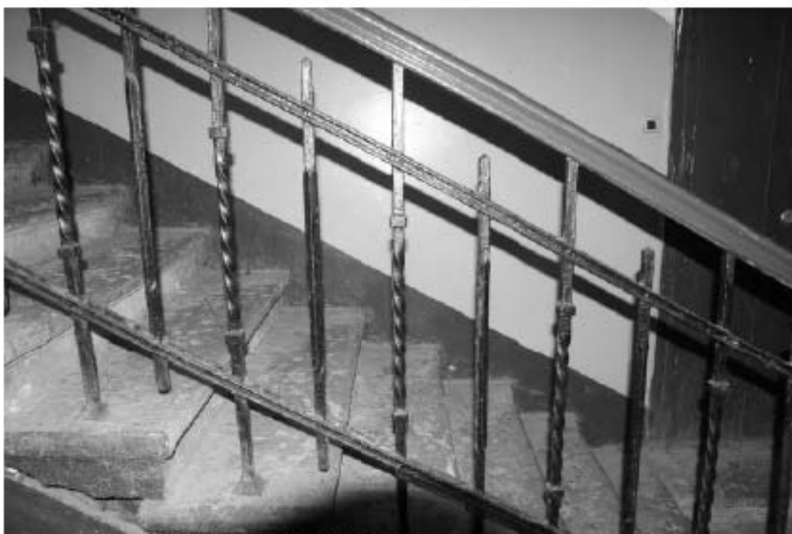
Фото 48. Лестница № 2(2): Фрагмент лестничного ограждения. Съемка 19.04.2021 г. Михайловская Г. В.
