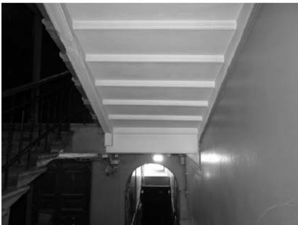
Фото 58. Лестница № 1: Площадка 1-го этажа. Лестница по косоурам. Съемка 19.04.2021 г. Михайловская Г. В.
