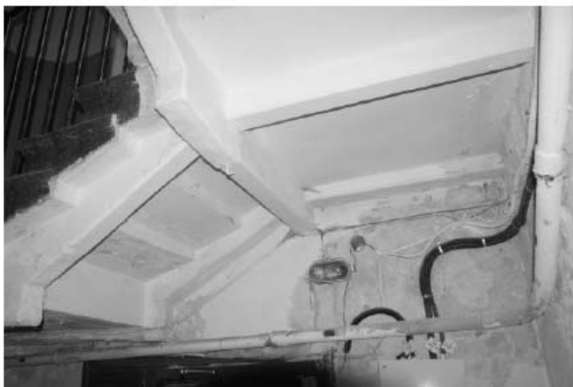
Фото 132. Лестница №4: 1-й этаж. Съемка 19.04.2021 г. Михайловская Г. В.
