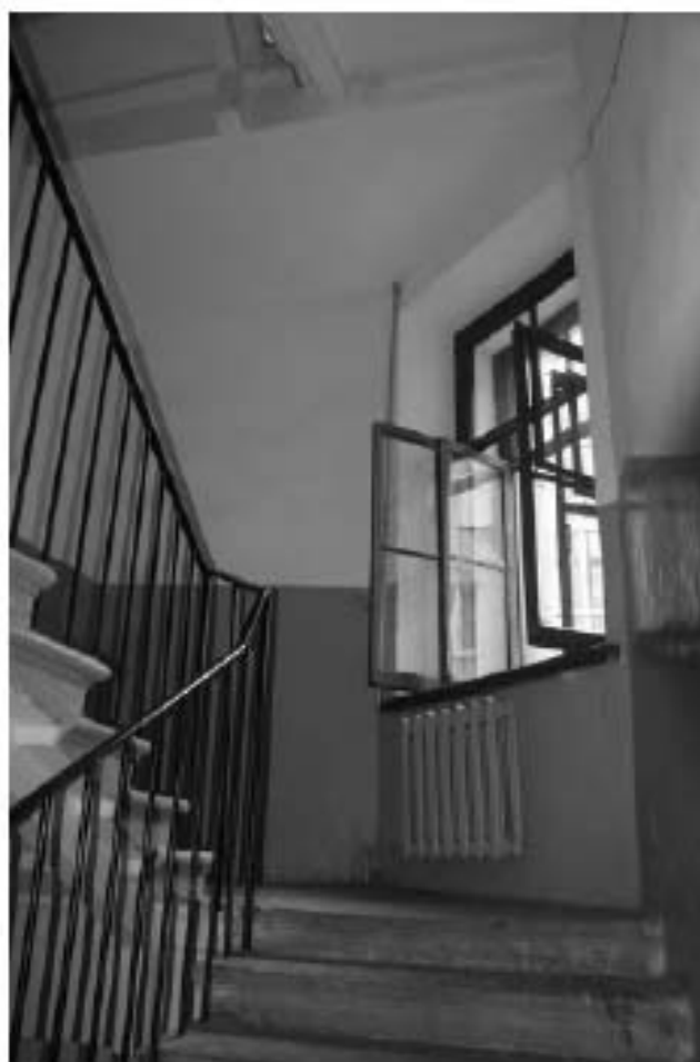
Фото 103. Лестница №4: Площадка м/у 2-м и 3-м этажом. Съемка 19.04.2021 г. Михайловская Г. В.
