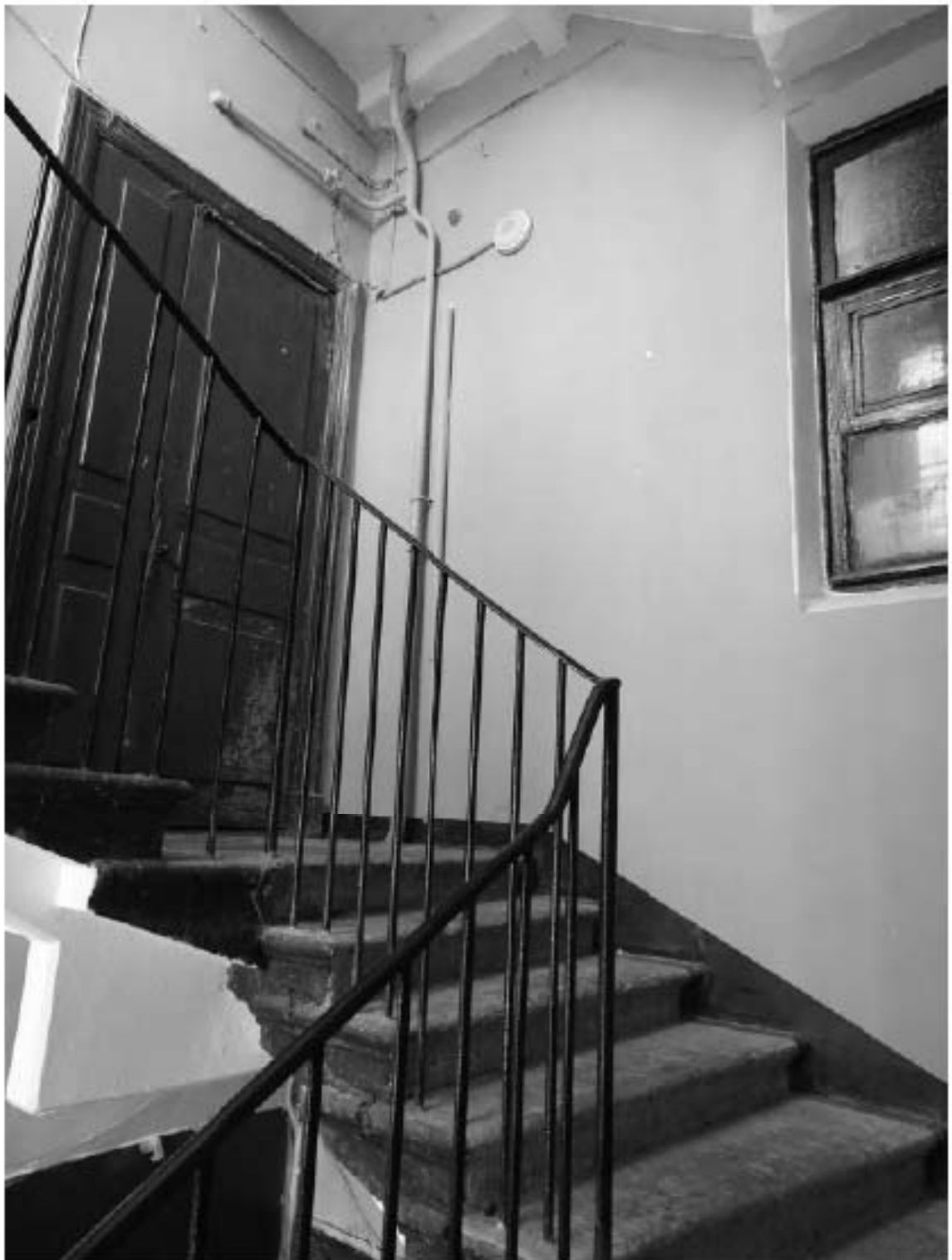
Фото 163. Лестница №6: 4-й этаж. Съемка 19.04.2021 г. Михайловская Г. В.
