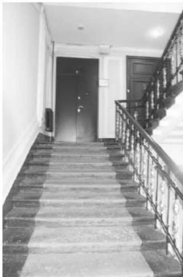
Фото 105. Лестница №1: 2-й этаж. Съемка 19.04.2021 г. Михайловская Г. В.
