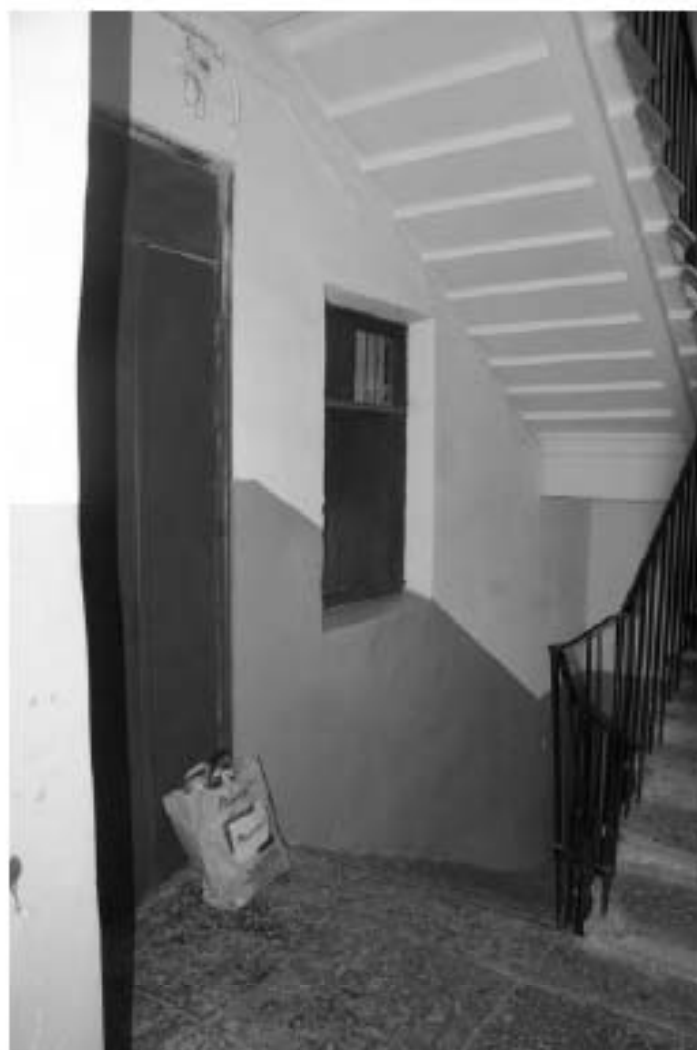
Фото 101. Лестница №4: 2-й этаж. Съемка 19.04.2021 г. Михайловская Г. В.
