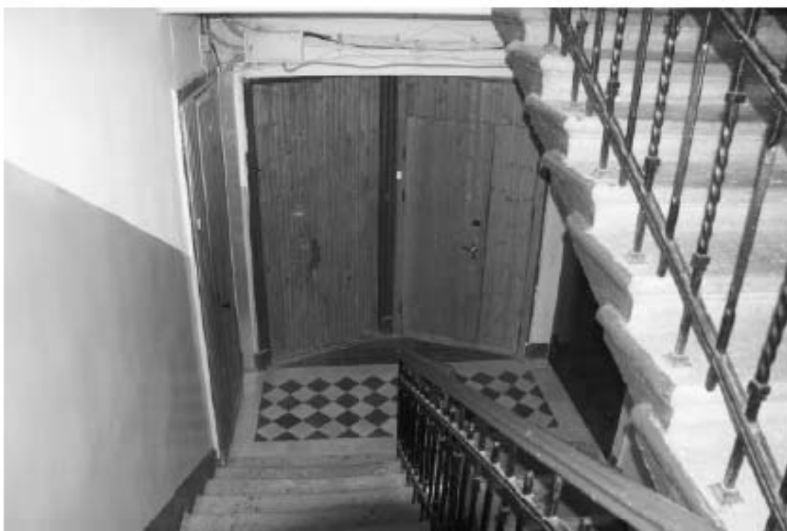
Фото 55. Лестница № 2(2): 3-й этаж. Съемка 19.04.2021 г. Михайловская Г. В.
