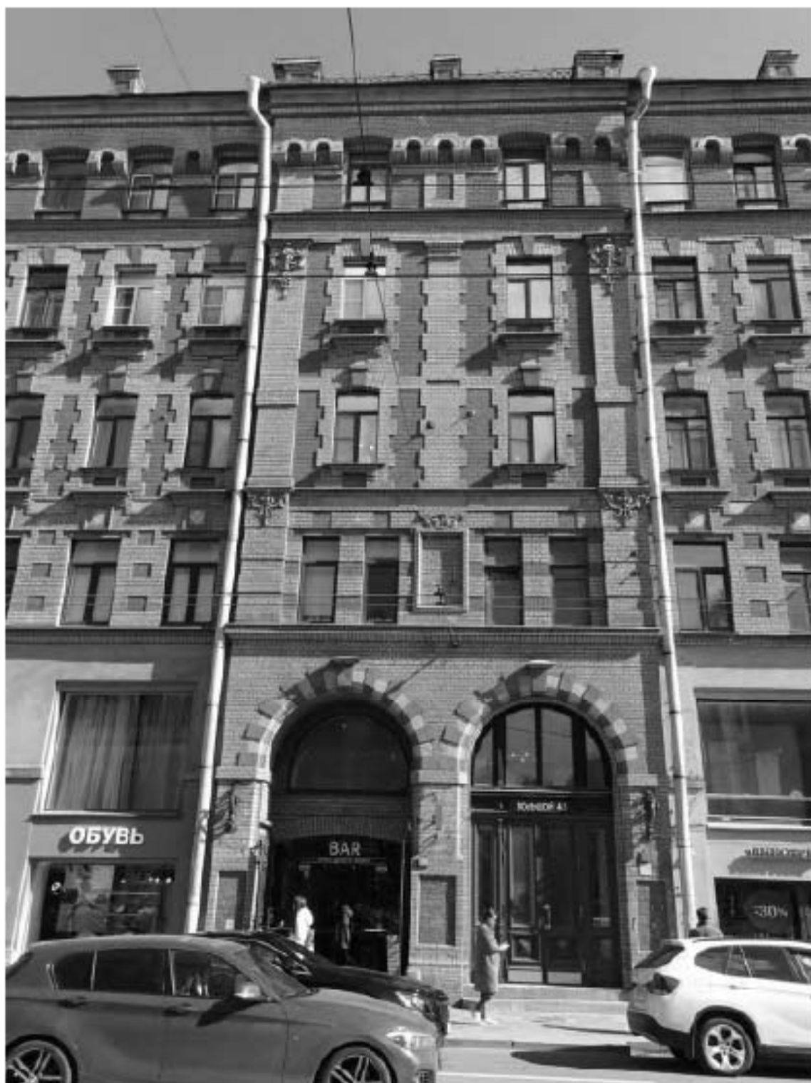
Фото 3. Здание по адресу: г. Санкт-Петербург, Большой проспект П.С., дом 45, литера А. Лицевой фасад. Фрагмент. Съемка 19.04.2021 г. Михайловская Г. В.
