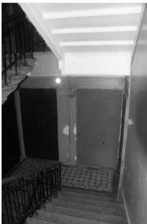
Фото 67. Лестница № 1: Вид на площадку 2-го этажа. Съемка 19.04.2021 г. Михайловская Г. В.
