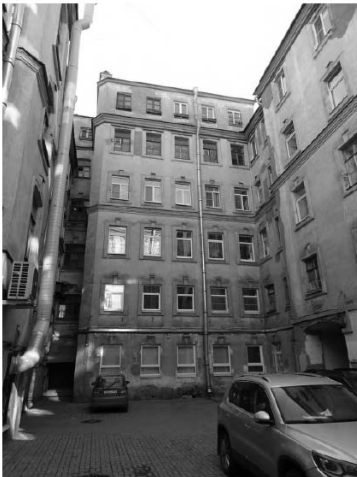
Фото 26. Здание по адресу: г. Санкт-Петербург, Большая Пушкарская улица, дом 38, литера А. Внутренний двор. Съемка 19.04.2021 г. Михайловская Г. В.
