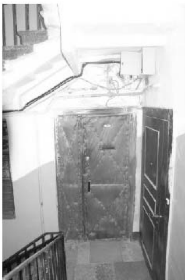
Фото 134. Лестница №4: 2-й этаж. Съемка 19.04.2021 г. Михайловская Г. В.
