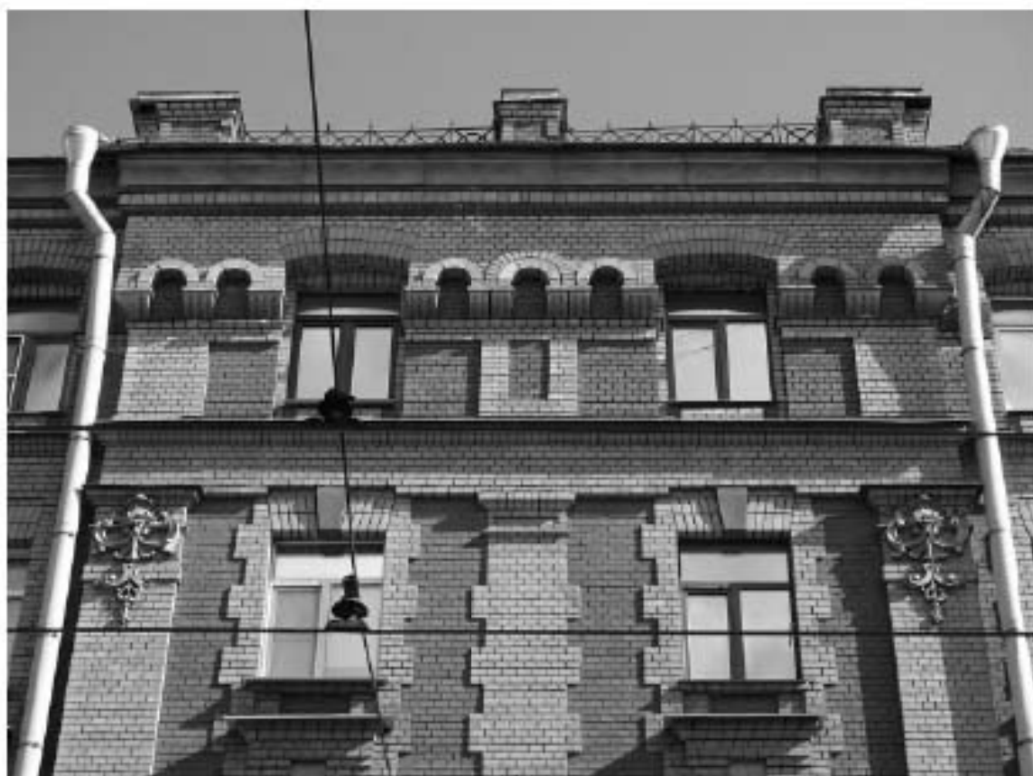
Фото 4. Здание по адресу: г. Санкт-Петербург, Большой проспект П.С., дом 45, литера А. Лицевой фасад. Фрагмент. Съемка 19.04.2021 г. Михайловская Г. В.
