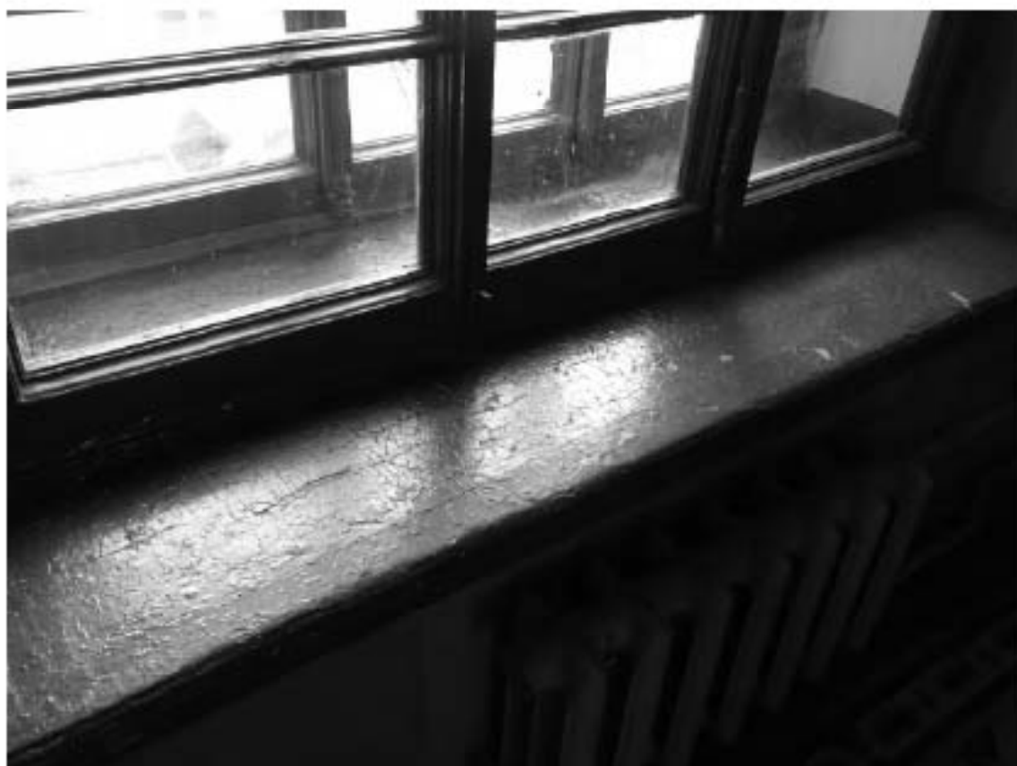
Фото 61. Лестница № 1: Площадка между 1-м и 2-м этажом. Оформление окна. Съемка 19.04.2021 г. Михайловская Г. В.
