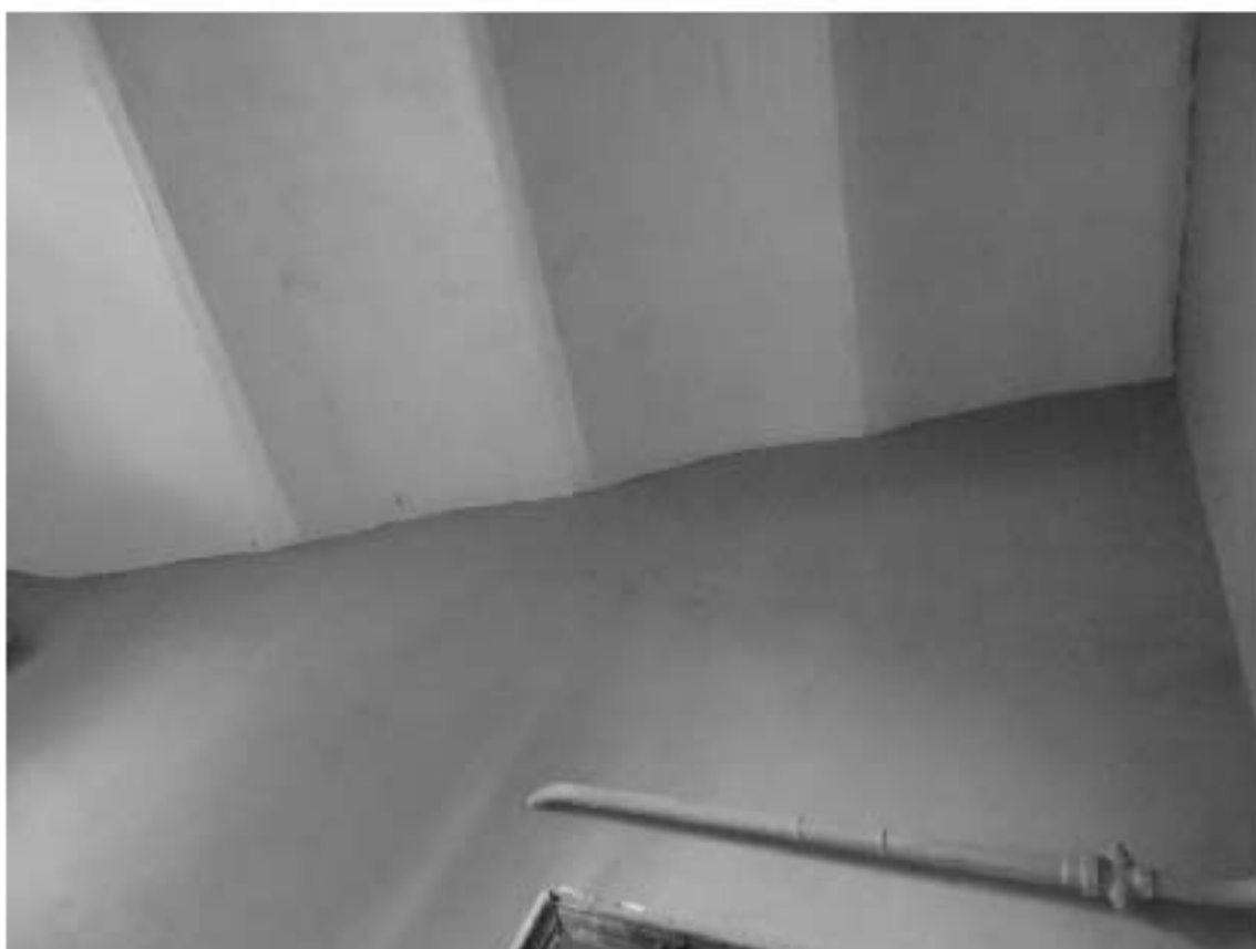
Фото 172. Лестница №6: 6-й этаж. Своды. Съемка 19.04.2021 г. Михайловская Г. В.
