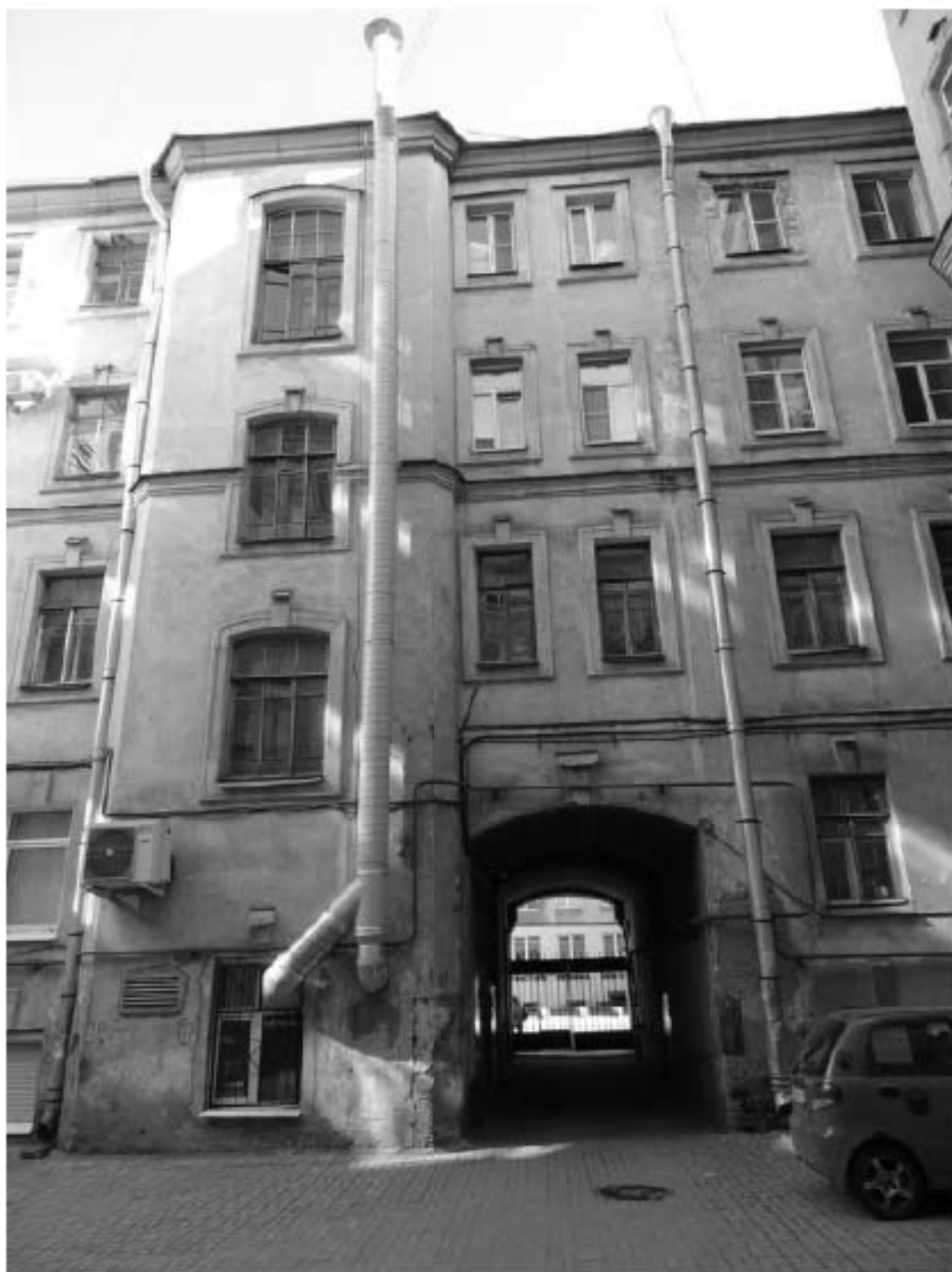
Фото 23. Здание по адресу: г. Санкт-Петербург, Большая Пушкарская улица, дом 38, литера А. Внутренний двор. Дворовой фасад лицевого корпуса. Съемка 19.04.2021 г. Михайловская Г. В.
