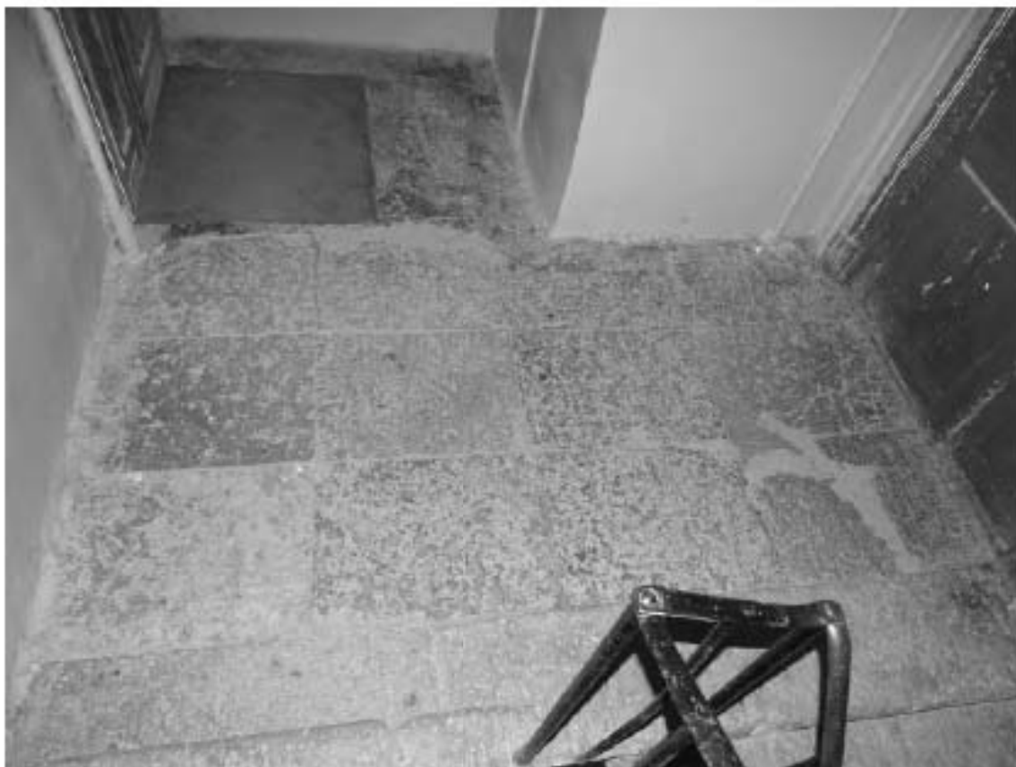
Фото 121. Лестница №4: 5-й этаж. Известняковые плиты. Съемка 19.04.2021 г. Михайловская Г. В.
