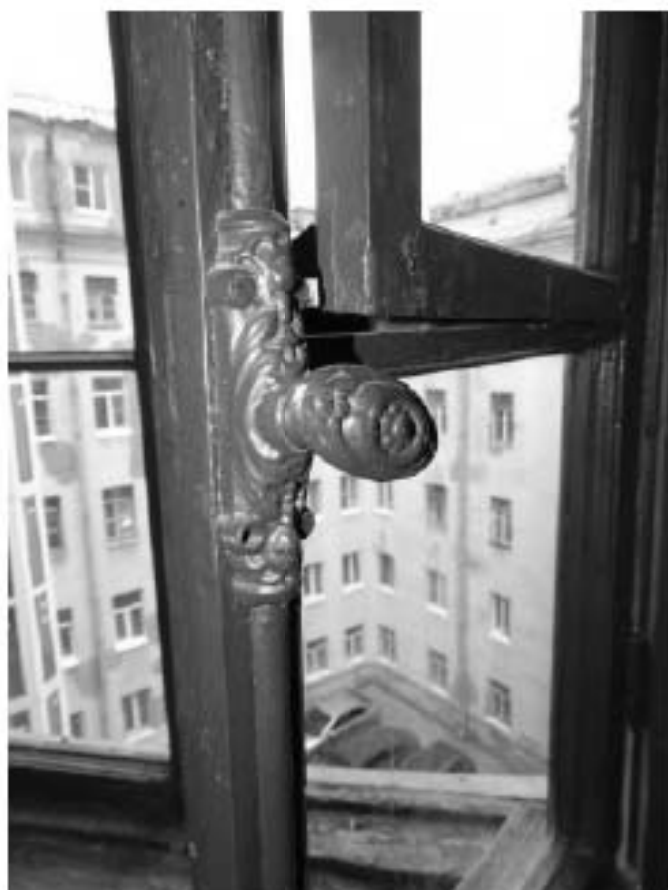
Фото 119. Лестница №4: Площадка м/у 4-м и 5-м этажом. Оконная фурнитура. Съемка 19.04.2021 г. Михайловская Г. В.
