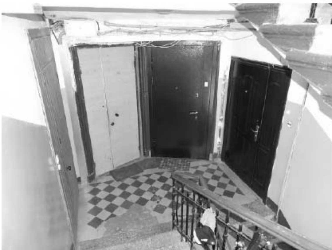
Фото 58. Лестница № 2(2): 4-й этаж. Съемка 19.04.2021 г. Михайловская Г. В.
