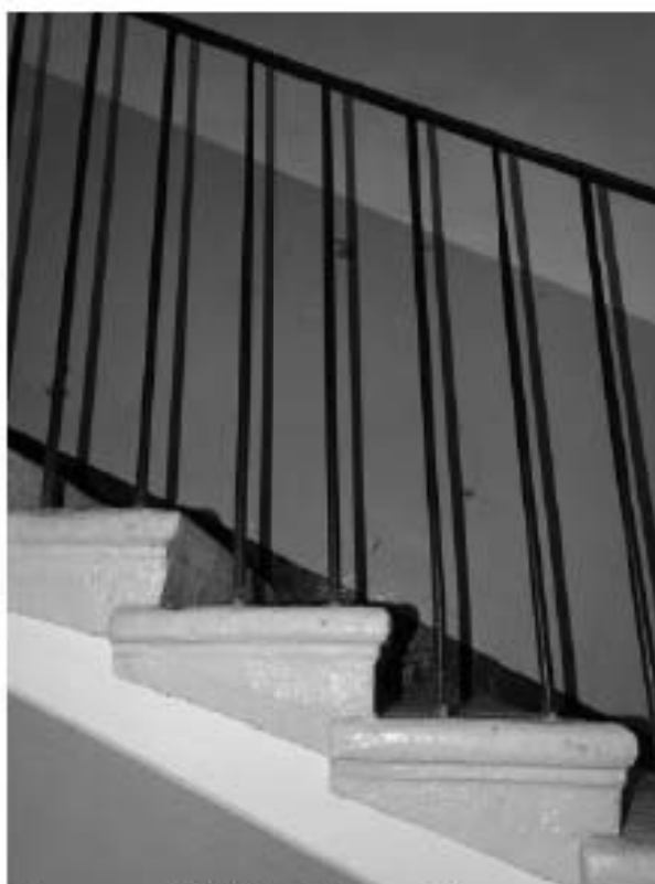
Фото 120. Лестница № 2(3): 4-й этаж. Лестничное ограждение. Съемка 19.04.2021 г. Михайловская Г. В.
