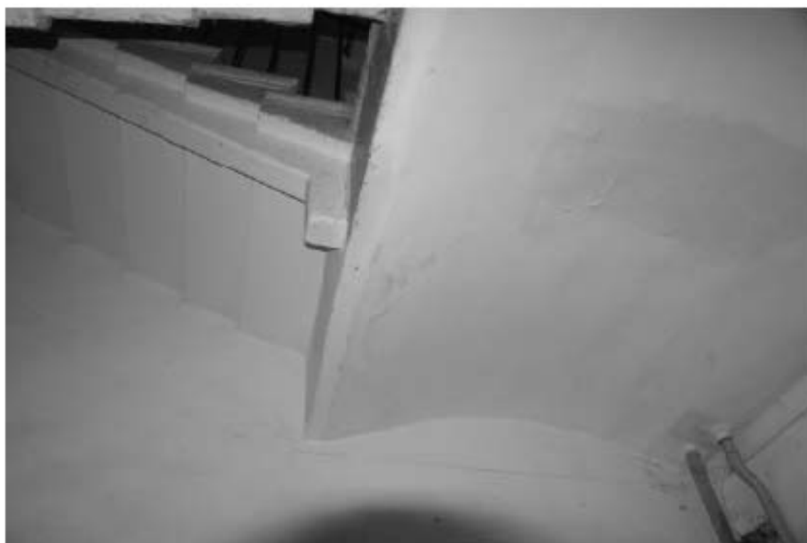
Фото 109. Лестница № 2(3): Площадка 2-го этажа. Прусский свод. Съемка 19.04.2021 г. Михайловская Г. В.
