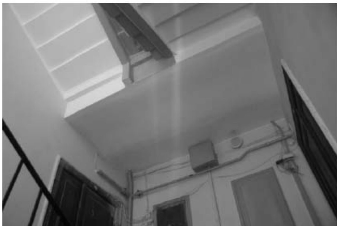
Фото 161. Лестница №3(1): 3-й этаж. Съемка 19.04.2021 г. Михайловская Г. В.
