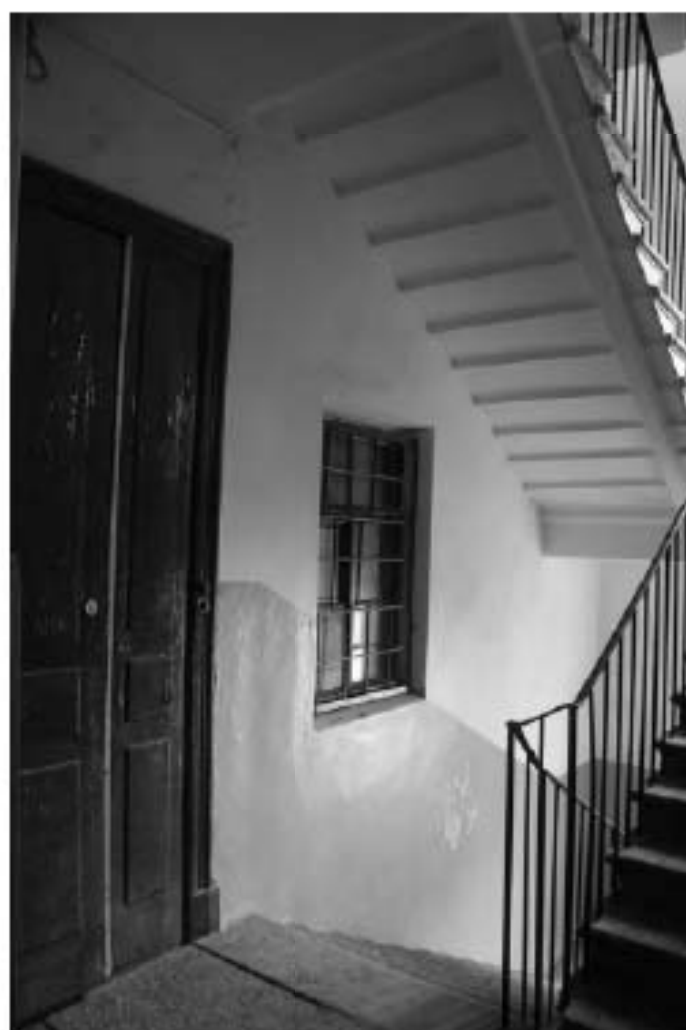
Фото 110. Лестница №4: 3-й этаж. Съемка 19.04.2021 г. Михайловская Г. В.
