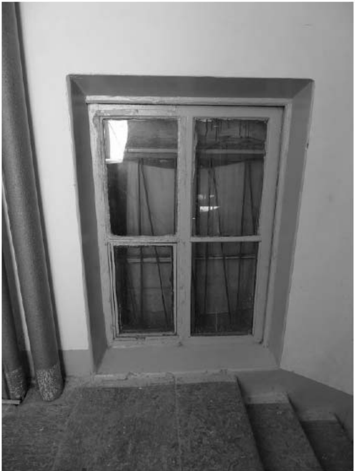
Фото 159. Лестница №3(1): Площадка м/у 2-м и 3-м этажом. Съемка 19.04.2021 г. Михайловская Г. В.
