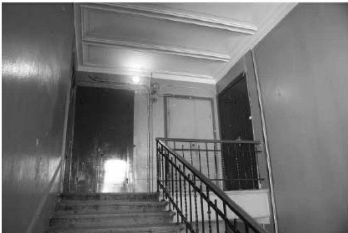
Фото 79. Лестница № 1: Вид на площадку 4-го этажа. Съемка 19.04.2021 г. Михайловская Г. В.
