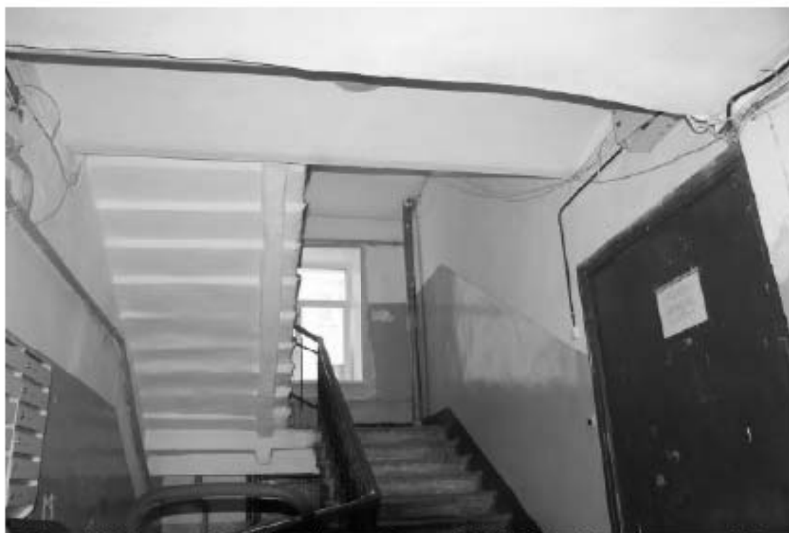
Фото 43. Лестница № 2(2): 1-й этаж. Съемка 19.04.2021 г. Михайловская Г. В.
