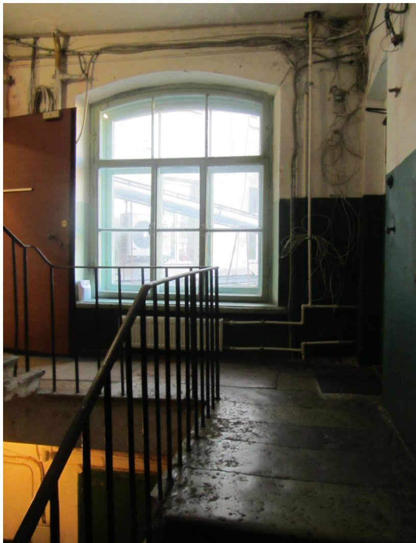
16. Площадка второго этажа лестничной клетки. Фрагмент.
