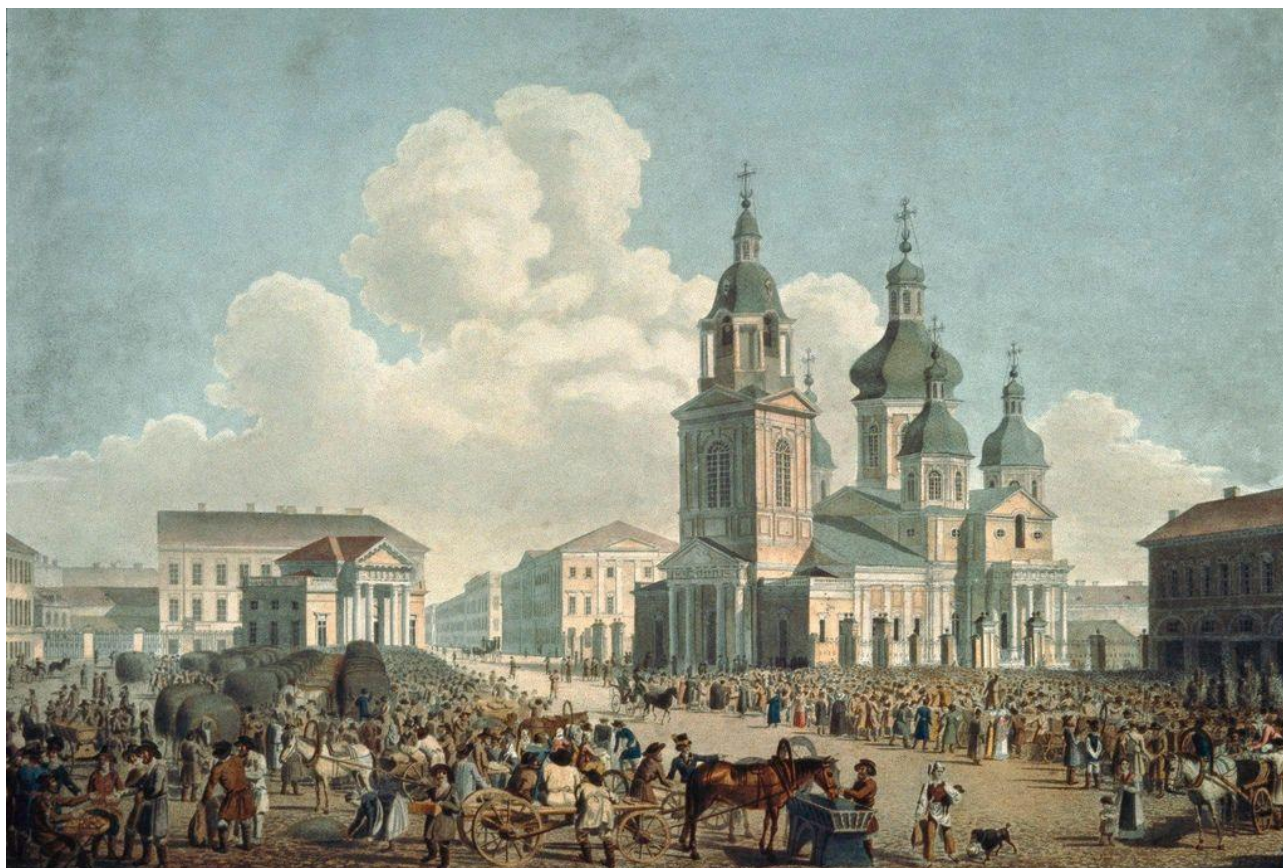
Илл. 8. А.П. Брюллов. Петербург. Сенная площадь. 1822 г. Бумага, акварель. Колокольня церкви, перестроенная по проекту Луиджи Руска в 1816-1817 гг. За зданием церкви дом купца Саввы Яковлева 1770-х гг. постройки.
