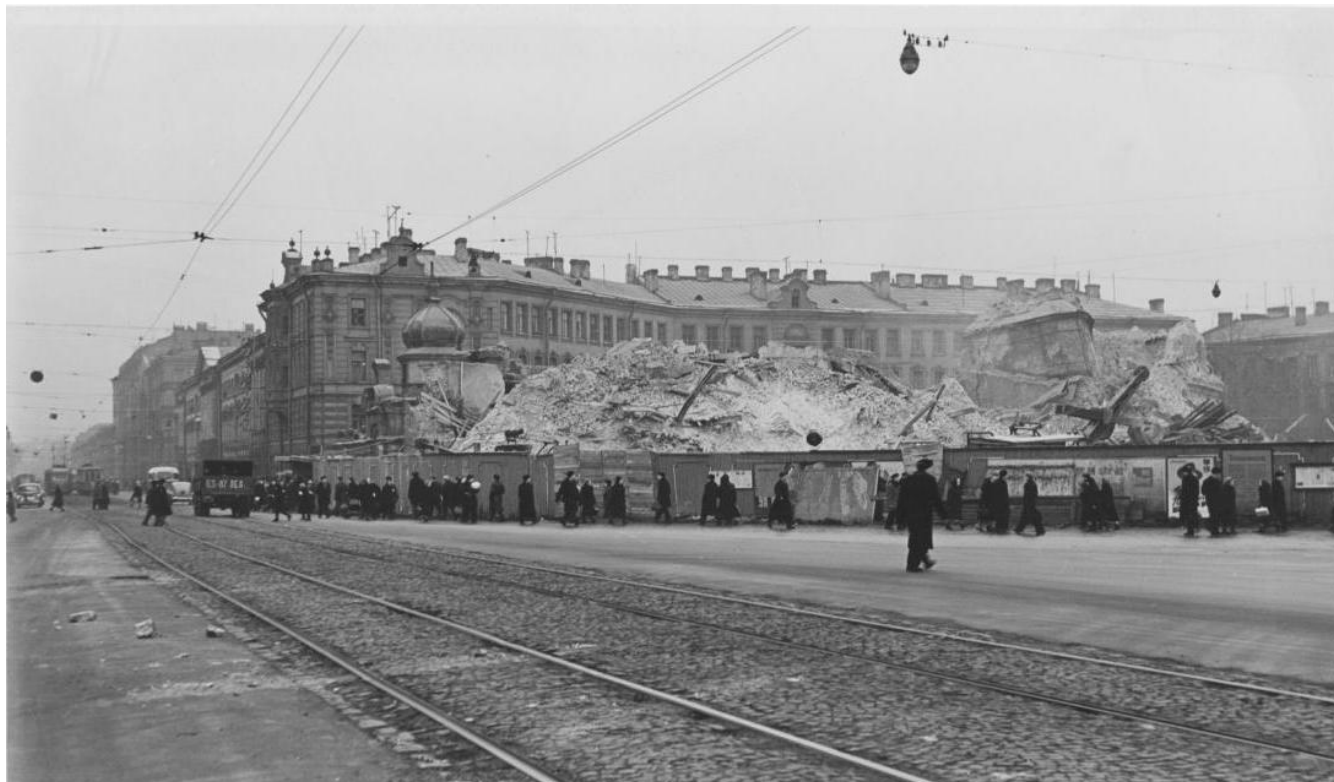
Илл. 29. Площадь Мира. Разрушение Успенской церкви. 1961 г.//Сайт: oldsp.ru.
