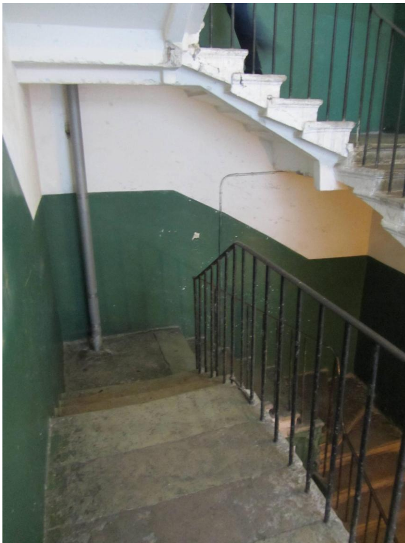
17. Лестничные марши между вторым и третьим этажами. Фрагмент.
