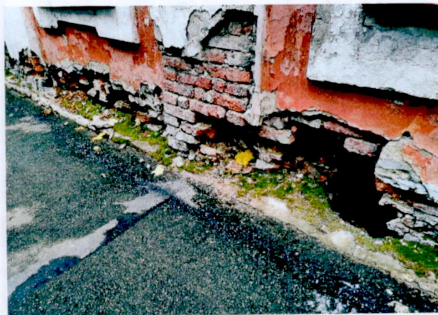
14. Фрагмент восточного фасада.
