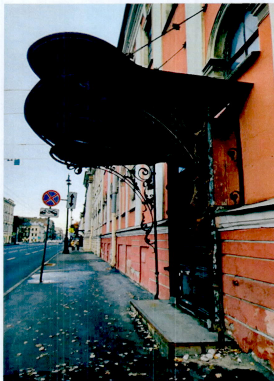
8. Фрагмент западного фасада. Козырек на кронштейнах.
