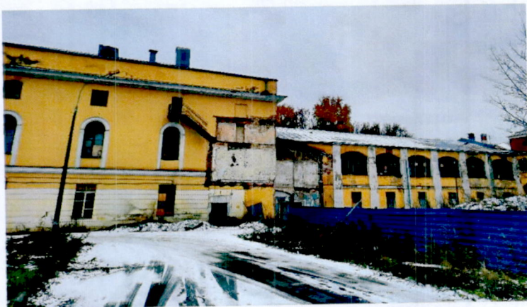
15. Фрагмент восточного фасада.
