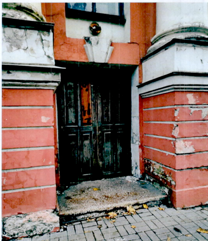
7. Фрагмент западного фасада.
