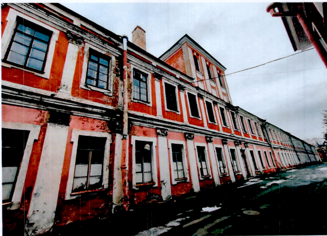
12. Фрагмент восточного фасада.
