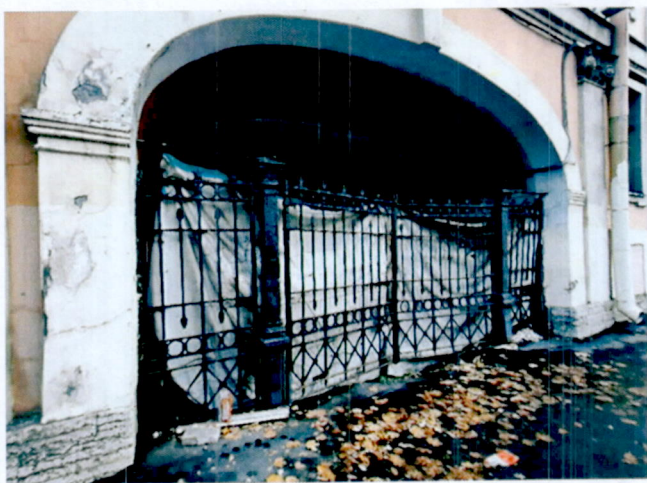
9. Фрагмент западного фасада. Воротный проезд.
