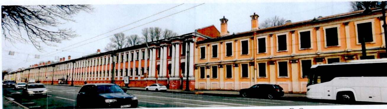
11. Фрагмент западного фасада - Кадетская линия В.О.
