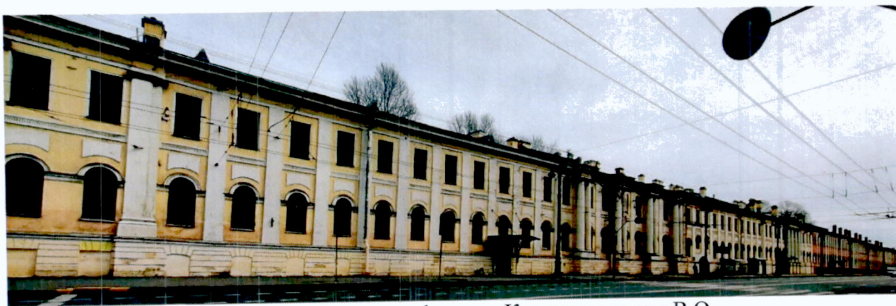
3. Фрагмент западного фасада - Кадетская линия В.О.
