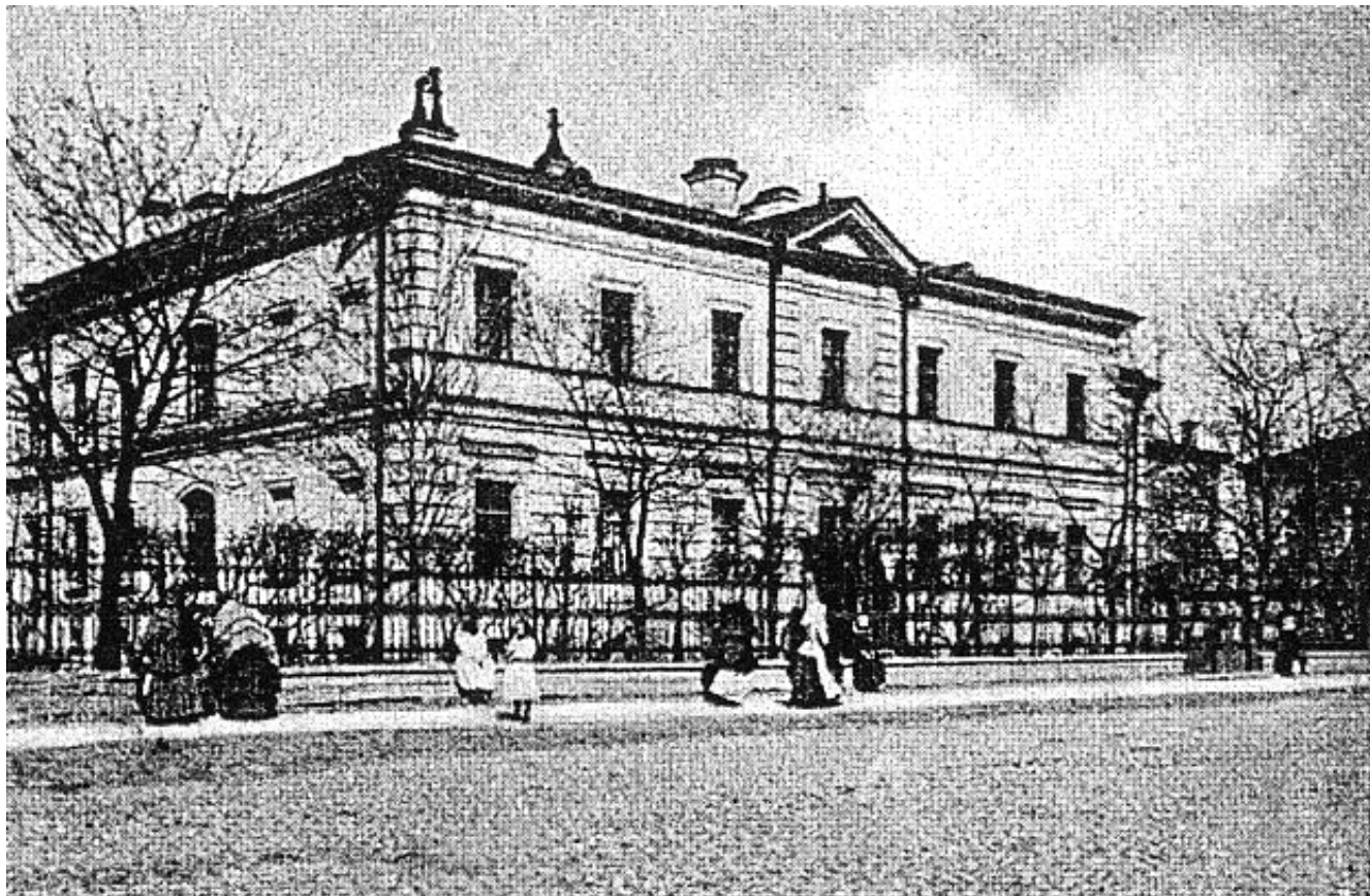
Илл. 21. Здание Дома призрения малолетних детей в память Государя Цесаревича и Великого Князя Николая Александровича в Кронштадте.
