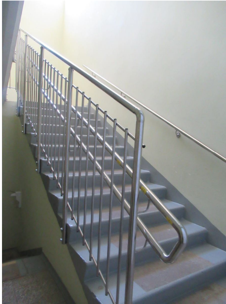
41. Вид на лестницу в уровне 1-го этажа (пом. 50).
