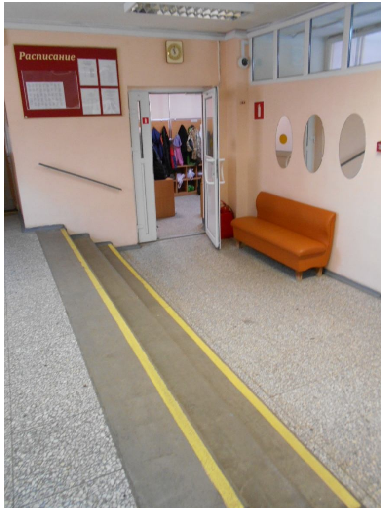
27. Вид в интерьере вестибюля 1-го этажа (пом. 15).
