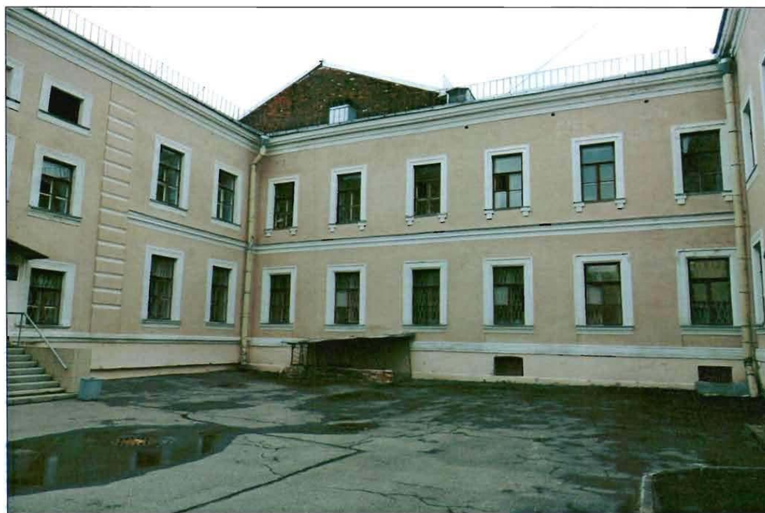
5. Общий вид дворовых фасадов с юго-запада.
