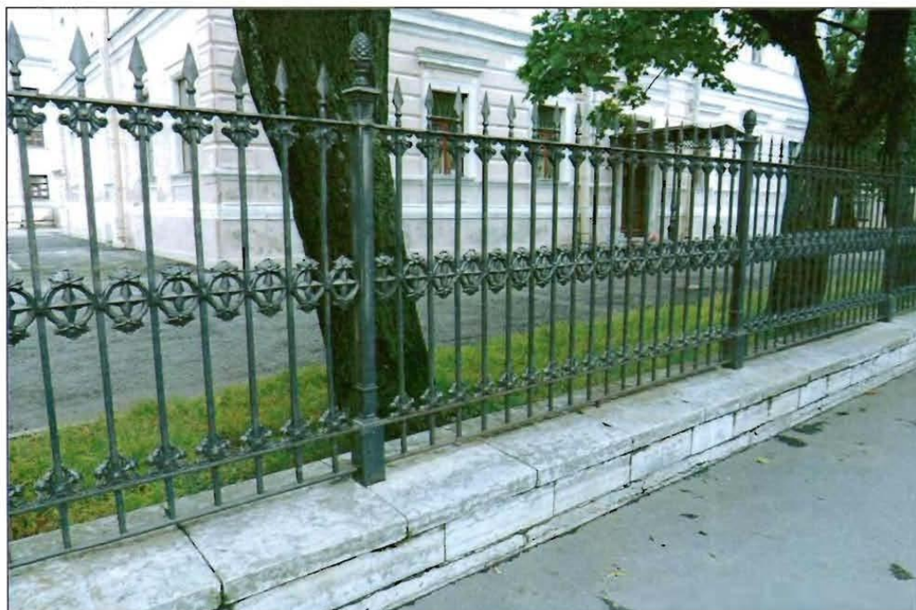
7. Общий вид чугунной ограды
