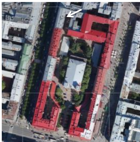
41. Фрагмент фасада дома № 10 по Большой Конюшенной ул. со стороны двора
