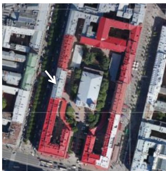
12. Деталь фасада дома № 12 по Большой Конюшенной ул.
