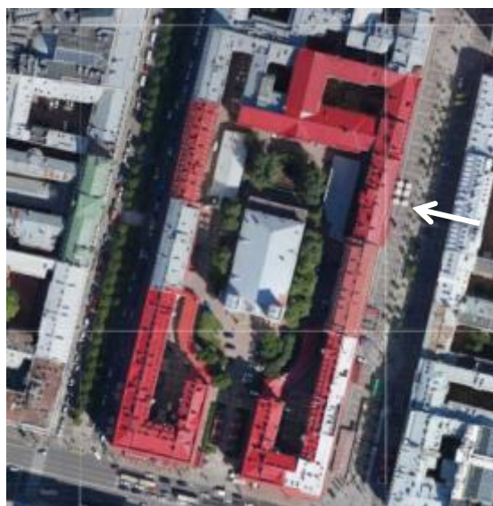
44. Фасад дома № 5 по Малой Конюшенной ул. (южная часть)
