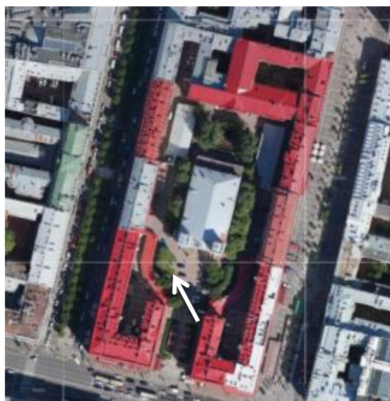
14. Общий вид дома № 12 по Большой Конюшенной ул. со стороны двора
