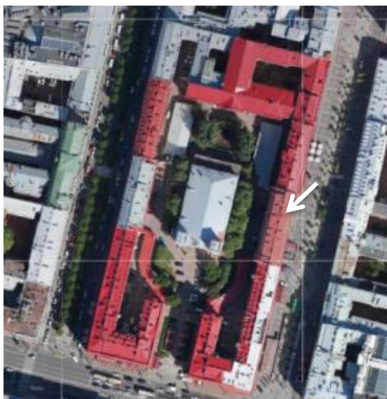
55. Фрагмент фасада дома № 7 по Малой Конюшенной ул.
