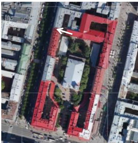
30. Фрагмент фасада дома № 10 по Большой Конюшенной ул. со стороны двора
