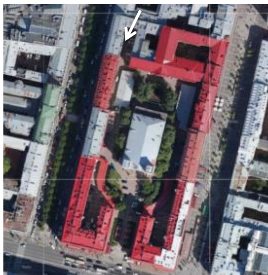
42. Фрагмент фасада дома № 10 по Большой Конюшенной ул. со стороны двора
