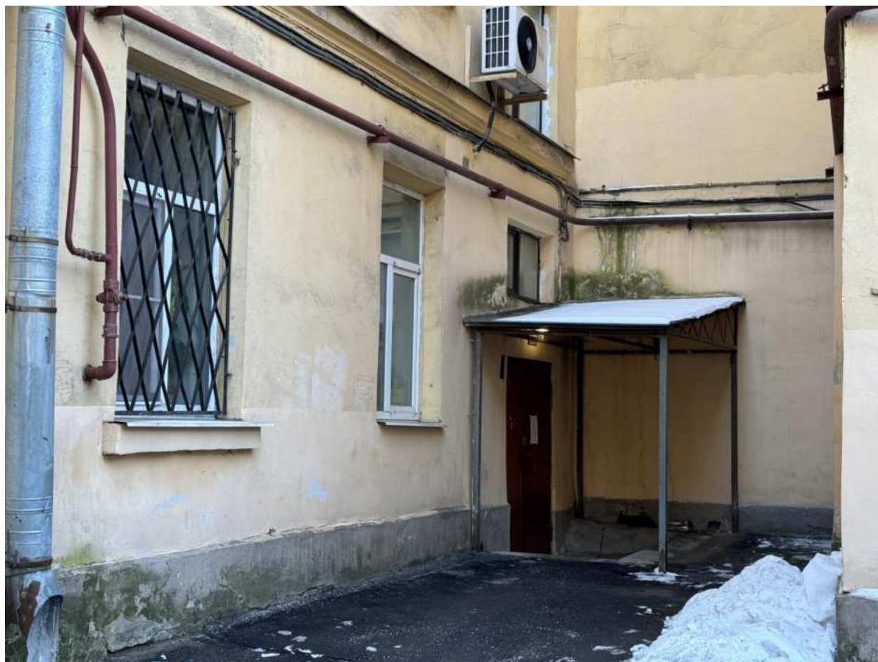
Фото 7. Фрагмент дворового фасада объекта культурного наследия.
