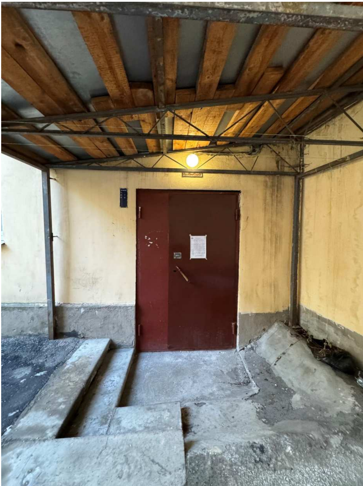
Фото 8. Вид на дверное заполнение, через которое осуществляется вход на лестницу объекта культурного наследия.
