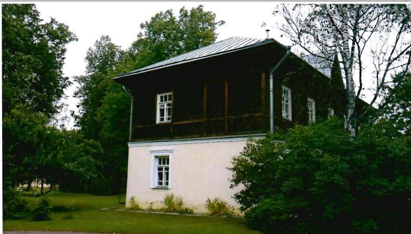
Фото 4. Западный фасад. Общий вид. 14.07.2017.
