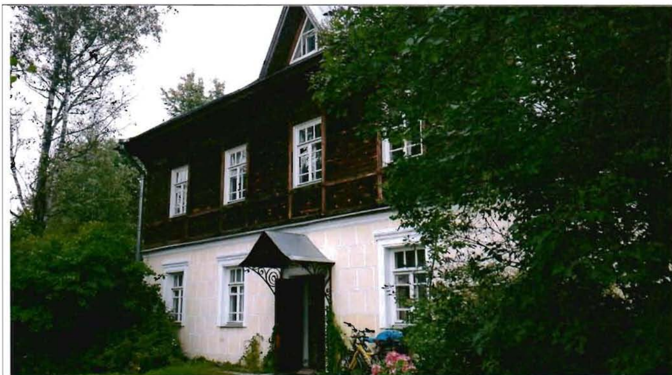
Фото 1. Южный фасад. Общий вид. 14.07.2017.
