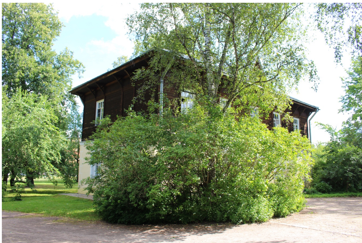
3. Вид с юго-запада
