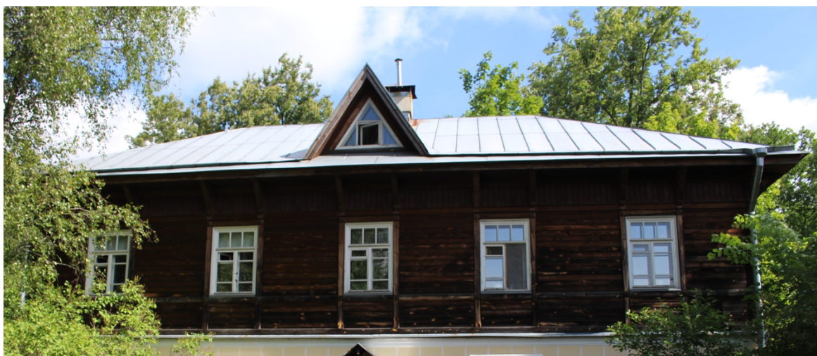
5. Фрагмент южного фасада
