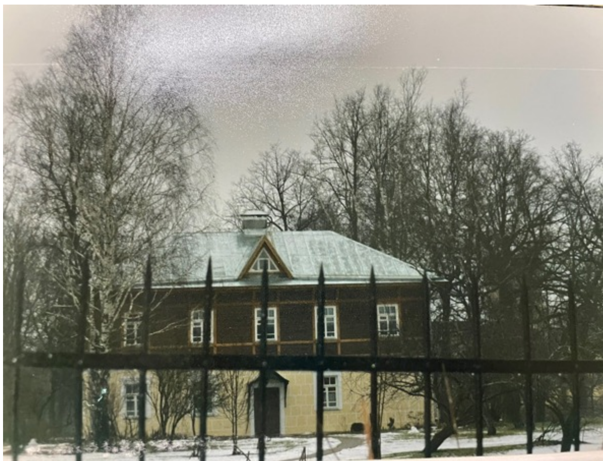
25. Дом Павловского дворцового правления (архитекторский). 2004 г. Архив КГИОП Паспорт объекта культурного наследия федерального значения «Парк «Мариенталь»
