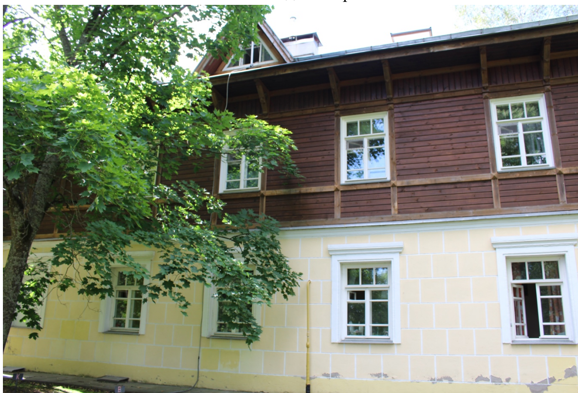
9. Фрагмент северного фасада
