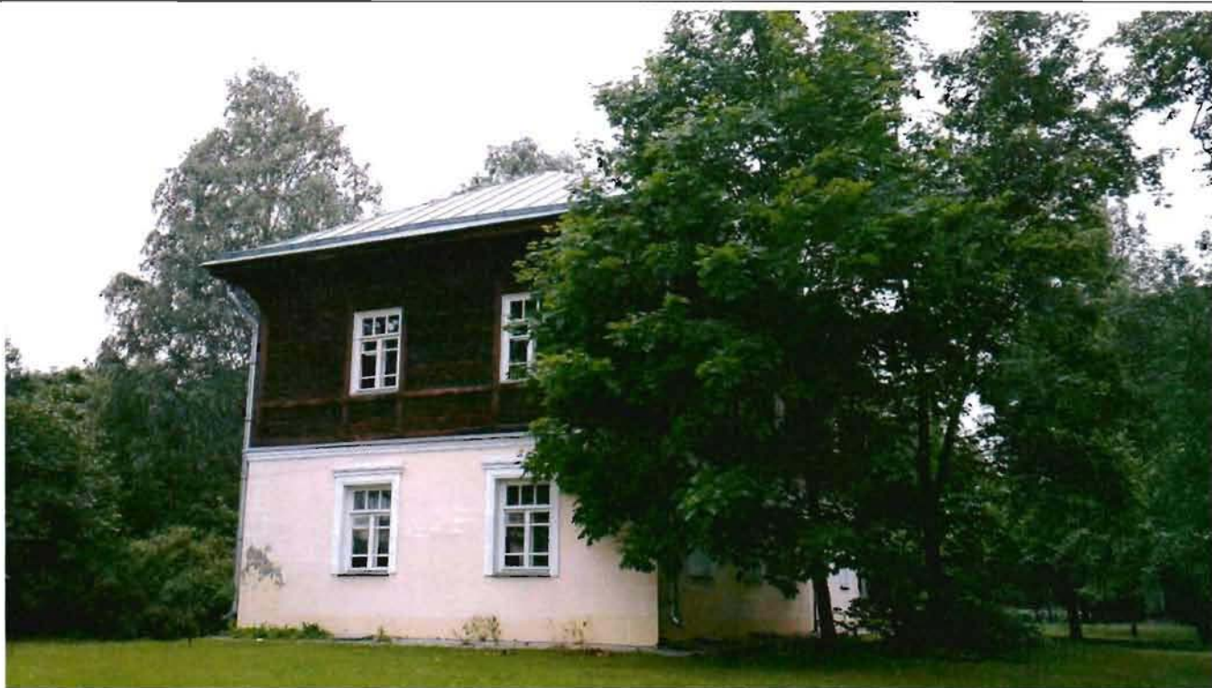
Фото 3. Восточный фасад. Общий вид. 14.07.2017.
