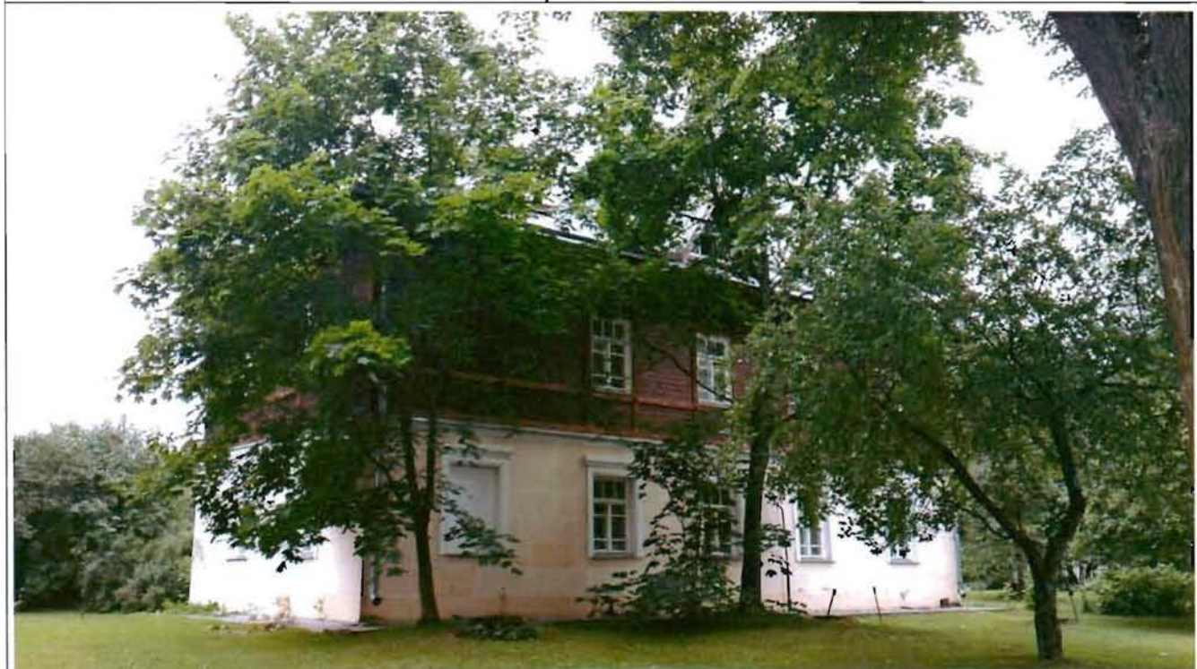
Фото 2. Северный фасад. Общий вид. 14.07.2017.
