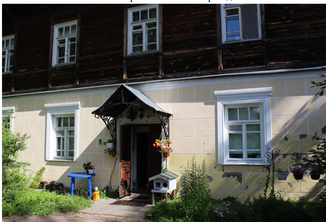
6. Фрагмент южного фасада
