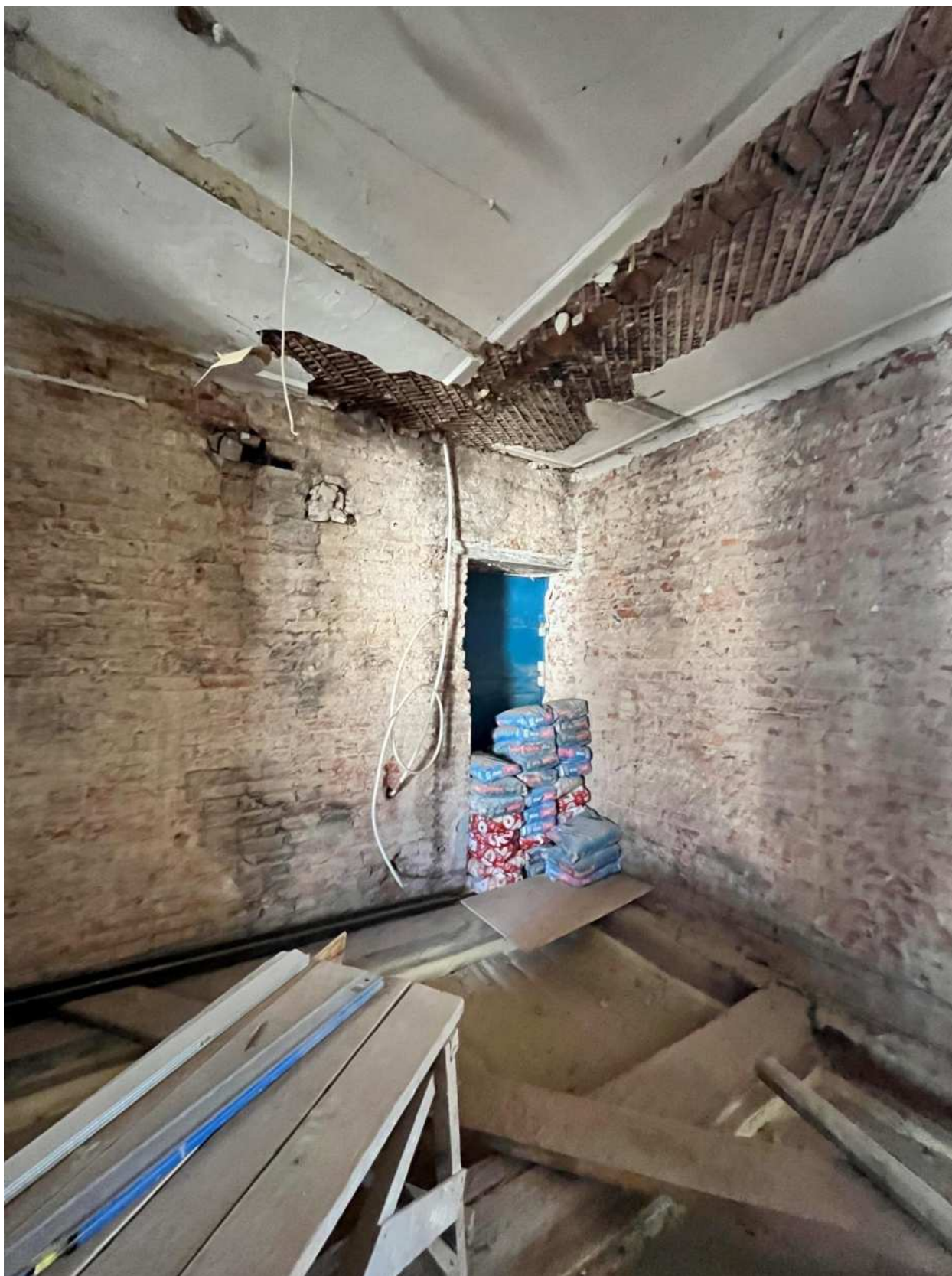
Фото 19. Вид на помещение квартиры № 81 объекта культурного наследия.
