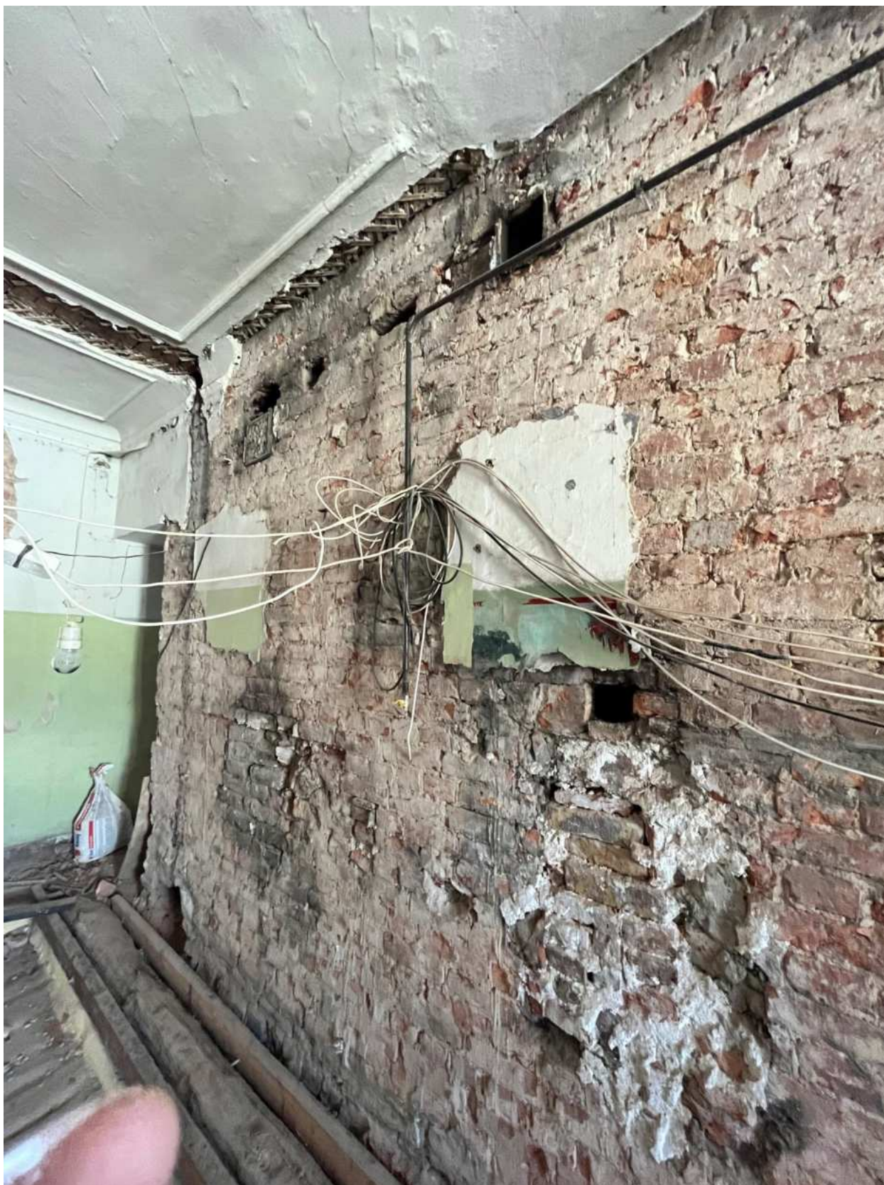
Фото 17. Вид на помещение квартиры № 81 объекта культурного наследия.
