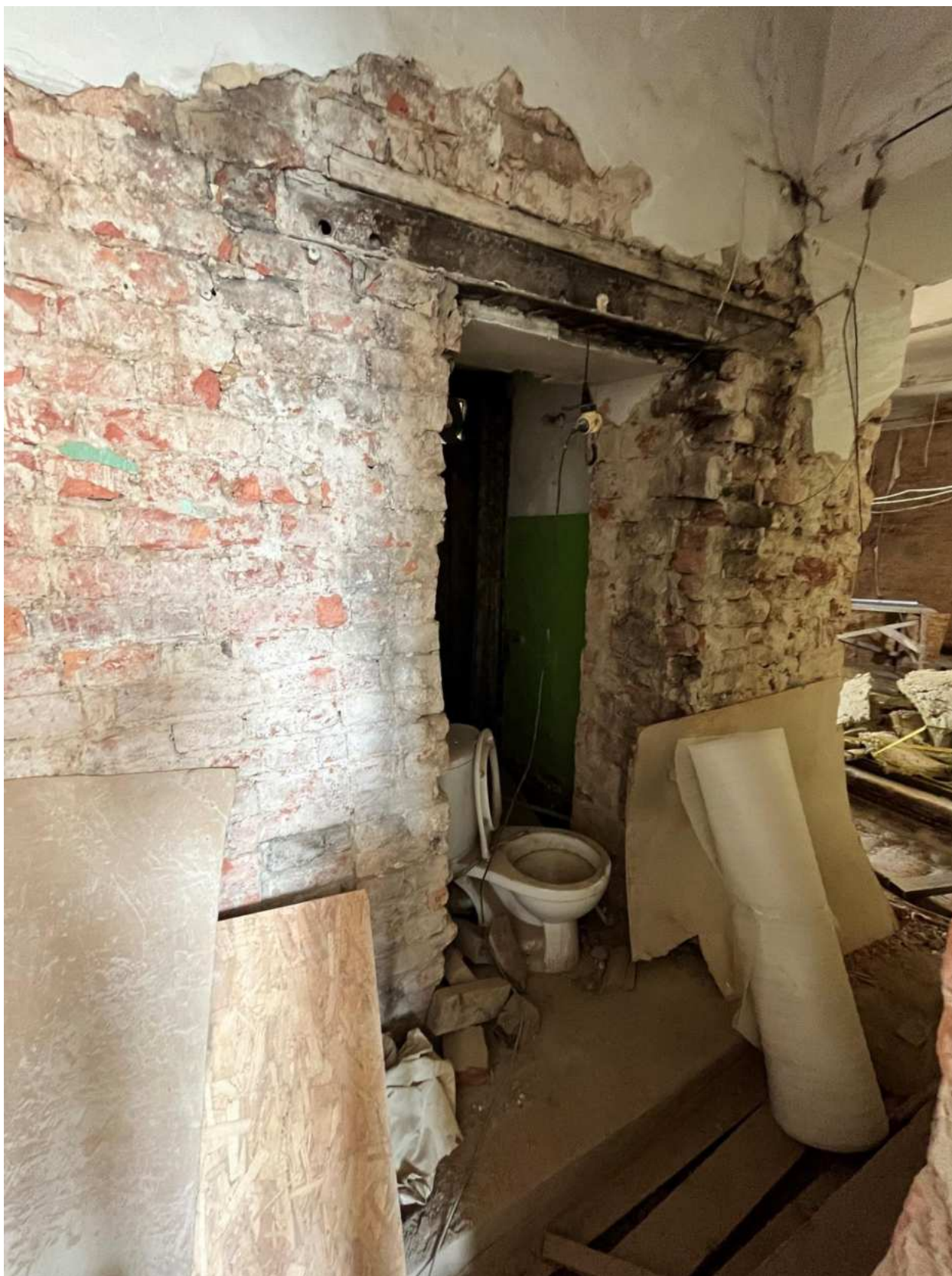
Фото 28. Вид на помещение квартиры № 81 объекта культурного наследия.
