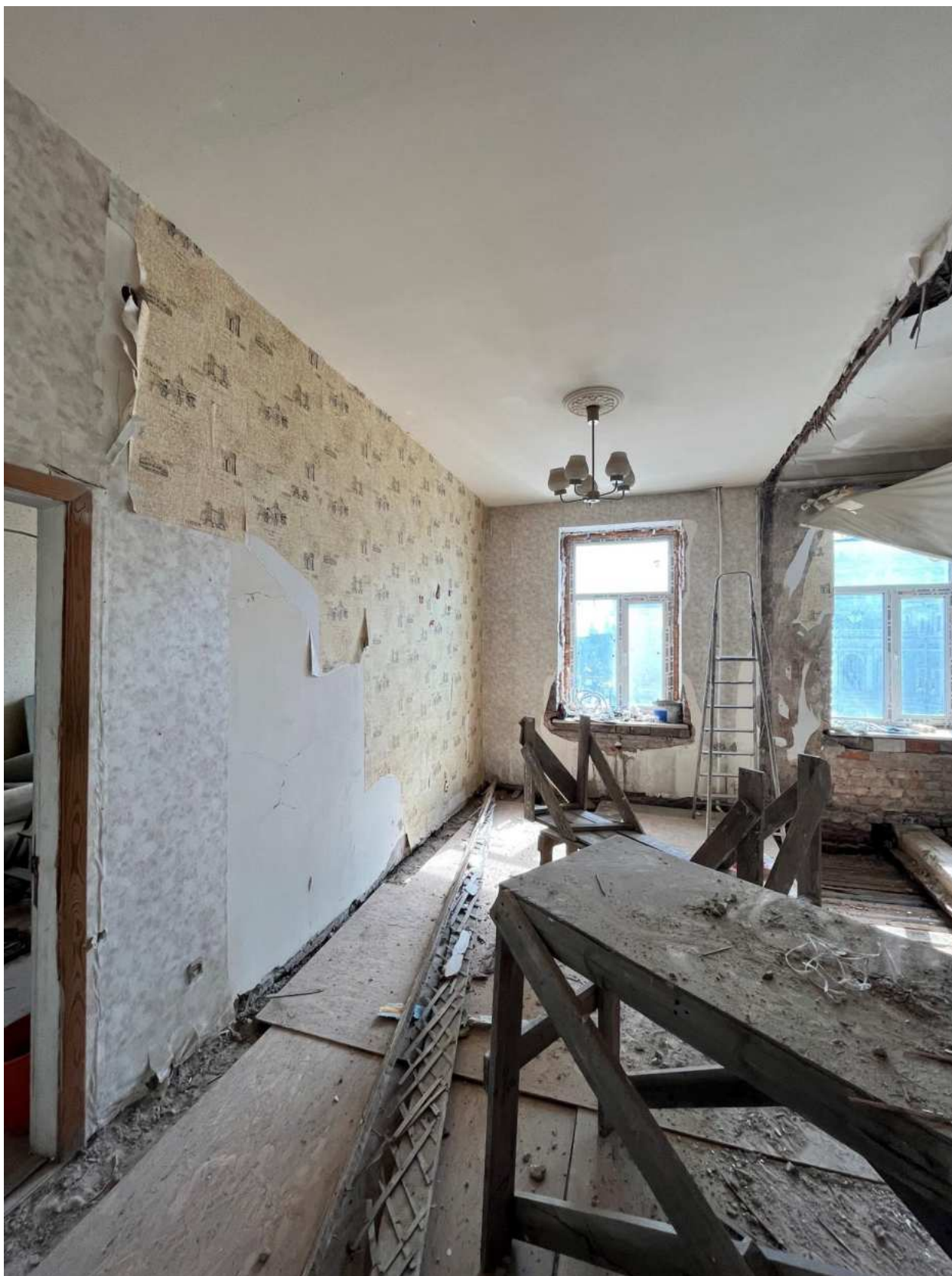
Фото 21. Вид на помещение квартиры № 81 объекта культурного наследия.
