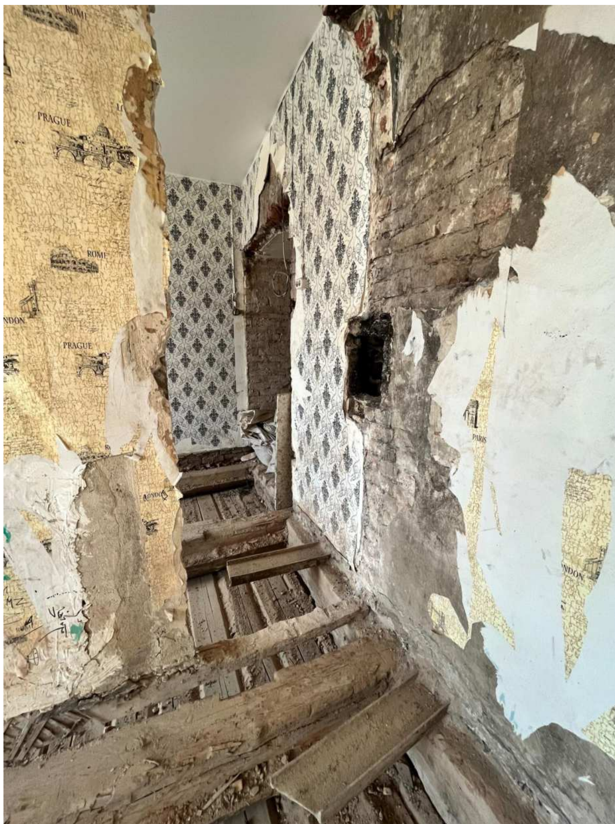
Фото 25. Вид на помещение квартиры № 81 объекта культурного наследия.
