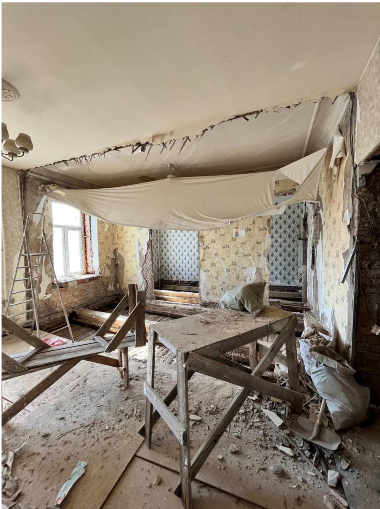
Фото 24. Вид на помещение квартиры № 81 объекта культурного наследия.
