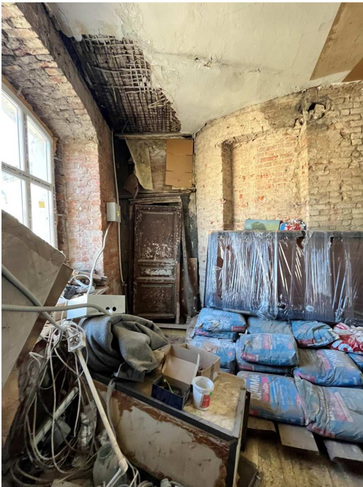
Фото 14. Вид на помещение квартиры № 81 объекта культурного наследия.
