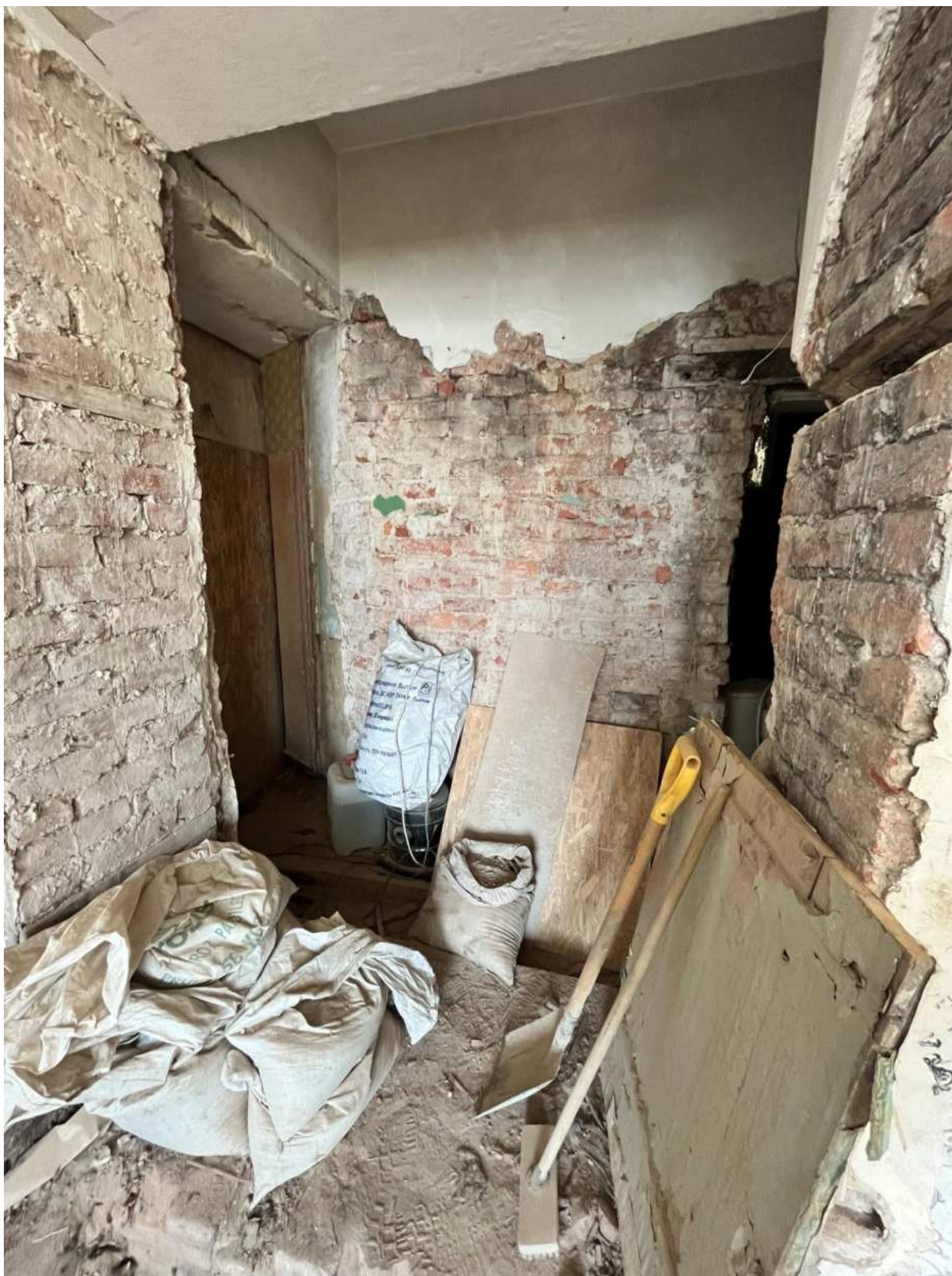
Фото 27. Вид на помещение квартиры № 81 объекта культурного наследия.
