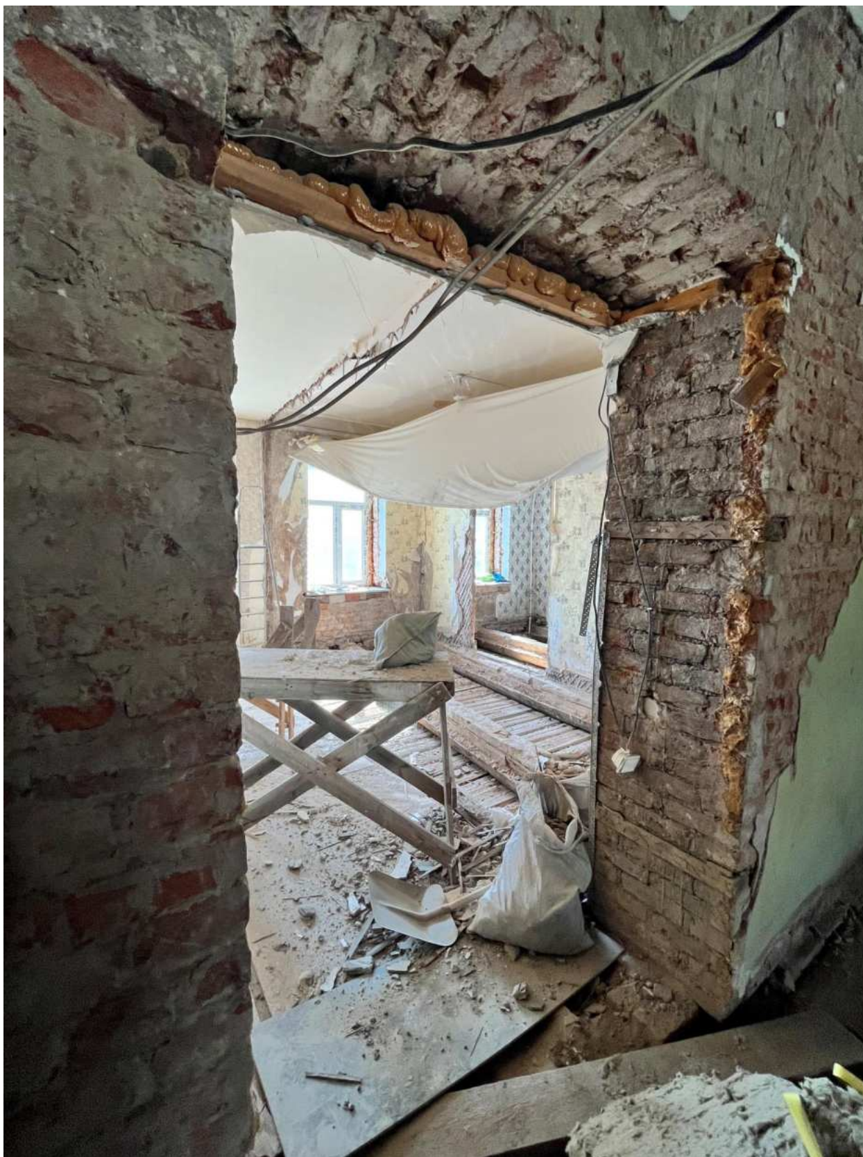
Фото 20. Вид на помещение квартиры № 81 объекта культурного наследия.
