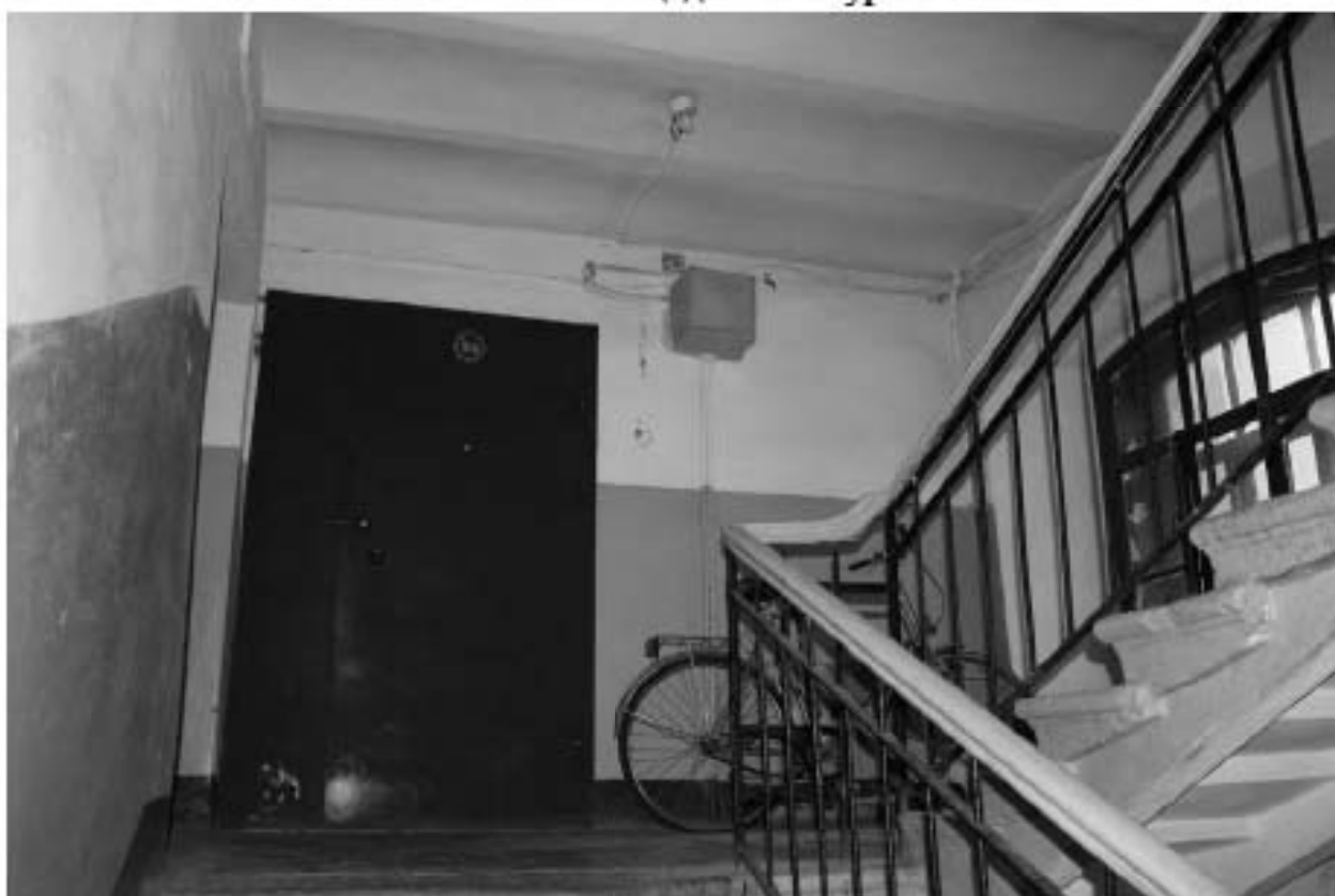
Фото 282. Лестничная площадка Л-2 в уровне 4-го этажа.
