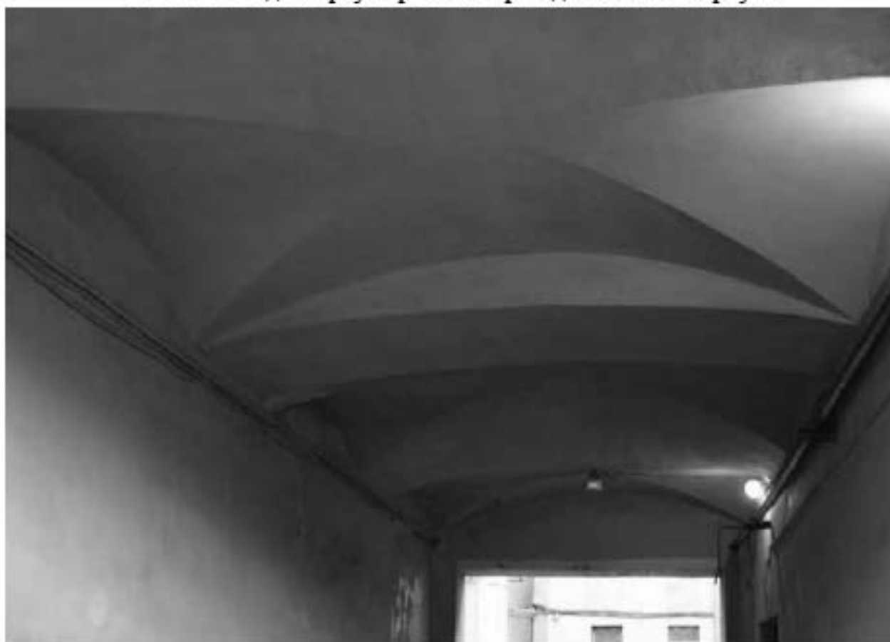
Фото 219. Вид на своды перекрытия арки воротного проезда.
