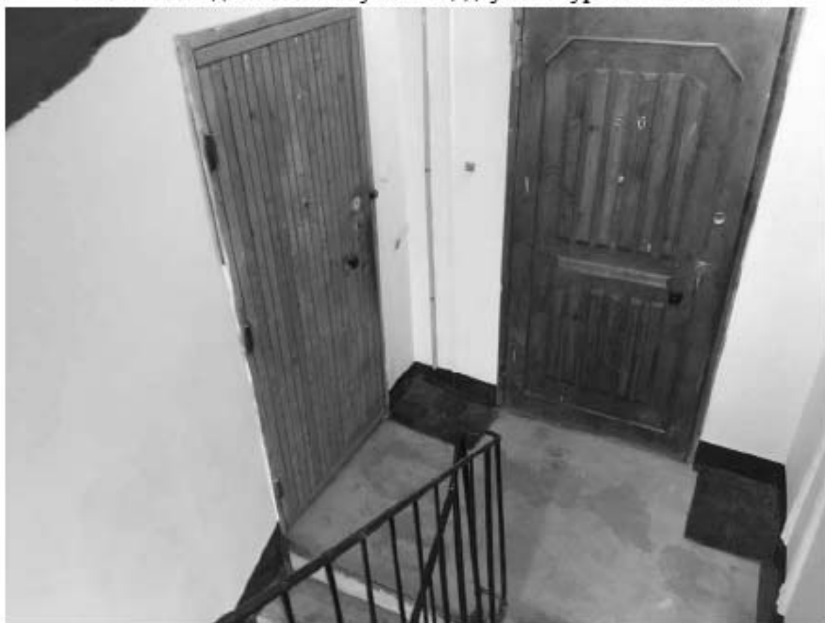
Фото 368. Вид на лестничную площадку Л-5 в уровне 3-го этажа.
