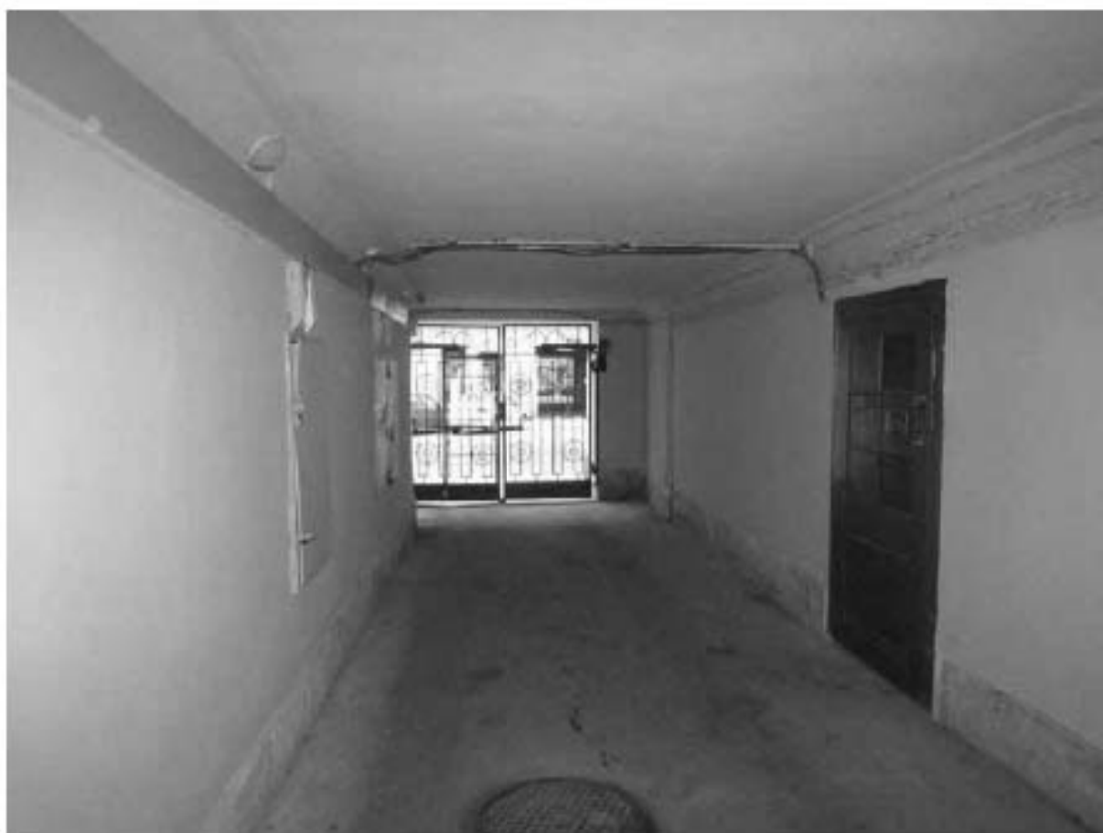
Фото 109. Арка воротного проезда в южном корпусе, вид с дворовой территории.
