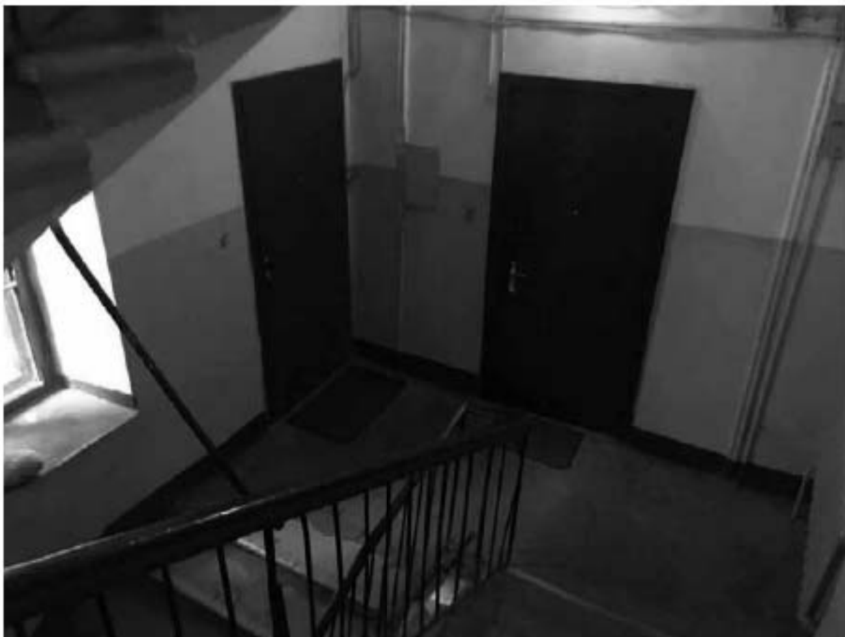
Фото 363. Лестничная площадка Л-3 в уровне 4-го этажа.
