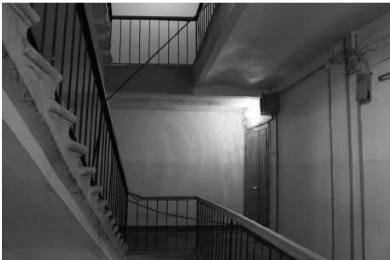
Фото 285. Лестница Л-3 в уровне 4-го – 5-го этажей.
