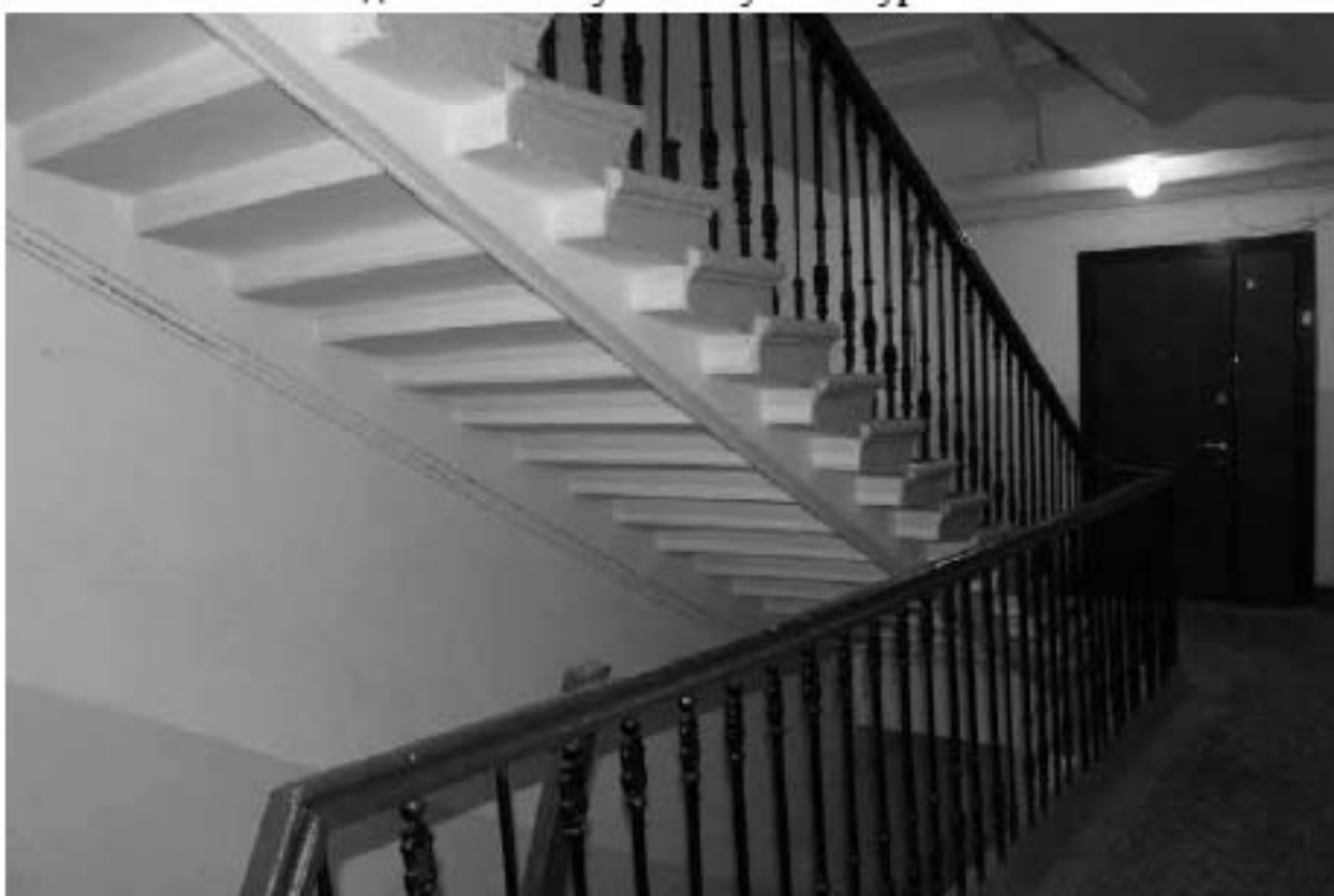
Фото 100. Вид на лестницу 4ЛК в уровне 3-го этажа.
