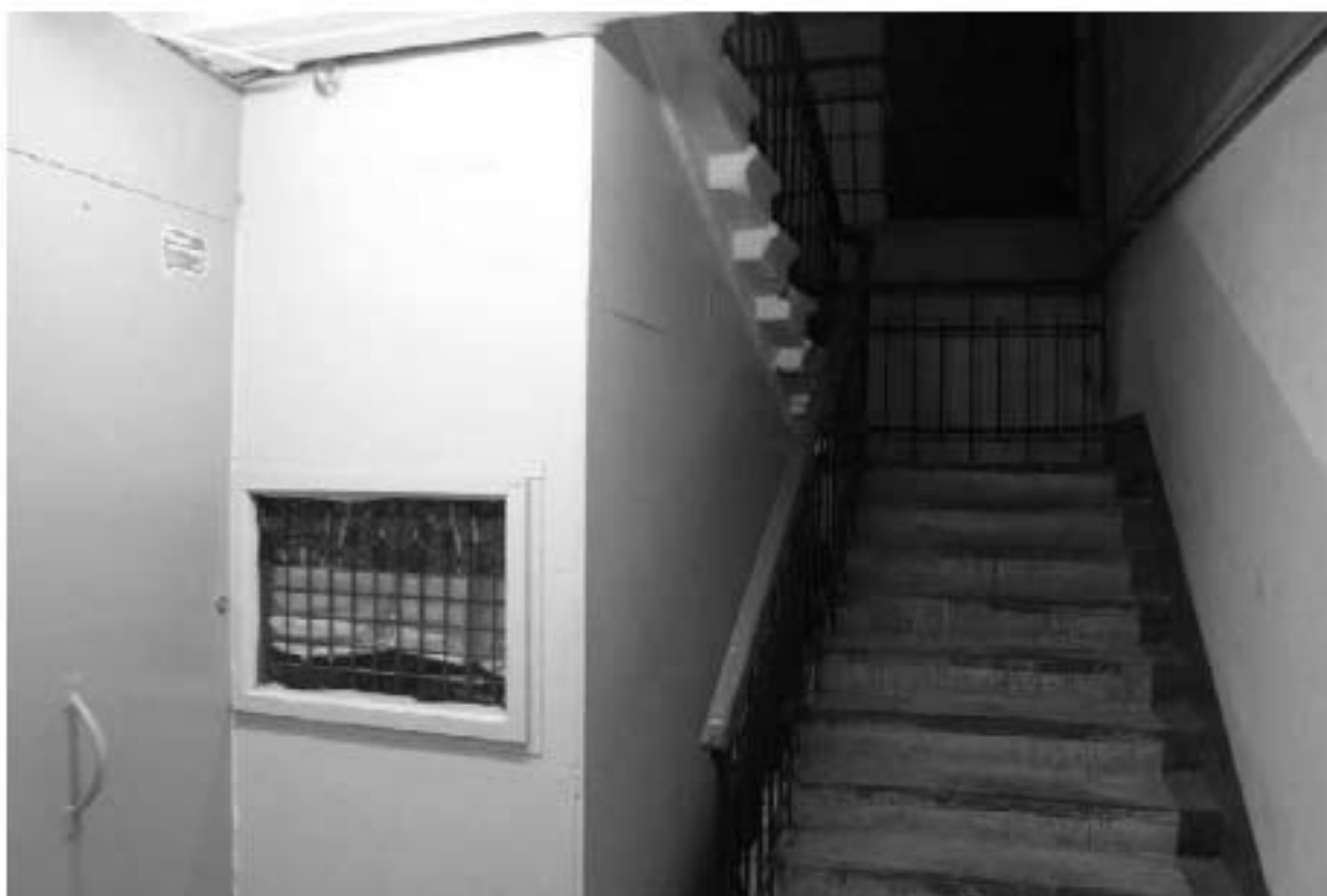
Фото 79. Вид на лестницу 1ЛК в уровне 1-го этажа.
