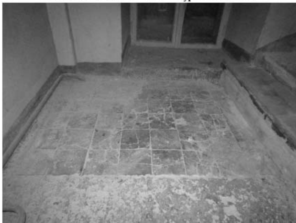
Фото 350. Сохранившиеся фрагменты плитки на лестнице Л-1 в уровне 1-го этажа.
