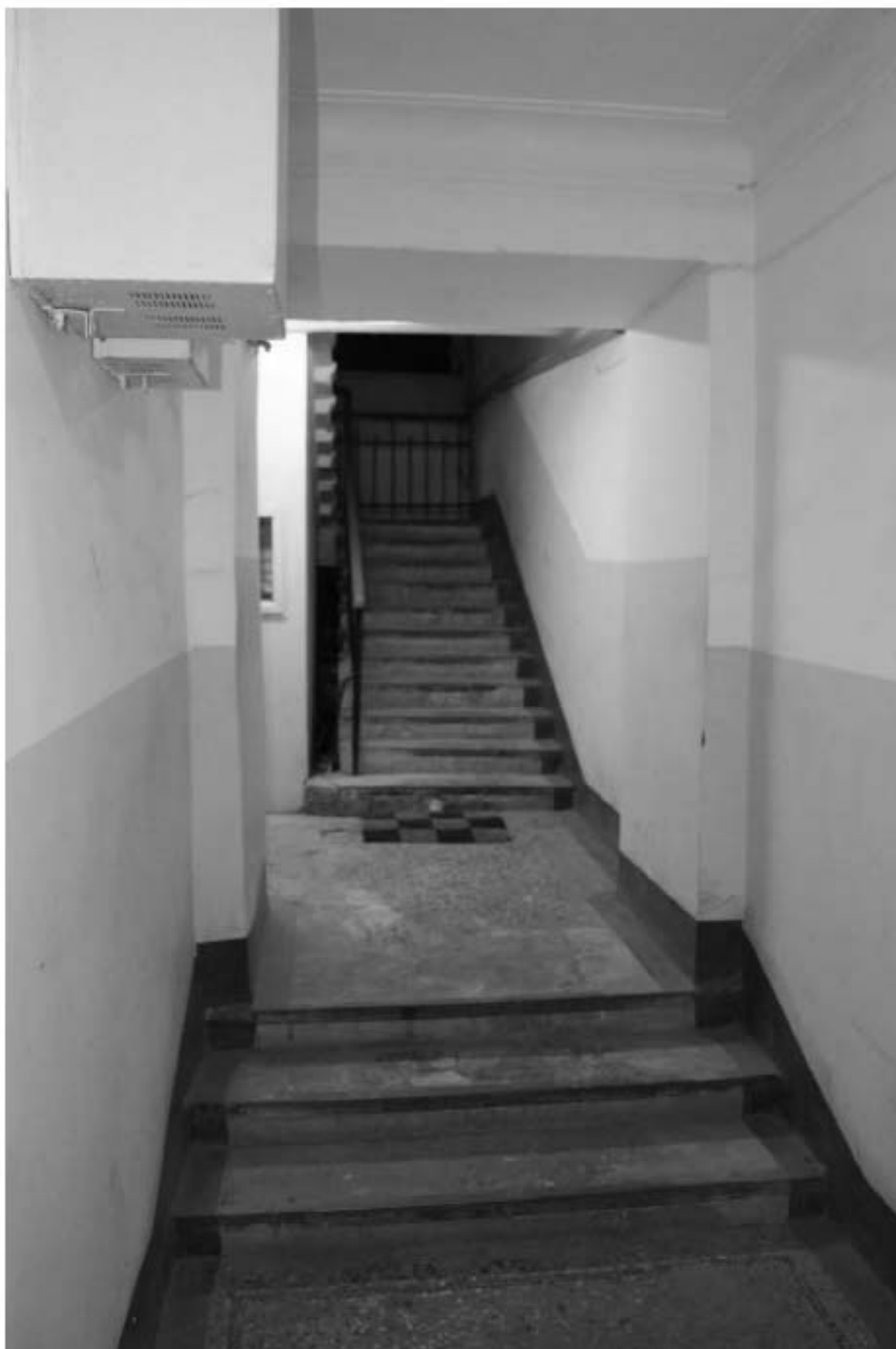
Фото 78. Вид на арку в вестибюле 1ЛК.
