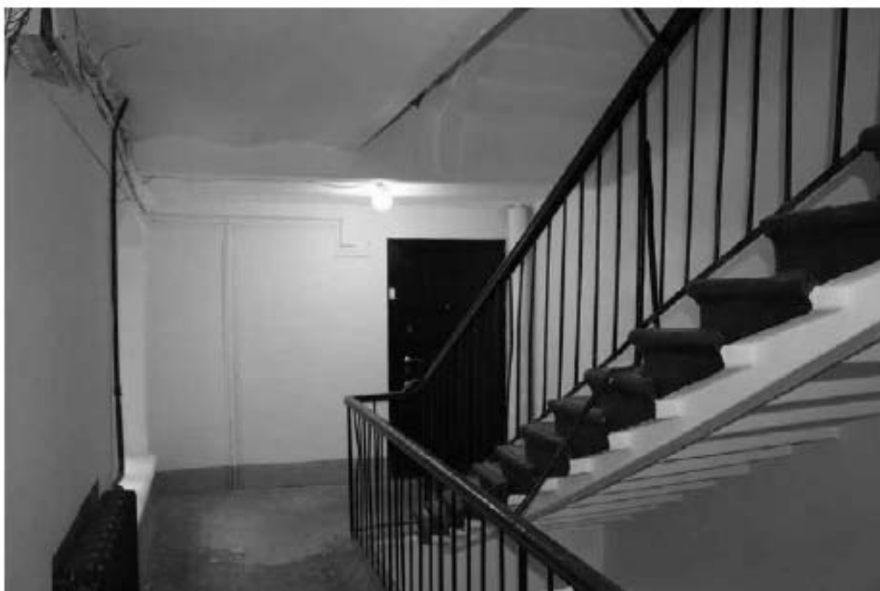
Фото 200. Вид на лестничную площадку 2ЛК в уровне 2-го этажа.
