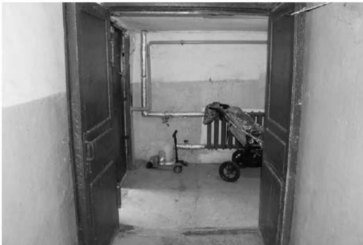
Фото 117. Вид на тамбур лестничной клетки 1ЛК.
