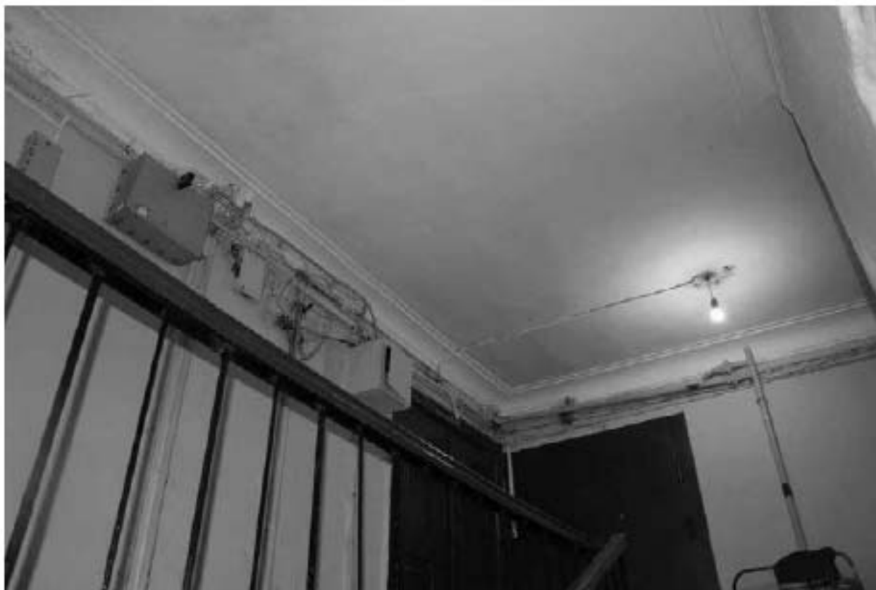
Фото 90. Вид на потолок лестничной клетки 1ЛК в уровне 6-го этажа.
