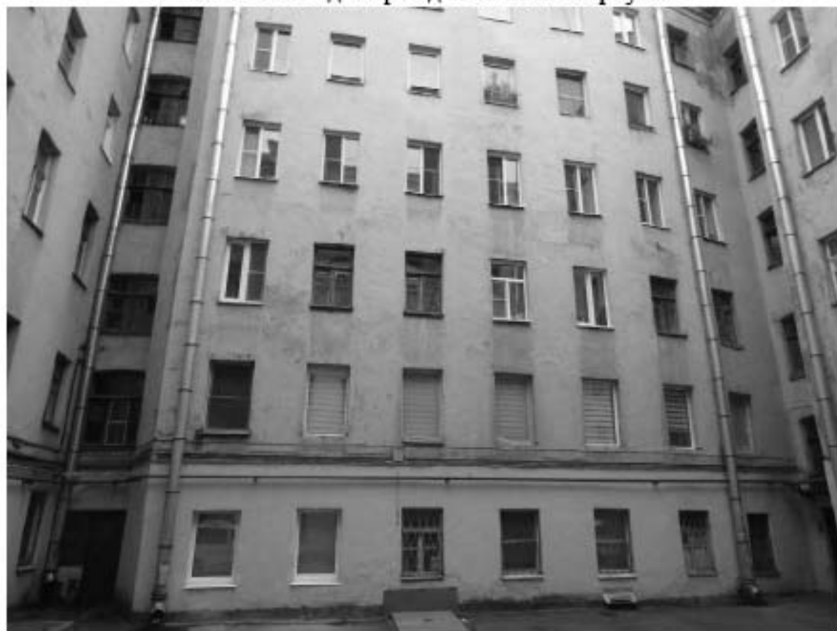
Фото 268. Вид на фасад западного корпуса.
