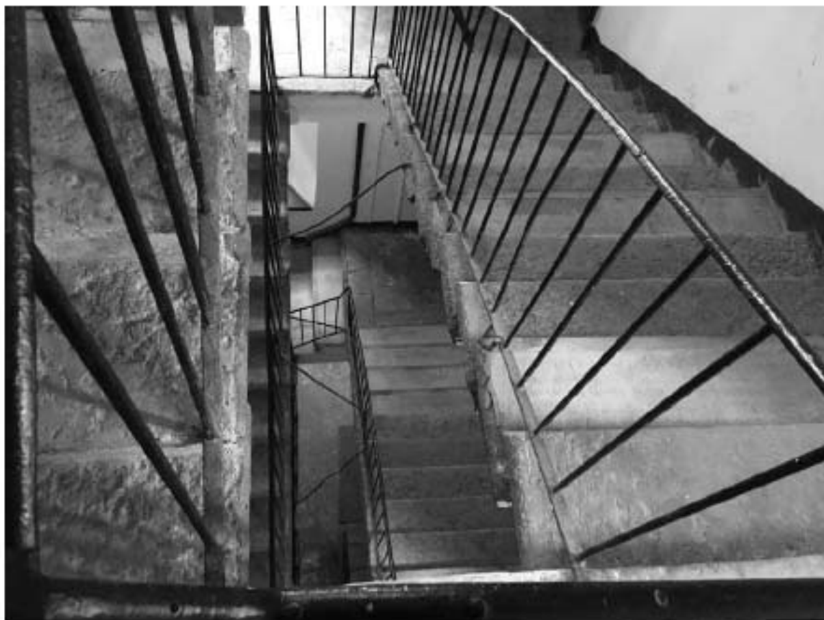
Фото 319. Вид на лестничную клетку Л-3 с 3-го этажа.
