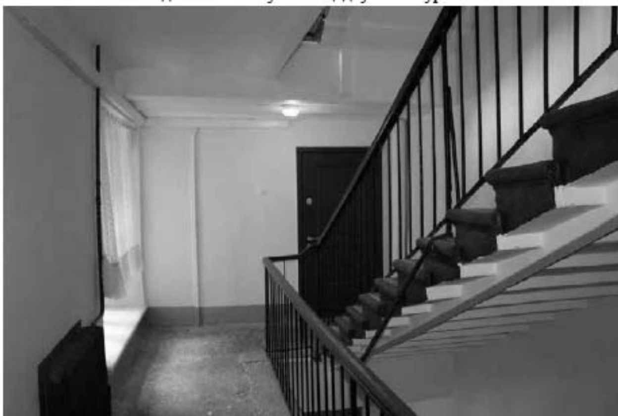
Фото 201. Вид на лестничную площадку 2ЛК в уровне 4-го этажа.
