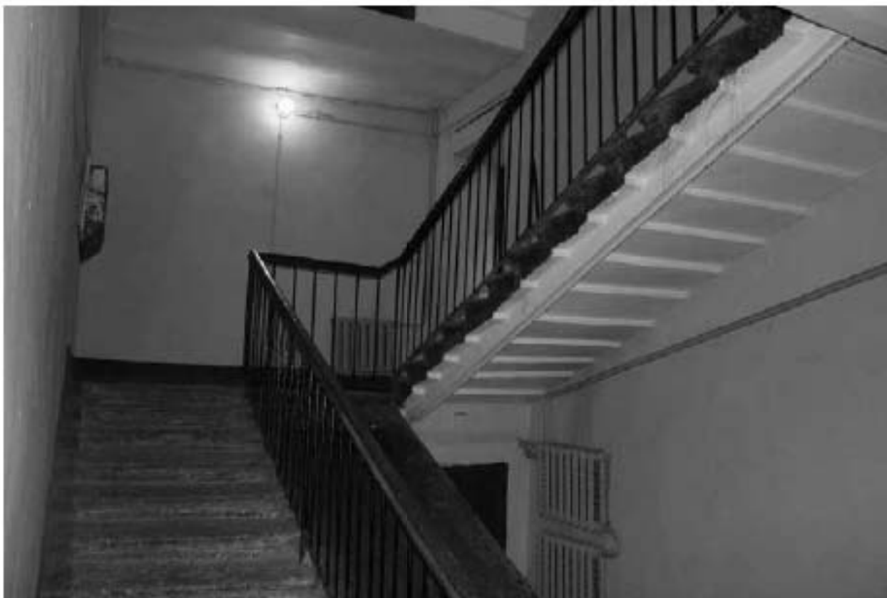
Фото 225. Вид на лестницу Л-1 в уровне 1-го этажа.
