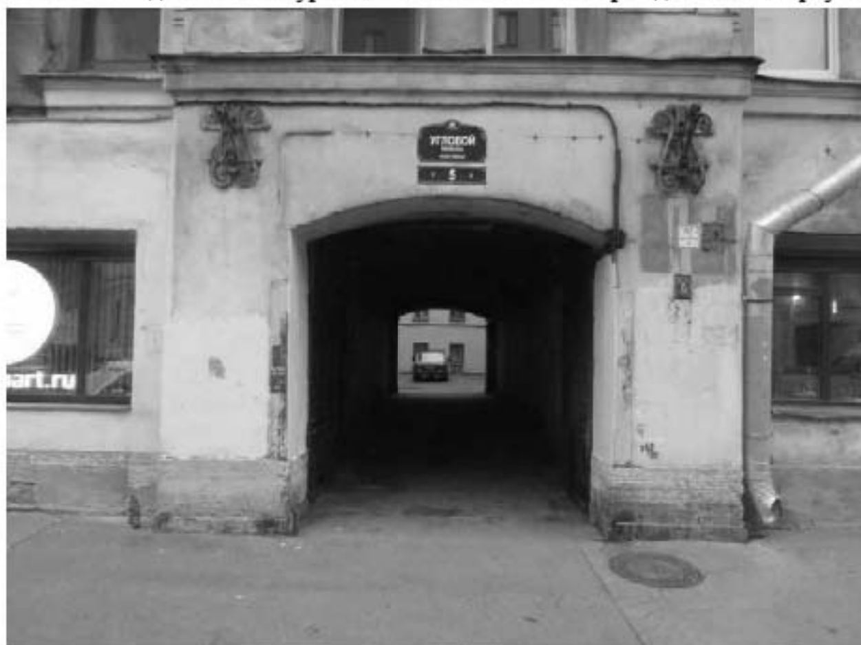
Фото 179. Вид на арку воротного проезда в южном корпусе.
