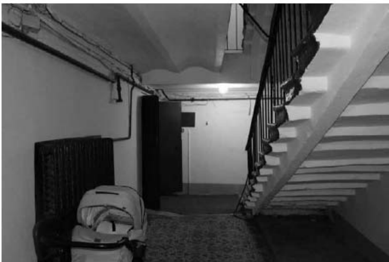
Фото 198. Вид на лестничную клетку 2ЛК в уровне 1-го этажа.
