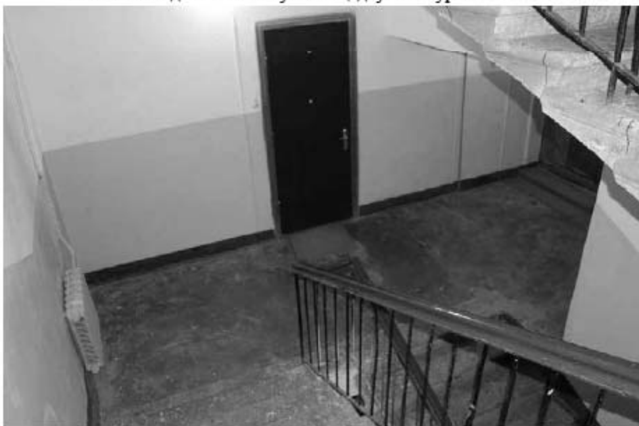
Фото 258. Вид на лестничную площадку Л-5 в уровне 4-го этажа.
