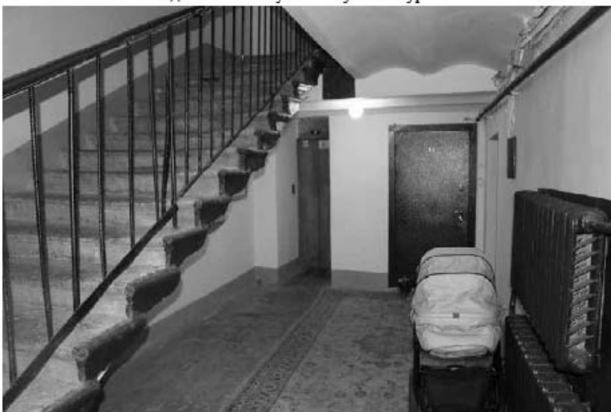
Фото 199. Вид на лестничную клетку 2ЛК в уровне 1-го этажа.
