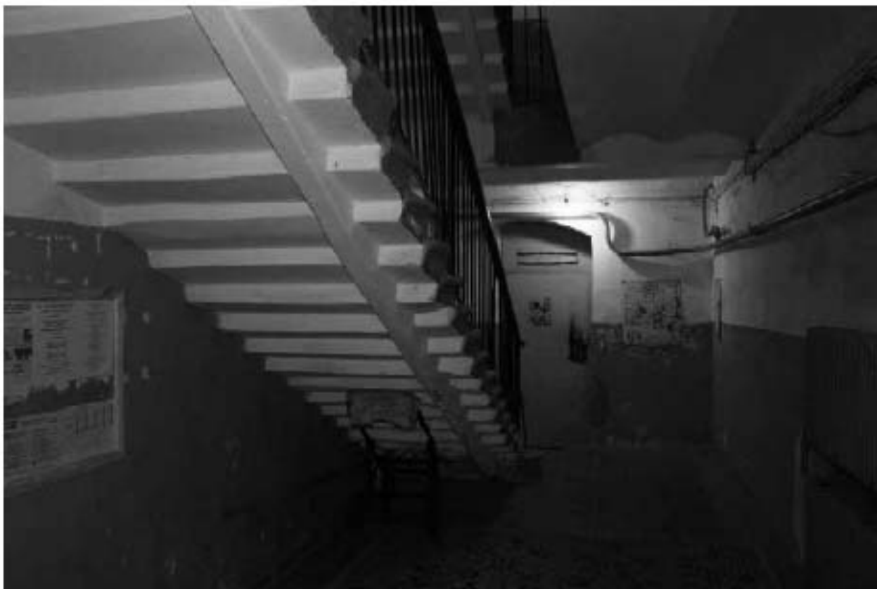
Фото 208. Вид на лестничную клетку 4ЛК в уровне 1-го этажа.
