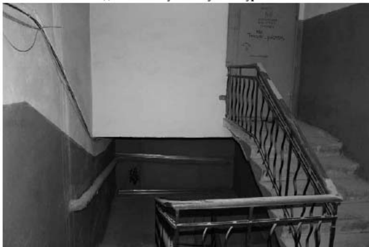
Фото 213. Вид на лестничную клетку 4ЛК в уровне 6-го этажа.
