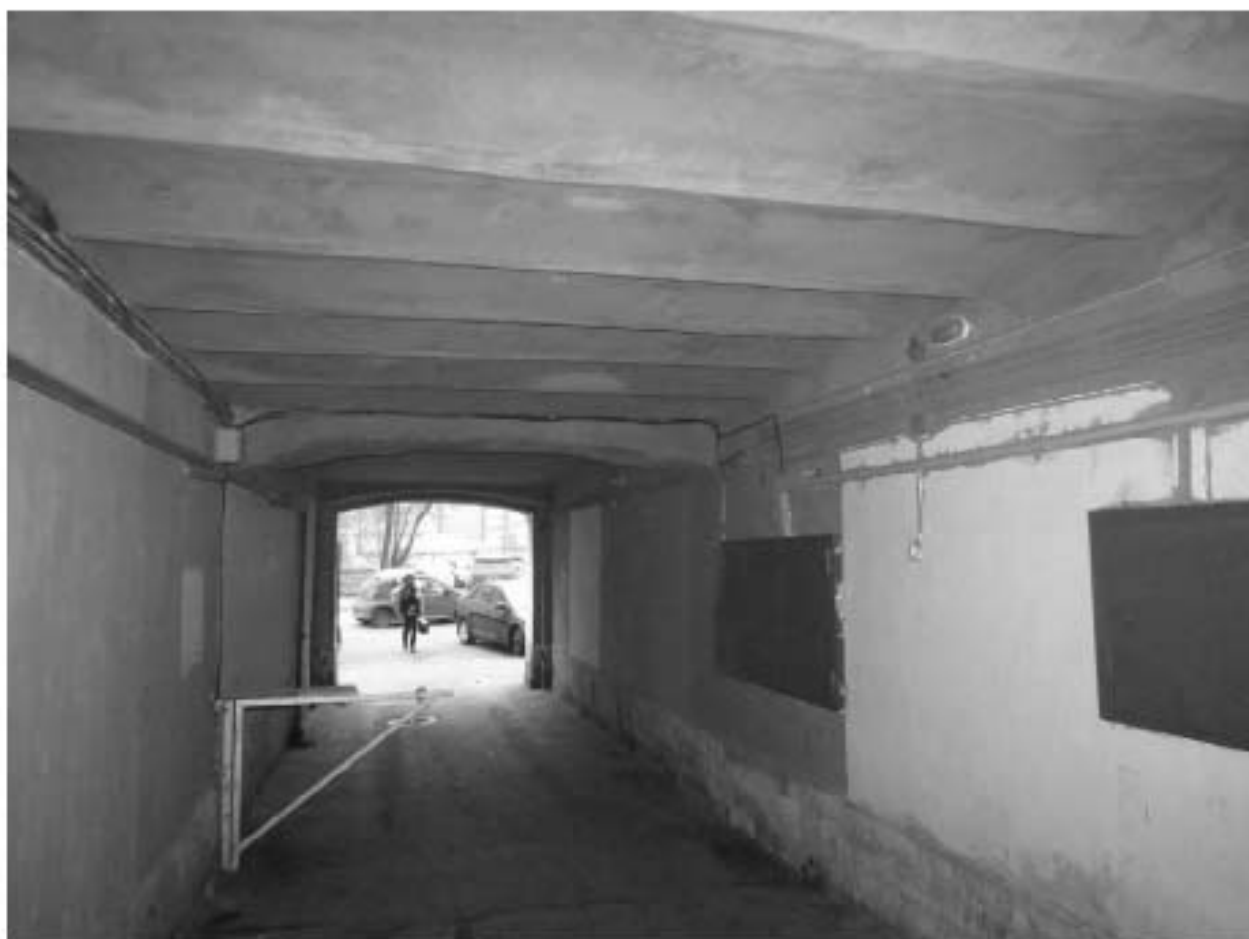
Фото 265. Вид на арку воротного проезда в южном корпусе со стороны двора.
