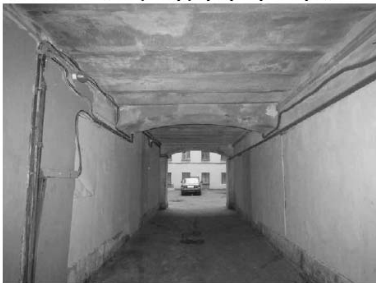
Фото 183. Арка воротного проезда южного корпуса, вид с Углового переулка.
