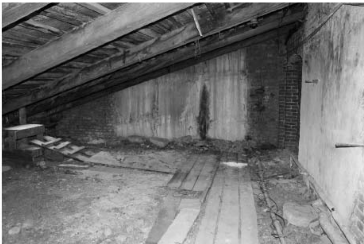
Фото 174. Вид на чердачные помещения.
