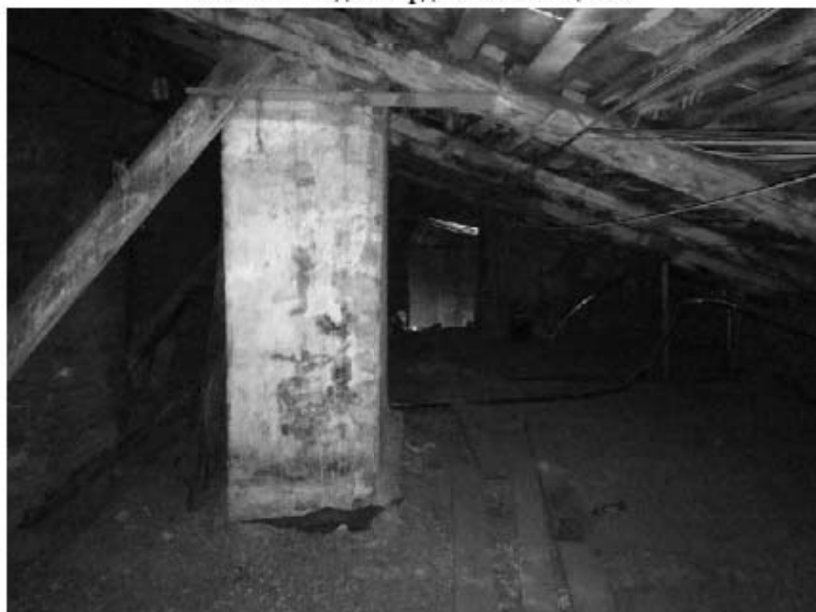
Фото 330. Вид на чердачные помещения.
