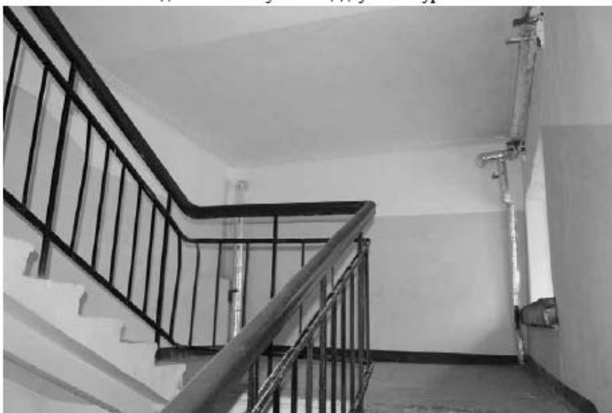
Фото 143. Вид на лестничную площадку 5ЛК в уровне 6-го этажа.
