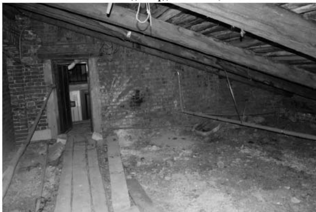
Фото 175. Вид на чердачные помещения.
