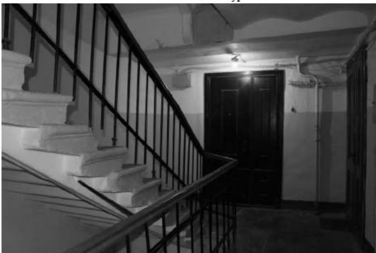
Фото 169. Лестничная клетка 4ЛК в уровне 2-го этажа.
