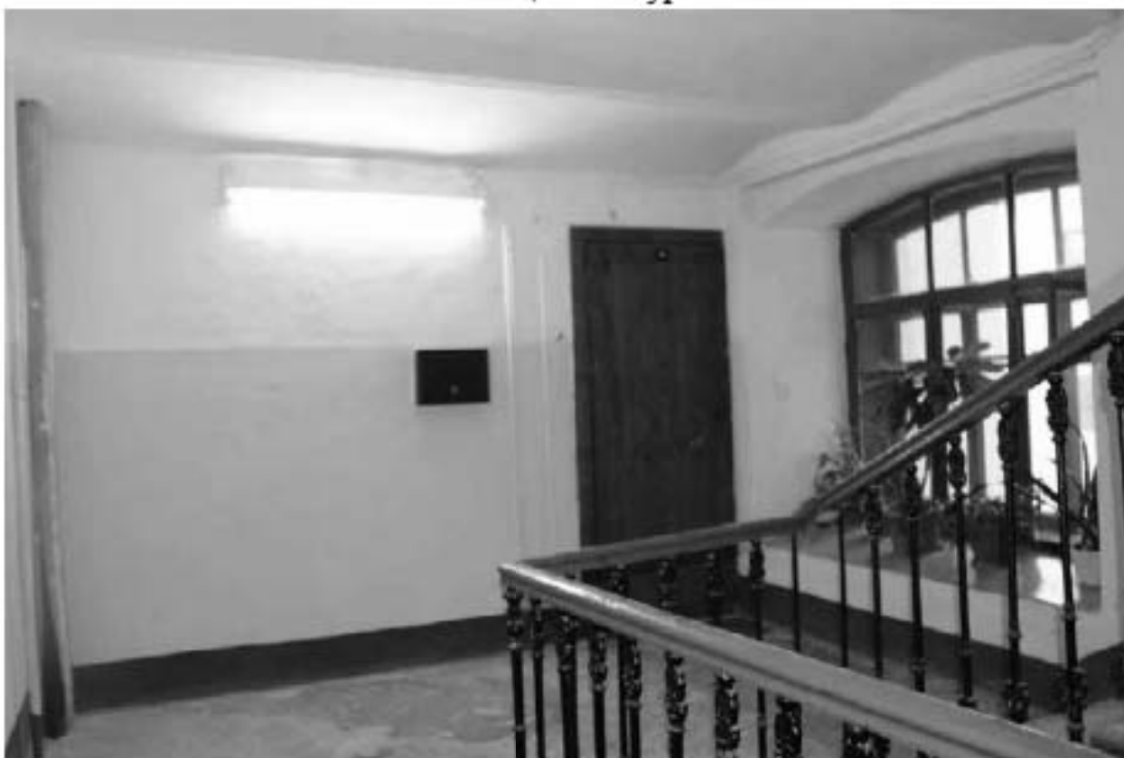
Фото 52. Вид на лестничную площадку Л-3 в уровне 5-го этажа.
