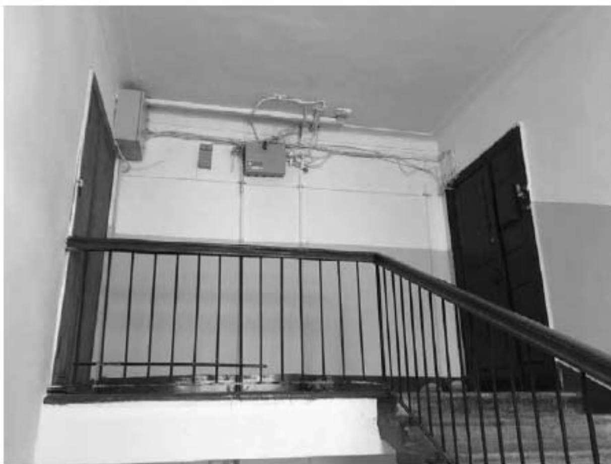
Фото 317. Вид на лестничную площадку Л-2 в уровне 5-го этажа.
