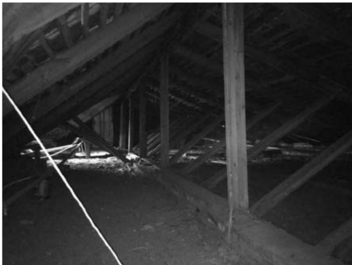
Фото 371. Вид на чердачные помещения.
