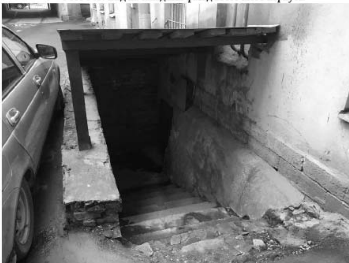
Фото 344. Вход в подвальные помещения.
