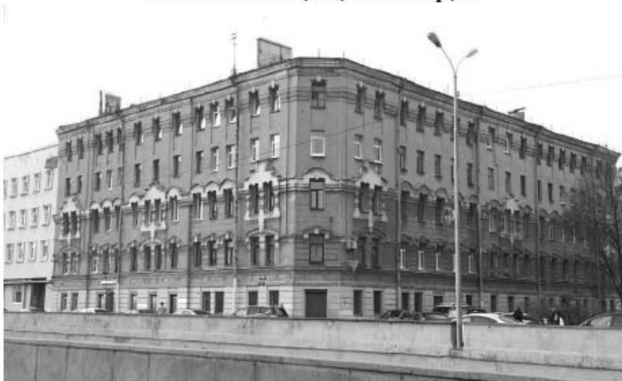
Фото 333. Вид на дом № 11 по Угловому переулку с набережной Обводного канала.
