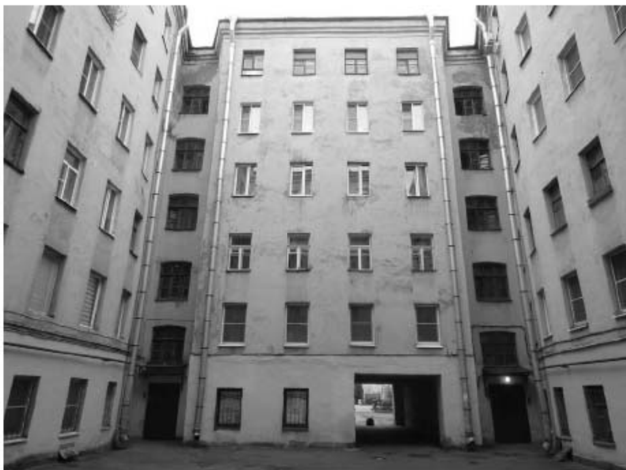
Фото 269. Вид на южный фасад северного корпуса.
