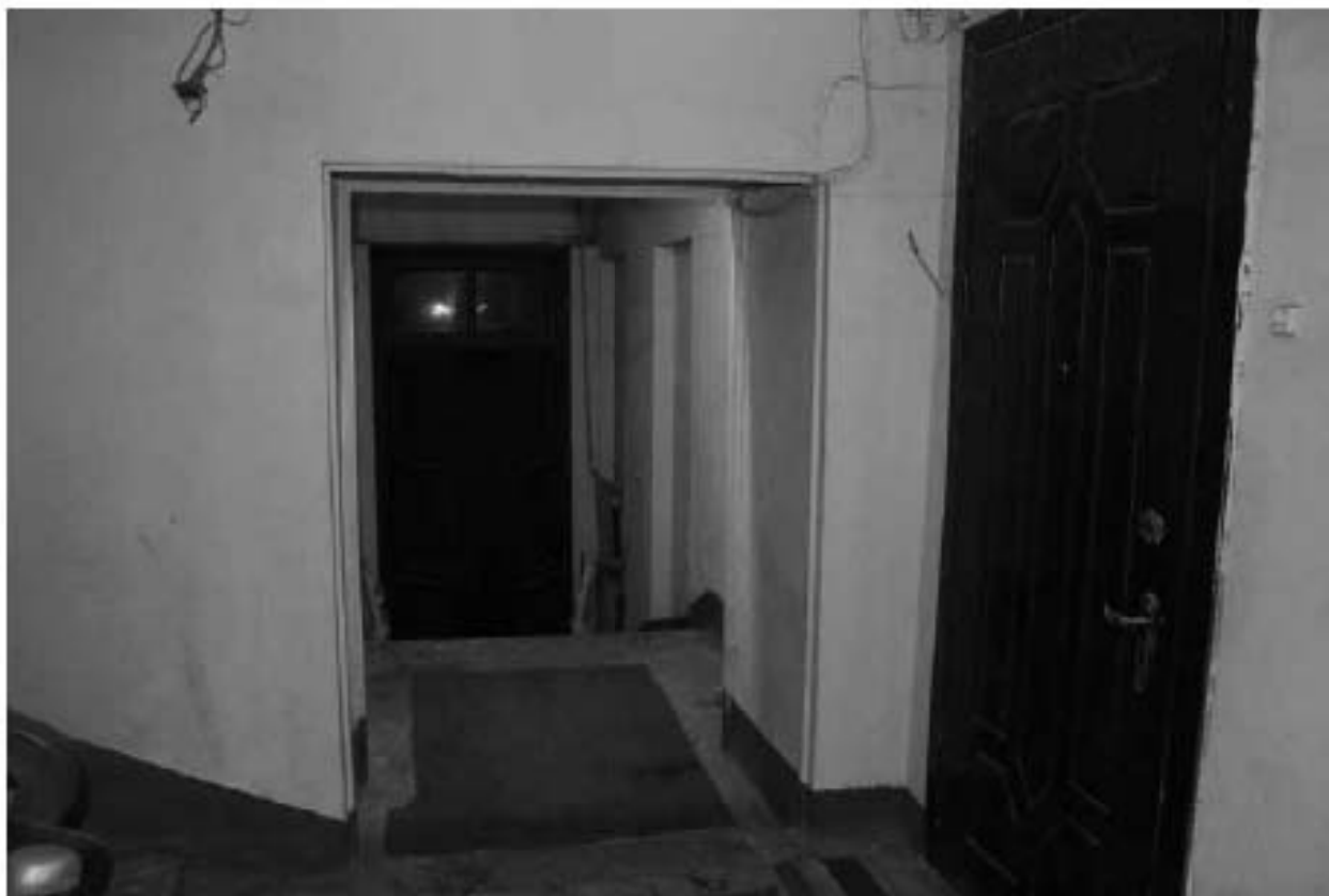
Фото 239. Вид на арку вестибюля Л-3.
