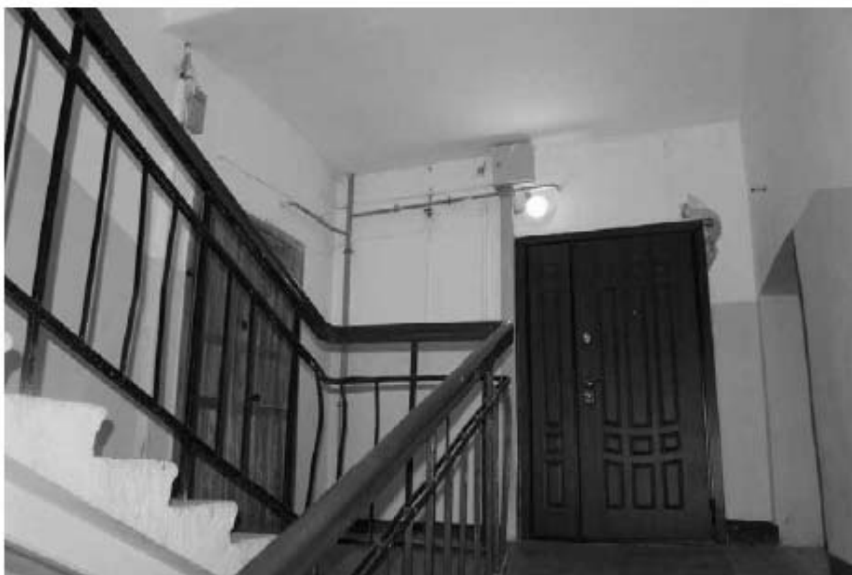
Фото 142. Вид на лестничную площадку 5ЛК в уровне 3-го этажа.
