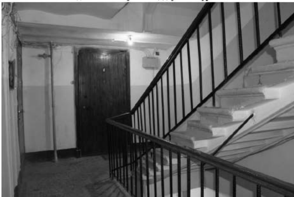
Фото 160. Вид на лестничную площадку ЗЛК в уровне 2-го этажа.
