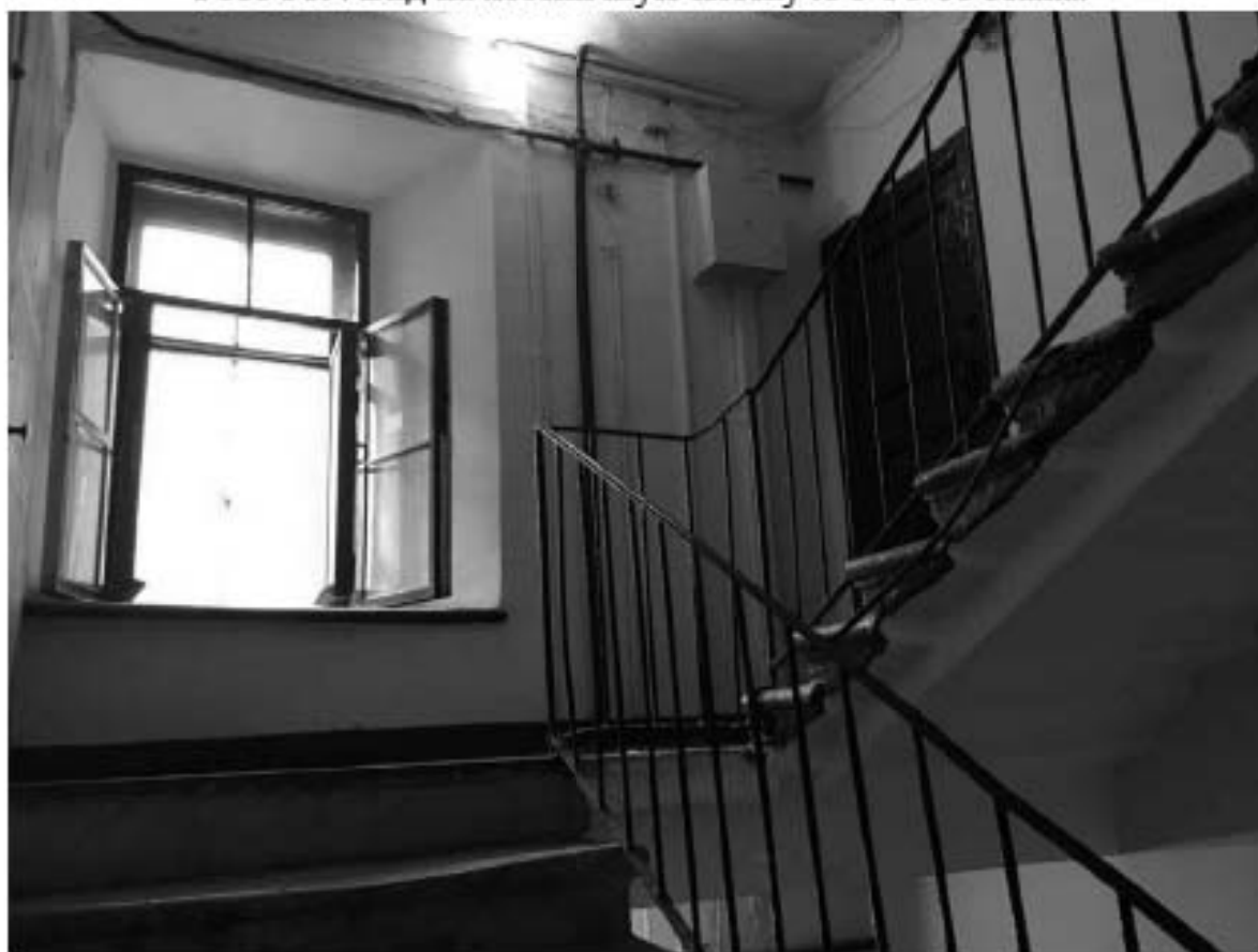
Фото 320. Вид на междуэтажную лестничную площадку Л-3 в уровне 3-го этажа.
