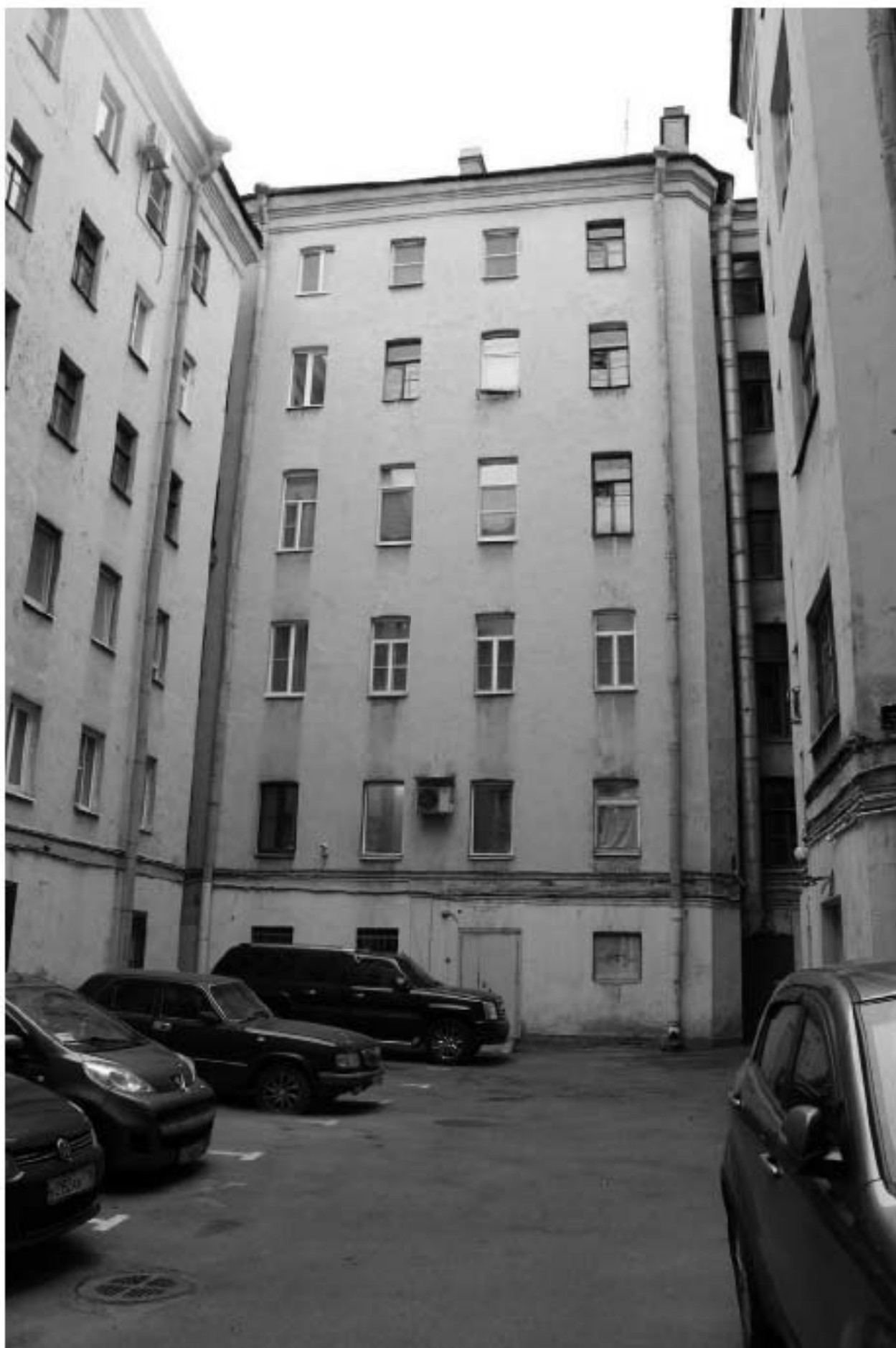
Фото 69. Вид на южный фасад северного корпуса.
