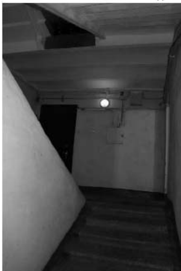
Фото 240. Вид на лестничную площадку Л-3 в уровне 1-го этажа.
