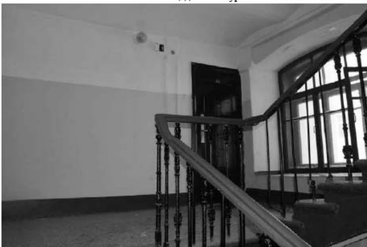
Фото 50. Вид на лестничную площадку Л-3 в уровне 4-го этажа.
