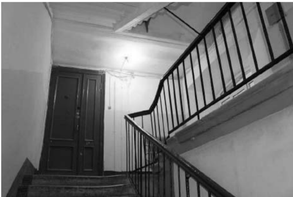
Фото 159. Вид на лестничную площадку ЗЛК в уровне 2-го этажа.
