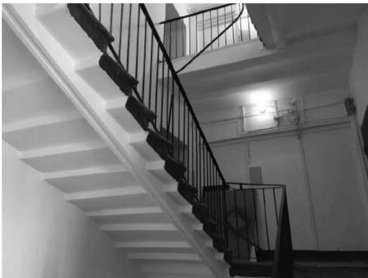
Фото 359. Вид на лестничную клетку Л-2 в уровне 4-го – 5-го этажей.
