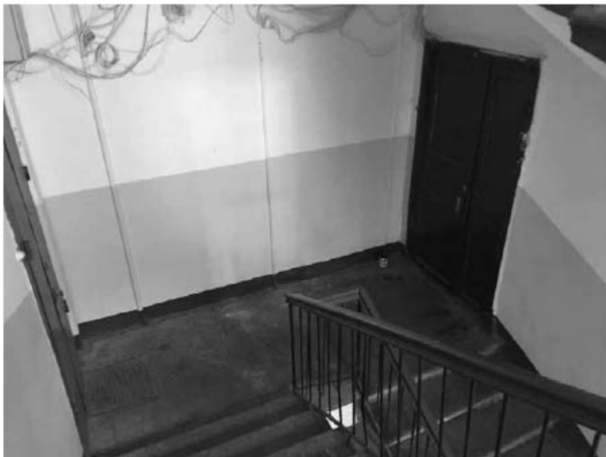
Фото 315. Вид на лестничную площадку Л-2 в уровне 3-го этажа.
