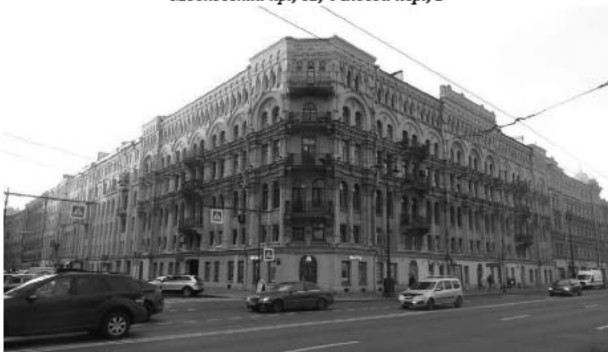
Фото 1. Вид на юго-восточный угол дома.
