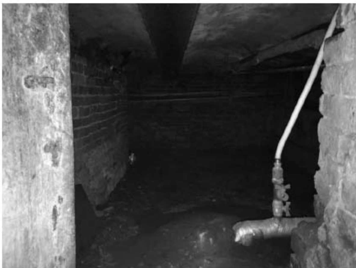
Фото 345. Вид на подвальные помещения.
