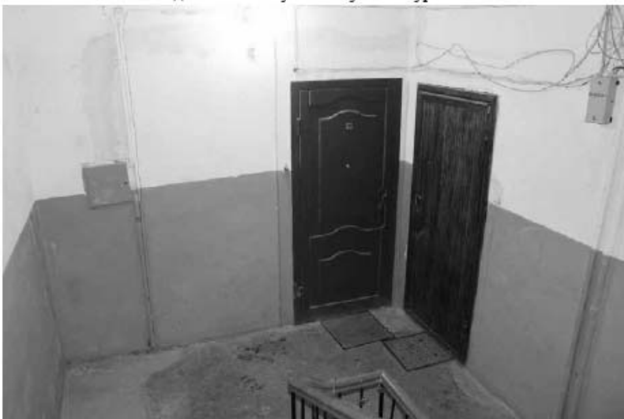
Фото 211. Вид на лестничную клетку 4ЛК в уровне 4-го этажа.
