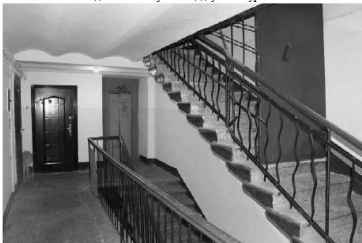
Фото 207. Вид на лестничную площадку ЗЛК в уровне 6-го этажа.
