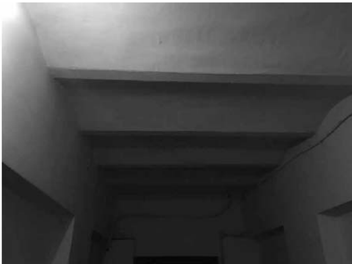
Фото 355. Вид на своды перекрытия вестибюля Л-2.
