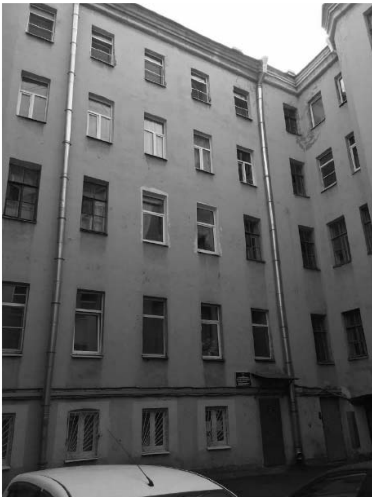
Фото 301. Фасад восточного корпуса.
