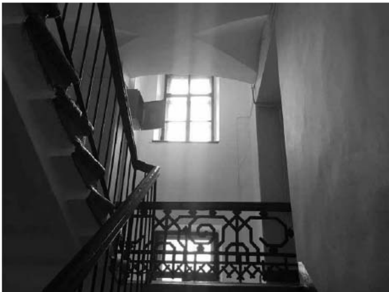
Фото 311. Вид на междуэтажную площадку 1ЛК в уровне 2-го – 3-го этажей.
