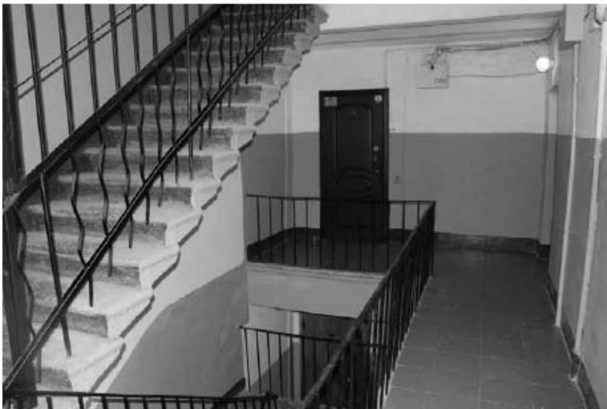
Фото 39. Вид на лестничную площадку Л-2 в уровне 6-го этажа.
