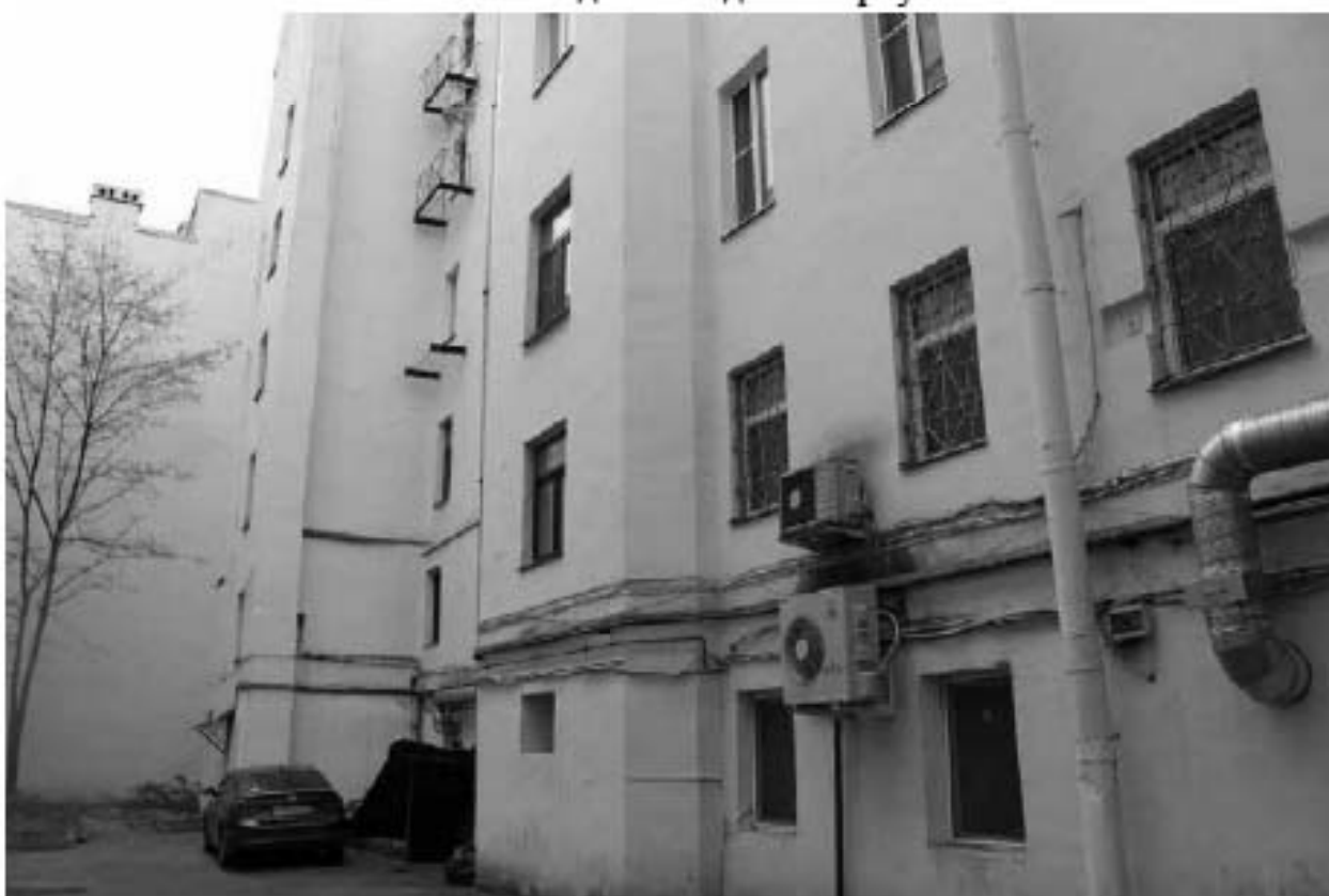
Фото 8. Вид на западный фасад восточного корпуса.
