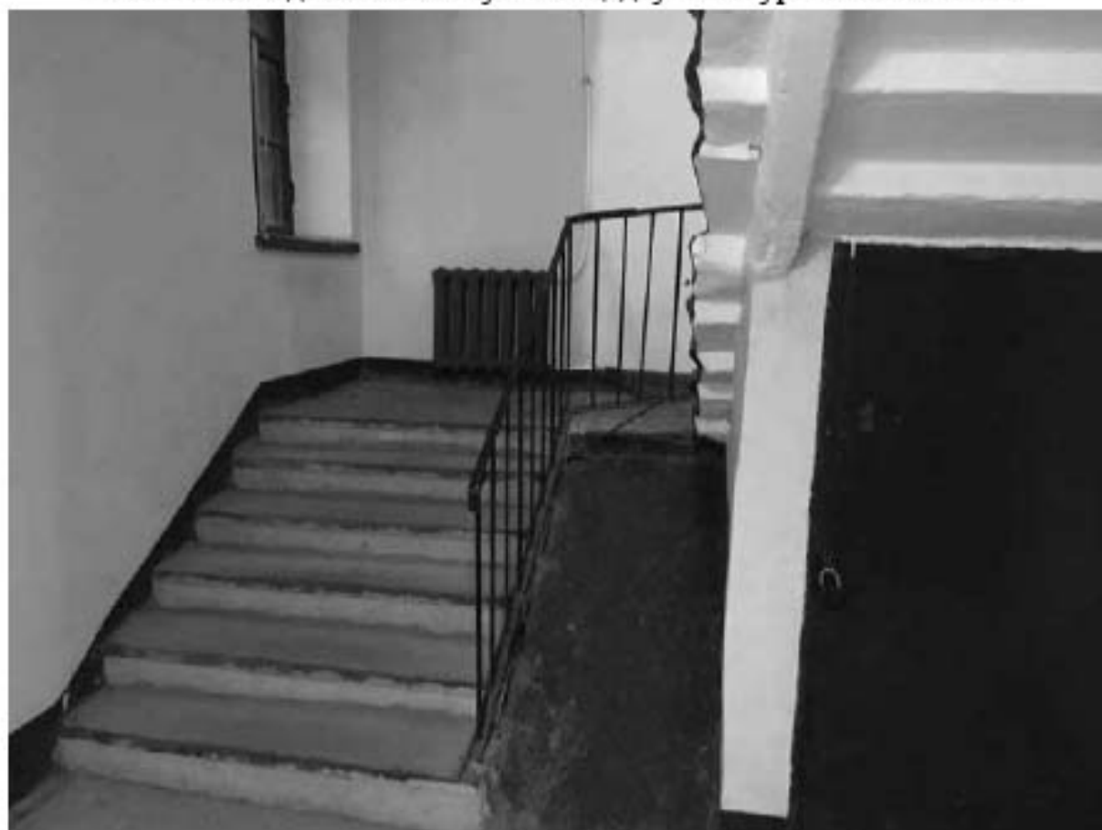
Фото 318. Вид на лестничную клетку Л-3 в уровне 1-го этажа.
