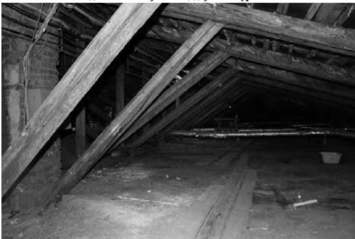
Фото 60. Вид на чердачные помещения.
