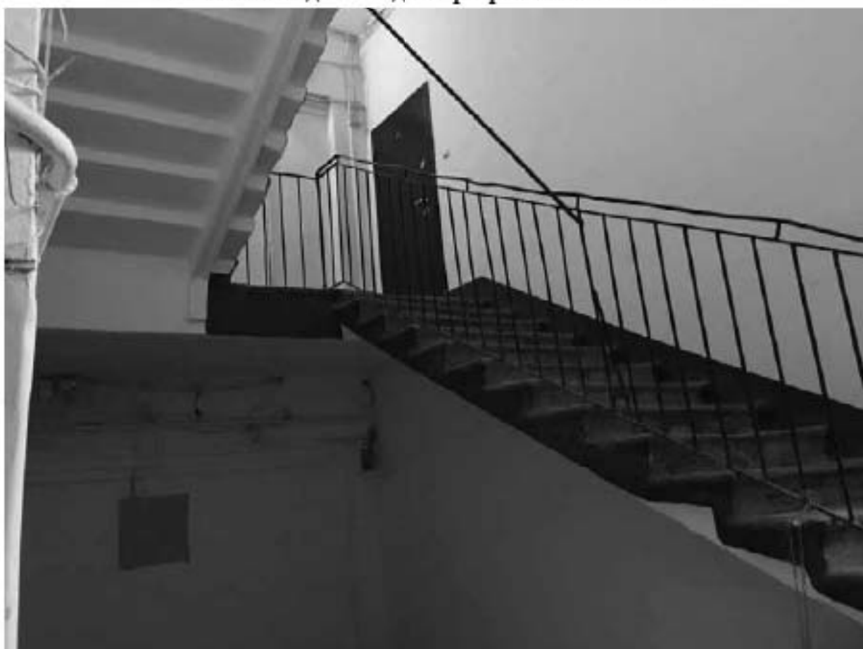
Фото 356. Вид на лестничную клетку Л-2 в уровне 1-го этажа.
