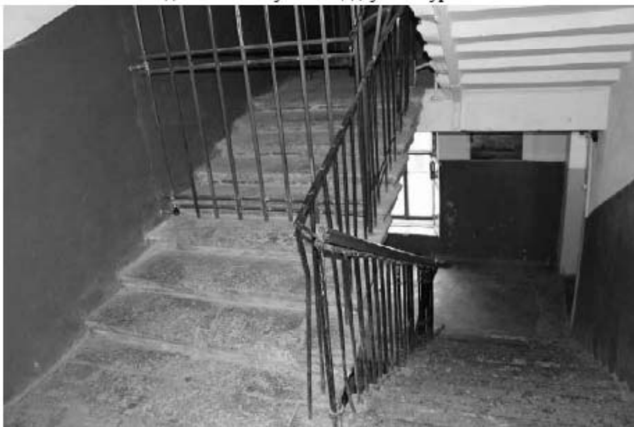
Фото 24. Вид на лестничную площадку Л-1 в уровне 6-го этажа.
