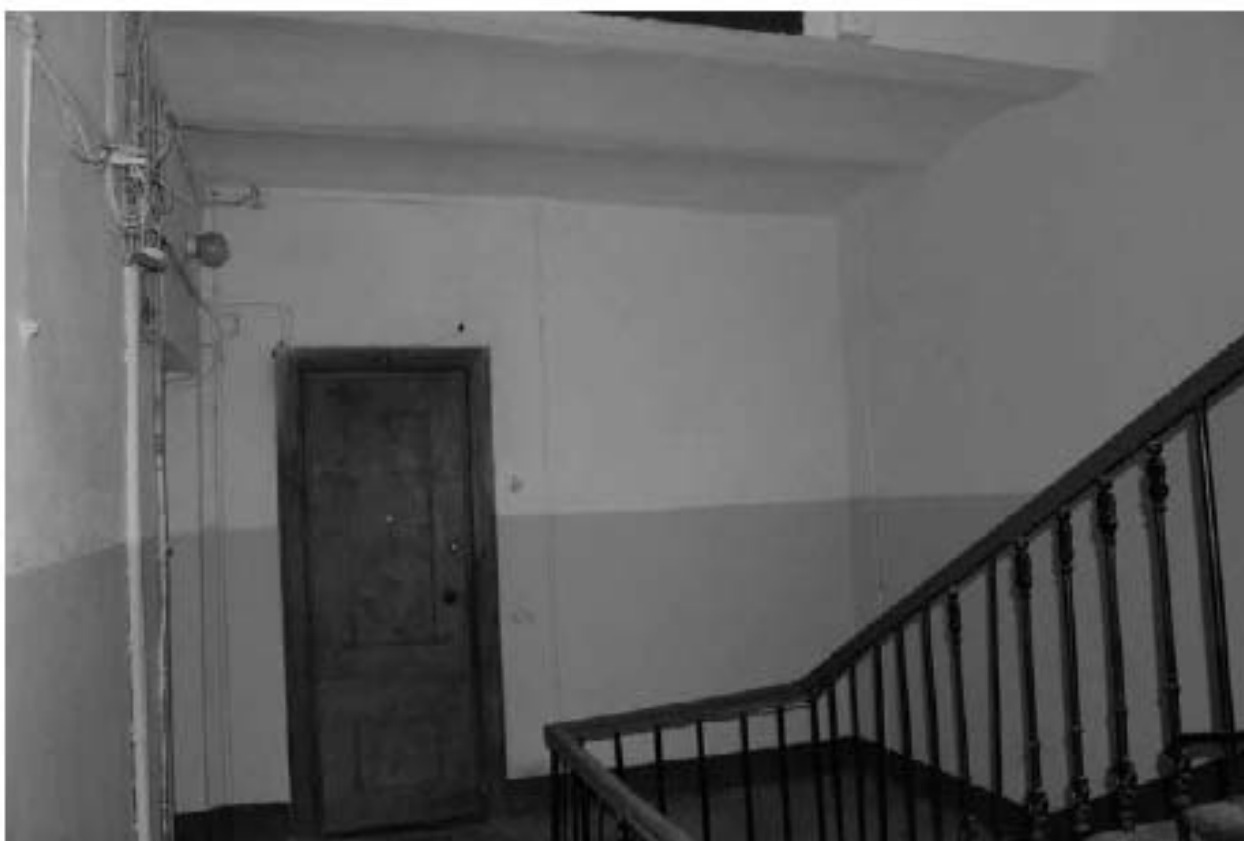
Фото 49. Лестничная площадка Л-3 в уровне 3-го этажа.
