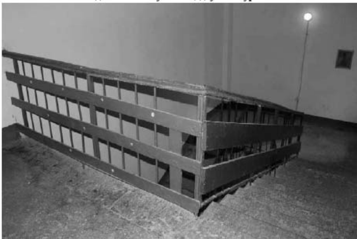
Фото 232. Общий вид лестницы Л-1 в уровне 5-го этажа.
