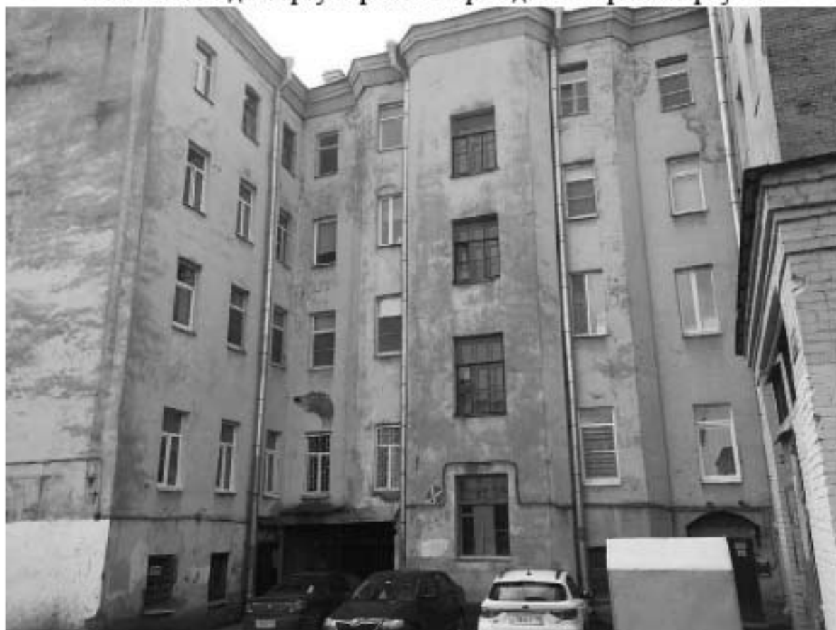
Фото 304. Северный фасад северного корпуса.
