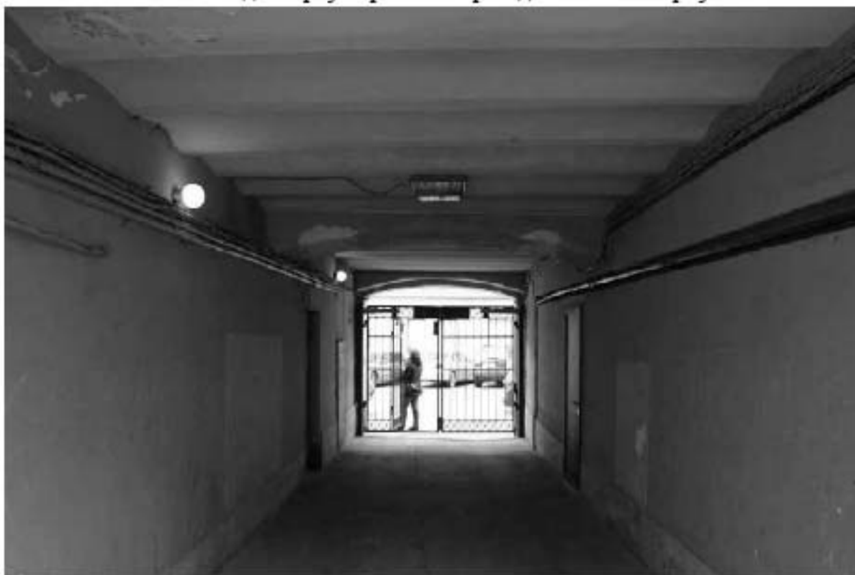
Фото 6. Арка воротного проезда в южном корпусе, вид с дворовой территории.
