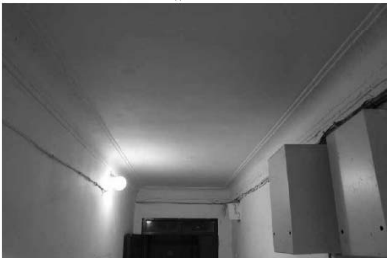
Фото 77. Вид на потолок вестибюля 1ЛК.
