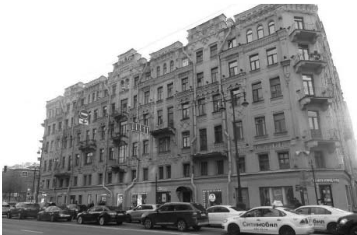
Фото 65. Вид на восточный фасад восточного корпуса.
