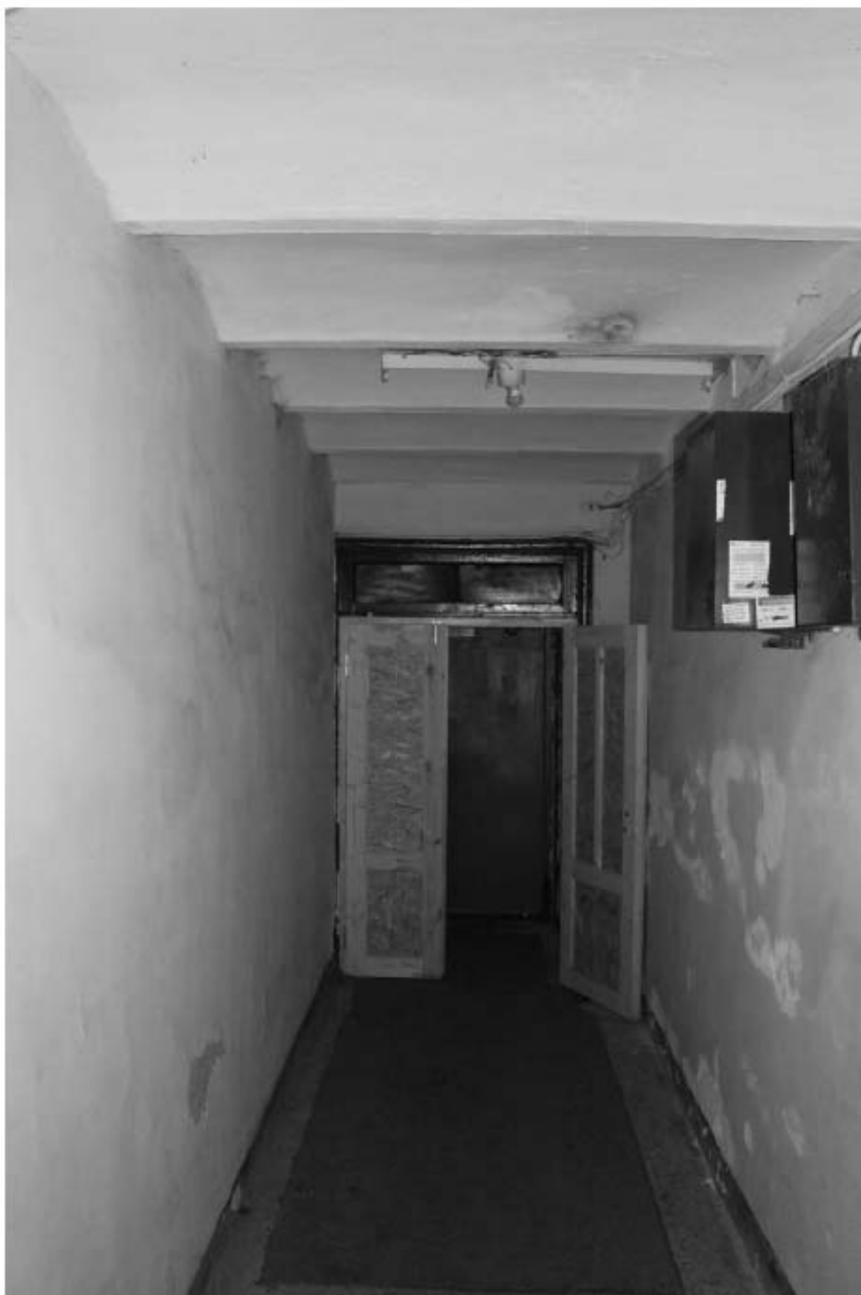
Фото 92. Вид на вестибюль ЗЛК.
