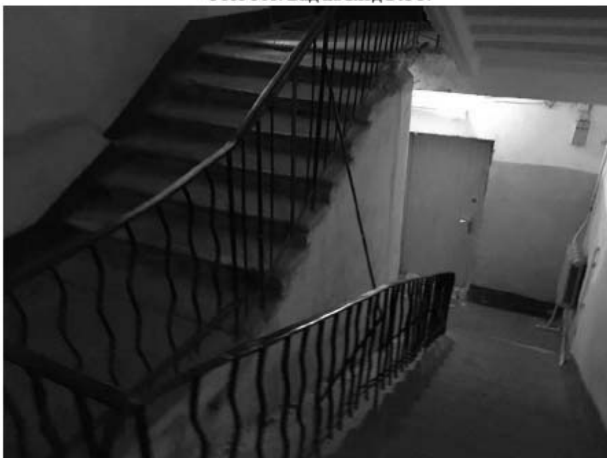
Фото 362. Лестничная клетка Л-3 в уровне 2-го – 3-го этажей.
