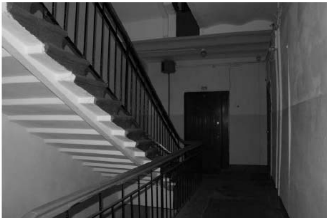
Фото 275. Лестничная площадка Л-1 в уровне 3-го этажа.
