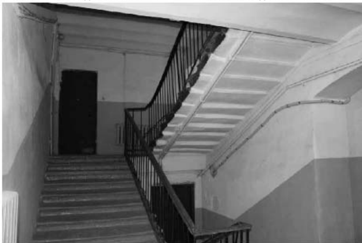
Фото 248. Лестничная клетка Л-4 в уровне 1-го этажа.
