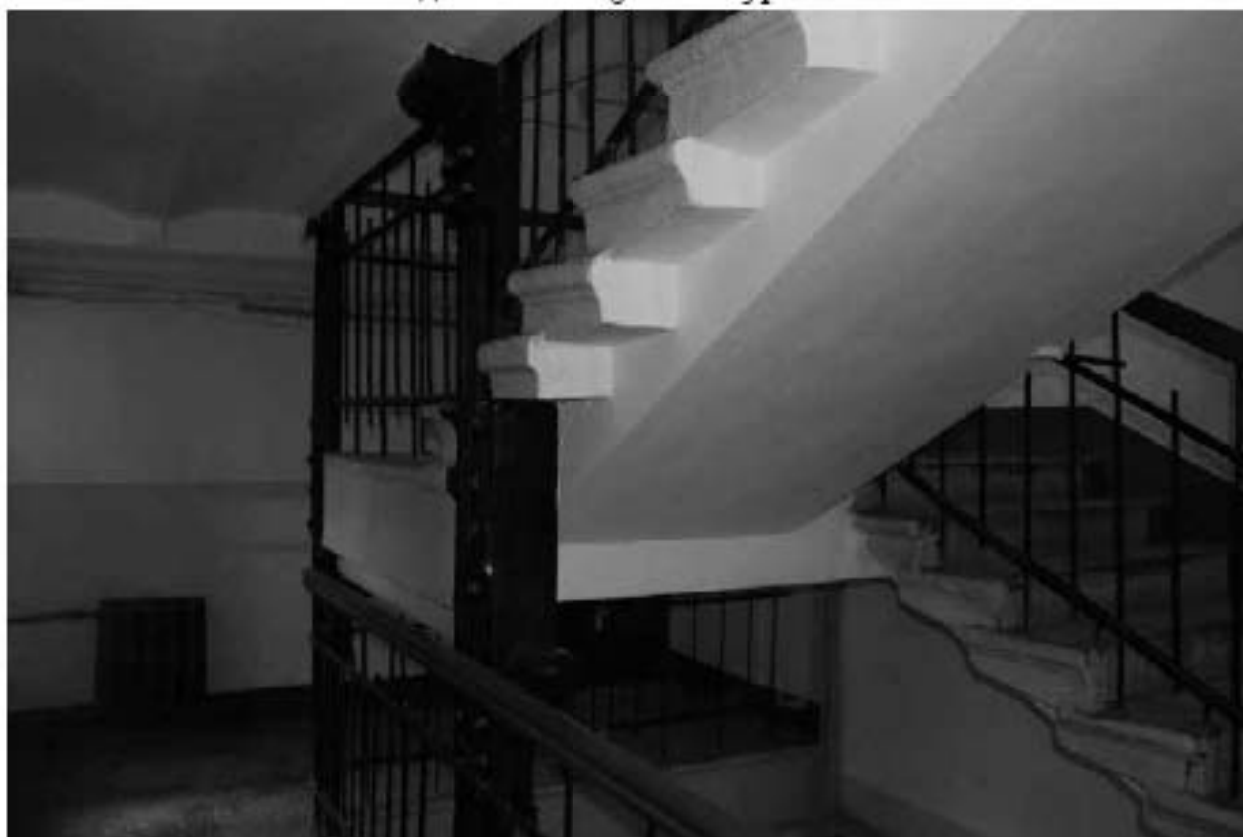
Фото 80. Вид на лестницу 1ЛК в уровне 2-го этажа.
