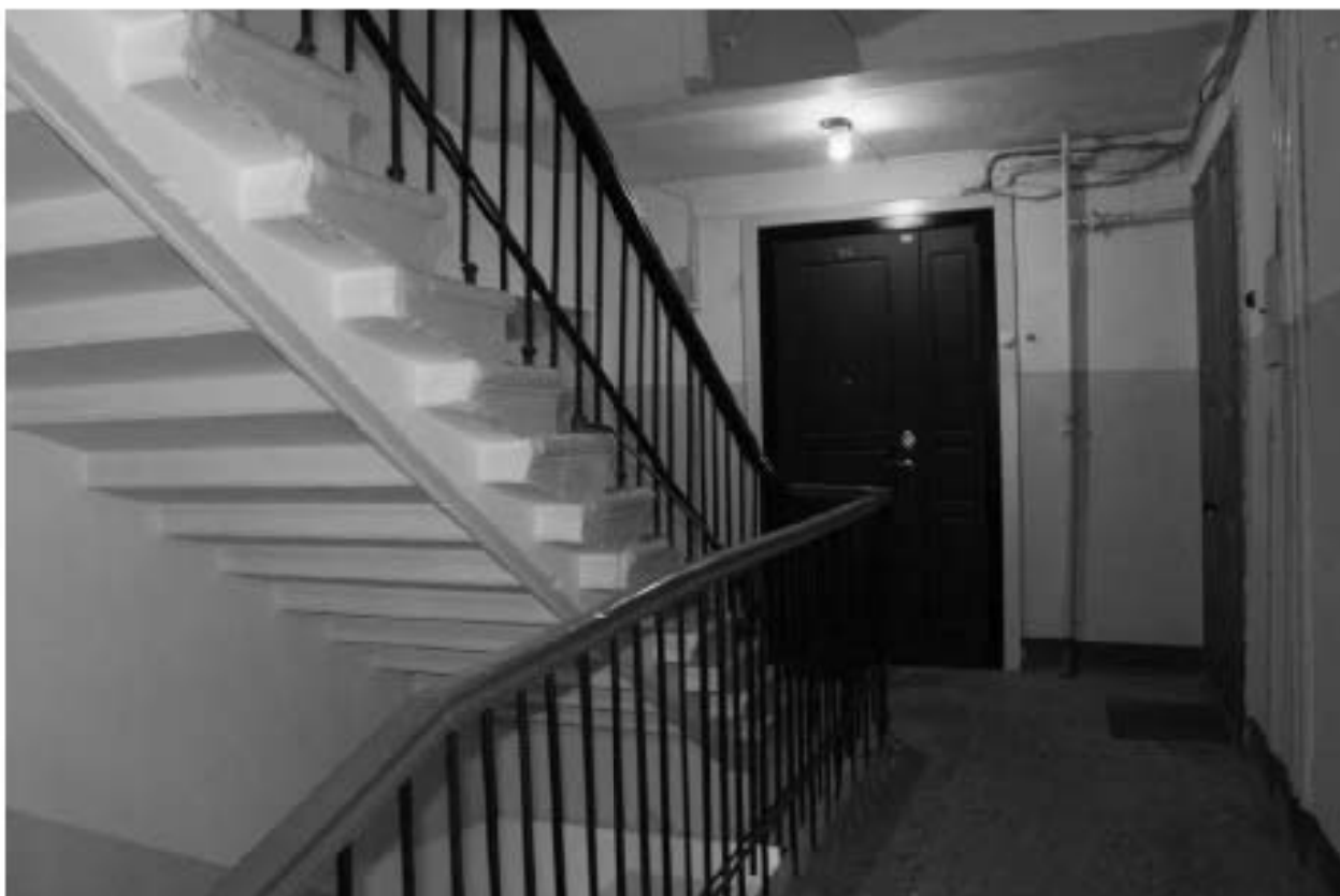
Фото 170. Лестничная клетка 4ЛК в уровне 3-го этажа.
