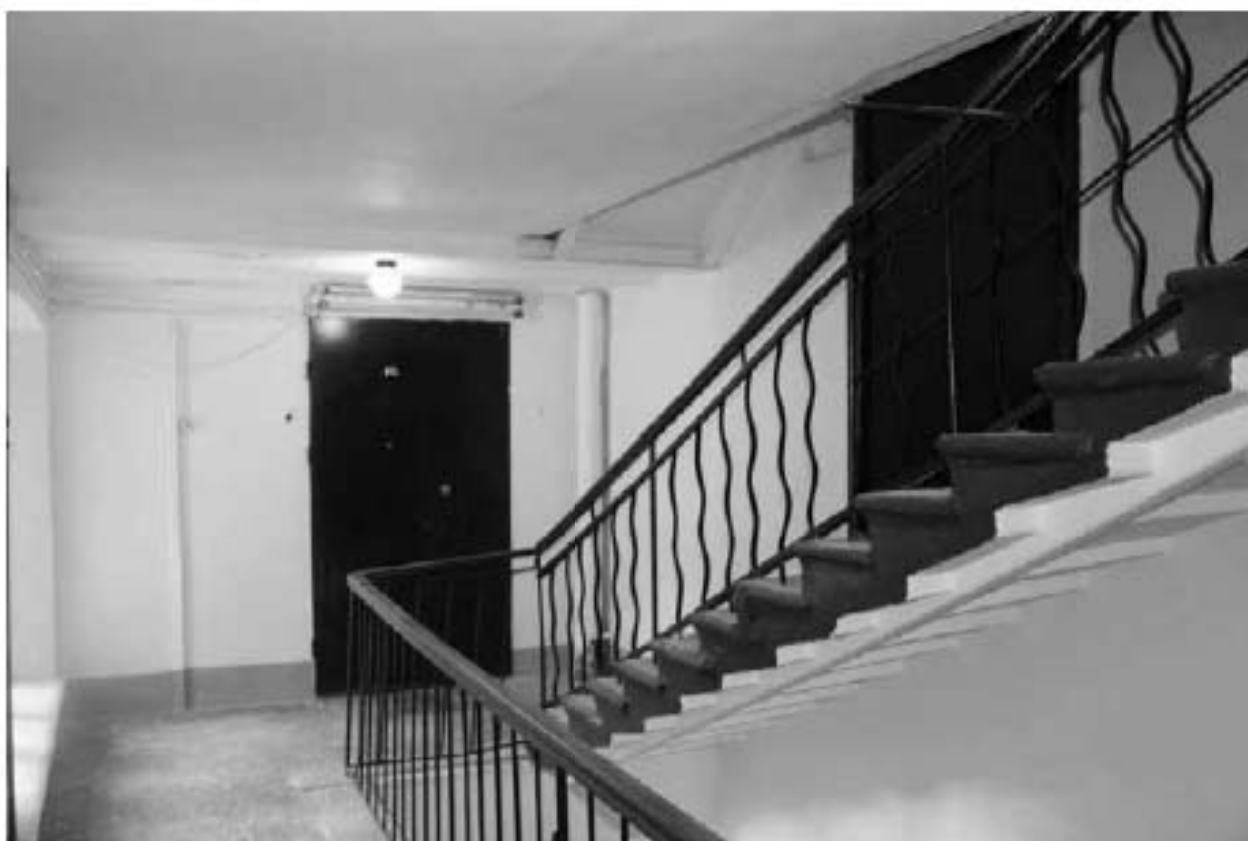
Фото 202. Вид на лестничную площадку 2ЛК в уровне 6-го этажа.
