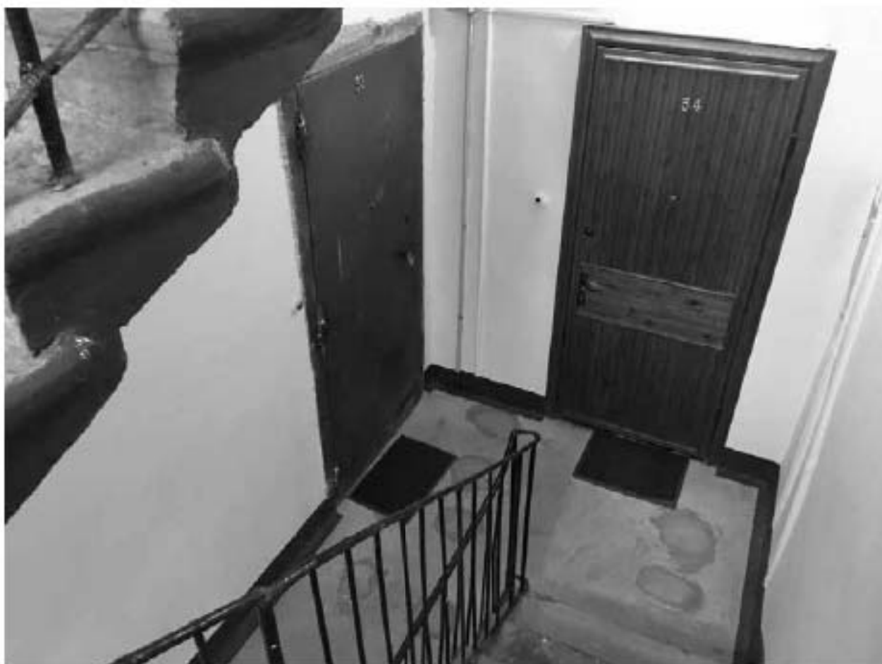
Фото 367. Вид на лестничную площадку Л-5 в уровне 2-го этажа.
