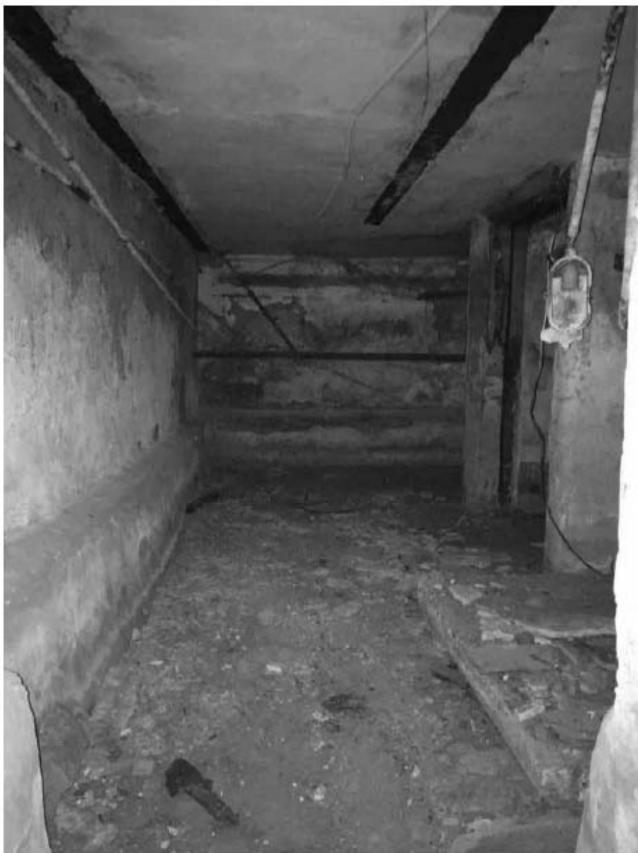
Фото 73. Вид на подвальные помещения.
