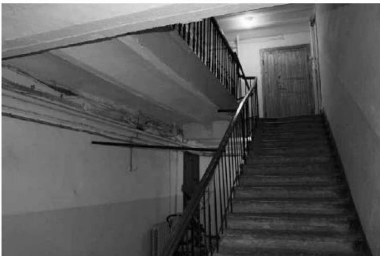
Фото 99. Вид на лестничную клетку 4ЛК в уровне 1-го этажа.
