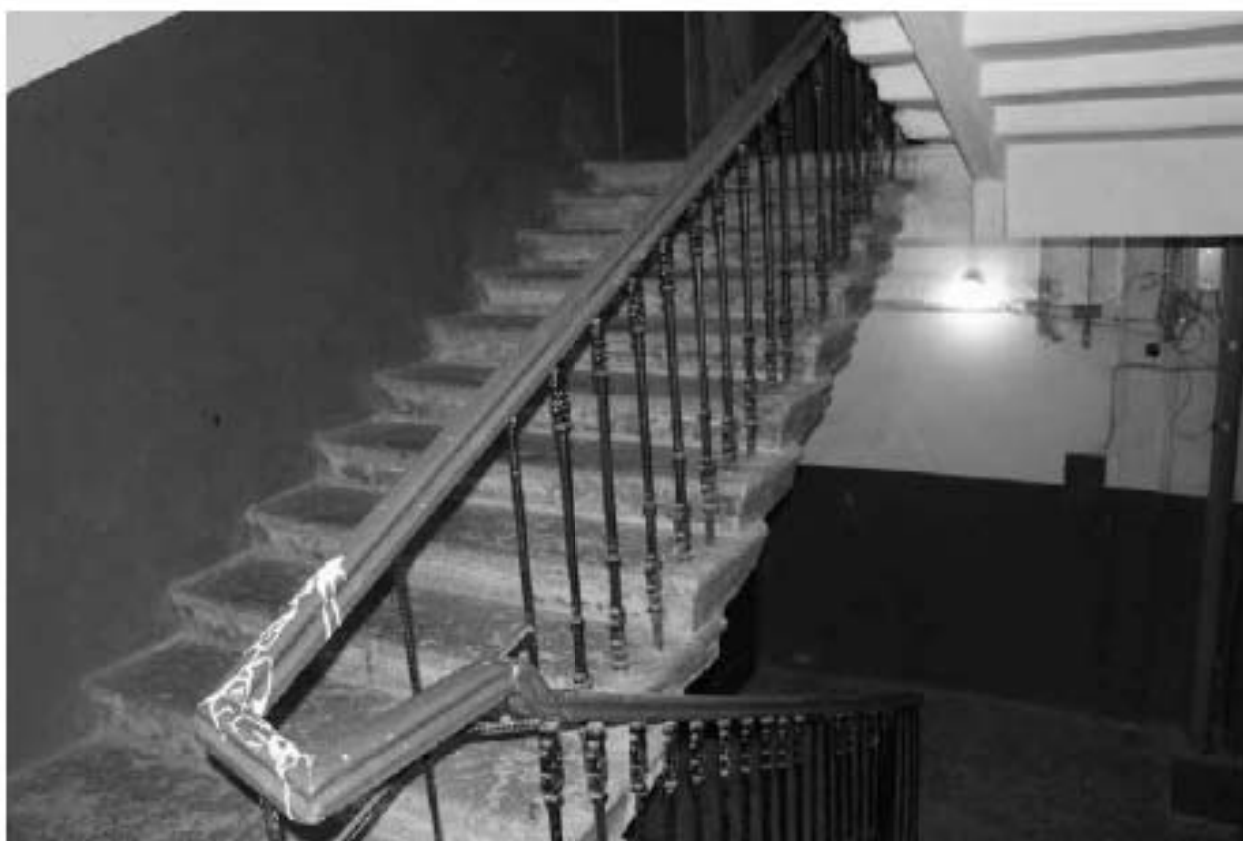
Фото 21. Вид на лестницу Л-1 в уровне 4-го – 5-го этажей.
