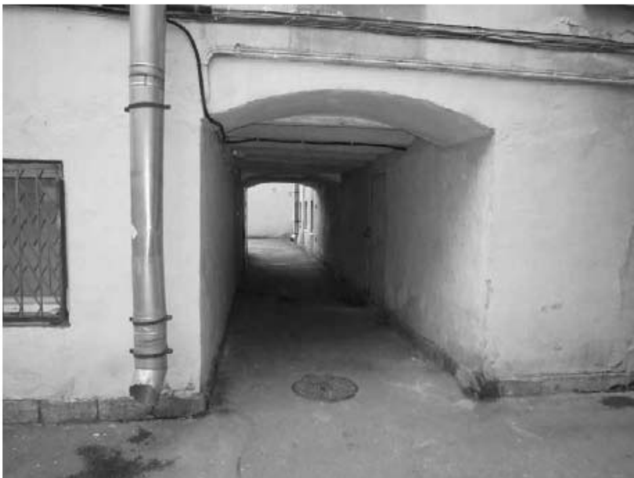
Фото 188. Арка воротного проезда в северном корпусе, вид с юга.
