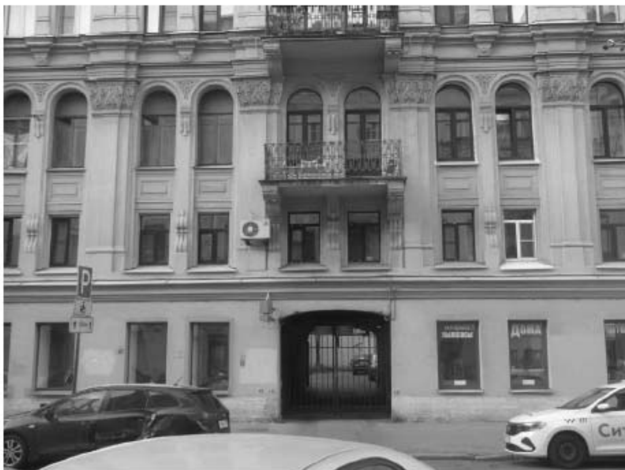
Фото 5. Вид на арку воротного проезда в южном корпусе.
