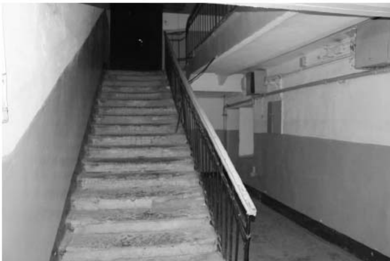
Фото 280. Лестница Л-2 в уровне 1-го этажа.
