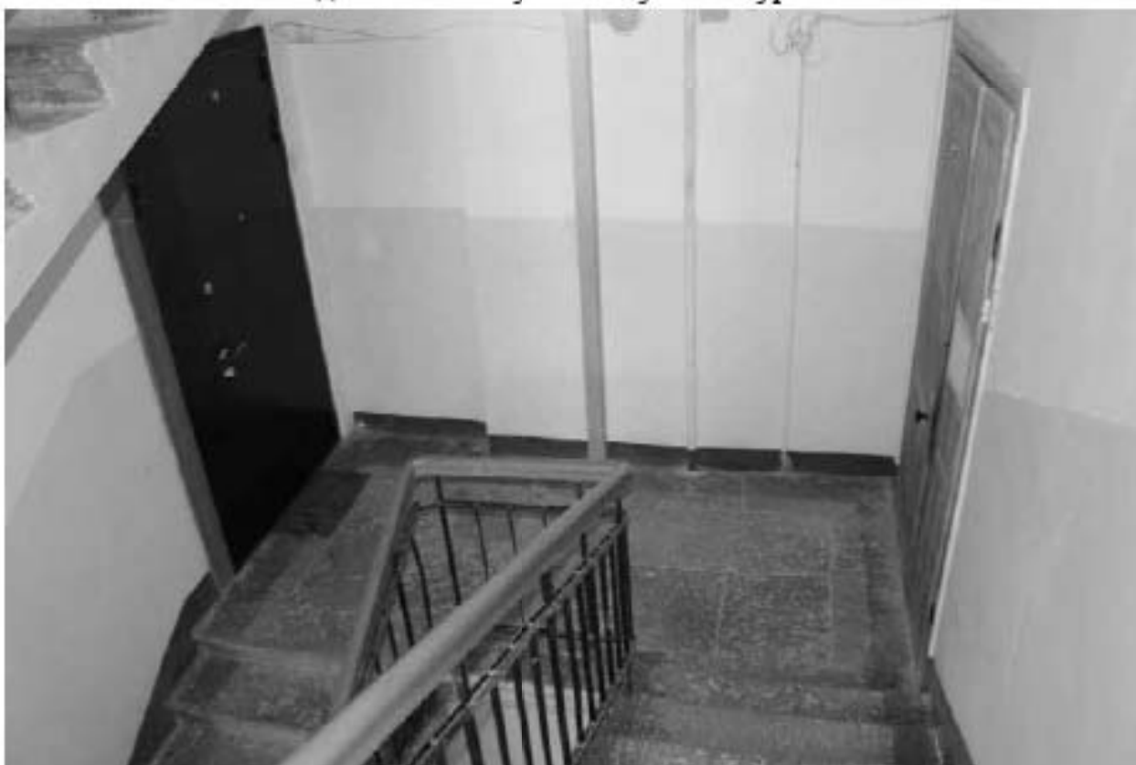
Фото 125. Лестничная площадка 2ЛК в уровне 2-го этажа.
