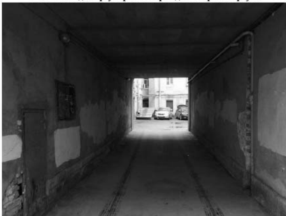
Фото 338. Арка воротного проезда в северном корпусе, вид с севера.
