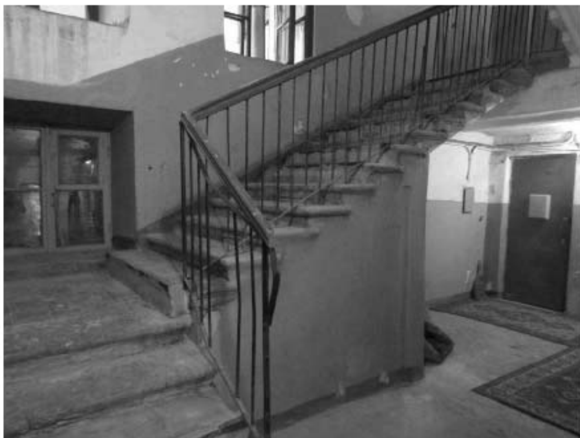
Фото 349. Лестничная клетка Л-1 в уровне 1-го этажа.
