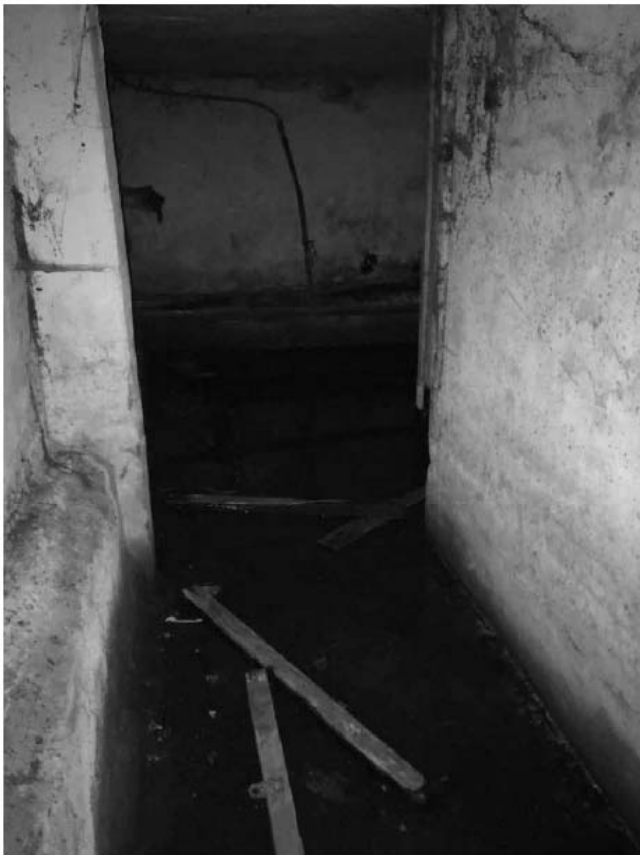
Фото 74. Вид на подвальные помещения.
