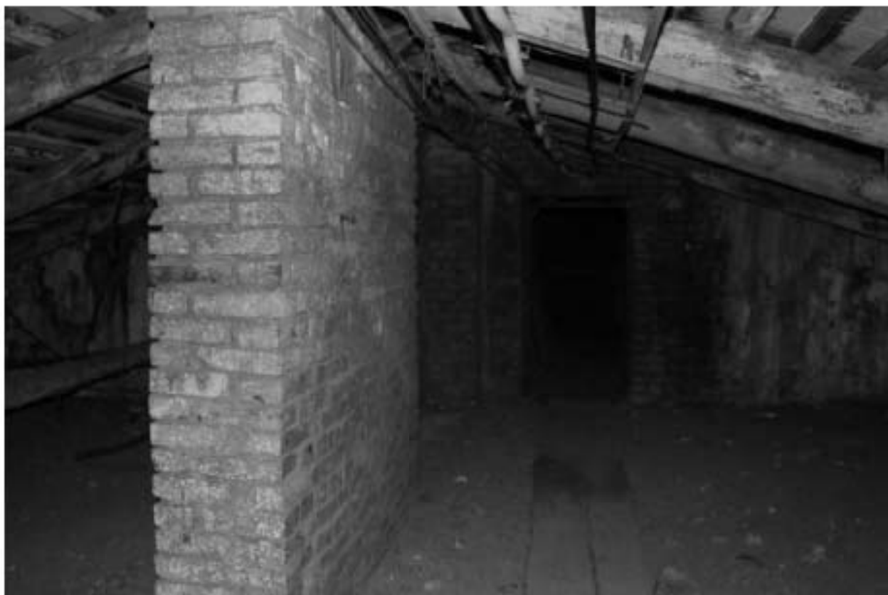
Фото 293. Вид на чердачные помещения.
