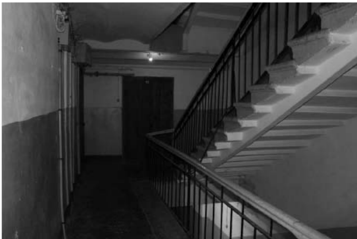
Фото 281. Лестничная площадка Л-2 в уровне 2-го этажа.
