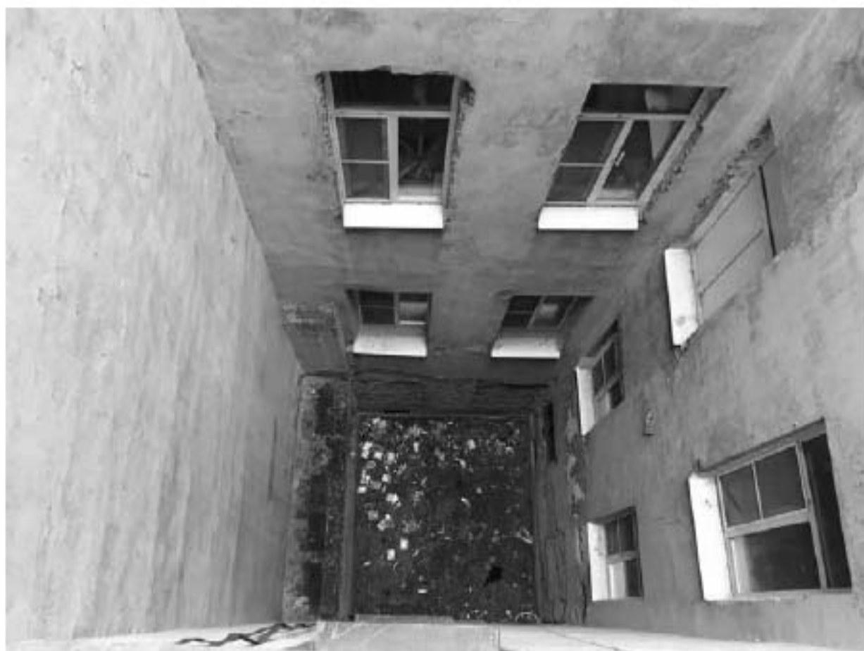
Фото 323. Вид на световой колодец с 4-го этажа.
