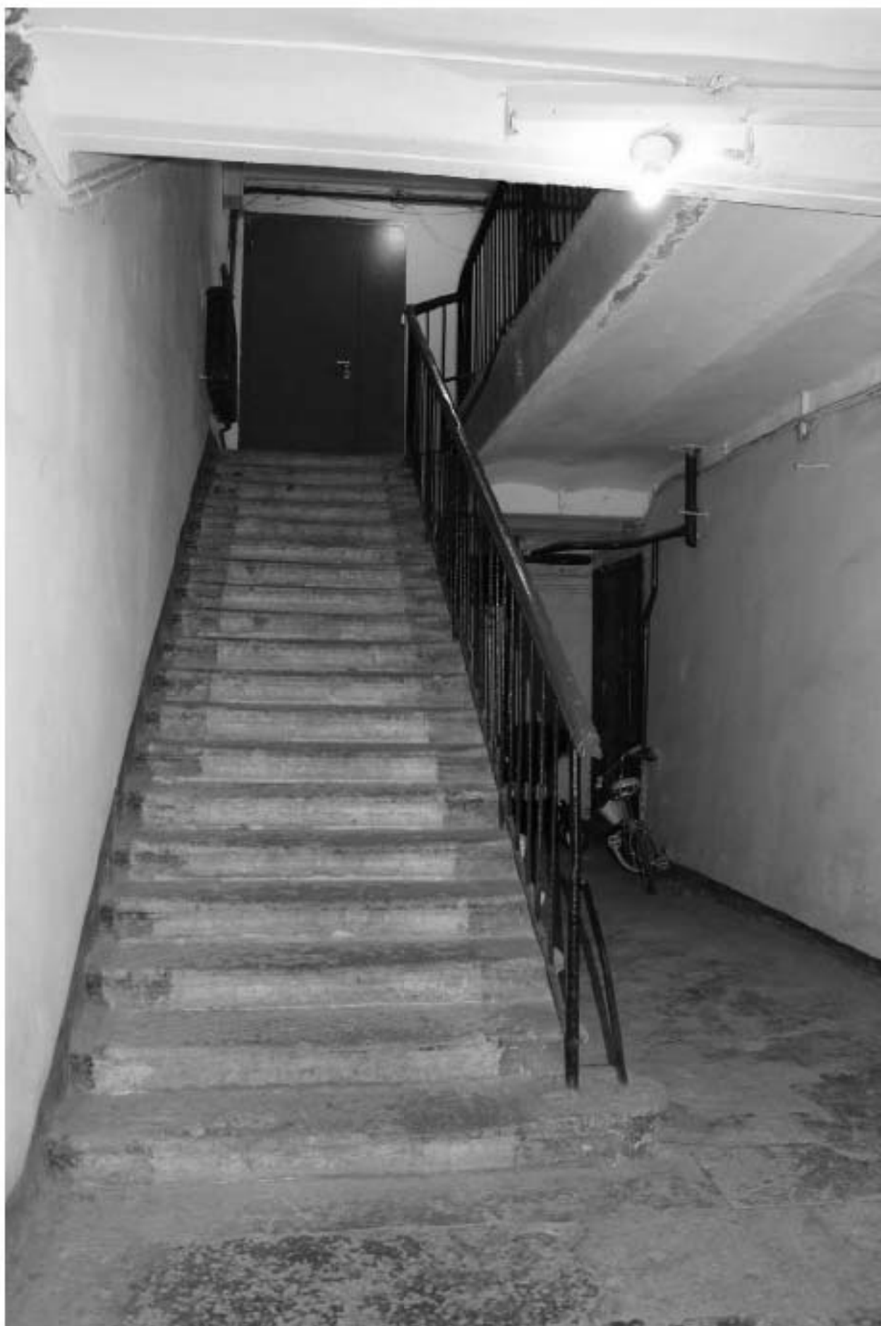
Фото 93. Лестница ЗЛК в уровне 1-го этажа.
