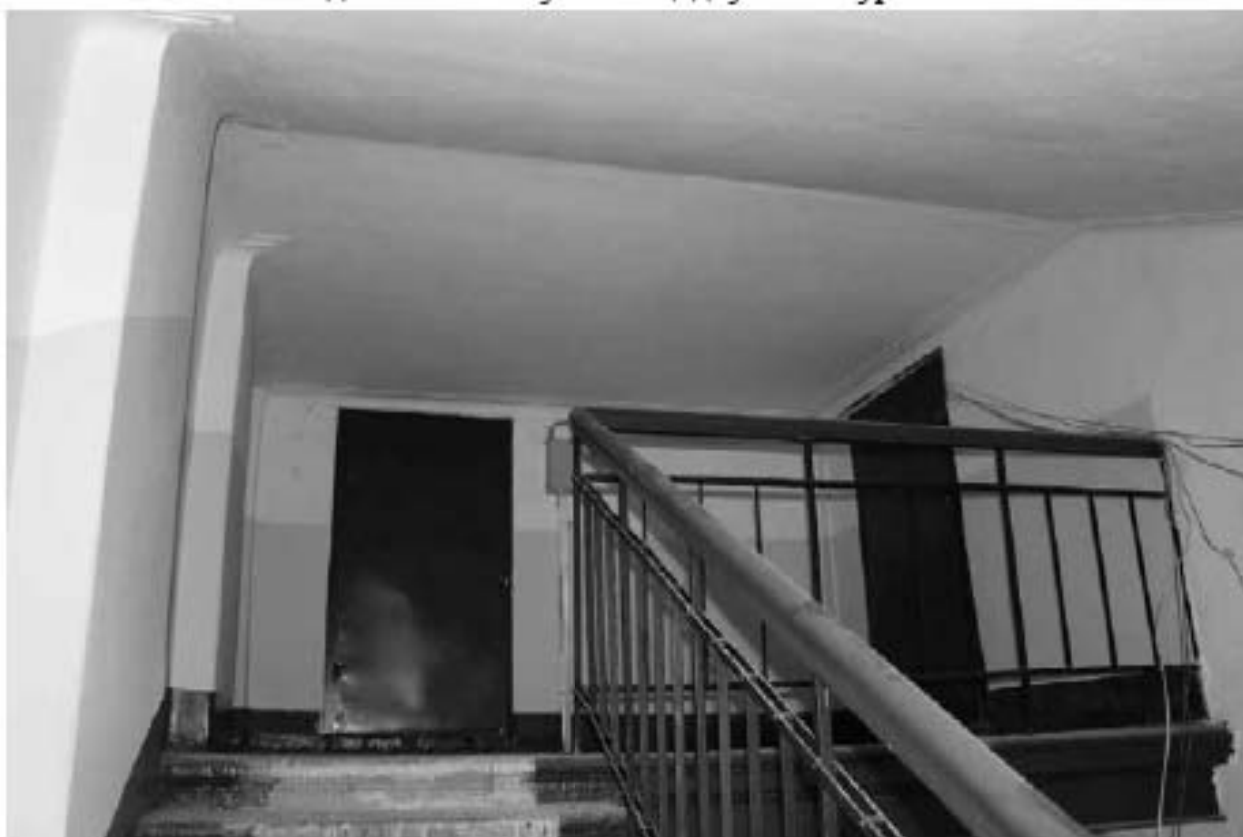
Фото 139. Вид на потолок лестничной клетки 4ЛК в уровне 6-го этажа.
