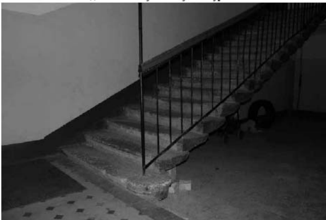
Фото 46. Вид на лестницу Л-3 в уровне 1-го этажа.
