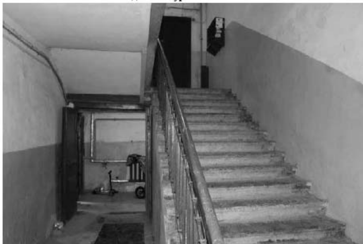
Фото 118. Вид на лестничную клетку 1ЛК в уровне 1-го этажа.
