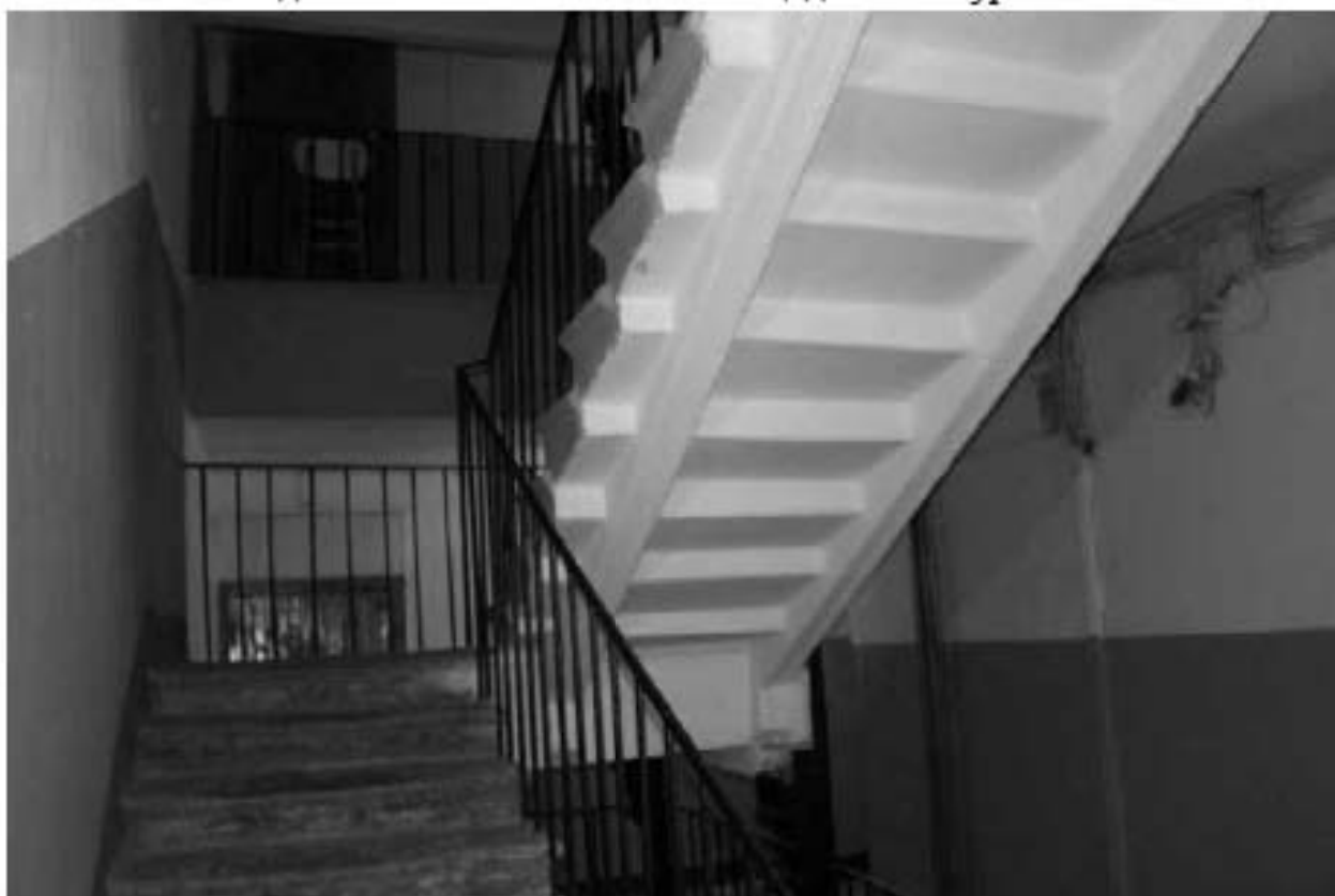
Фото 34. Лестничная площадка Л-2 в уровне 3-го этажа
