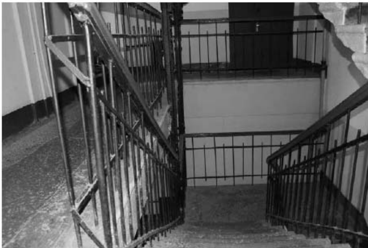
Фото 83. Вид на лестницу 1ЛК в уровне 5-го этажа.
