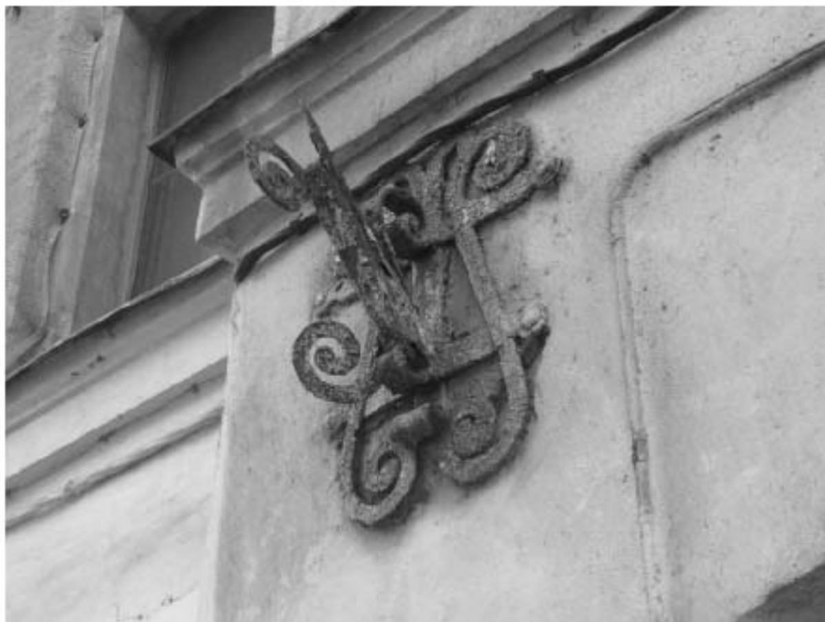
Фото 180. Вид на флагодержатель на южном фасаде южного корпуса.
