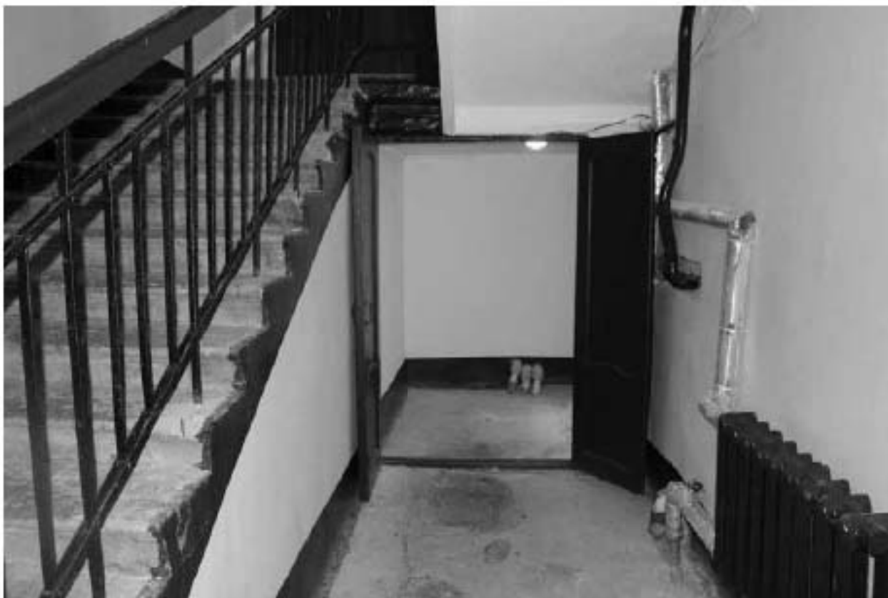
Фото 128. Вид на лестничную клетку ЗЛК в уровне 1-го этажа.
