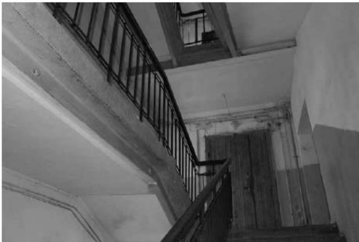
Фото 122. Вид на лестничную площадку 1ЛК в уровне 4-го этажа.
