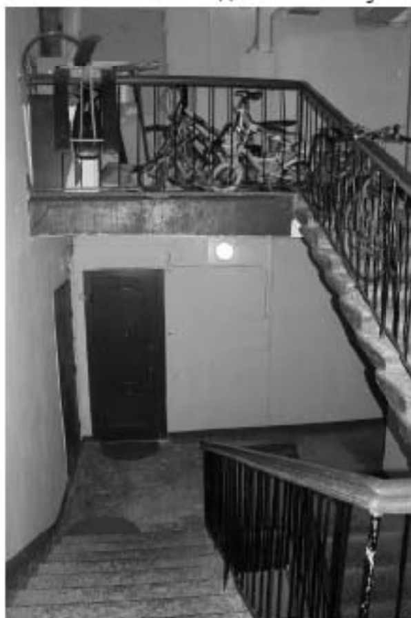
Фото 244. Вид на лестничную клетку Л-3 в уровне 4-го – 5-го этажей.
