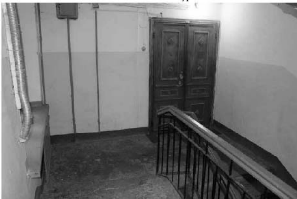
Фото 274. Лестничная площадка Л-1 в уровне 2-го этажа.
