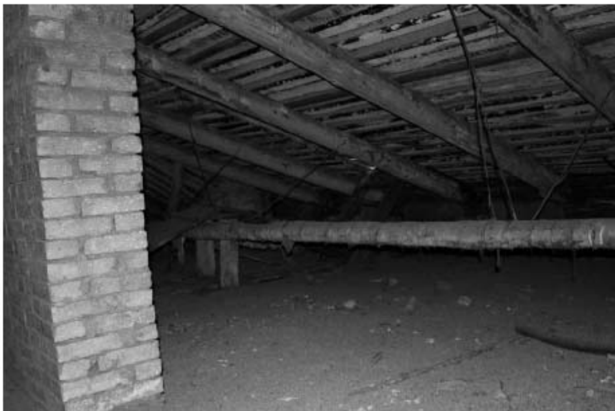
Фото 291. Вид на чердачные помещения.
