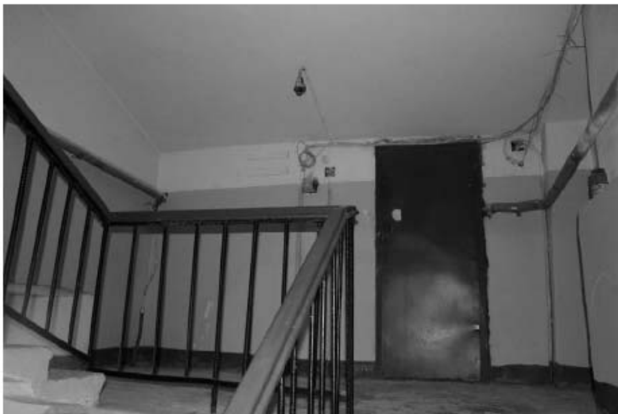
Фото 172. Верхний этаж лестничной клетки 4ЛК.
