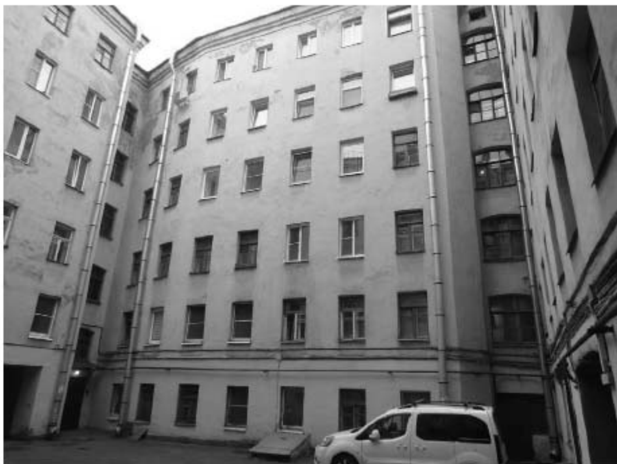
Фото 267. Вид на фасад восточного корпуса.
