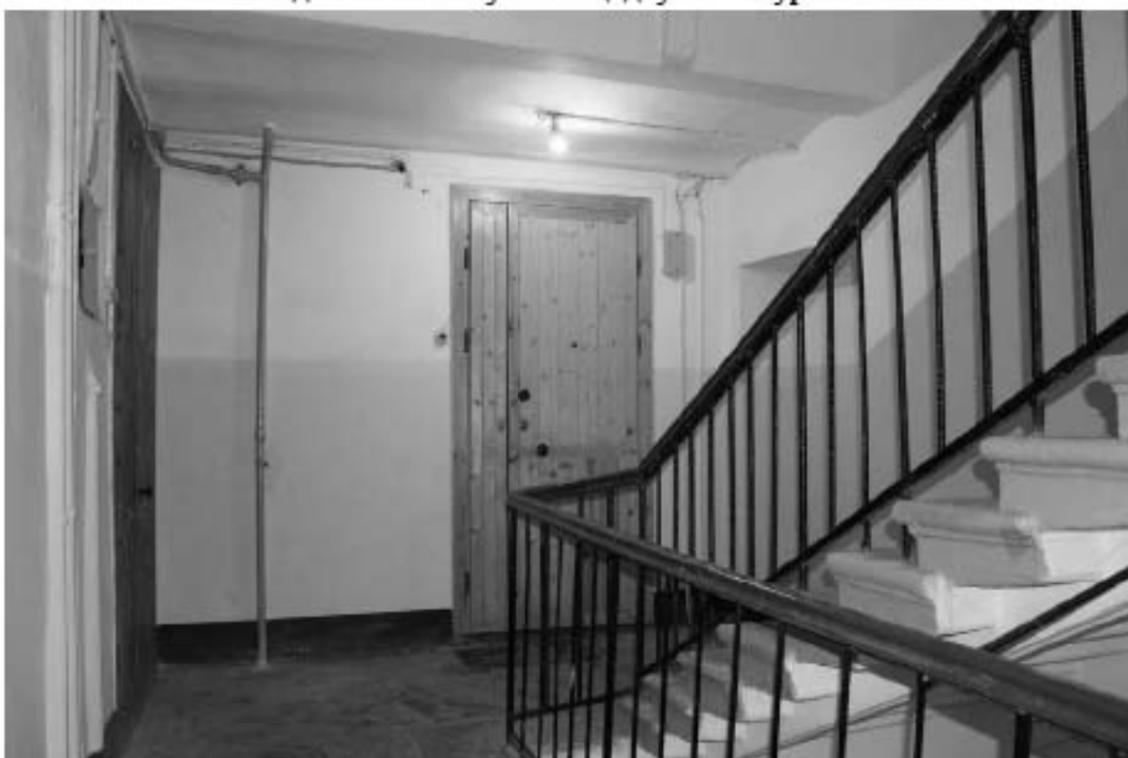
Фото 162. Вид на лестничную площадку ЗЛК в уровне 4-го этажа.
