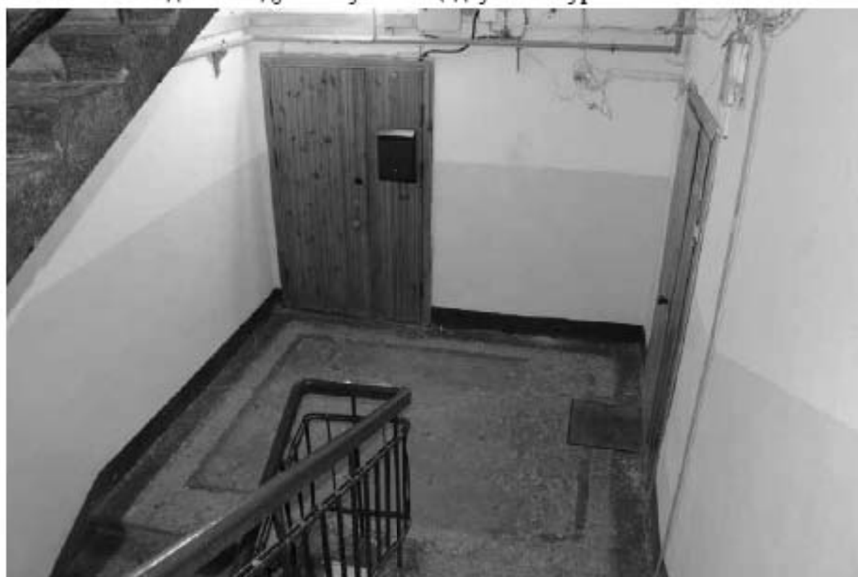
Фото 137. Вид на лестничную площадку 4ЛК в уровне 2-го этажа.
