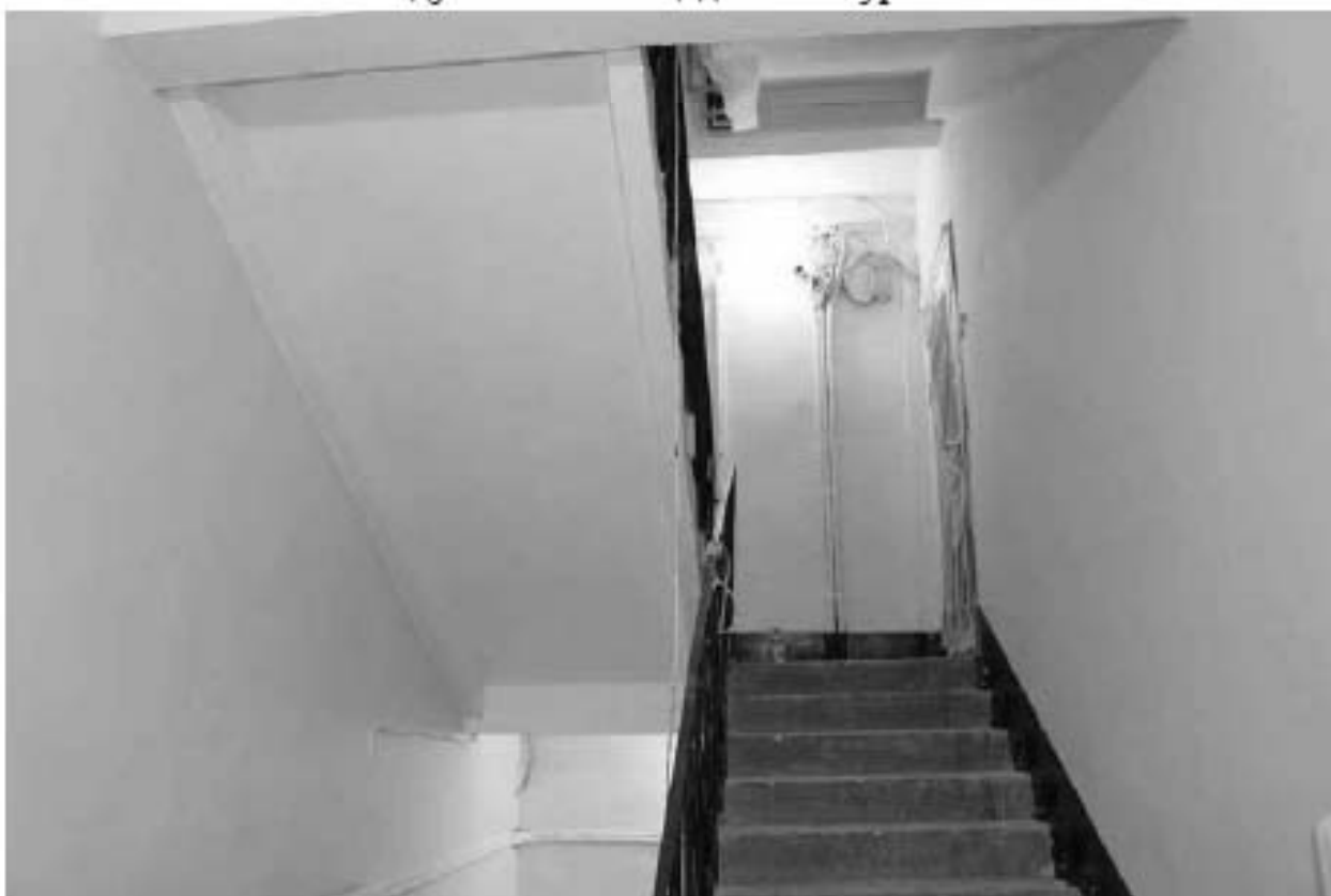
Фото 56. Вид на 4ЛК в уровне 2-го этажа.
