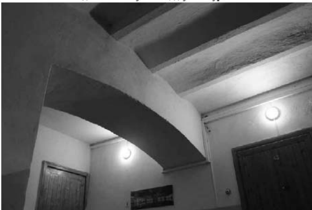
Фото 252. Вид на потолок лестничной площадки Л-4 в уровне 5-го этажа.
