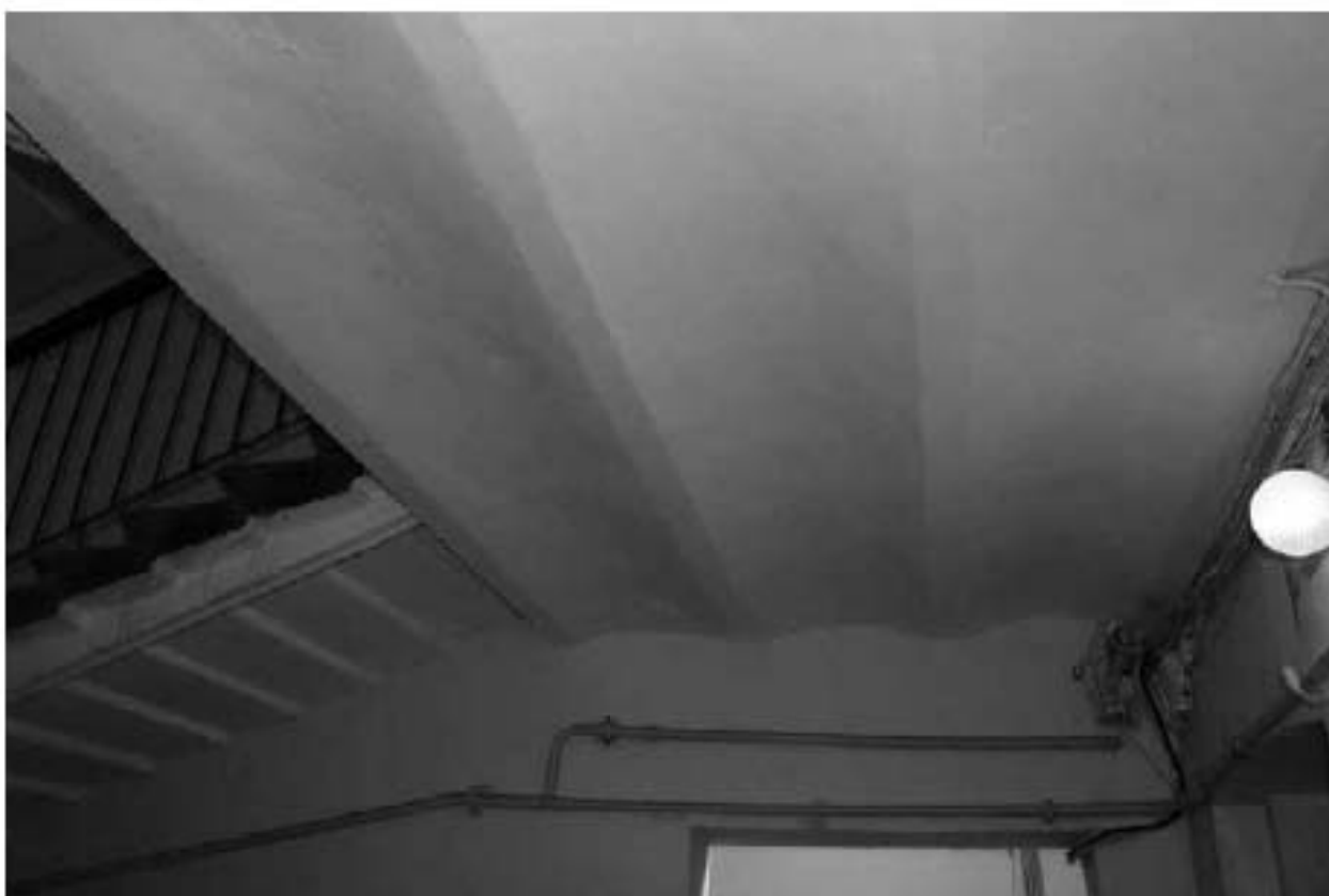
Фото 227. Вид на своды перекрытия лестничной клетки Л-1 в уровне 1-го этажа.
