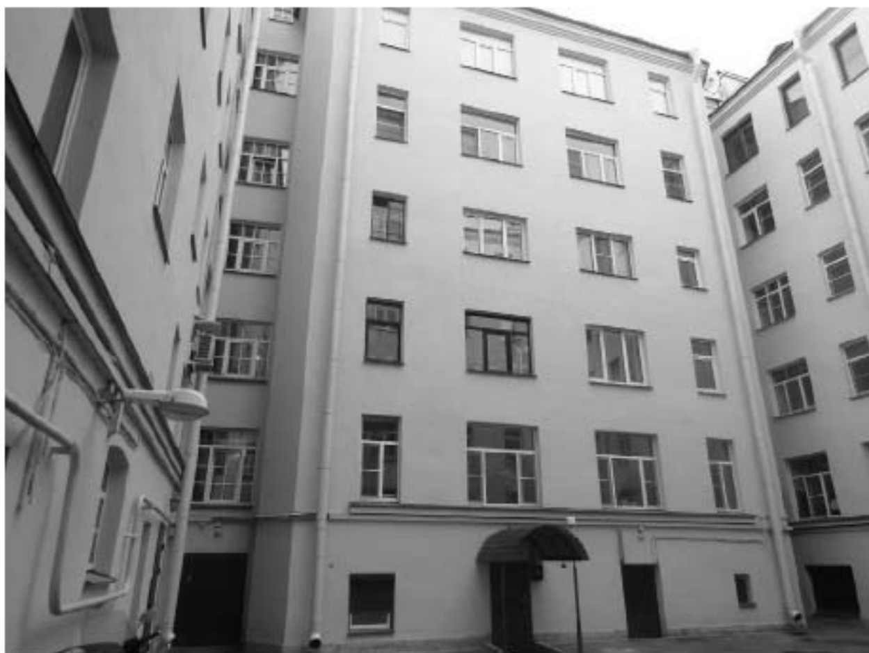
Фото 111. Вид на западный корпус.
