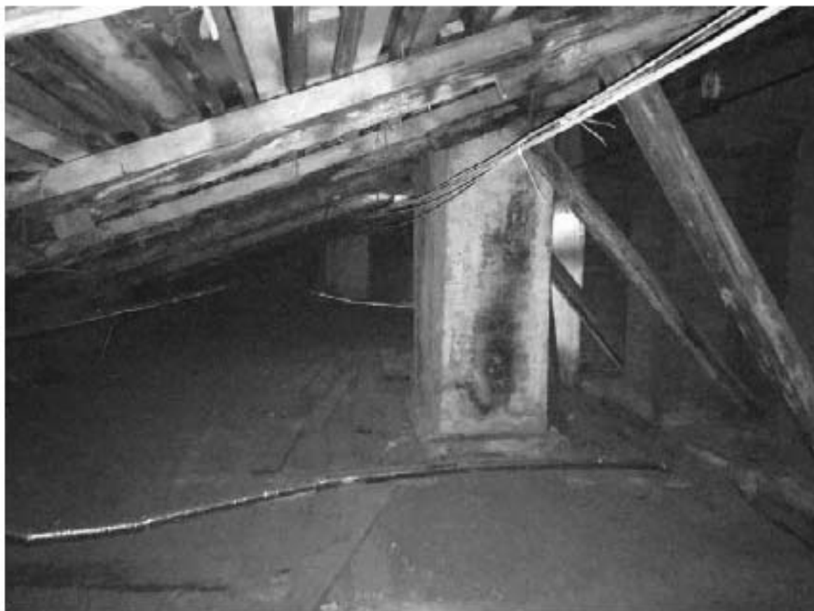
Фото 329. Вид на чердачные помещения.
