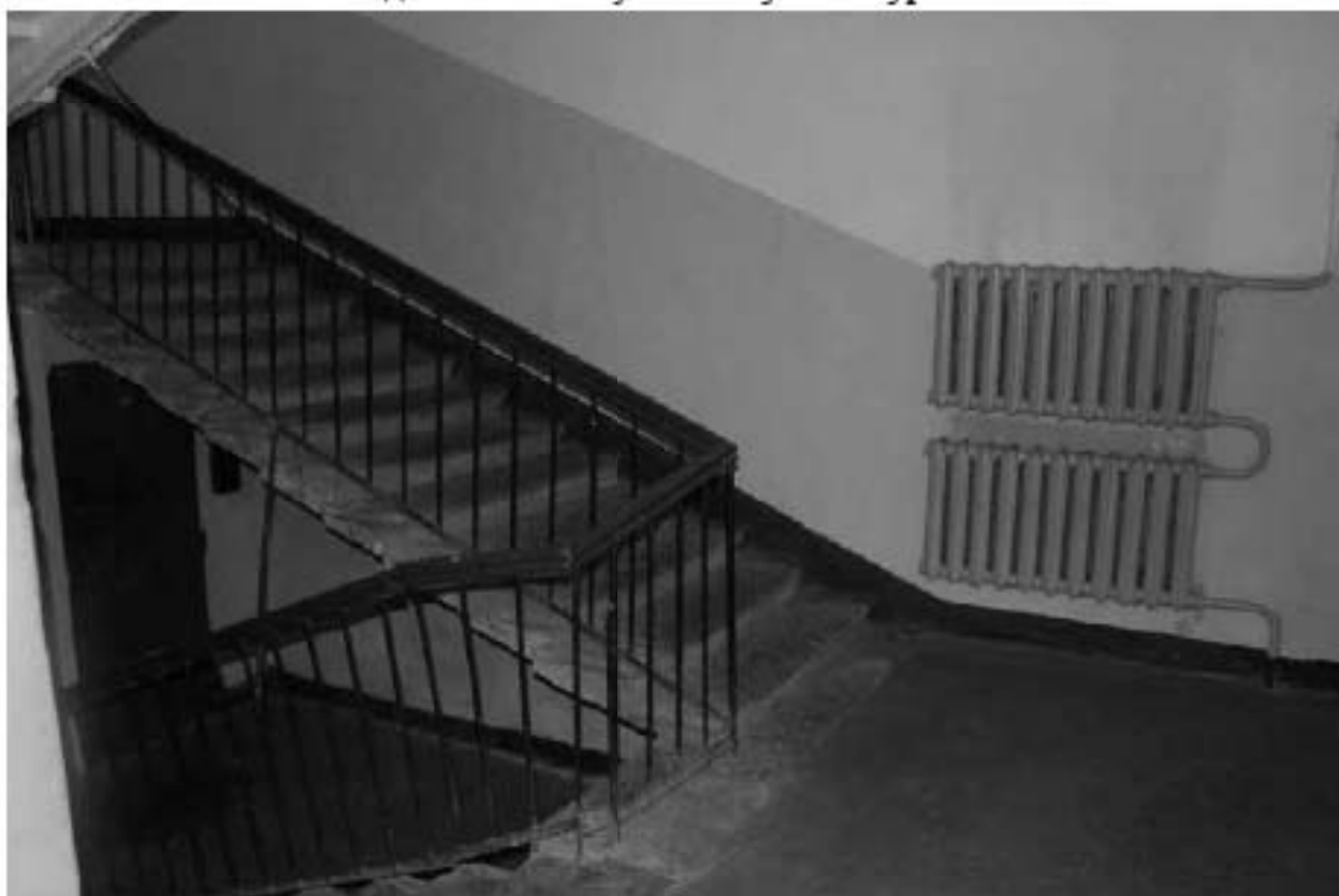
Фото 254. Вид на лестничную клетку Л-5 в уровне 1-го этажа.
