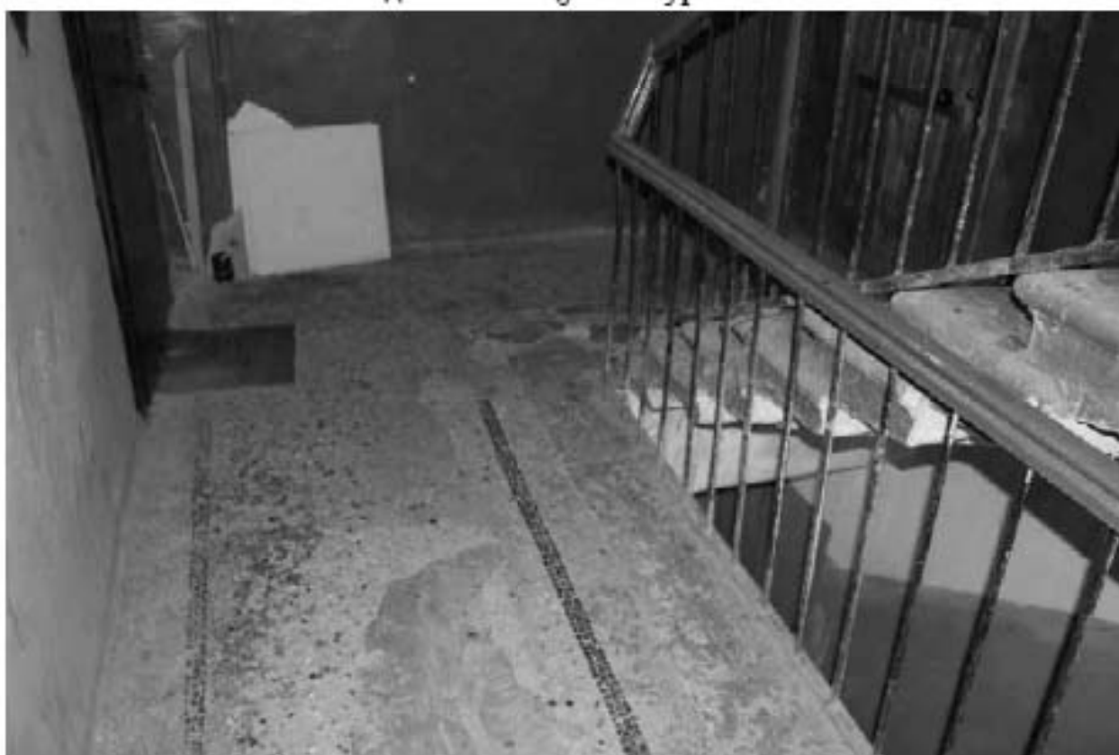
Фото 16. Лестничная площадка Л-1 в уровне 2-го этажа.
