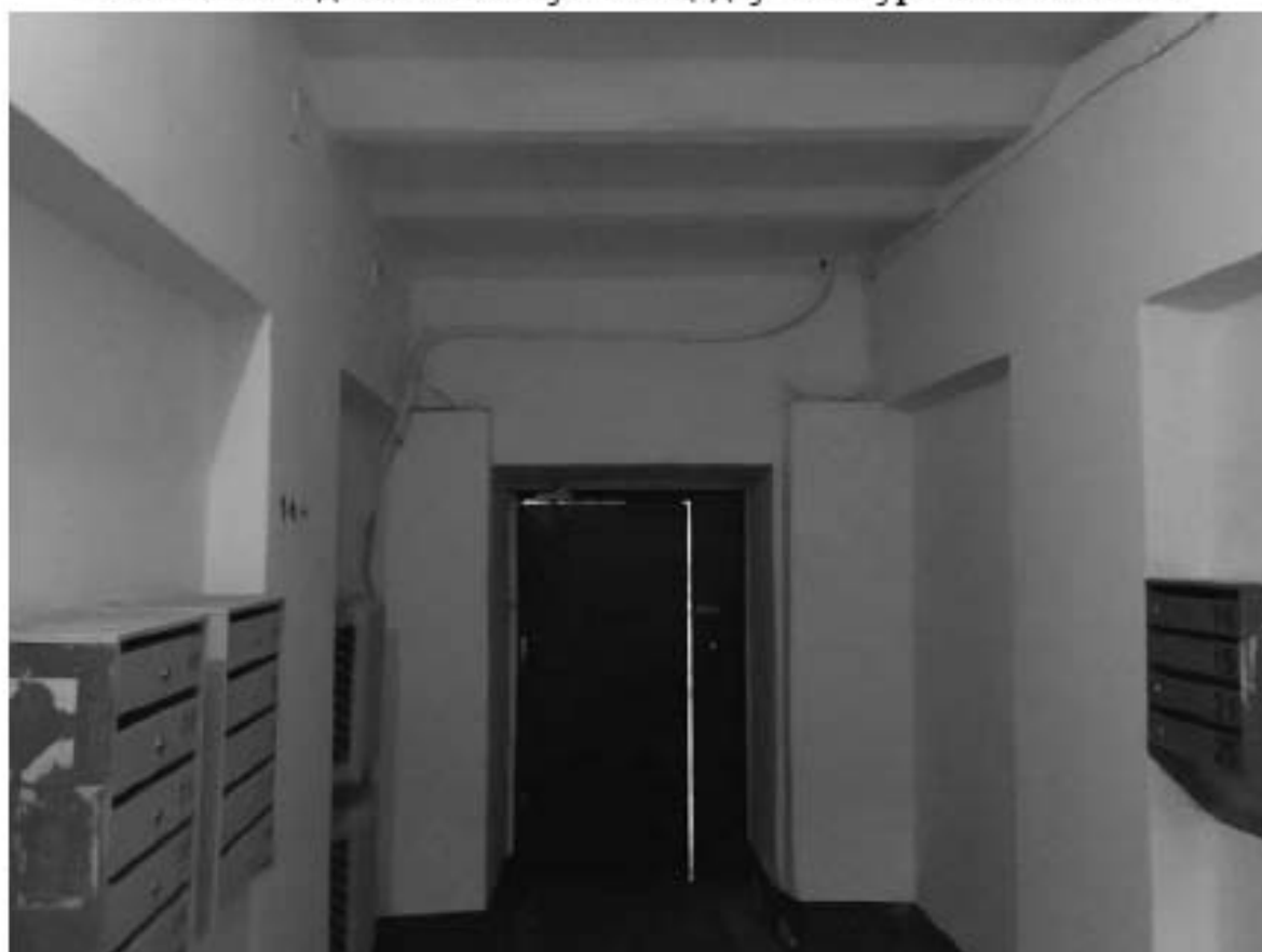
Фото 354. Вид на вестибюль лестницы Л-2.
