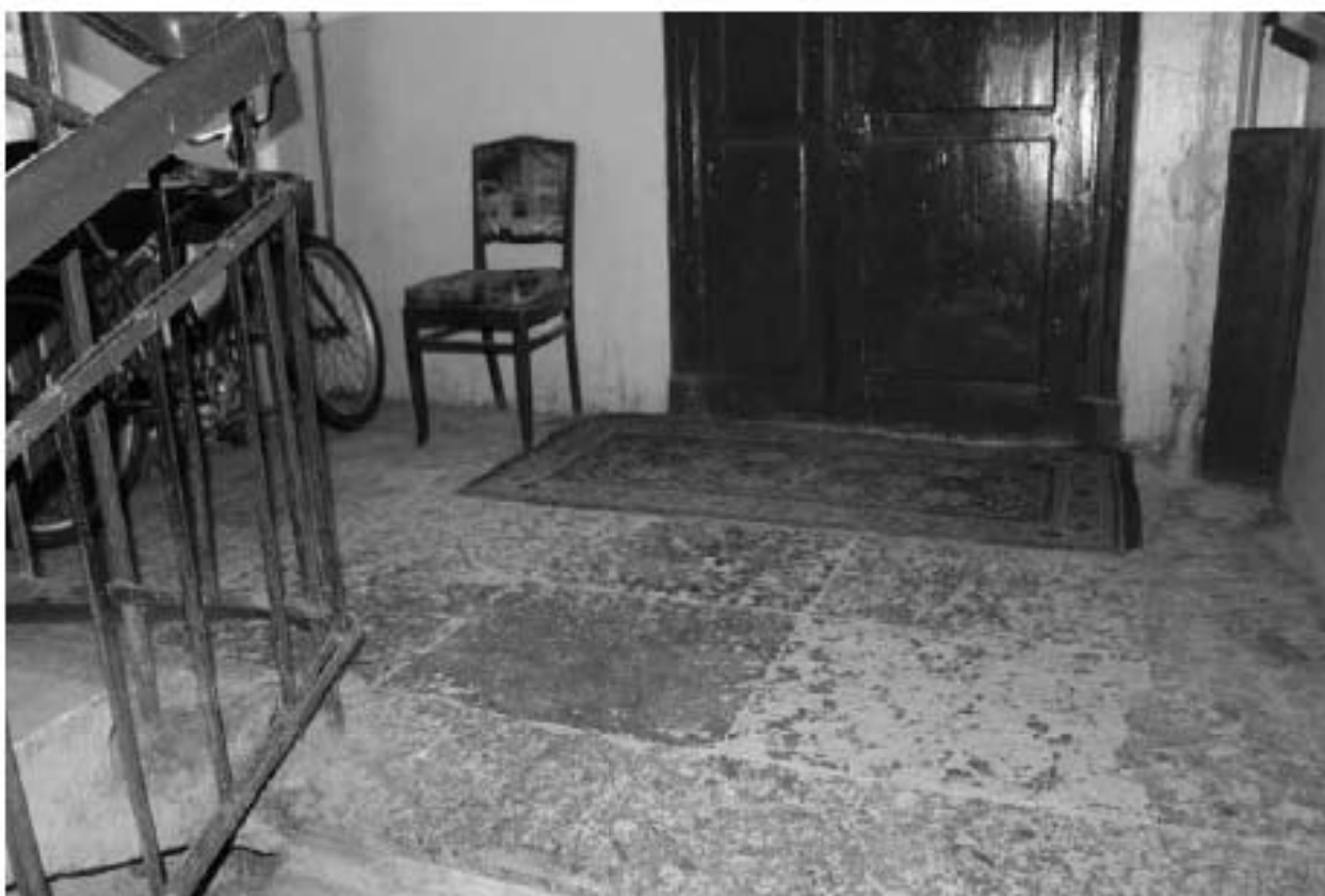
Фото 119. Вид на пол лестничной площадки 1ЛК в уровне 2-го этажа.
