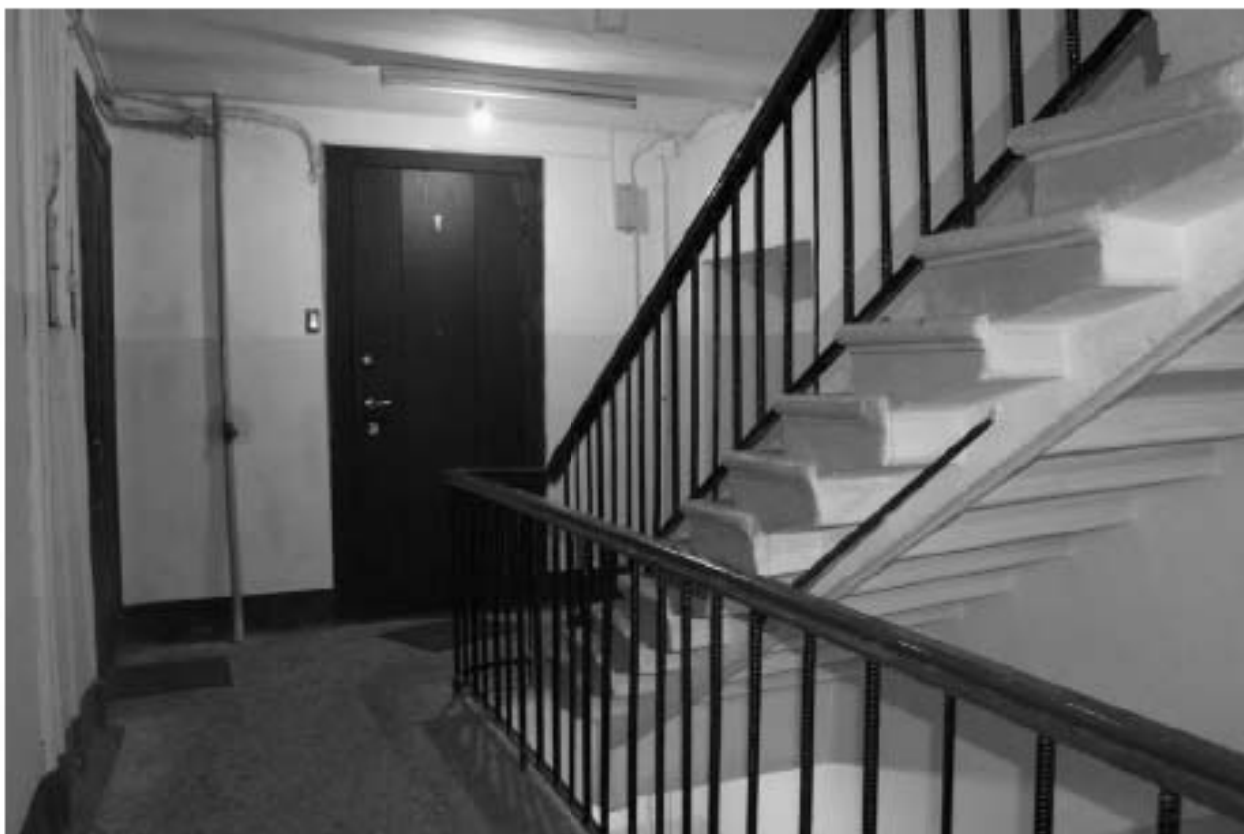
Фото 161. Вид на лестничную площадку ЗЛК в уровне 3-го этажа.
