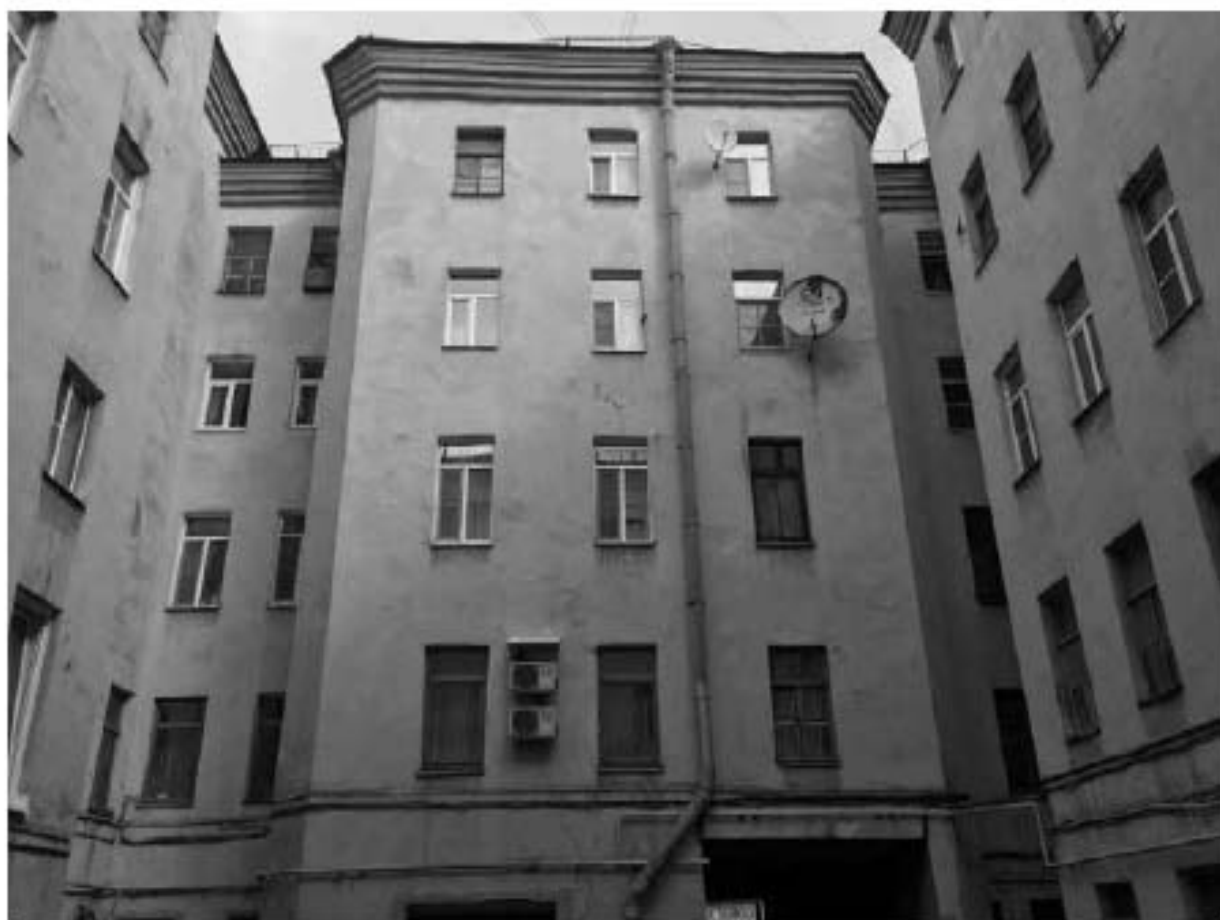
Фото 339. Вид на южный фасад северного корпуса.
