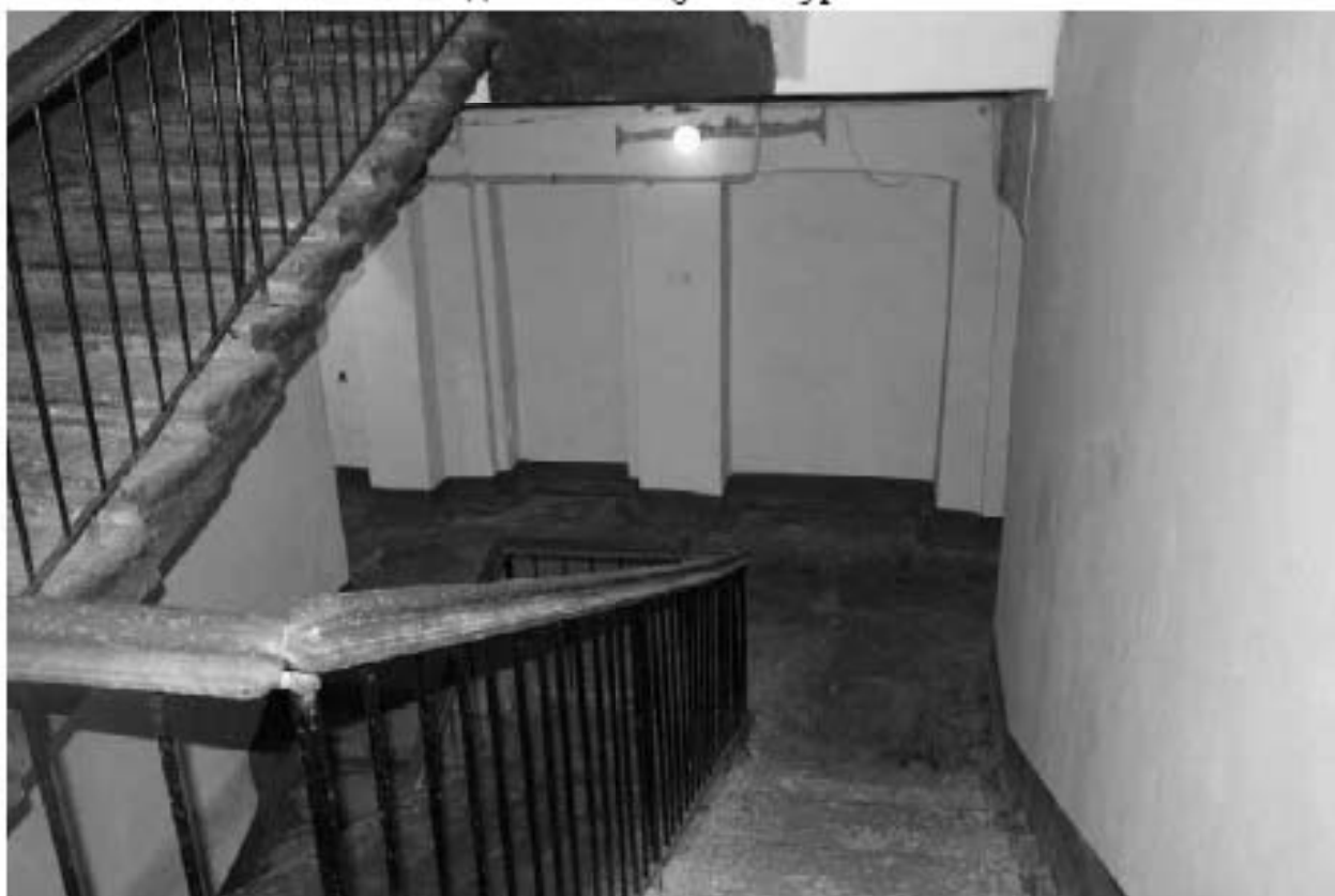
Фото 226. Вид на лестничную площадку Л-1 в уровне 1-го этажа.
