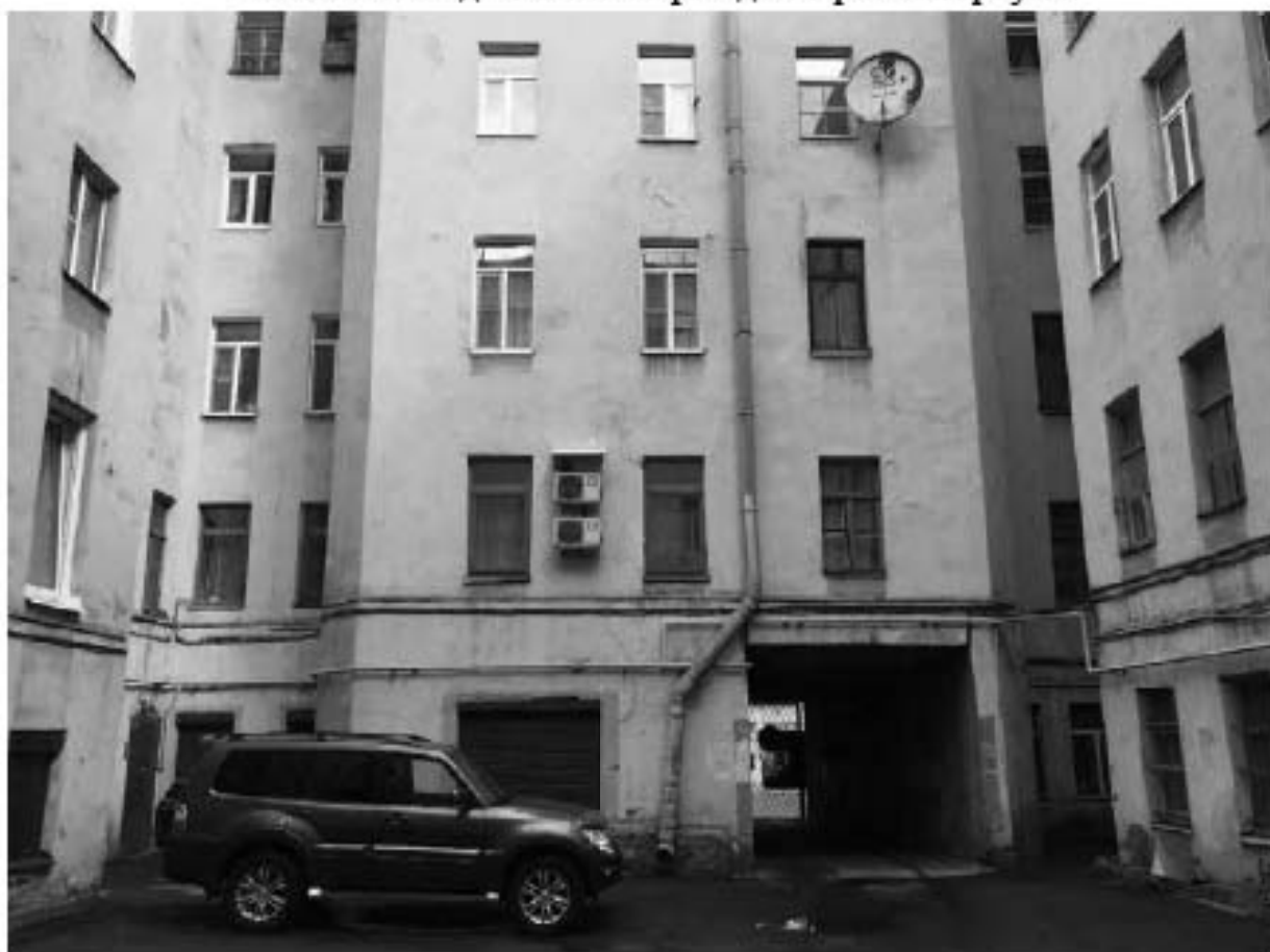
Фото 340. Вид на южный фасад северного корпуса.
