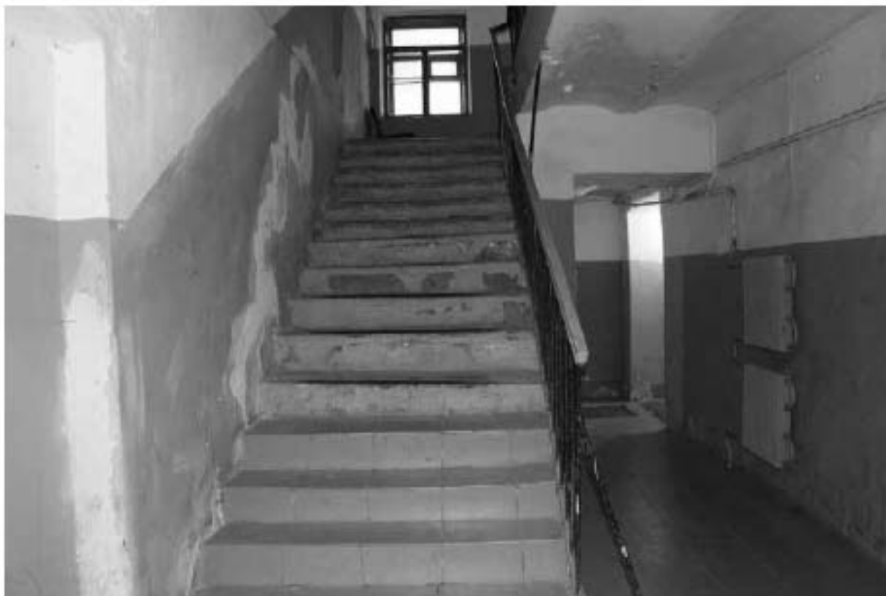
Фото 13. Лестница Л-1 в уровне 1-го этажа.
