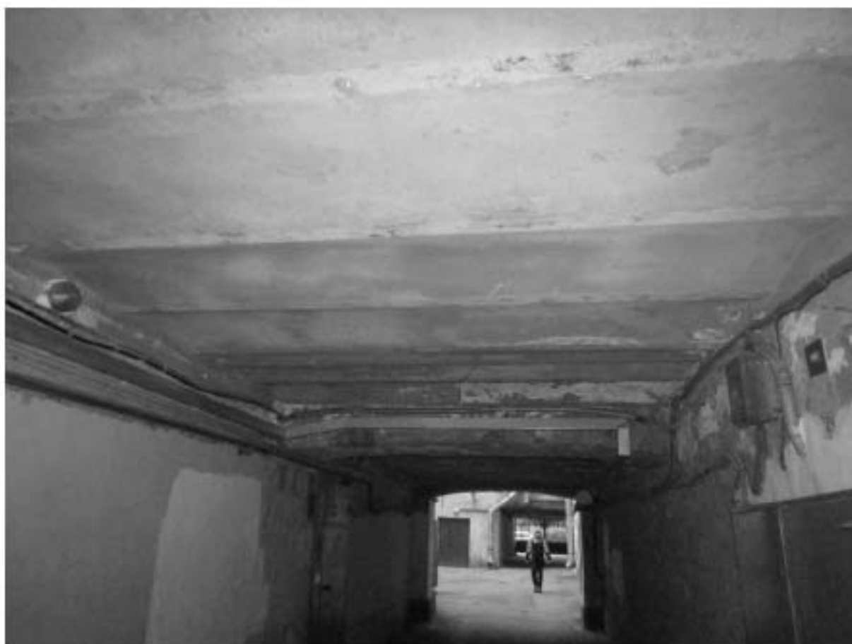
Фото 298. Вид на своды перекрытия южной арки воротного проезда.
