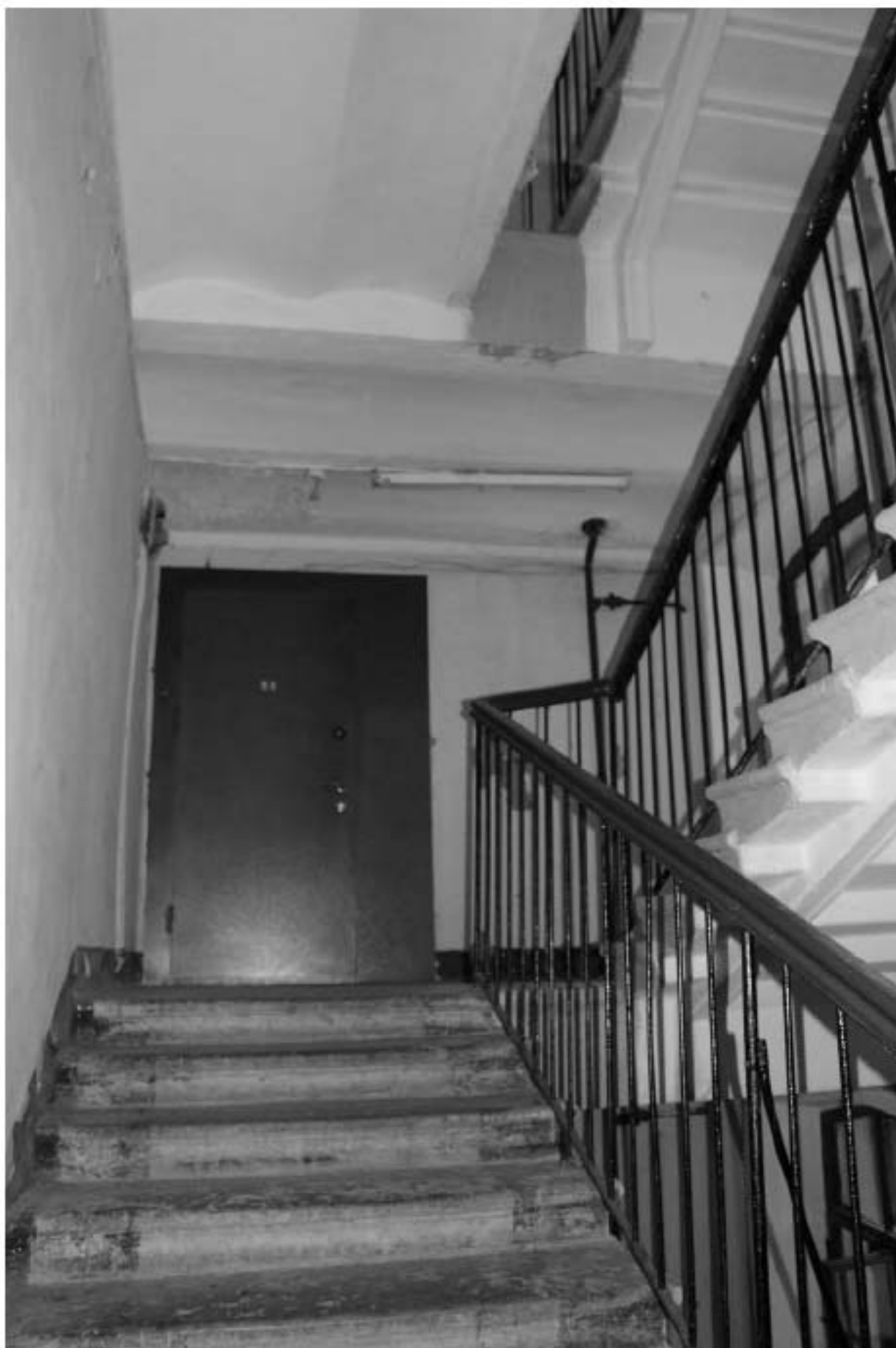
Фото 96. Вид на лестничную площадку ЗЛК в уровне 4-го этажа.
