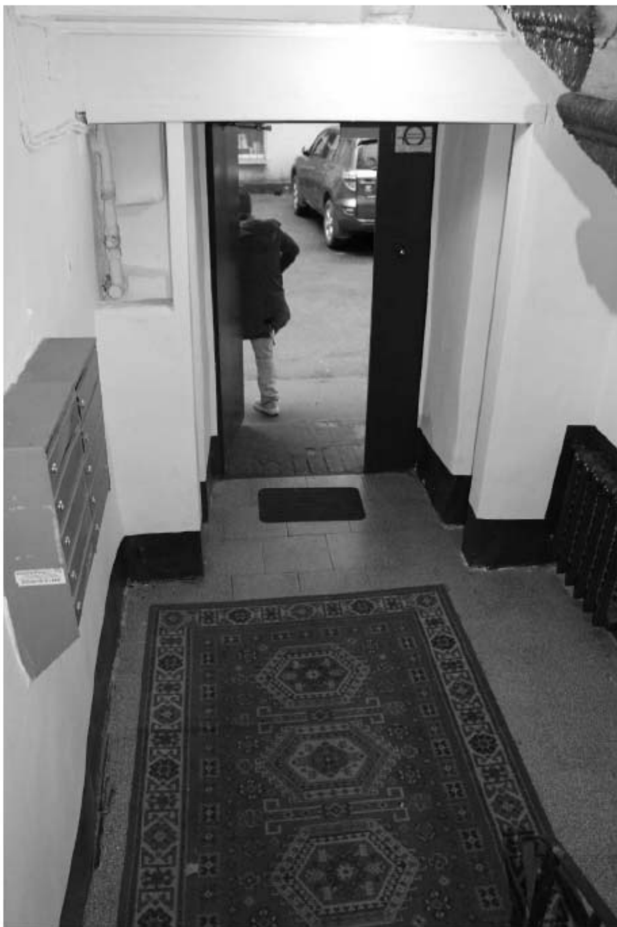
Фото 233. Вид на лестничную клетку Л-2 в уровне 1-го этажа.
