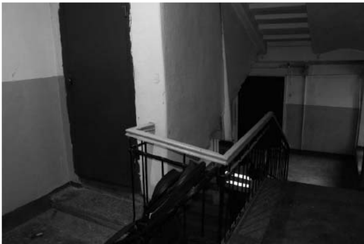
Фото 283. Лестница Л-2 в уровне 6-го этажа.
