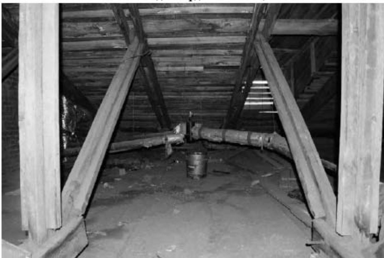
Фото 62. Вид на чердачные помещения.
