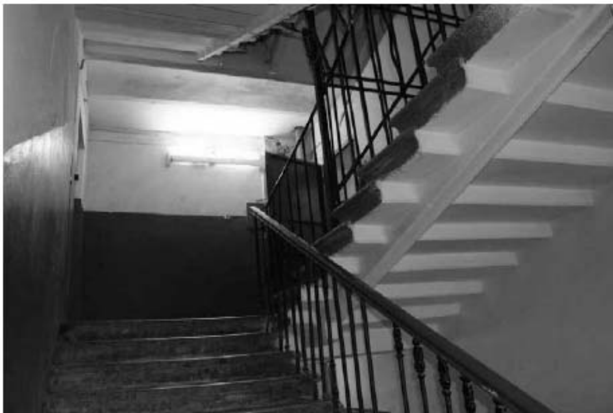
Фото 23. Вид на лестничную площадку Л-1 в уровне 6-го этажа.
