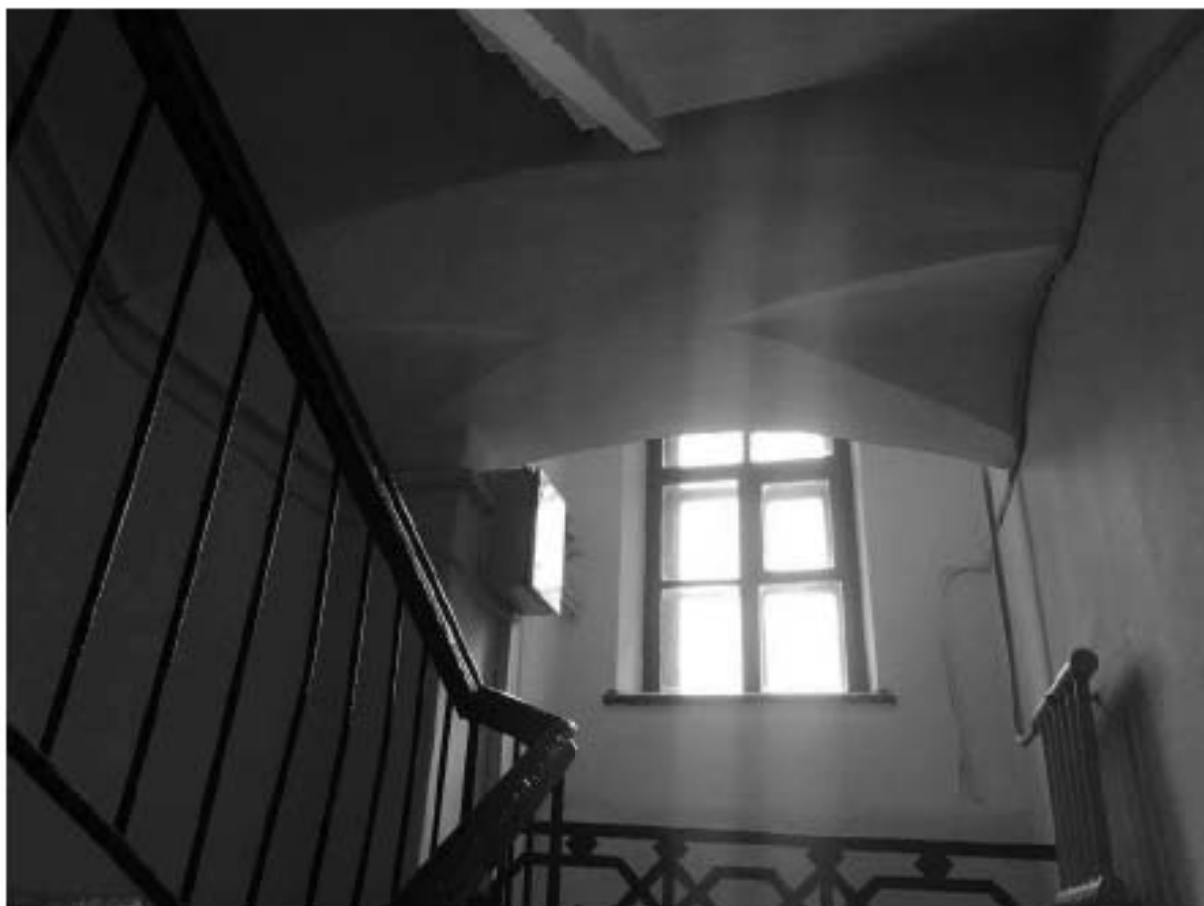
Фото 307. Вид на междуэтажную площадку 1ЛК в уровне 1-го – 2-го этажей.
