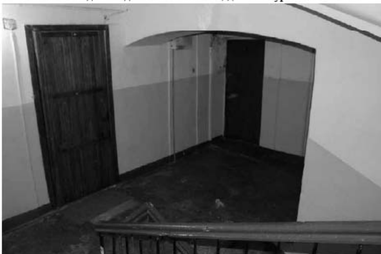
Фото 260. Вид на лестничную площадку Л-5 в уровне 5-го этажа.
