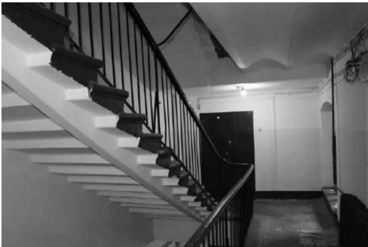
Фото 204. Вид на лестничную площадку ЗЛК в уровне 2-го этажа.
