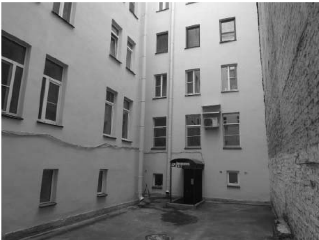
Фото 115. Вид на территорию к северу от северного корпуса.
