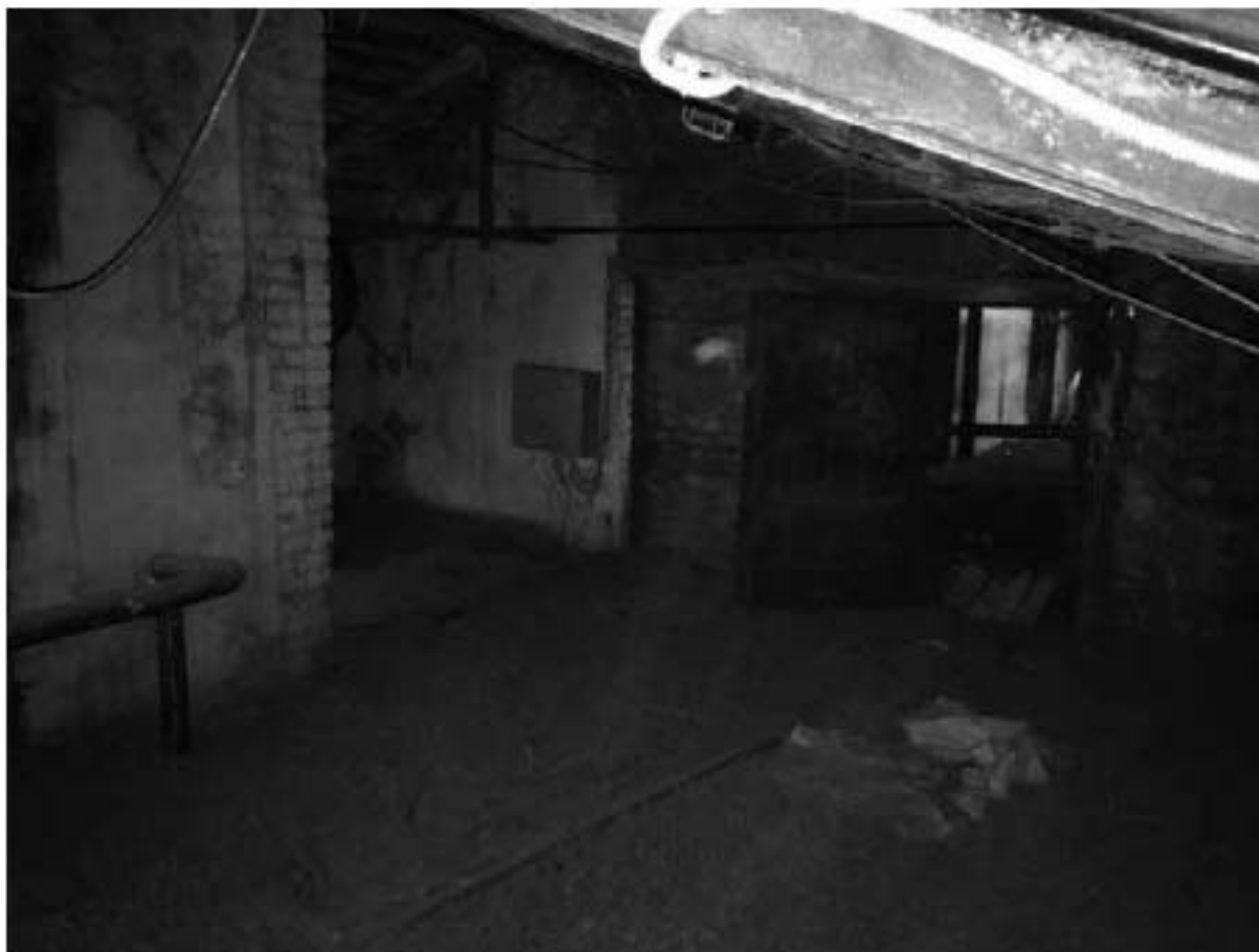
Фото 331. Вид на чердачные помещения.
