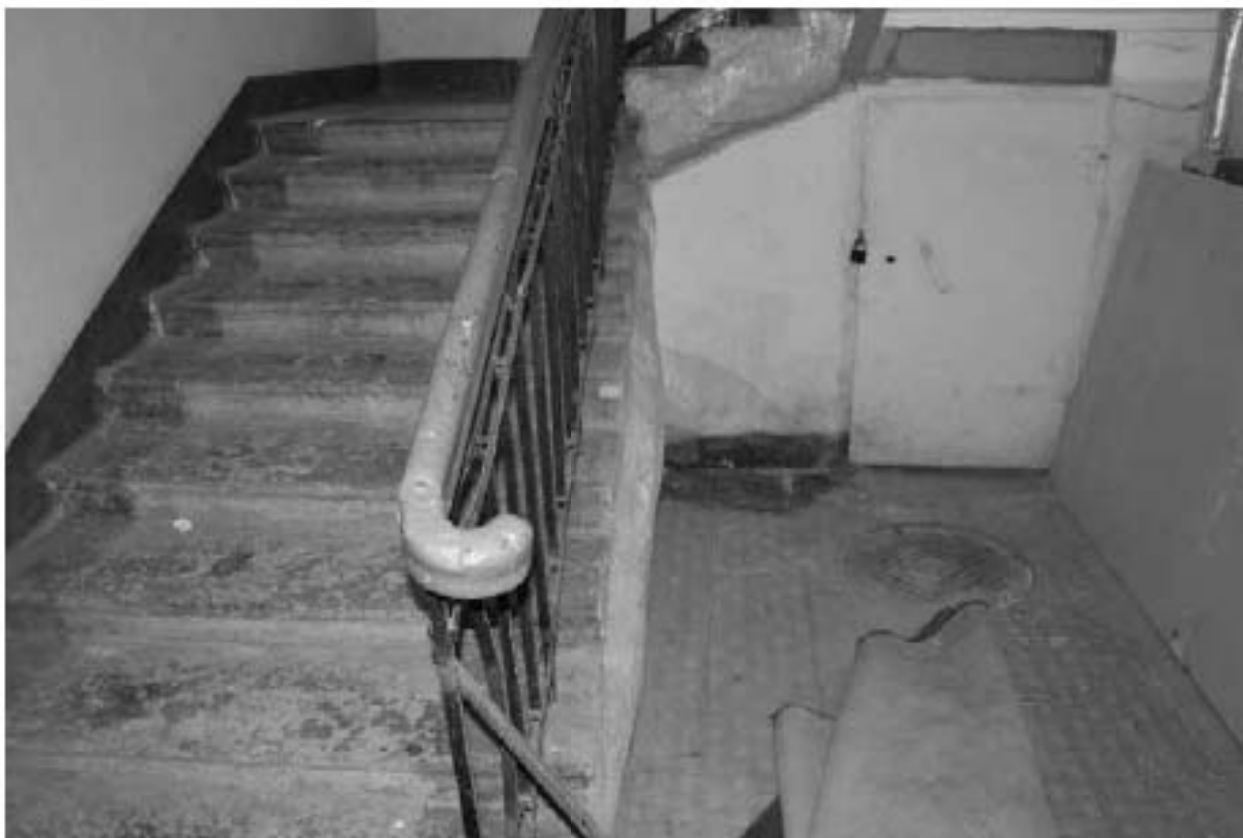
Фото 124. Вид на лестничную клетку 2ЛК в уровне 1-го этажа.
