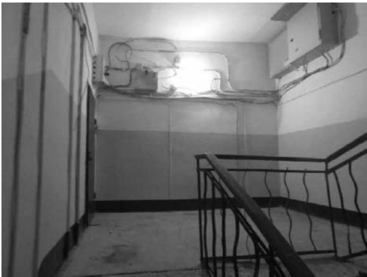
Фото 196. Вид на лестницу 1ЛК в уровне 6-го этажа.
