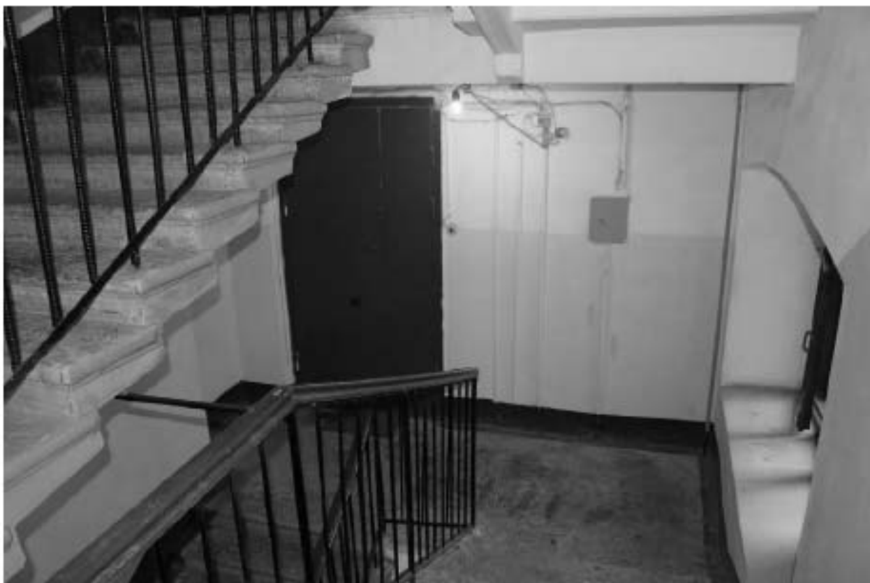
Фото 163. Вид на лестничную площадку ЗЛК в уровне 5-го этажа.
