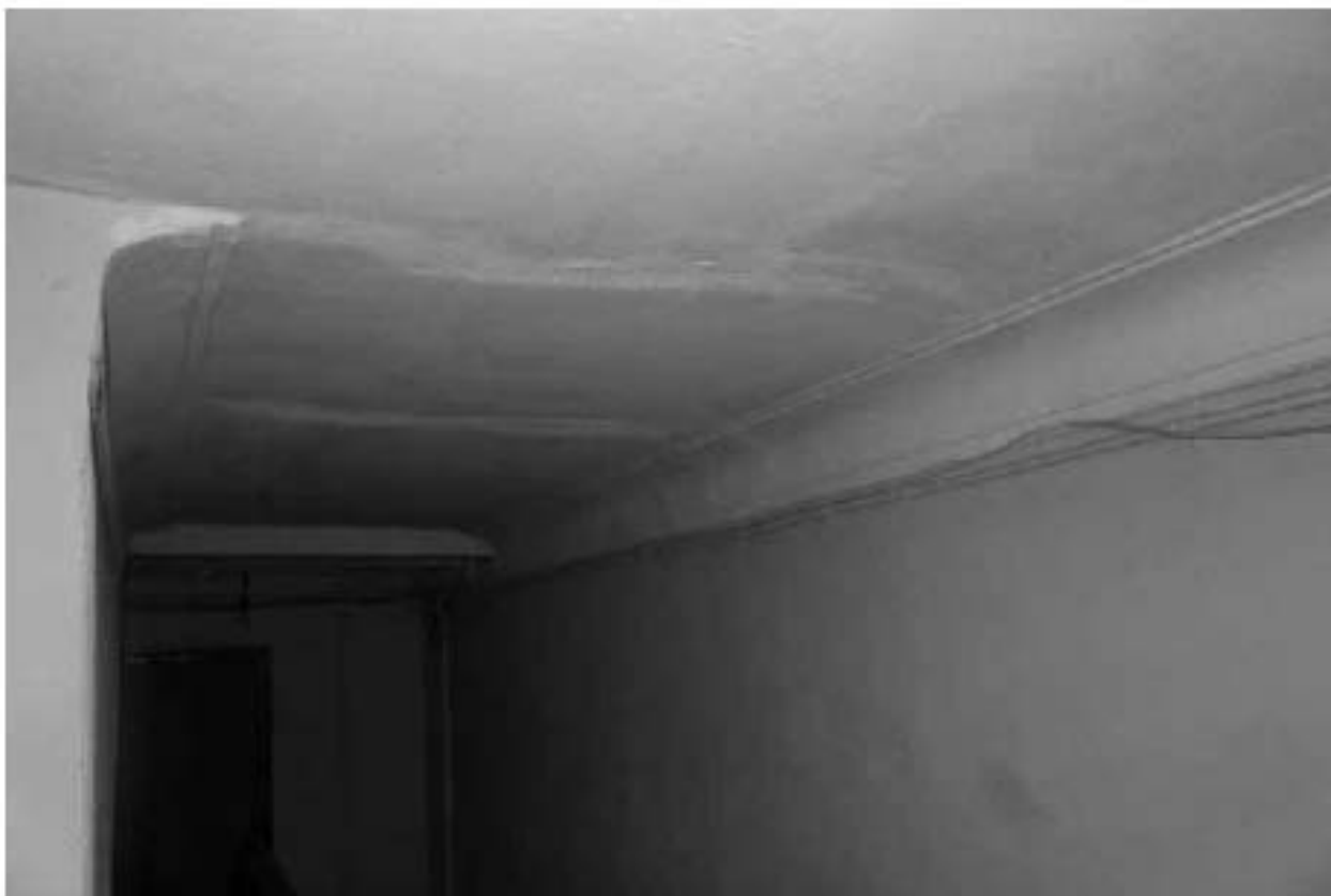
Фото 97. Вид на потолок лестничной клетки 3ЛК в уровне 6-го этажа.
