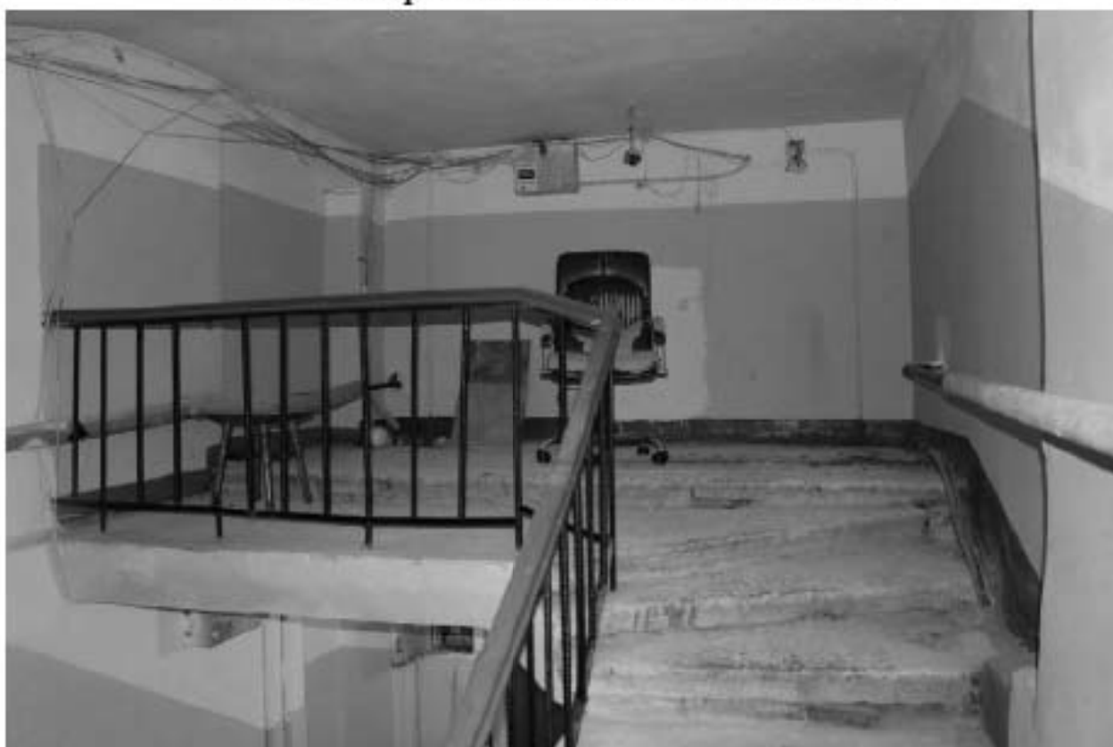
Фото 173. Верхний этаж лестничной клетки 4ЛК.
