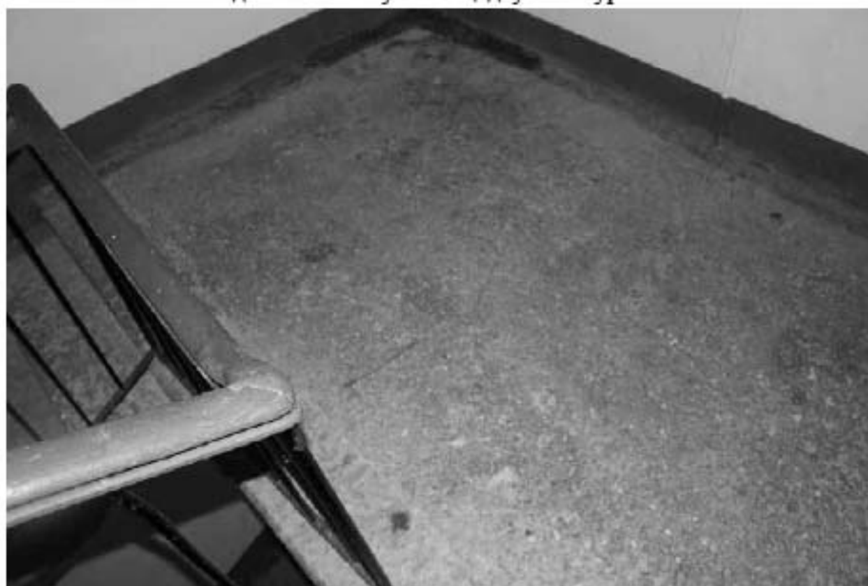
Фото 230. Вид на пол междуэтажной площадки Л-1 в уровне 3-го – 4-го этажей.
