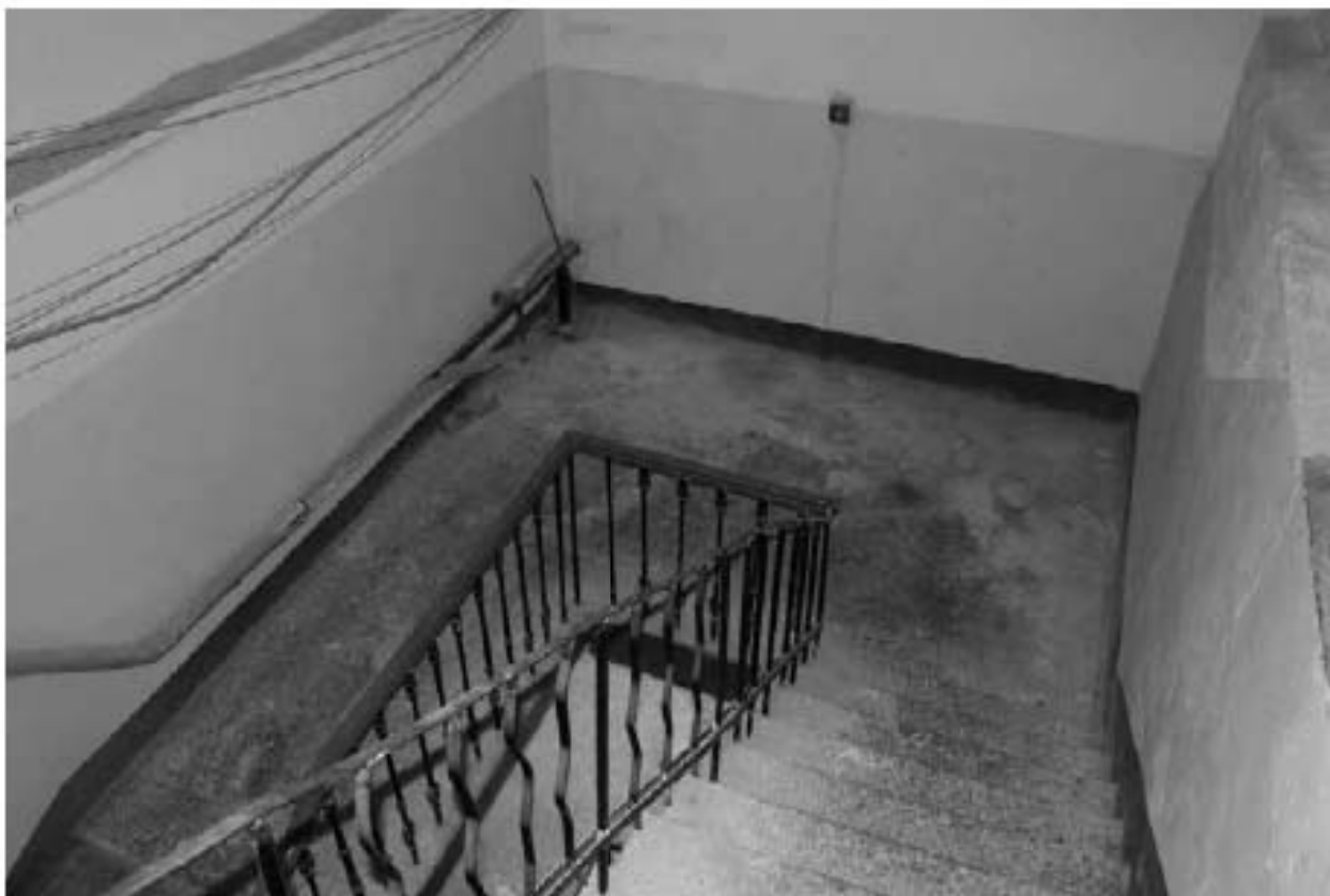
Фото 55. Междуэтажная площадка Л-3 в уровне 6-го этажа.
