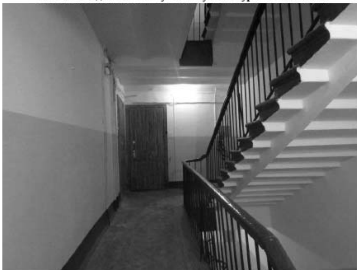
Фото 193. Вид на лестничную клетку 1ЛК в уровне 3-го этажа.
