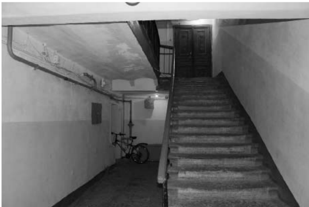
Фото 273. Лестничная клетка Л-1 в уровне 1-го этажа.
