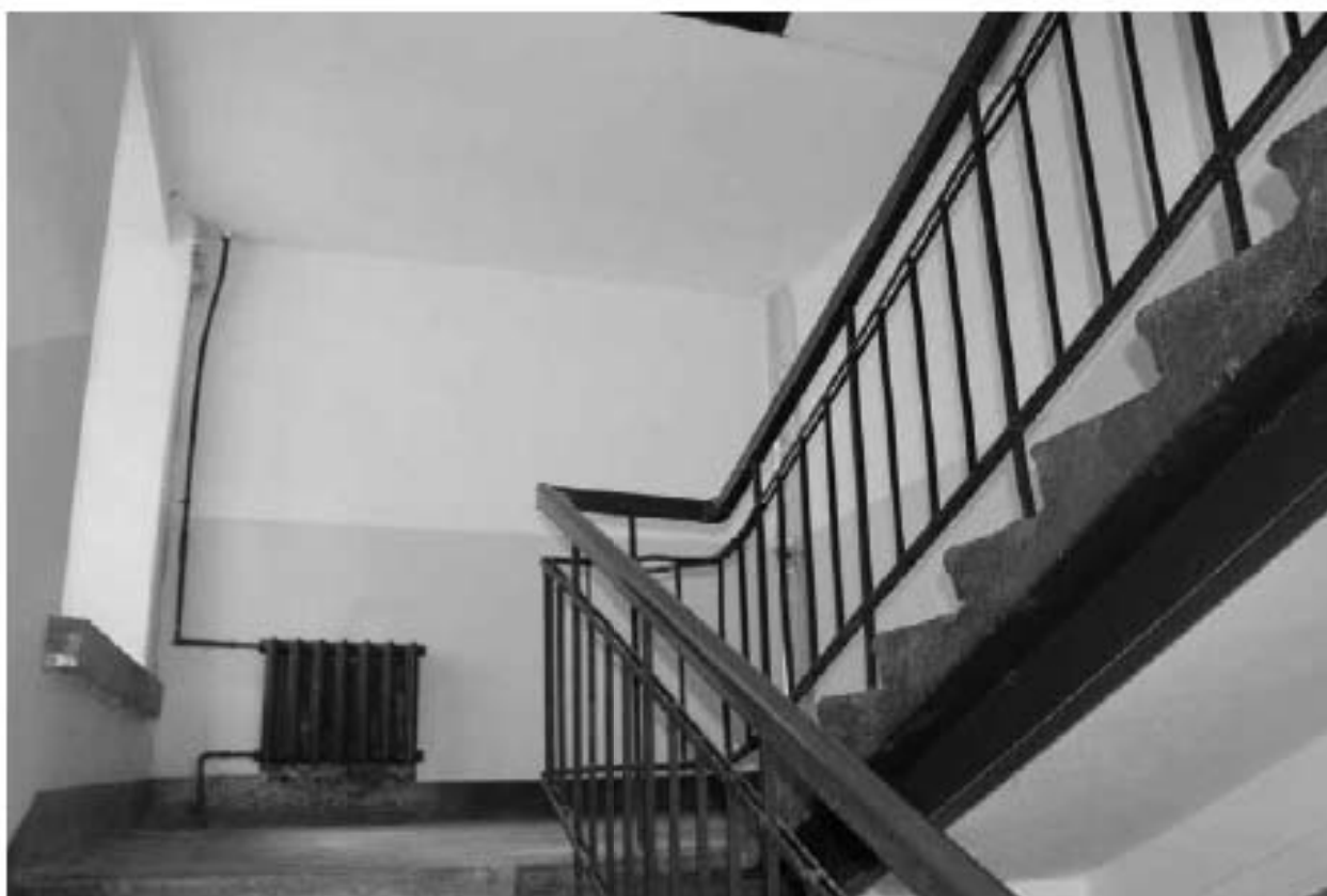
Фото 136. Вид на междуэтажную площадку 4ЛК в уровне 1-го – 2-го этажей.
