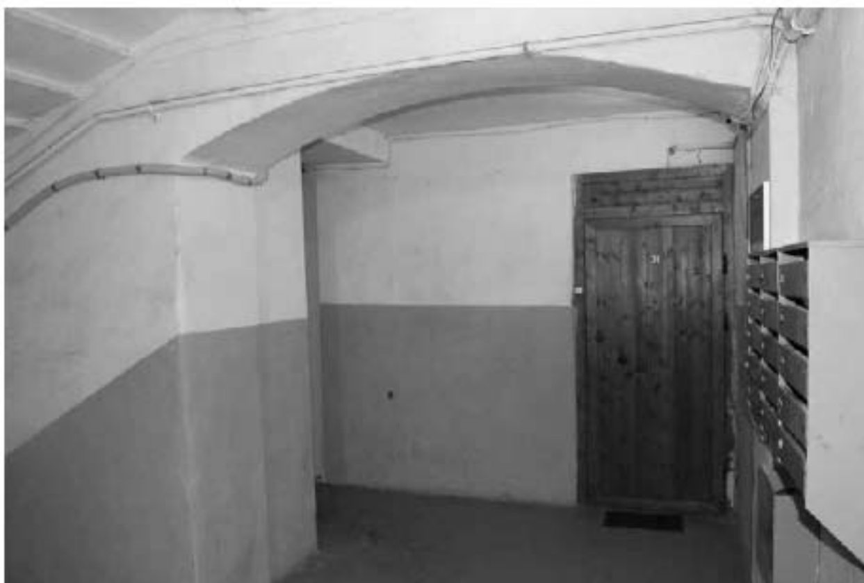
Фото 249. Вид на арку лестничной клетки Л-4 в уровне 1-го этажа.
