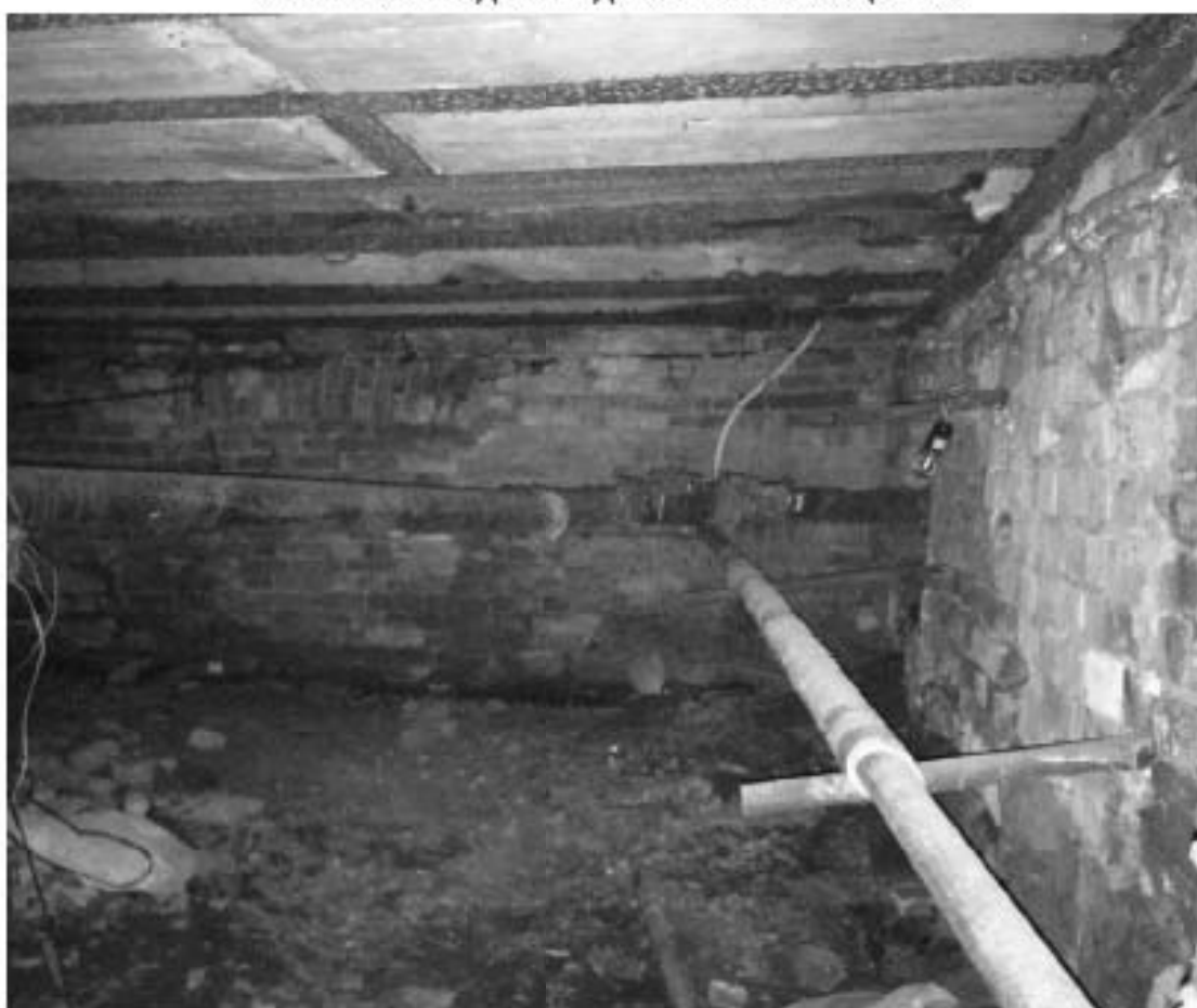
Фото 346. Вид на подвальные помещения.
