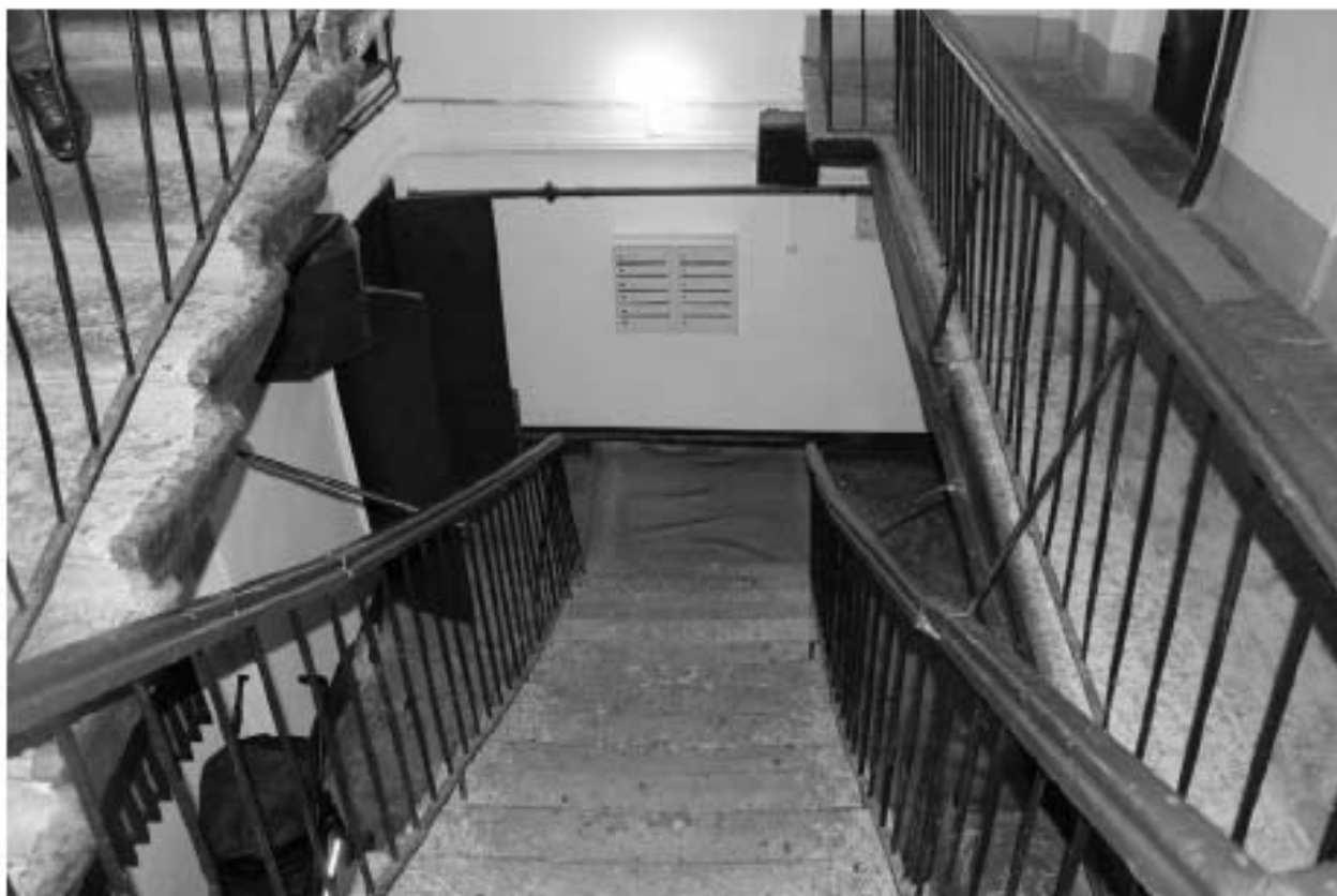
Фото 287. Лестница Л-4 в уровне 1-го этажа.
