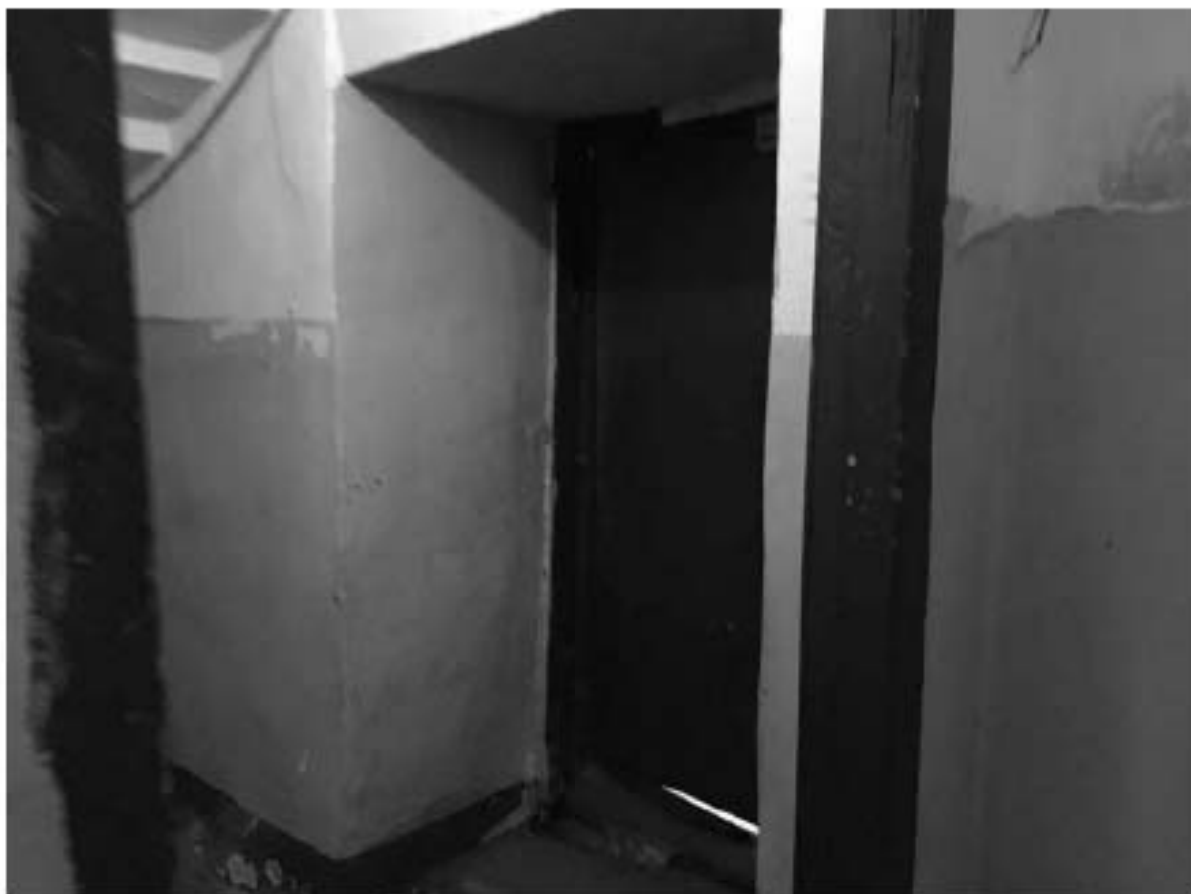
Фото 361. Вид на вход в Л-3.
