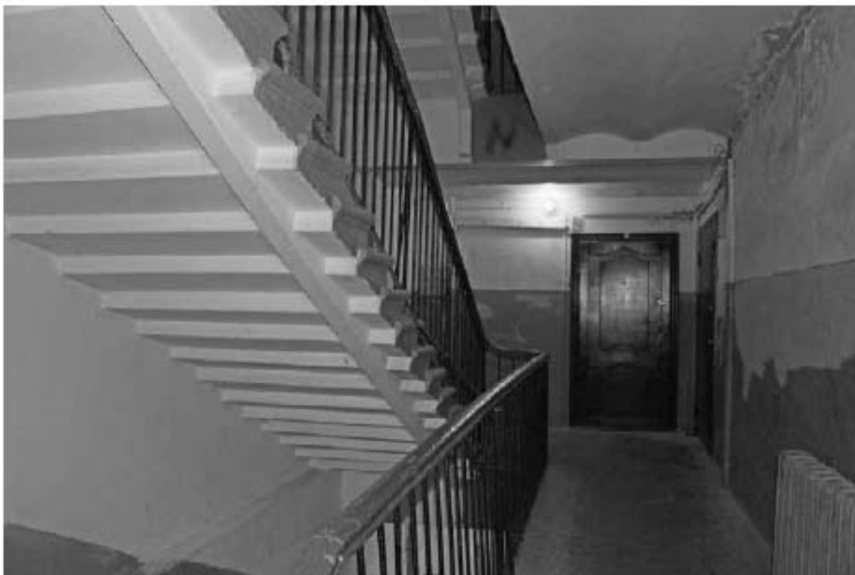
Фото 210. Вид на лестничную клетку 4ЛК в уровне 2-го этажа.
