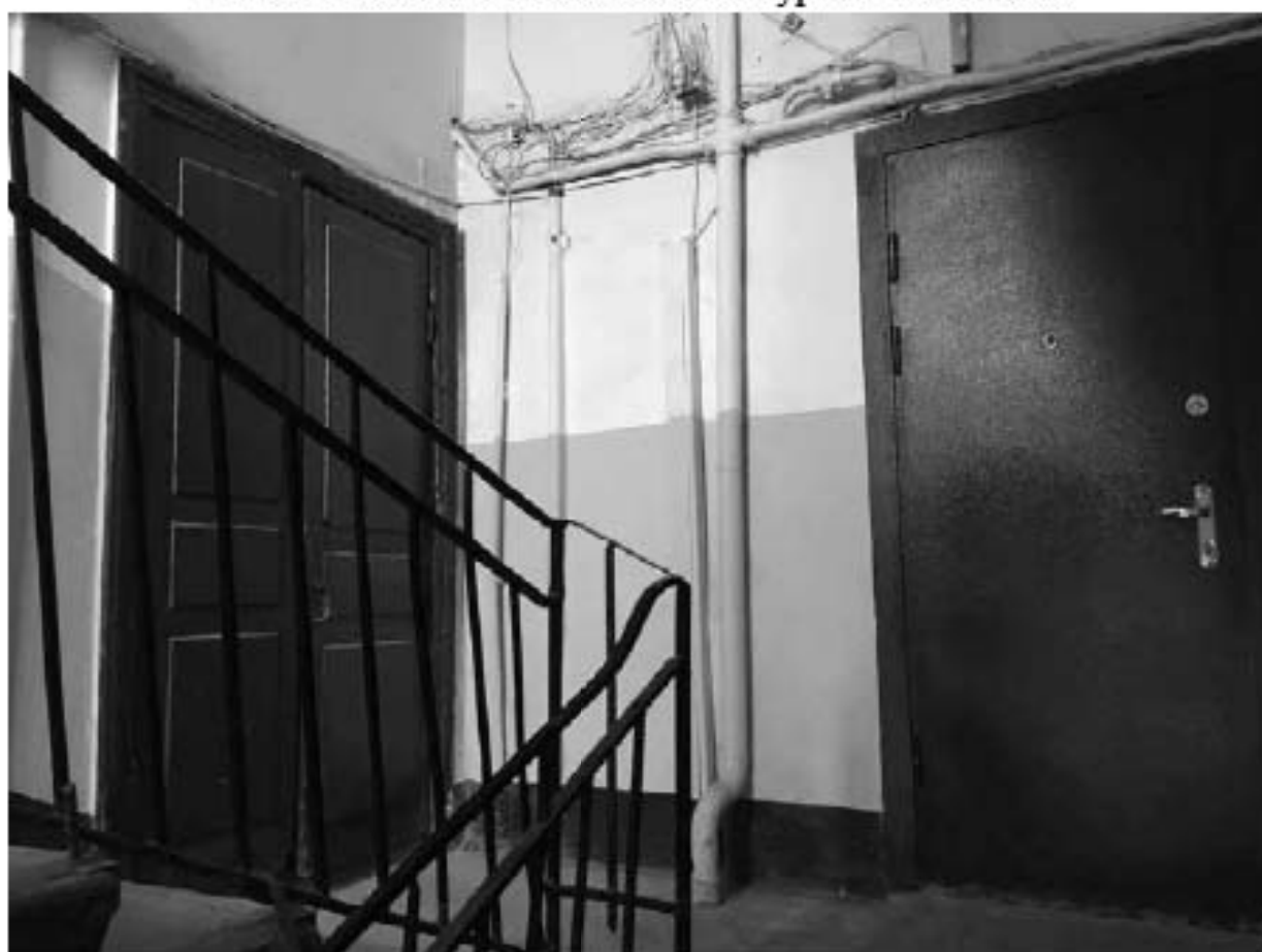
Фото 326. Вид на лестничную площадку Л-5 в уровне 2-го этажа.
