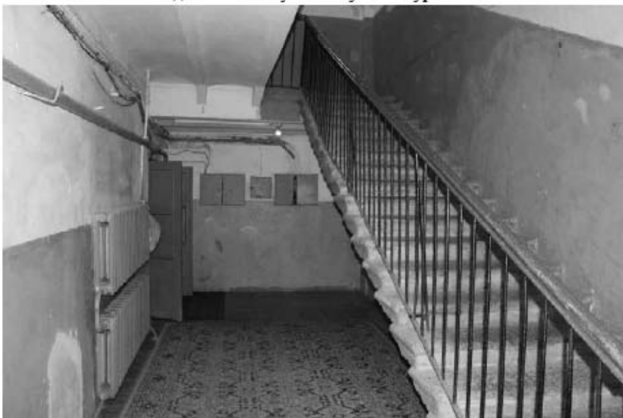
Фото 209. Вид на лестничную клетку 4ЛК в уровне 1-го этажа.
