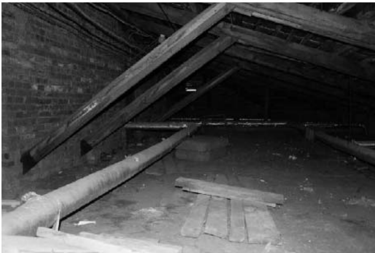
Фото 61. Вид на чердачные помещения.
