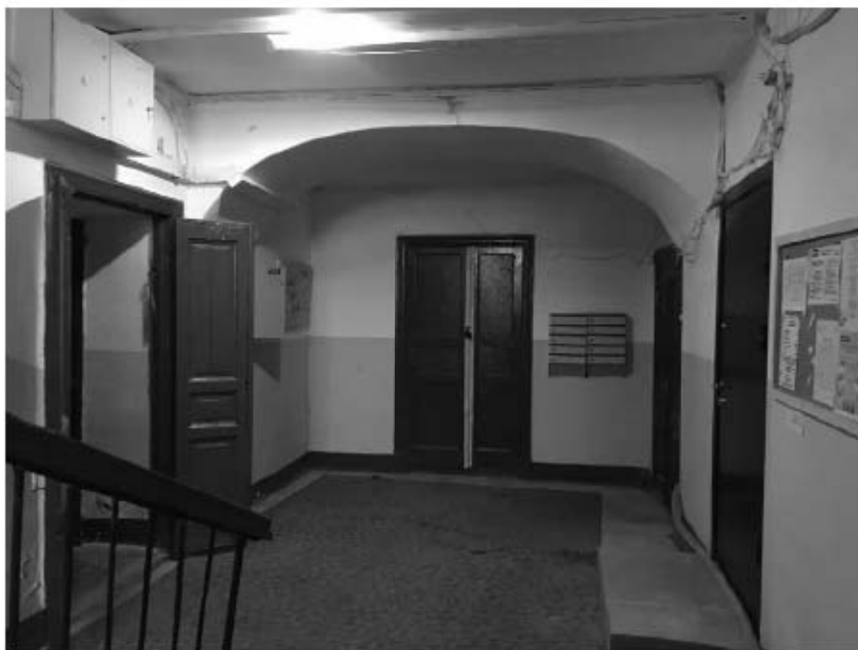
Фото 313. Вид на лестничную клетку Л-2 в уровне 1-го этажа.
