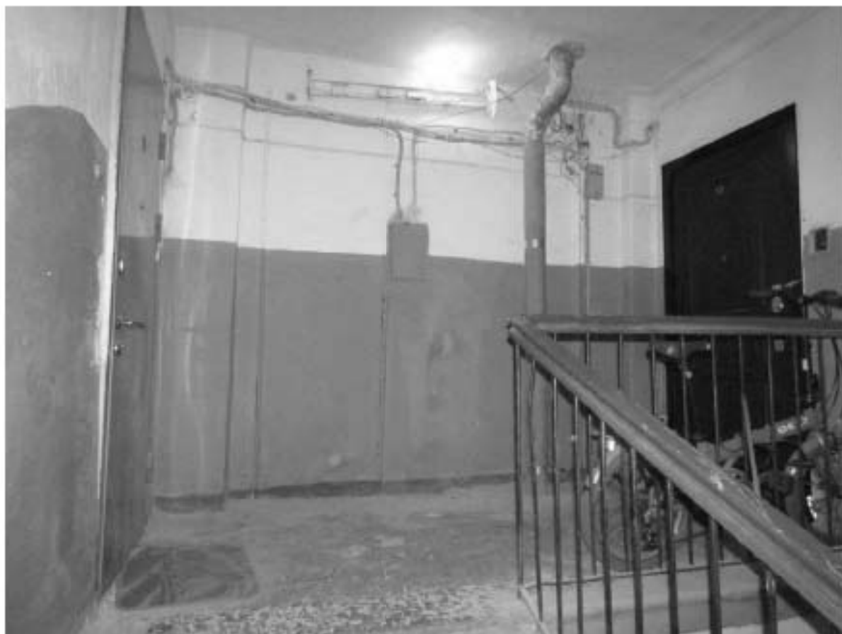
Фото 353. Вид на лестничную площадку Л-1 в уровне 5-го этажа.
