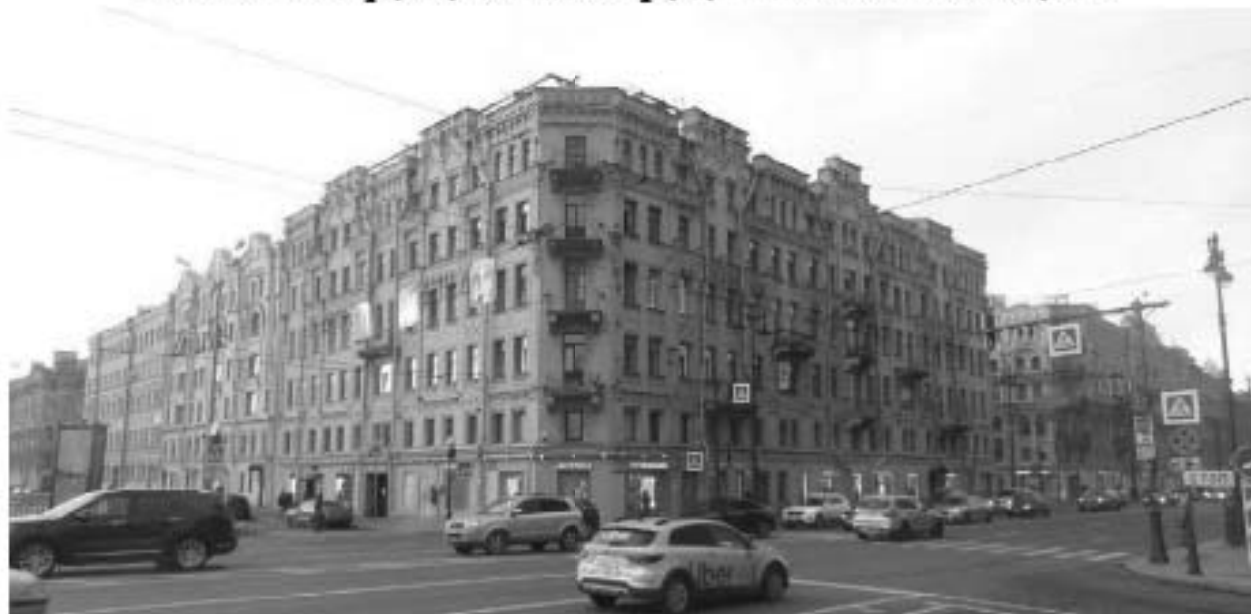
Фото 63. Вид на юго-восточный угол дома.
