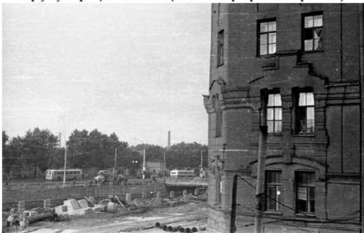
Илл. 150. Вид на обводный канал из дома № 135 (дом № 11 по Угловому пер. справа). 1966 г. (источник: https://pastvu.com/p/285087 ).
