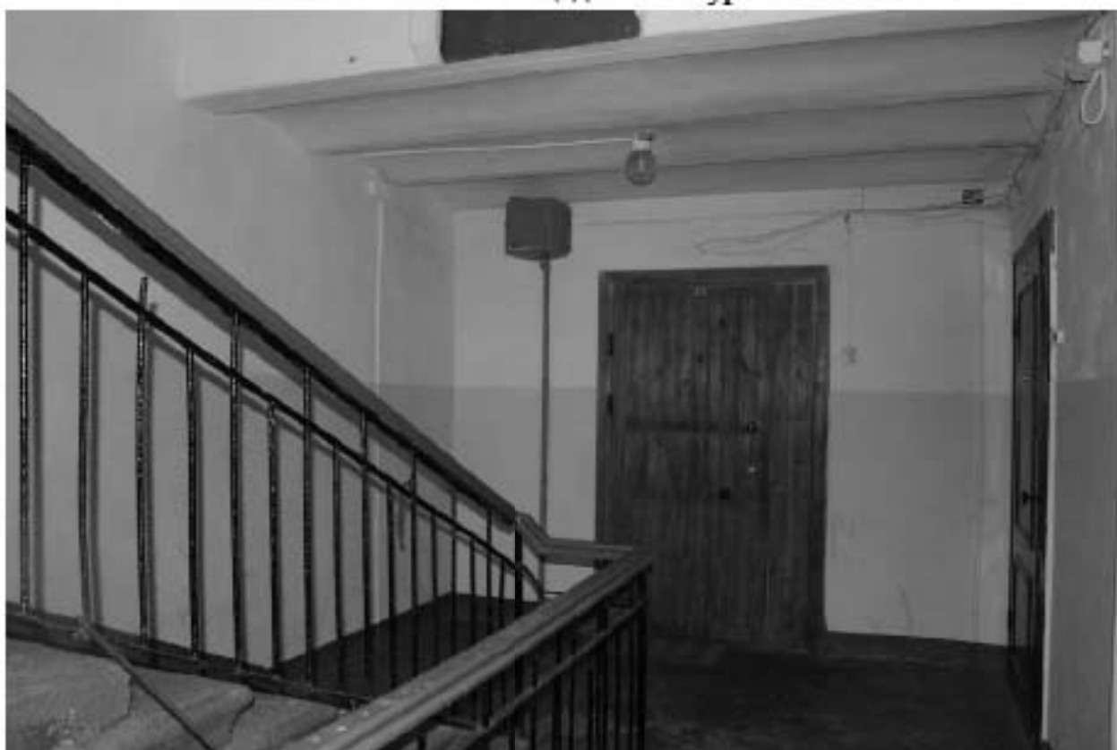
Фото 276. Лестничная площадка Л-1 в уровне 4-го этажа.
