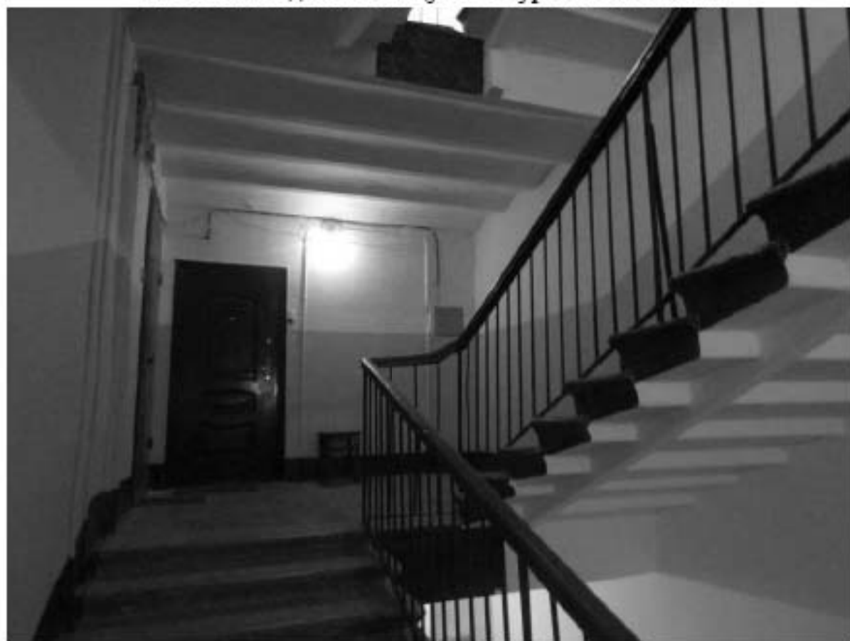
Фото 195. Вид на лестничную площадку 1ЛК в уровне 5-го этажа.
