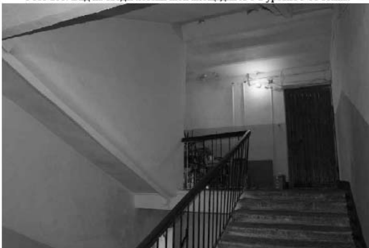
Фото 262. Вид на лестничную площадку Л-5 в уровне 6-го этажа.
