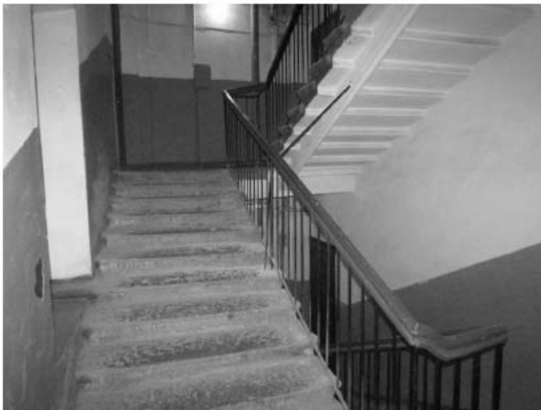
Фото 351. Вид на лестницу Л-1 в уровне 2-го – 3-го этажей.
