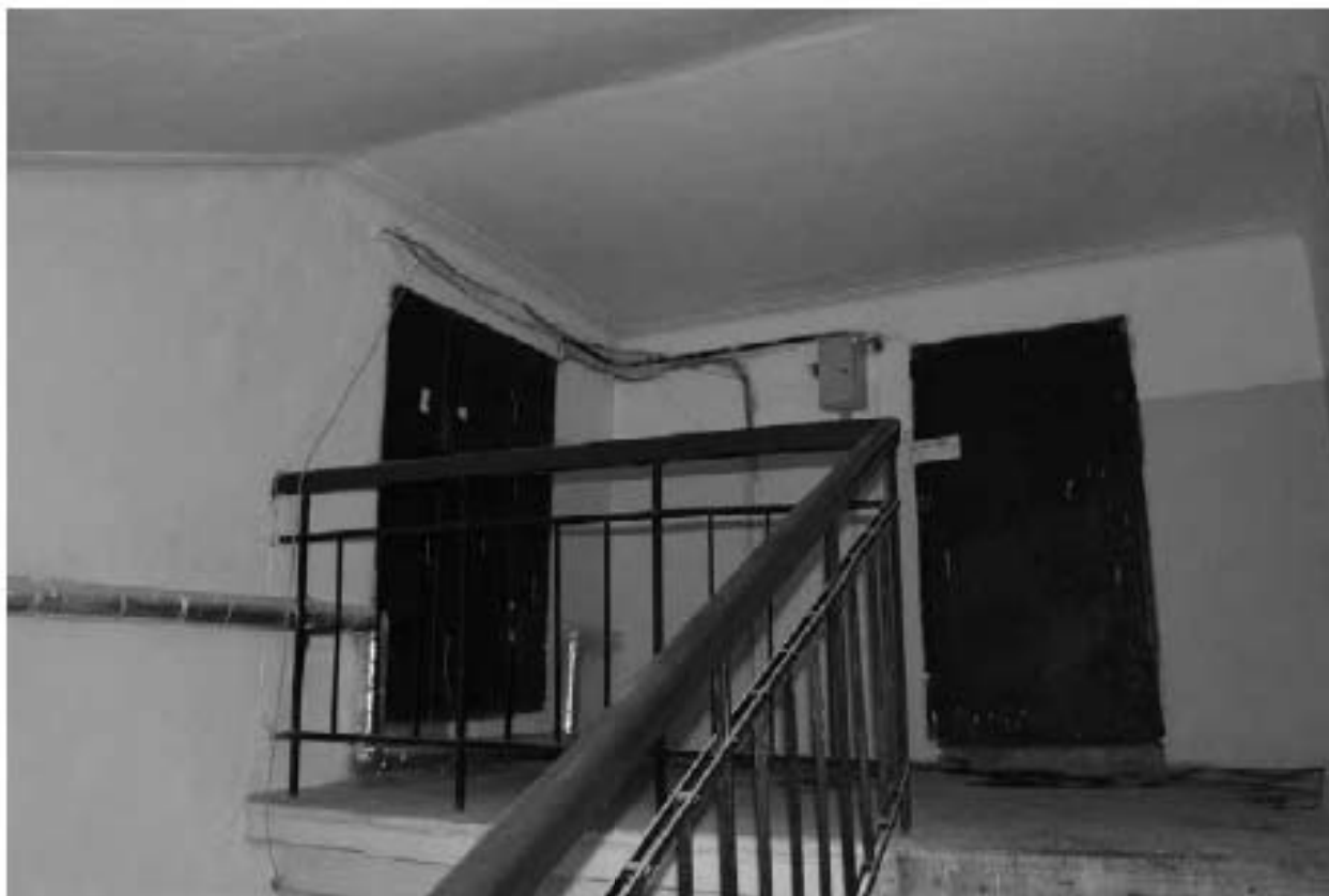
Фото 144. Вид на лестничную площадку 5ЛК в уровне 6-го этажа.
