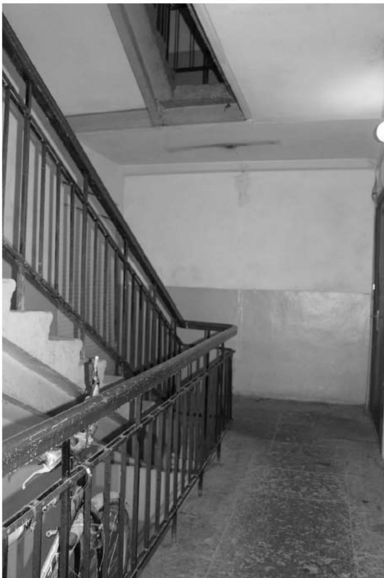
Фото 121. Вид на лестничную клетку 1ЛК в уровне 3-го этажа.
