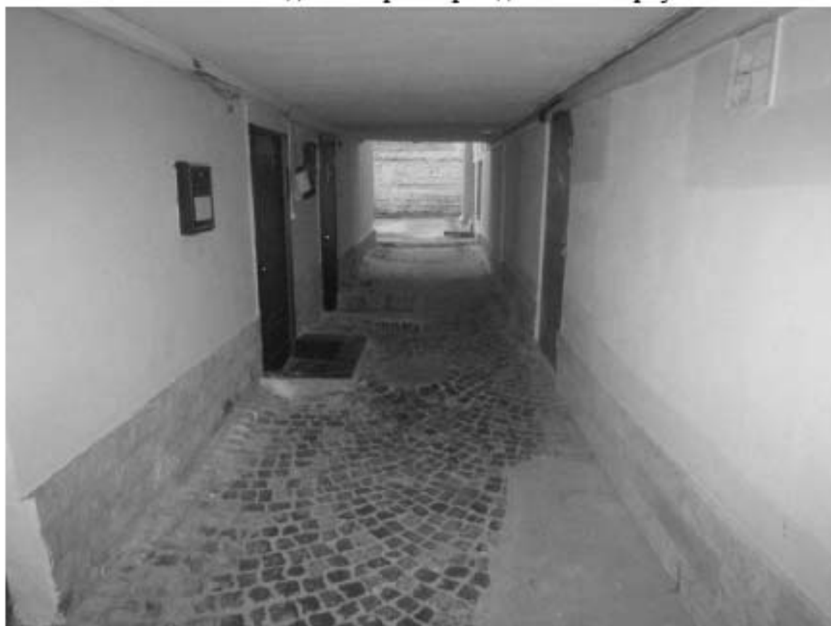
Фото 114. Арка воротного проезда в северном корпусе.
