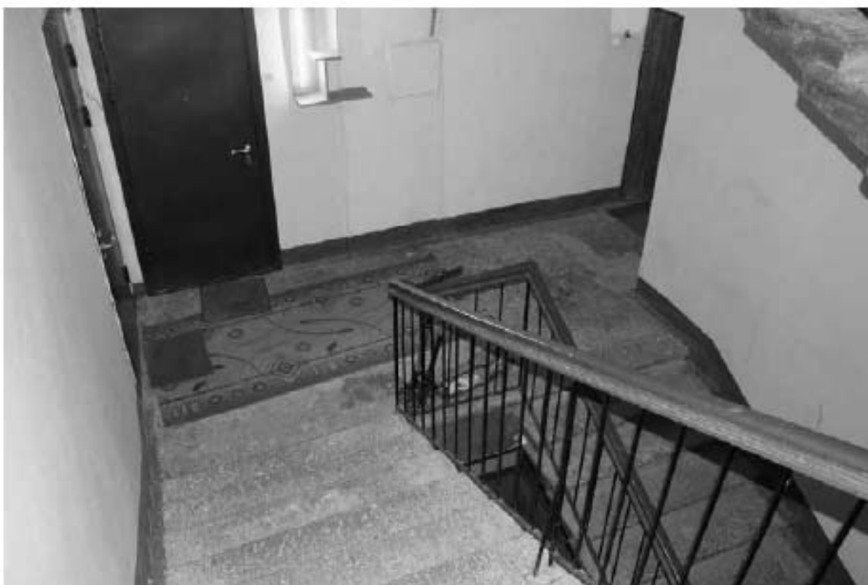
Фото 243. Вид на лестничную площадку Л-3 в уровне 3-го этажа.
