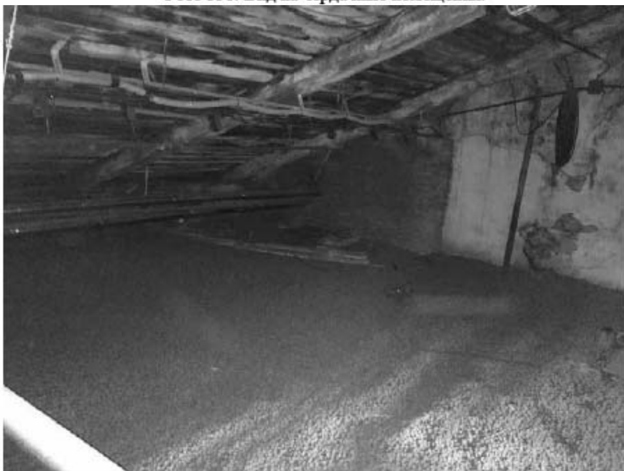
Фото 332. Вид на чердачные помещения.
