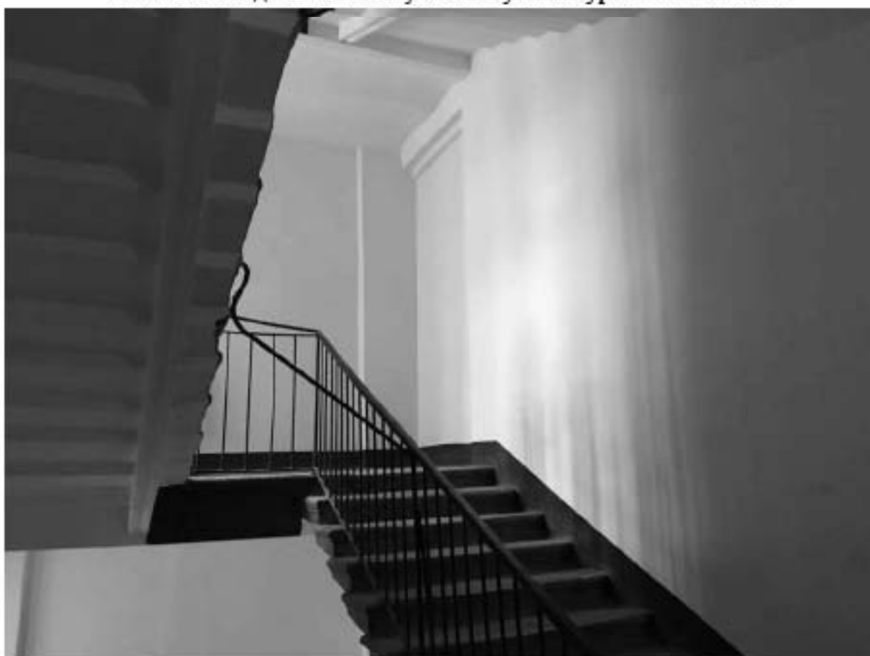
Фото 358. Вид на междуэтажную площадку Л-2 в уровне 2-го – 3-го этажей.
