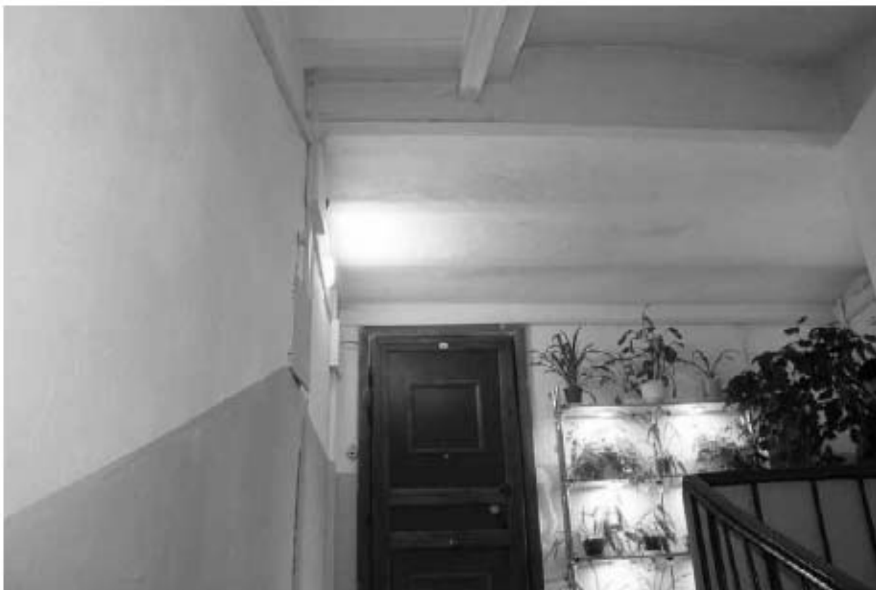
Фото 253. Вид на лестничную клетку Л-4 в уровне 6-го этажа.
