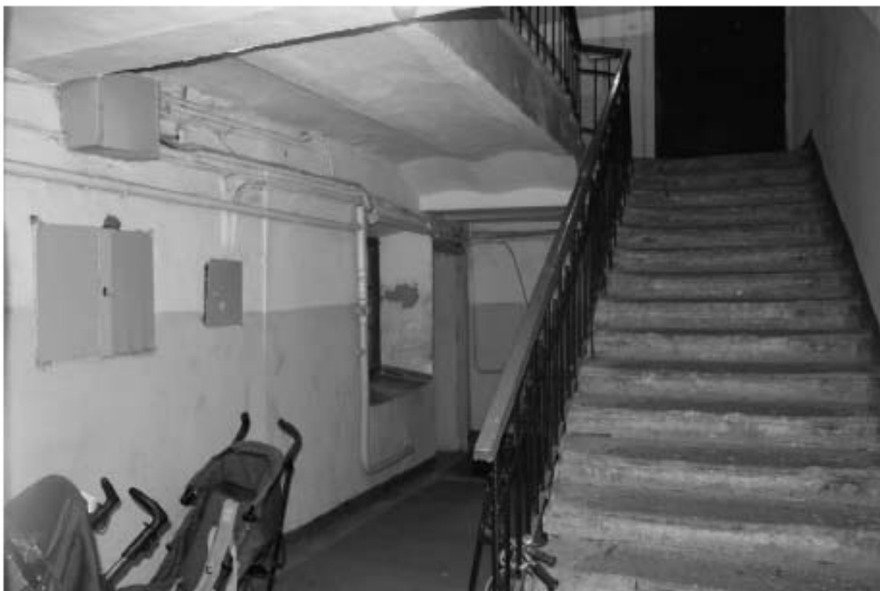
Фото 168. Лестничная клетка 4ЛК в уровне 1-го этажа.
