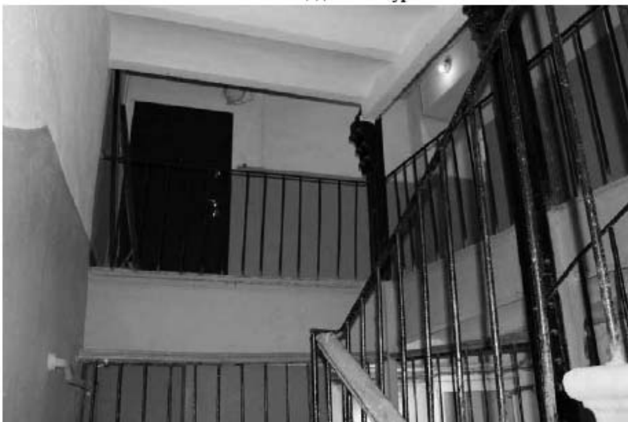
Фото 32. Вид на междуэтажную площадку Л-2 в уровне 2-го – 3-го этажей.
