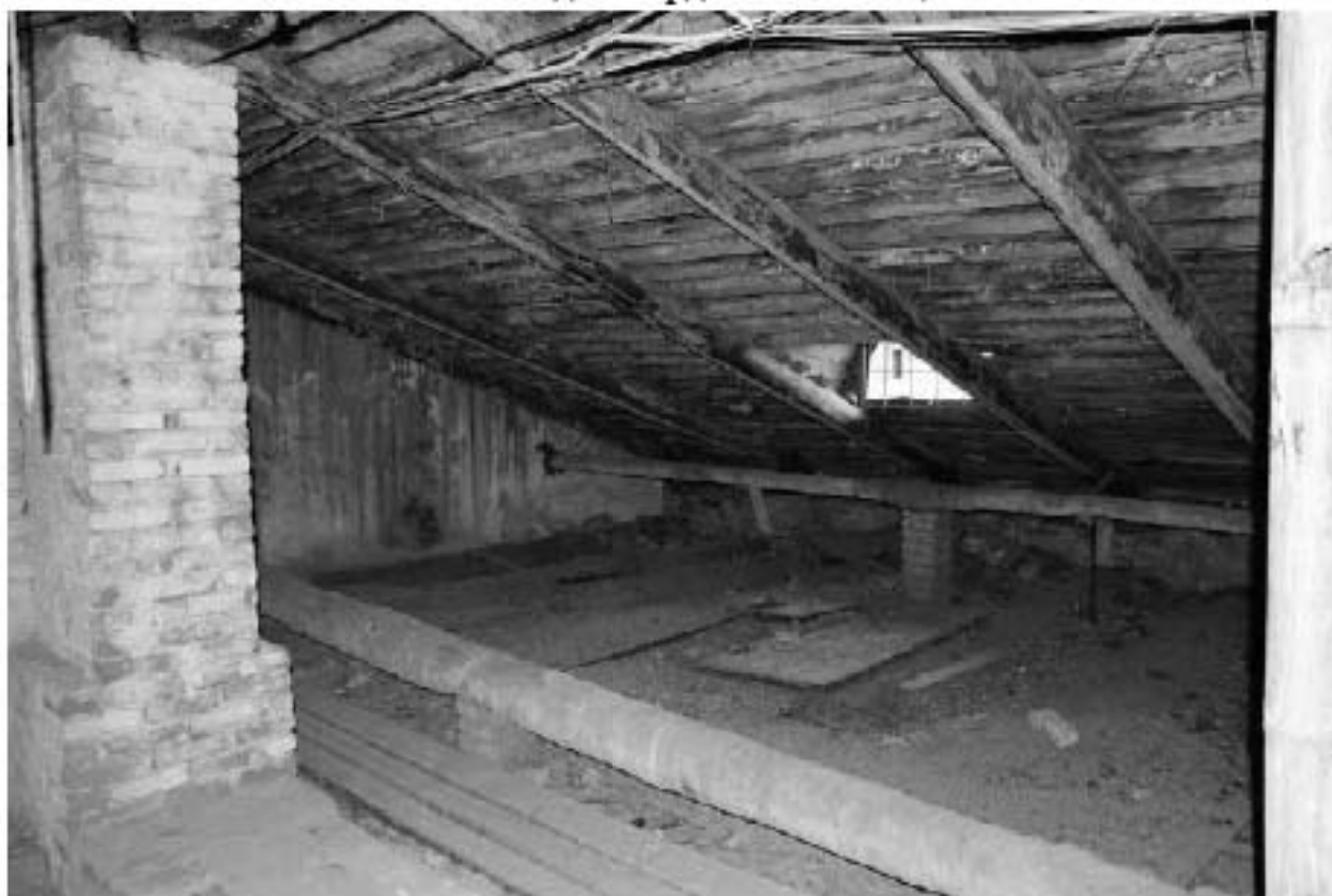
Фото 104. Вид на чердачные помещения.
