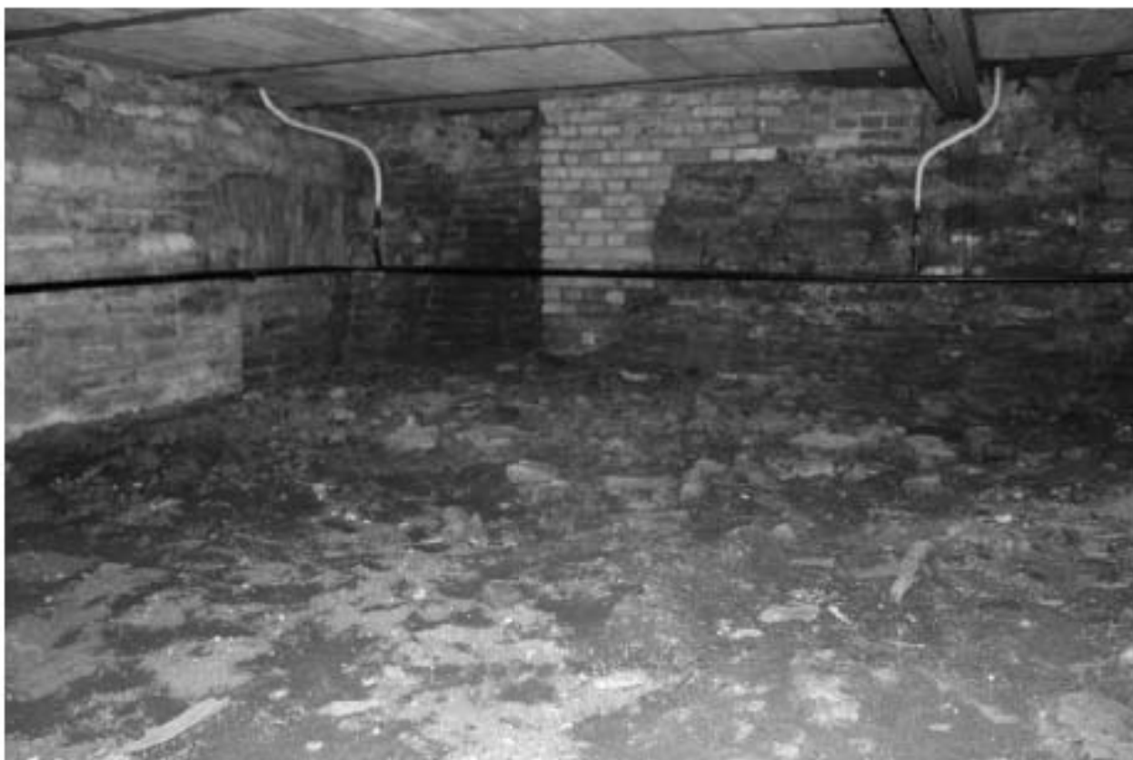
Фото 155. Вид на подвальные помещения.
