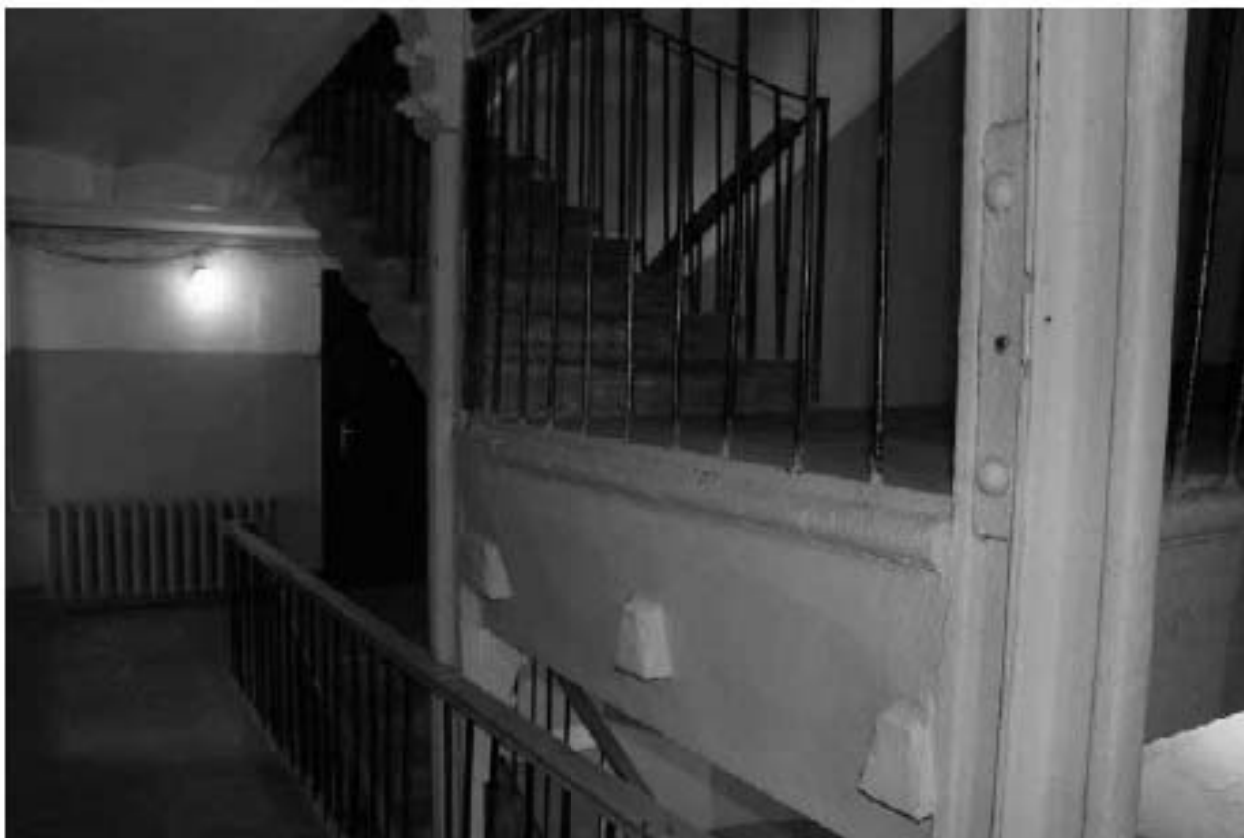
Фото 31. Лестничная площадка Л-2 в уровне 2-го этажа.
