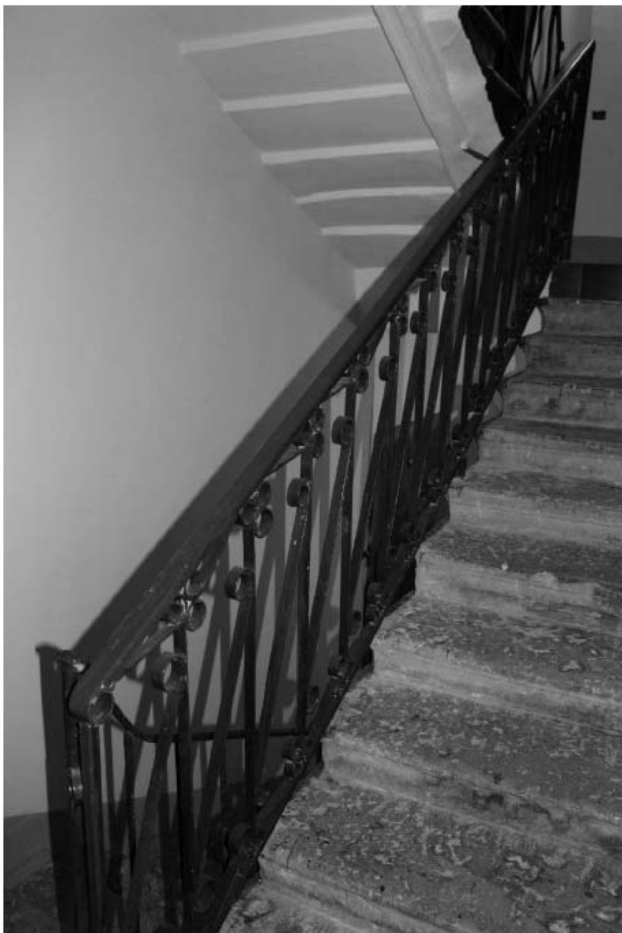
Фото 237. Вид на ограждение лестницы Л-2 в уровне 4-го – 5-го этажей.
