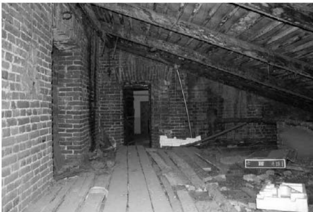
Фото 105. Вид на чердачные помещения.
