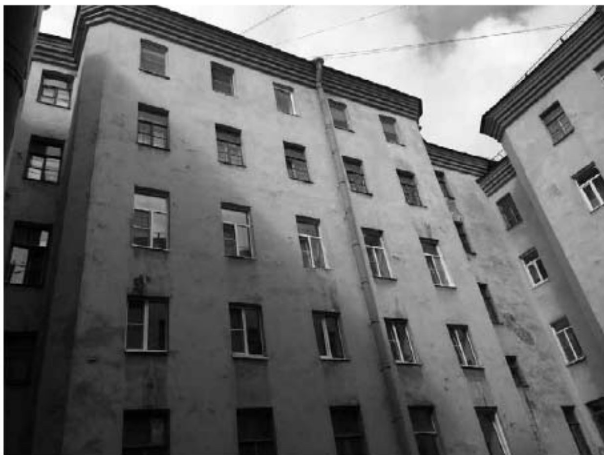
Фото 341. Вид на фасад западного корпуса.
