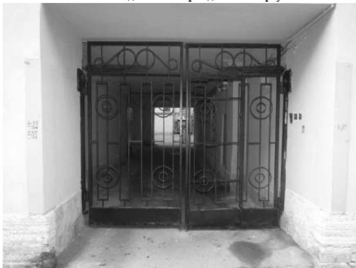
Фото 108. Вид на арку воротного проезда в южном корпусе.
