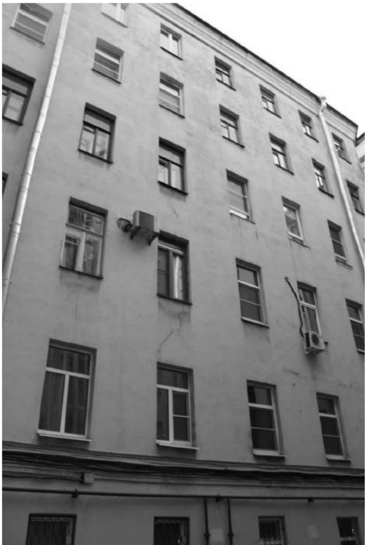
Фото 223. Вид на фасад восточного корпуса.
