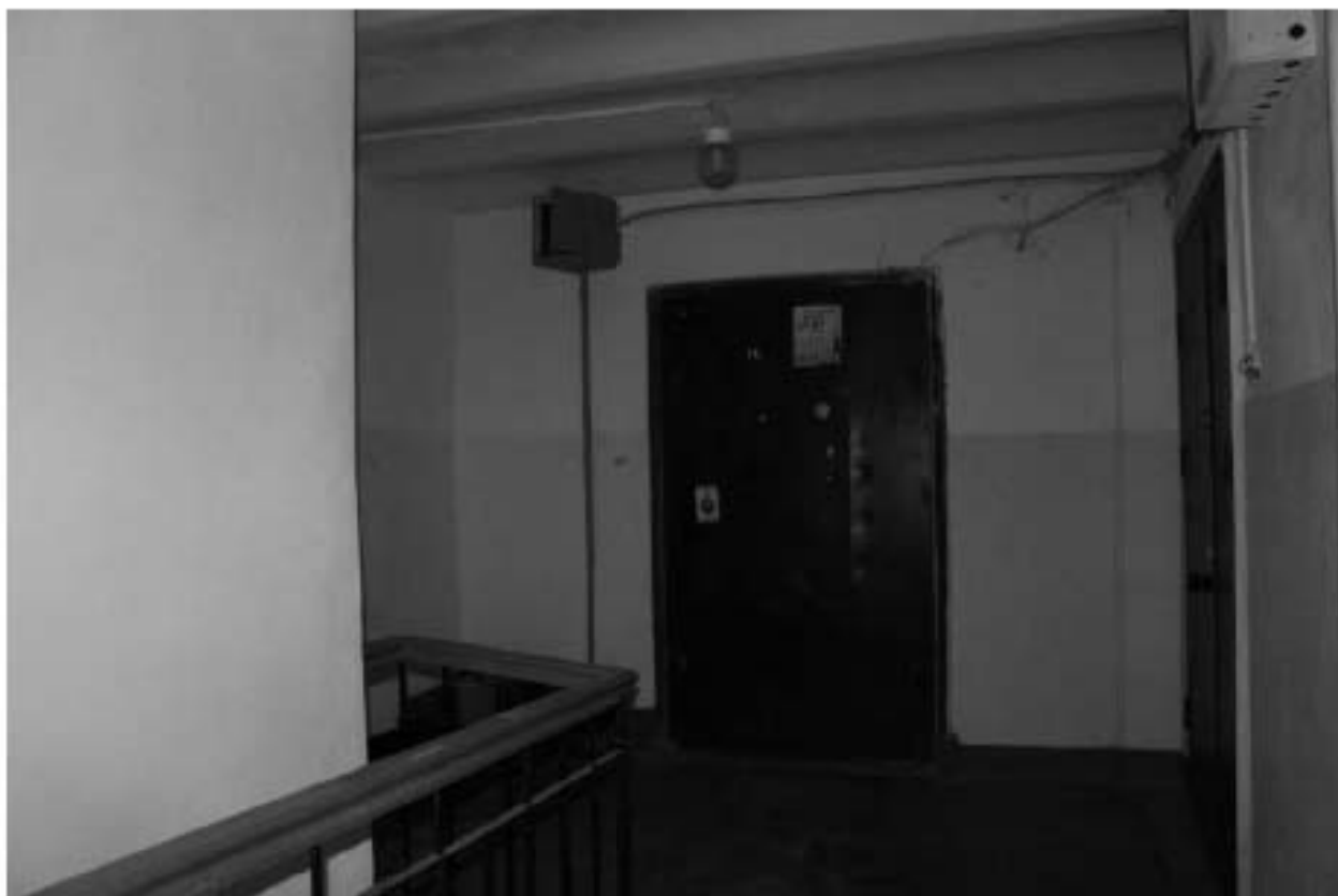
Фото 277. Лестничная площадка Л-1 в уровне 6-го этажа.
