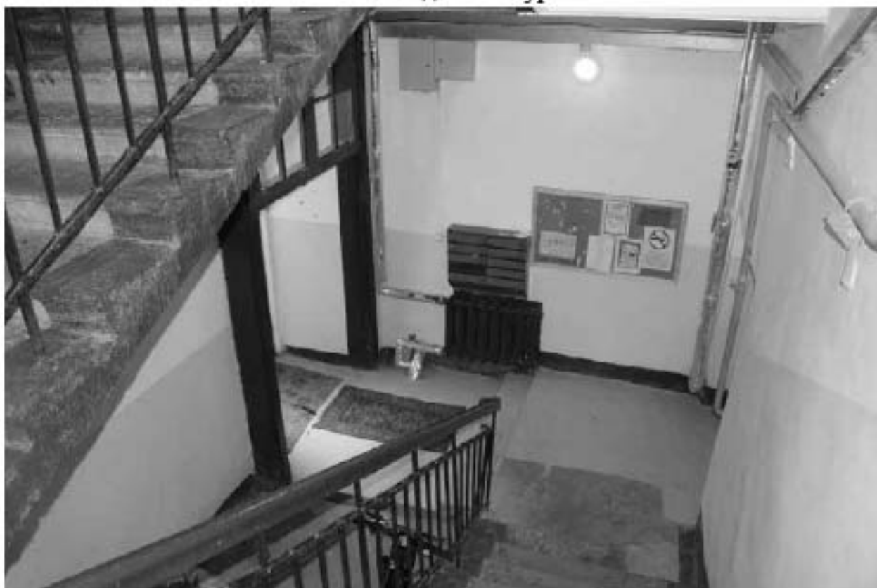
Фото 135. Вид на лестничную клетку 4ЛК в уровне 1-го этажа.
