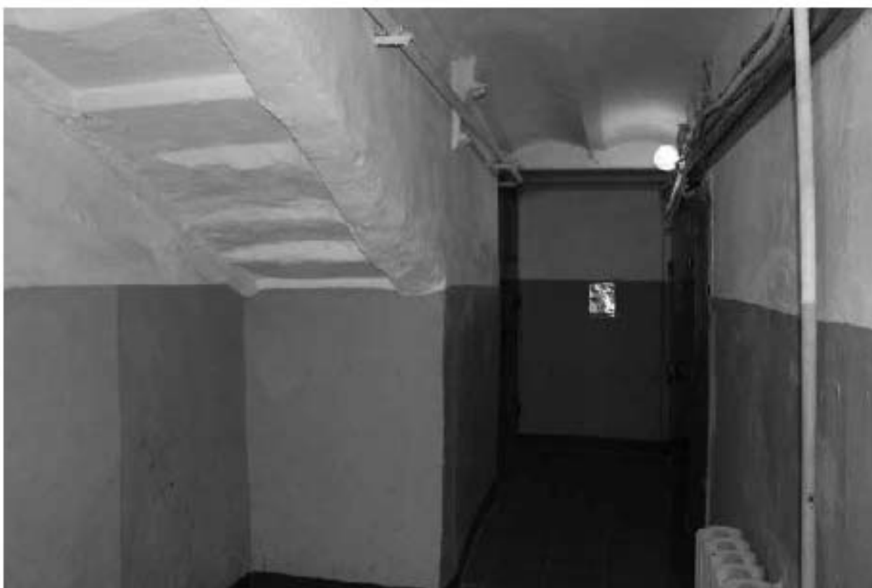
Фото 29. Лестница Л-2 в уровне 1-го этажа.
