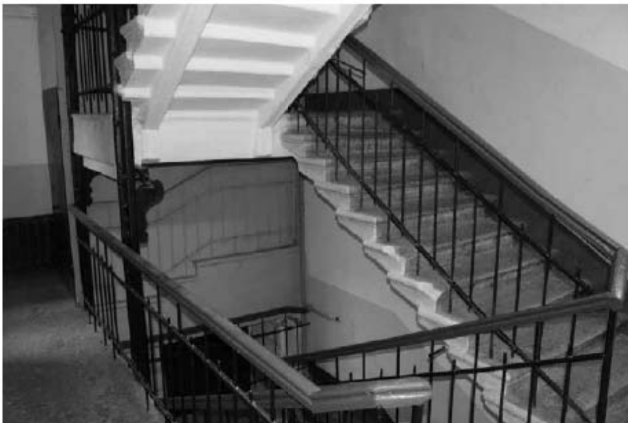
Фото 81. Вид на лестницу 1ЛК в уровне 3-го этажа.
