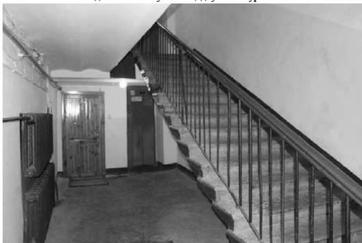
Фото 203. Вид на лестничную клетку 3ЛК в уровне 1-го этажа.
