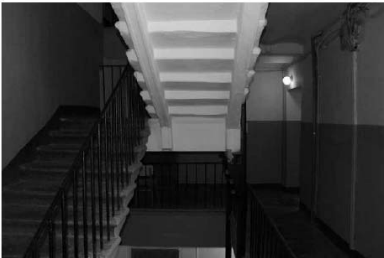
Фото 37. Вид на лестничную площадку Л-2 в уровне 5-го этажа.
