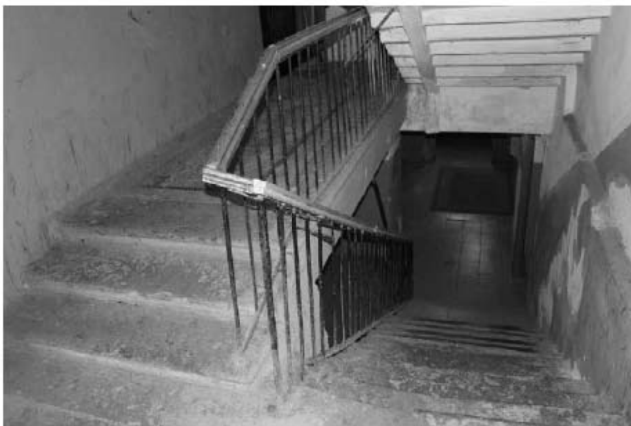
Фото 15. Вид на лестницу Л-1 в уровне 2-го этажа.
