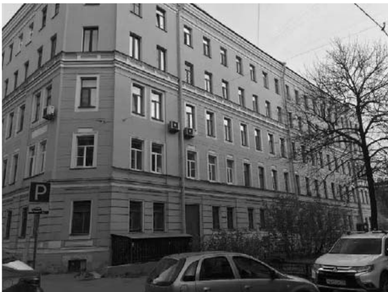
Фото 216. Вид на западный фасад западного корпуса.
