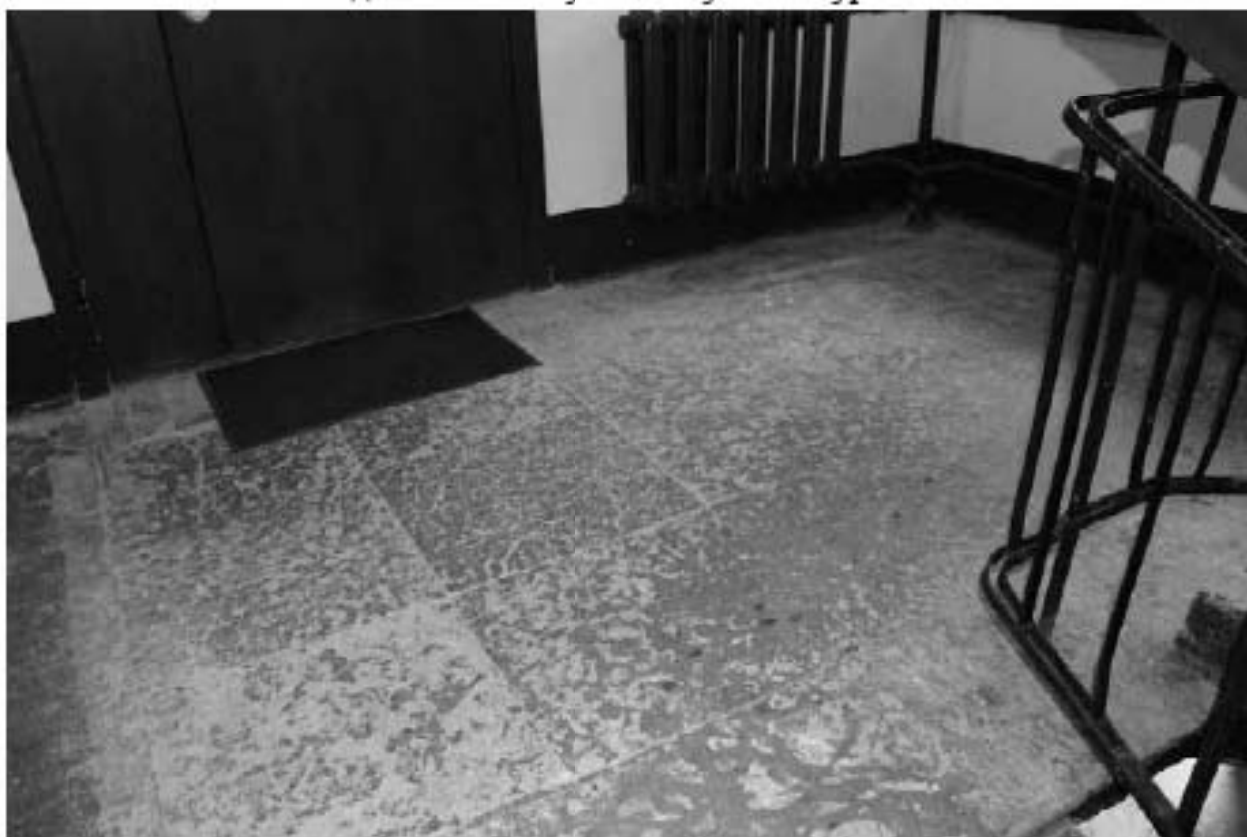
Фото 129. Вид на пол лестничной площадки ЗЛК в уровне 2-го этажа.
