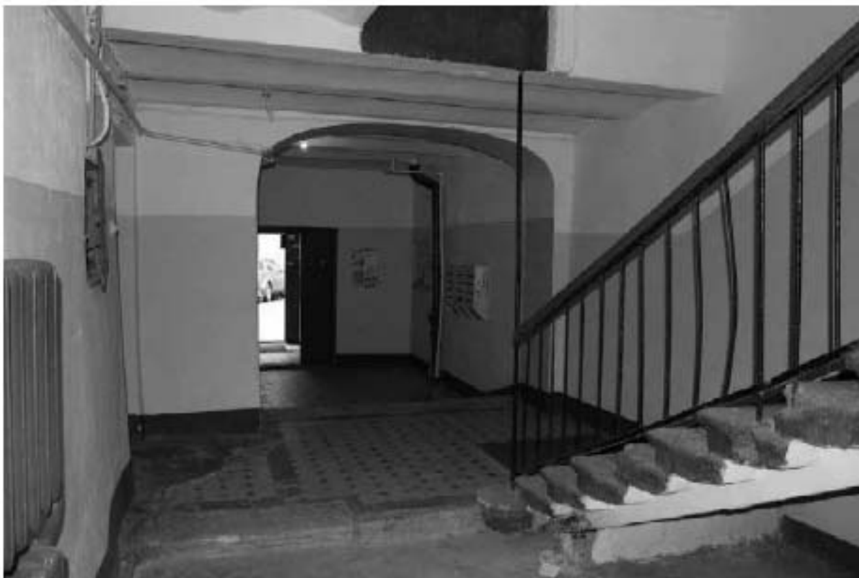
Фото 45. Вид на лестничную клетку Л-3 в уровне 1-го этажа.
