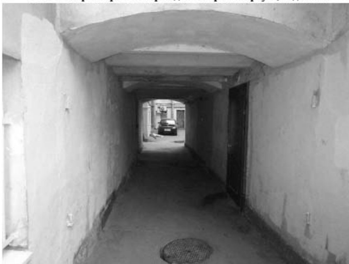
Фото 189. Арка воротного проезда в северном корпусе, вид с севера.
