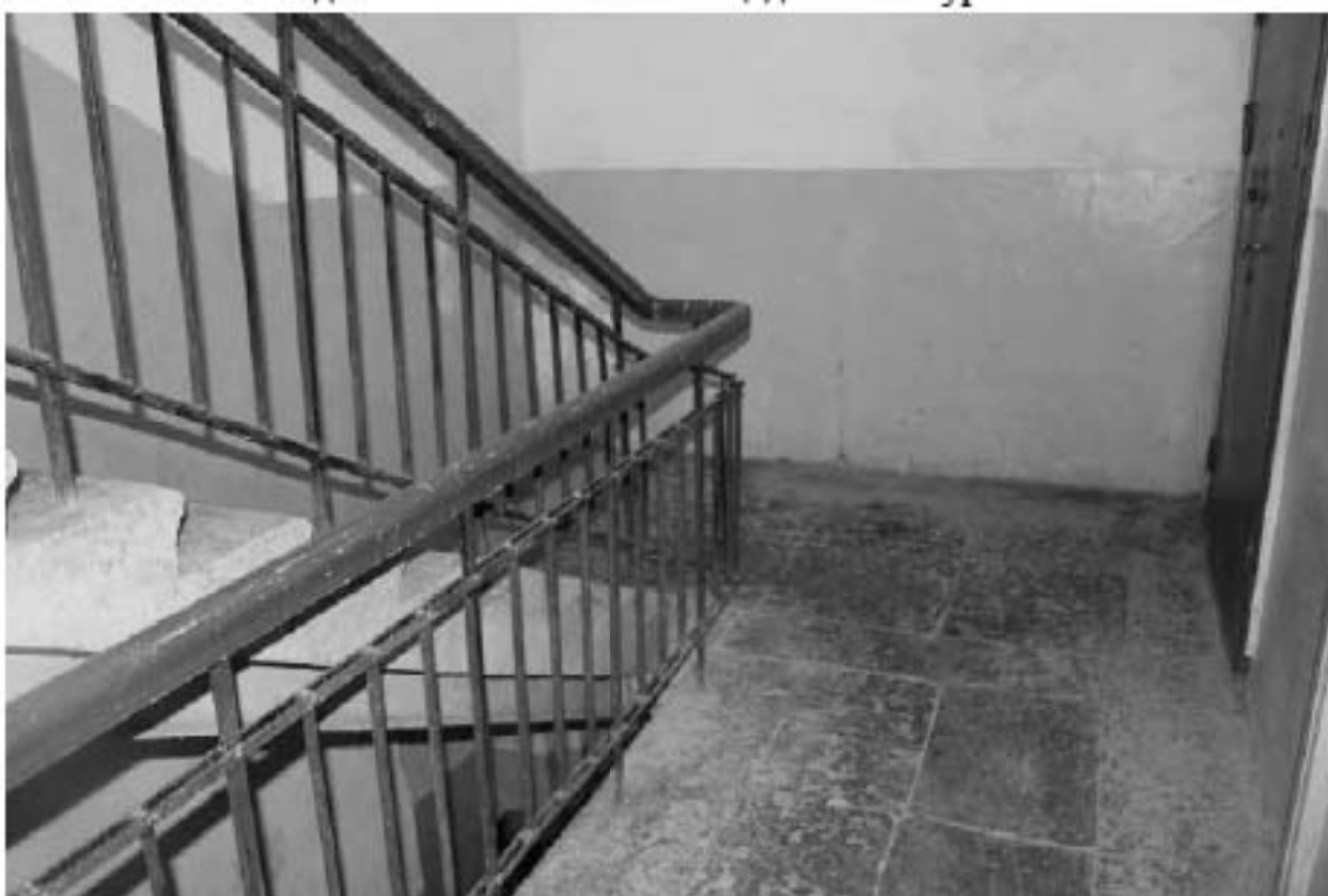
Фото 120. Вид на лестничную площадку 1ЛК в уровне 2-го этажа.
