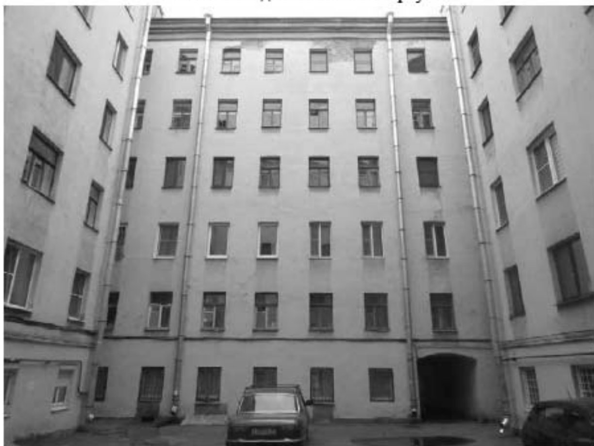
Фото 187. Вид на южный фасад северного корпуса.
