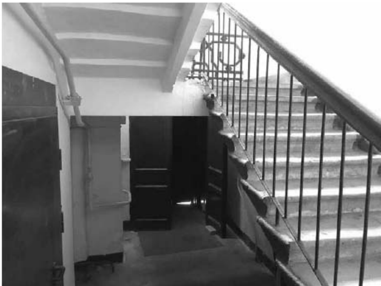
Фото 305. Вид лестничной клетки 1ЛК в уровне 1-го этажа.
