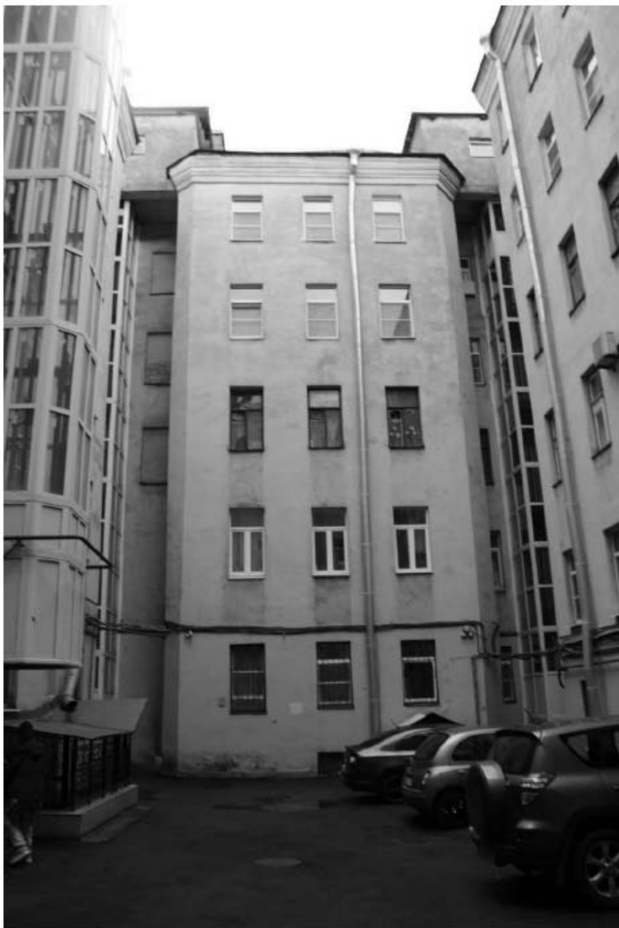
Фото 221. Вид на южный фасад северного корпуса.
