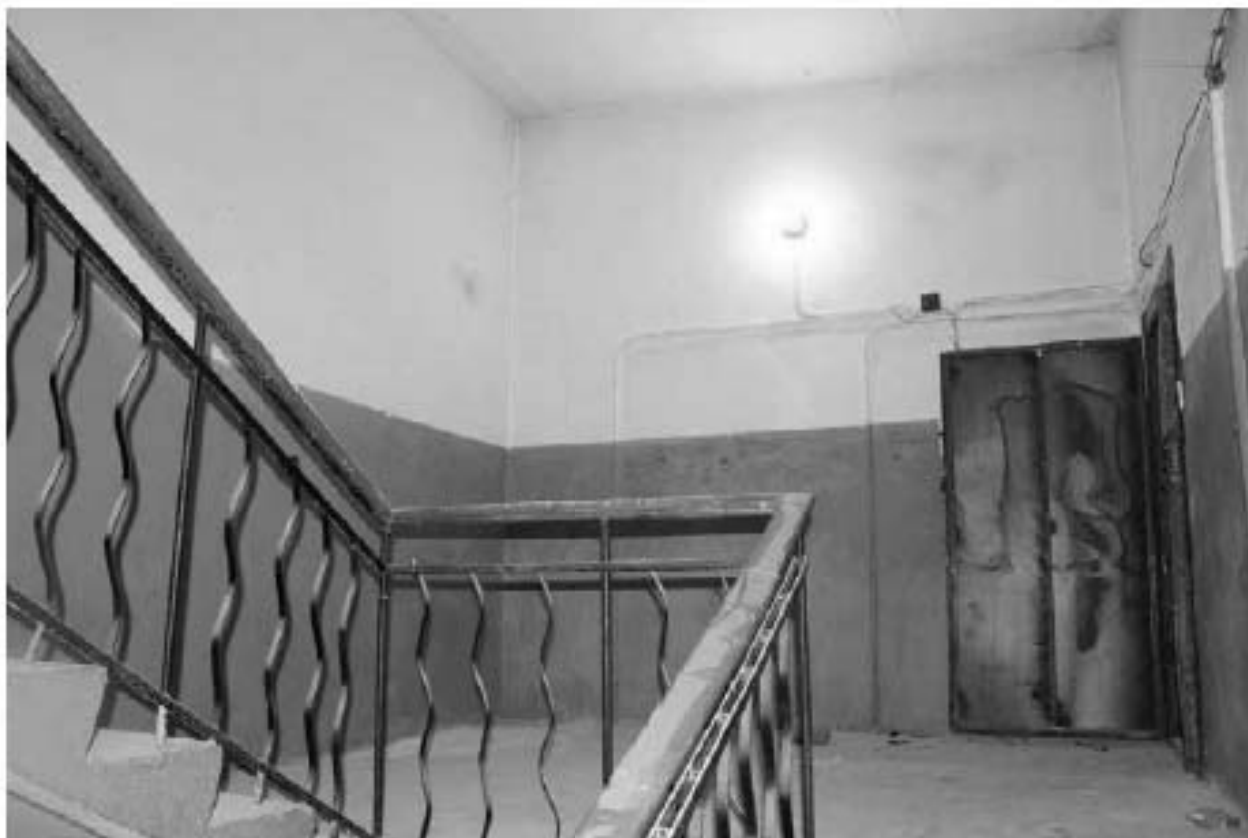
Фото 212. Вид на лестничную клетку 4ЛК в уровне 6-го этажа.
