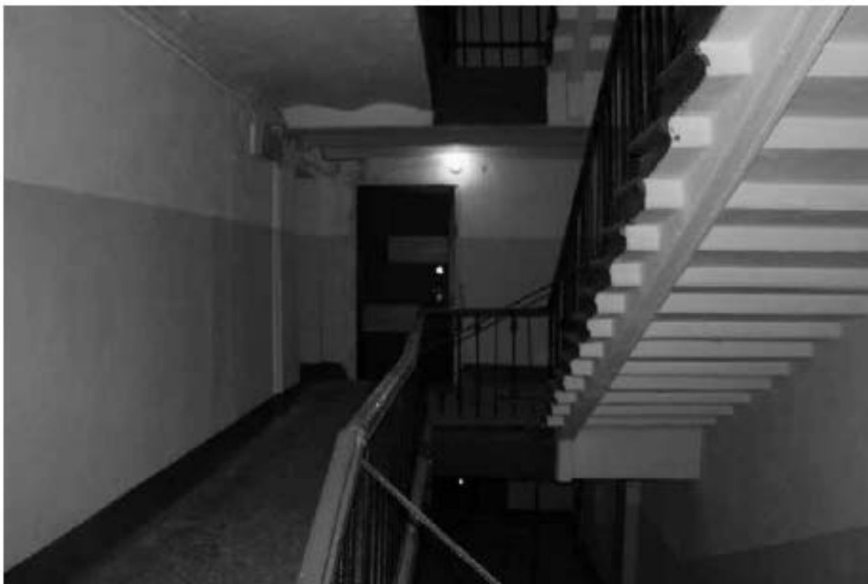
Фото 47. Вид на лестничную площадку Л-3 в уровне 2-го этажа.
