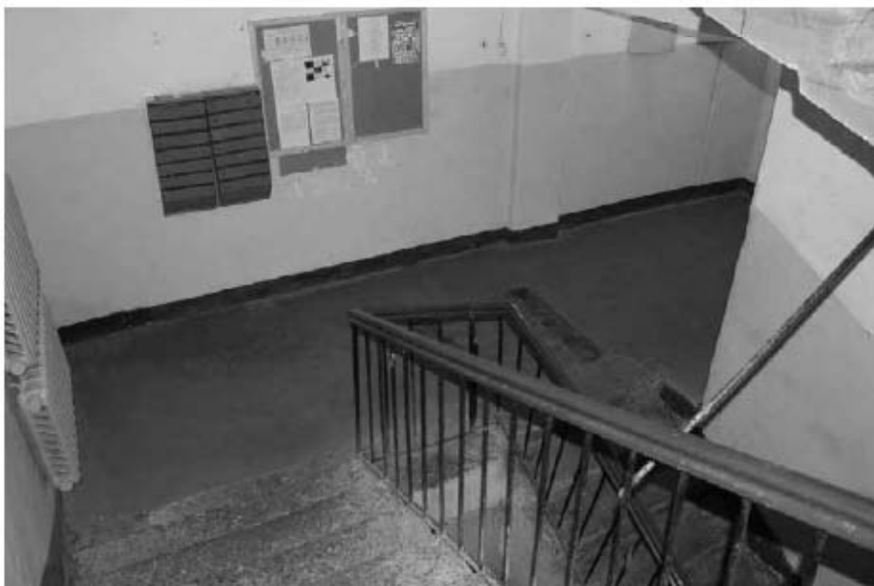
Фото 256. Вид на лестничную площадку Л-5 в уровне 2-го этажа.
