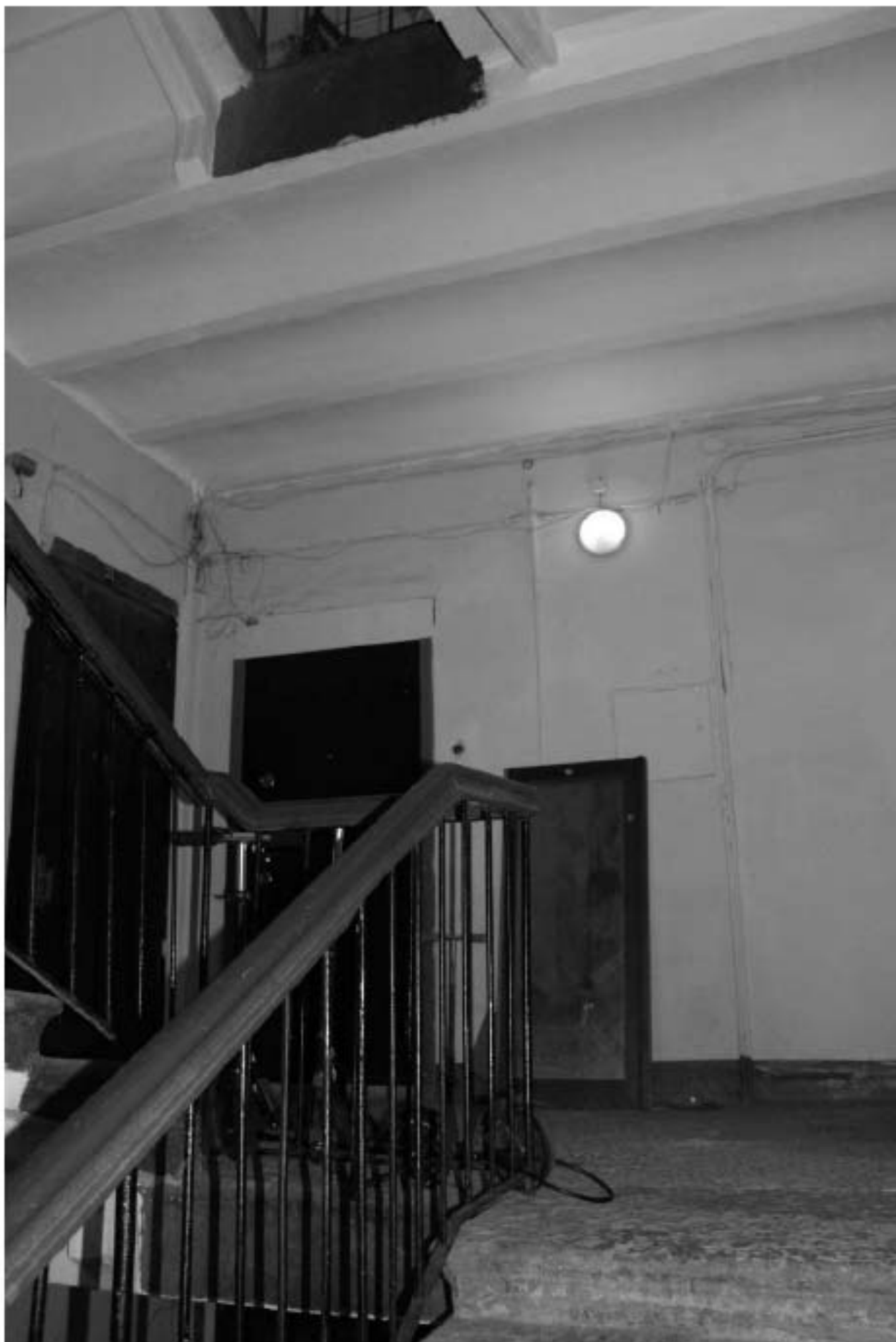
Фото 242. Вид на лестничную площадку Л-3 в уровне 2-го этажа.
