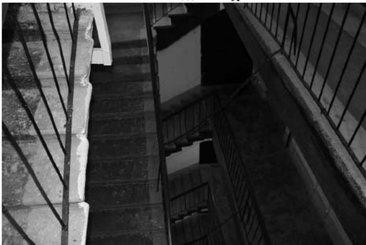
Фото 290. Общий вид лестницы Л-4 с верхнего этажа.
