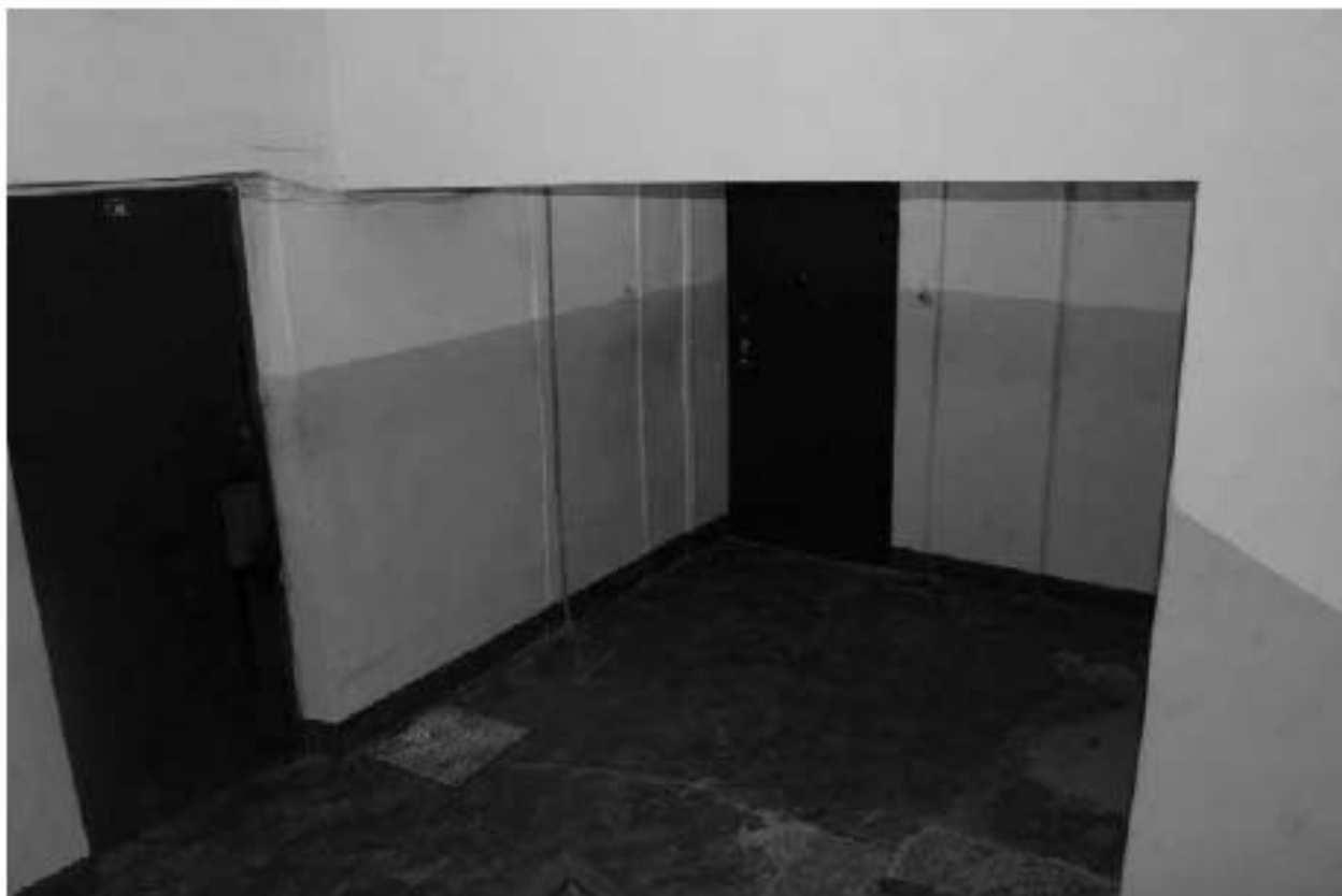
Фото 257. Вид на лестничную площадку Л-5 в уровне 3-го этажа.
