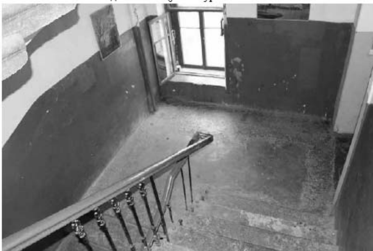
Фото 22. Вид на междуэтажную площадку Л-1 в уровне 5-го – 6-го этажей.
