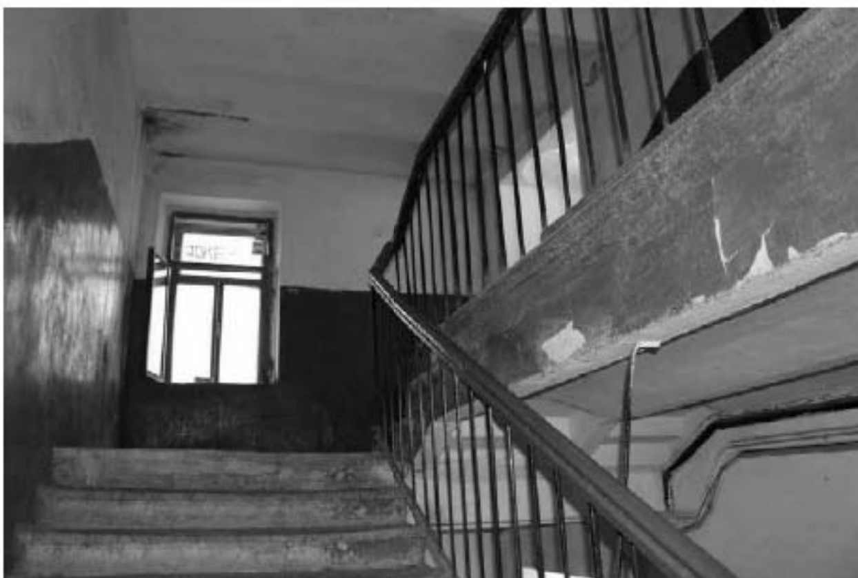
Фото 17. Вид на лестничную площадку Л-1 в уровне 3-го этажа.
