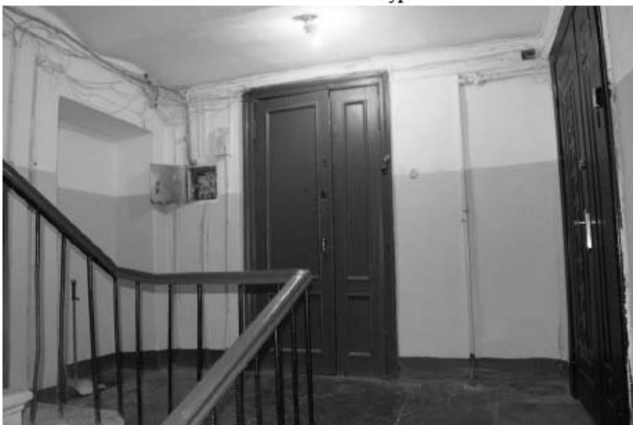
Фото 171. Лестничная клетка 4ЛК в уровне 6-го этажа.
