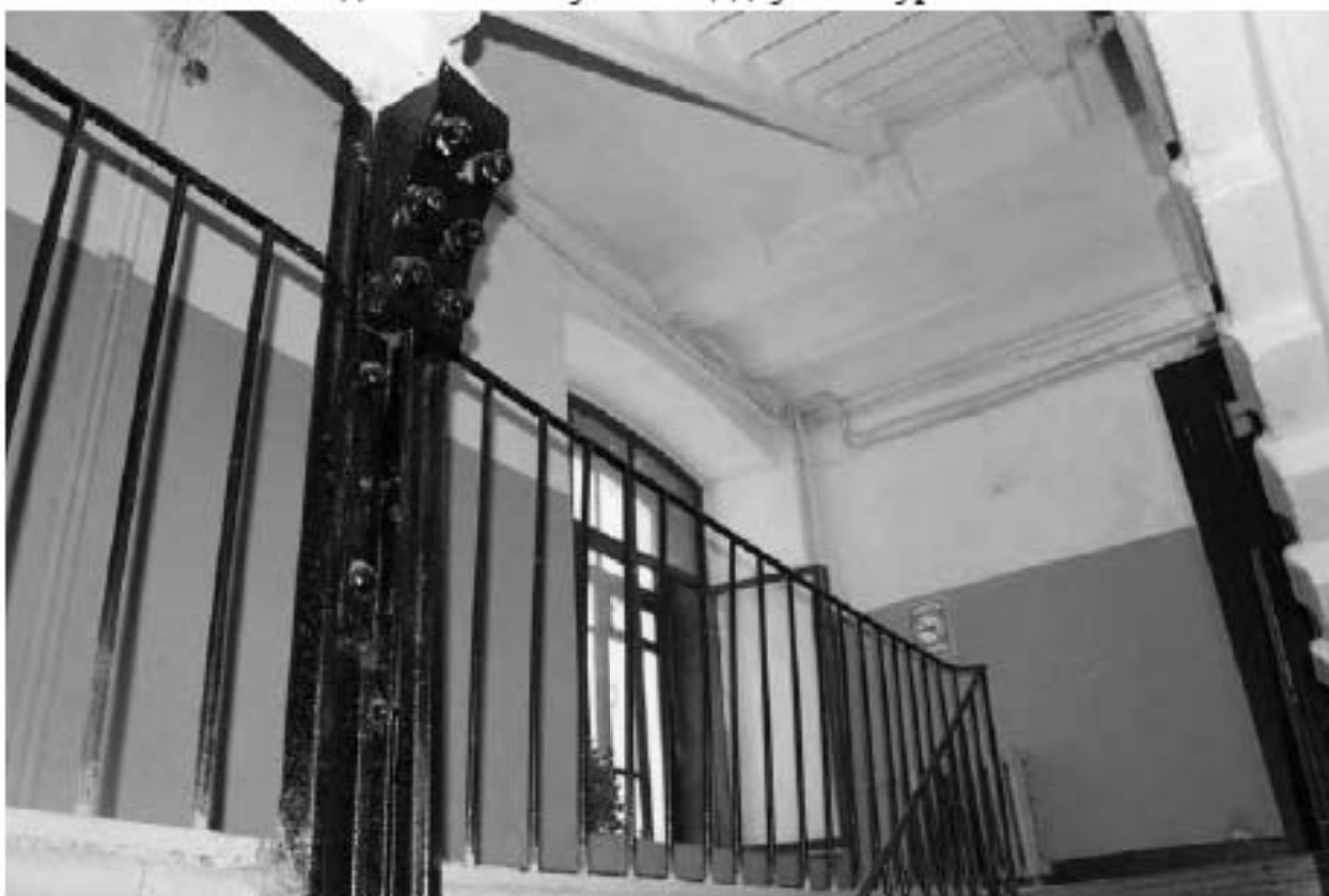
Фото 36. Вид на потолок лестничной площадки Л-2 в уровне 5-го этажа.
