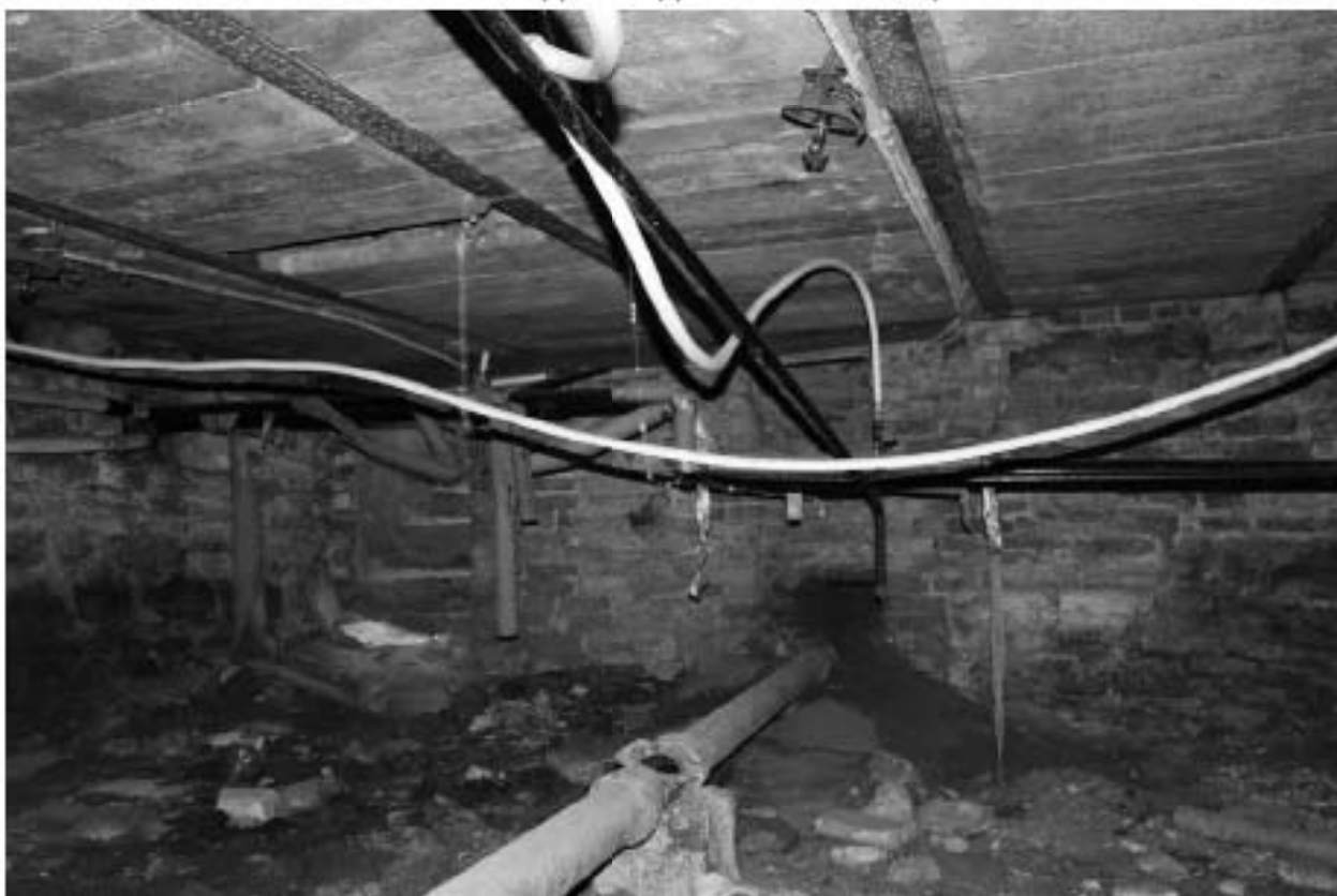
Фото 156. Вид на подвальные помещения
