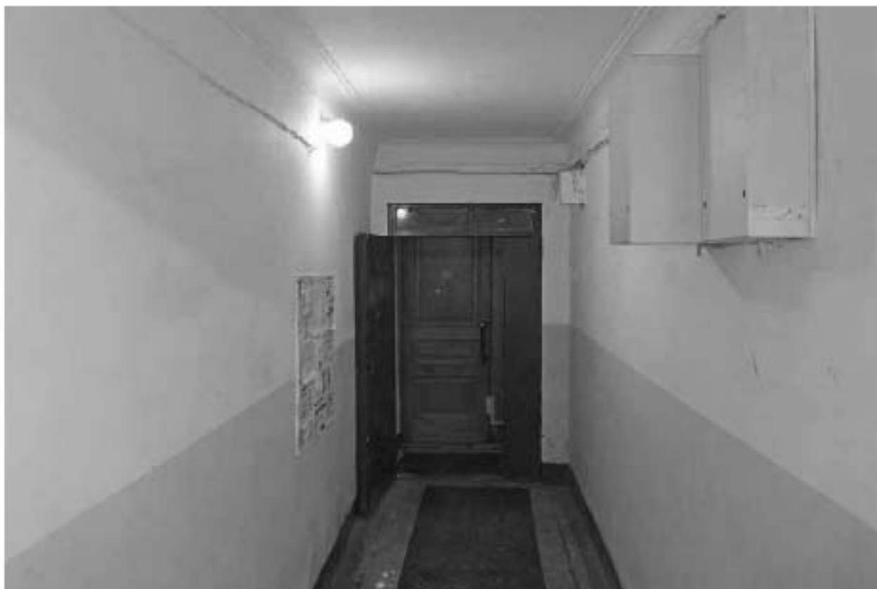
Фото 76. Вид на вестибюль 1ЛК.
