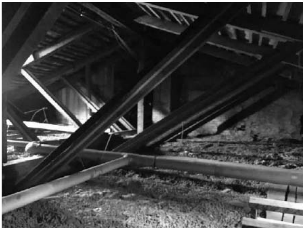
Фото 369. Вид на чердачные помещения.
