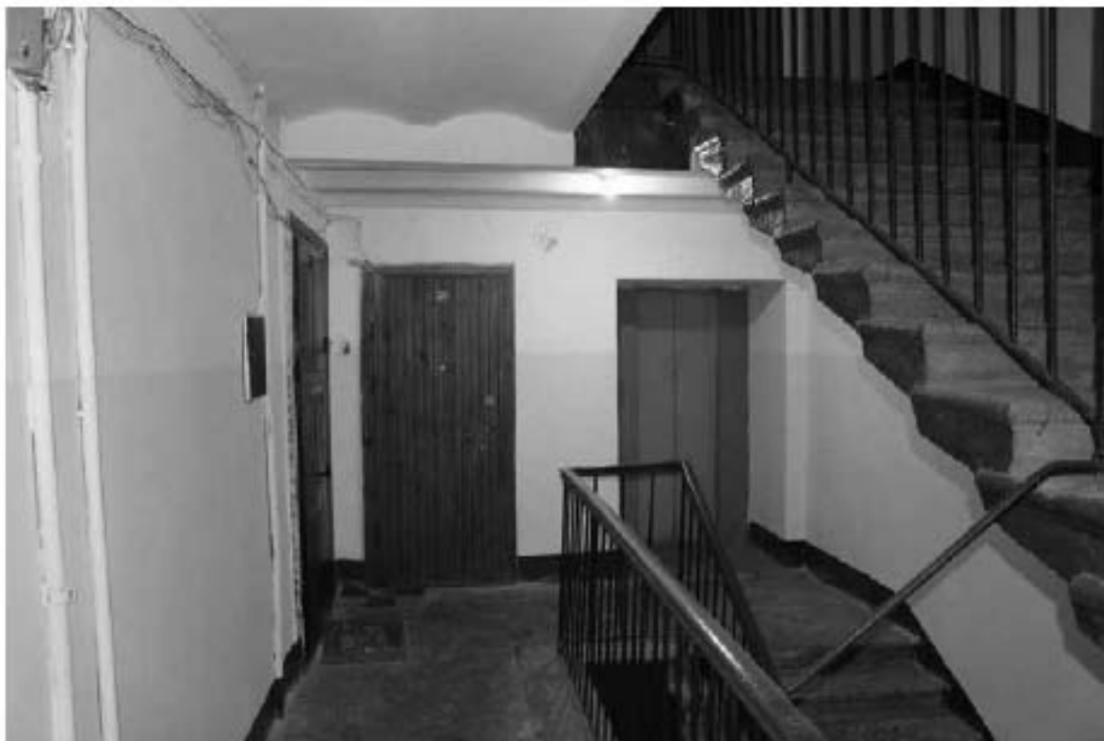
Фото 206. Вид на лестничную площадку ЗЛК в уровне 5-го этажа.
