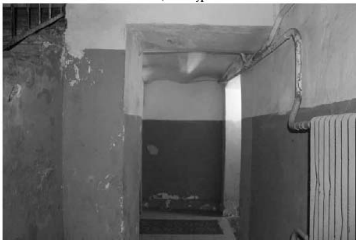
Фото 14. Лестница Л-1 в уровне 1-го этажа.
