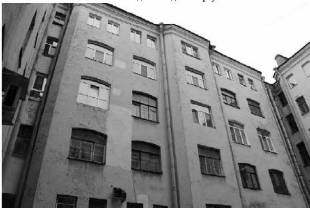
Фото 71. Вид на западный фасад восточного корпуса.
