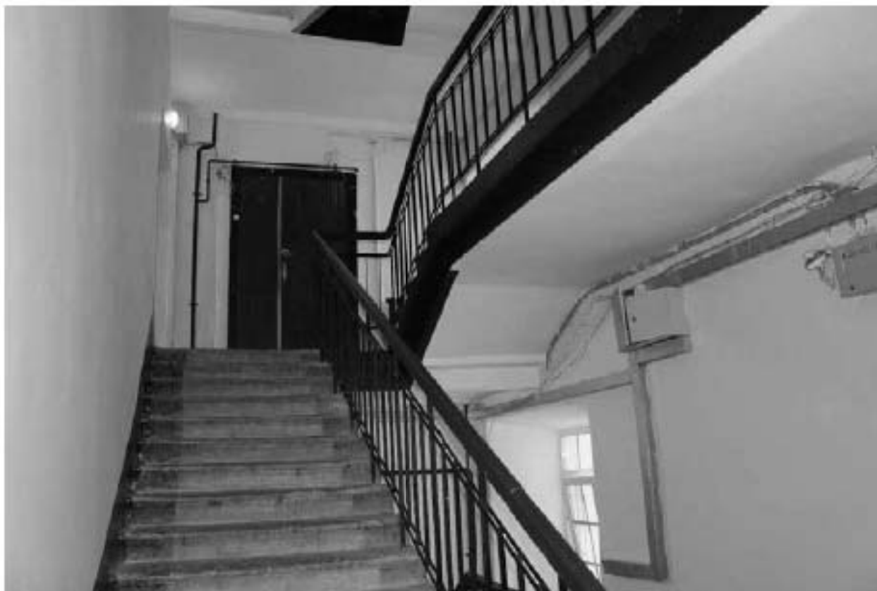
Фото 130. Вид на лестничную клетку ЗЛК в уровне 3-го – 4-го этажей.
