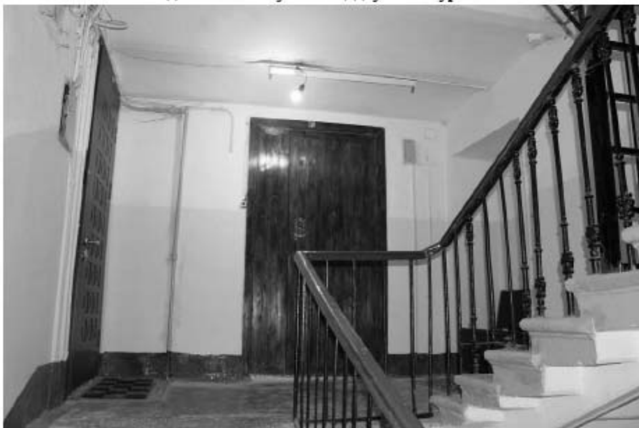
Фото 164. Вид на лестничную площадку ЗЛК в уровне 6-го этажа.
