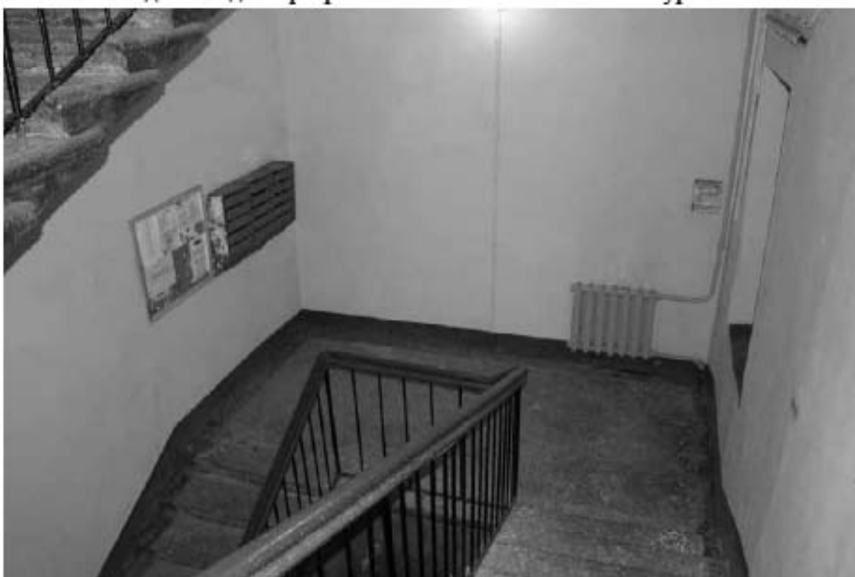
Фото 228. Вид на междуэтажную площадку Л-1 в уровне 1-го – 2-го этажей.
