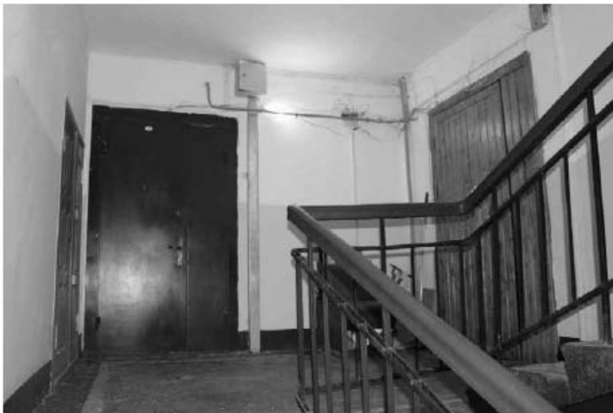
Фото 138. Вид на лестничную площадку 4ЛК в уровне 4-го этажа.
