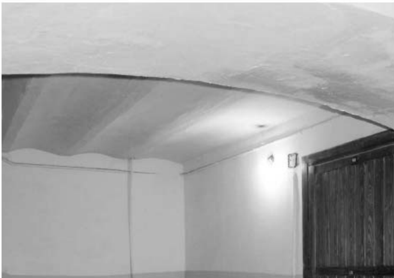
Фото 261. Вид на своды лестничной площадки Л-5 в уровне 5-го этажа.
