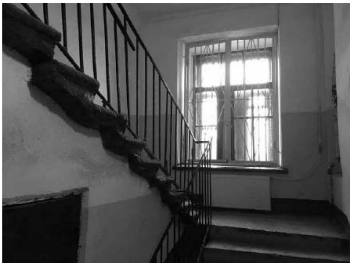
Фото 325. Лестничная клетка Л-5 в уровне 1-го этажа.
