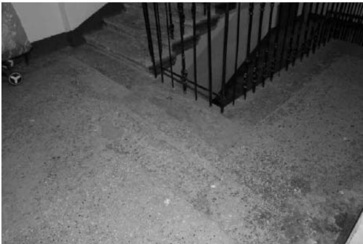
Фото 51. Пол лестницы Л-3 в уровне 4-го этажа.
