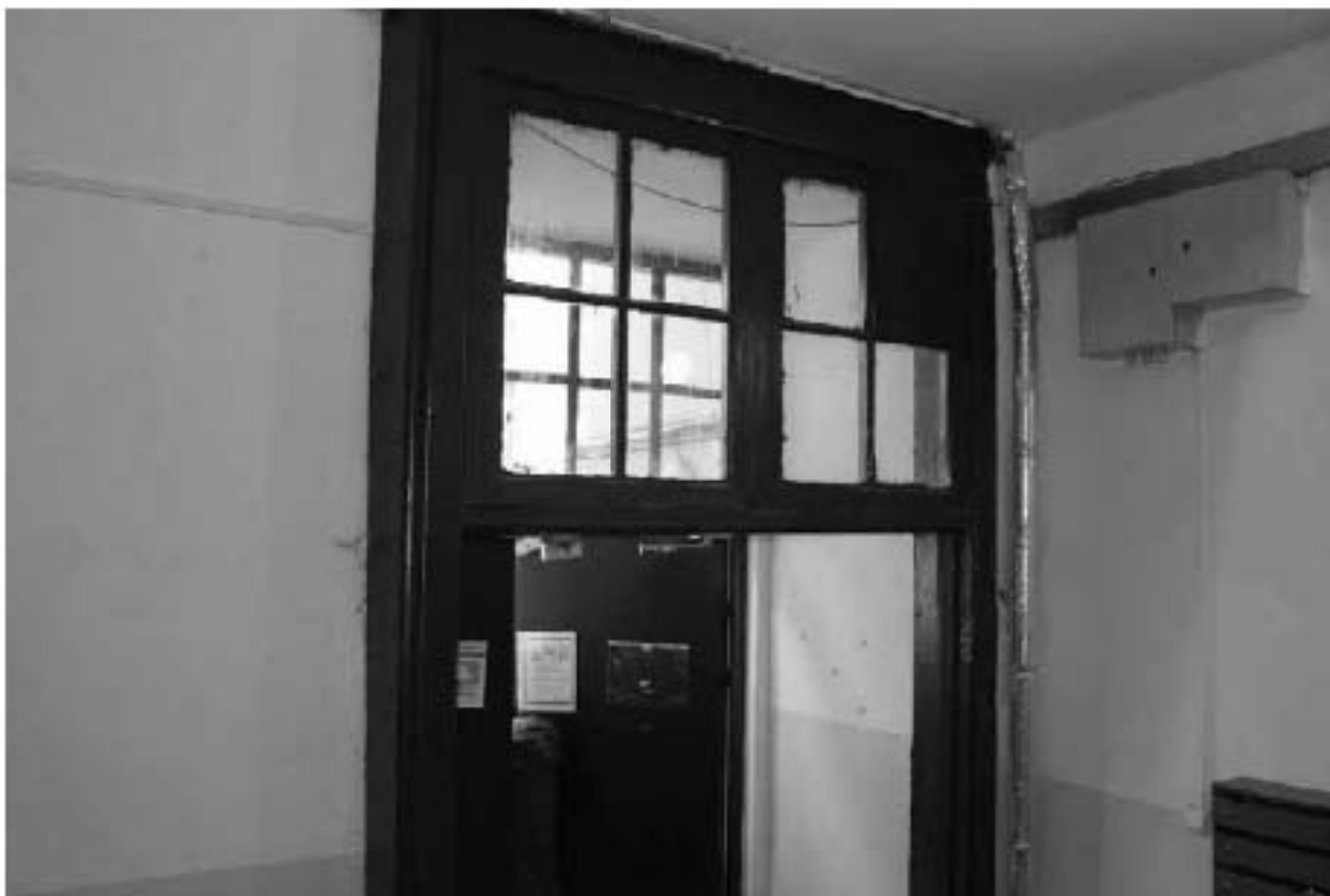
Фото 134. Вид на тамбур 4ЛК.
