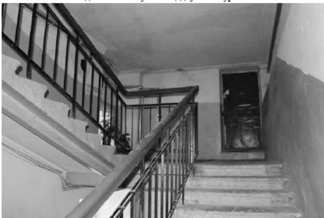
Фото 123. Вид на лестничную клетку 1ЛК в уровне 6-го этажа.
