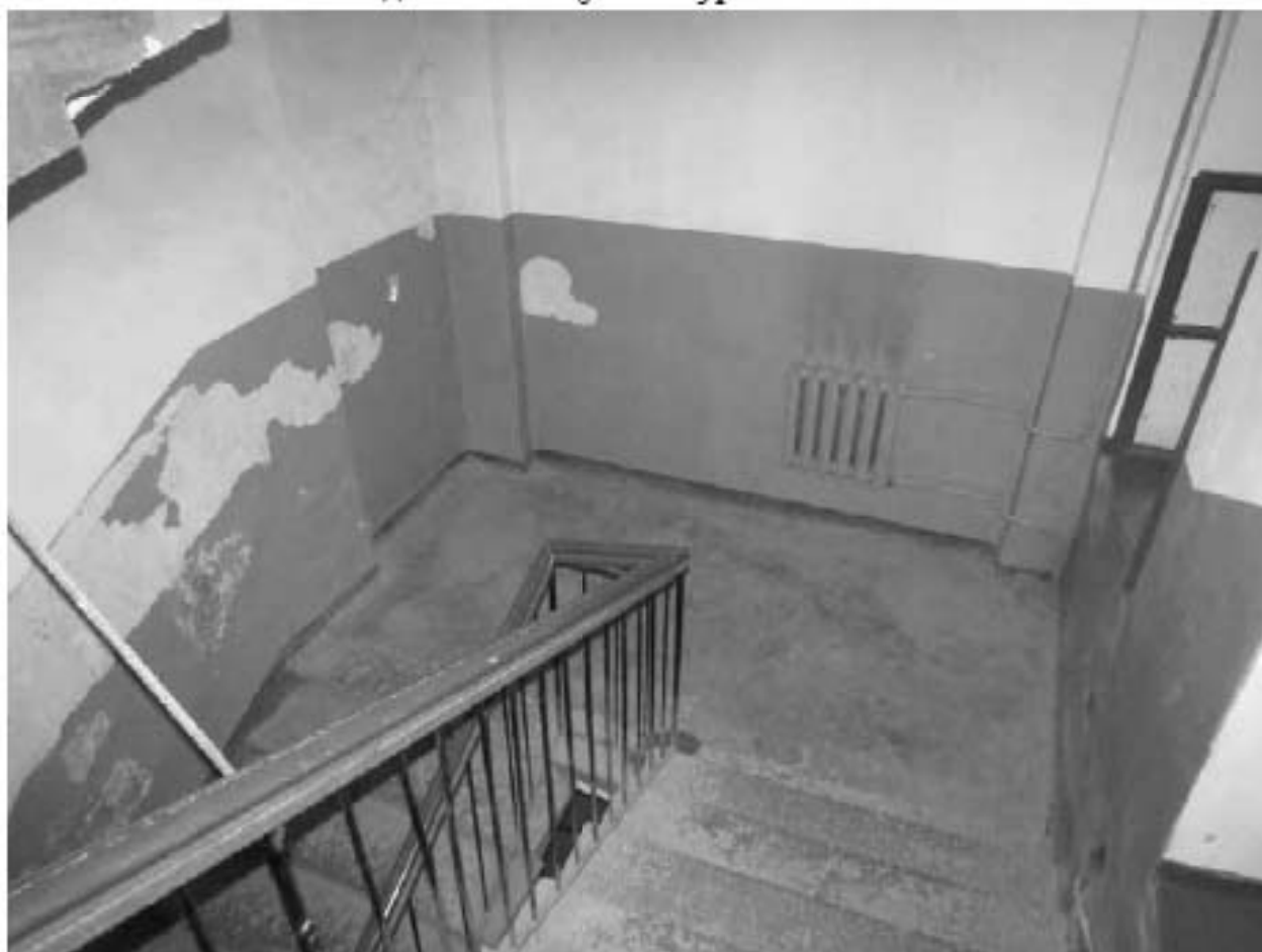
Фото 352. Вид на междуэтажную площадку Л-1 в уровне 4-го – 5-го этажей.
