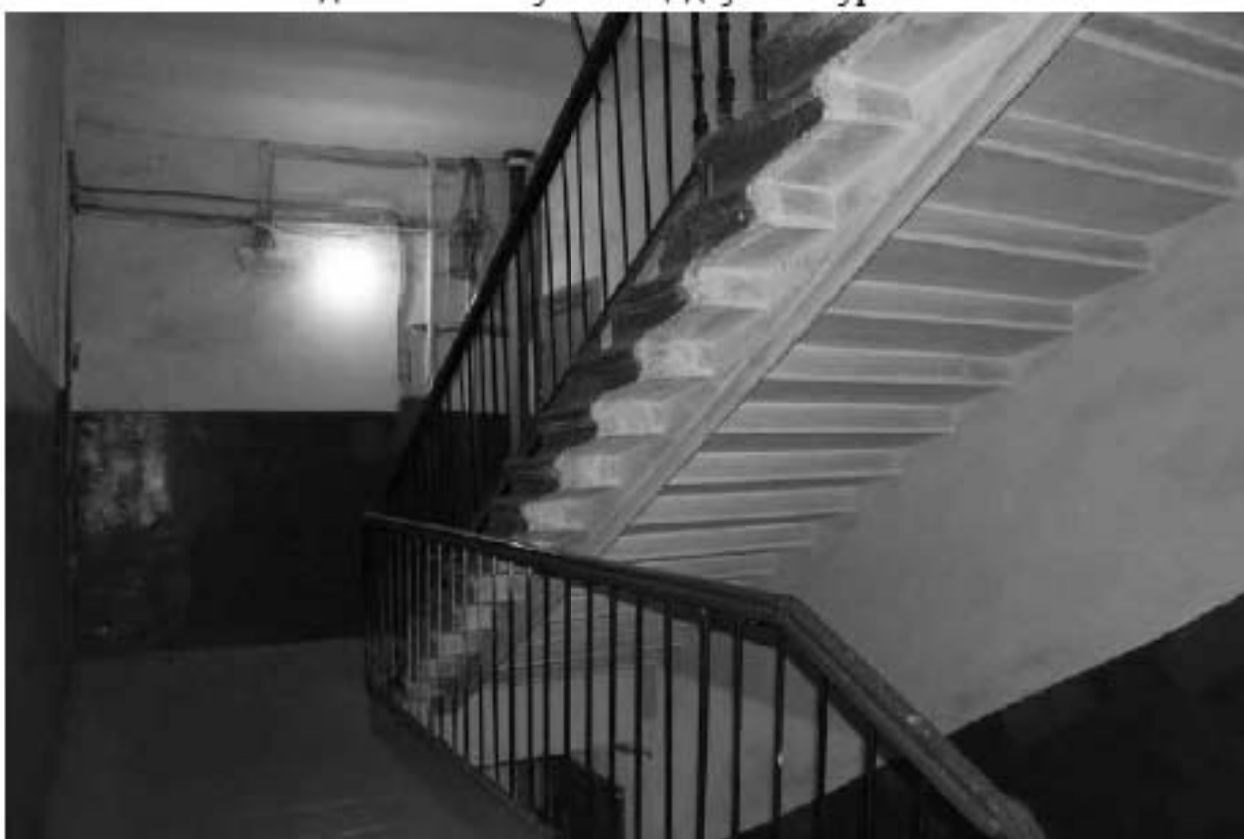
Фото 18. Вид на лестницу Л-1 в уровне 3-го этажа.
