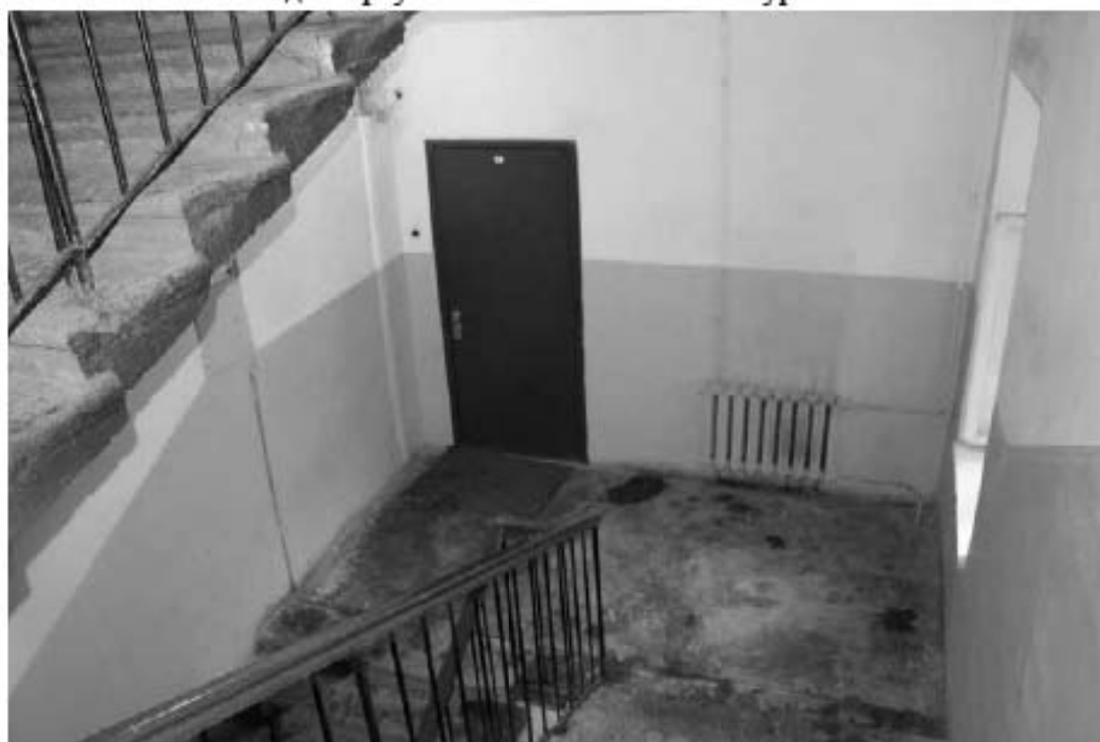
Фото 250. Вид на междуэтажную площадку Л-4 в уровне 3-го – 4-го этажей.
