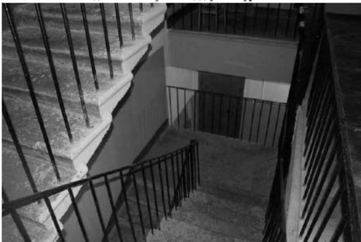
Фото 38. Вид на междуэтажную площадку Л-2 в уровне 5-го – 6-го этажей.
