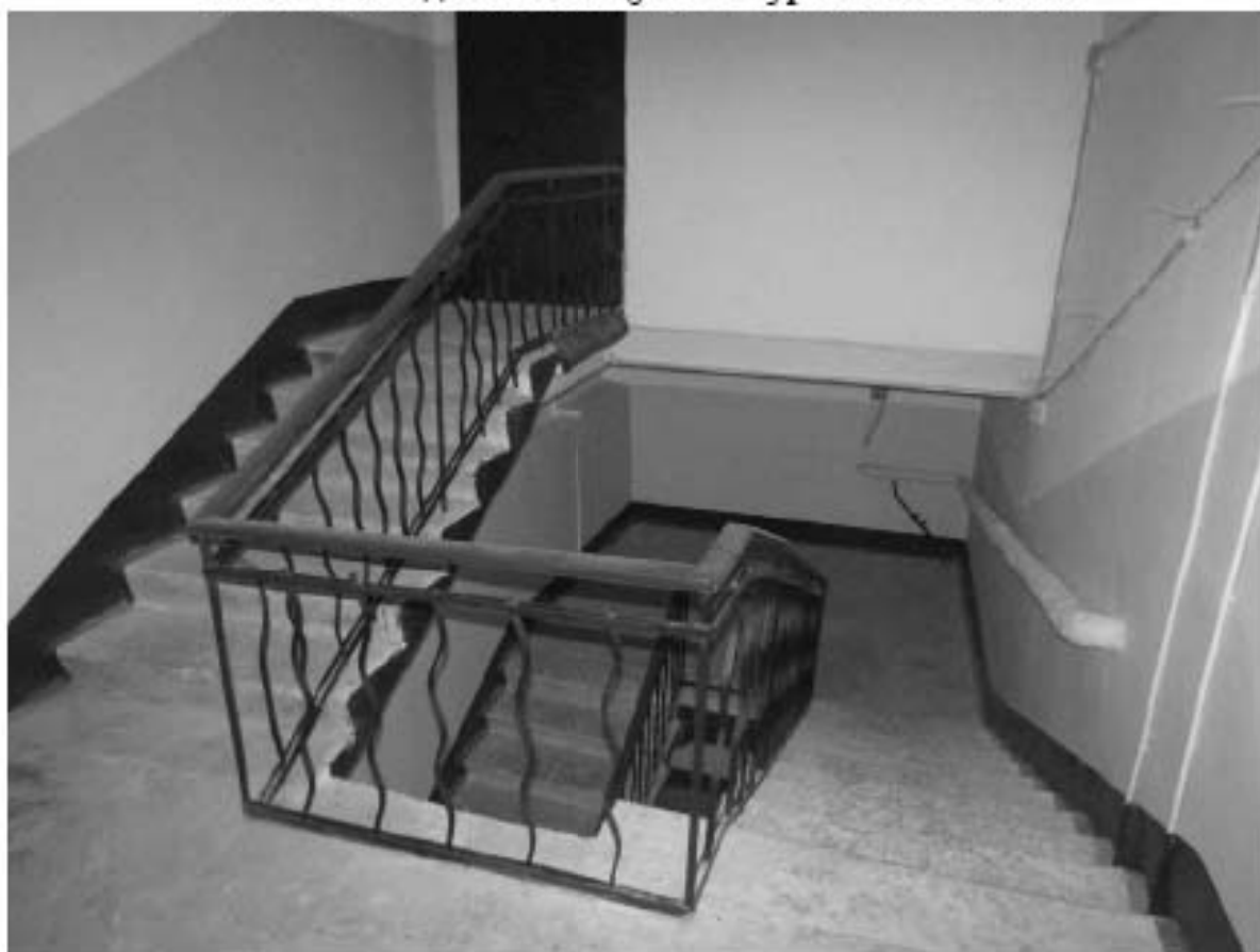
Фото 197. Вид на лестницу 1ЛК в уровне 6-го этажа.
