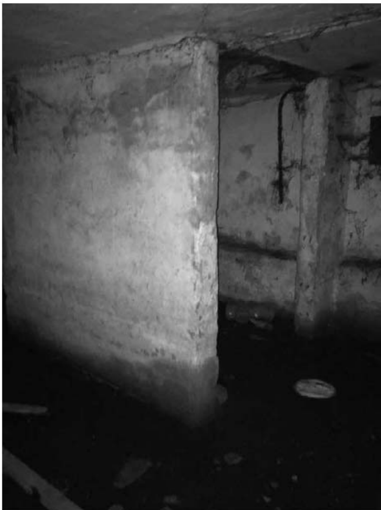
Фото 75. Вид на подвальные помещения.
