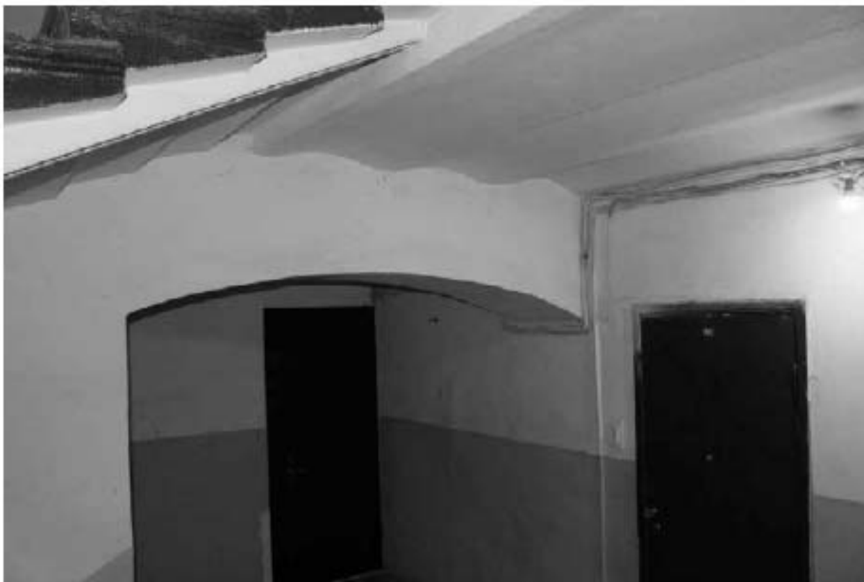
Фото 251. Вид на лестничную площадку Л-4 в уровне 4-го этажа.
