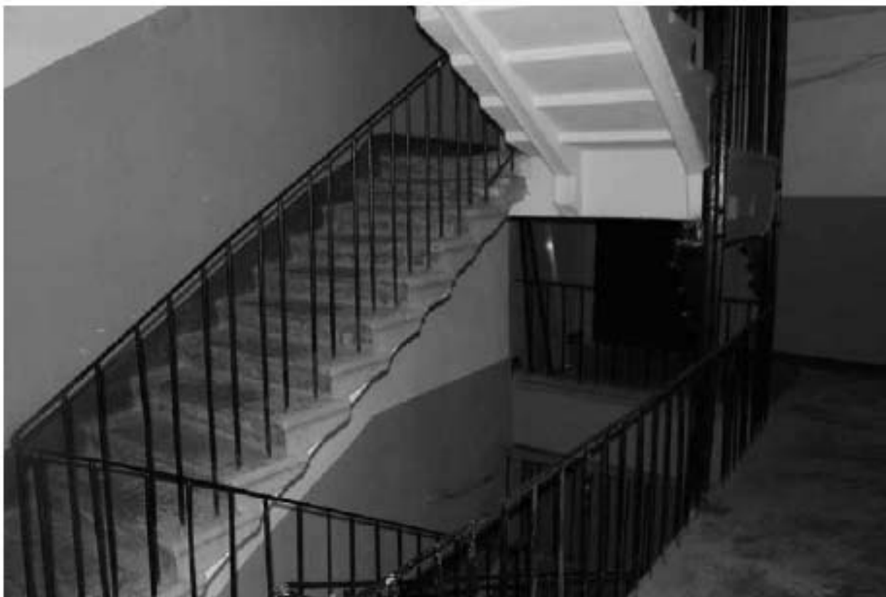
Фото 35. Вид на лестничную площадку Л-2 в уровне 4-го этажа.
