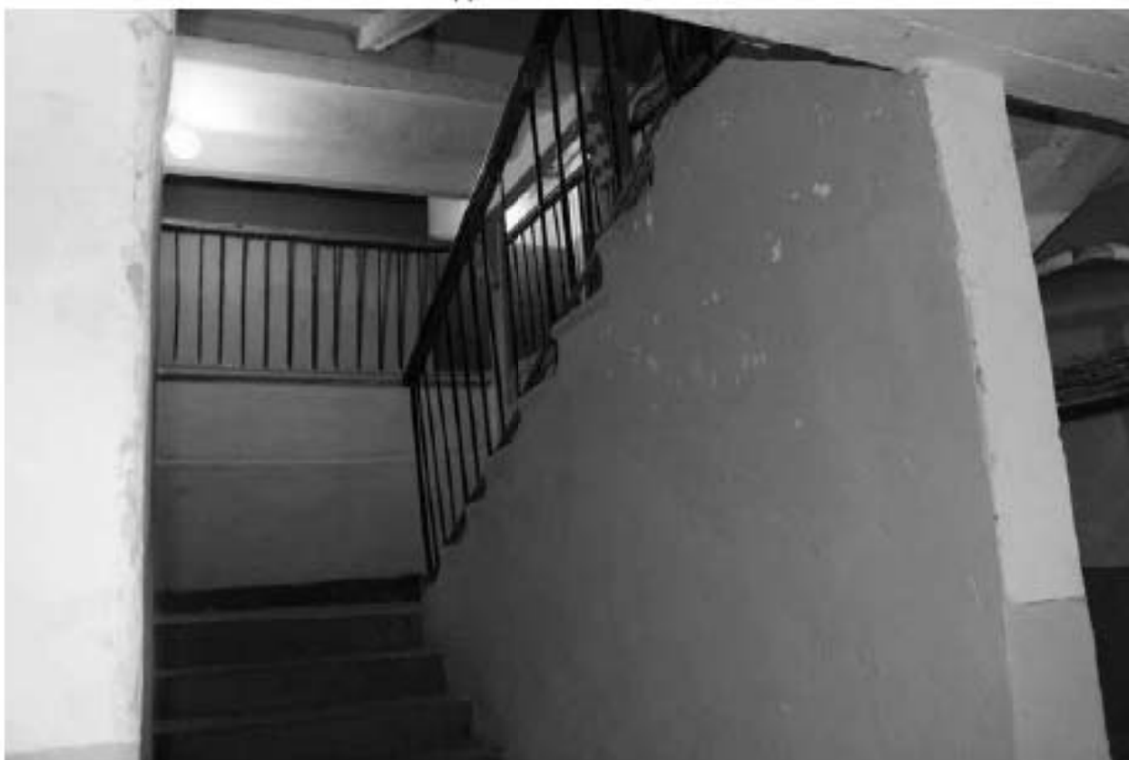
Фото 28. Лестница Л-2 в уровне 1-го этажа.
