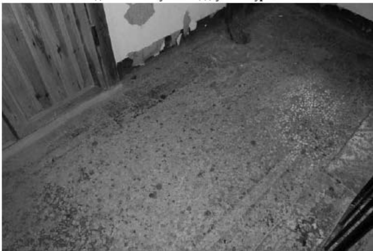
Фото 95. Вид на пол лестничной площадки ЗЛК в уровне 2-го этажа.
