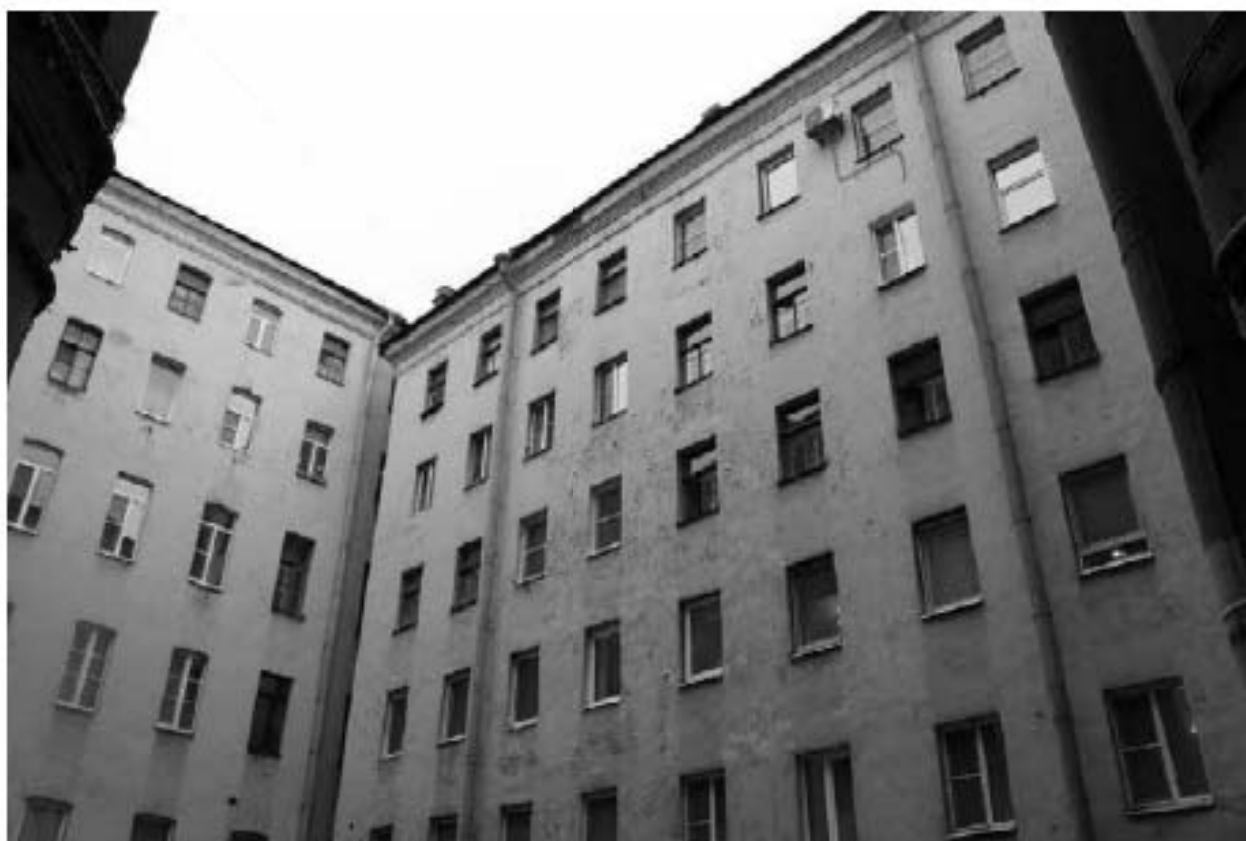
Фото 70. Вид на западный корпус.
