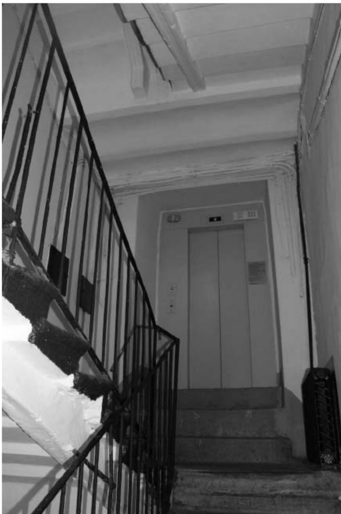
Фото 235. Вид на междуэтажную площадку Л-2 в уровне 1-го – 2-го этажей.
