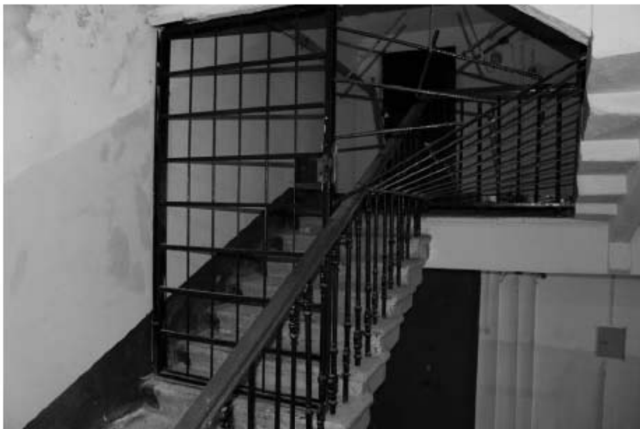
Фото 165. Вид на лестничную клетку ЗЛК в уровне 6-го этажа.
