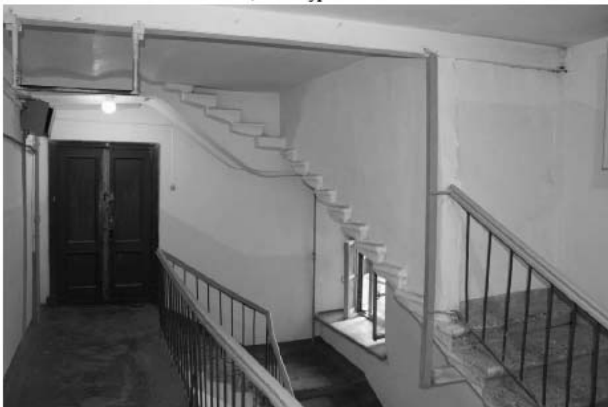
Фото 286. Лестничная площадка Л-3 в уровне 6-го этажа.
