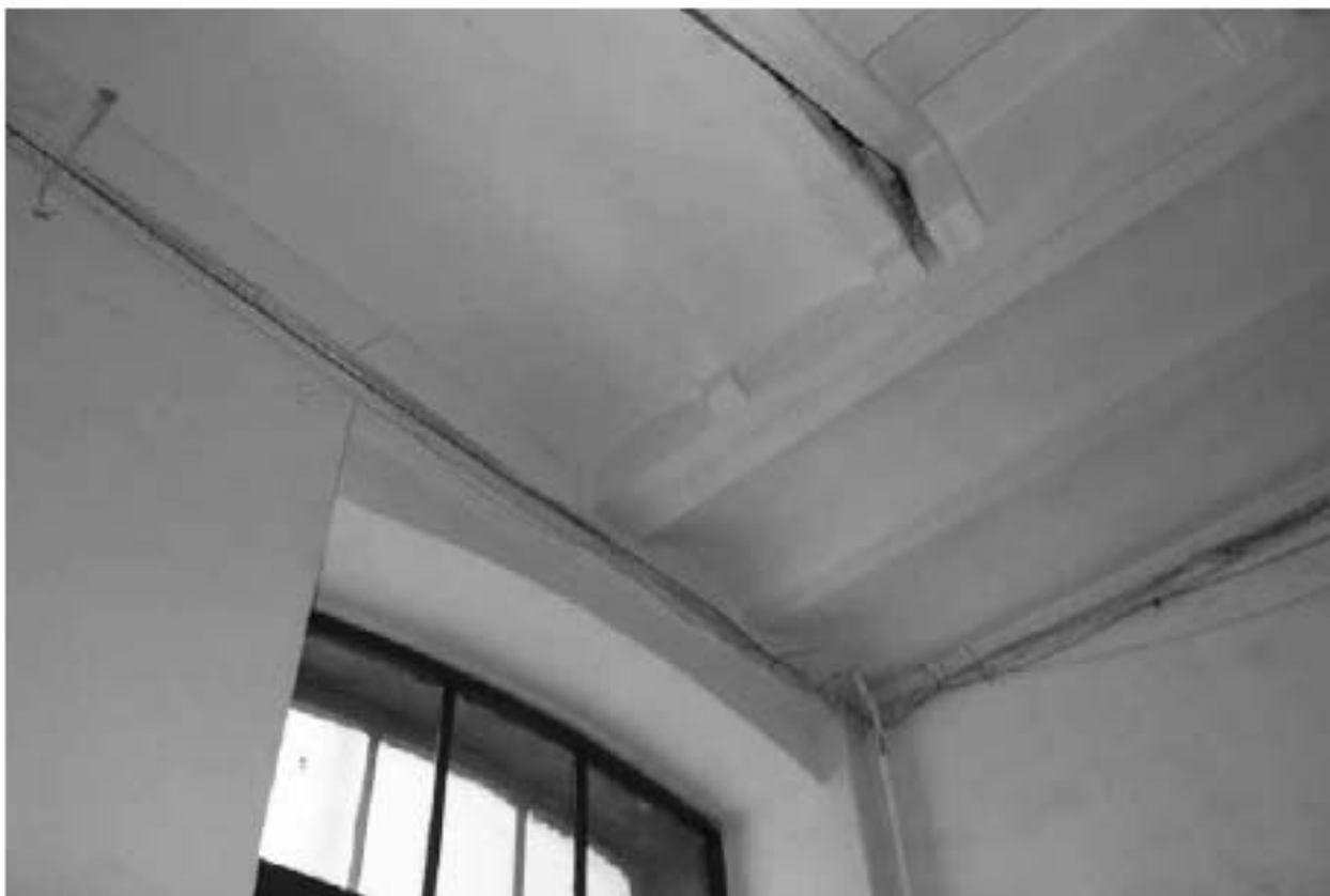
Фото 33. Вид на потолок лестничной площадки Л-2 в уровне 3-го этажа.
