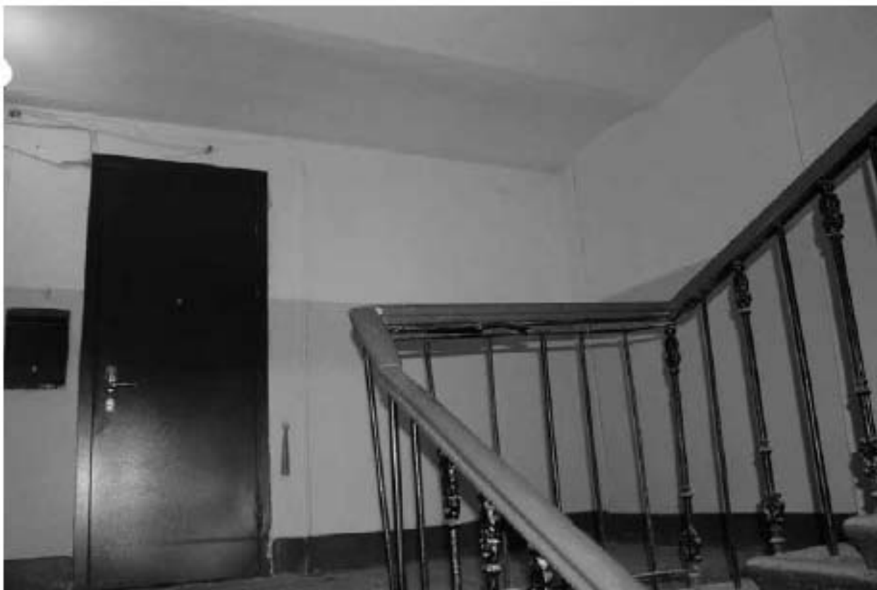
Фото 53. Вид на лестничную площадку Л-3 в уровне 6-го этажа.
