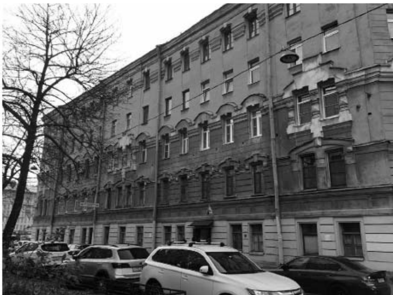
Фото 335. Вид на восточный фасад восточного корпуса.
