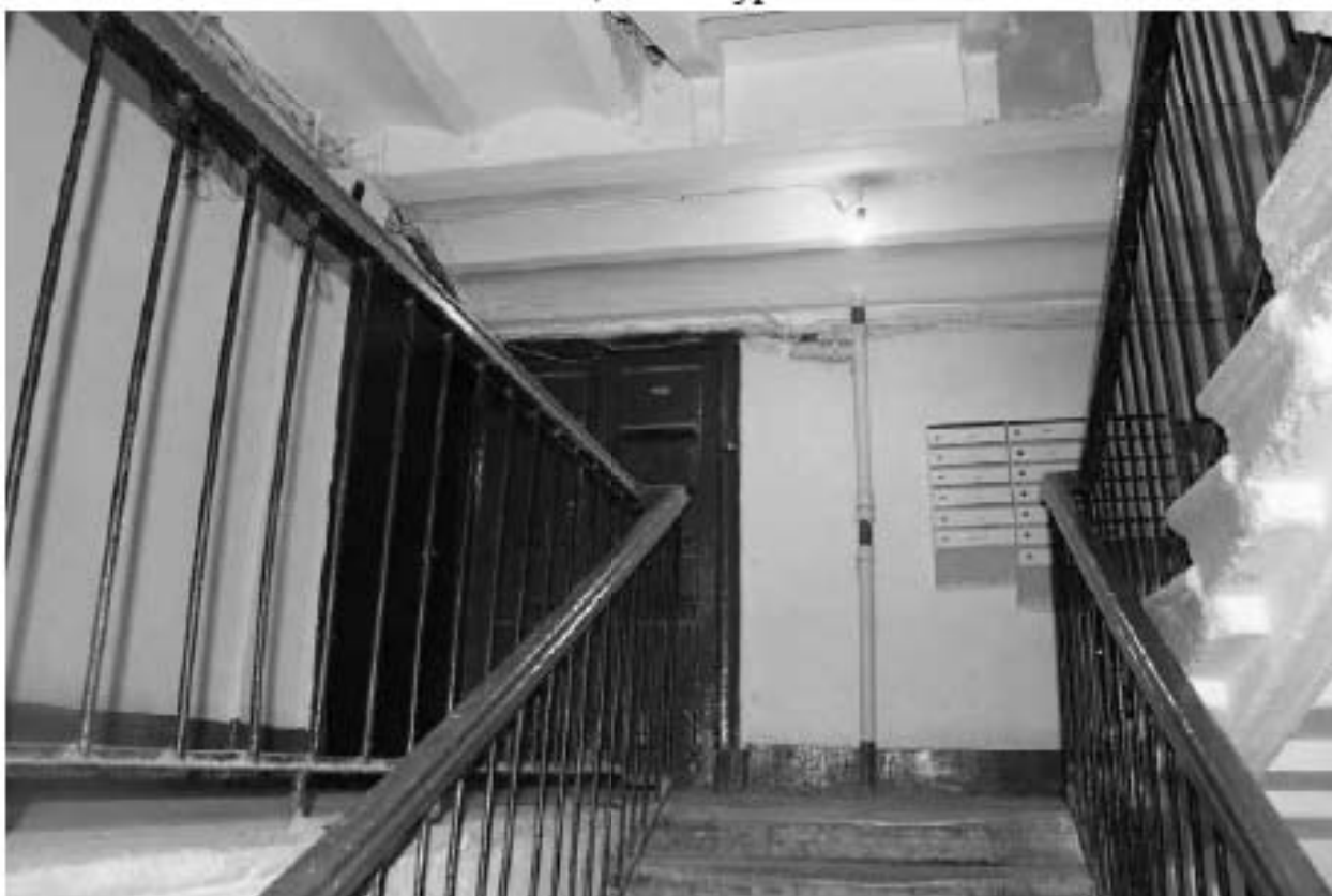
Фото 87. Вид на лестничную площадку 2ЛК в уровне 2-го этажа.
