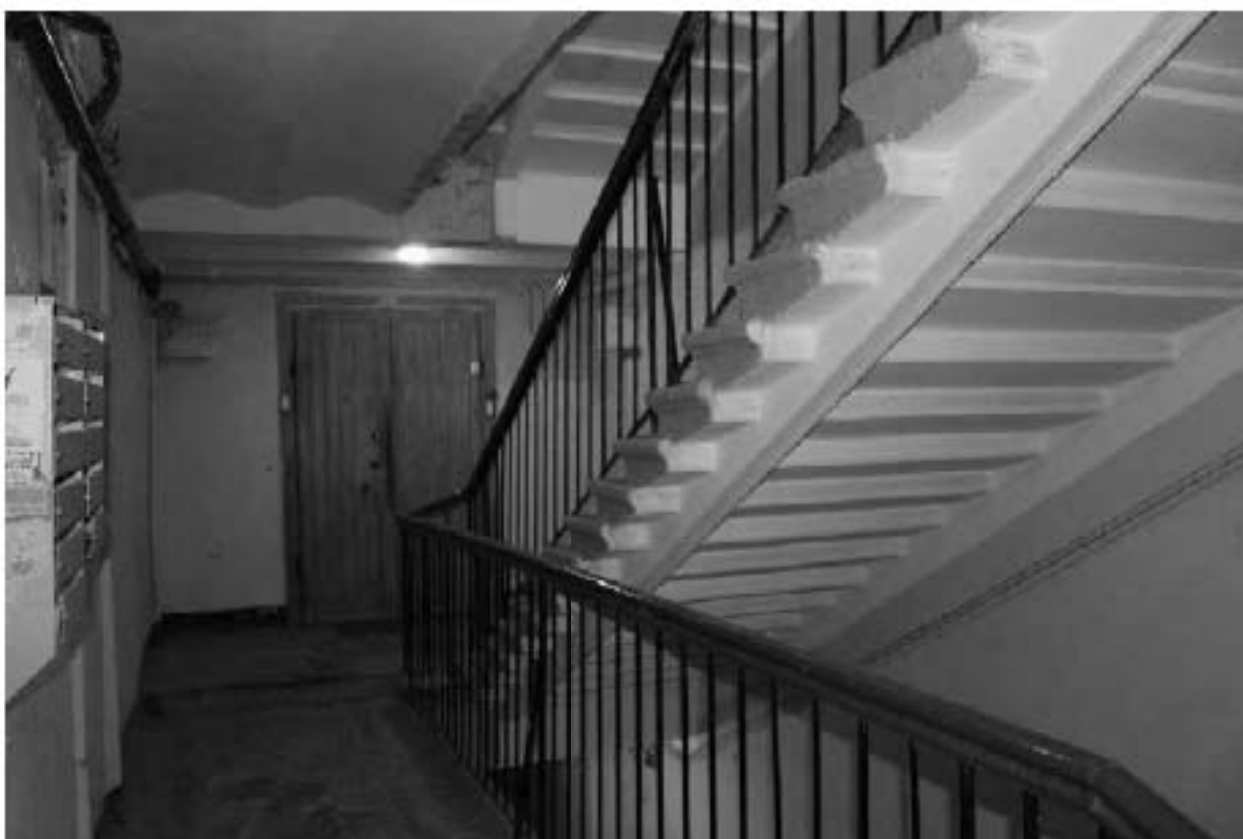
Фото 94. Вид на лестничную площадку ЗЛК в уровне 2-го этажа.
