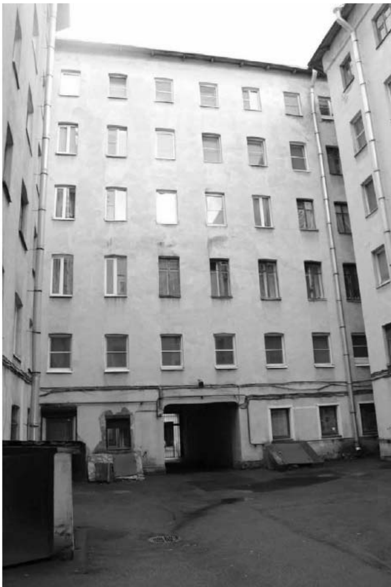
Фото 154. Вид на южный фасад северного корпуса.
