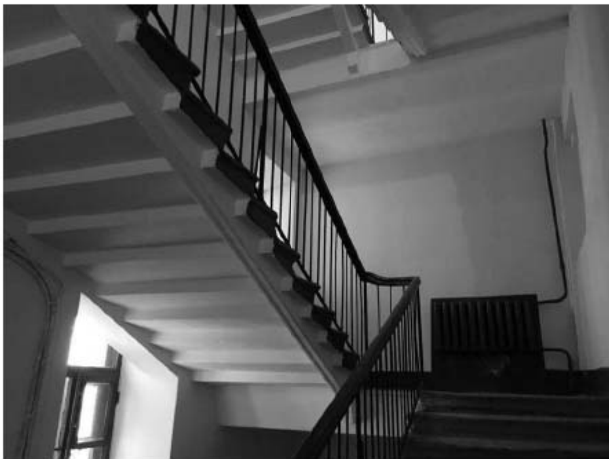
Фото 365. Вид на лестницу Л-4 в уровне 2-го – 3-го этажей.
