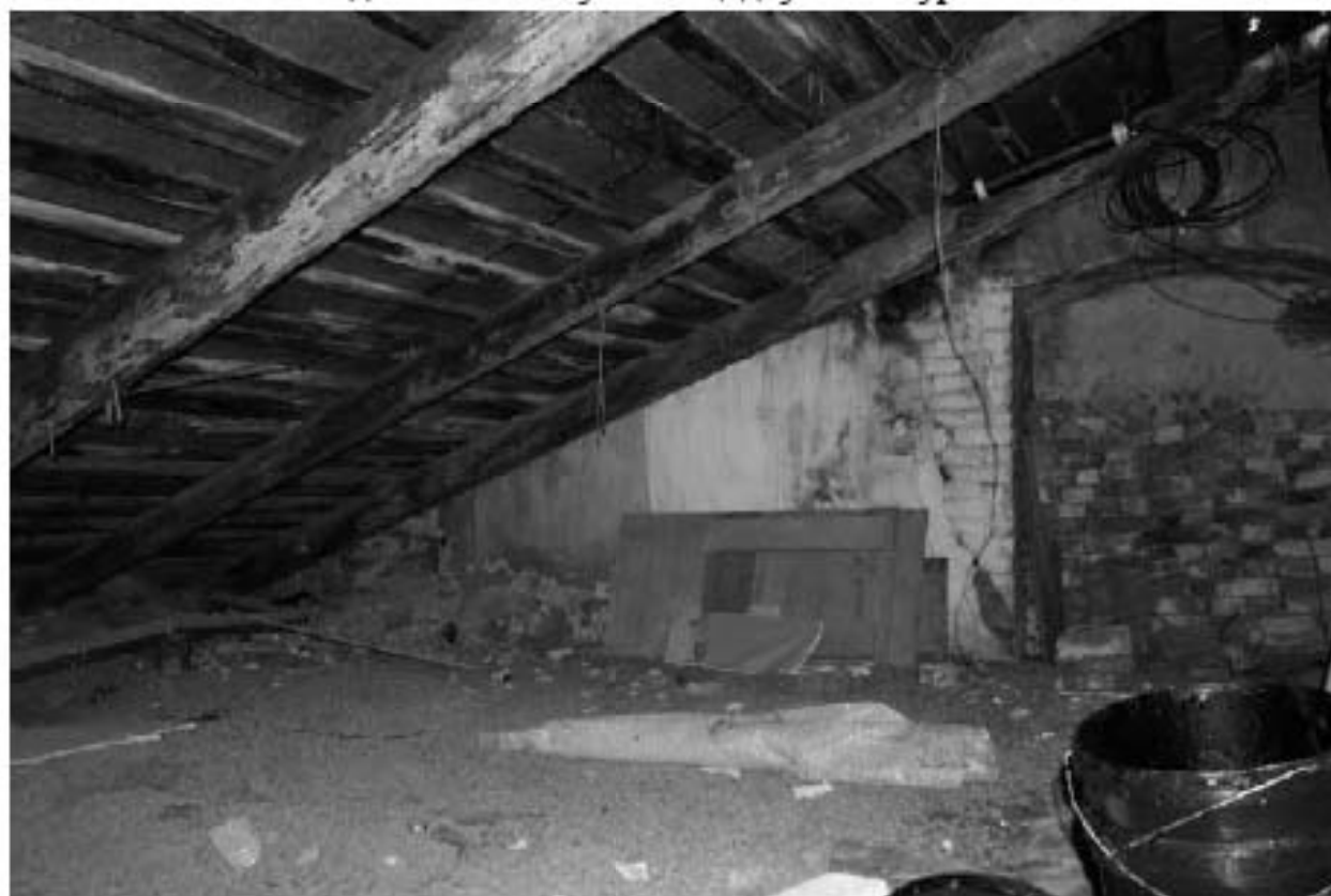
Фото 145. Вид на чердачные помещения.
