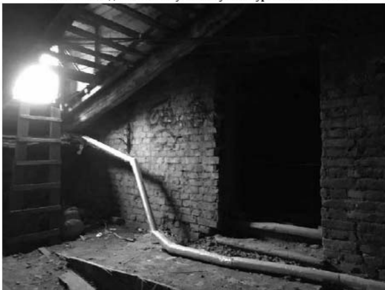
Фото 328. Вид на чердачные помещения.
