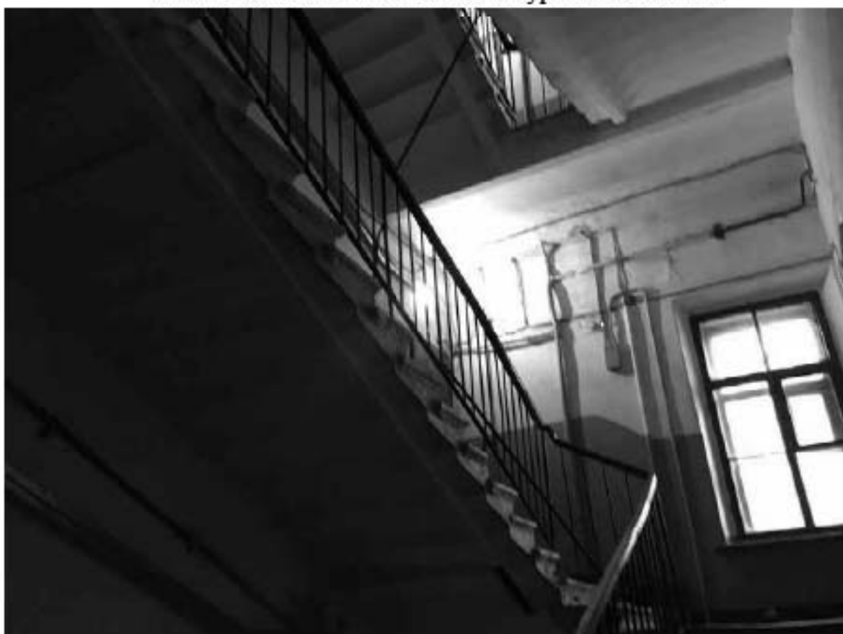
Фото 322. Лестничная клетка Л-4 в уровне 2-го этажа.
