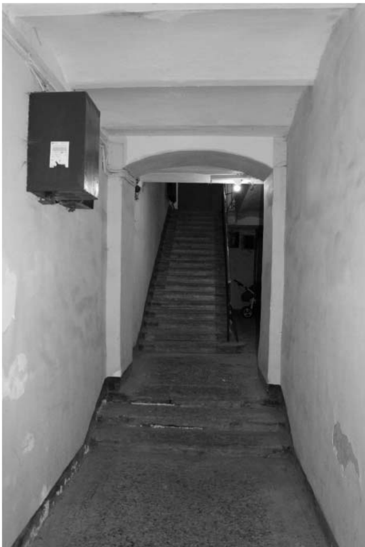
Фото 91. Вид на вестибюль ЗЛК
