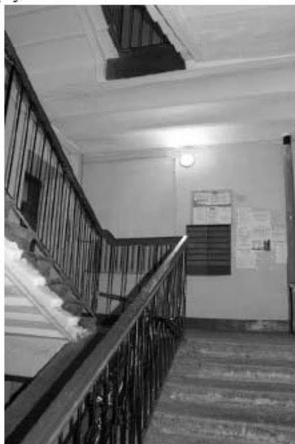
Фото 241. Вид на междуэтажную площадку Л-3 в уровне 1-го – 2-го этажей.
