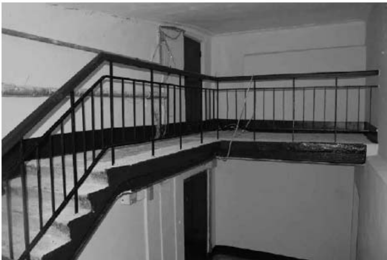
Фото 132. Вид на лестничную клетку ЗЛК в уровне 6-го этажа.
