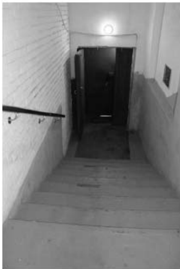
Фото 246. Вид вестибюль Л-4.
