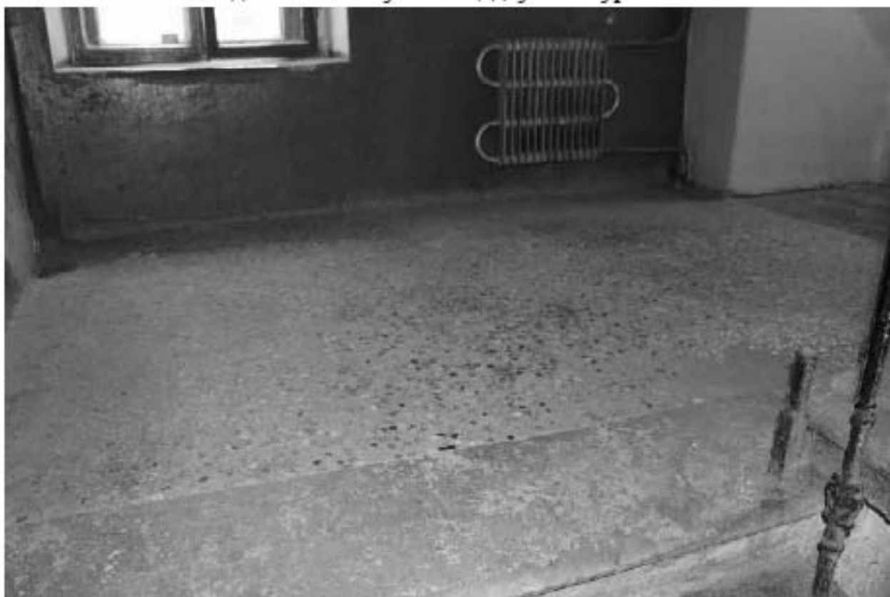
Фото 20. Междуетажная площадка Л-1 в уровне 4-го – 5-го этажей.
