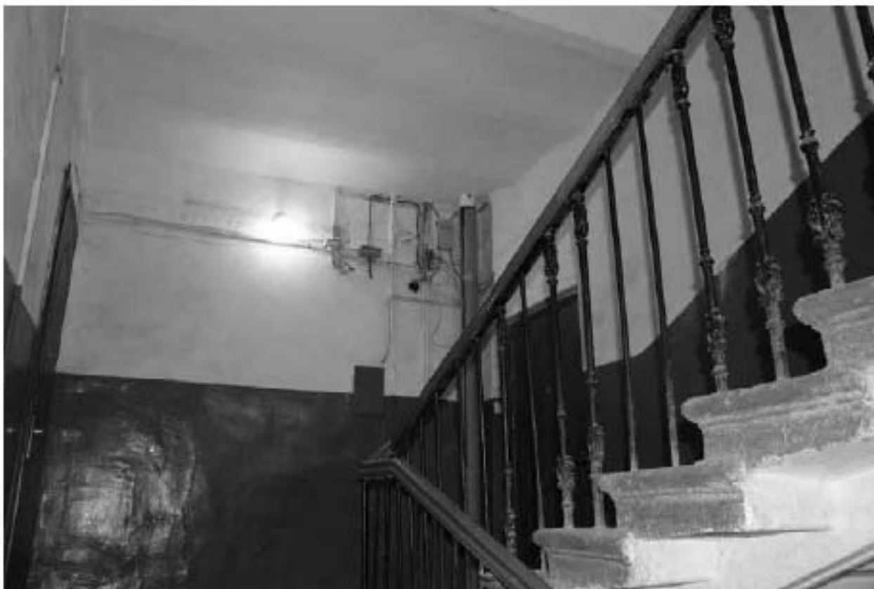
Фото 19. Вид на лестничную площадку Л-1 в уровне 4-го этажа.
