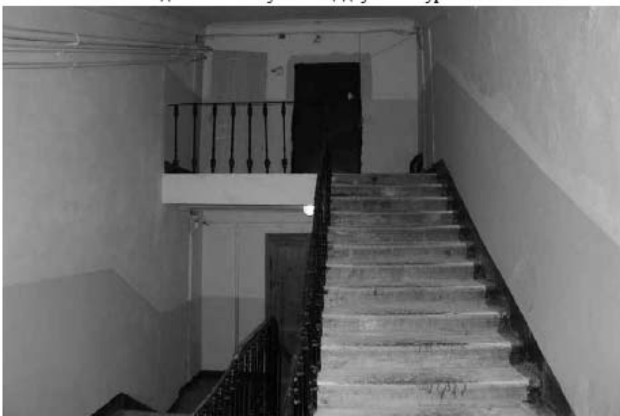
Фото 102. Вид на лестничную клетку 4ЛК в уровне 6-го этажа.
