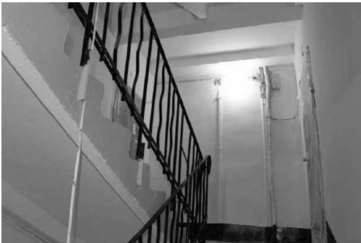
Фото 59. Вид на лестничную площадку 4ЛК в уровне 5-го этажа.
