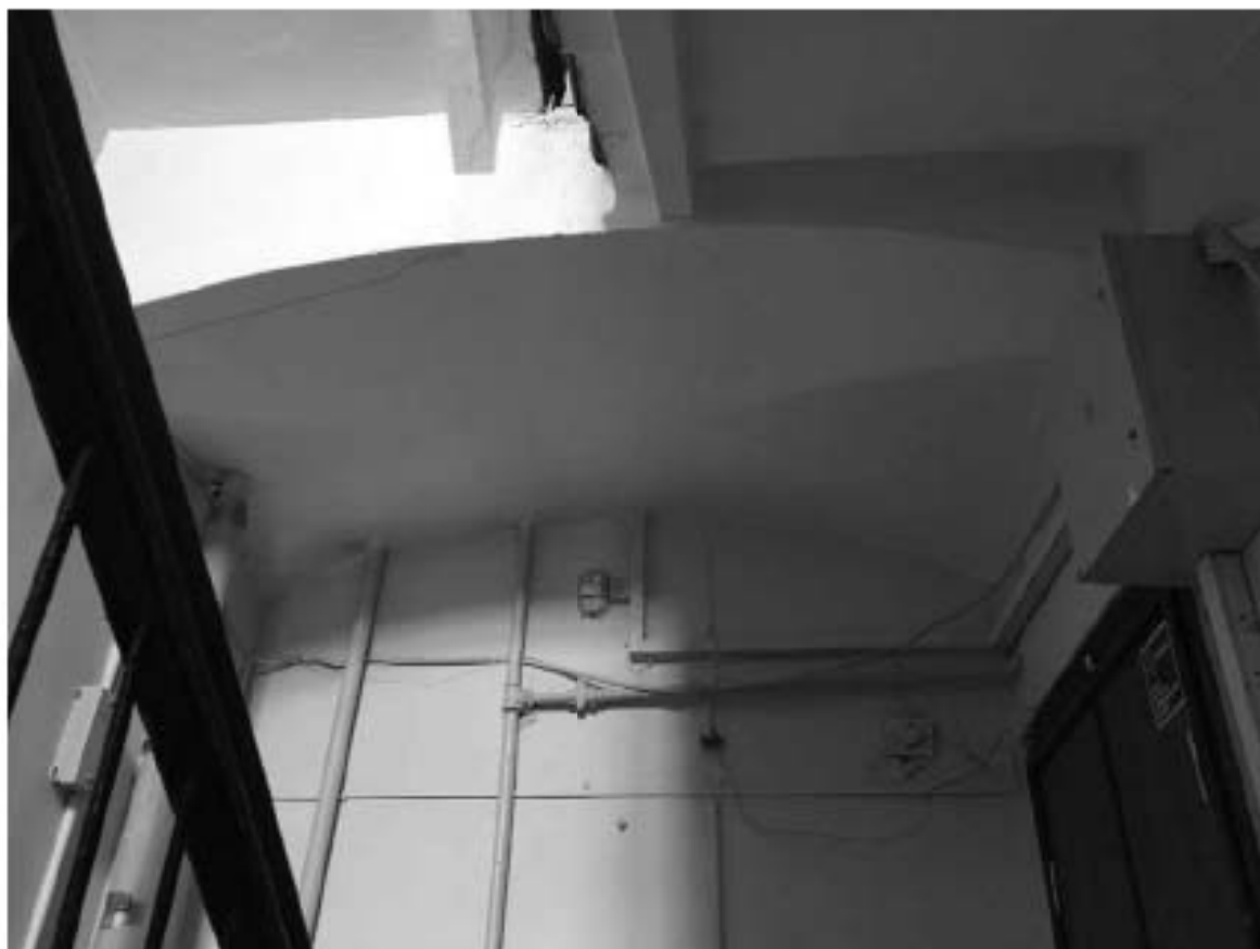
Фото 309. Вид на сводчатое перекрытие лестничной площадки 1ЛК в уровне 2-го этажа.
