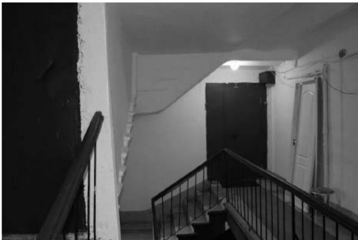
Фото 289. Лестничная площадка Л-4 в уровне 6-го этажа.
