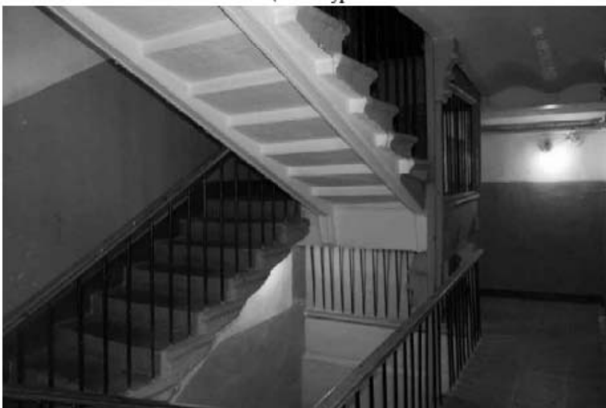
Фото 30. Лестничная площадка Л-2 в уровне 2-го этажа.
