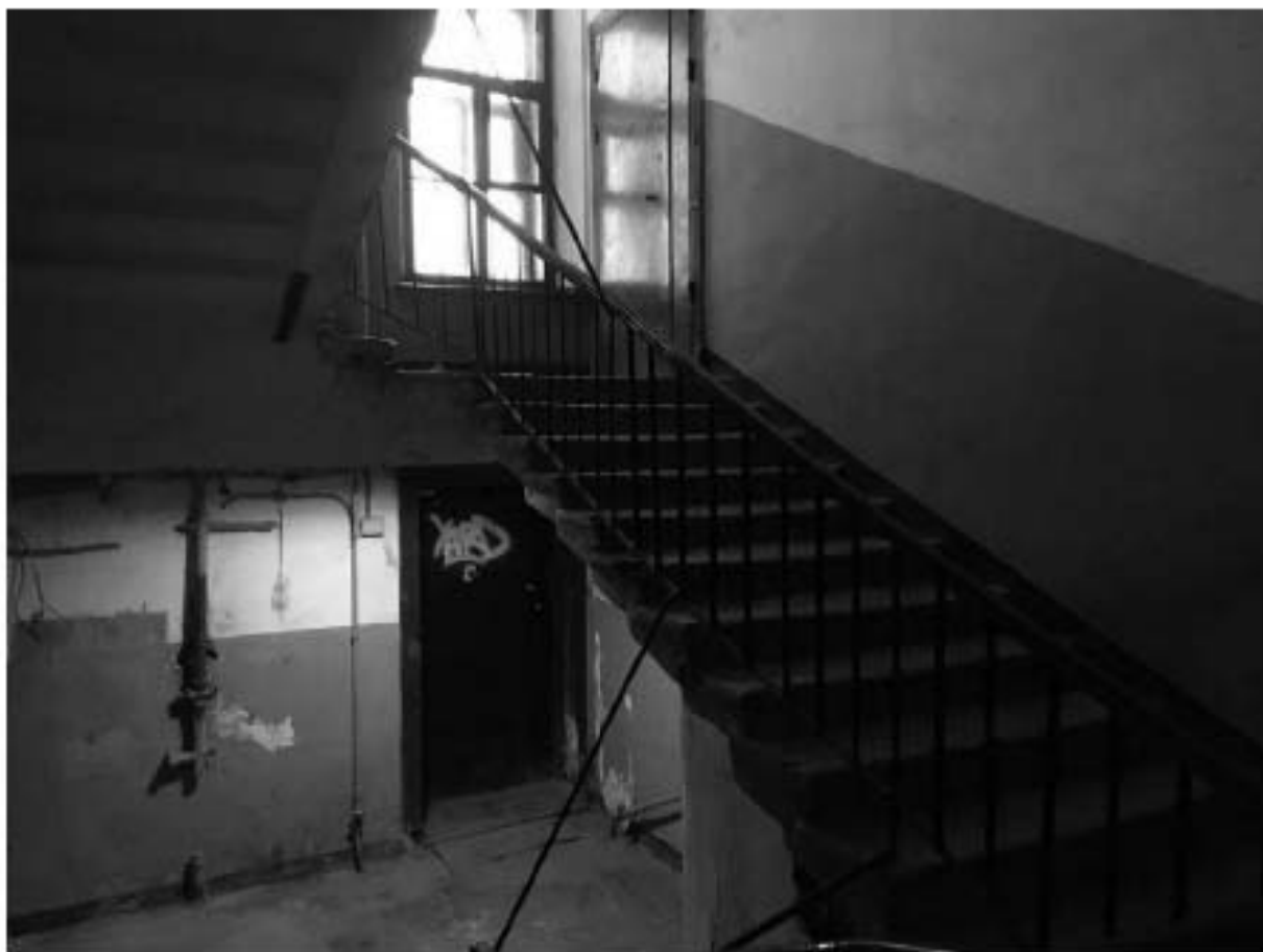
Фото 321. Лестничная клетка Л-4 в уровне 1-го этажа.
