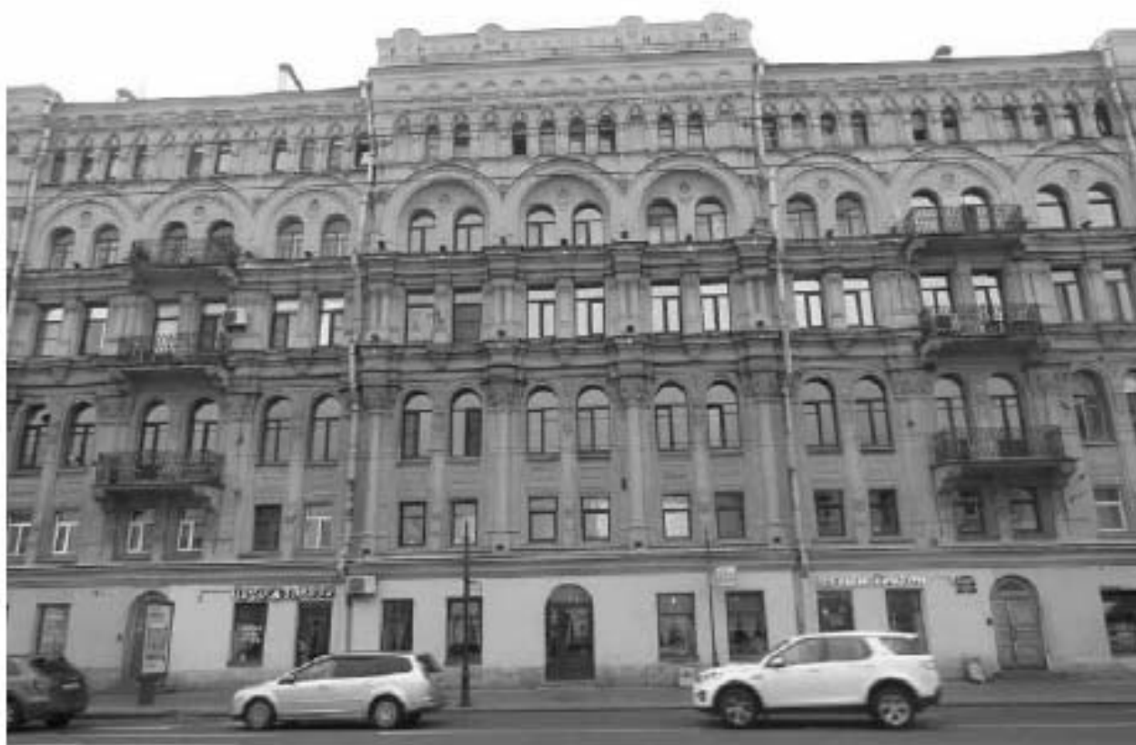
Фото 3. Вид на восточный фасад восточного корпуса.
