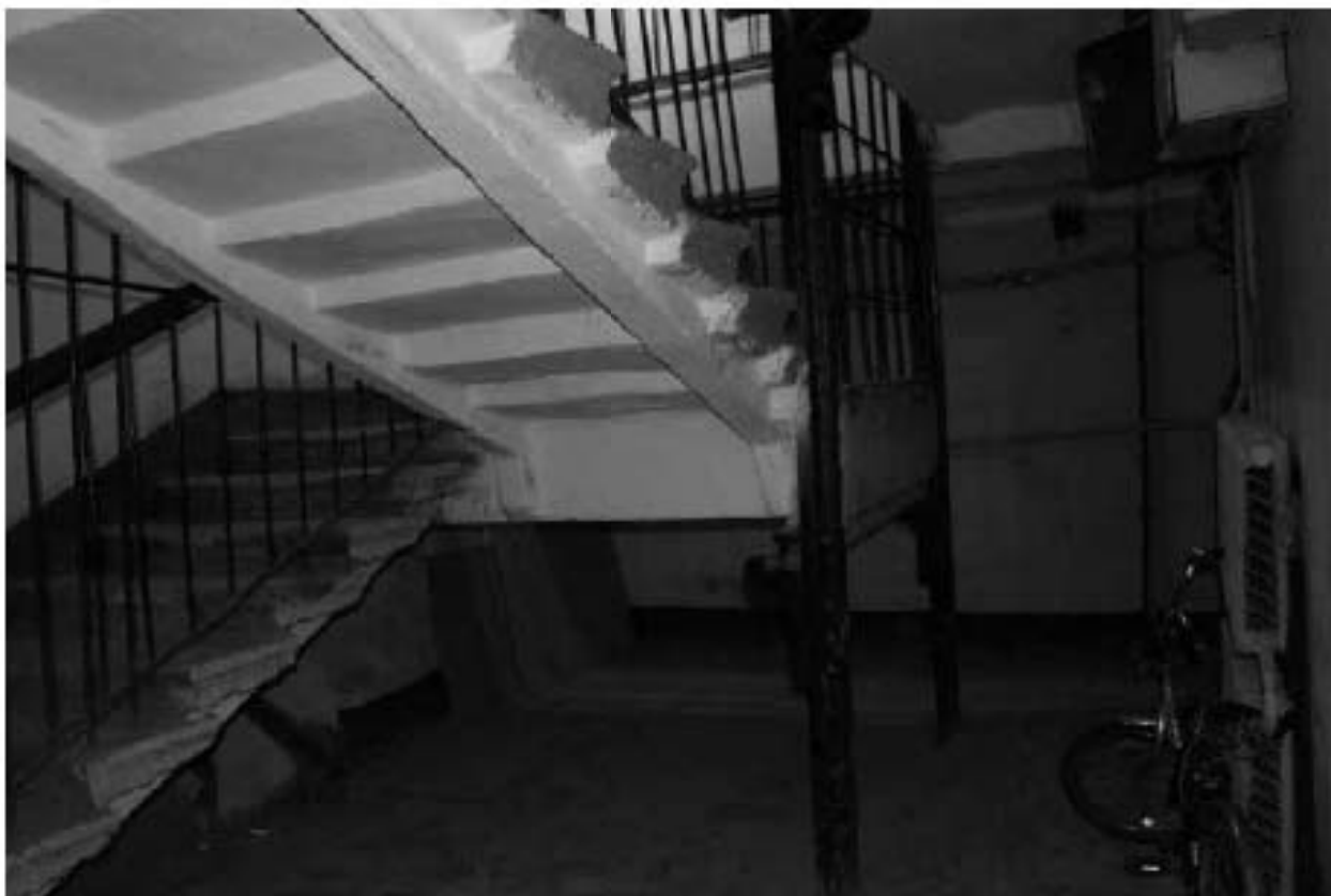
Фото 86. Лестница 2ЛК в уровне 1-го этажа.
