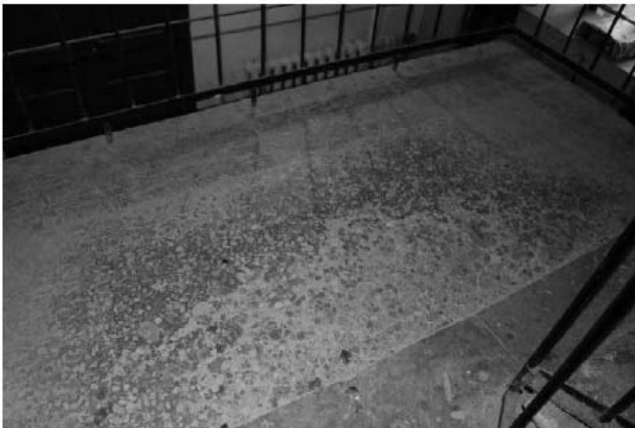
Фото 88. Вид на пол междуэтажной площадки лестницы 2ЛК в уровне 3-го – 4-го этажей.
