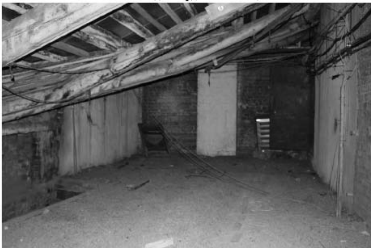
Фото 292. Вид на чердачные помещения.
