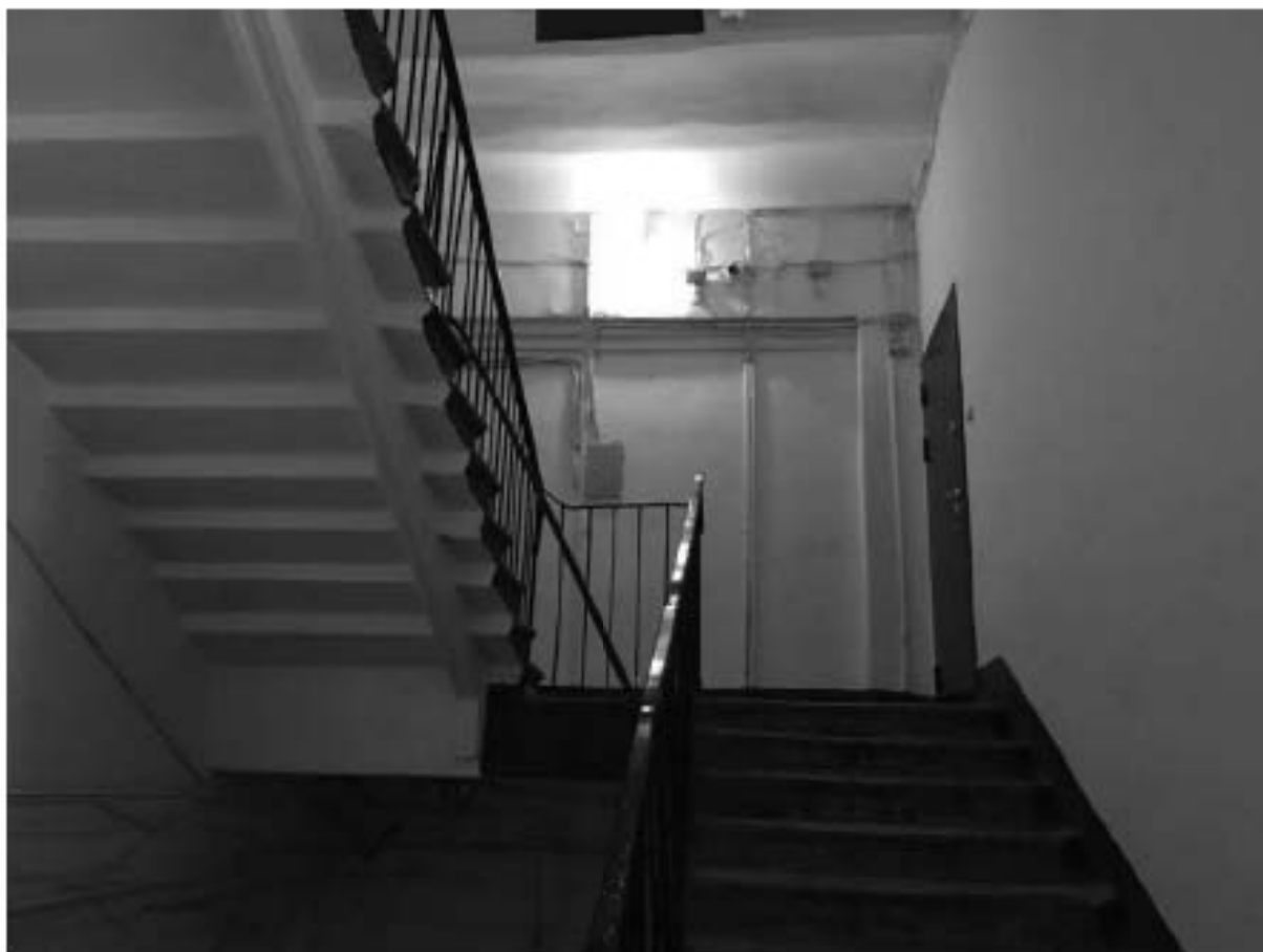
Фото 357. Вид на лестничную клетку Л-2 в уровне 2-го этажа.
