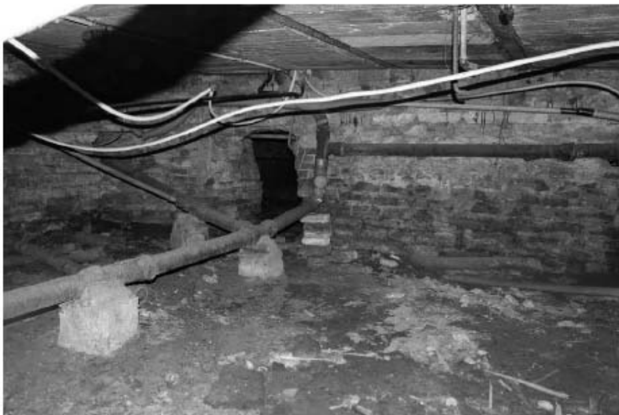
Фото 157. Вид на подвальные помещения.
