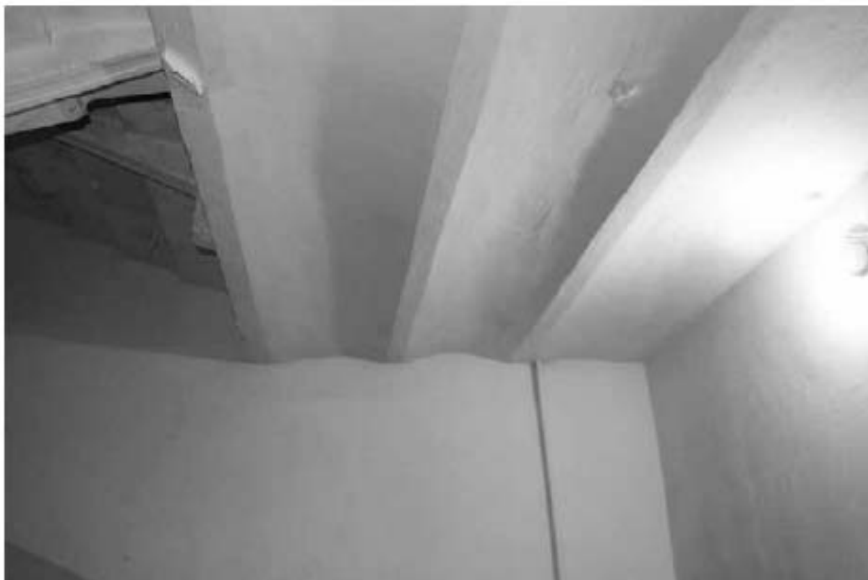
Фото 259. Вид на своды лестничной площадки Л-5 в уровне 4-го этажа.
