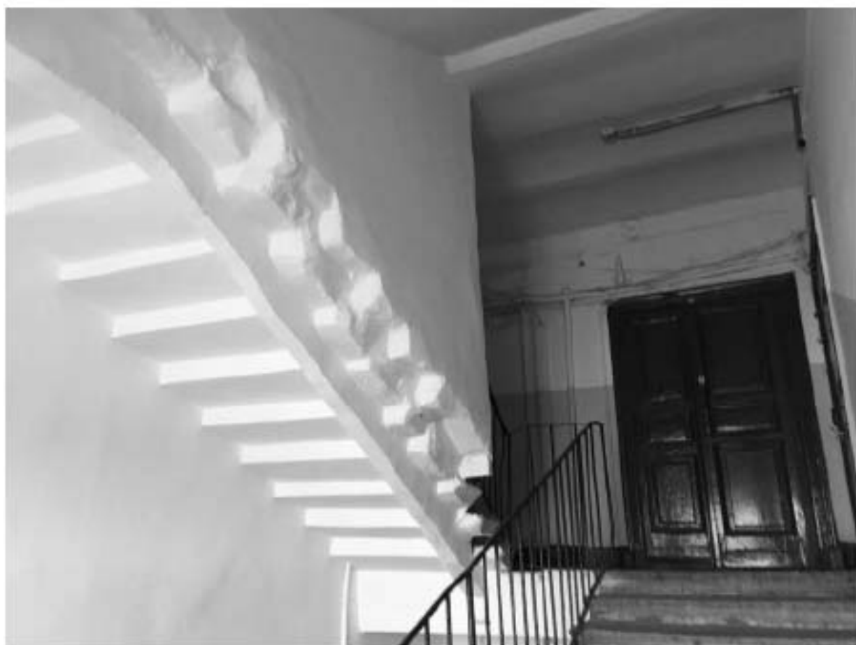
Фото 327. Вид на лестничную клетку Л-5 в уровне 5-го этажа.
