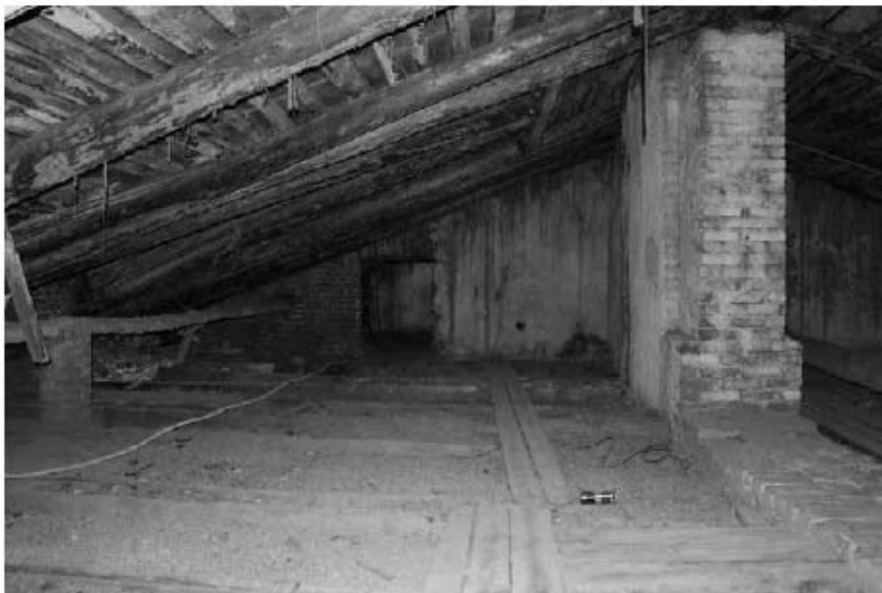
Фото 103. Вид на чердачные помещения.
