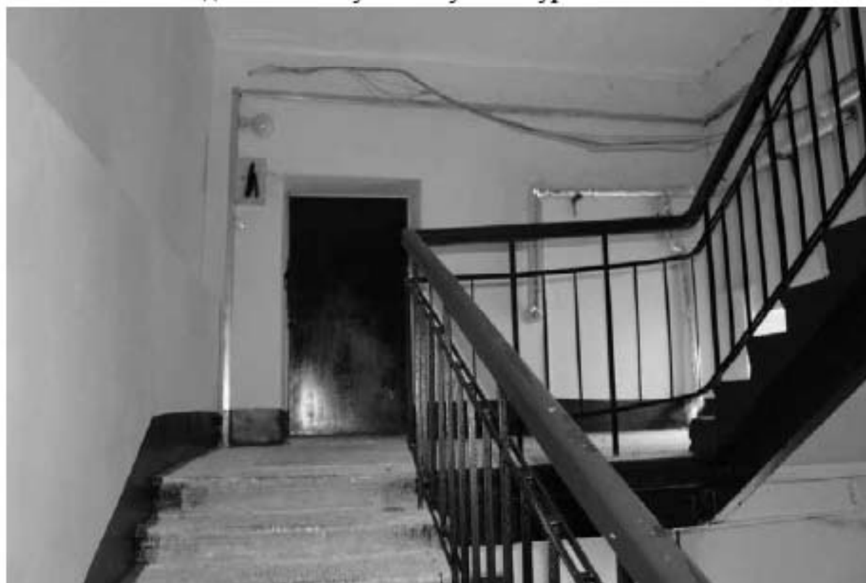
Фото 131. Вид на лестничную клетку ЗЛК в уровне 6-го этажа.
