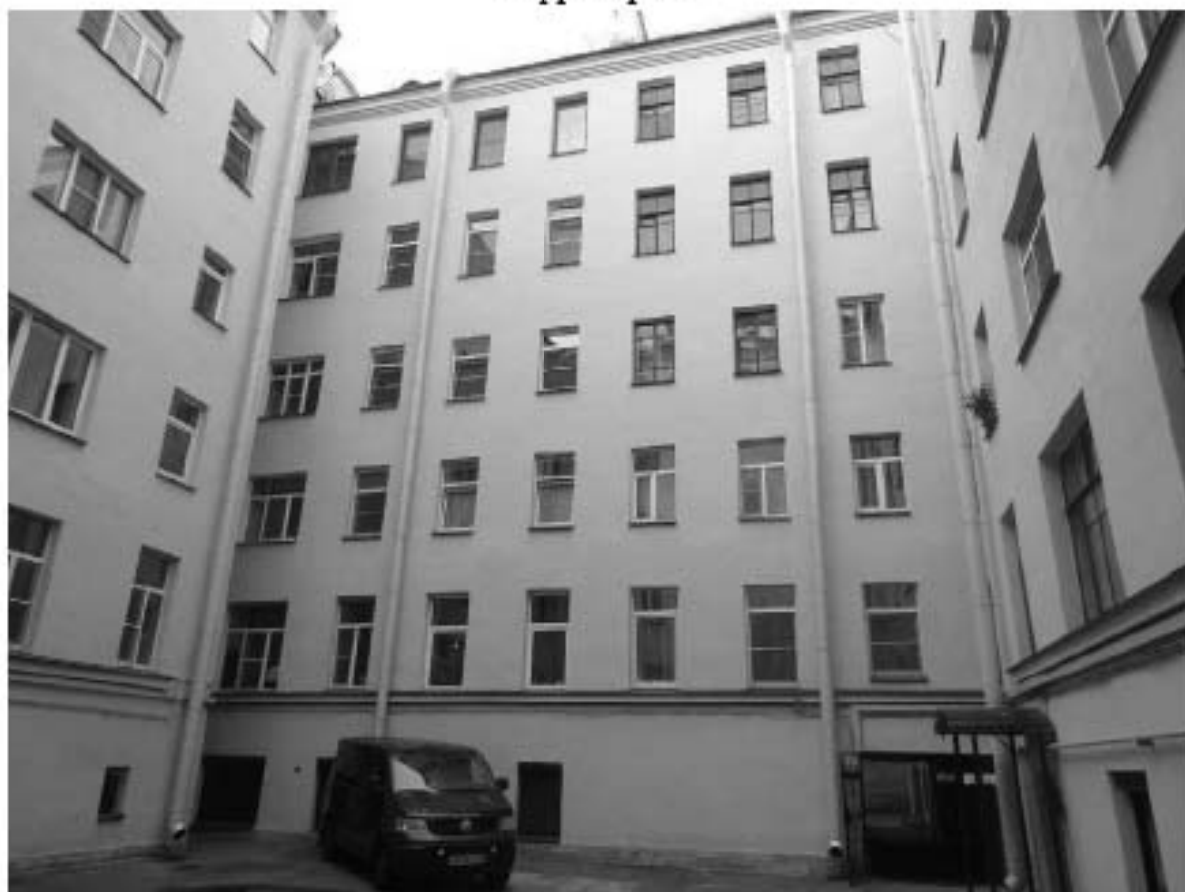
Фото 110. Вид на южный фасад северного корпуса.
