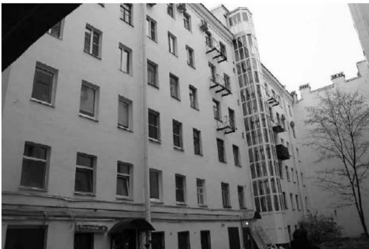
Фото 7. Вид на западный корпус.
