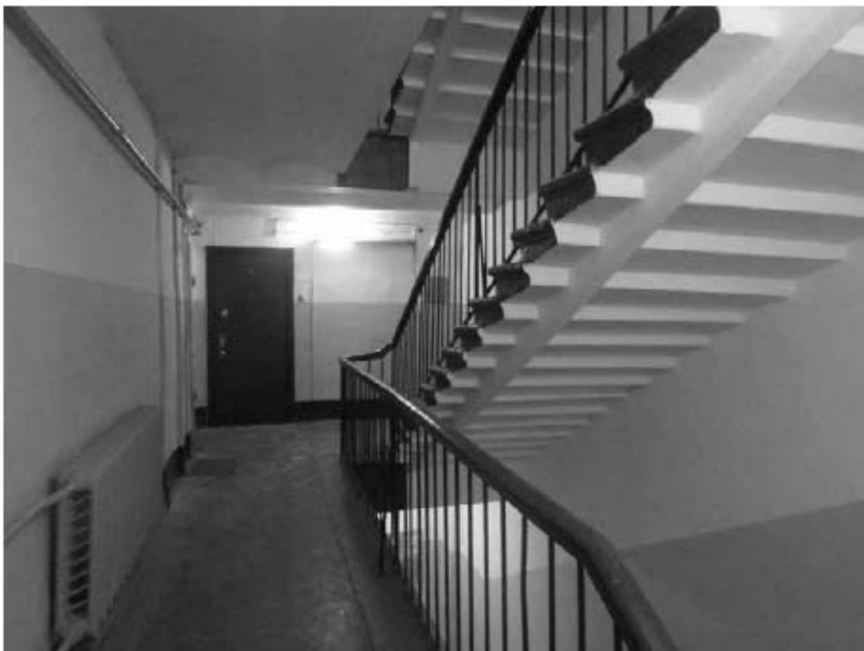
Фото 192. Вид на лестничную клетку 1ЛК в уровне 2-го этажа.
