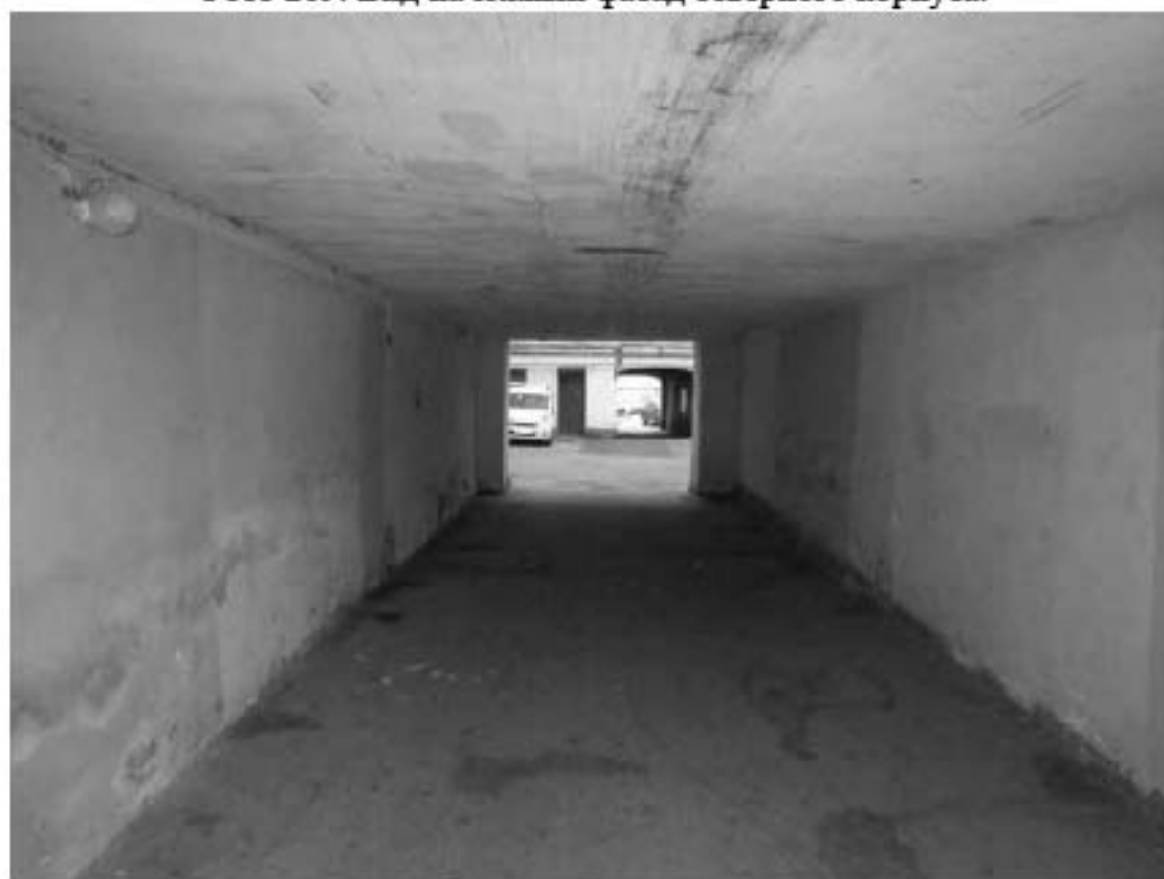
Фото 270. Арка воротного проезда в северном корпусе, вид с севера.
