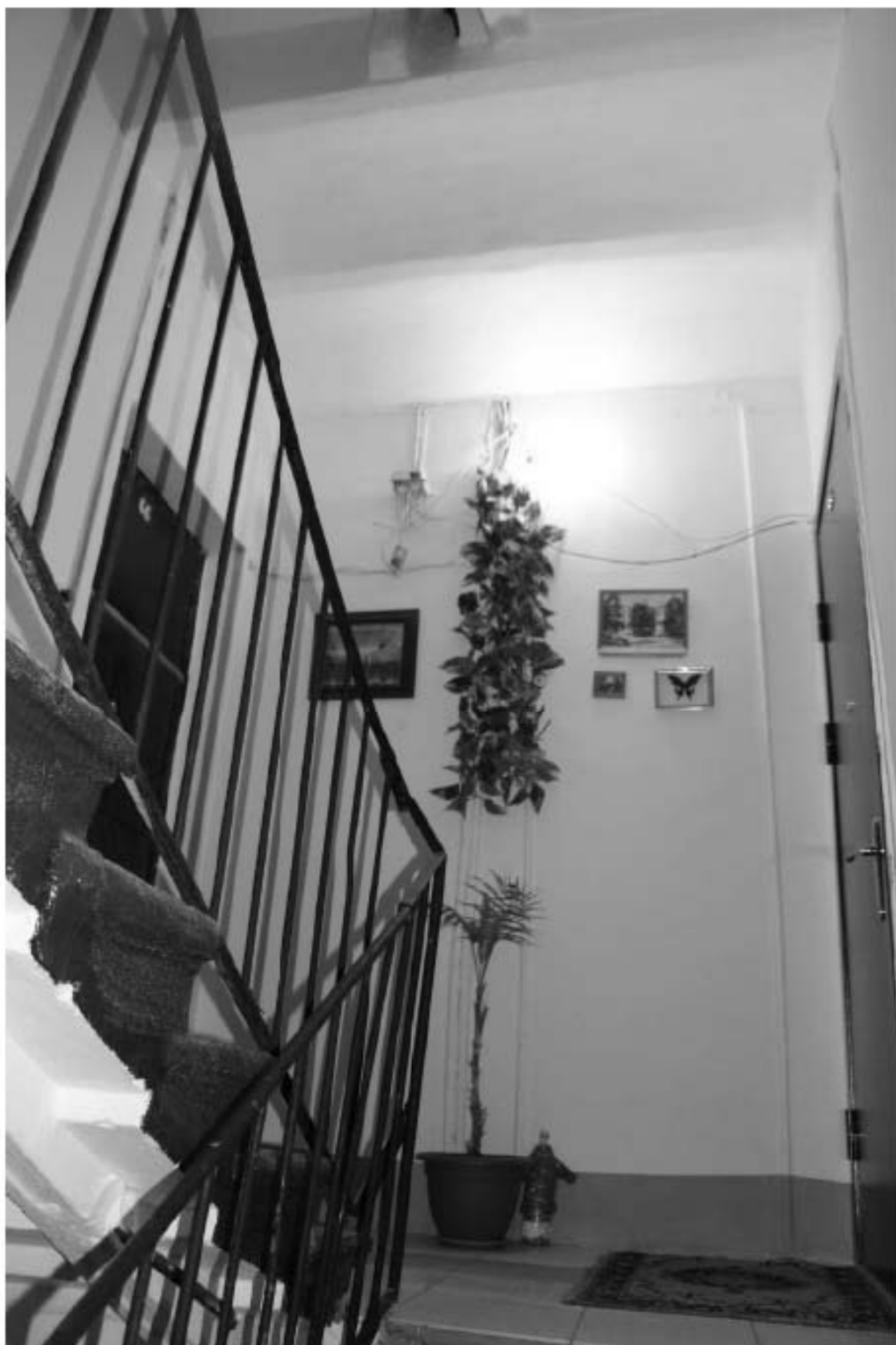
Фото 236. Вид на лестничную площадку Л-2 в уровне 3-го этажа.
