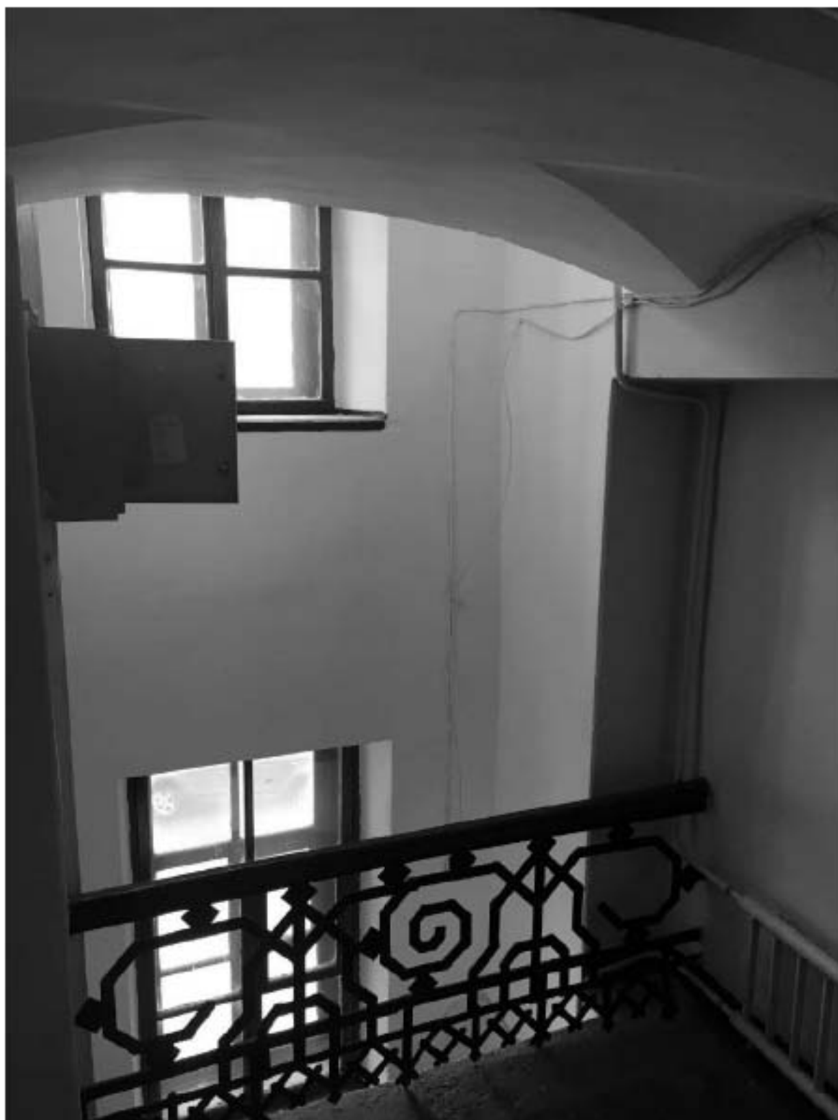
Фото 310. Вид на междуэтажную площадку 1ЛК в уровне 2-го – 3-го этажей.
