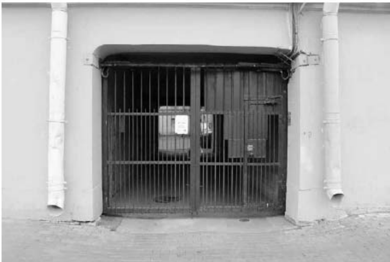
Фото 67. Вид на арку воротного проезда в южном корпусе.
