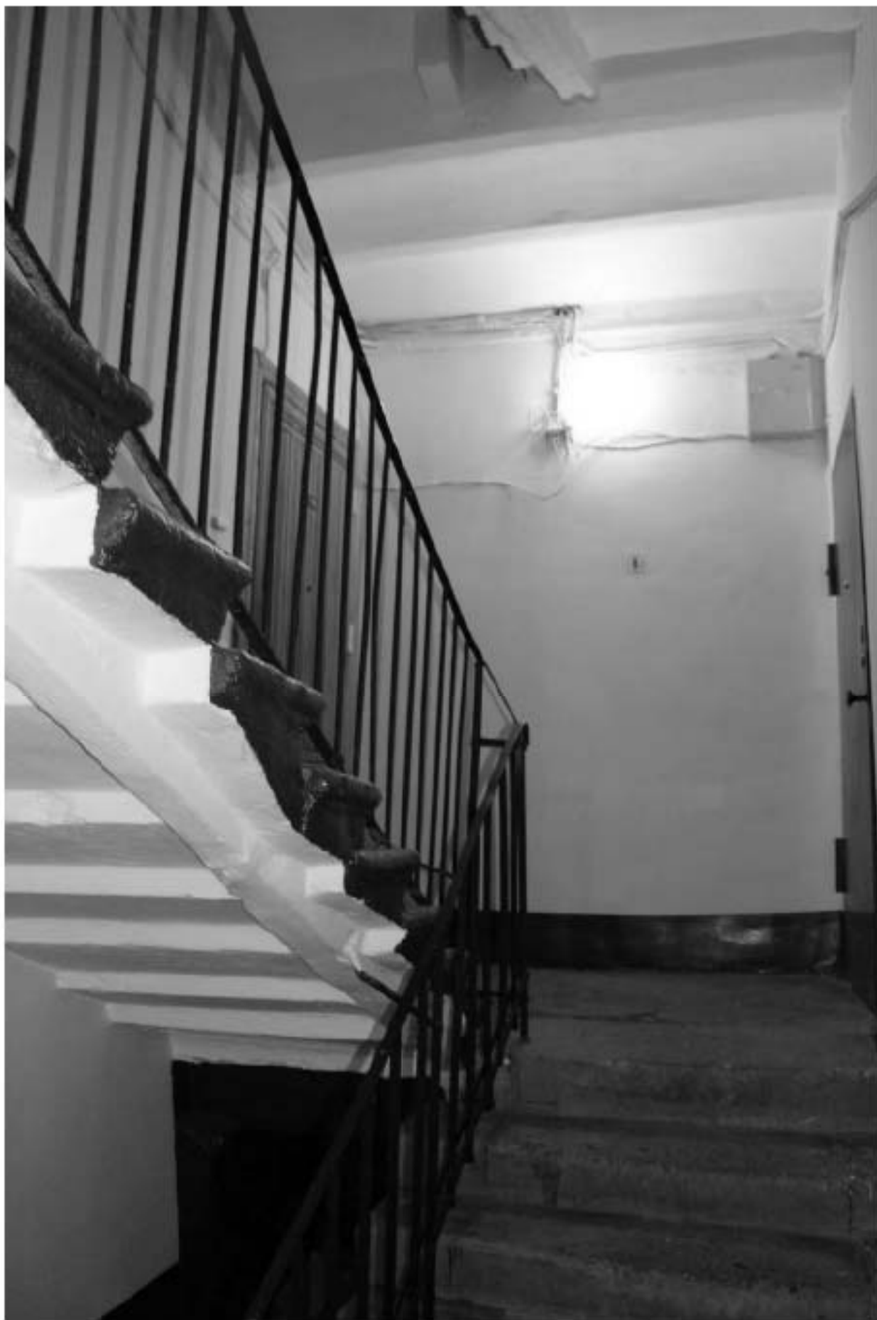
Фото 234. Вид на лестничную клетку Л-2 в уровне 1-го этажа.
