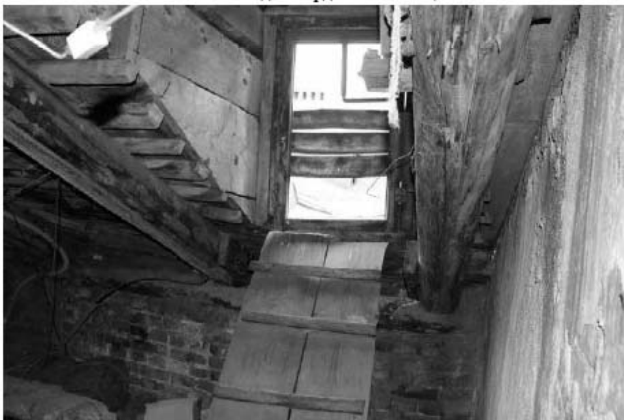
Фото 106. Вид на чердачные помещения.
