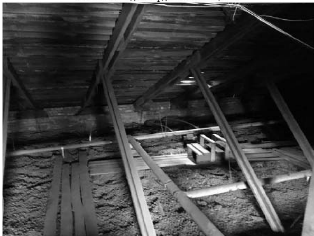
Фото 370. Вид на чердачные помещения.
