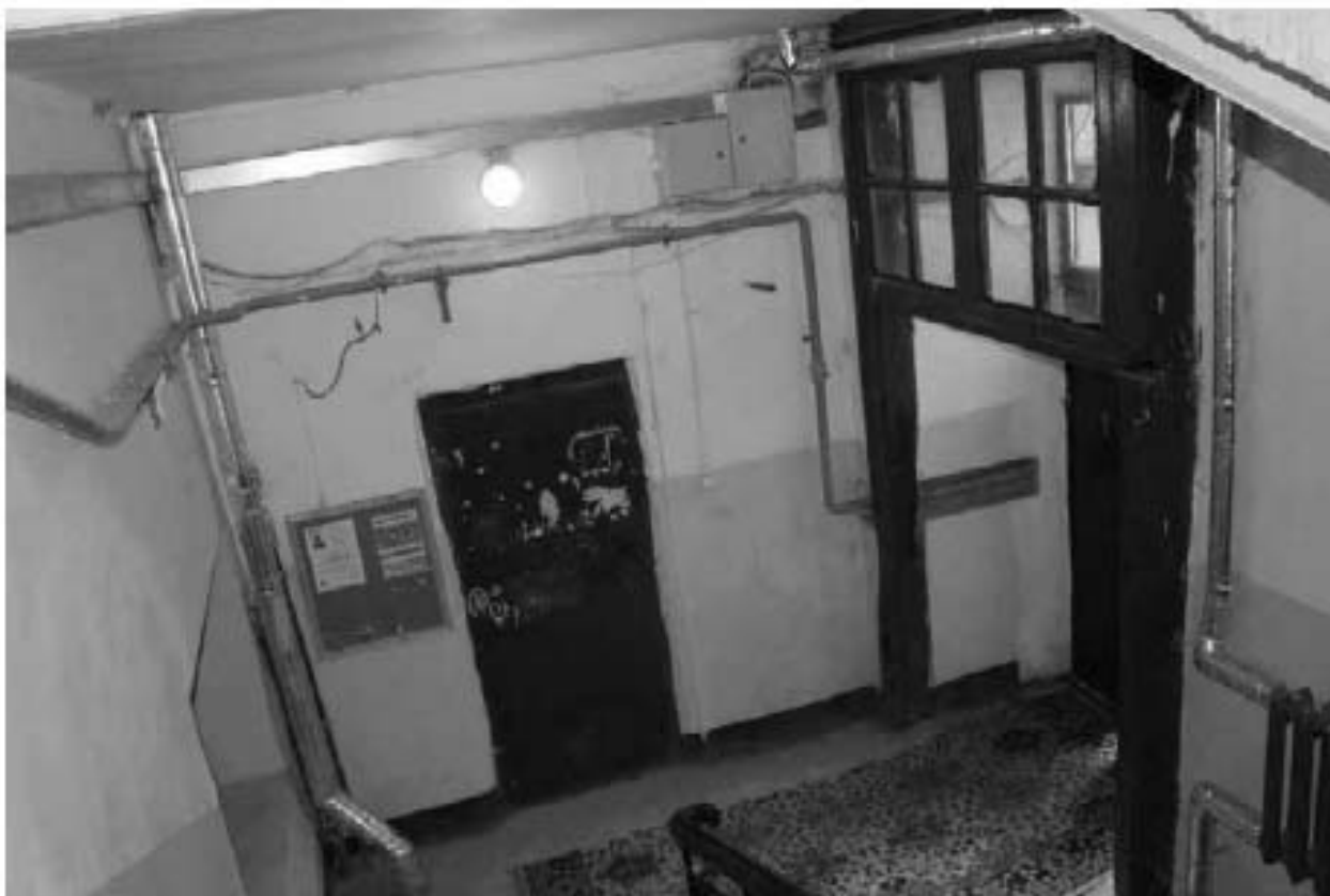
Фото 140. Вид на лестничную клетку 5ЛК в уровне 1-го этажа.
