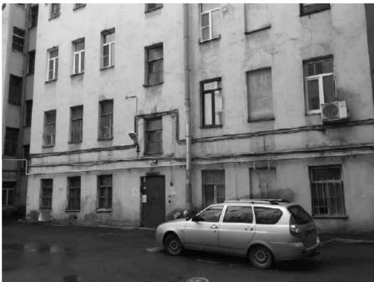
Фото 343. Вид на западный фасад восточного корпуса.
