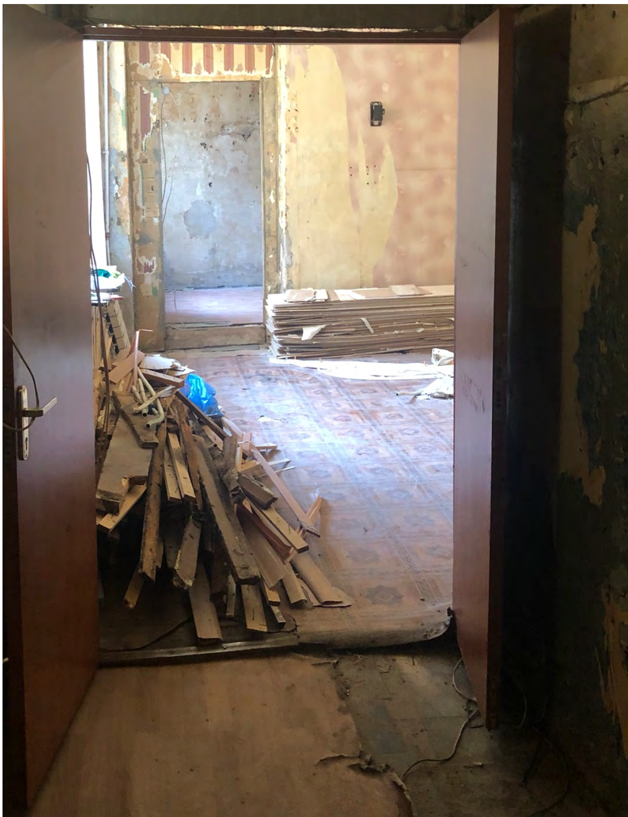
6. Фрагмент интерьера коридора (помещение 1/7.2);
