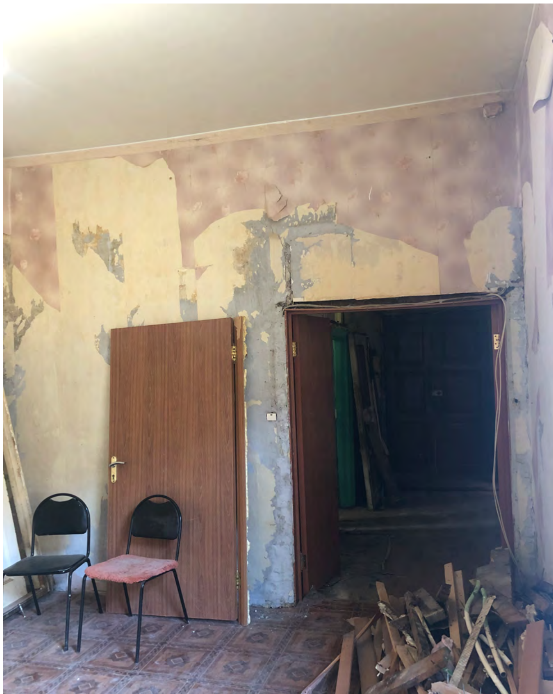
9. Фрагмент интерьера комнаты (помещение 5/17.3);
