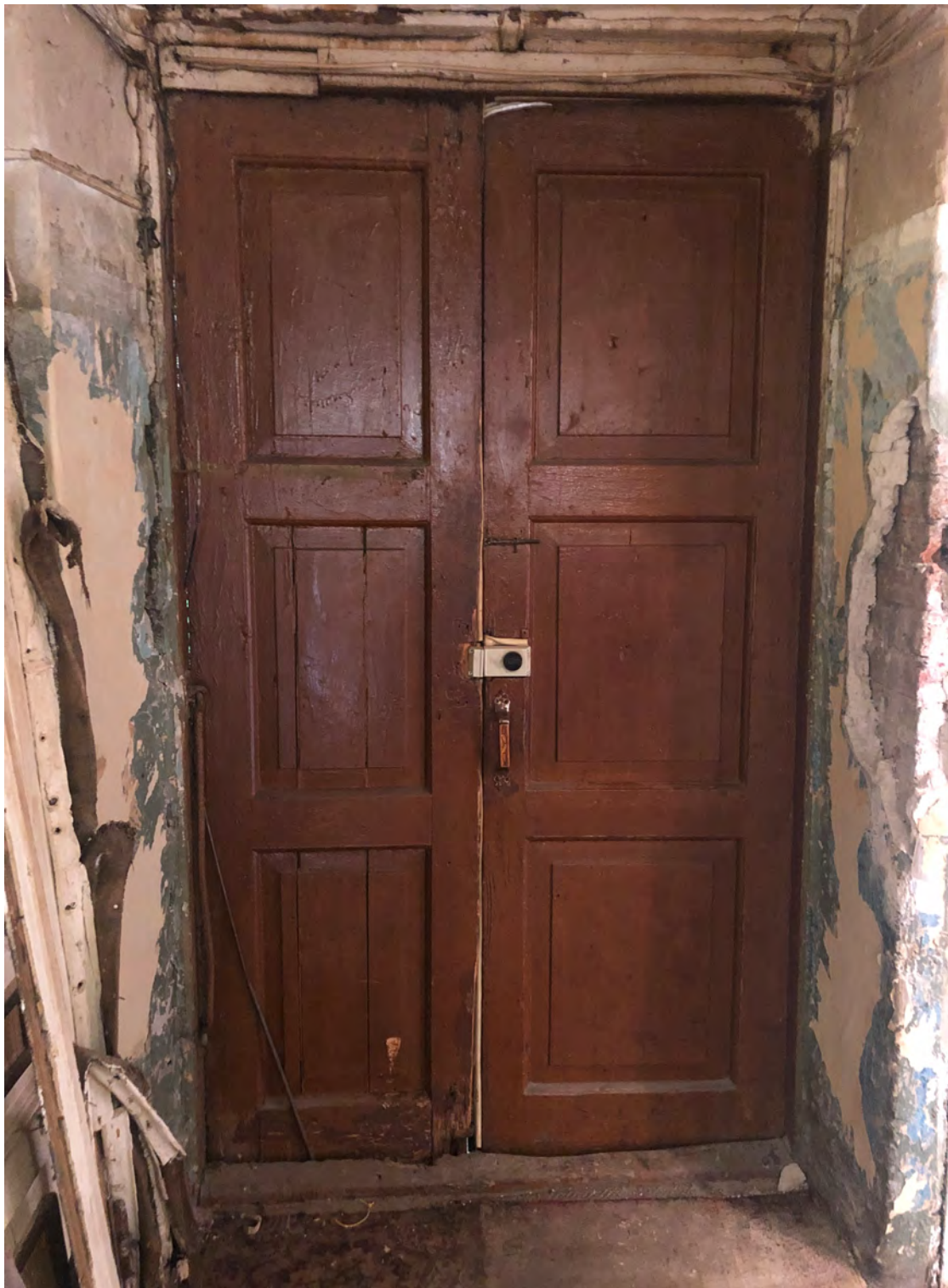
3. Вид на входную дверь в квартире;
