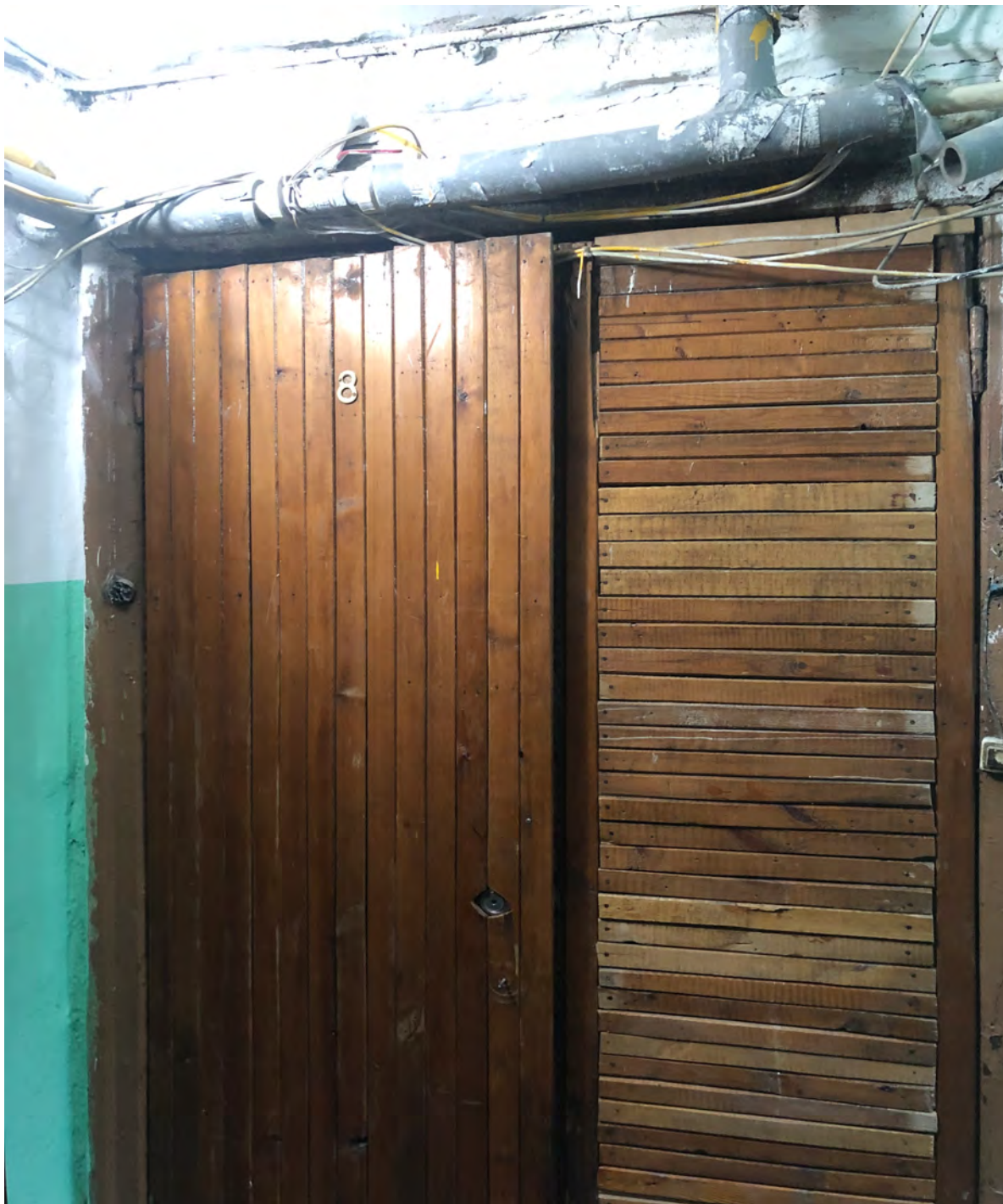
2. Вид на входную дверь в квартиру;
