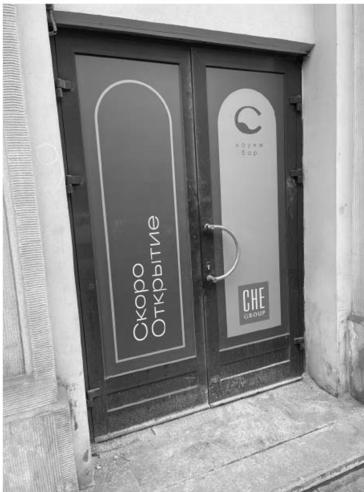
4. Вид на входную дверь в помещение 1-Н
