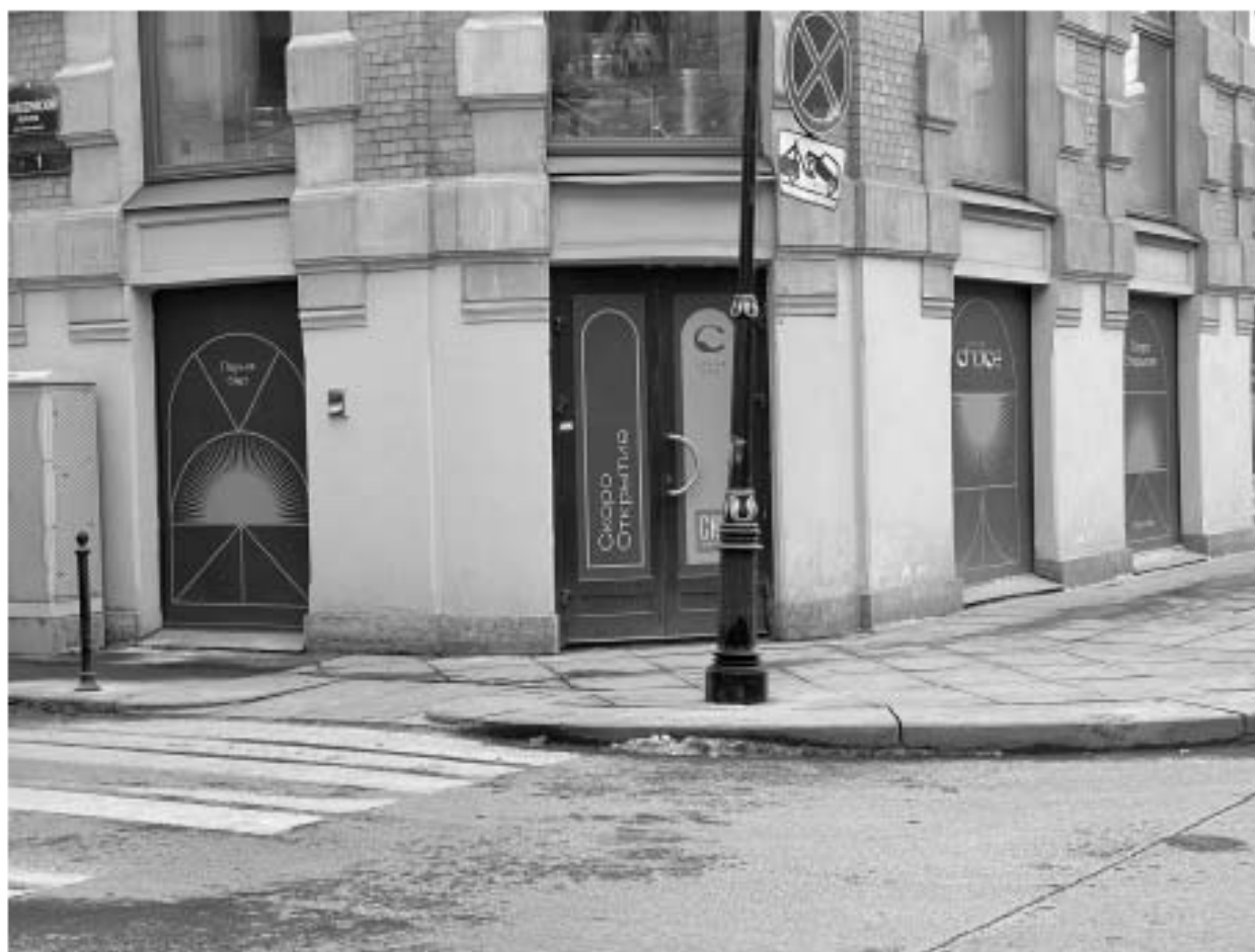
3. Вид на входную дверь в помещение 1-Н;
