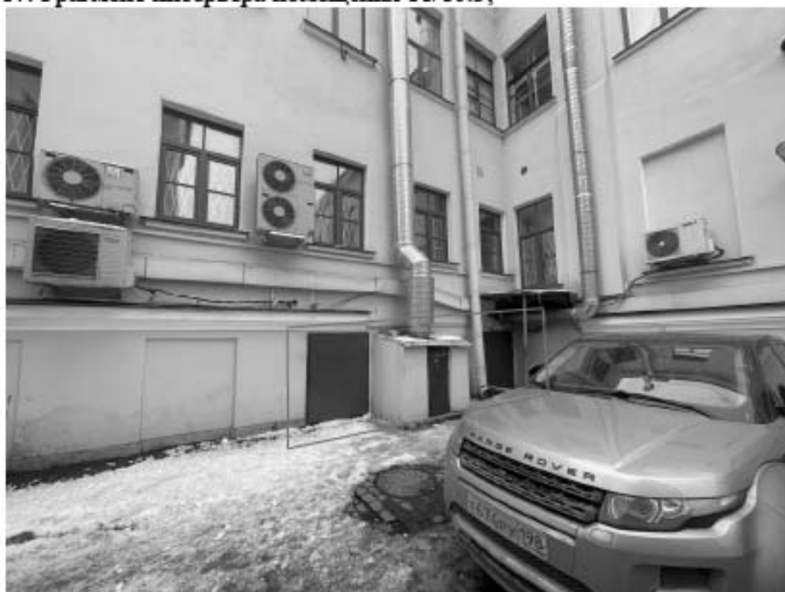
18. Вид дворового фасада;
