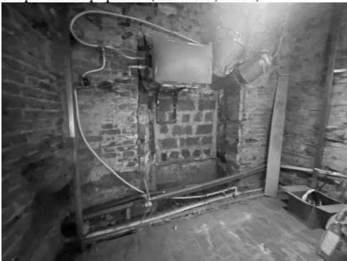
20. Фрагмент интерьера помещения 18/5.2;
