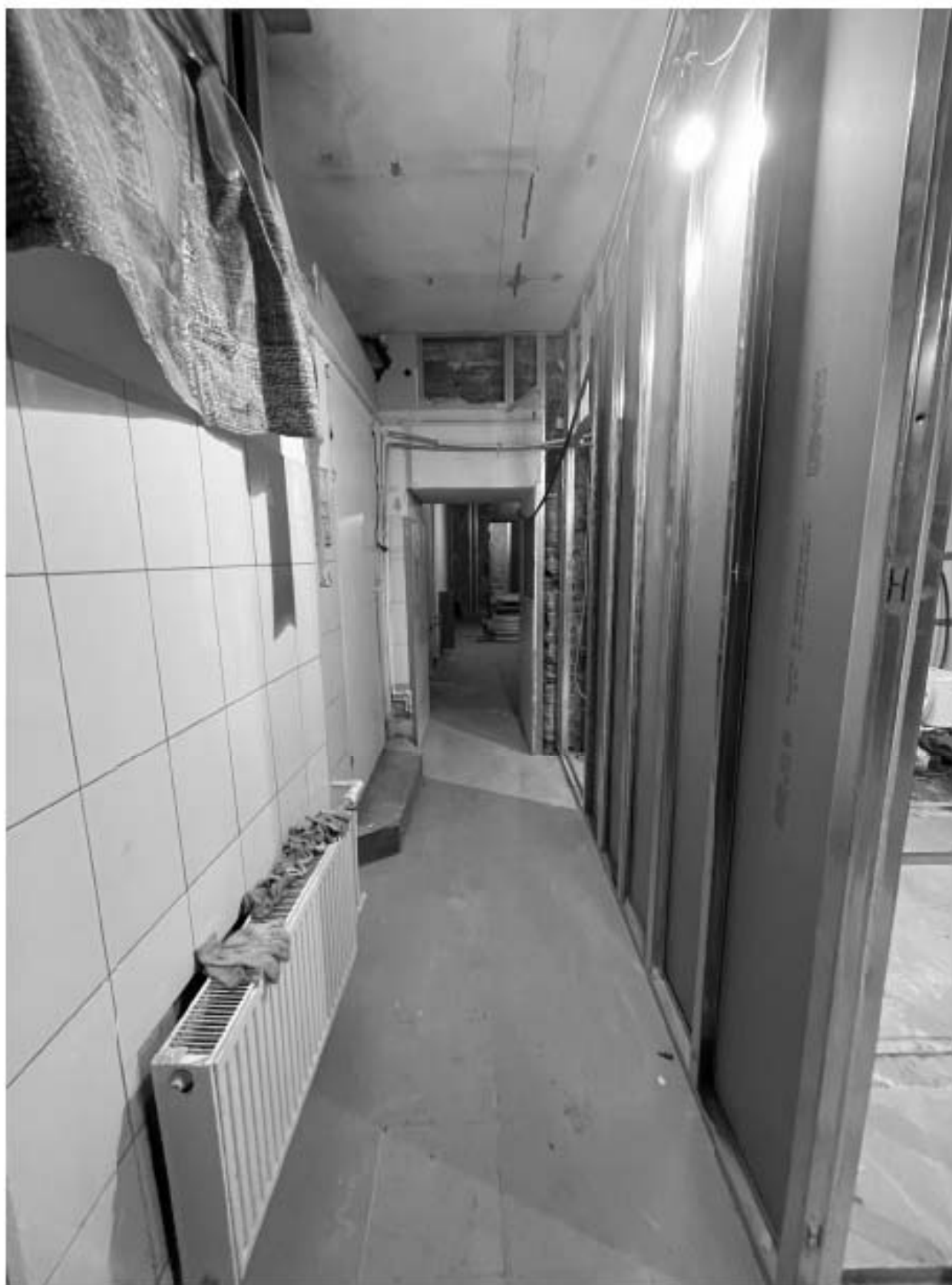
16. Фрагмент интерьера помещений 10/5.8/; 16/3.7;;
