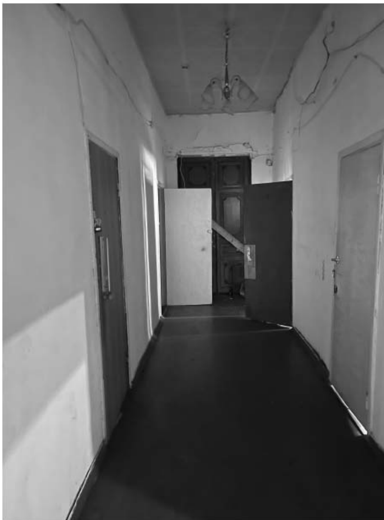
15. Вид на входную дверь в помещение;
