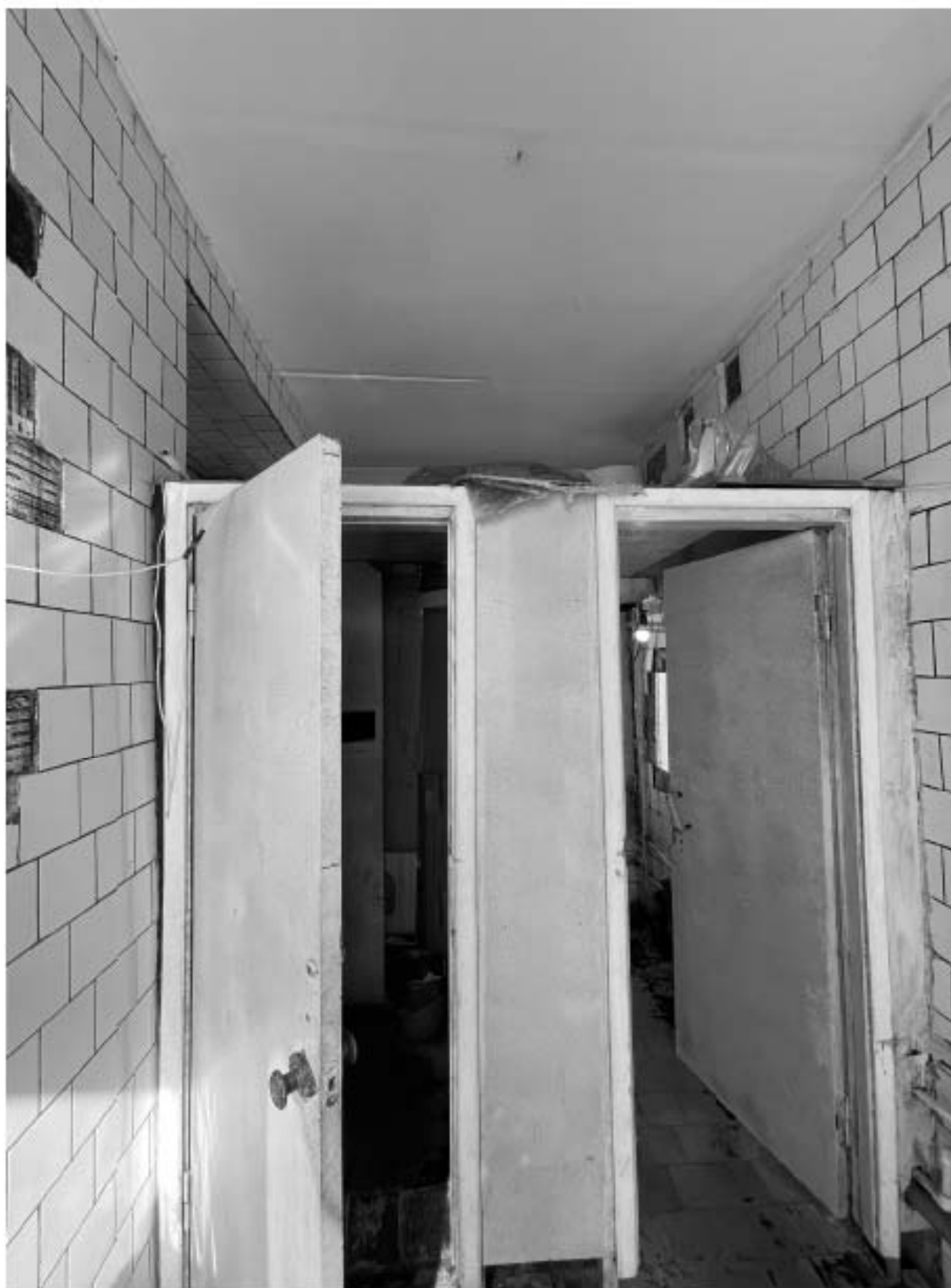
22. Фрагмент интеръера туалета (помещение 9/3.9);
