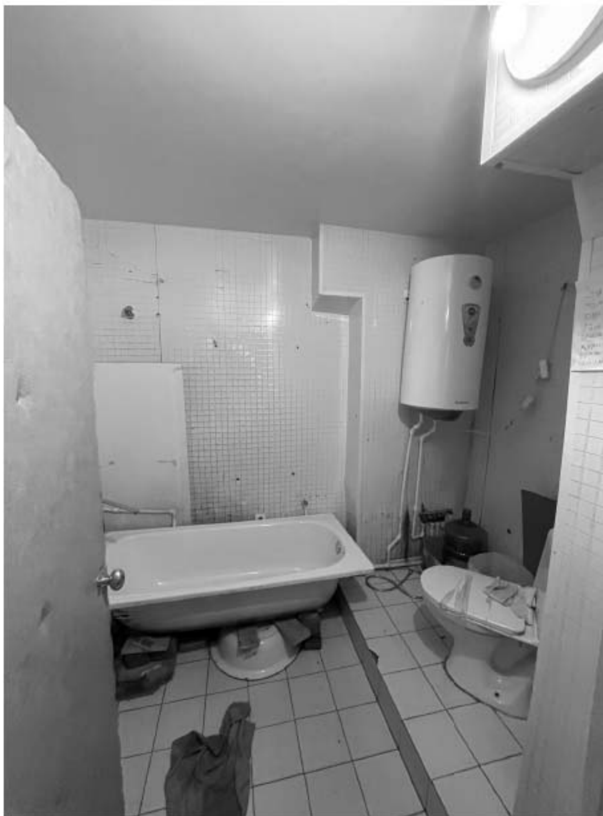
11. Фрагмент интерьера ванной (помещение 21/5.1);
