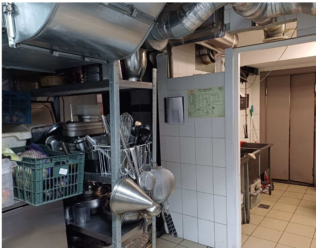
Илл. 10. Помещение 1-Н. Кухня. Съемка 18.10.2024 г. Полетайкин В.В.
