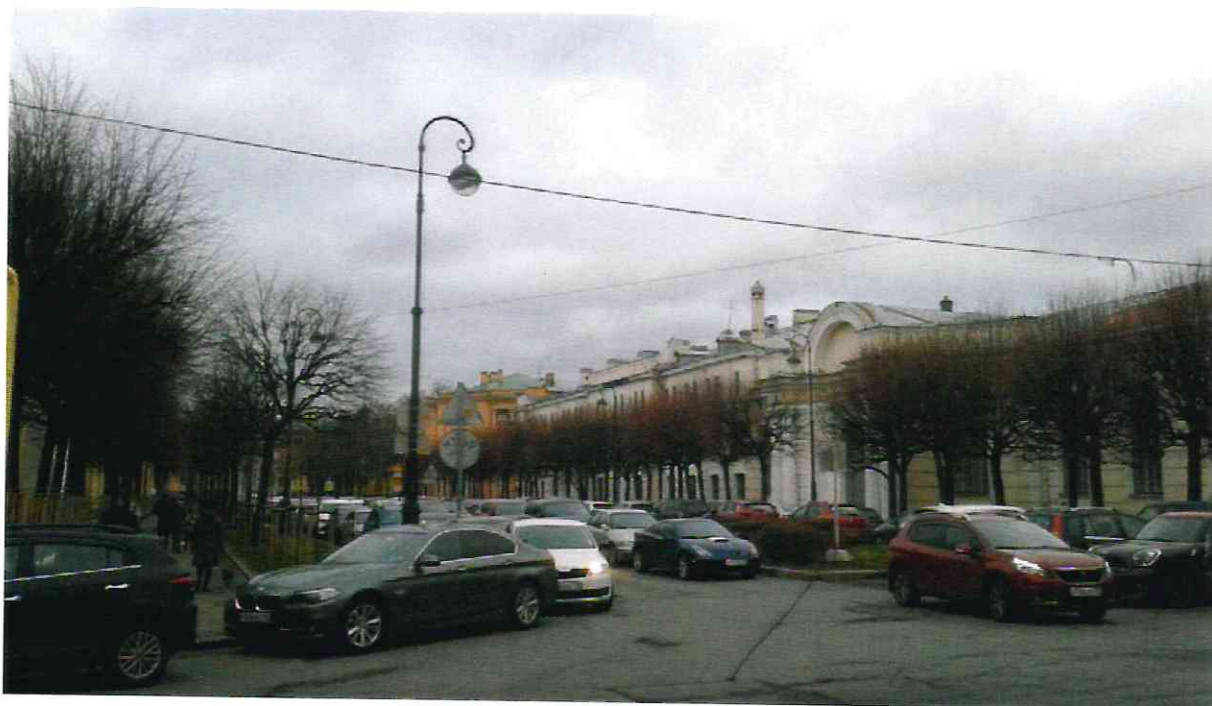
1. Объект культурного наследия федерального значения «Аллея лип» по адресу: г. Санкт-Петербург, Кленовая ул., входящий в состав объекта культурного наследия федерального значения «Михайловский (Инженерный) замок». Общий вид с юга.
