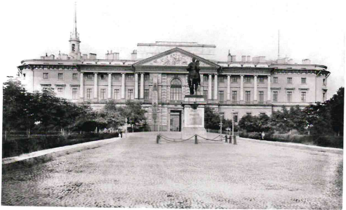
Château des Ingénieurs.
