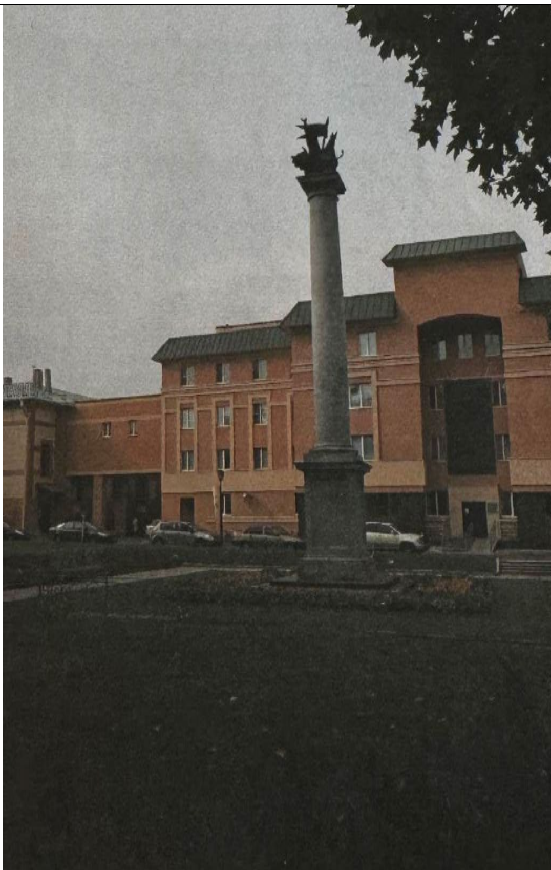
16. Колонна Крымская («Сибирская»), фото 17.09.2015
