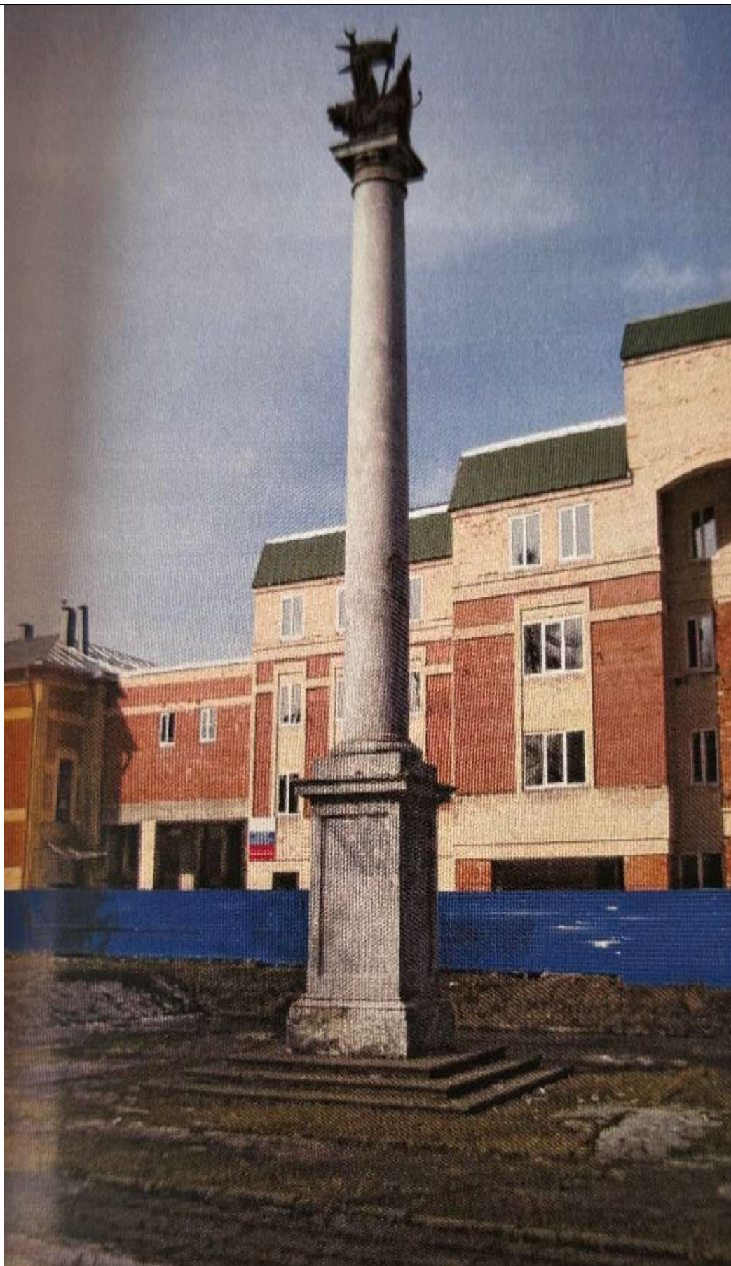
15. Колонна Крымская («Сибирская»), фото 03.04.2008
